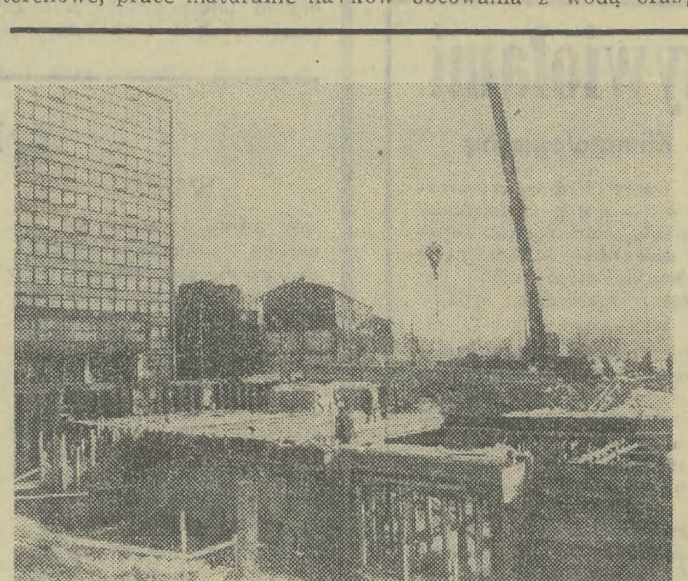
Wczoraj na Placu Bohaterów Getta miała miejsce skomplikowana operacja — rozpoczęto tu bowiem układanie stropów nad przejściem podziemnym, które powstaje w tym rejonie miasta. Uprawni ono znacznie ruch w tej okolicy, stworzy pieszym możliwość bezpiecznego dojazdu do pracy i domów... Fot. W. Klag
