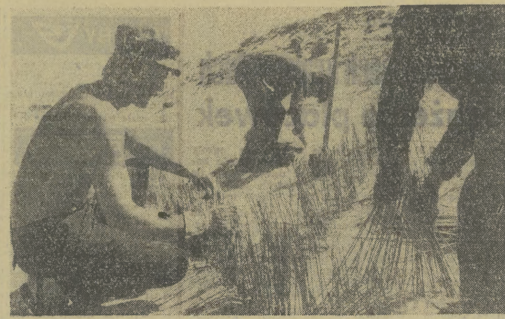
Pracownicy Urzędu Morskiego w Szczecinie budują umocnienia brzegu morskiego w Międzyzdrojach.
