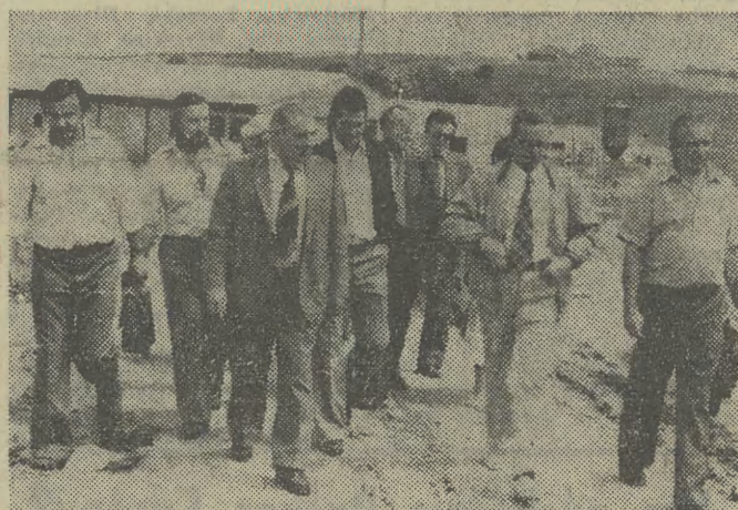
Jan Gluza i Edward Barszcz wraz z towarzyszącymi im osobami wizytują plac budowy fermy SKR w Krzęcinie. Fot. — W. Kłag
