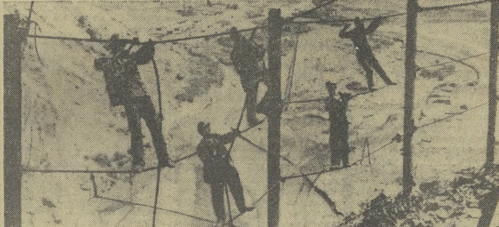
ZSR. Po ukończeniu budowy na rzece Akbura w Kirgizji zapory o wysokości 120 m., utworzony zostanie zbiornik wodny o pojemności 250 tys. m. sześć. Na zdjęciu: montaż stalowej siatki ochronnej, która zatrzymać będzie spadające odłamki skał w czasie budowy tamy. Fot.: CAF — TASS
