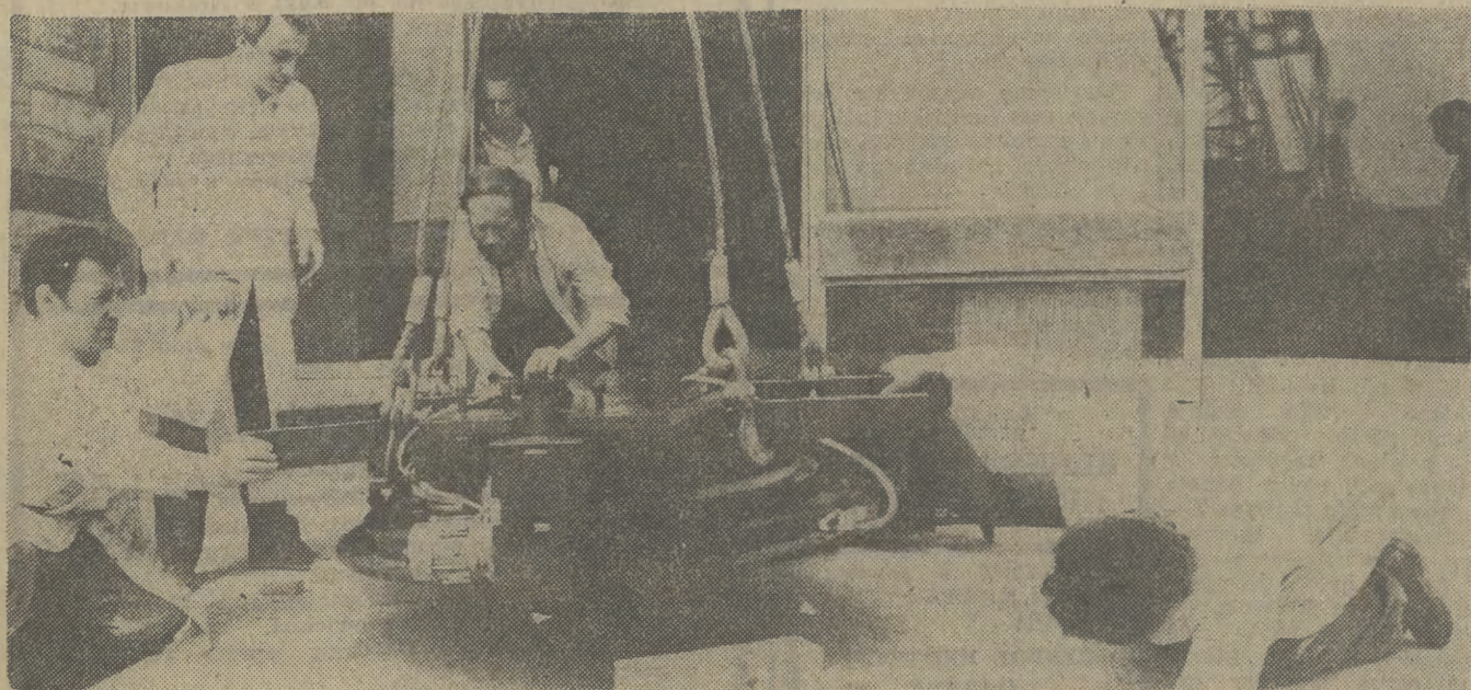
W Zakładzie Teloradioterapii funkcjonuje już rentgen do tzw. głębokiej terapii. Inne specjalistyczne urządzenia są montowane. Na ad.: montaż stołu terapeutycznego wchodzącego w skład urządzenia bomby kobaltowej. CAF — M. Broniarek
