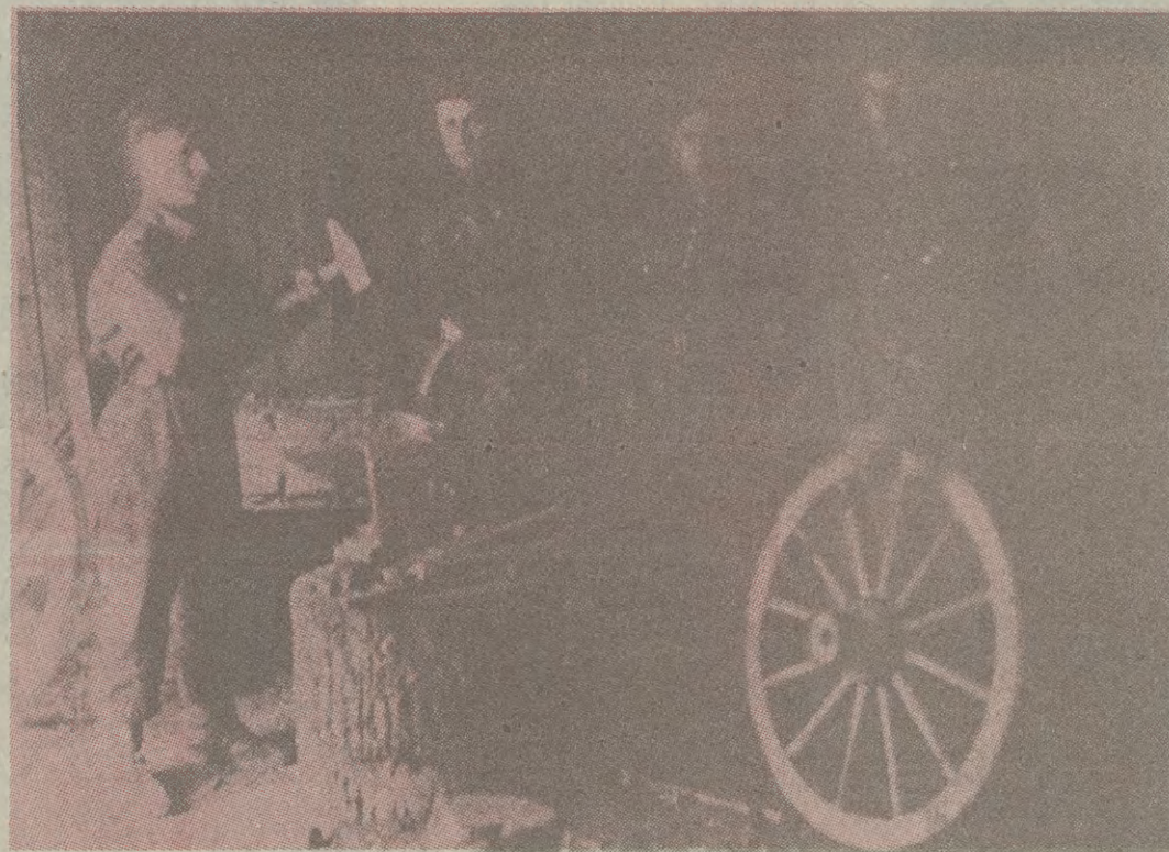
Rok 1935. Budowa zapory w Rożnowie — robotnicy warsztatu mechanicznego.
