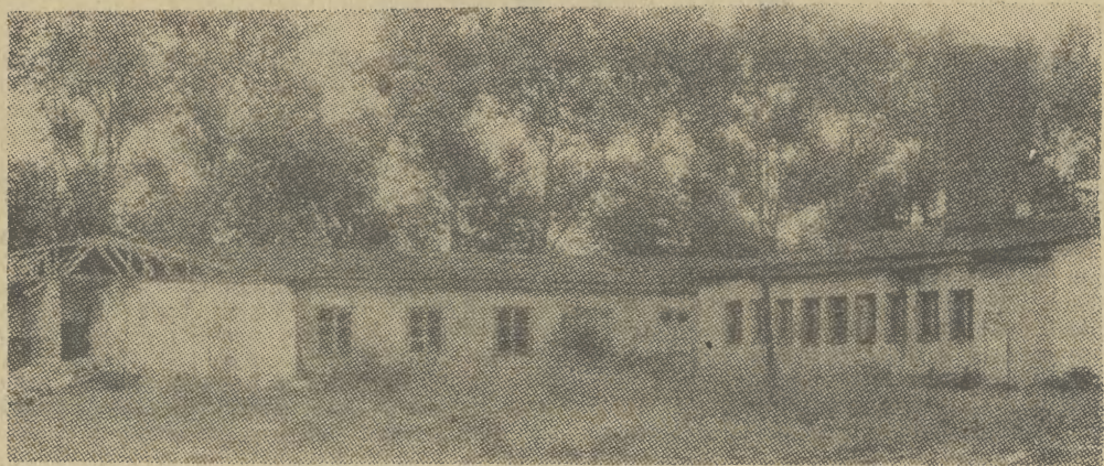
W miejscu baraków dawnego hotelu robotniczego powstanie też blok mieszkalny. Fot. O. LINK
