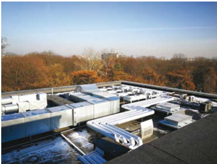
53. Budowa nowej siedziby Archiwum Narodowego w Krakowie. Dach nowego budynku – kanały wentylacyjne i urządzenia zapewniające klimatyzację, widoczna panorama miasta (fot. Paweł Ząbczyński)
