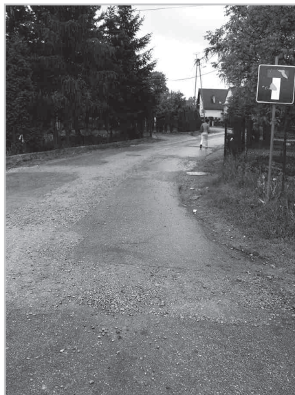
Tak wygląda nawierzchnia ul. Kowalskiej już pod koniec dnia pracy
