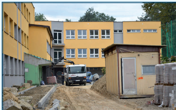
Wrzesień 2013 – finał budowy skrzydła gimnazjum, remont wejścia do szkoły podstawowej i prace terenowe wokół kompleksu szkolnego w Rudniku
