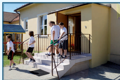
Odnowione wejście do budynku szkolnego w Biertowicach
