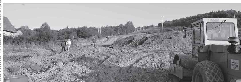
Na budowie wyciągu w Harbutowicach na przełomie października i listopada
