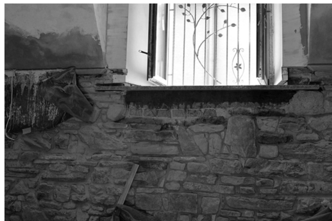
30 września 2016 – zakończono piaskowanie kamienia, z którego zbudowane są ściany kościółka. Kamień zostanie jeszcze zapuszczony prepa- ratem konserwującym, który dodatkowo wydobywa jego barwę (efekt mokrego kamienia). Pęknięcia na sklepieniu zostały zabezpieczone i spięte kłami (po kilka kłami na jedno pęknięcie, a następnie zatynkowane, zgodnie z pierwotnym wyglądem. Zespół pracujący przy remoncie, po ukończeniu prac przy sklepieniu, przystępuje do kładzenia kamiennych posadzek.
