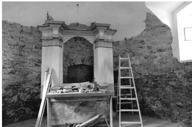
10 kwietnia 2016 – pierwsze prace remontowe, polegające na odkuciu tynku pokrywającego ściany kościółka, wykonała Grupa Gospodar- cza Urzędu Miejskiego w Sułkowicach. Ściany wzniesione są z ka- mienia, sklepienie jest murowane z cegieł.
