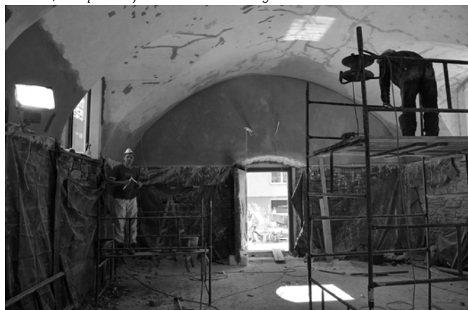
30 września 2016 – zakończono piaskowanie kamienia, z którego zbudowane są ściany kościółka. Kamień zostanie jeszcze zapuszczony prepa- ratem konserwującym, który dodatkowo wydobywa jego barwę (efekt mokrego kamienia). Pęknięcia na sklepieniu zostały zabezpieczone i spięte kłami (po kilka kłami na jedno pęknięcie, a następnie zatynkowane, zgodnie z pierwotnym wyglądem. Zespół pracujący przy remoncie, po ukończeniu prac przy sklepieniu, przystępuje do kładzenia kamiennych posadzek.
