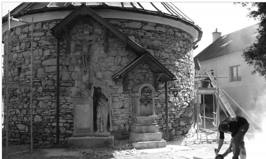
Prace remontowe odkrywają urodę kamiennych ścian kościołka
