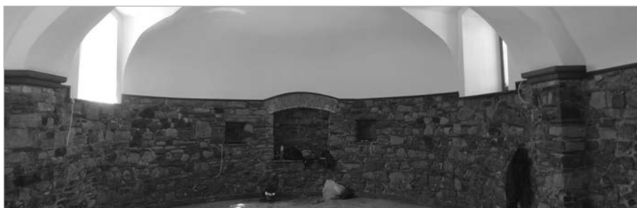
Wnętrze jest już gotowe. Czekają tylko na wyposażenie
