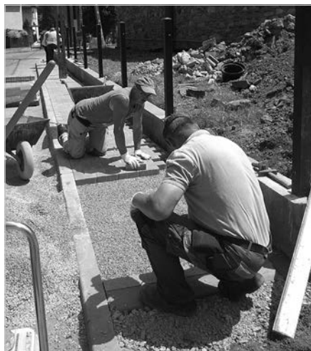
Układanie chodnika przy kościółku św. Zofii – widoczne dwie warstwy podkładu
