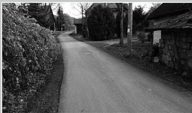
Sułkowice – modernizacja 70 mb drogi bocznej od ul. Kowalskiej – koszt 37 967,64 zł
