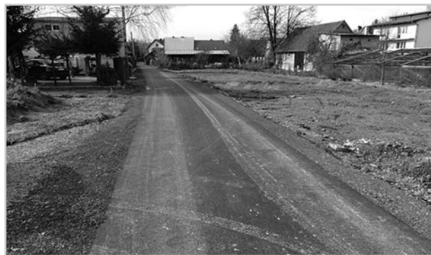
Biertowice – 210 mb nakładki asfaltowej na drodze nr 25 – koszt 95 510,12 zł
