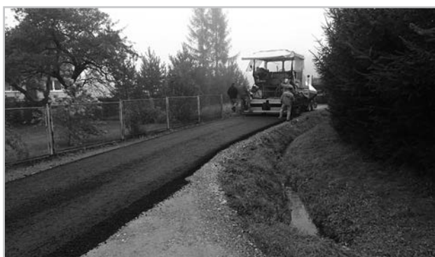
Krzywaczka – 410 mb nakładki asfaltowej na drodze nr 1580/1 – koszt 173 543,01 zł
