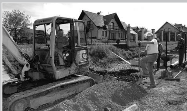
Sułkowice – odwodnienie na długości 193 mb drogi na działce nr 2281 przy ul. Wyzwolenia – koszt 51 500 zł
