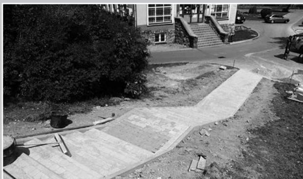
Sułkowice – schody od apteki do ZSZiO w Sułkowicach wraz z odcinkiem chodnika naprzeciwko apteki – koszt 12 tys. zł
