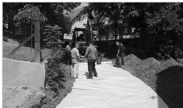
Sułkowice – droga przy ul. Partyzantów, wykonano 200 mb nakładki asfaltowej – koszt 73 325,77 zł
