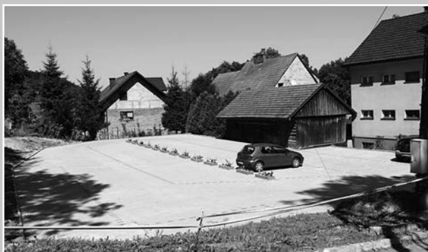
Harbutowice – parking przy kościele – o powierzchni 800 m 2 – koszt ok. 90 tys. zł
