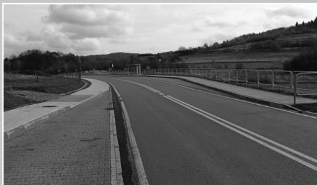
Harbutowice – obustronne zatoki przystankowe przy drodze wojewódzkiej na przełęczy Sanguszkowej wraz z wiatami przystankowymi – koszt 174 690,01 zł
