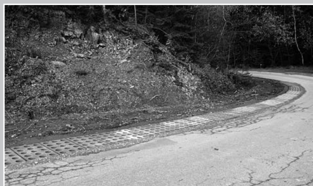
Harbutowice – umocnienie poboczy drogi na Końcówkę przez grupę gospodarczą UM, koszt –
