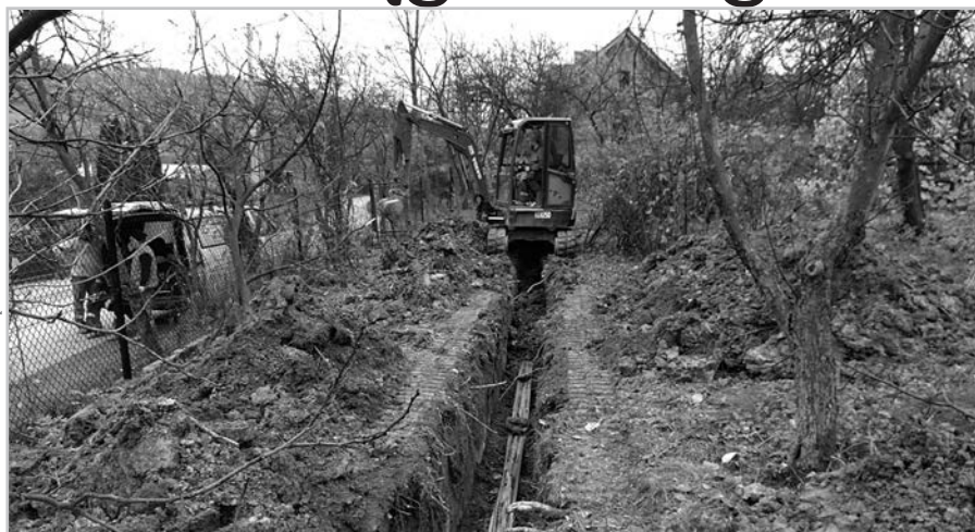
Budowa wodociągu na Pagorku w Harbutowicach
