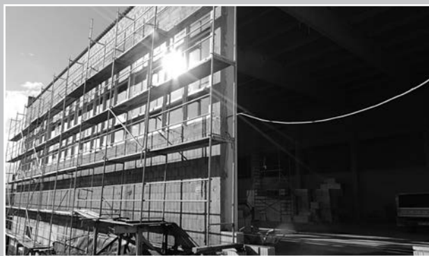
Wykonywane są tynki i ocieplenie zewnętrzne, zamówiona została także stolarka zewnętrzna.
