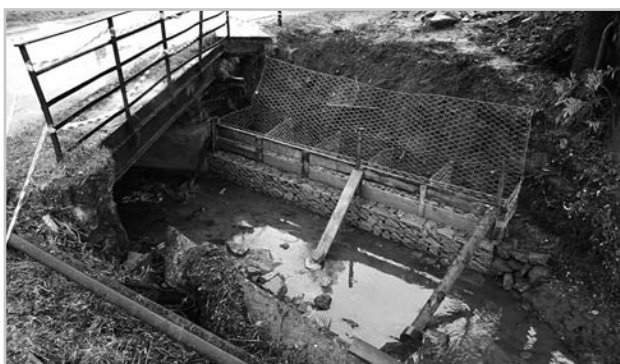
Rudnik, Sułkowice, Harbutowice – zabezpieczenie przyczółku mostu w Rudniku i naprawa przepustów po intensywnych opadach deszczu – koszt 30 000 zł
