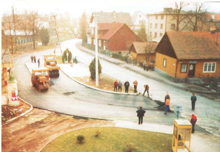
Prace na przystanku PKS
