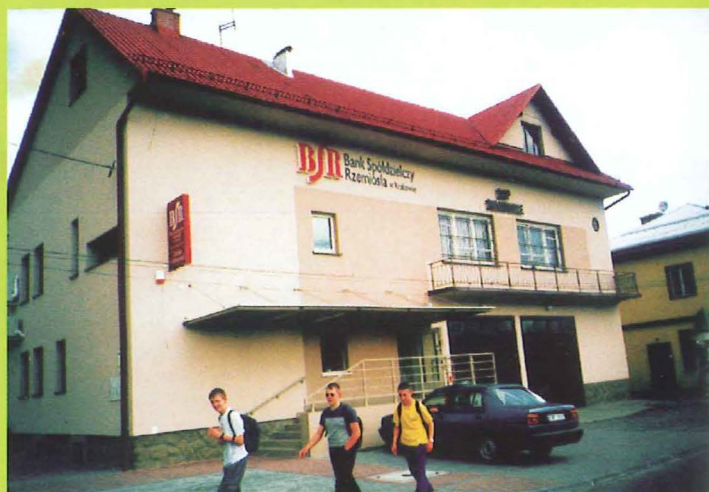
Strażnica OSP z odnowioną elewacją
