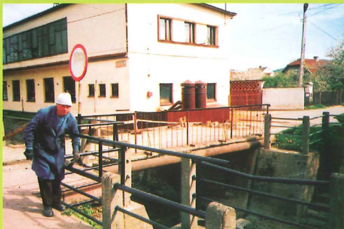
Remont most obok Cepelii rozpocznie się w czerwcu. Tymczasem "Małgoška" maluje poręcz.
