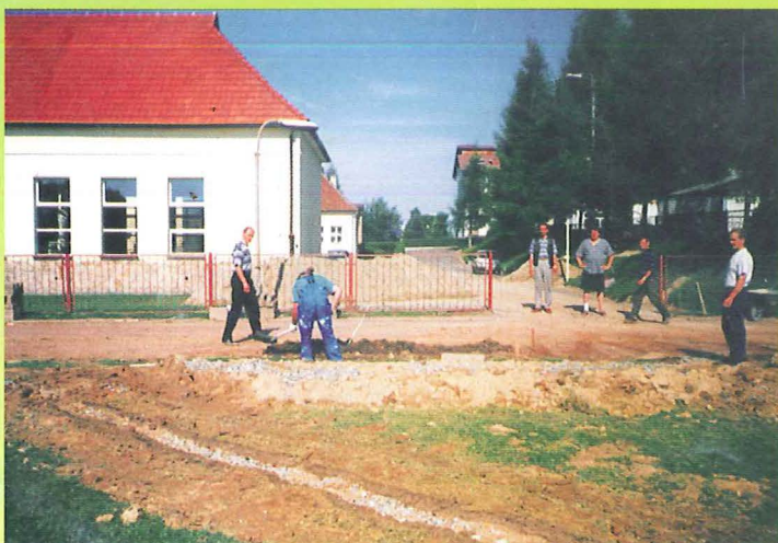
● Remont kapitalny boiska szkolnego w Sułkowicach
