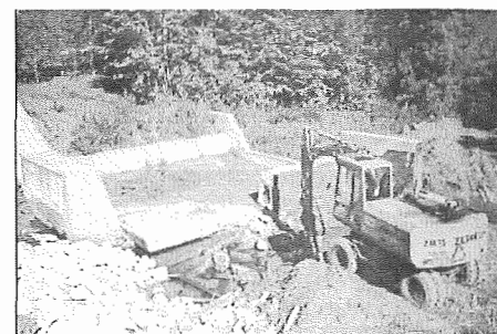
Odbudowa tamy przed Kolonią
