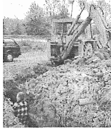
Budowa sieci wodociągowej w Krzywaczce
