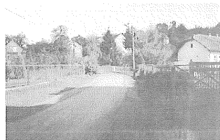
Nowa nawierzchnia drogi na Skotnicę
