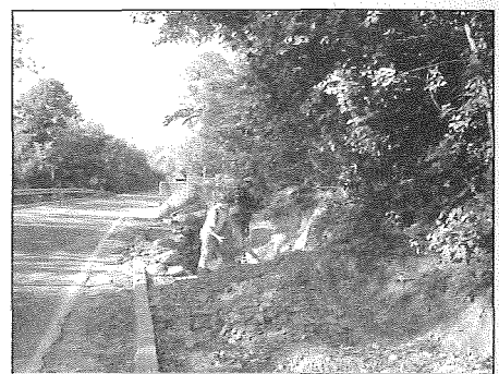
Harbutowice - budowa chodnika
