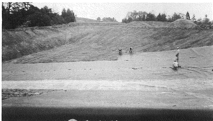
Nowe wysypisko w budowie.
