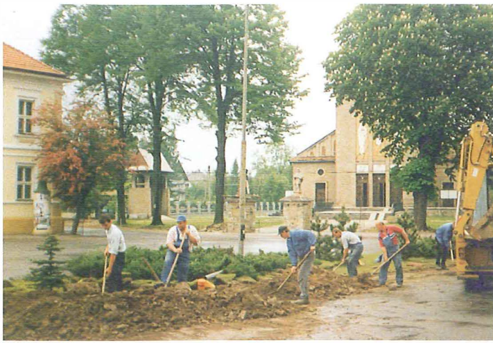
Budowa linii światłowodowej w Ryńku
