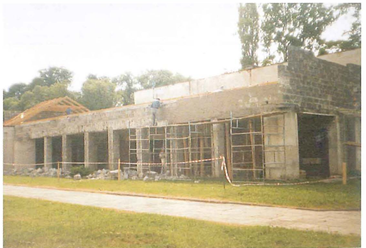
Nowy dach na ruinach hotelu
