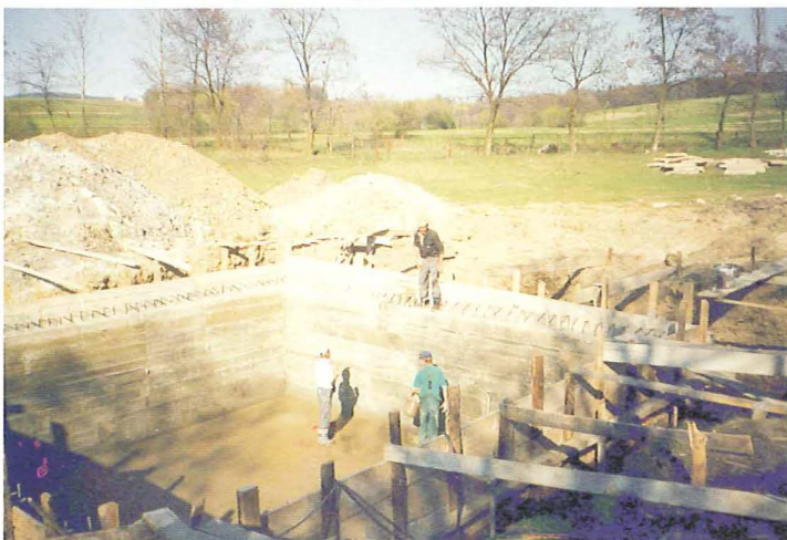
Budowa zbiornika sanitarnego dla gimnazjum
