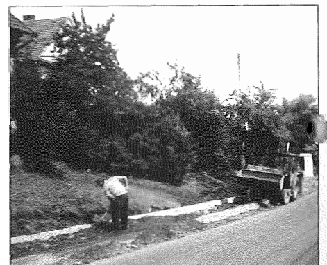
Budowa chodnika w Charbutowicach
