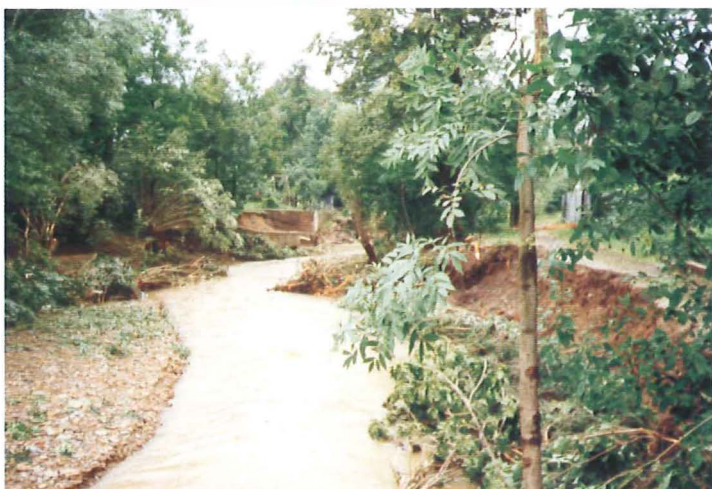
Uszkodzone brzegi rzeki
