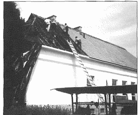
Remontowany budynek Szkoły Podstawowej w Sułkowicach
