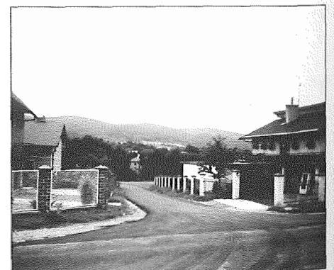
Nowa asfaltowa droga w Rudniku
