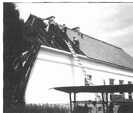
Remontowany budynek Szkoły Podstawowej w Sułkowicach
