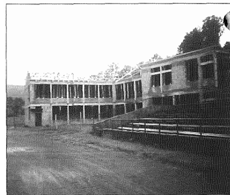
Budowa budynku Gimnazjum nr 2
