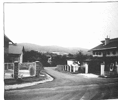
Nowa asfaltowa droga w Rudniku
