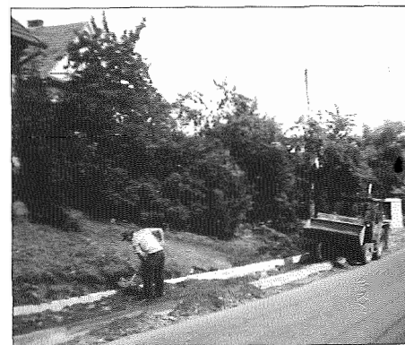
Budowa chodnika w Charbutowicach
