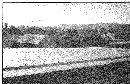
Nowe pokrycie dachu na hali sportowej w Krzywaczce
