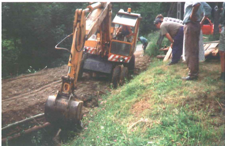
Naprawa drogi na Jaworze
