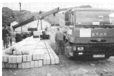
Budowa sieci teletechnicznej
