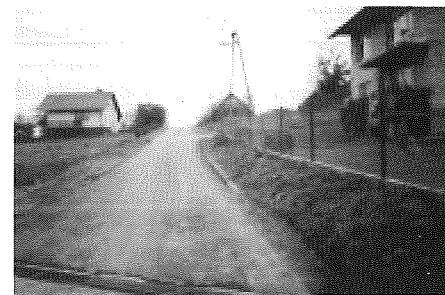
Nowa droga asfaltowa - Rudnik Dolny
