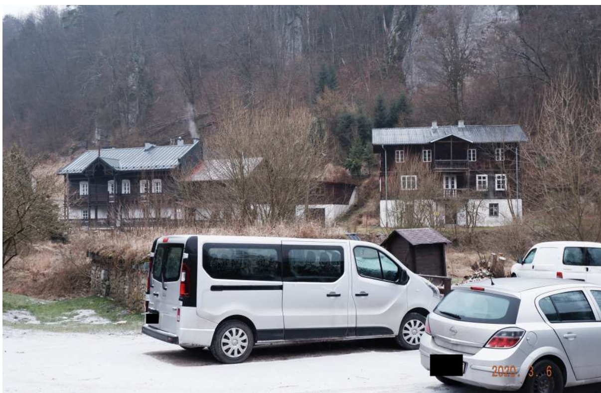
Fot. nr 92 (92-93). Murowany hotel Pod Żółtą Górą (z lewej pod nr 22), powstały na przełomie XIX i XX wieku i drewniana willa Grzybowskich pod nr 21, również pochodząca z tego okresu.
