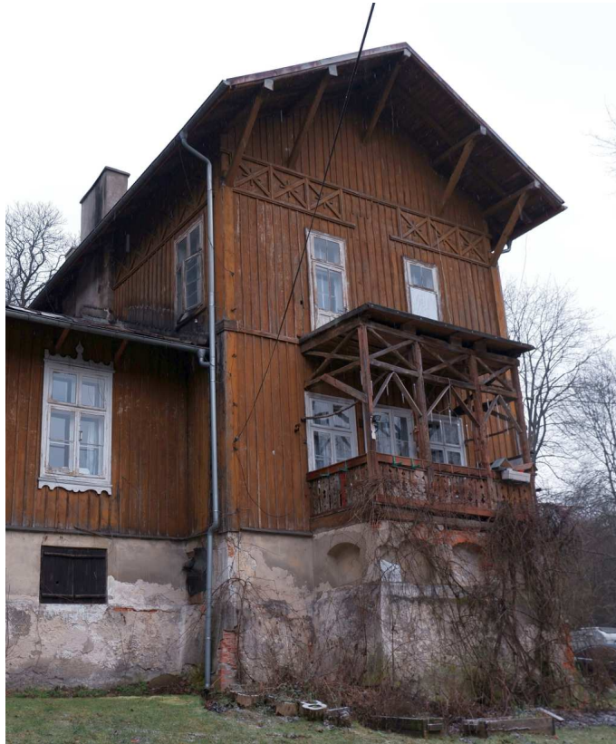
Fot. nr 105 (105-106). Fasada od strony drogi z loggią widokową.
