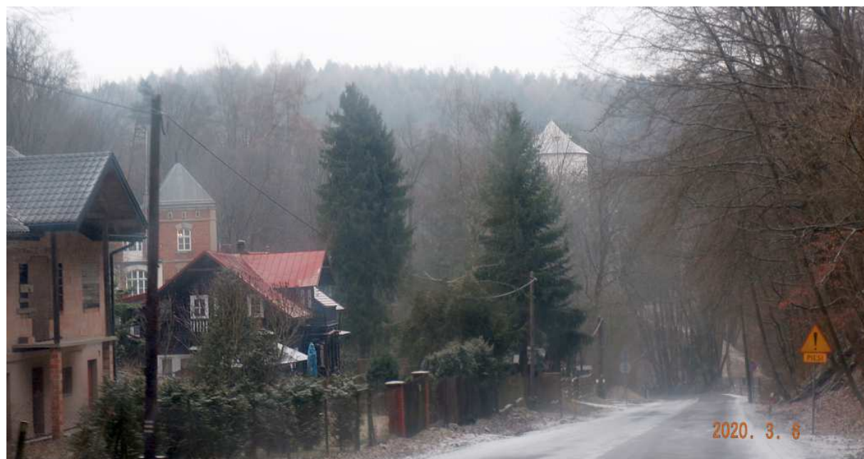
Fot. nr 36 (36-39). Willa Zorza pod nr 8. Ten drewniany obiekt powstał w roku 1907.
