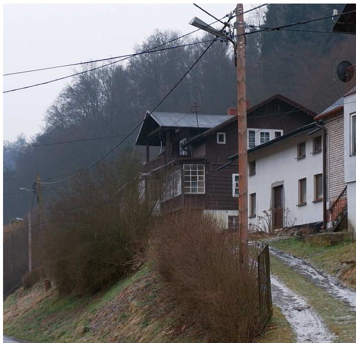
Fot. nr 99. Willa Dulewiczówka pod nr 25. To obiekt murowano-drewniany z przełomu wieków: XIX i XX.
