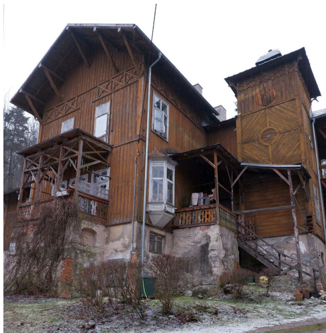
Fot. nr 108 (108-110). Wieża dobudowana do prawego boku obiektu.
