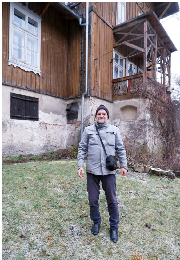
Fot. nr 3. Przed willą Pod Berłem. Ten przepiękny zabytkowy obiekt, wybudowany w roku 1885, szczególnie potrzebuje pilnego remontu.
