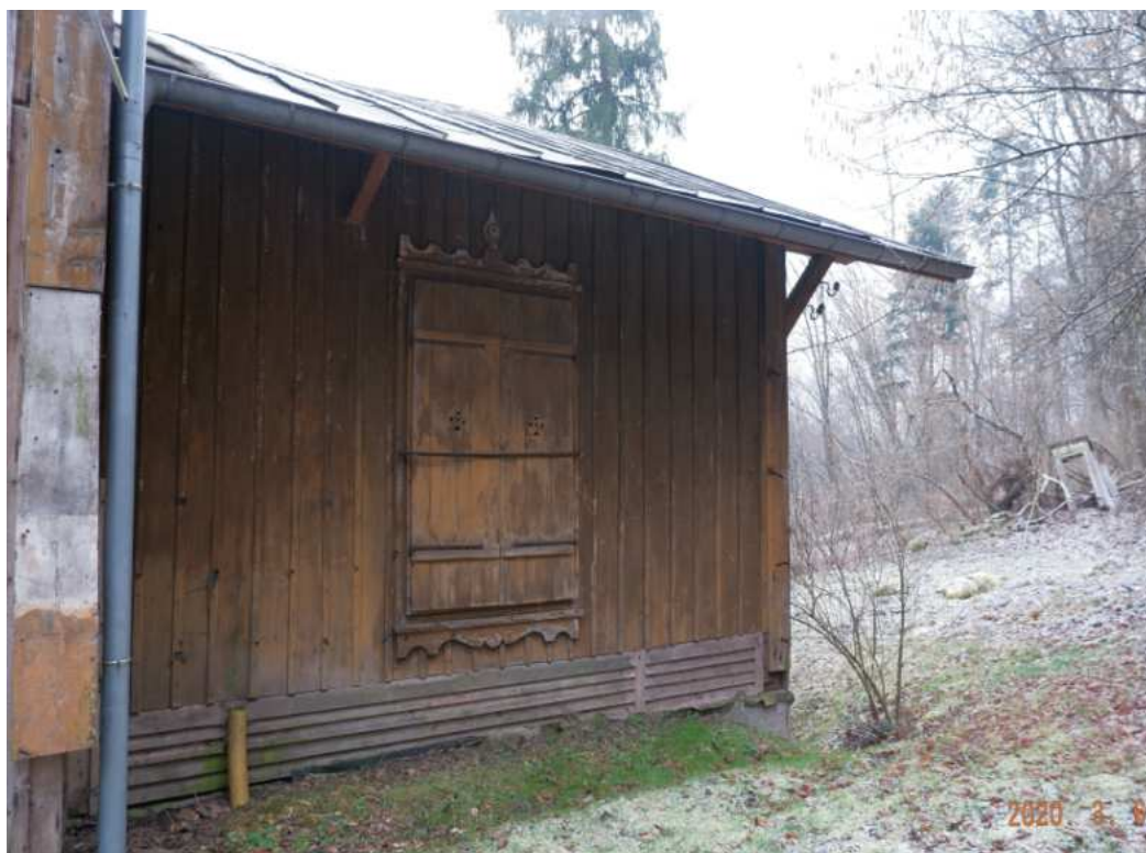
Fot. nr 113. Detale stolarki.
