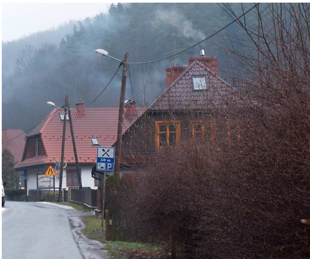
Fot. nr 142. Drewniane kiedyś domy pod nr 3 i 4, wybudowane ok. roku 1875, dziś przebudowane na obiekty murowane.
