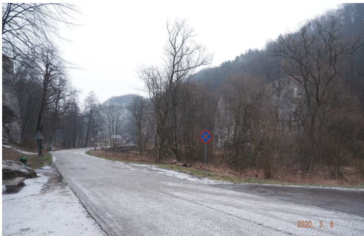
Fot. nr 116 (116-118). Zamknięta dla ruchu droga wiodąca z Murowni, pokryta oryginalną, przedwojenną kostką.
