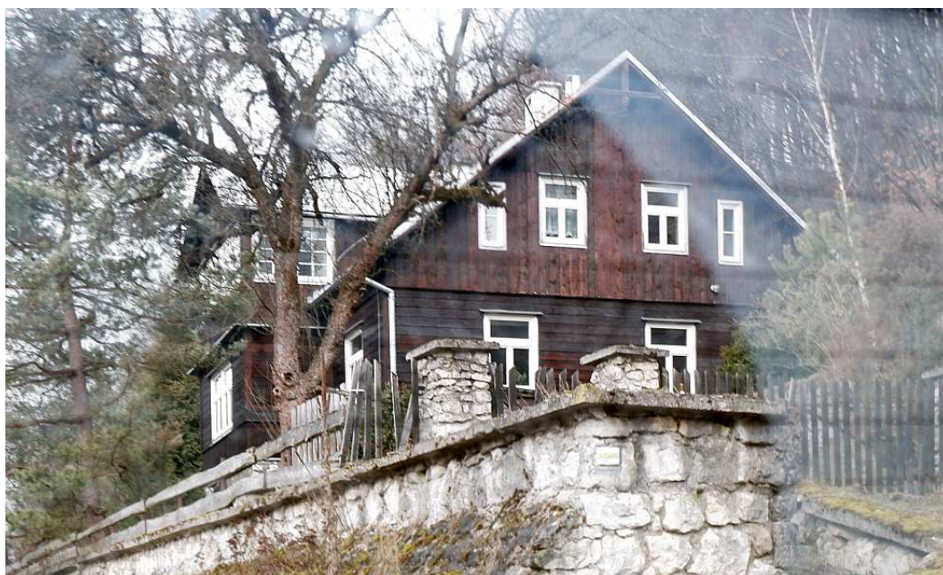
Fot. nr 152. Willa Warzechówka (nr 90) w przysiółku Podkalinowie, ukończona w roku 1939. To obiekt drewniany posadowiony na podmurówce. Własność OPN.
