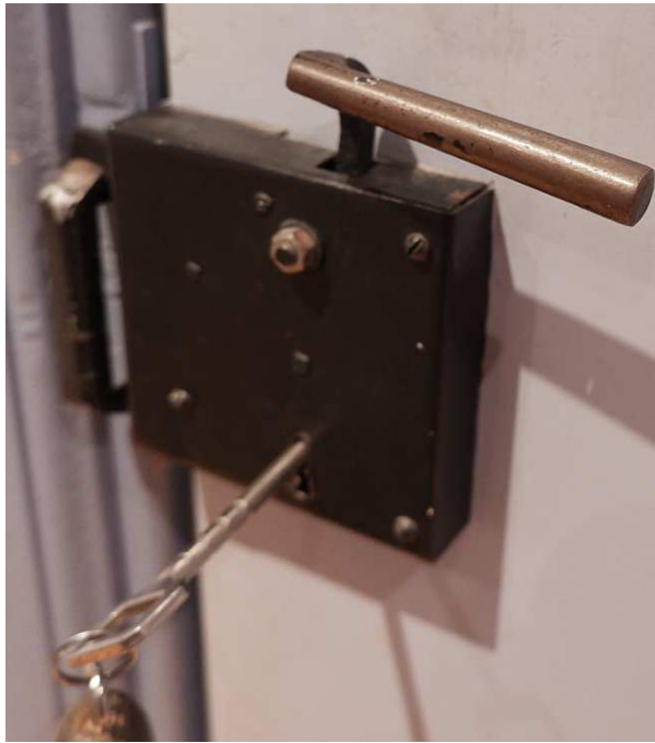
Fot. nr 64 (64-66). Zachowane detale. Oryginalny zamek w drzwiach.
