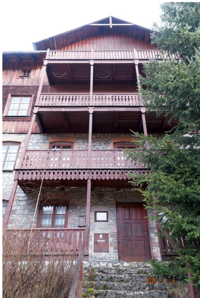
Fot. nr 151. Fasada pierwotnie drewnianego obiektu, przebudowanego w latach 80. XX wieku na murowany.
