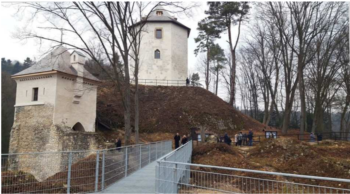
Fot. nr 48. Świeżo odrestaurowane: brama zamkowa oraz baszta ośmioboczna. (fot. Monika Bogdanowska - luty 2020)
