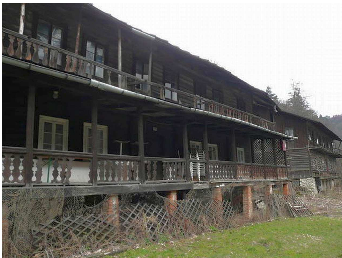
Fot. nr 30. Drewniane budynki pod nr: 16 i 17. (2004)
