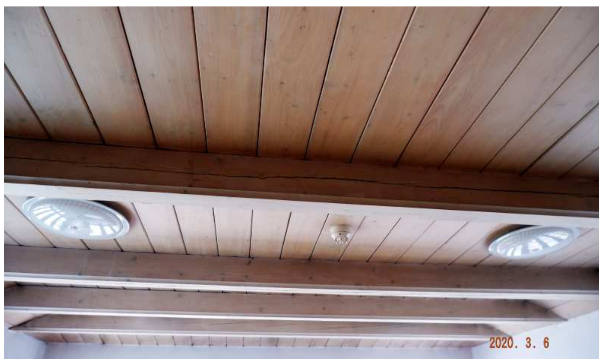
Fot. nr 63. Sufit podparty na dźwigarach.
