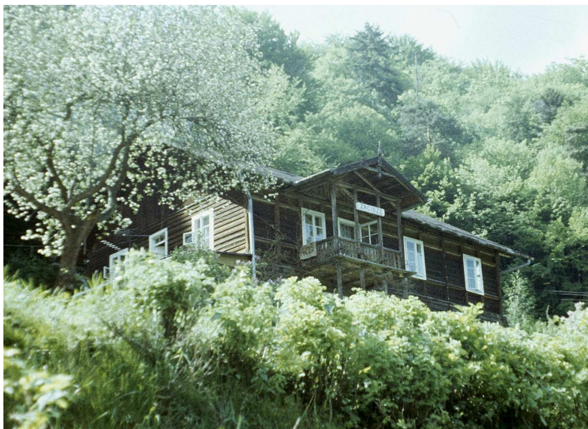
Fot. nr 23. Pochodząca z końca XIX wieku drewniana willa Zacisze spod nr 28, posadowiona na podmurówce.
