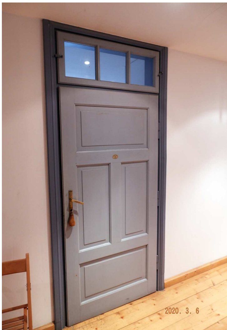
Fot. nr 65 (65-66). Drzwi z przełomu lat 20/30 XX wieku.
