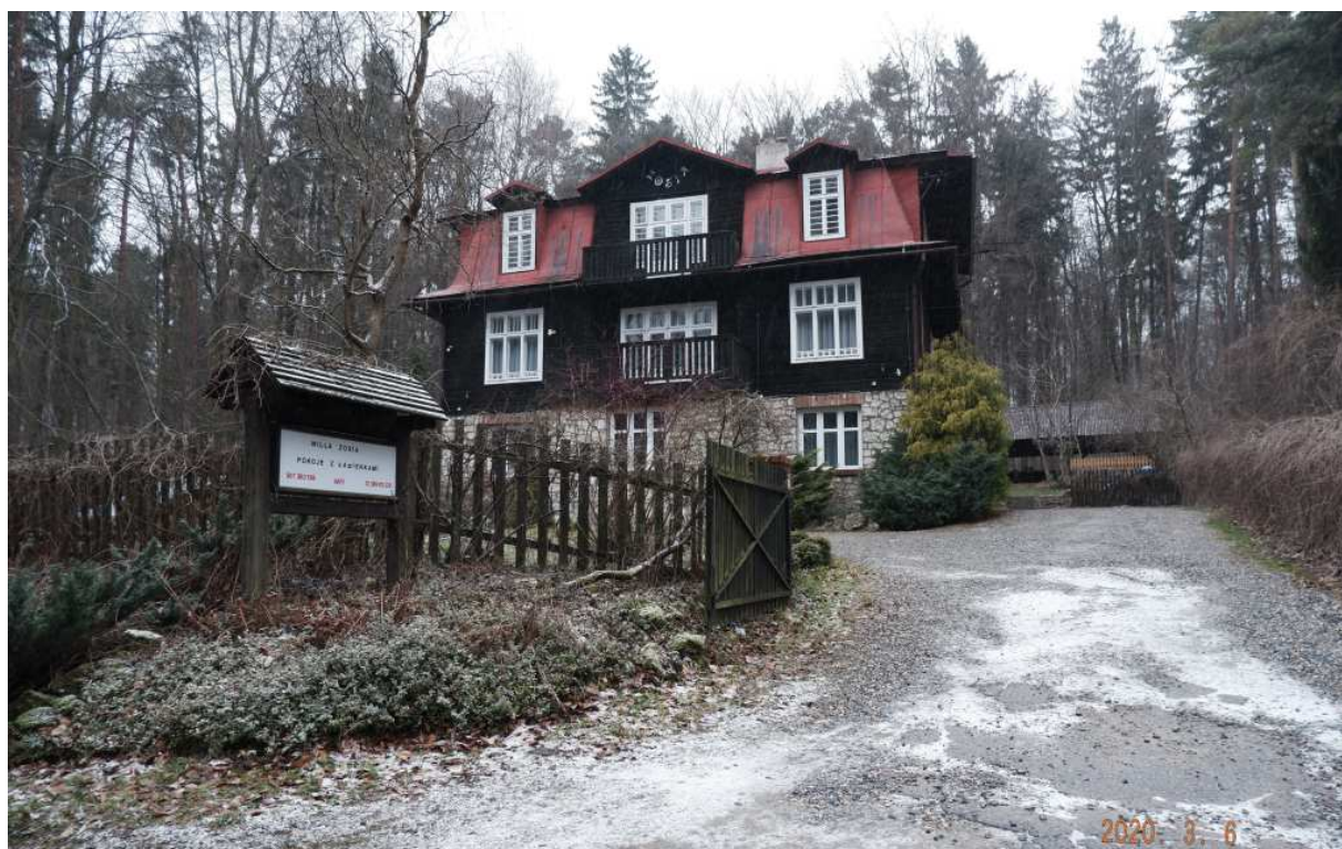
Fot. nr 32 (32-33). Willa Zosia - Żłota Góra nr 4, wybudowana w latach 20. XX wieku. Własność OPN.
