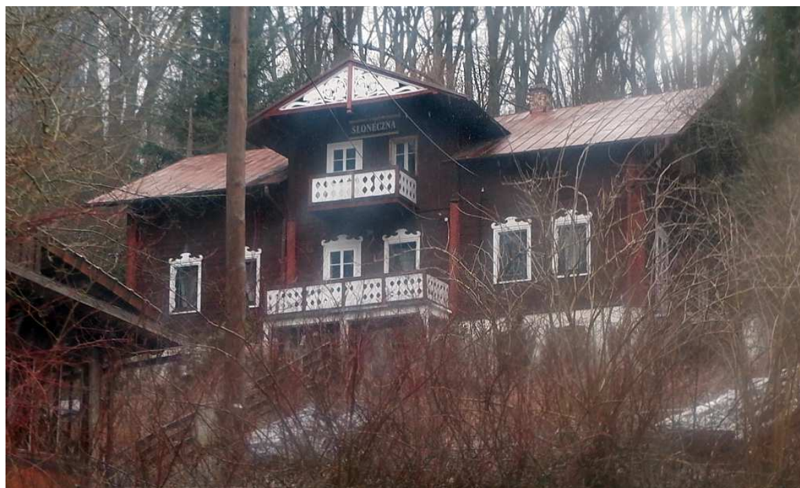
Fot. nr 40 (40-42). Willa Słoneczna pod nr 6, obiekt drewniany na podmurówce, ukończony w roku 1903.
