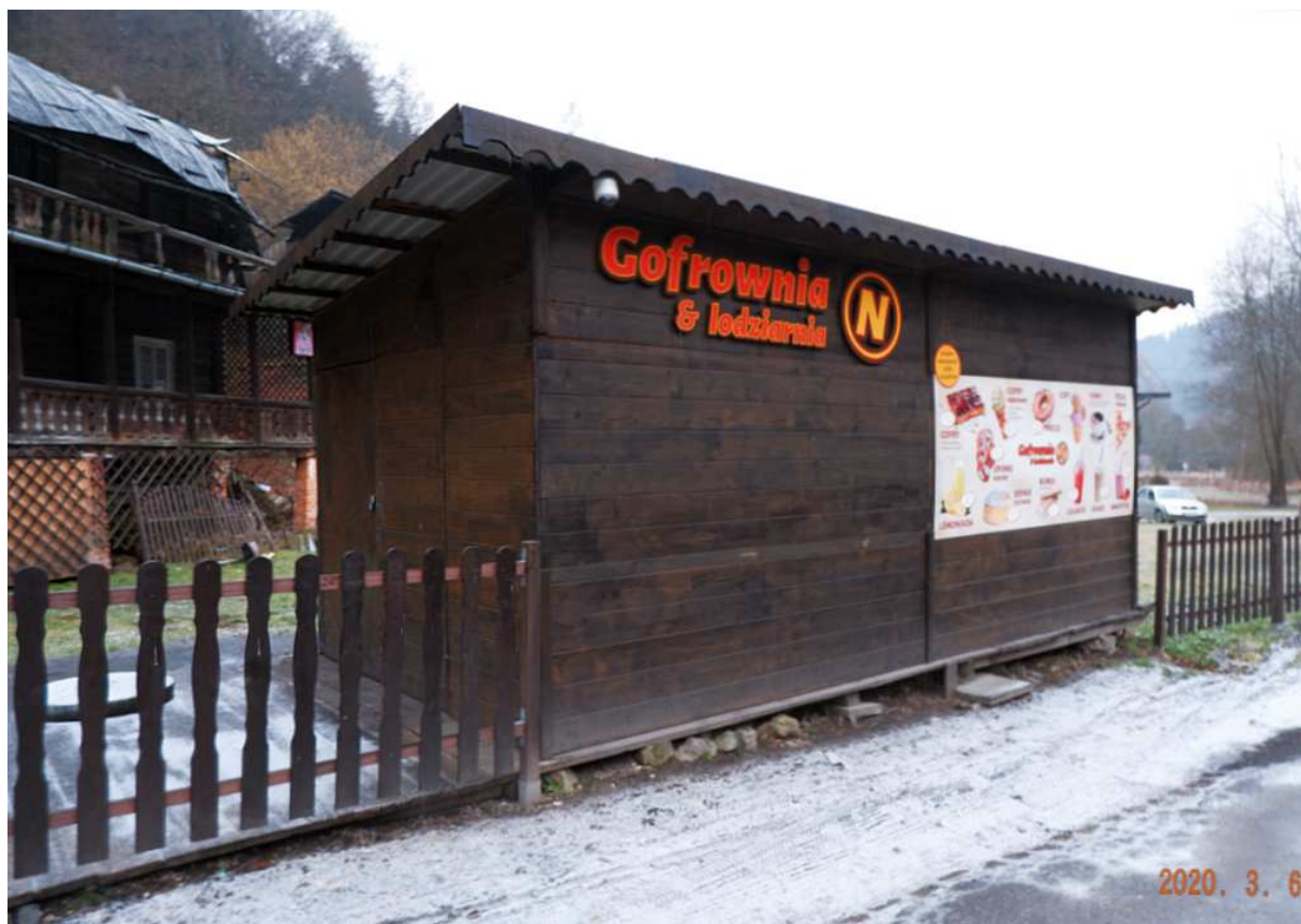
Fot. nr 74 (74-75). Nie posiadający fundamentów, kryty falistą blachą kiosk gastronomiczny na przedpolu Zawiszówki. Boże chroń od wichur.
