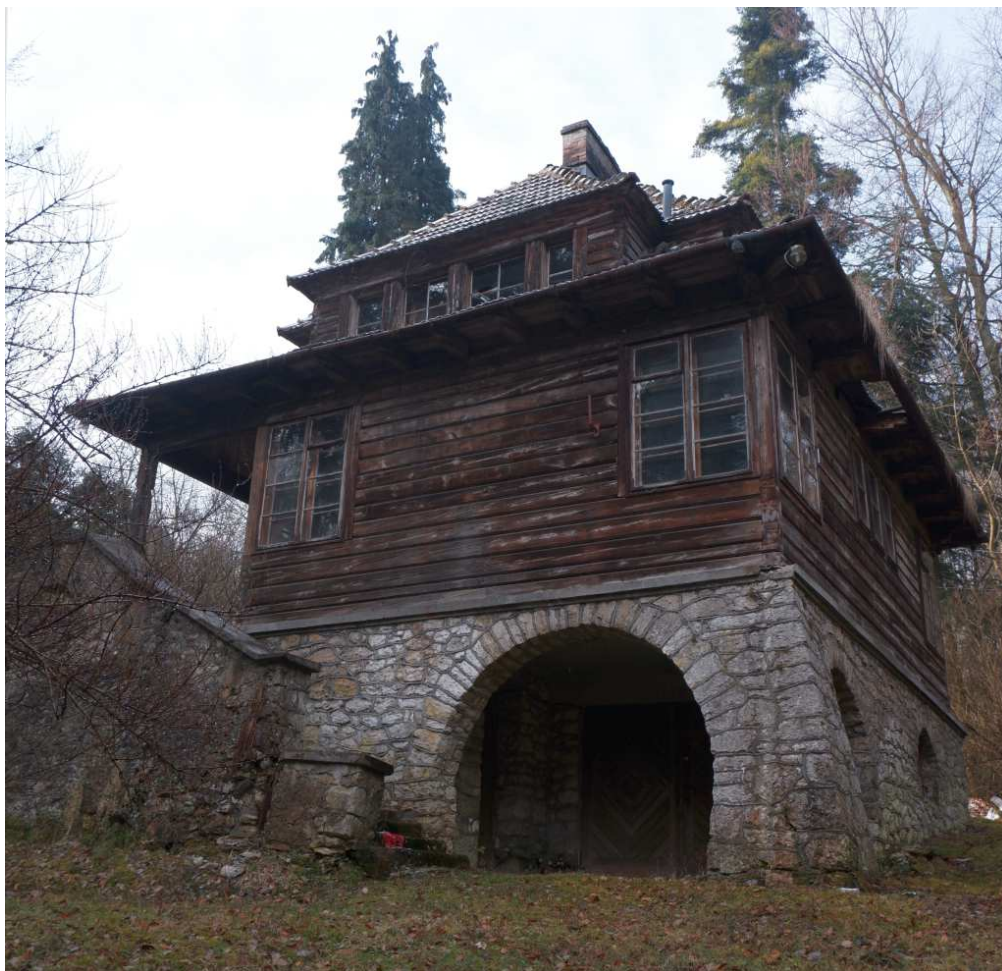
Fot. nr 34. Fasada drewnianego obiektu, który powstał na kamiennej podmurówce.
