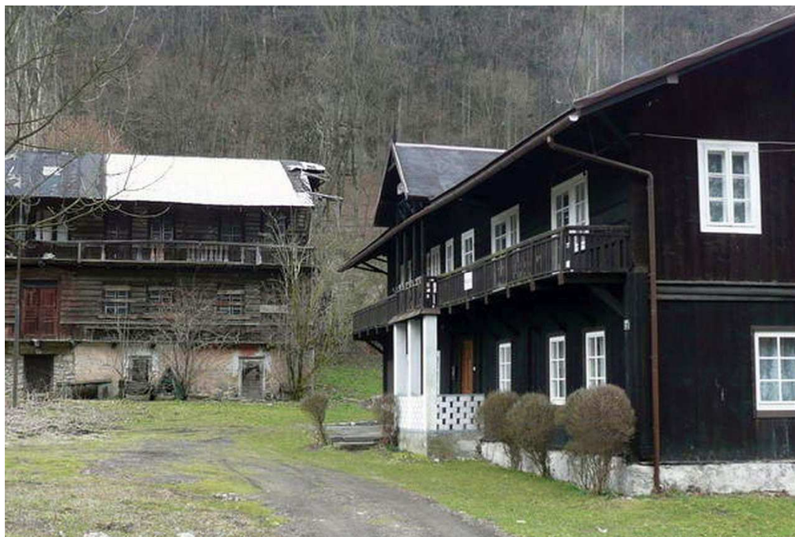
Fot. nr 29 (29-30). Kompleks Zawiszówki. Budynki pod nr: 19 (z prawej) i nr 17. (2004)
