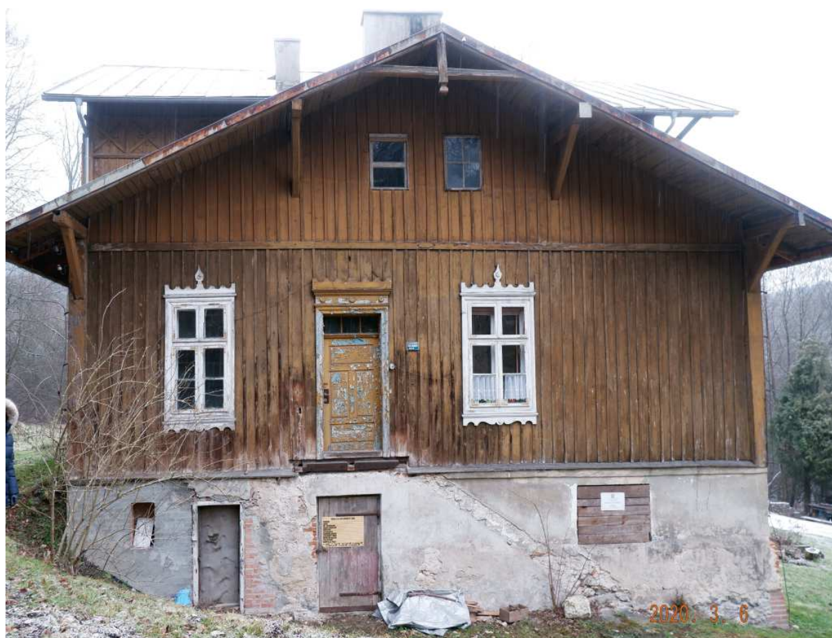
Fot. nr 114. Ściana willi z jej lewej strony.
