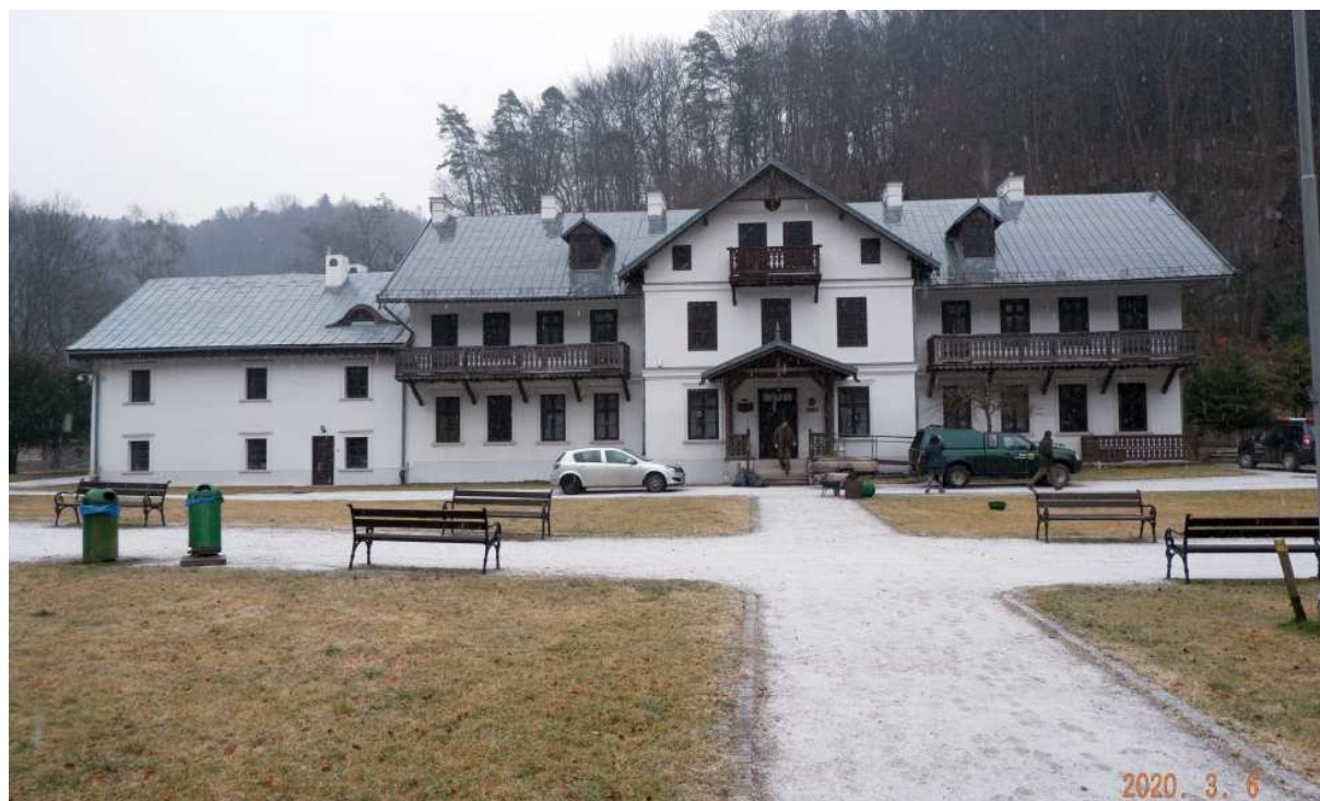
Fot. nr 56 (56-57). Fasada obiektu od strony parku. Ten murowany obiekt powstał w roku 1885.
