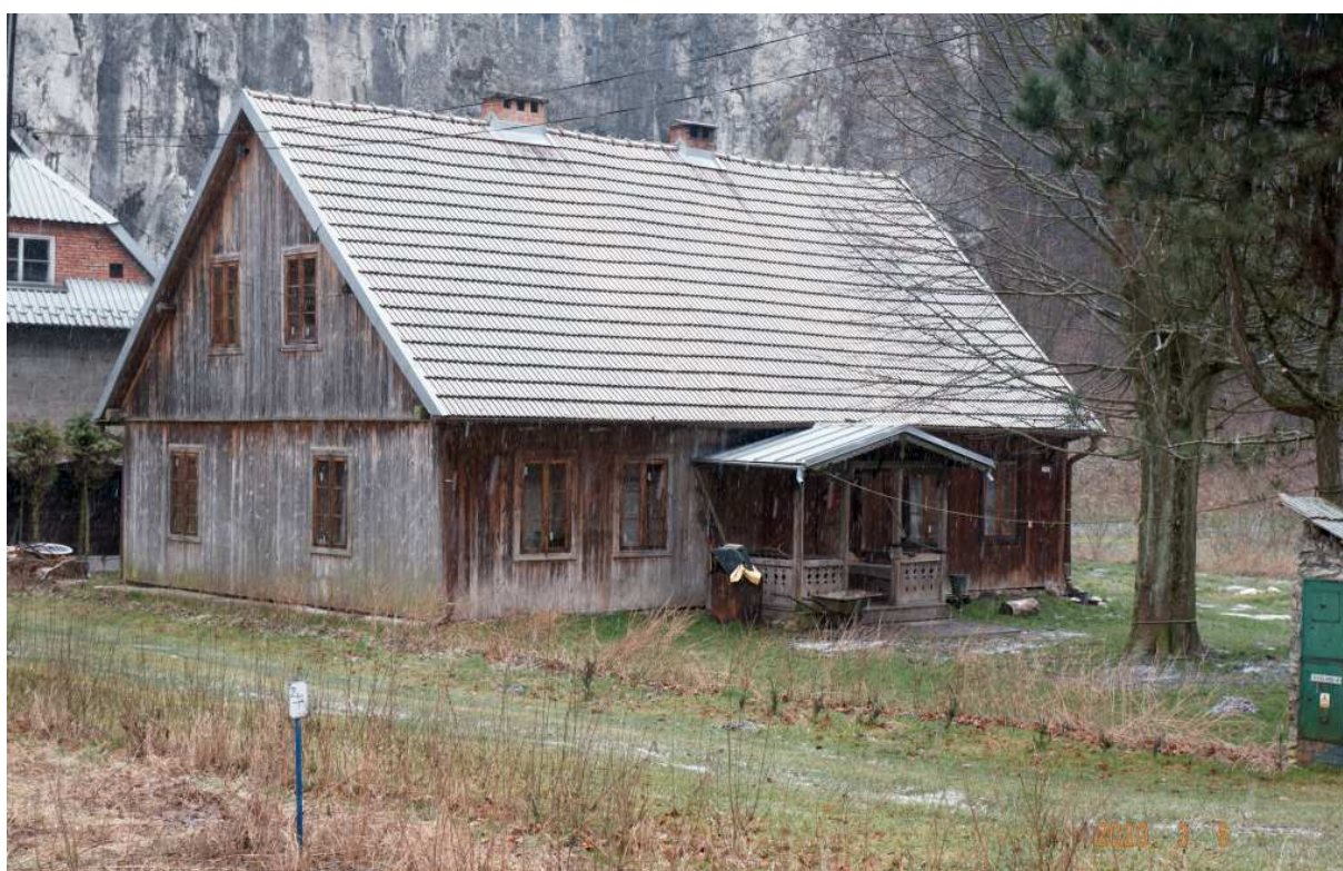
Fot. nr 122. Dom drewniany pod nr 52, który powstał niemal 100 lat temu, bo w latach 1922/23.
