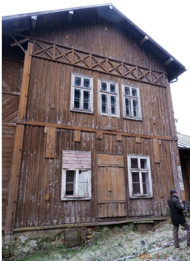
Fot. nr 112. Ryzalit w tylnym fragmencie.
