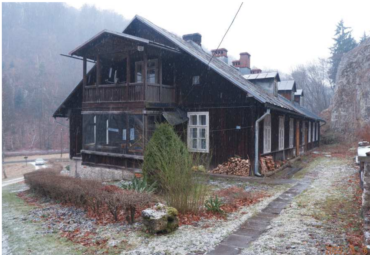
Fot. nr 129 (129-130). Tylny fragment obiektu.
