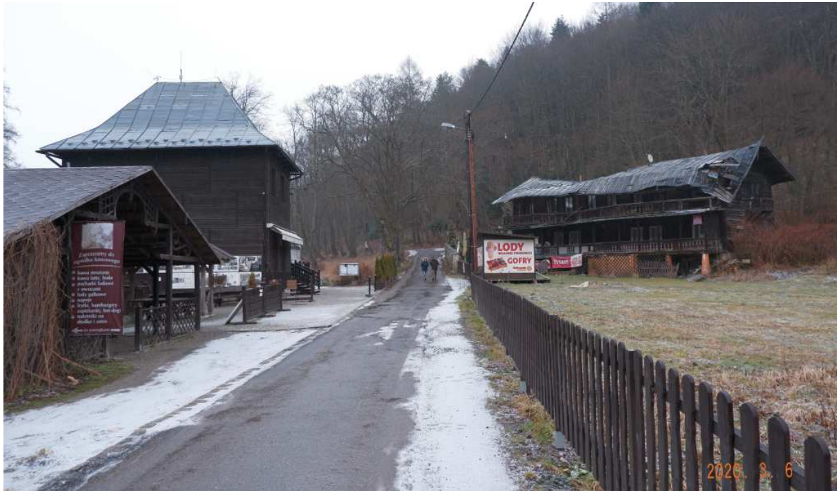
Fot. nr 72. Widok na Bazar Warszawski pod nr 15 (z lewej) i ciągle czynny, pomimo fatalnego stanu technicznego, budynek pod nr 16 z kompleksu Zawiszówki. A z lewej wiatra gastronomiczna i otwarty kompleks ław dla turystów, który nie przystaje do dawnej koncepcji zabudowy.
