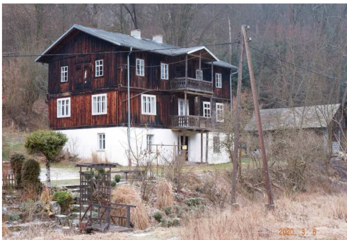
Fot. nr 94. Willa Grzybowskiach pod nr 21, która prosi się o remont.
