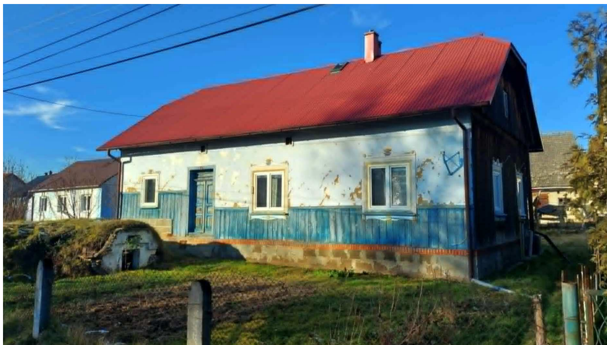
Fot. nr 32 (32-33). Znacznie przebudowany już dom w zagrodzie pod nr 119. Na fasadzie, w dolnej części pozostało jeszcze pasmo szalunku z drewnianych desek. (18.01.2025)
