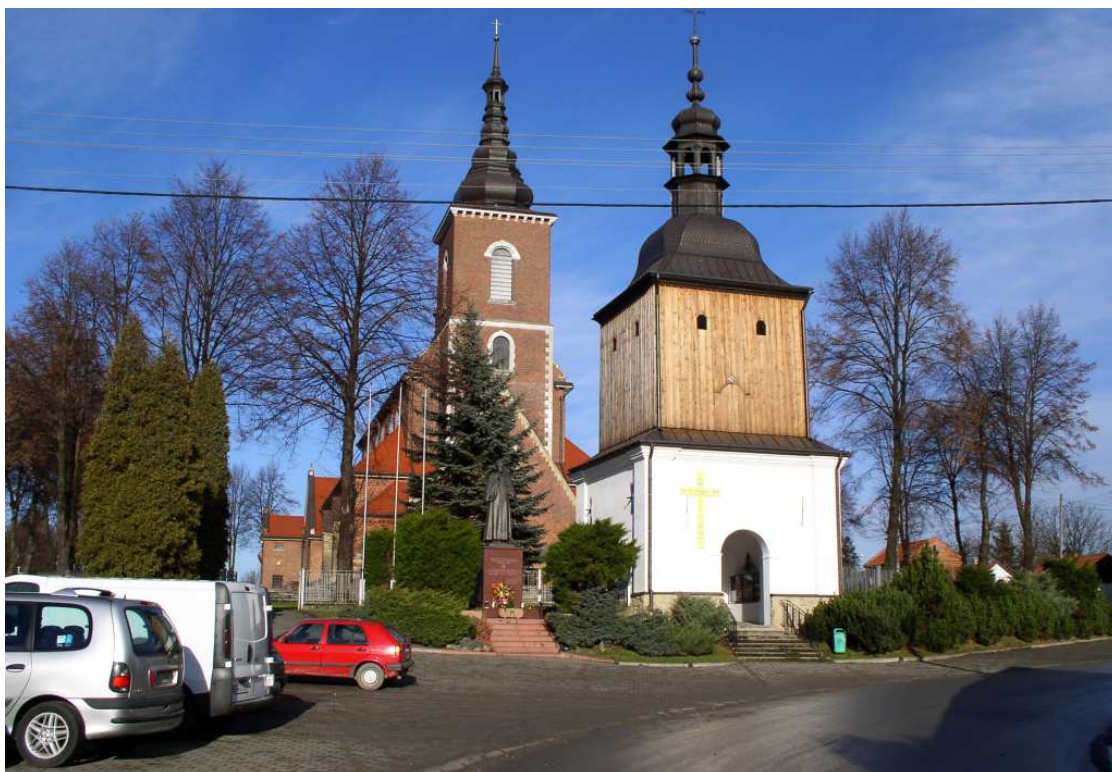
Fot. nr 65 (65-67). Nowy kościół p.w. Wniebowzięcia NMP, który został ukończony w roku 1959, a przed nim stara dzwonnica z I ćwierci XIX wieku, która jest wpisana do Rejestru Zabytków. (06.12.2008)
