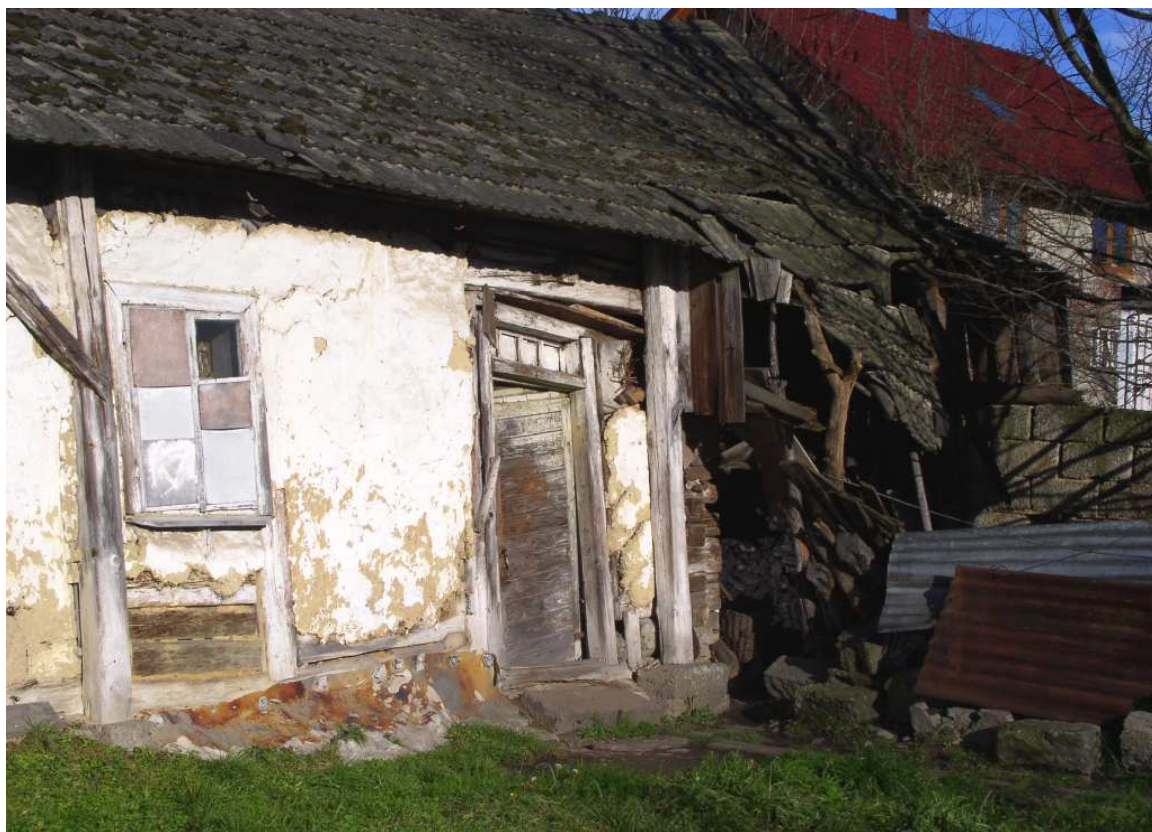
Fot. nr 228. Archaiczne detale fasady. (02.12.2008)
