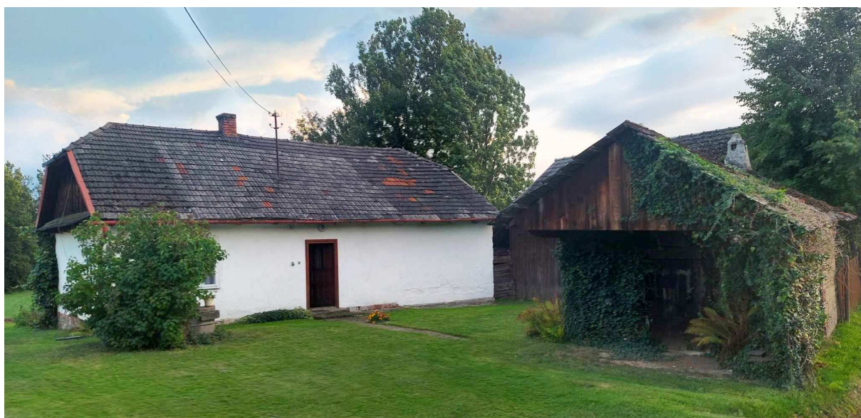
Fot. nr 27 (27-28). Kompletna zagroda pod nr 54, a w niej chałupa, przysłonięta z prawej stodoła oraz pomieszczenie gospodarcze. (27.08.2024)
