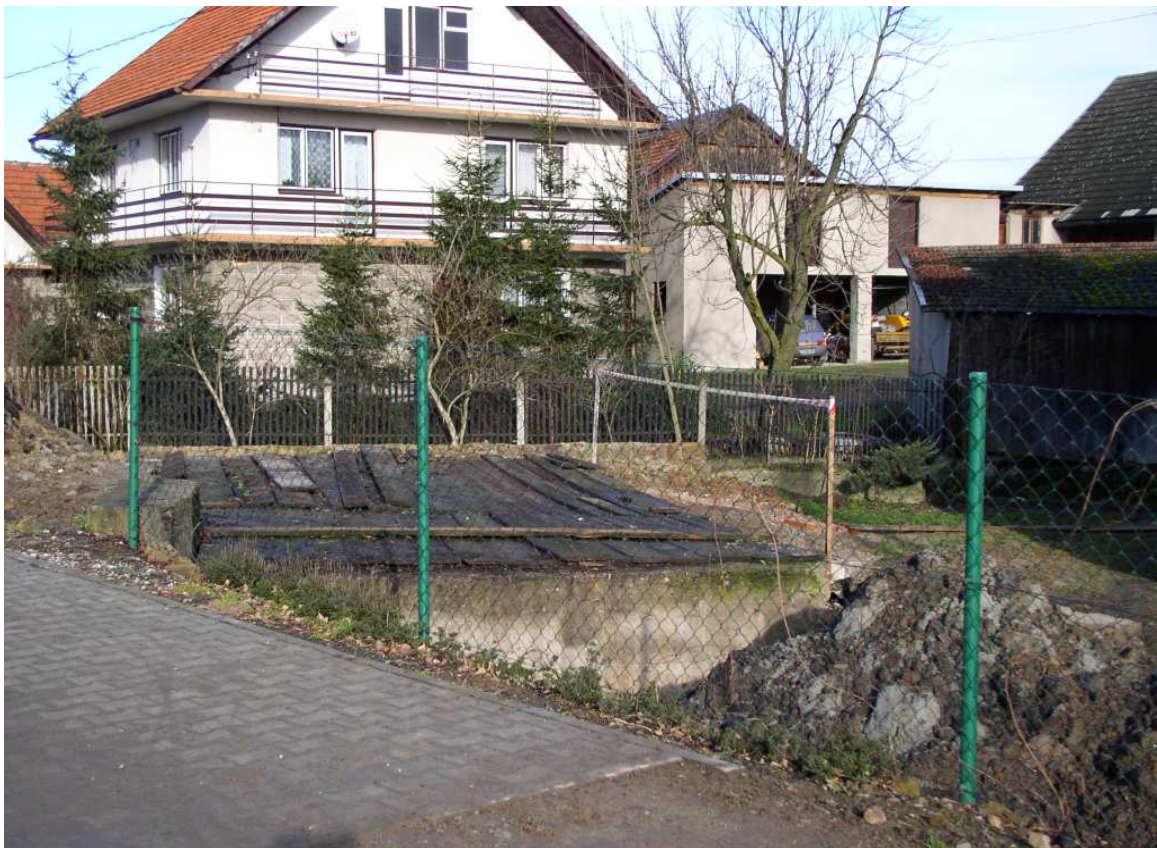
Fot. nr 43. Jeszcze w lecie 2008 stały tu, na posesji pod nr 8, drewniane zabudowania starego młyna. Na zdjęciu widoczne są tylko resztki są betonowego jazu. (06.12.2008)
