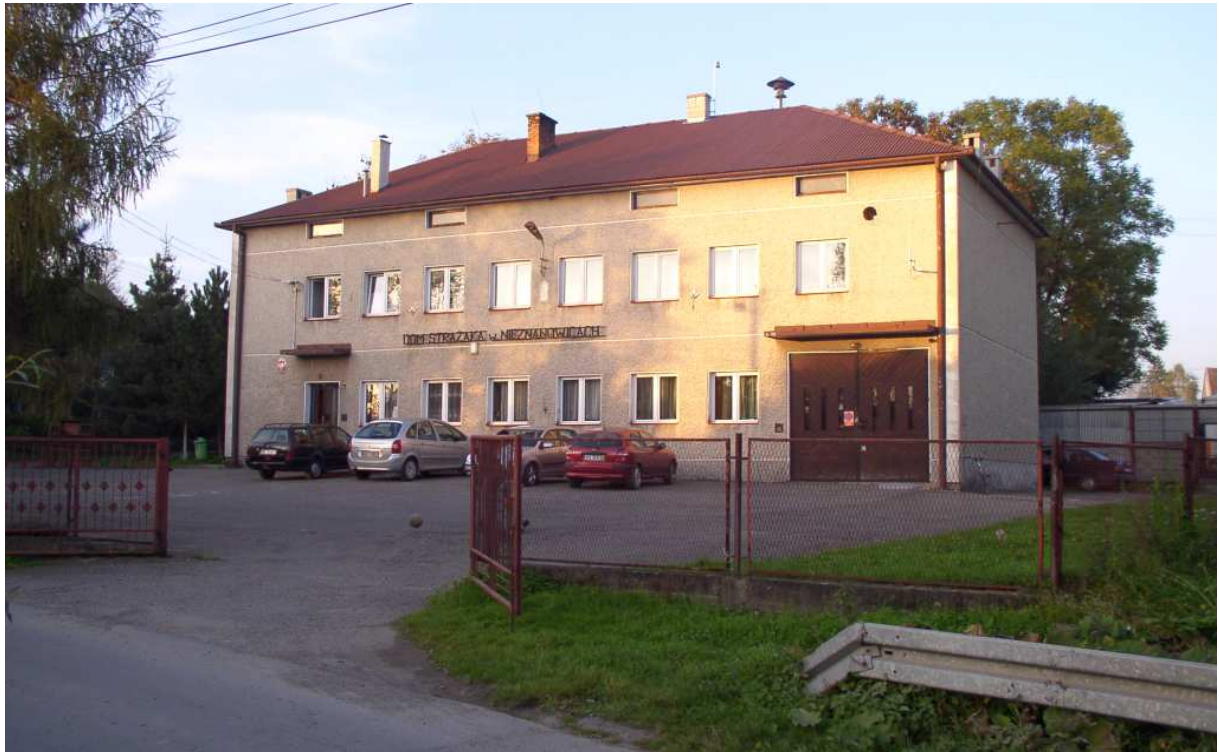
Fot. nr 171. Współczesny budynek OSP pod nr 151. (24.09.2010)
