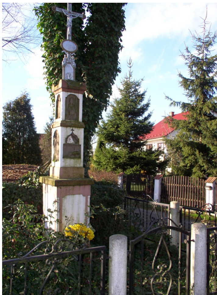
Fot. nr 212 (212-213). Mocno zniszczona, ale bogata w nieopisane figury kapliczka słupowa z ok. roku 1850; fundacja rodziny Antosiewiczów. (02.12.2008)
