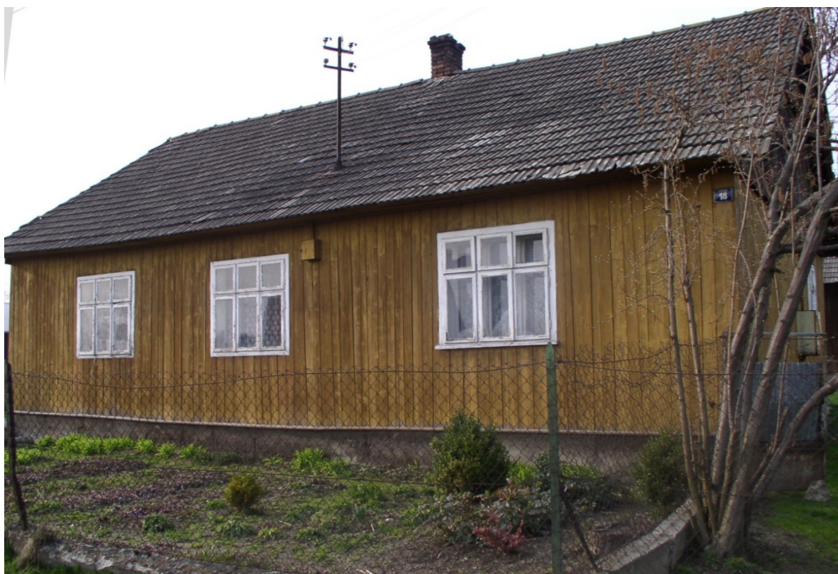
Fot. nr 99. Oszalowana fasada z oknami typu weneckiego. (04.05.2009)
