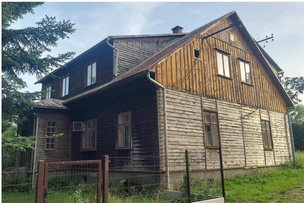
Fot. nr 22 (22-23). Około 100-letnia, stara plebania pod nr 9. Bliska oryginałowi fasada z dobudowanym w późniejszym okresie piętrem. (22.06.2024)
