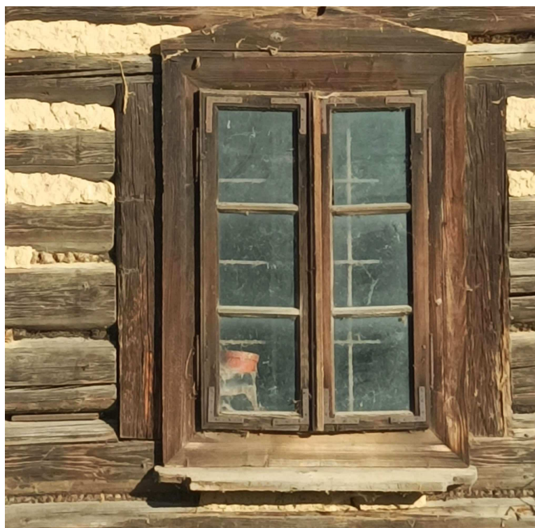
Fot. nr 111a. Oryginalne okno wielowej chałupy. Zdjęcie wykonane przez Joannę Kucharz (04.12.2024)
