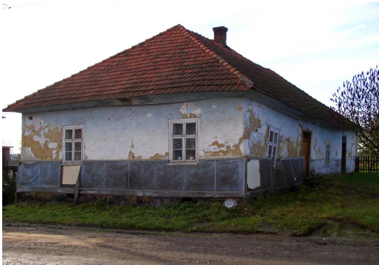
Fot. nr 46. Boczna ściana od strony drogi. (06.12.2008)
