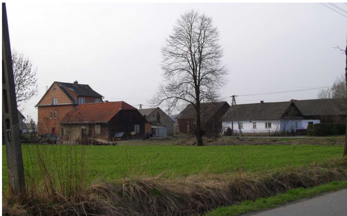
Fot. nr 7. Widok z drogi Marszowice – Niegowić na zabudowania zagrody o numerach: 63 (z lewej) i 42. (05.04.2009)
