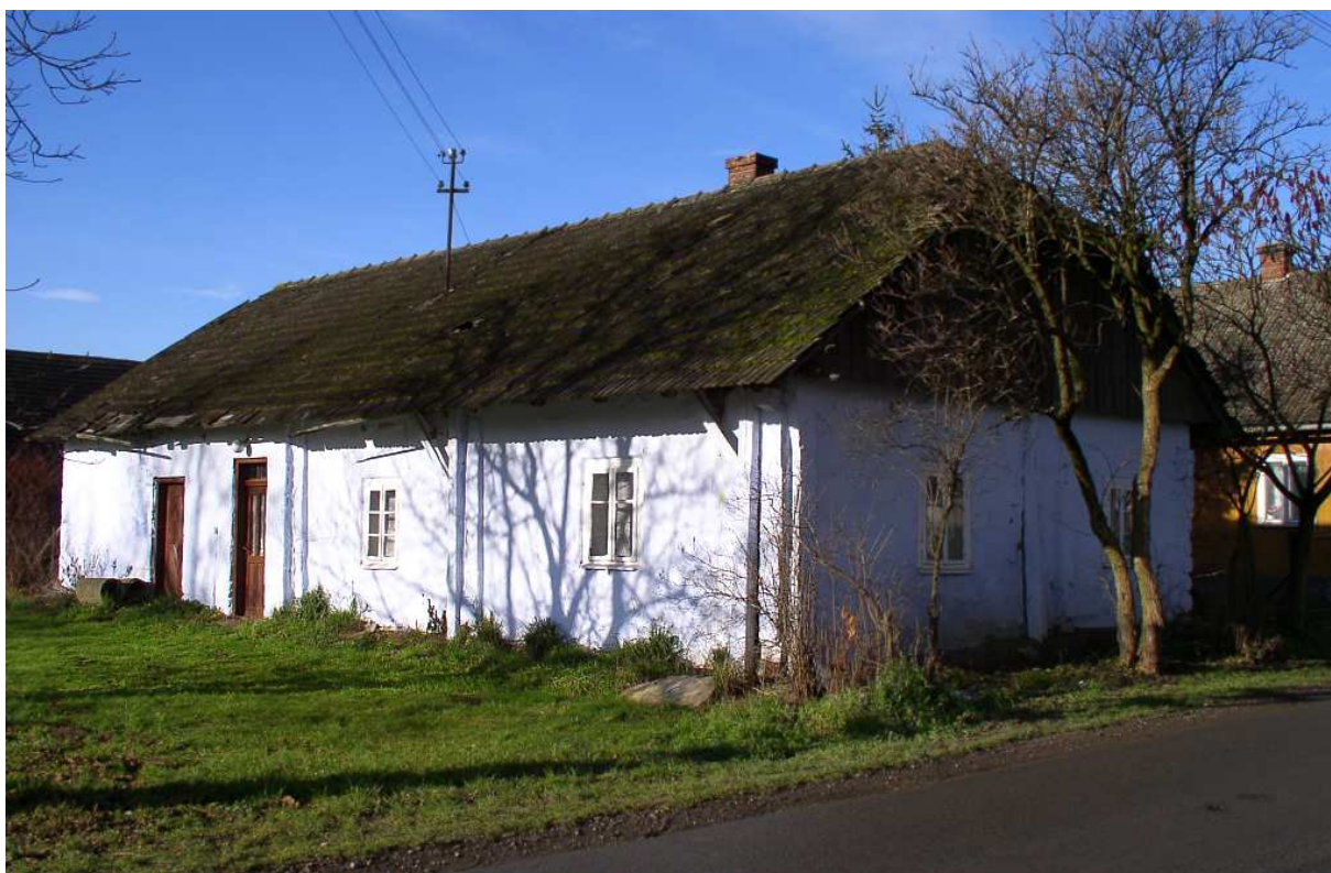
Fot. nr 13 (13-17). Widoki z drogi do Niegowici. Uwagę zwraca tradycyjne bielenie i konstrukcja przysłopowa. (06.12.2008)
