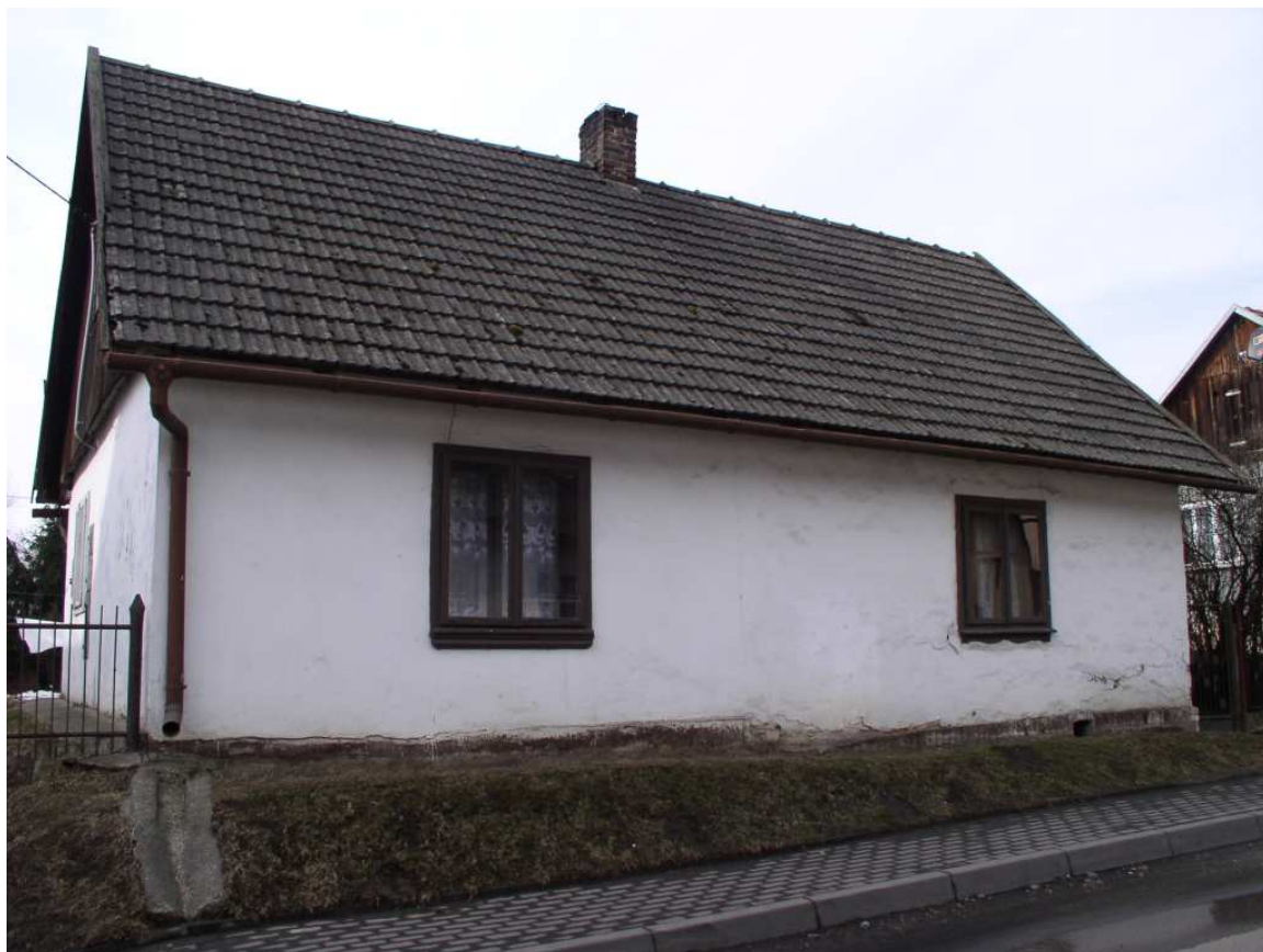
Fot. nr 58. Pokryta tynkiem dawna chałupa pod nr 25. (05.03.2011)
