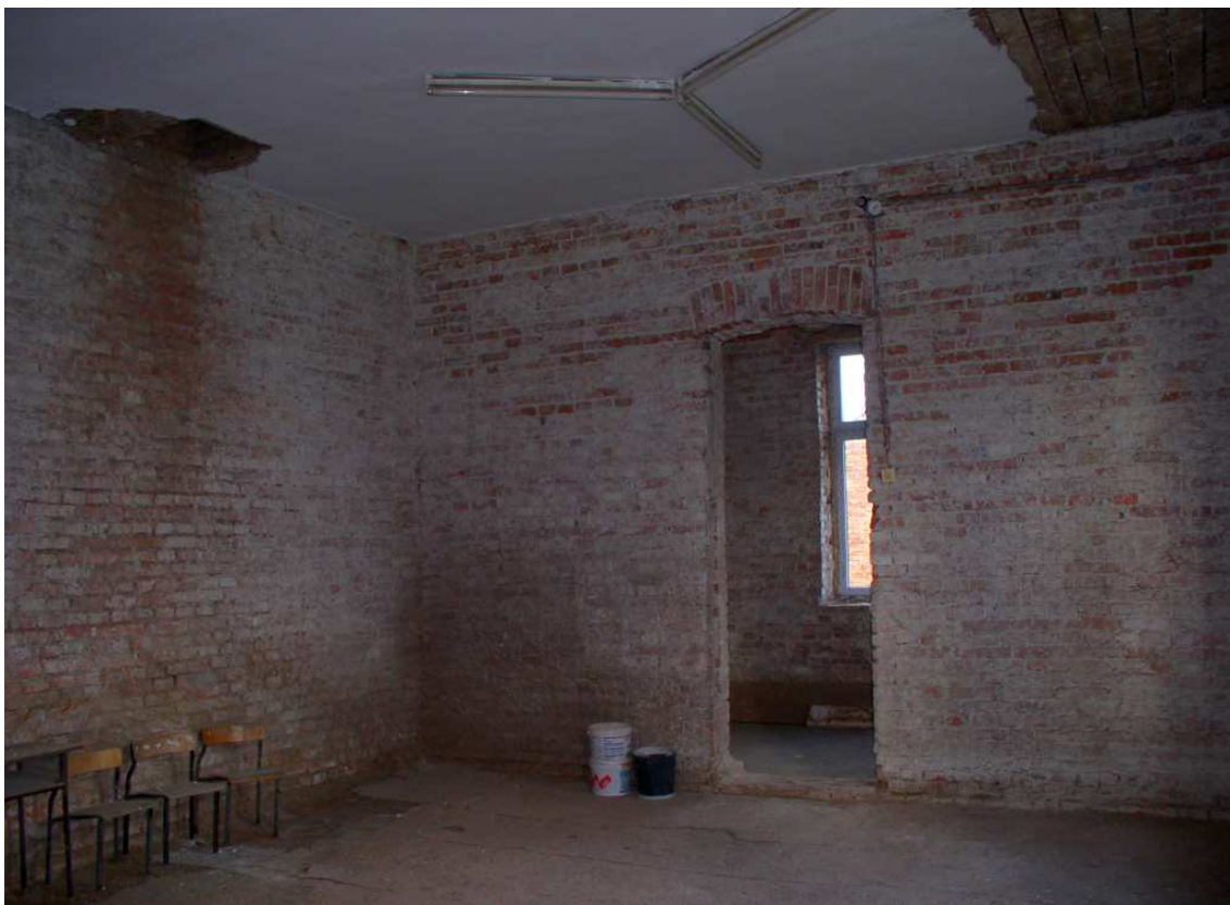
Fot. nr 183 (183-185). Wnętrze szkoły na etapie remontu. (02.09.2010)
