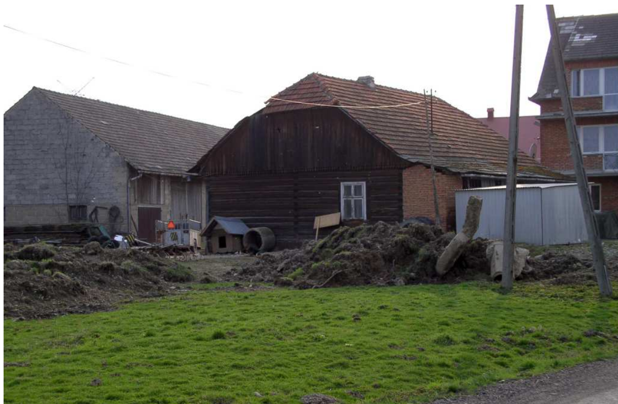
Fot. nr 8. Oryginalna ściana szczytowa drewnianego domu z siodełkowym dachem. (05.04.2009)
