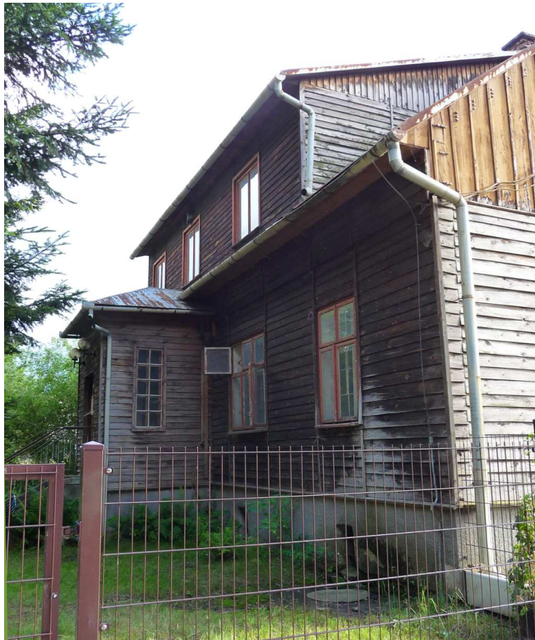
Fot. nr 307. Fasada z gankiem od strony ogrodu. (04.07.2024)
