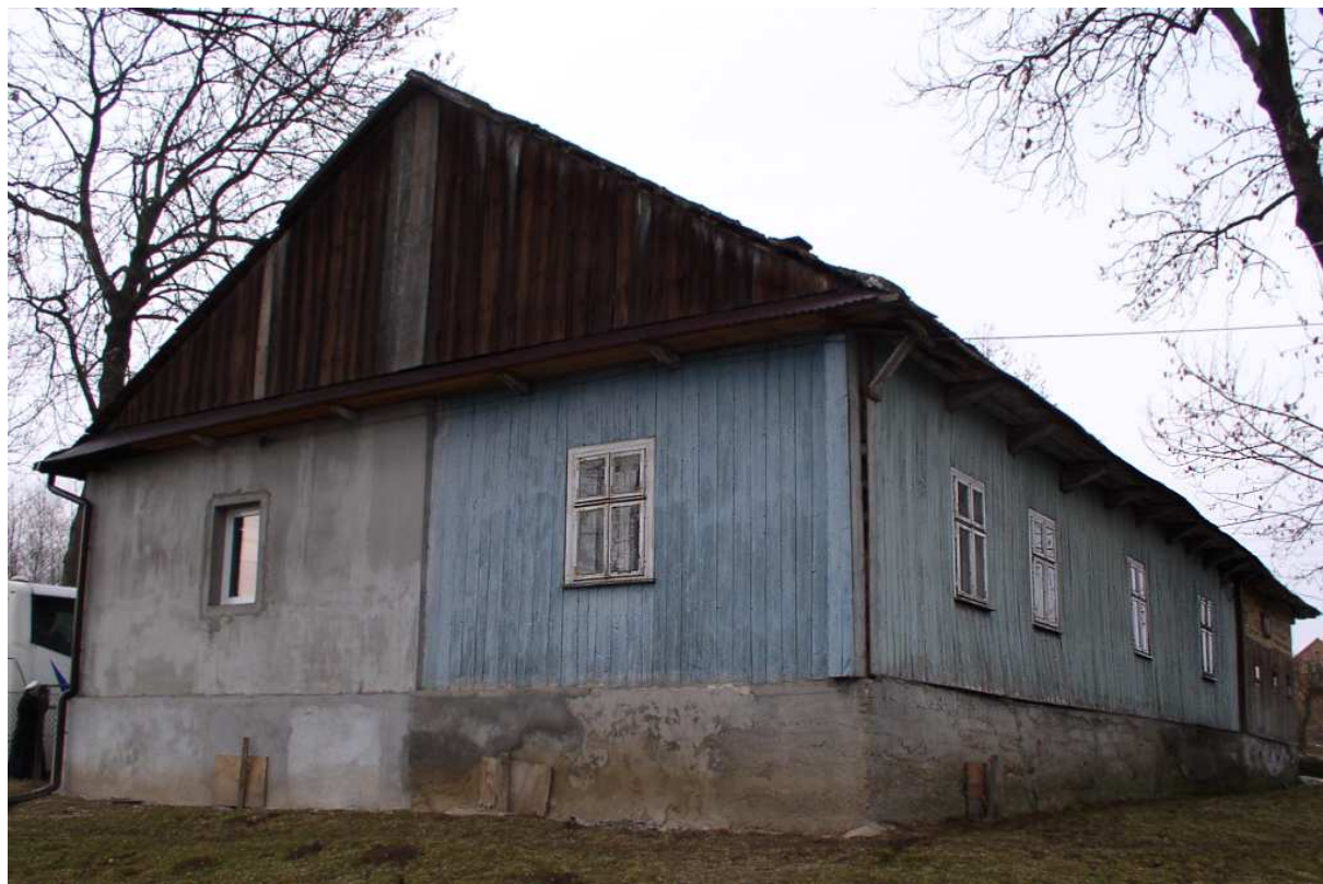
Fot. nr 116. Oryginalny fragment budynku. Część od strony dziedzińca niestety została znacząco przebudowana. (05.03.2011)
