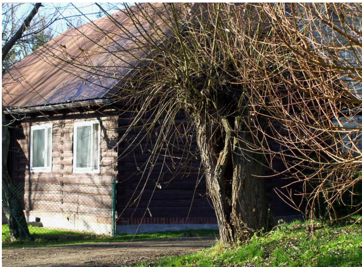
Fot. nr 230. Przebudowany, drewniany dom o konstrukcji zrębowej (nr 127 ??) przy drodze ku Wygonowi. (02.12.2008)
