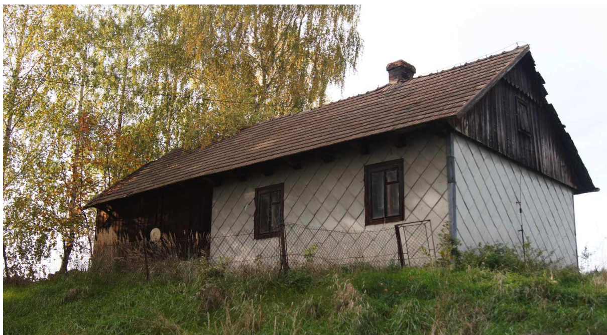
Fot. nr 113 (113-113c). Około 100-letnia chałupa pod nr 38. Fot. Joanna Kucharz. Fot. nr: 113-113a – Fasada obiektu, którego ściany zewnętrzne są pokryte sidingiem z eternitowych rybich łusek. Część mieszkalna w jednym korpusie ze stodołą. (06.11.2024)
