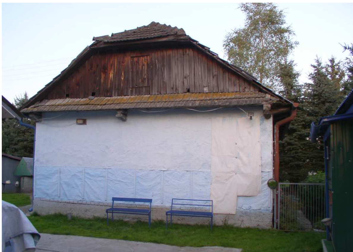
Fot. nr 206. Boczna ściana. (24.09.2010)
