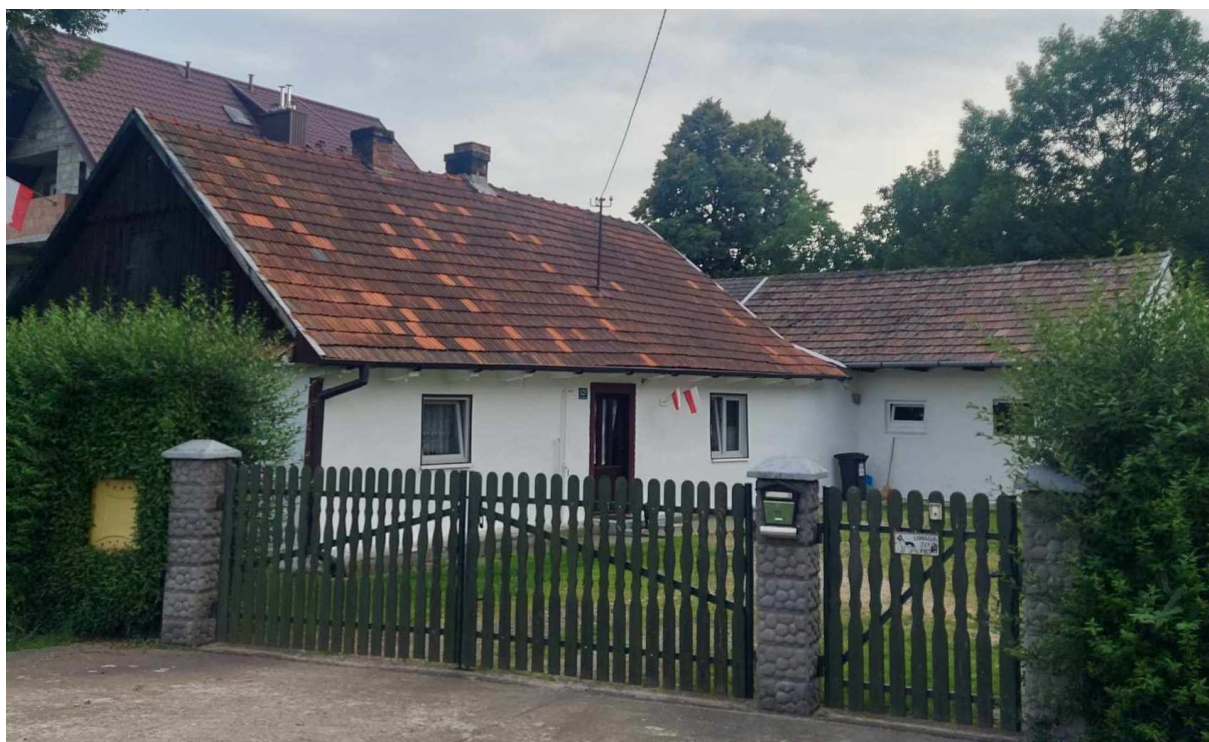
Fot. nr 15. Tylny fragment z przylegającym w poprzek do domu budynkiem gospodarczym. (22.06.2024)
