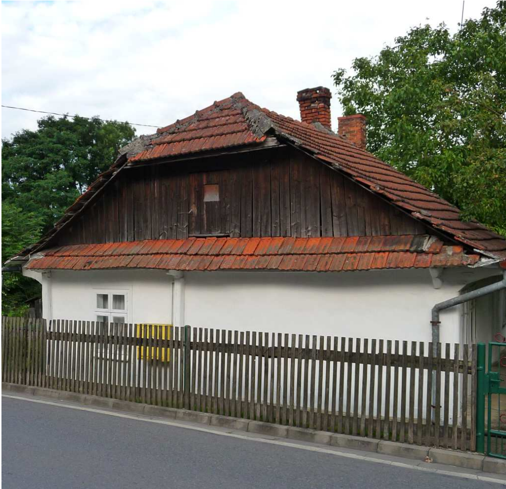
Fot. nr 295 (295-296). Boczna ściana szczytowa i dach siodełkowy zakończony okapem. (04.07.2024)
