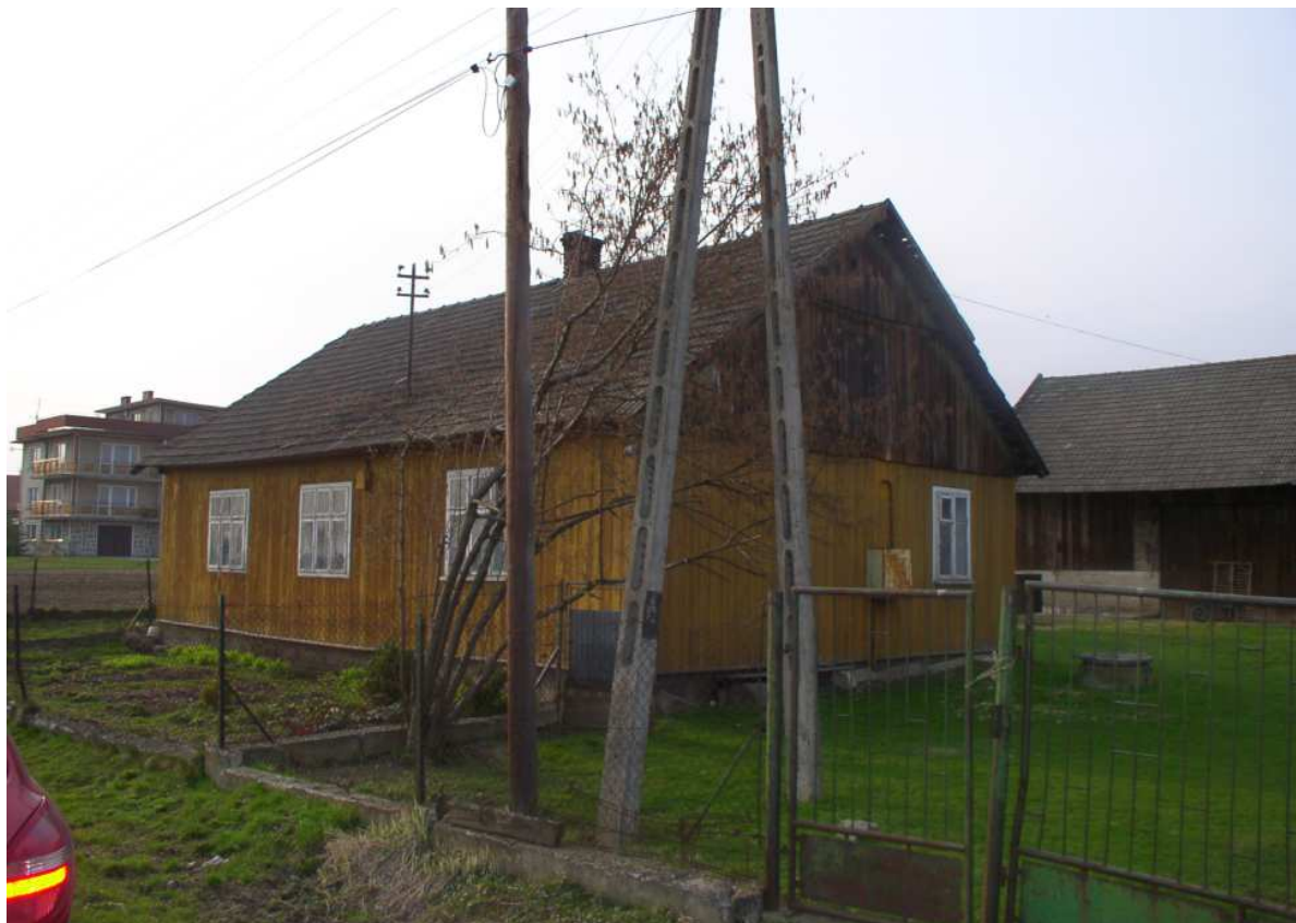
Fot. nr 98 (98-99). Przebudowany zapewne w II ćwierci XX wieku dom spod nr 18, który mógł powstać nawet pod koniec XIX wieku, co podpowiada okienko w bocznej ścianie. (04.05.2009)
