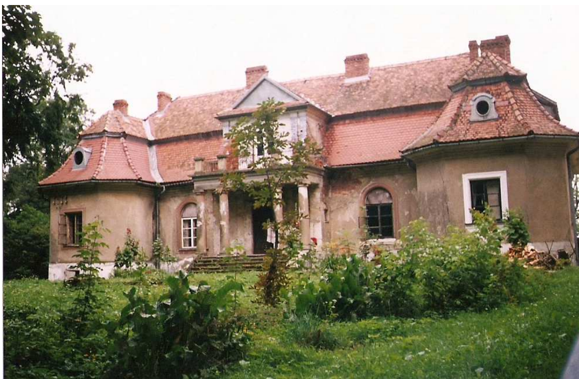
Fot. nr 28 (28-31). Dwór Włodków pod nr 1. Murowany obiekt, o cechach klasycystycznych, pochodzi z początku XX wieku. Tu stan z roku 2000. Zespół dworski jest wpisany do Rejestru Zabytków.
