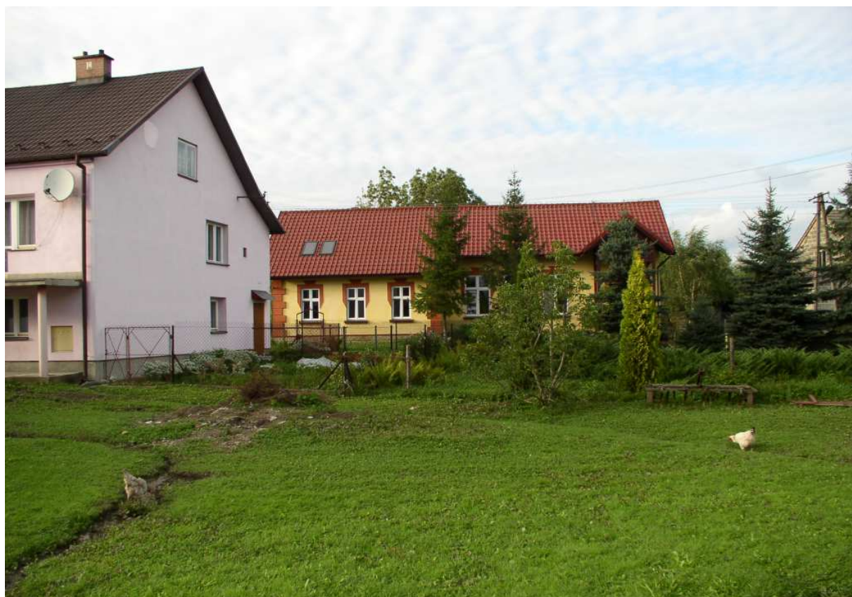
Fot. nr 180 (180-182). Dawny budynek szkoły ludowej z roku 1909 spod nr 24. Widok na etapie remontu i przebudowy na przedszkole. (02.09.2010)
