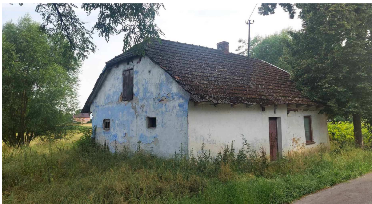
Fot. nr 2 (2-3). Dawna chałupa, ze zniekształconą i ukrytą pod tynkiem drewnianą fakturą fasadą, pod nr 62. (22.06.2024)
