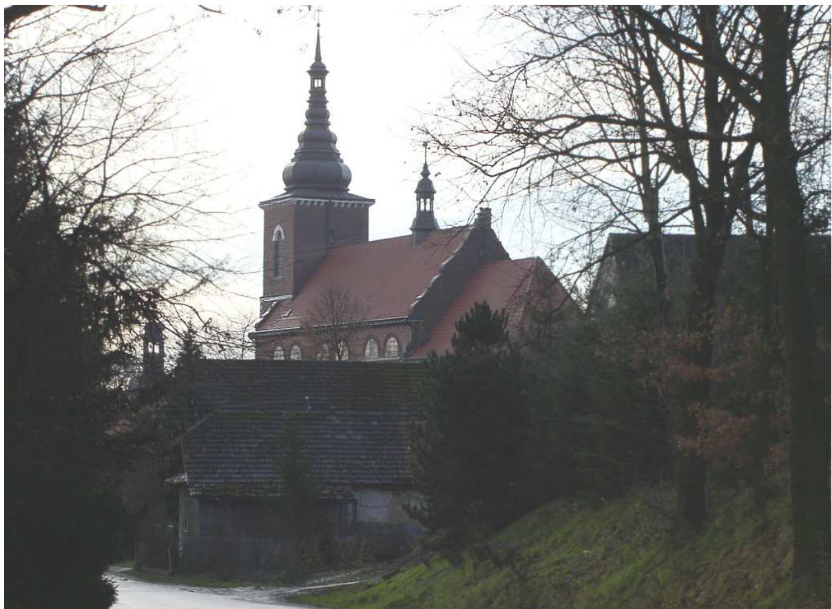
Fot. nr 83. Widok od strony cmentarza. (06.12.2008)
