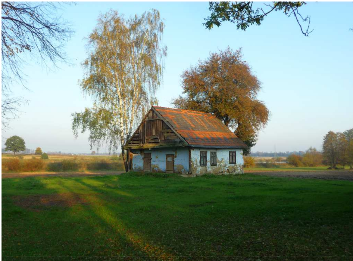
Fot. nr 102 (102-102b). Stan po częściowym wyburzeniu z dnia 22.02.2012.
