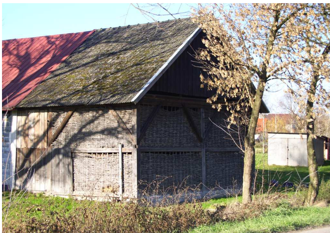
Fot. nr 224. Stodoła typ o ścianach plecionkowych na posesji pod nr 84. Obiekt wpisany do GEZ. (02.12.2008)
