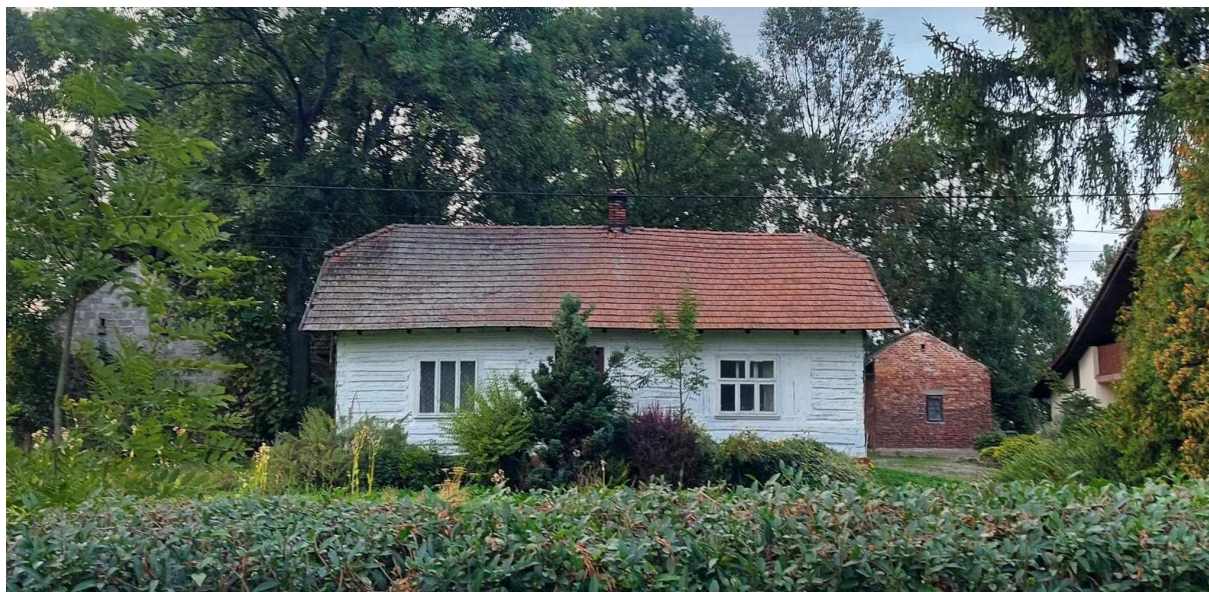
Fot. nr 26. Nadal bielona fasada chałupy pod 36. (27.08.2024)
