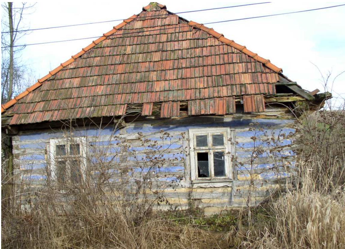
Fot. nr 120. Szczytowa ściana od strony drogi. (06.12.2008)
