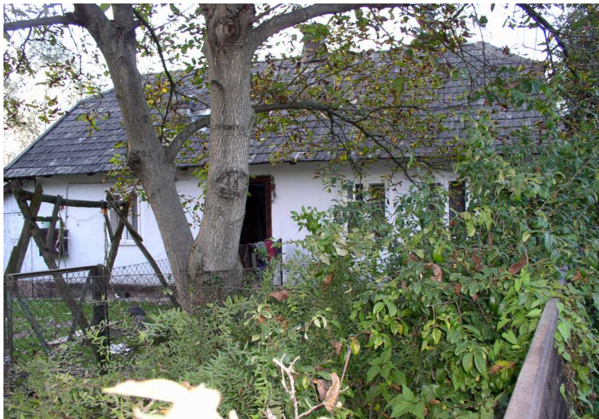
Fot. nr 199 (199-200). Widoki na fasadę od strony podwórka. (24.09.2010)
