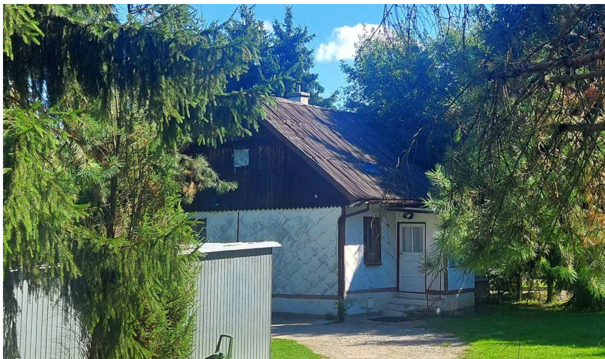
Fot. 19. Zapewne dawna chałupa pod nr 77, której elewacja została wtórnie pokryta „rybimi łuskami” z eternitu. (01.08.2024)
