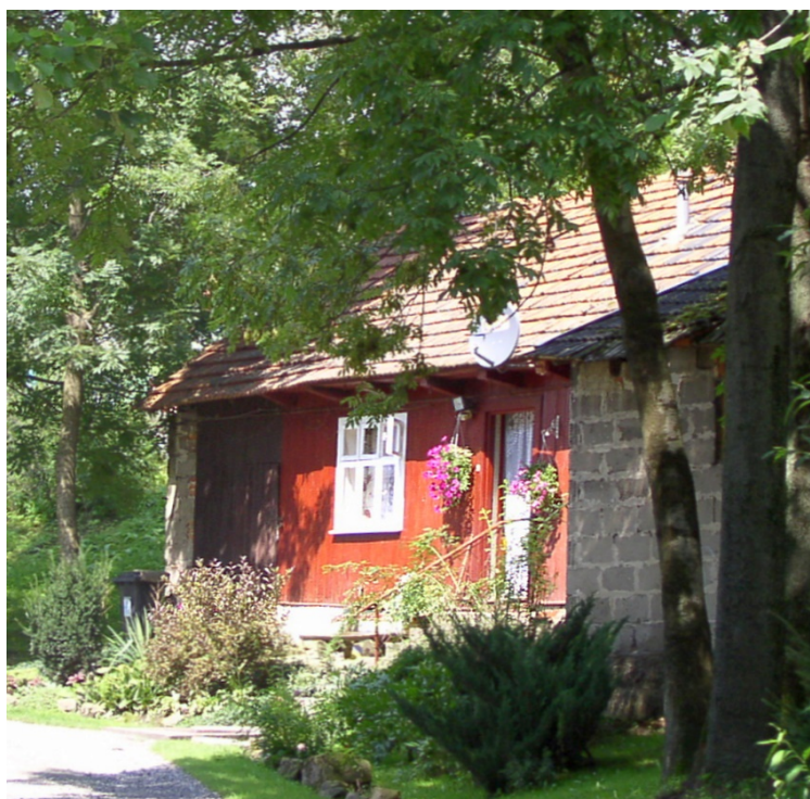
Fot. nr 130. Kompleks z częścią mieszkalną i przylegającą do niej niewielką stodołą. Sądząc po numerze może to być przykład zabudowy z końca XIX wieku, choć część mieszkalna mogła zostać przebudowana przed II wojną światową. (20.08.2010)
