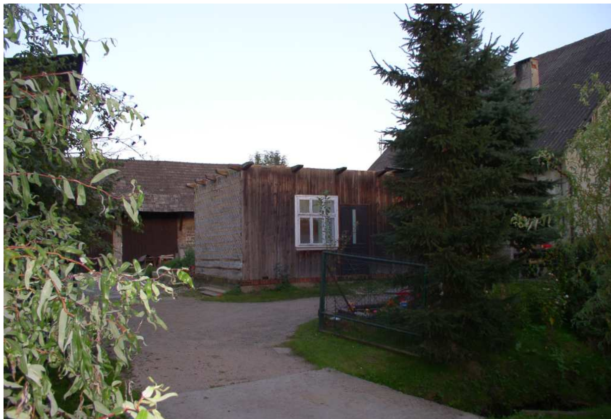
Fot. nr 203. Fragment dawnej chałupy (nr 11 (?)) na etapie rozbiórki. (24.09.2010)
