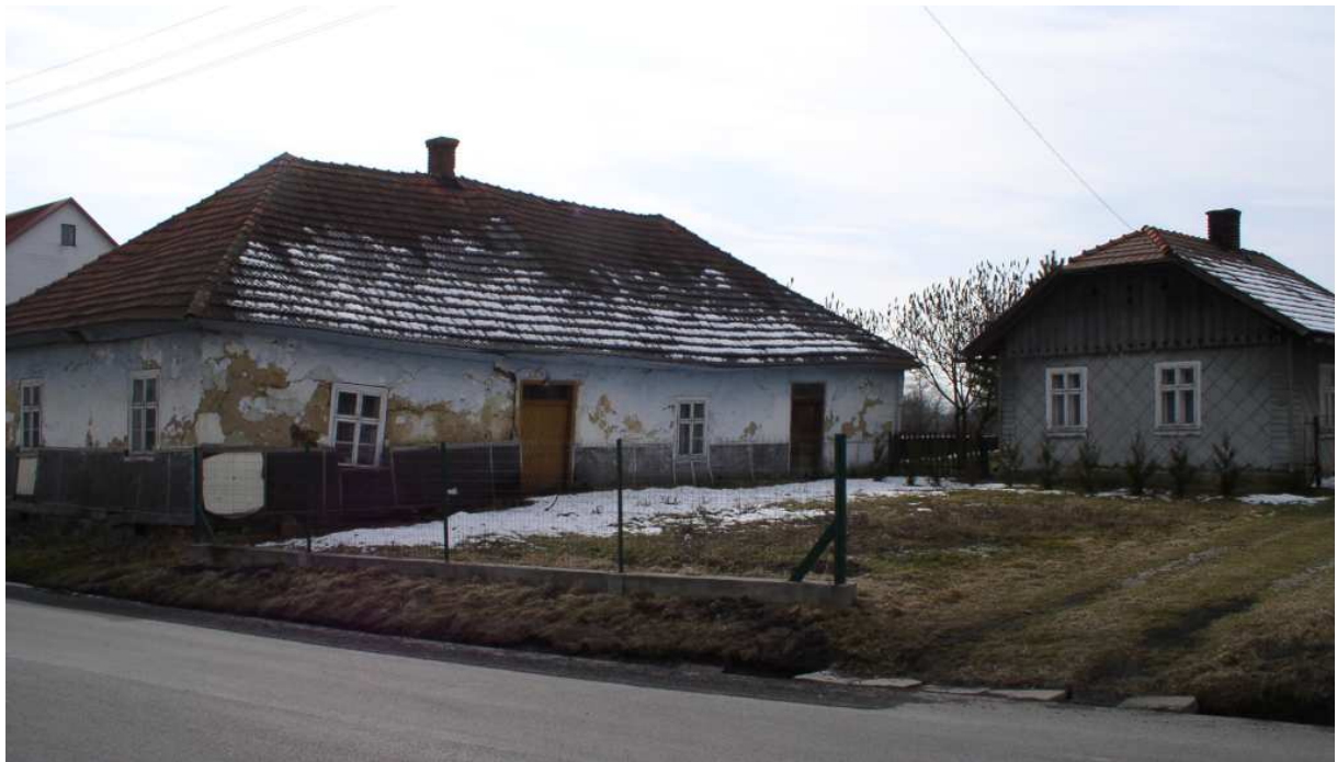
Fot. nr 48. Domy pod nr: 46 i 24 (z prawej). (05.03.2011)
