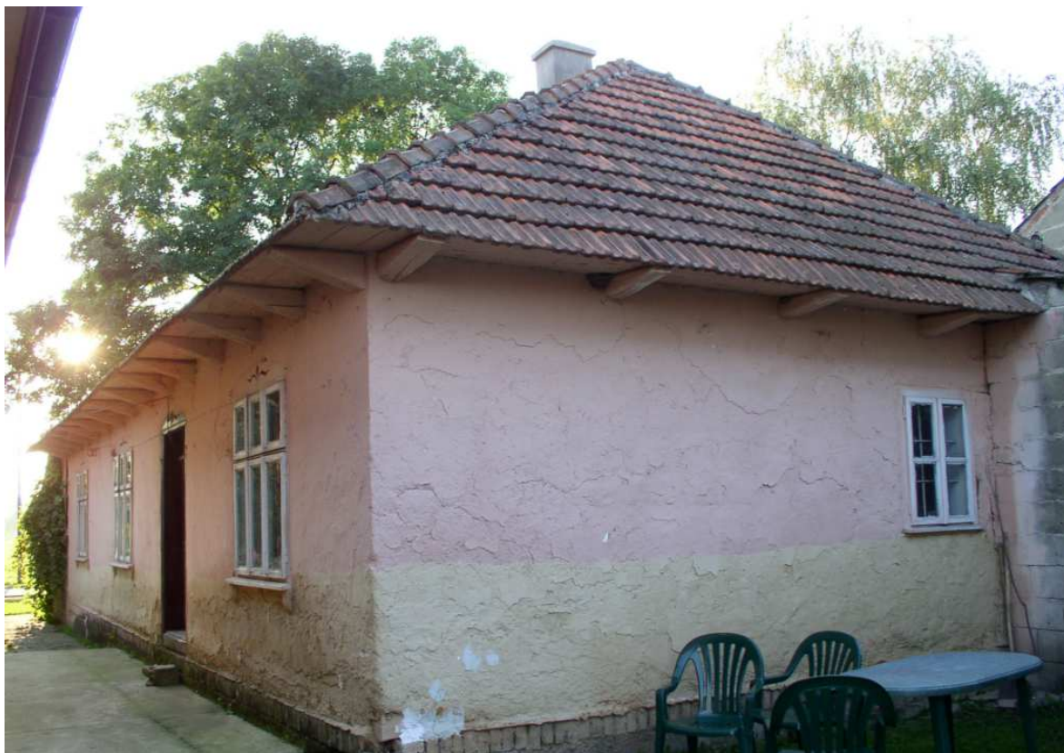
Fot. nr 242 (241-243). Fasada z oryginalnymi oknami. (21.09.2009)
