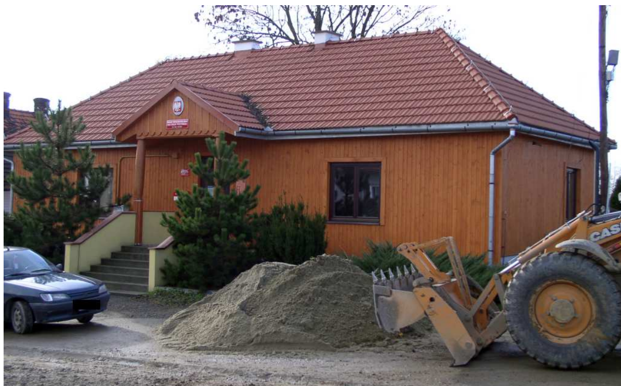
Fot. nr 53. Oszalowany dom z gankiem na kształt portyku spod nr 161, w którym mieści się placówka Poczty Polskiej. (06.12.2008)
