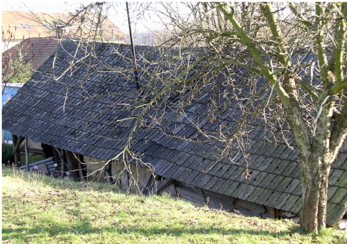
Fot. nr 229. Tylna część chałupy wkopanej w brzeg. (02.12.2008)
