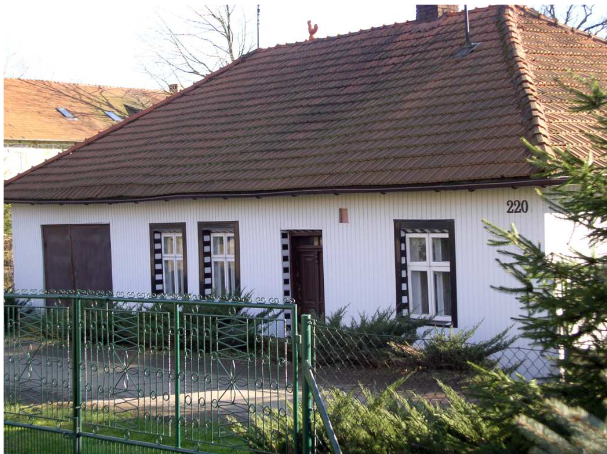
Fot. nr 225 (225-226). Przebudowany dom, zapewne z końca XIX wieku, spod nr 220, usytuowany w przysiółku Tuczarnia. Obiekt wpisany do GZ. (02.12.2008)
