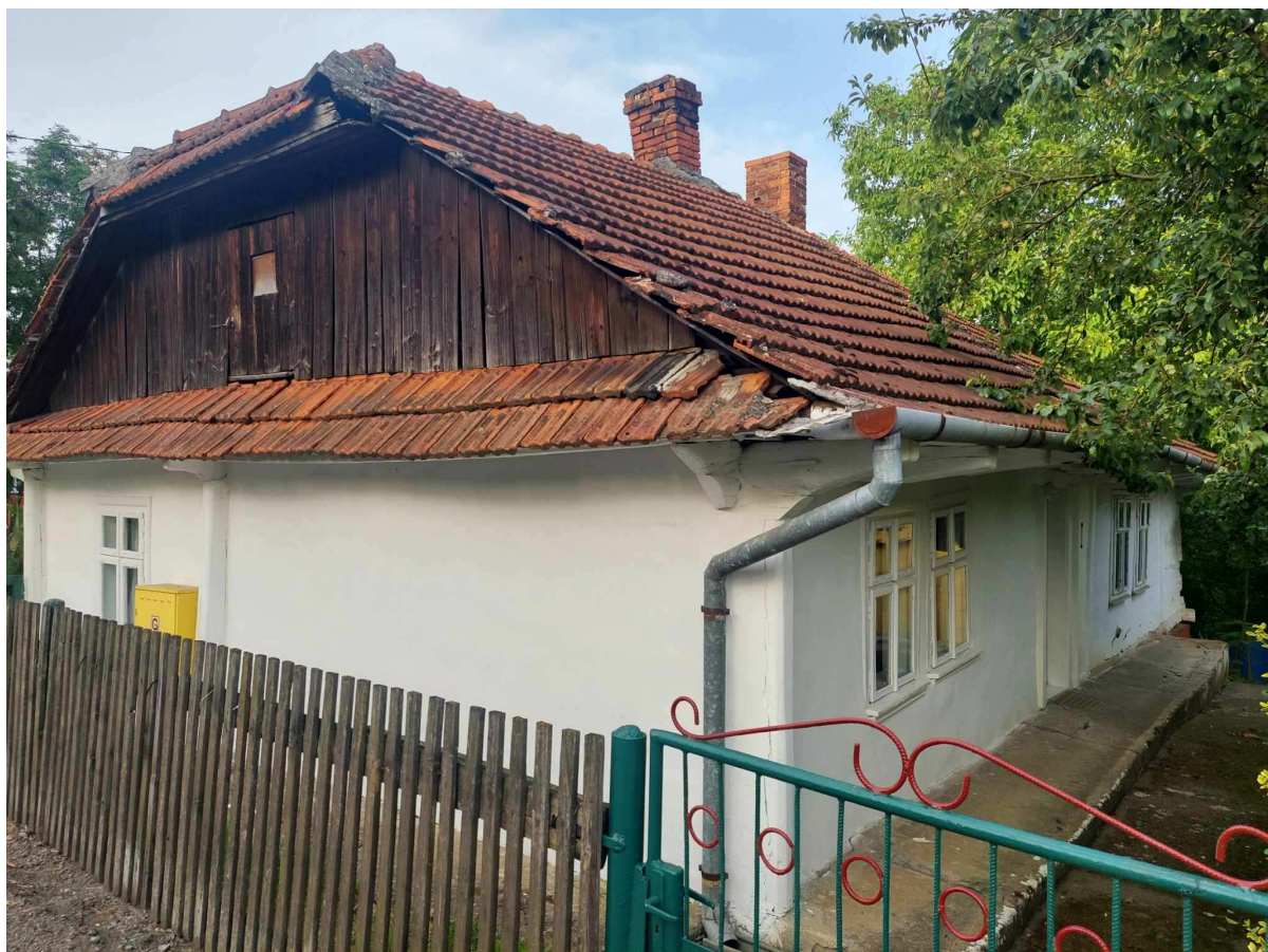
Fot. nr 10 (10-11). Dwutraktowa, nadal solidnie bielona chałupa pod nr 45, zapewne z okolic przełomu XIX i XX wieku. Obiekt wpisany do GEZ. (22.06.2024)
