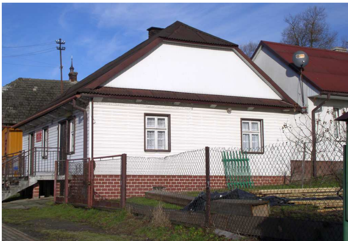
Fot. nr 59. Pokryty sidingiem, więc trudny do datowania dom pod nr 14. Niska numeracja podpowiada jego powstanie nawet na przełomie XIX i XX wieku. (06.12.2008)
