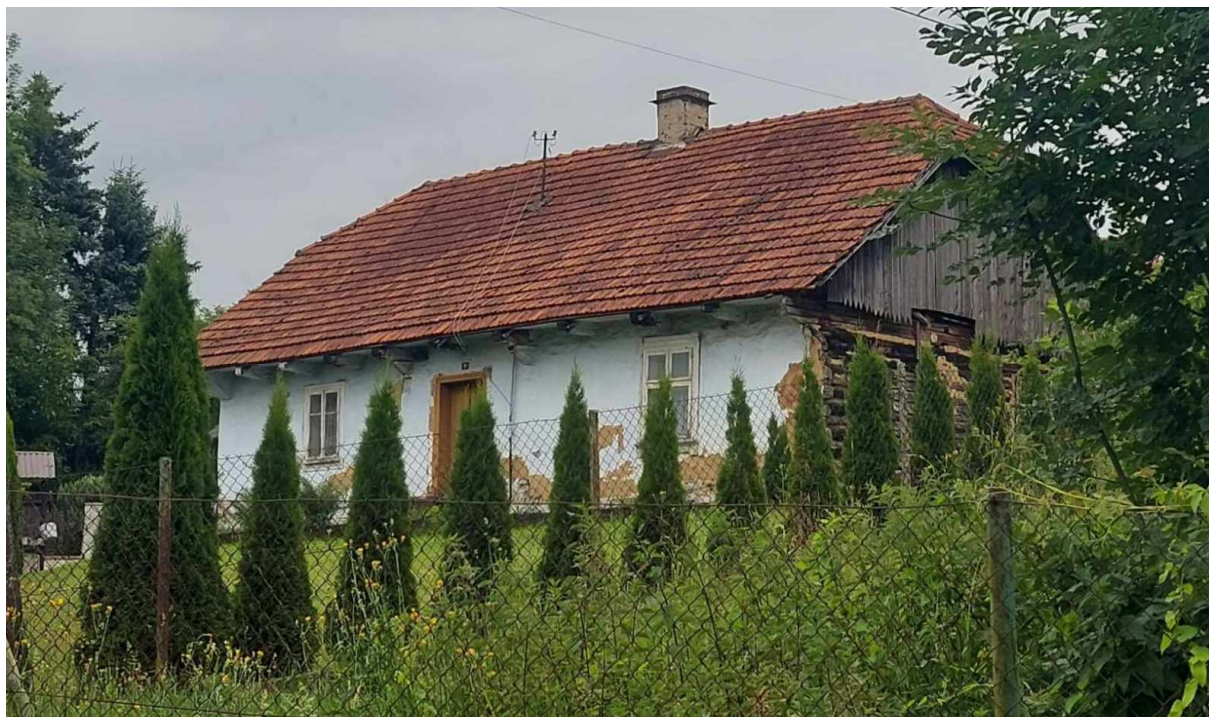
Fot. nr 6. Dwutraktowa chałupa z Książnic pod nr 9, zapewne z końca XIX wieku, wpisana do Rejestru Zabytków. (12.06.2024)
