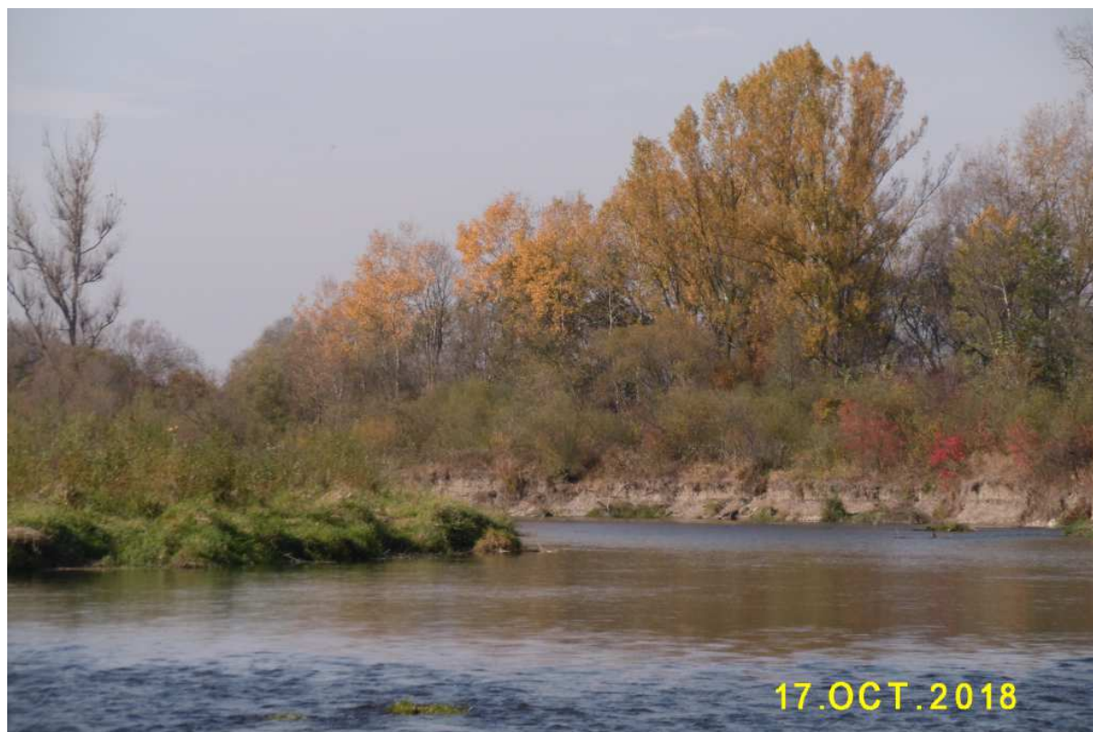
Fot. nr 289. Pozrywane brzegi i zniszczone drogi nadbrzeżne przez wezbraną Rabę.
