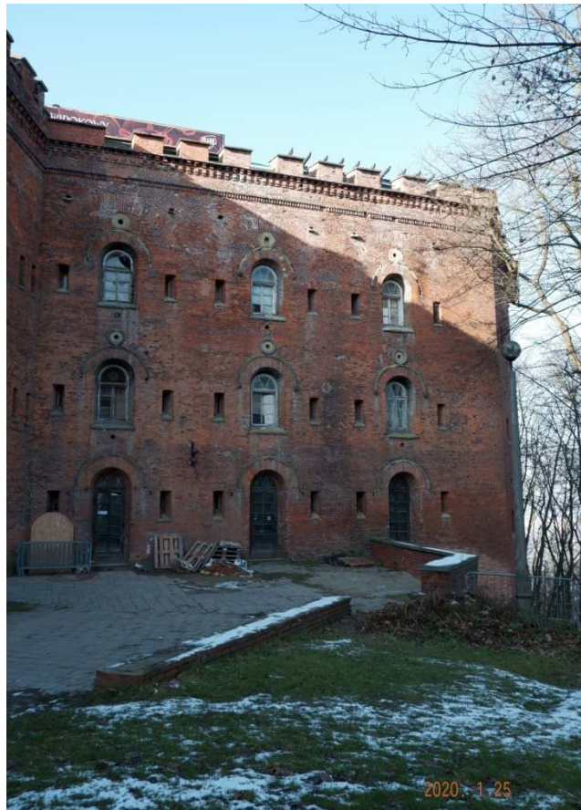
Fot. nr 164. Bastion nr IV, którego remont nie może się rozpocząć.
