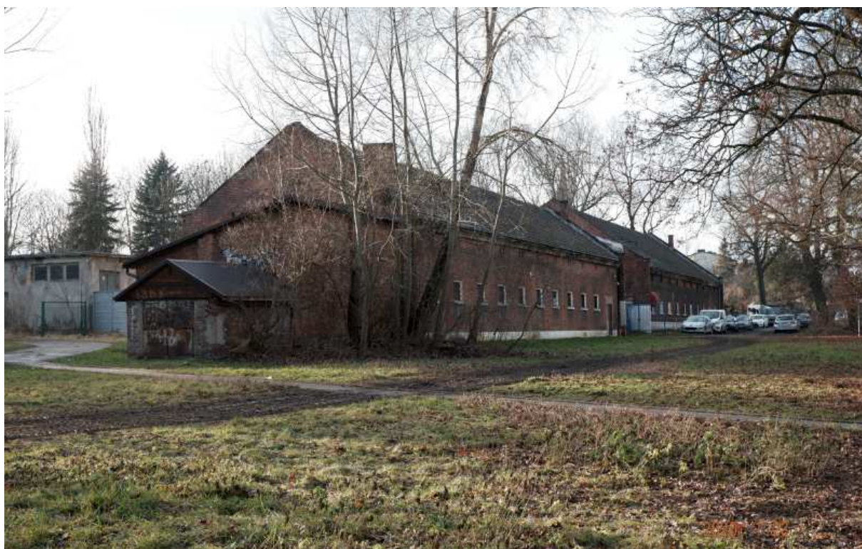
Fot. nr 348. Dawny folwark Na Wrzosach przy ulicy Żniwnej 1, który Erazm Jerzmanowski wybudował pod koniec XIX wieku.
