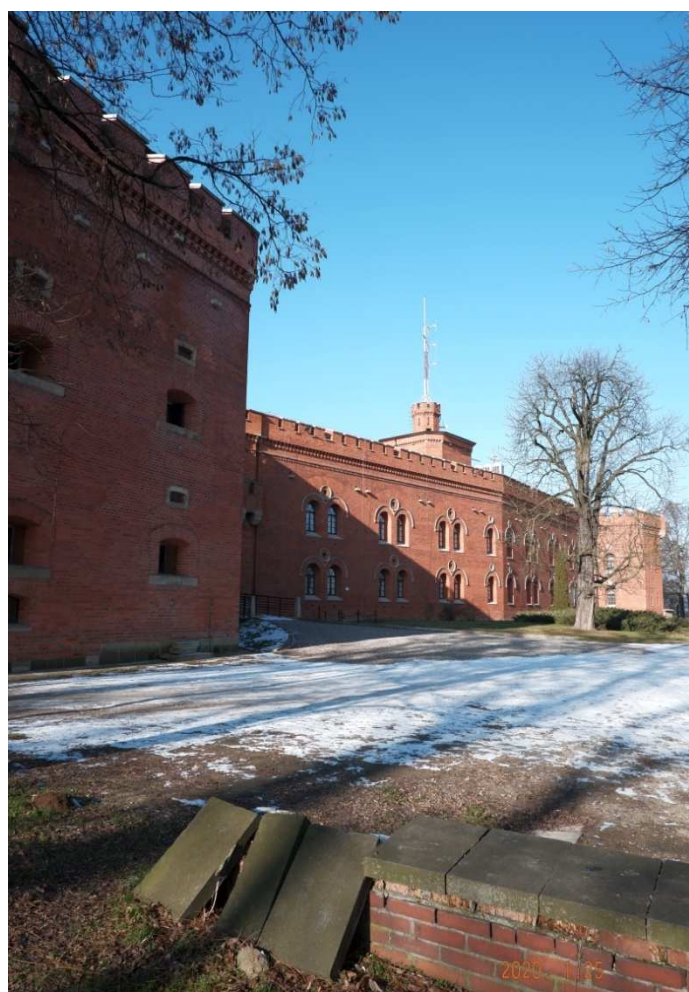
Fot. nr 167. Widok na koszary spod bastionu nr V.
