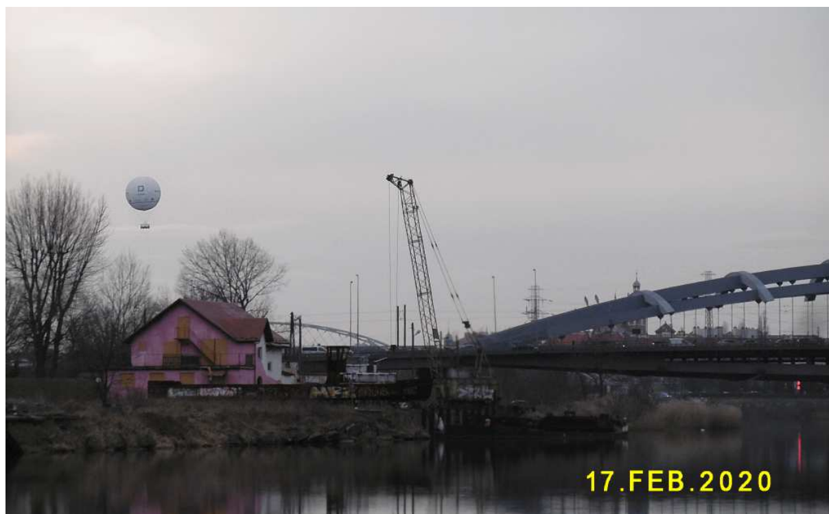
Fot. nr 192. Ponad mostem kolejowym w stronę Kazimierza (z prawej).
