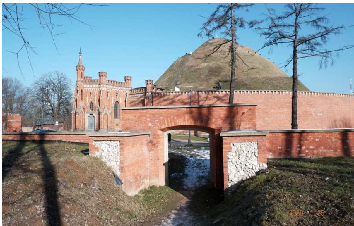
Fot. nr 157 (157-159). Próba odtworzenia bramy wjazdowej do bastionu nr I.
