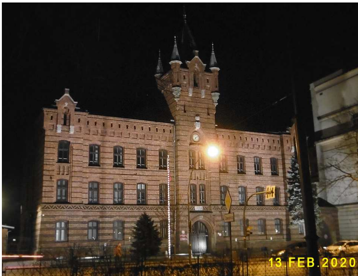
Fot. nr 15. Budynek Straży Pożarnej przy ulicy Westerplatte 19.
