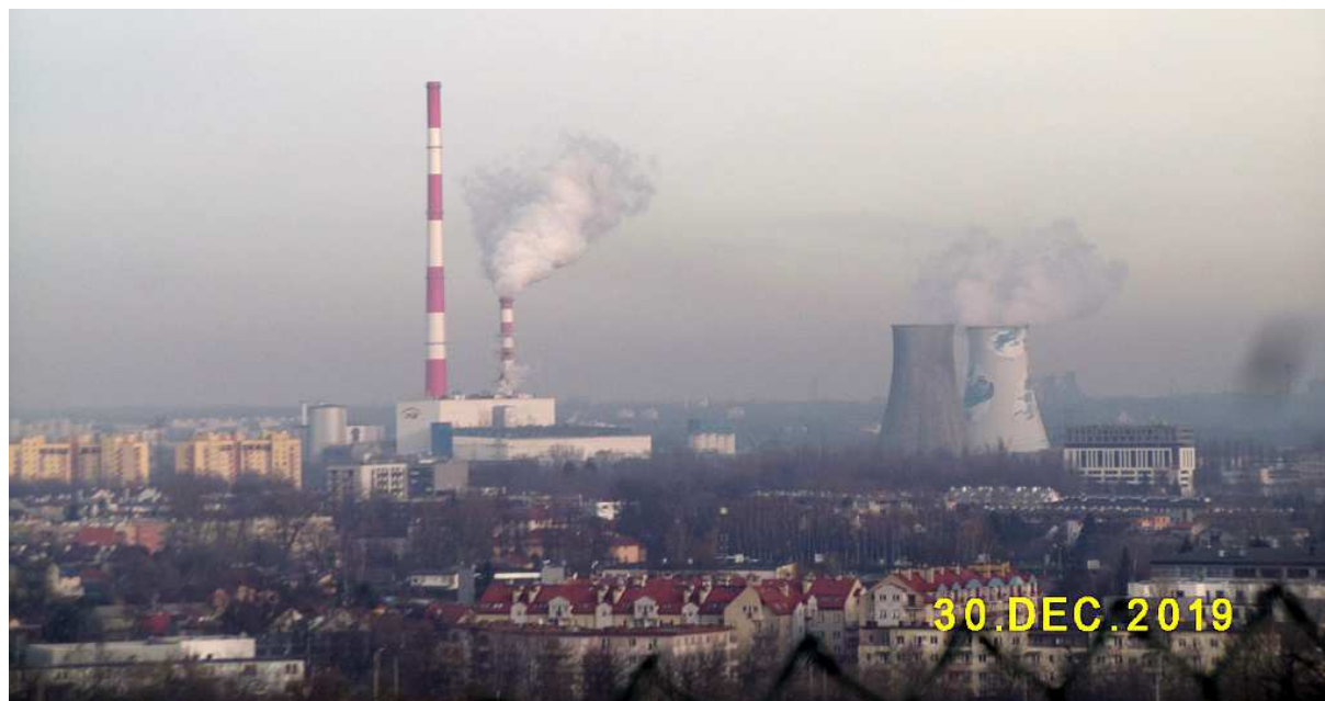
Fot. nr 285 (285-286). Kominy elektociepłowni w Łęgu.
