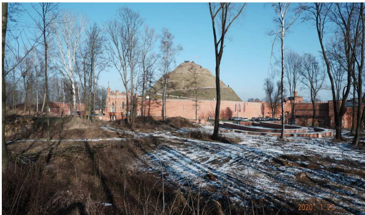
Fot. nr 150 (150-152). Wyeksponowane przyziemie bastionu nr I.
