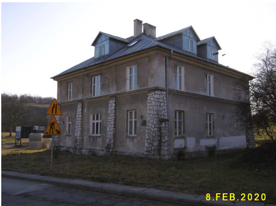
Fot. nr 305. Szary Dom, budynek administracyjny przy podgórskim kirkucie, wybudowany na początku lat 30. W czasie funkcjonowania KL Płaszów swoją siedzibę mieli tu ss-mani.
