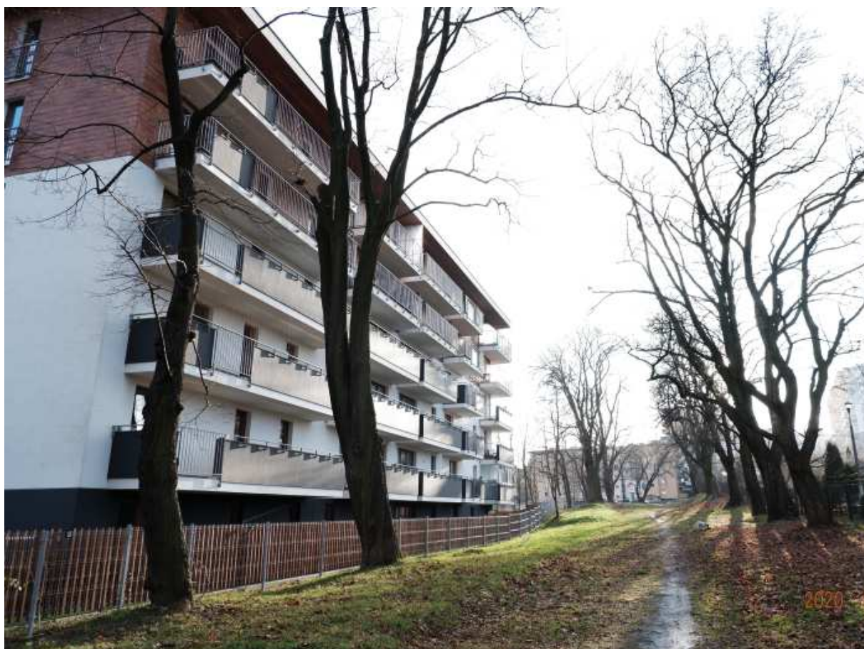
Fot. nr 352. Ku ulicy Wielickiej. Na potrzeby dojazdu do placu budowy blokowiska aleja została mocno przetrzebiona.
