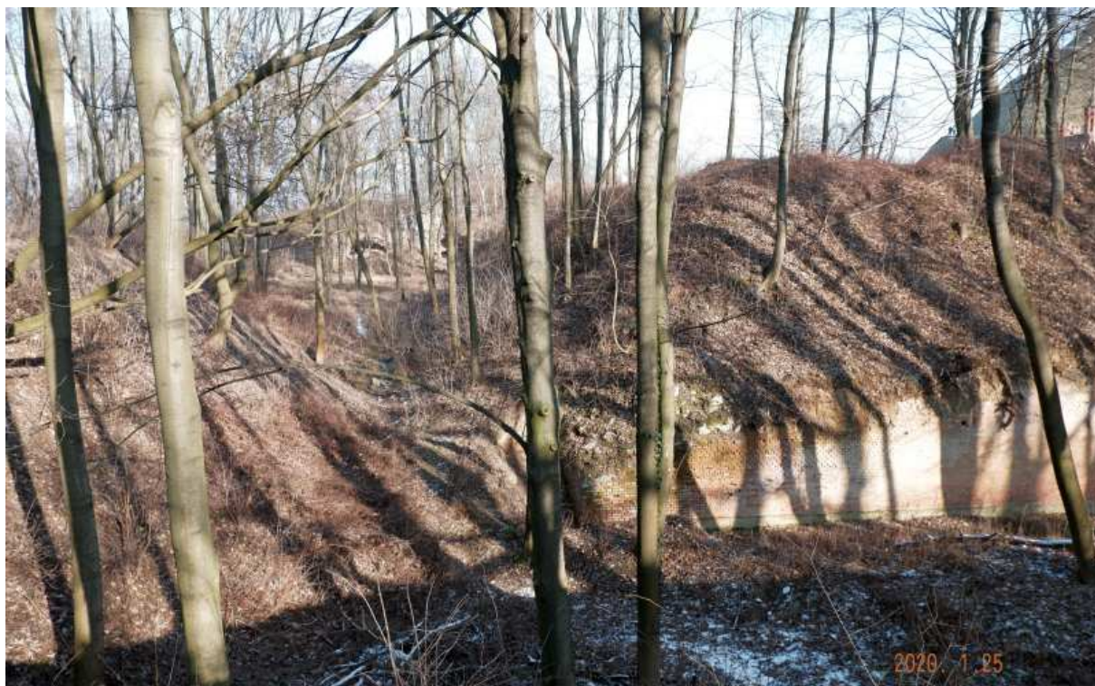
Fot. nr 154 (154-156). Ruina części zewnętrznej bastionu nr II.
