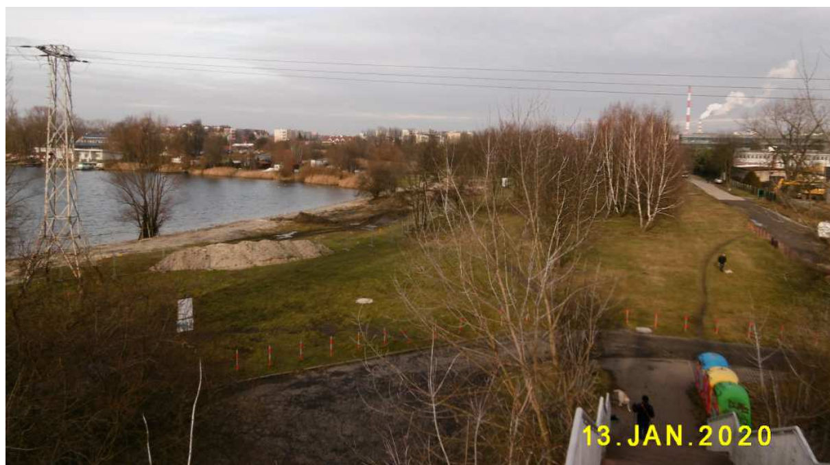
Fot. nr 330. Trwa przebudowa dzikiej plaży przy ulicy Bagrowej. Pytanie: komu to potrzebne?
