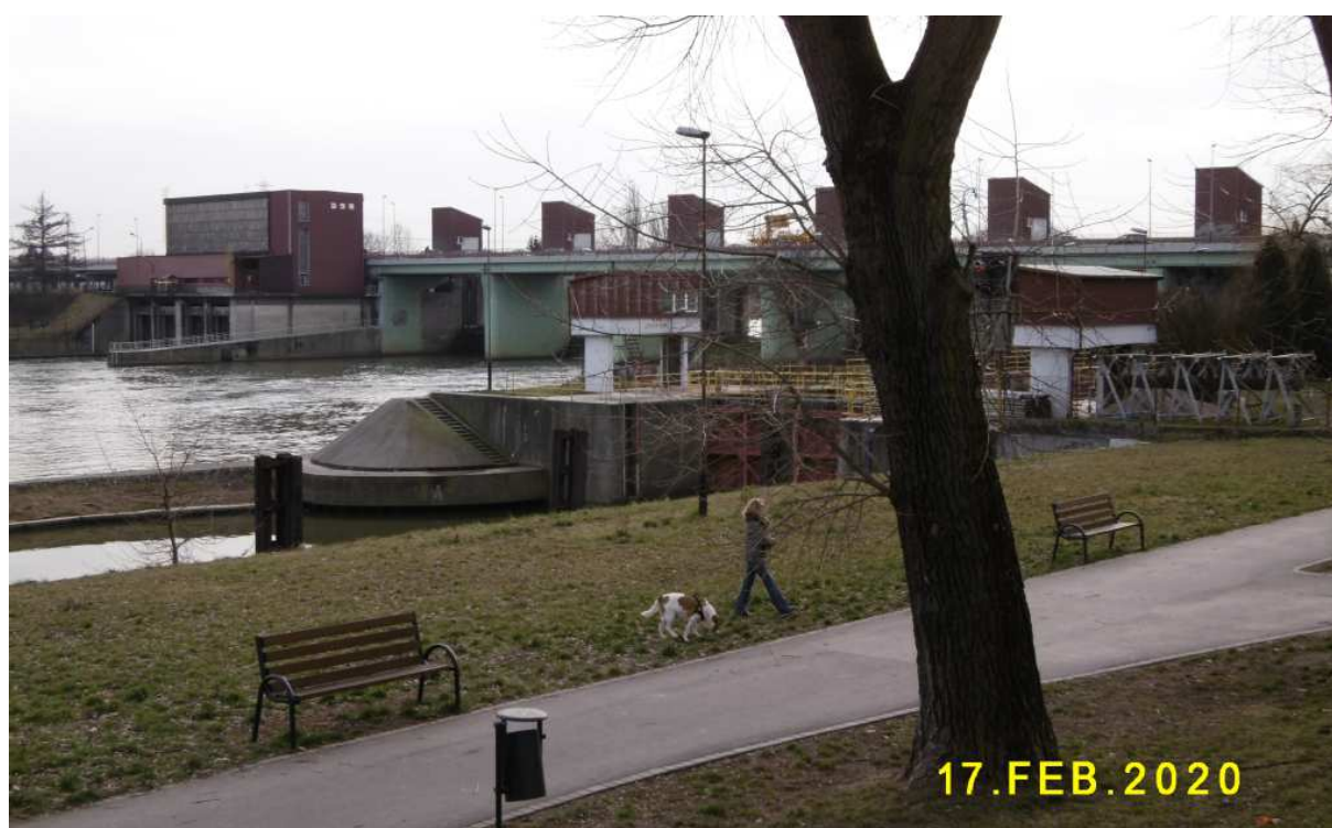
Fot. nr 193. Zapora na Dąbiu.
