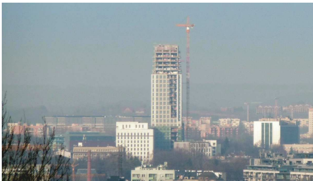
Fot. nr 171a. Szkieletor wkracza w końcowy etap przebudowy. (25.12.2019)
