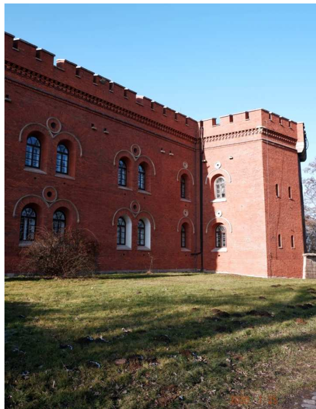
Fot. nr 165. Basteja pomiędzy bastionami nr: IV i V.
