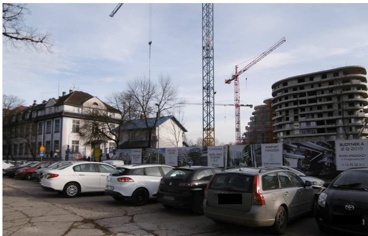
Fot. nr 181 (181-182). Blokowisko na terenie dawnych zakładów Zieleniewskiego przy ulicy Grzegórzeckiej 69. Tu widok z ulicy Grzegórzeckiej. (17.02.2020)
