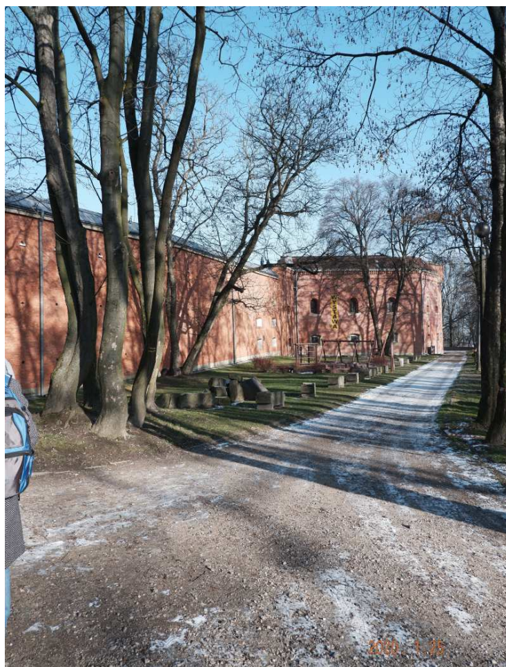
Fot. nr 145 (145-167). Wokół fortu Kościuszko. Tu wzdłuż kurtyny I-V.
