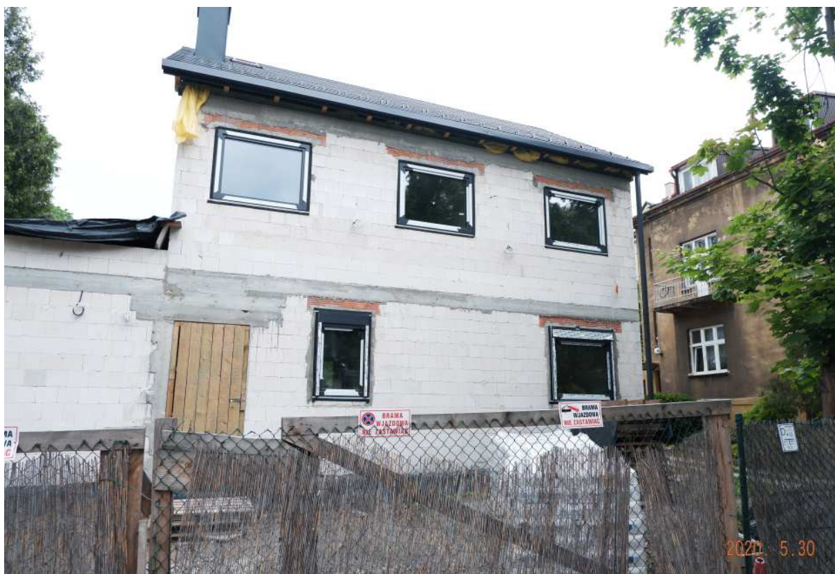
Fot. nr 168. Dom pod nr 90 na etapie przebudowy.
