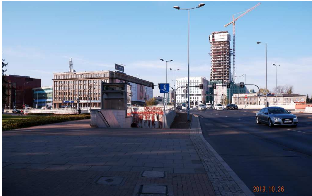
Fot. nr 265 (265-268). „Szkieletor” na końcowym etapie przebudowy. Fot. nr: 265-267 - widoki z ronda Mogilskiego.
