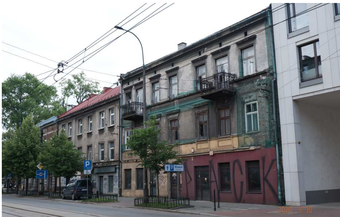
Fot. nr 72. Fragment (jeszcze) niskiej zabudowy ulicy o nr: 18-22. Wkrótce tym dwóm ostatnim przybędą dwa piętra. Niechronione przez PZP Półwie dramatycznie się zmienia.
