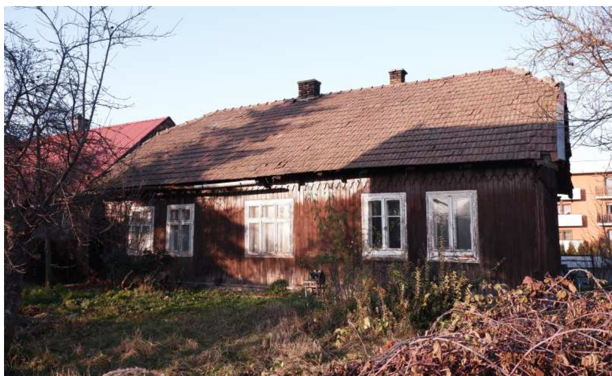
Fot. nr 322. Widok od strony podwórka.
