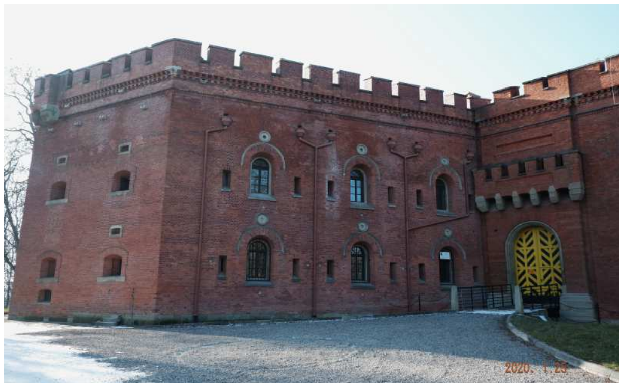
Fot. nr 241. Bastion nr V.
