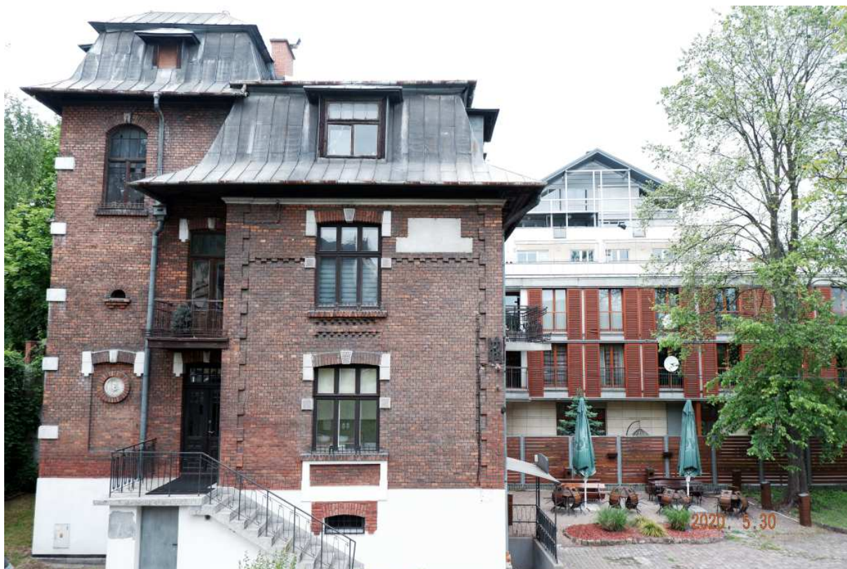
Fot. nr 123 (123-124). Modernistyczna willa z ulicy Emaus 3, która powstała w roku 1911 wg projektu Józefa Wilczyńskiego i Alfreda Kramarskiego.
