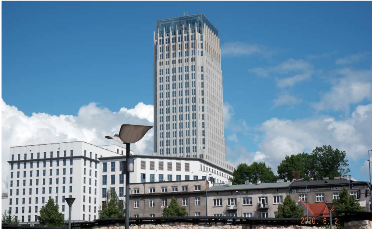
Fot. nr 269 (269-271). A to już finalny efekt prac nad przebudową „szkieletora”.
