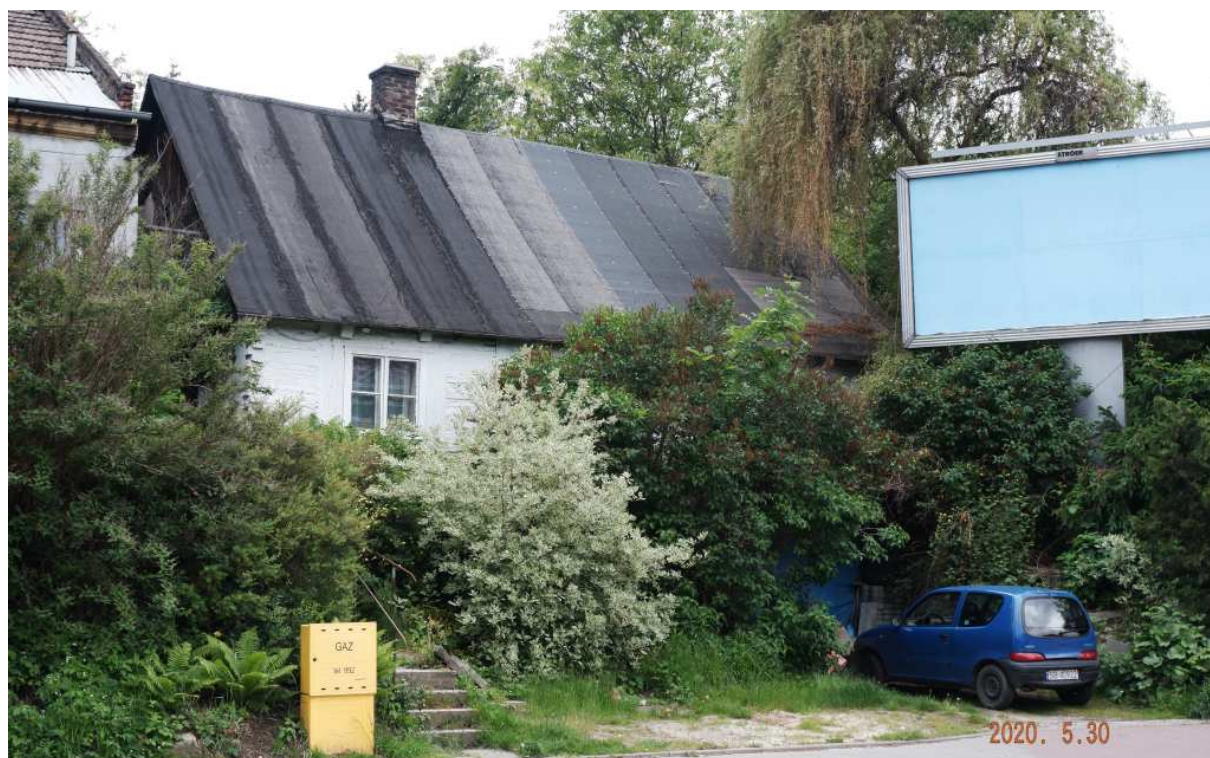
Fot. nr 177 (177-178). Chałupa pod nr 116, jedna z ostatnich ostałych na Zwierzyńcu.
