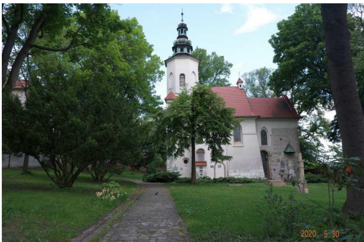
Fot. nr 210. Kościół p.w. św. Salwatora pod nr 5.
