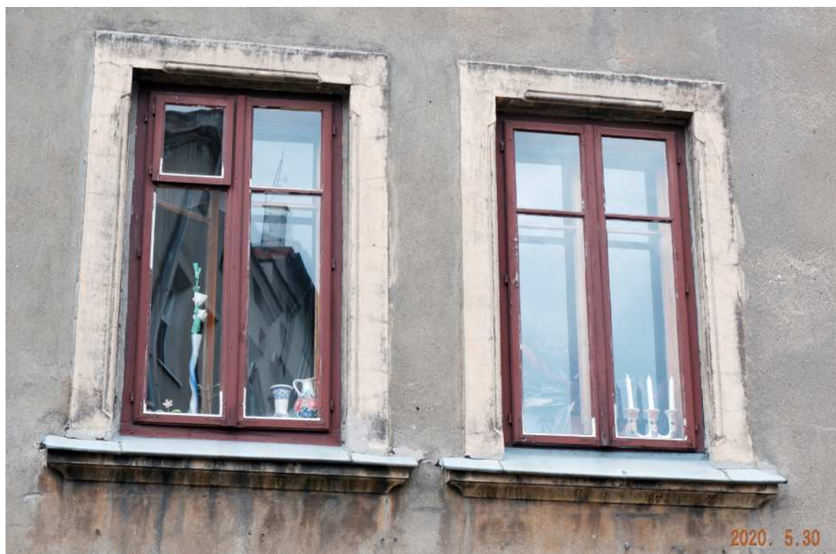
Fot. nr 53. Oryginalne okna, w tym jedno z lufcikiem, w kamienicy pod nr 10.
