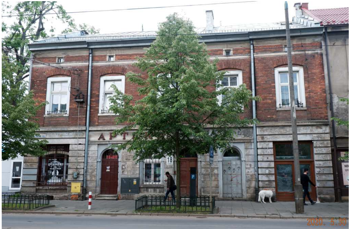
Fot. nr 57. Fasada jednopiętrowej kamieniczki, typowej dla zabudowy przedmieść.
