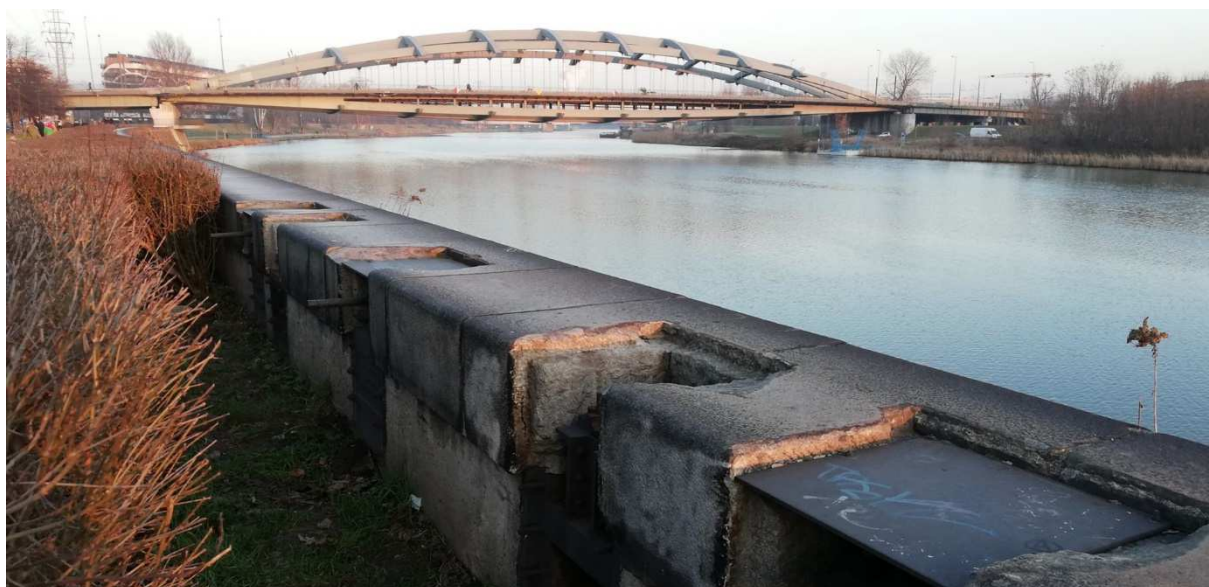
Fot. nr 282 (282-285). Umykające uwadze urządzenie zamykające odpływ ścieków z dawnej krakowskiej rzeźni, dziś przy galerii Kazimierz. (fot. Łukasz Opałek). (25.01.2020)
