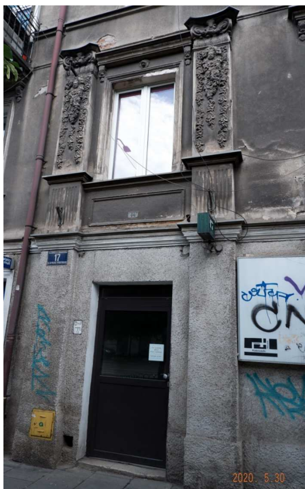
Fot. nr 74. Oryginalne pilastry nad drzwiami kamienicy pod nr 17.
