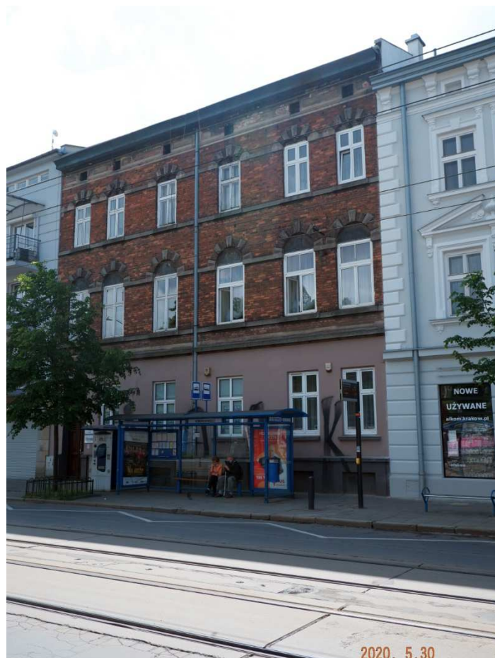
Fot. nr 81. Fasada ponad stuletniej kamienicy.
