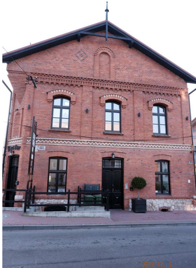
Fot. nr 315 (315-316). Budynek bieńczyckiego Sokoła z ulicy Cienistej 1.
