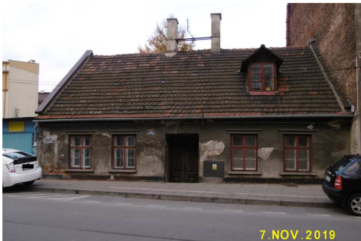
Fot. nr 399. Fasada z facjatką w dachu.
