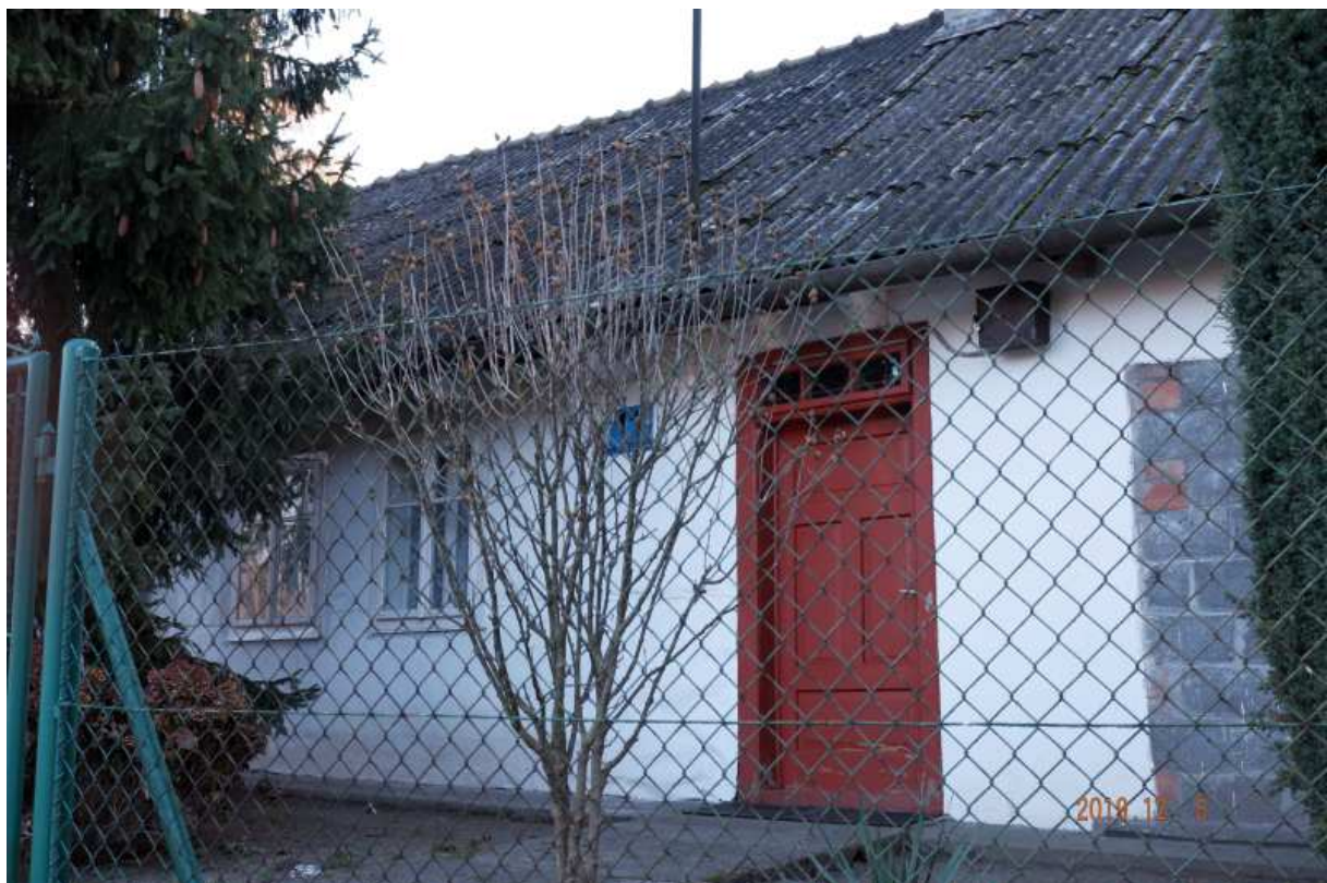
Fot. nr 330. Fasada od strony ulicy.
