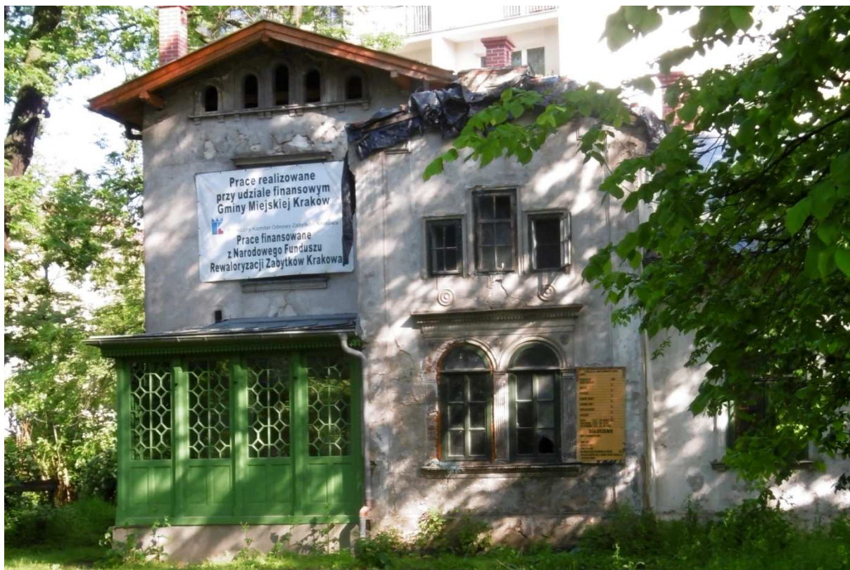
Fot. nr 44. Zrekonstruowana weranda i wymieniony dach to pierwsze widoczne efekty w trakcie ciągnącego się od kilku lat remontu. Zmiana właściciela wróży jednak postęp.
