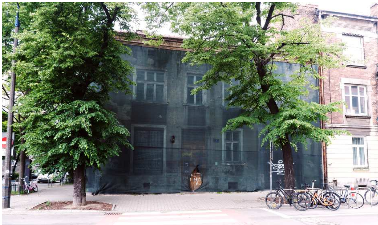
Fot. nr 104 (104-105). Jak niedługo będzie wyglądać ta klimatyczna kamieniczka z ulicy Senatorskiej 5/Filarecka 1, której próżno szukać nawet w ewidencji zabytków?
