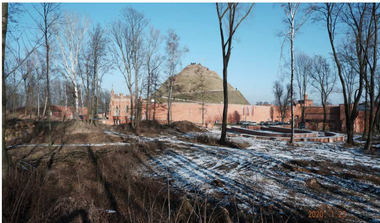
Fot. nr 222 (222-225). Wyeksponowane przyziemie bastionu nr I.
