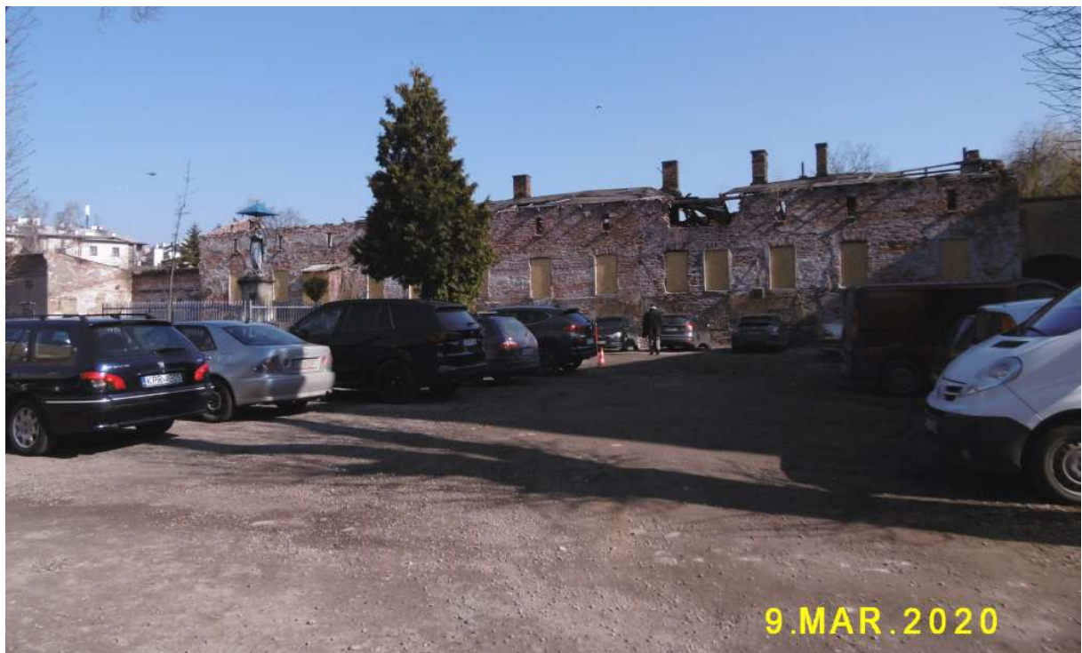
Fot. nr 24 (24-30). Zabudowa w obrębie dziedzińca należącego do o.o. Karmelitów na tyłach posesji pod nr: 21-25.
