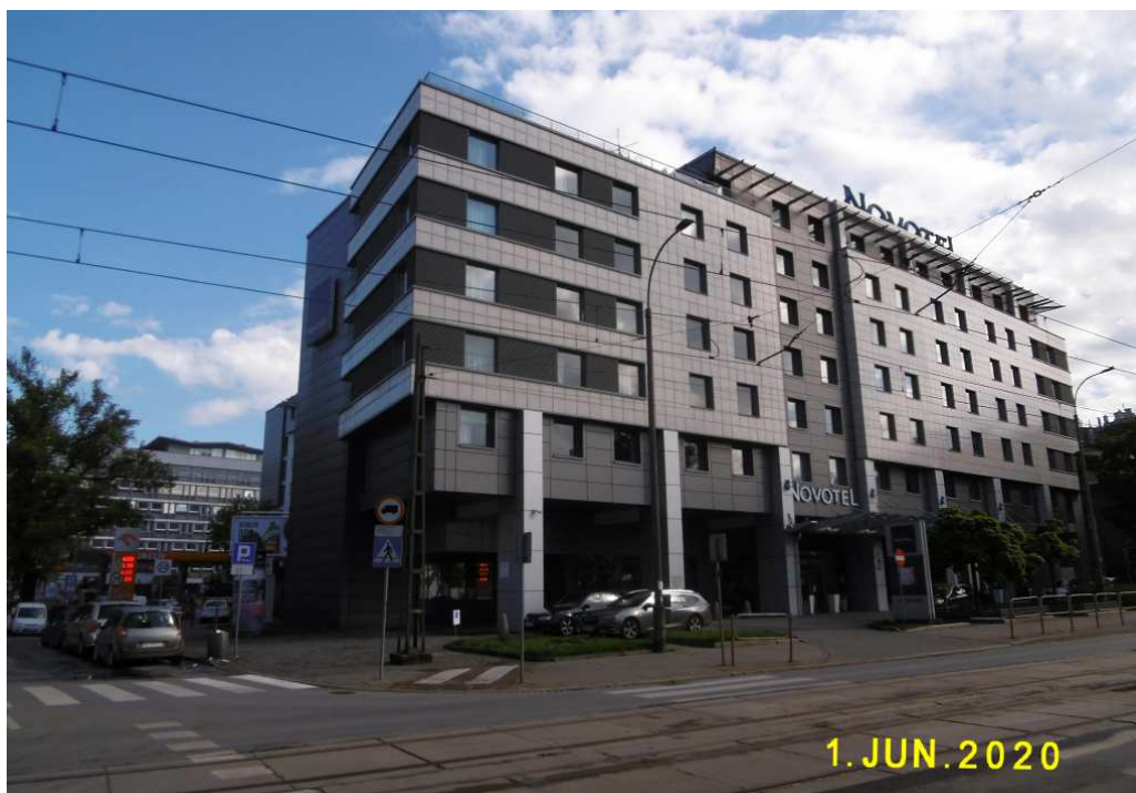
Fot. nr 51. Hotel Novotel przy ulicy Kościuszki 5.
