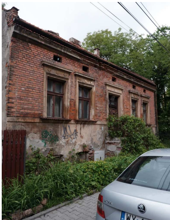
Fot. nr 151. Piękny obiekt podmiejski z I ćwierci XX wieku, którego los wydaje się być przesądzonym.
