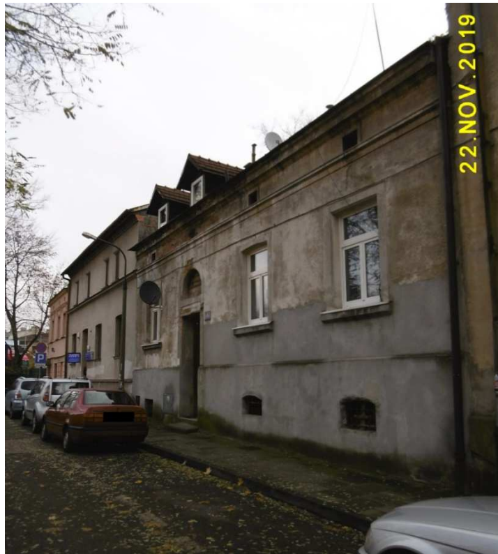
Fot. nr 373. Fragment zabudowy w dół domu spod nr 10.
