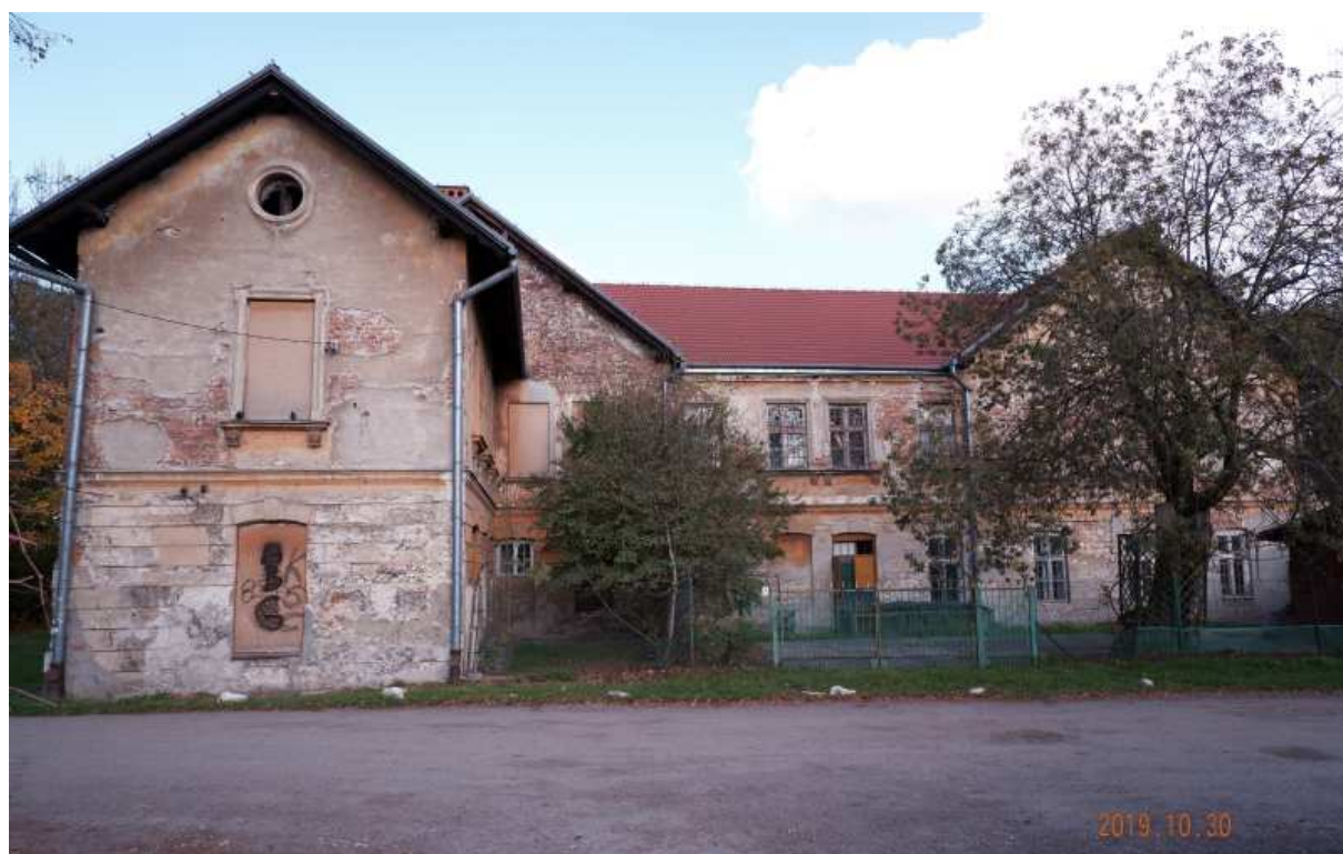
Fot. nr 442. Fasada obiektu, który powstał pod koniec XIX wieku z połączenia z dwóch luźnostojących budynków gospodarczych.
