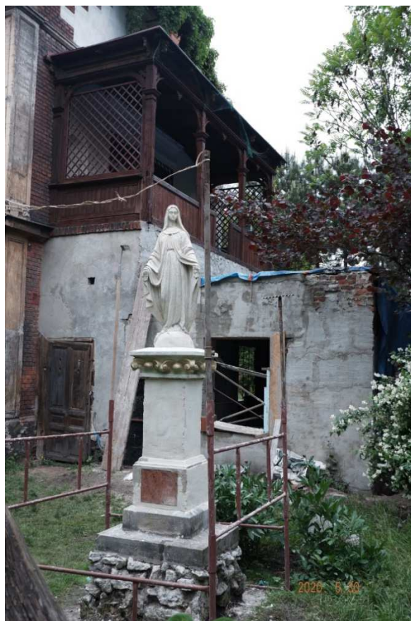
Fot. nr 116. Figura w otaczającym dom ogrodzie, a w tle loggia widokowa.
