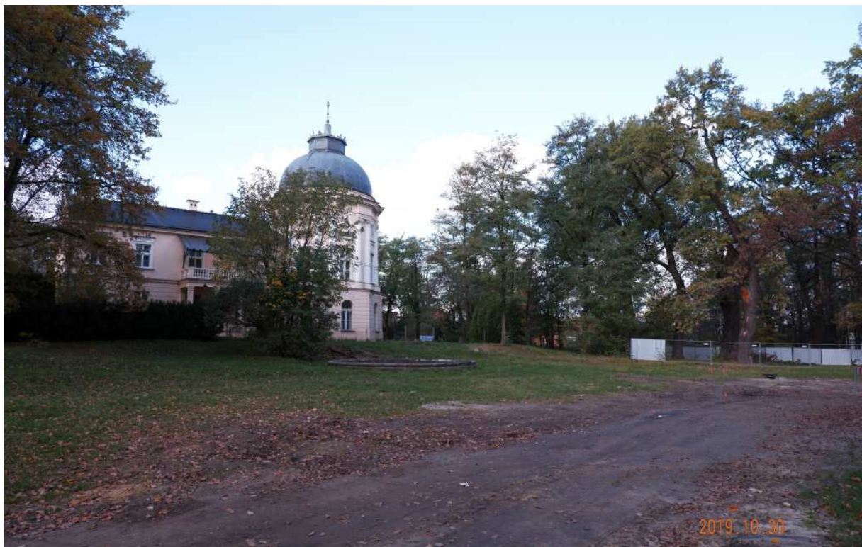
Fot. nr 444 (444-445). Fasada pałacu Wodzickich-Jerzmanowskich. W Parku Jerzmowskich trwają właśnie prace rewitalizacyjne..
