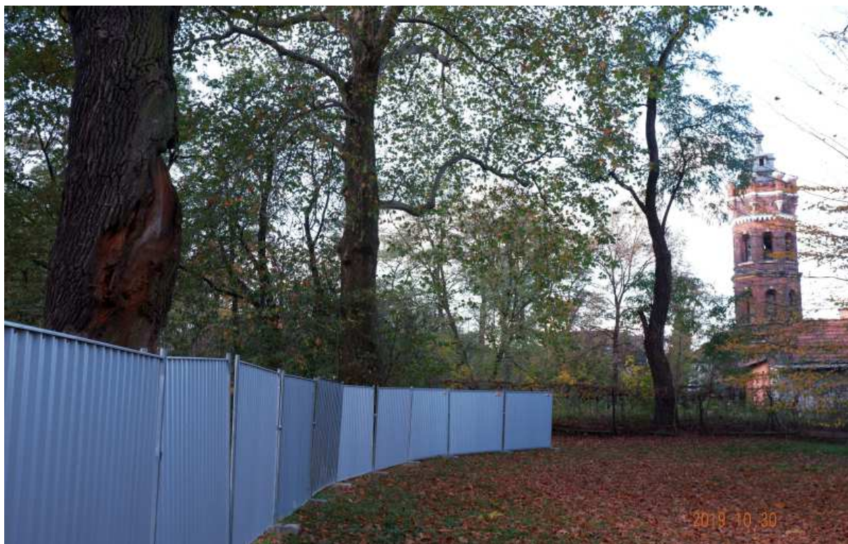
Fot. nr 447 (447-448). Dawna wieża ciśnień na skraju ulicy Górników pod nr 25.
