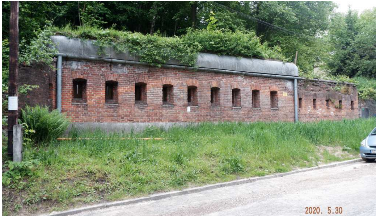
Fot. nr 195 (195-196). Fragmenty zespołu bramnego 3b fortu Kościuszko pod nr 23: mury obronne ze strzelnicami, ostróg-wartownia i wał ziemny.
