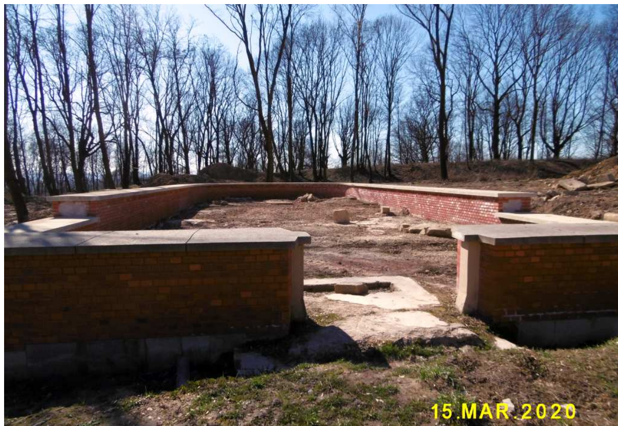
Fot. nr 220. Odtworzone przyziemie bastionu nr I.
