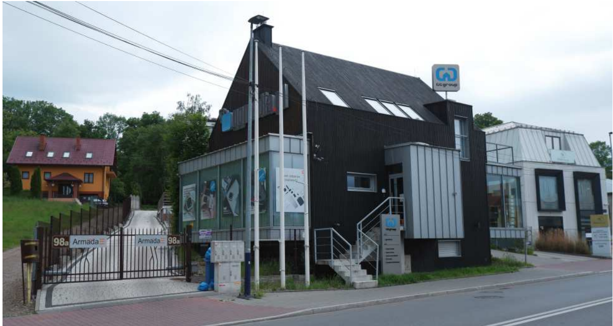
Fot. nr 171. Współcześnie powstała zabudowa pod nr: 96, 98 i 100. Jeszcze 10 lat temu pod nr 98 stała chałupa z gankiem.
