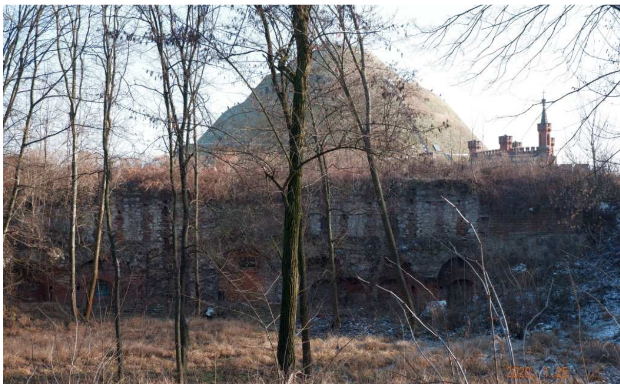
Fot. nr 228 (228-229). Ruina części zewnętrznej bastionu nr II.
