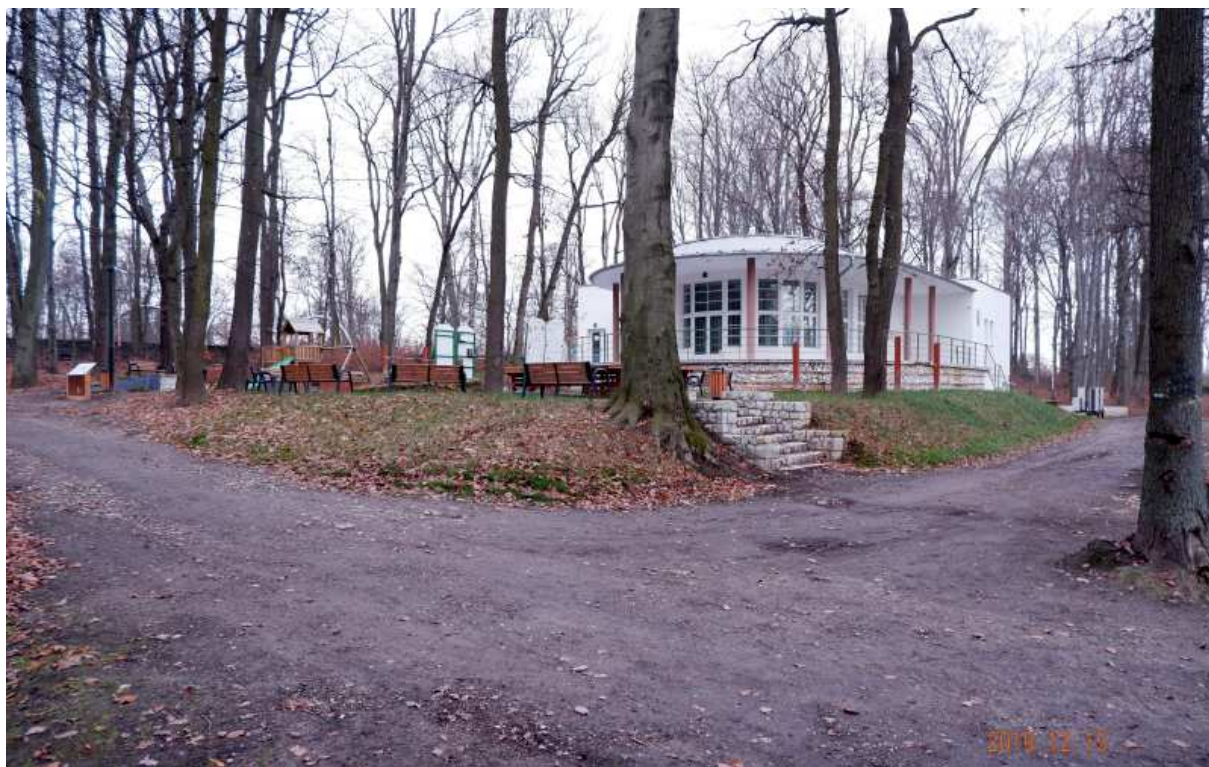
Fot. nr 263 (263-264). Po latach niepewności i zaniedbania przedwojenny Pawilon Okocimski odzyskał dawny blask. A niewiele brakowało by podzielił los kawiarenki Baba Jaga.
