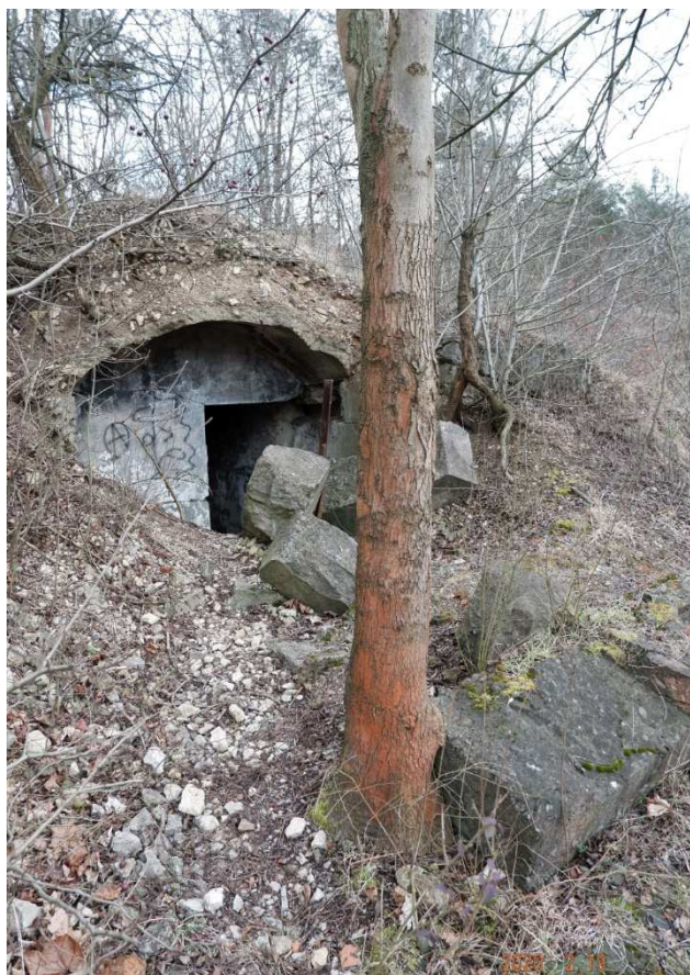
Fot. nr 378. Bunkier przy dawnym kamieniołomie w bliskości dawnego domu Cyganów.
