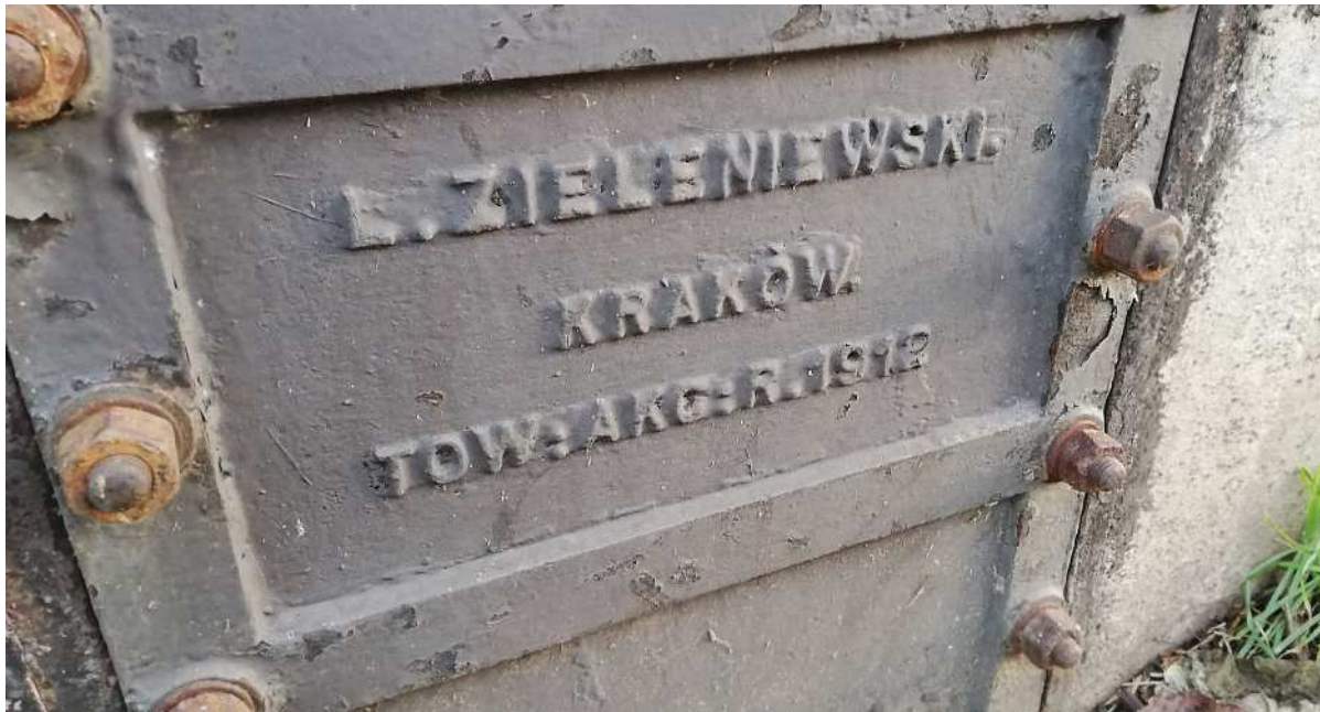
Fot. nr 285. Firma nie była jaka to wykonała - po sąsiedztwie. (25.01.2020)
