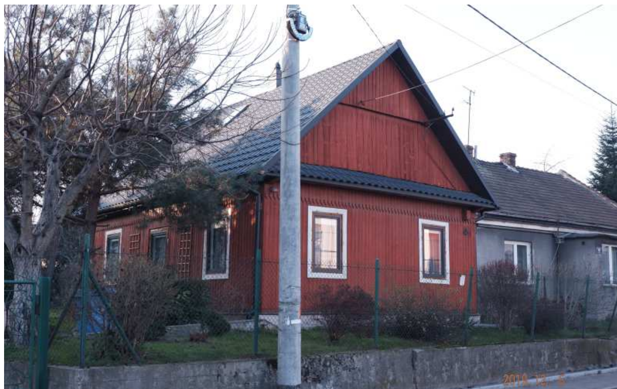
Fot. nr 362. Dom z ulicy Fatimskiej 45. I tu nie ma już oryginalnych okien, które co dopiero zastąpiły dawne oryginały.
