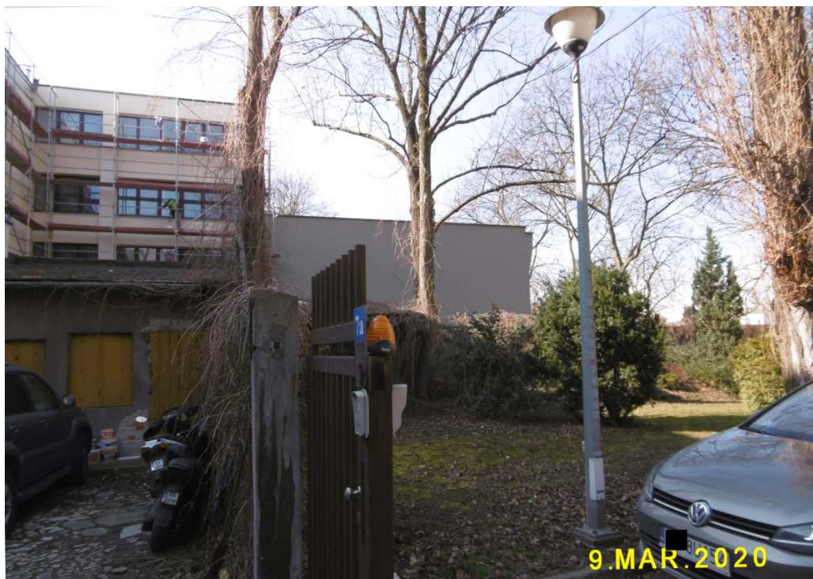
Fot. nr 22. Dobudowane skrzydło kamienicy pod nr 9.
