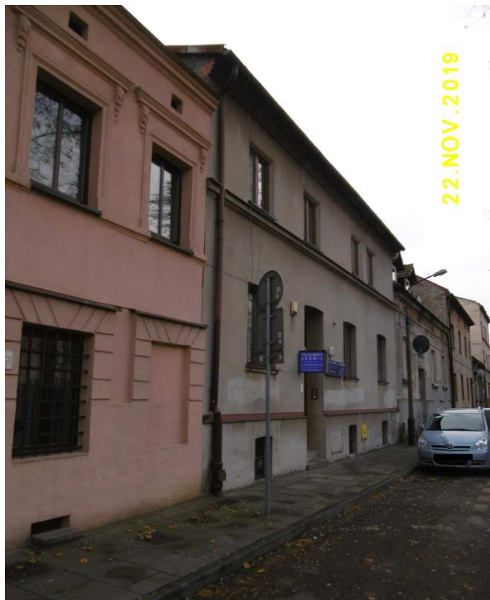
Fot. nr 375. Widok z ulicy Konopnickiej w stronę ulicy Barskiej.
