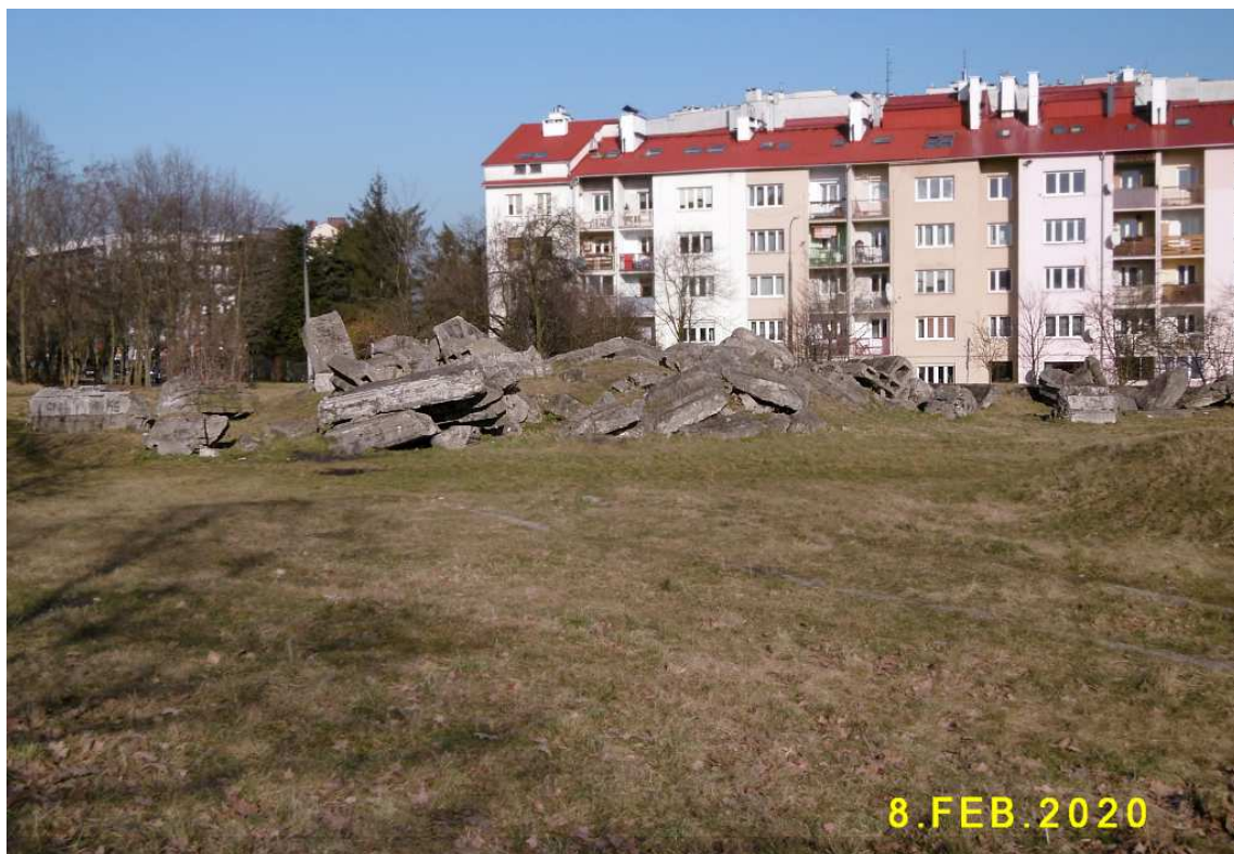
Fot. nr 408. Ruina domu przedpogrzebowego z pocz. lat 30. przy podgórskim kurkucie.
