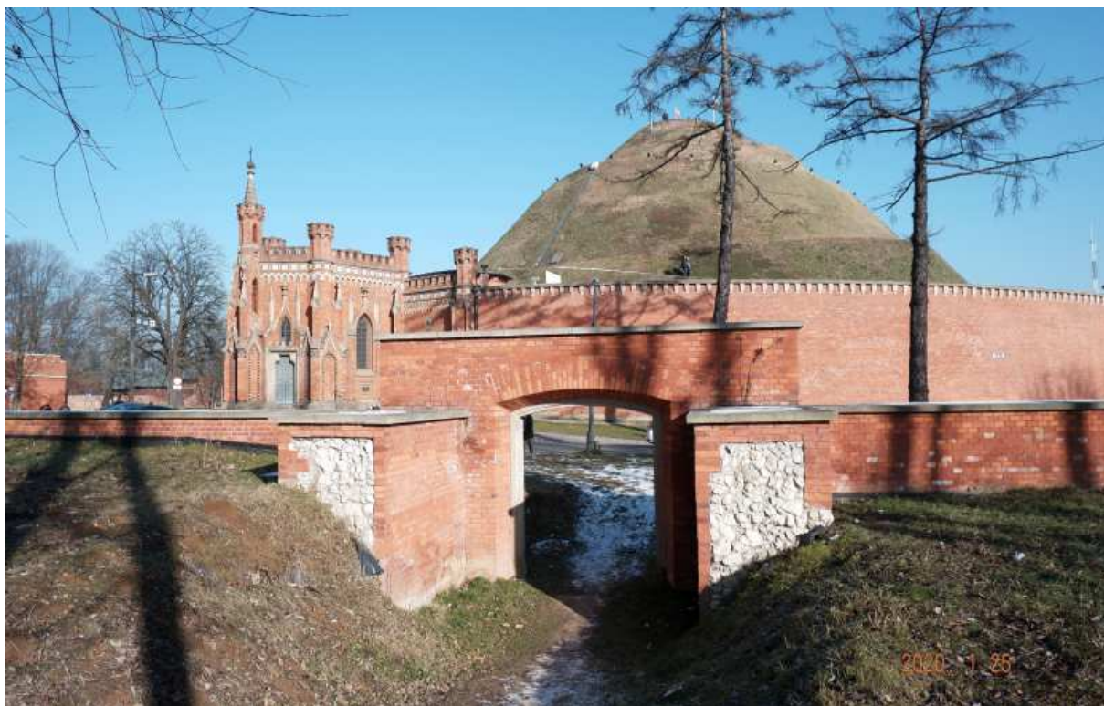
Fot. nr 227. Próba odtworzenia bramy wjazdowej od strony dziedzińca.
