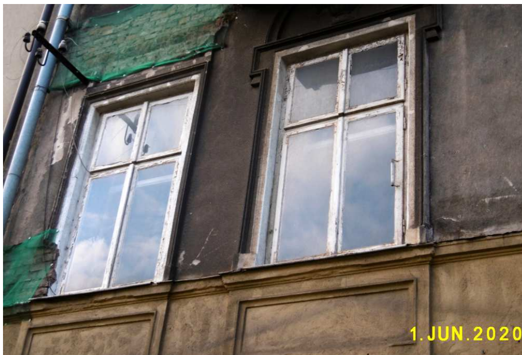
Fot. nr 73. Oryginalne okna ocienkich szprosach na I piętrze kamienicy pod nr 20. Pewnie to ich ostatni widok.
