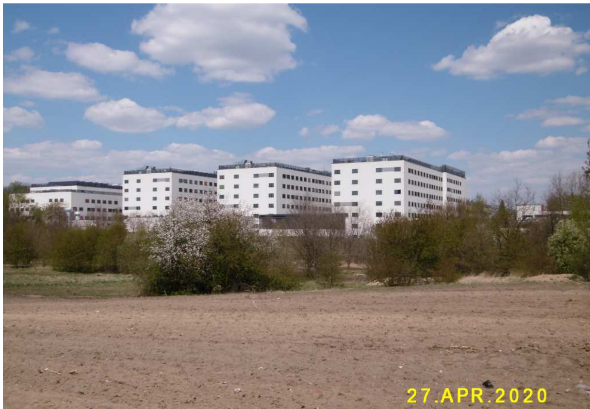
Fot. nr 464. Kompleks szpitalny UJ przy ulicy Jakubowskiego.
