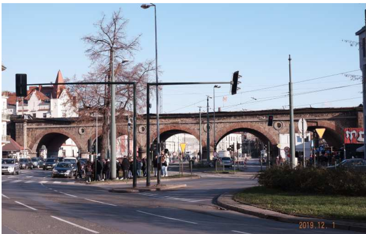
Fot. nr 275. Jaki los czeka wiadukt kolejowy przy ulicy Grzegórzeckiej? Choć to zabytek z roku 1863, wybudowany na kształt rzymskiego akweduktu, grozi mu rozbiórka.
