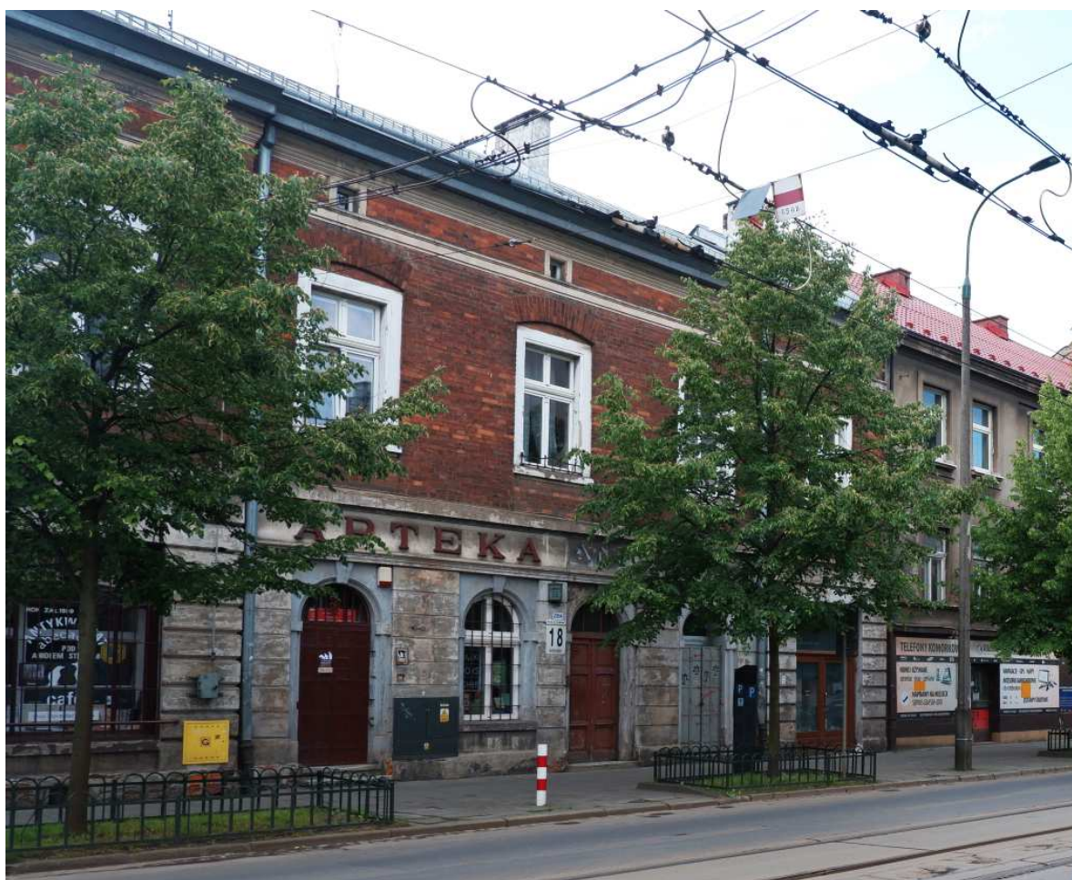
Fot. nr 56 (56-71). Dom pod nr 18, który powstał w I poł. XIX wieku i jego detale.
