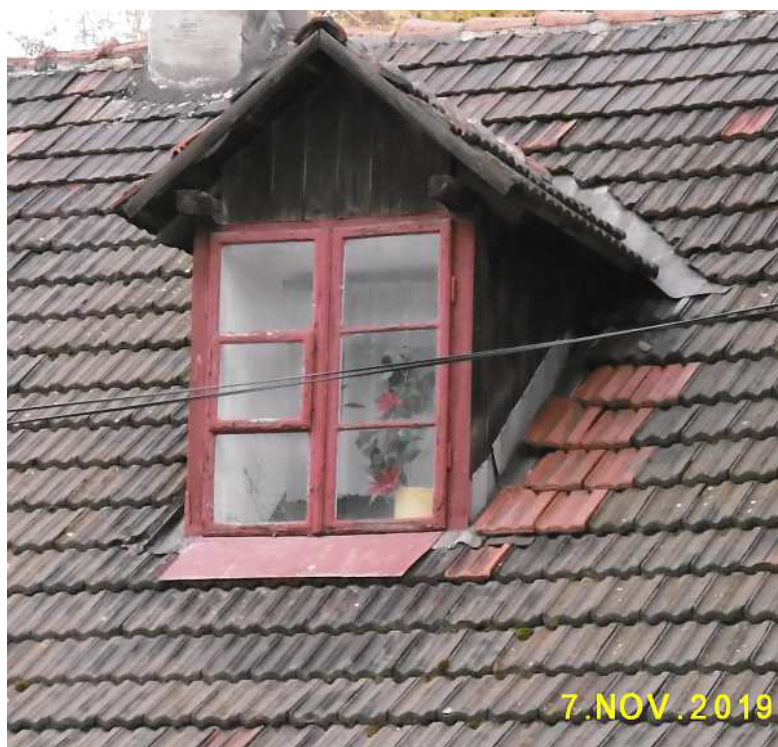
Fot. nr 400. Facjatka w dachu domu.
