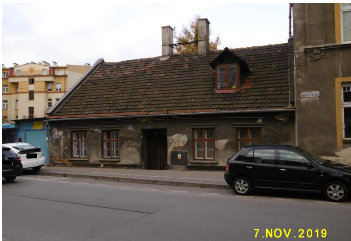
Fot. nr 398(398-400). Relikt niskiej zabudowy Podgórze z ulicy Dąbrówki 12.
