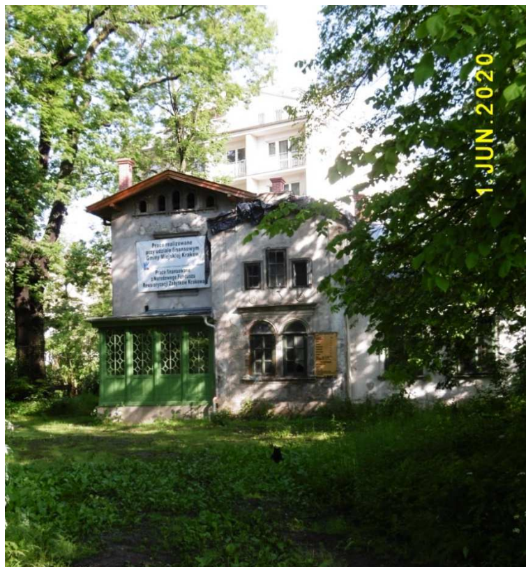
Fot. nr 43 (43-44). Wykupiona przez UMK Kossakówka ciągle na etapie remontu.
