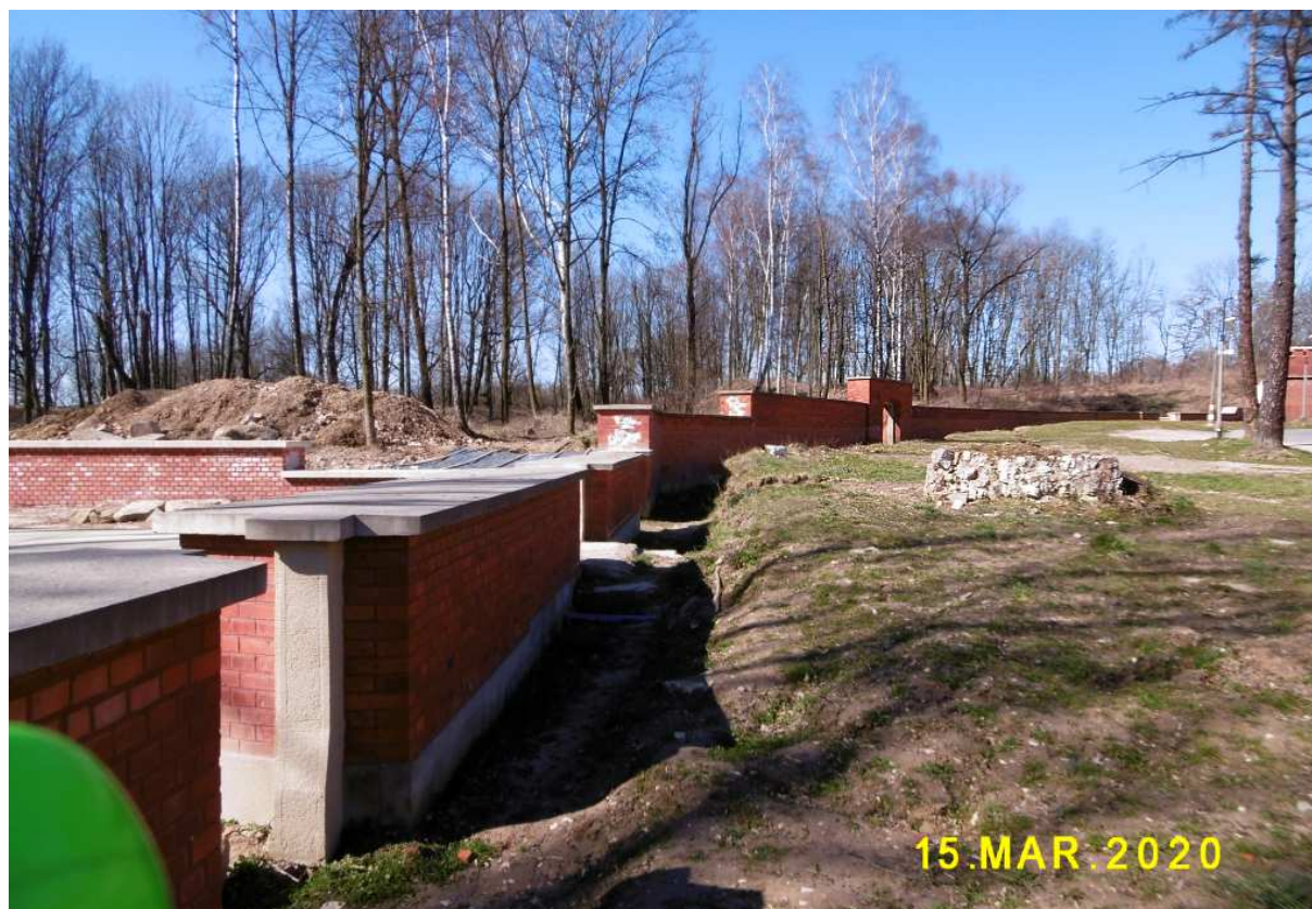
Fot. nr 219. Wzdłuż zaznaczonego narysu kurtyny I-II.
