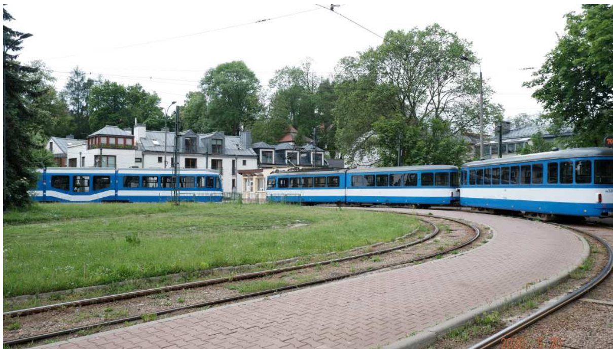
Fot. nr 125. Pętla tramwajowa na Salwatorze.
