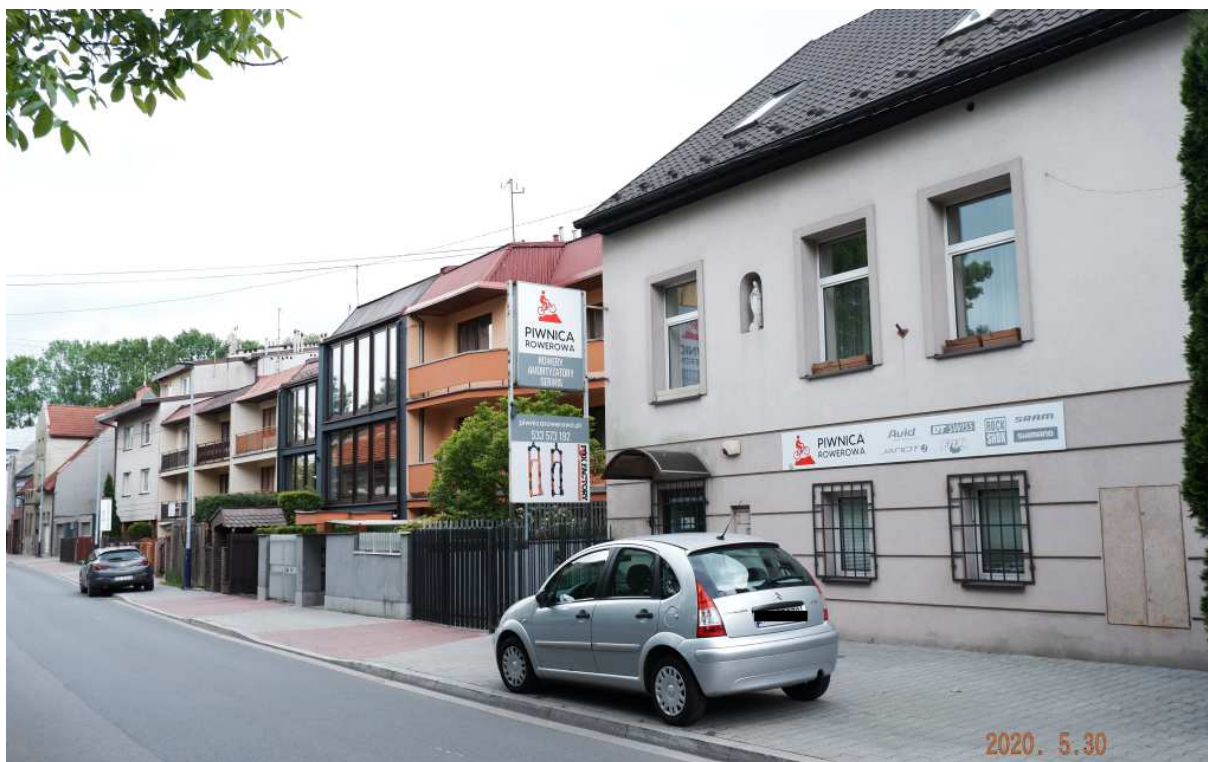
Fot. nr 144. Widok w dół domu pod nr 60.
