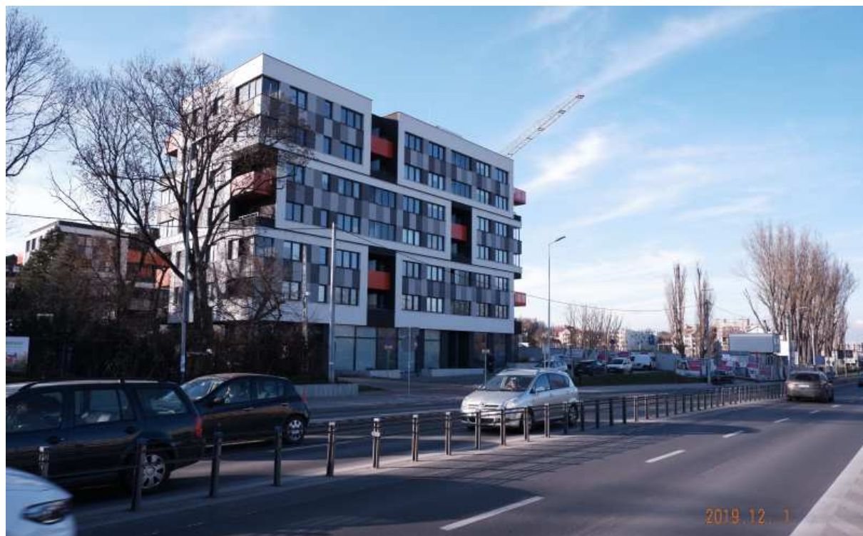
Fot. nr 411. Nowa rzeczywistość po wyburzeniu niskiej zabudowy ulicy Wielickiej o numerach: 105-111.
