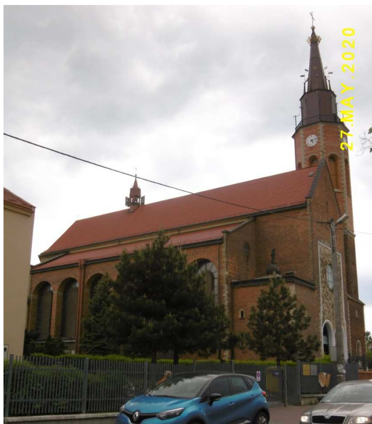
Fot. nr 419. Kościół parafialny przy ulicy Prostej po zakończeniu prac związanych z budową wieży.
