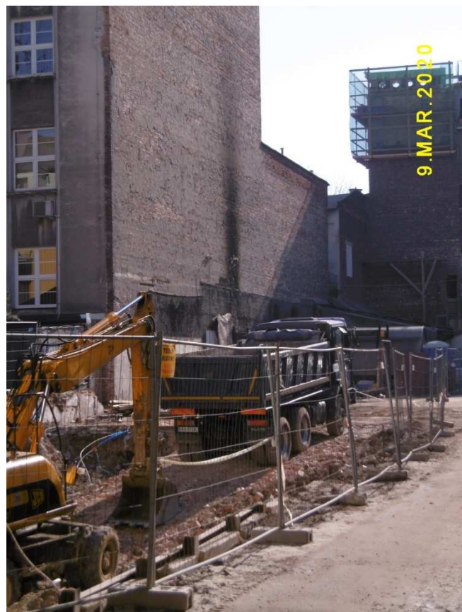
Fot. nr 18. Pusta przestrzeń po wyburzonej oficynie z ulicy Karmelickiej 13, na tyłach posesji hotelu Aleksander z ulicy Garbarskiej 18. Ma tu powstać przedłużenie hotelu.
