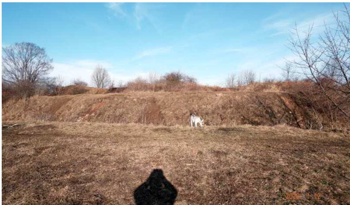
Fot. nr 385 (385-388). Fort nr 53 Bodzów i ostale jeszcze detale po próbie jego wyburzenia w połowie lat 50. zeszłego wieku.
