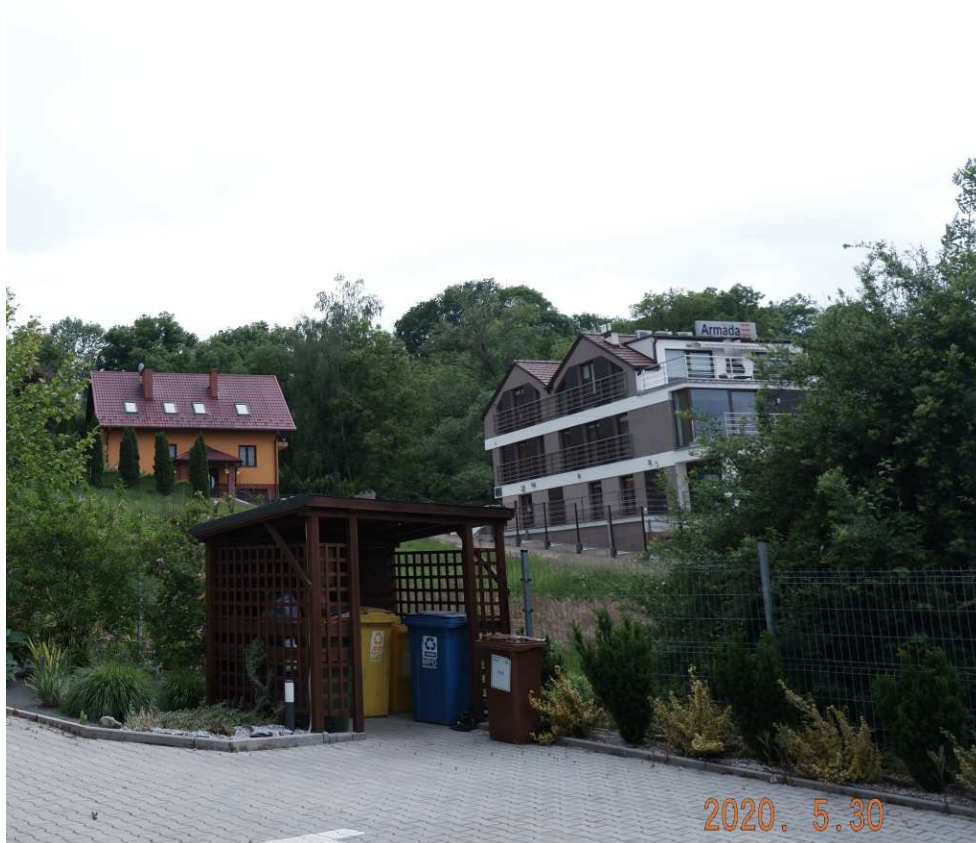
Fot. nr 170. Współcześnie wybudowane domy pod nr: 96 i 98 a.
