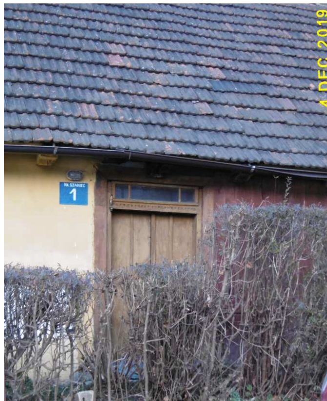
Fot. nr 304. Oryginalne drzwi ze światlikiem, które pozwalają datować obiekt nawet na koniec XIX wieku.
