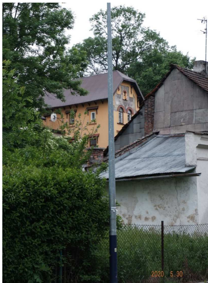
Fot. nr 160 (160-161). Eklektyczna willa z ogrodem pod nr 76. Powstała w latach 1905-1912 wg projektu Józefa Wilczyńskiego.
