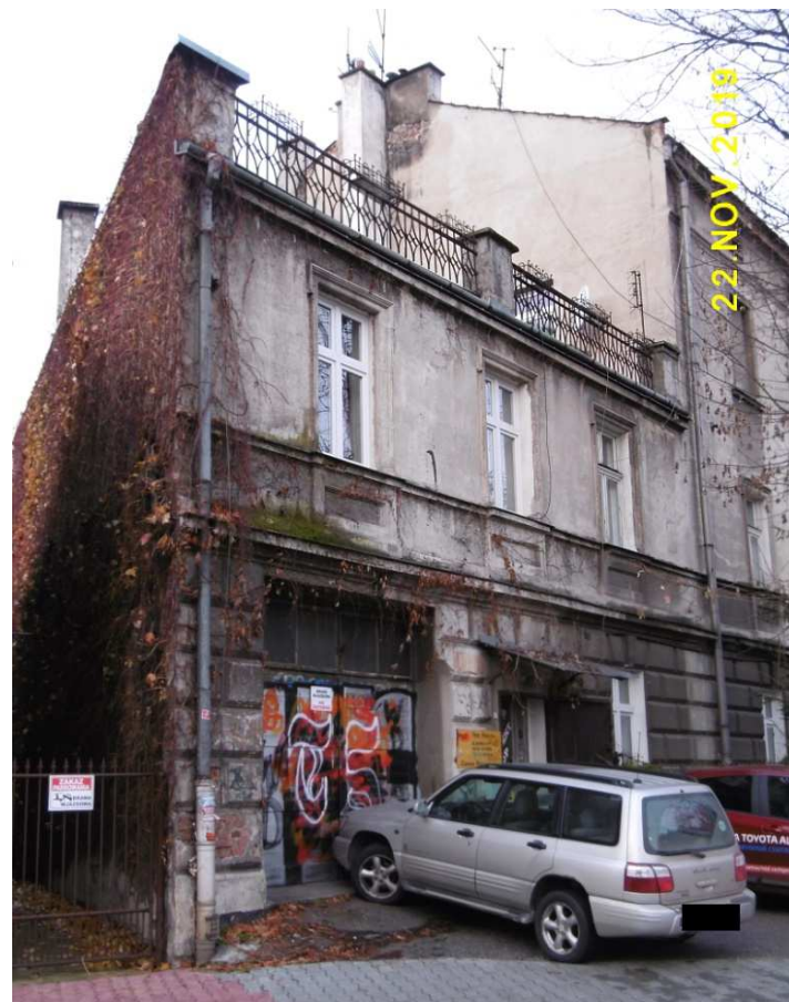
Fot. nr 368. Piętrowy dom z ulicy Barskiej 41.
