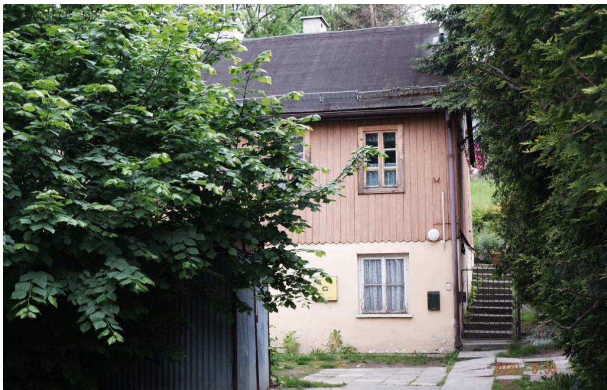
Fot. nr 167. Piętrowy dom pod nr 88.
