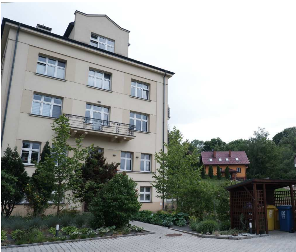
Fot. nr 169. Przedwojenna kamienica pod nr 92, a z prawej współczesny dom pod nr 96, który stoi na posesji po wyburzonej w roku 2009 chałupie.
