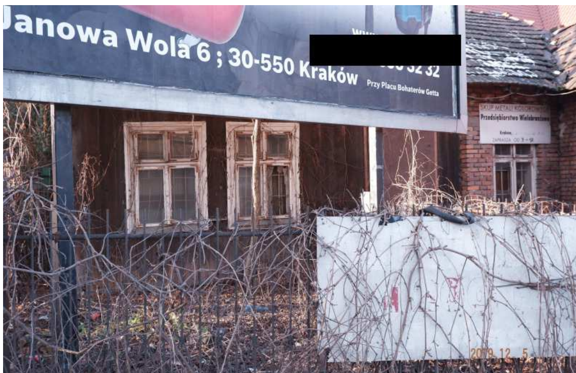
Fot. nr 320. Opustoszały już budynek mieszkalny.
