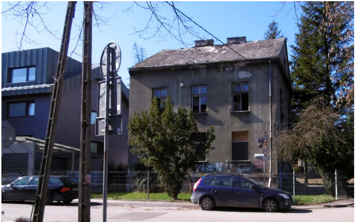
Fot. nr 244 (244-245). Przedwojenny dom z ulicy Tondosa 10 na etapie remontu bądź przebudowy.
