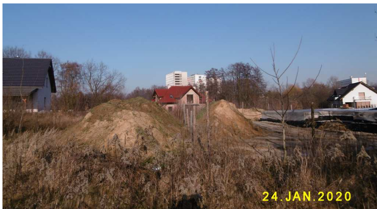
Fot. nr 462. Trwa budowa nowych domów. W tle wzgórze Baranówka w Prokocimiu.
