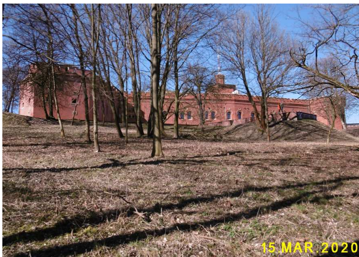
Fot. nr 242. Widok na koszary z zapola fortu od strony ulicy Małeckiego.
