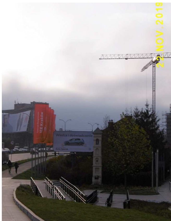
Fot. nr 379. Kapliczka - dawna latarnia, przeniesiona w nowe miejsce z sąsiedztwa ulicy Bułhaka w związku z budową Centrum Kongresowego.
