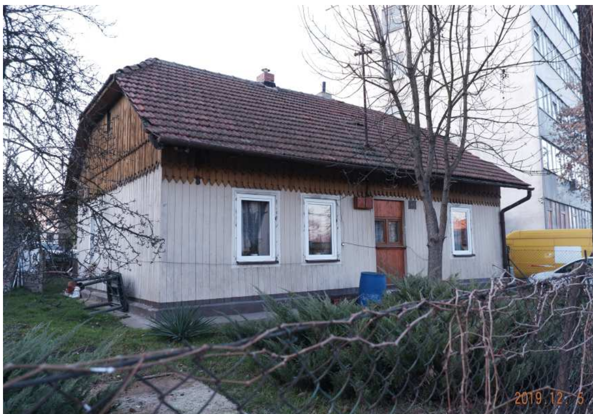
Fot. nr 360 (360-361). Dom z ulicy Fatimskiej (dawnej Polewki) 41, już z plastikowymi oknami.
