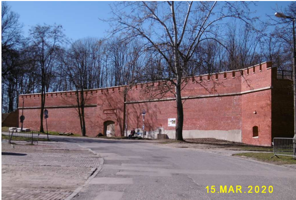
Fot. nr 233. Ściana zewnętrzna bastionu nr II.
