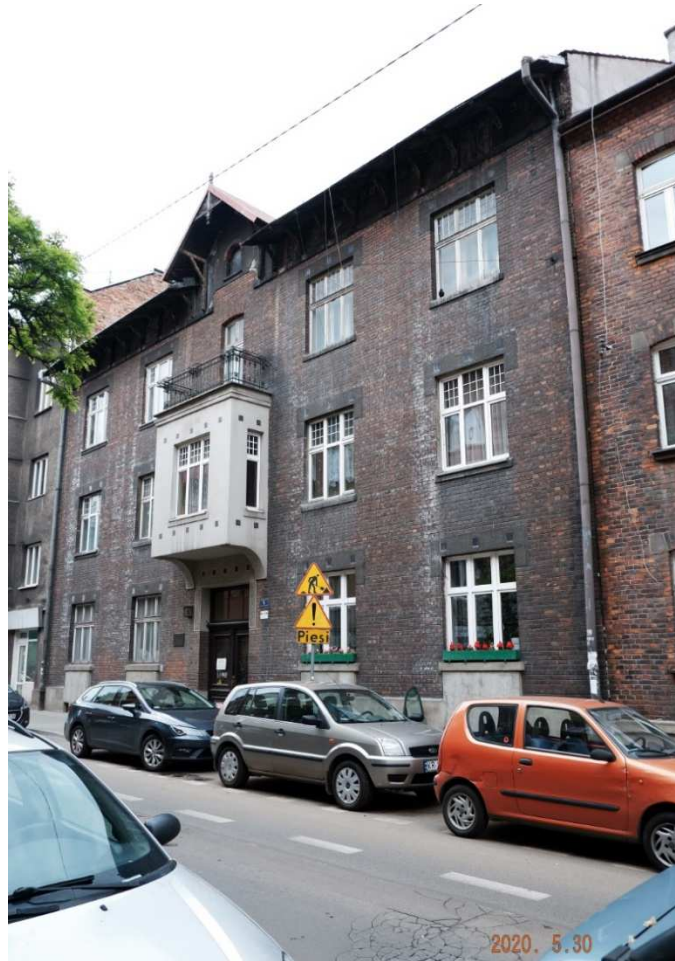
Fot. nr 101. Modernistyczna kamienica z lat 1909-11 pod nr 6.
