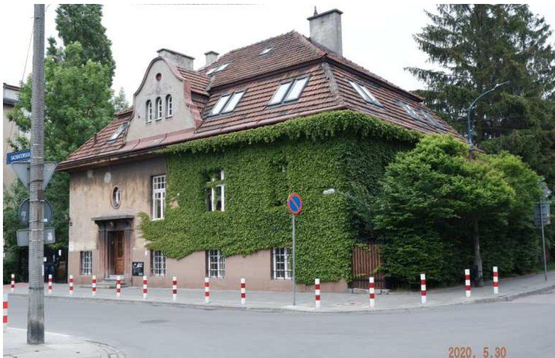
Fot. nr 113 (113-114). Pokryta dzikim winem modernistyczna willa Cyrankiewiczów z ulicy Salvatorskiej 22, której nie ma nawet w ewidencji zabytków.
