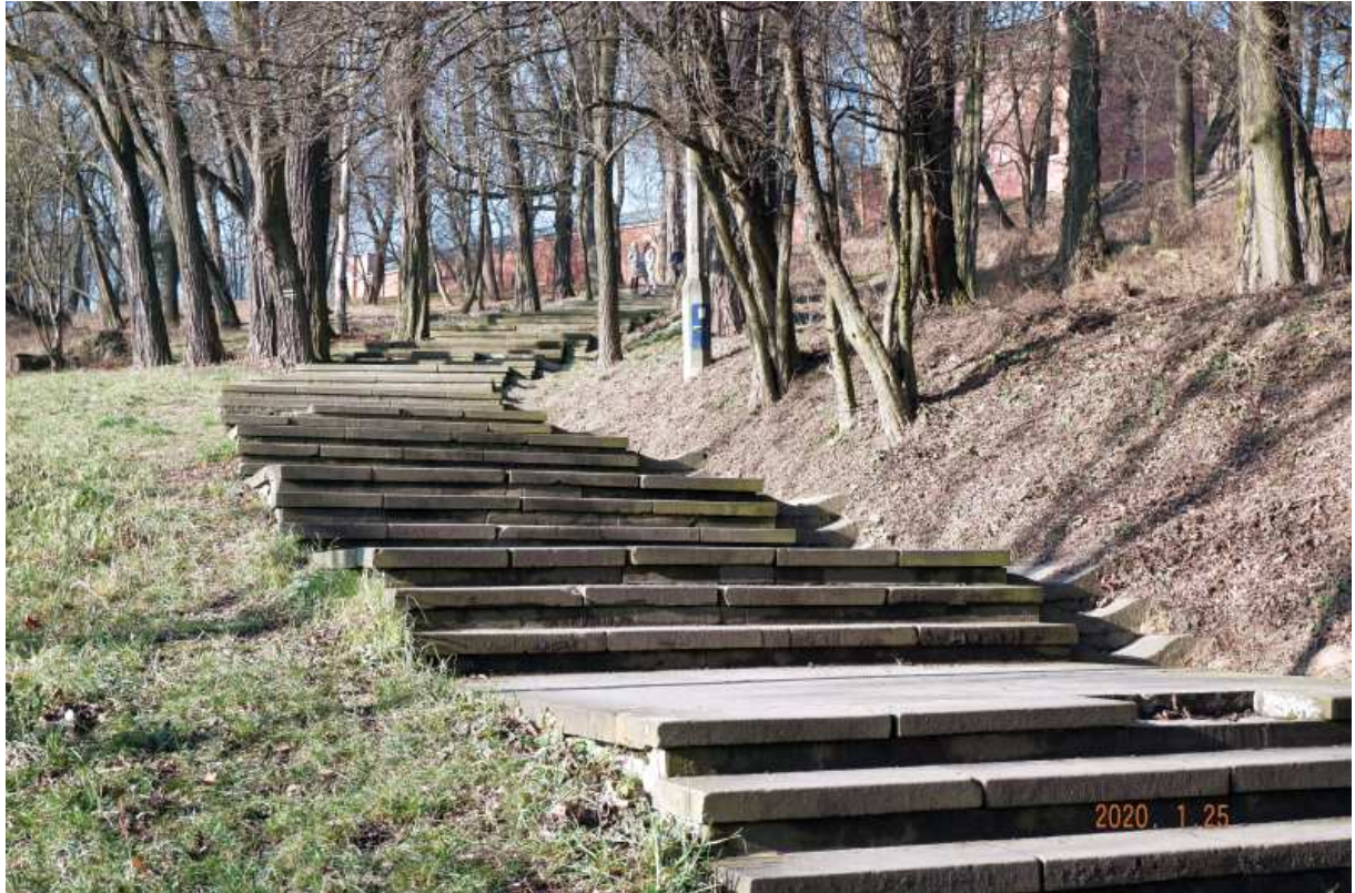
Fot. nr 215 (215-216). Powstałe w połowie lat 60. schody wiodące z alei Waszyntona ku bastionowi nr V fortu Kościuszko.
