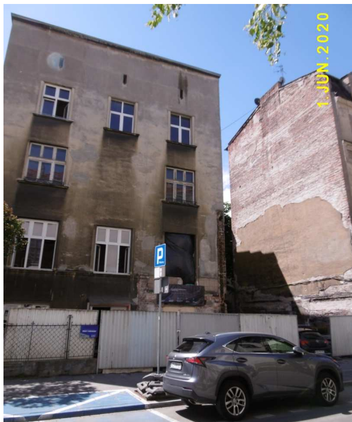
Fot. nr 35. Kamienica pod nr 16 podczas przebudowy. Co tu powstanie?
