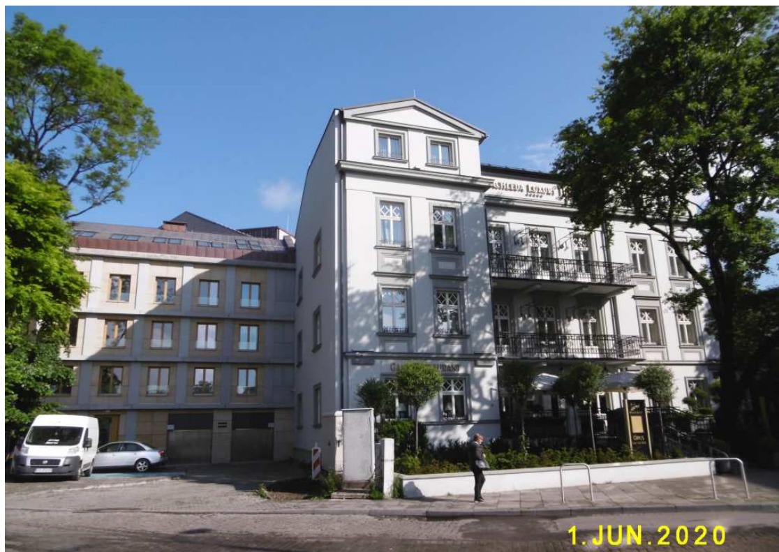
Fot. nr 46 (46-50). Bachleda Luxury Hotel przy placu Kossaka 6. Z willi Medyńskich pozostały tylko zewnętrzne ściany, a zachodnie skrzydło powstało współcześnie.
