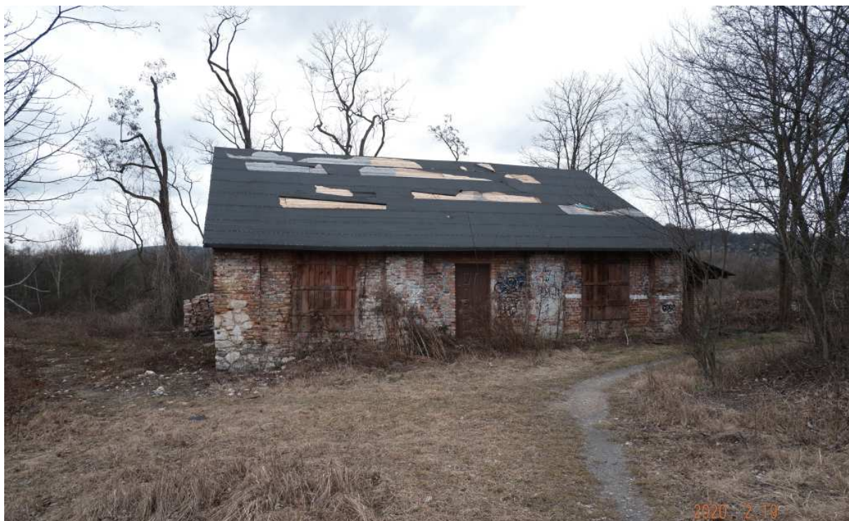
Fot. nr 377. Odbudowany dom w sąsiedztwie ulicy Tynieckiej, gdzie dawniej mieszkali Cyganie.
