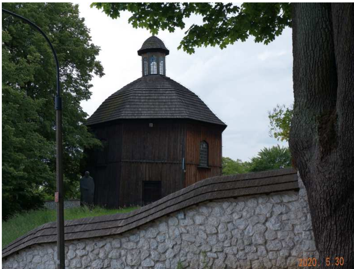
Fot. nr 211. Ośmioboczna kaplica św. Małgorzaty spod nr 2a, pierwotnie wybudowana pod koniec XVI wieku. Wg tradycji stanęła w miejscu pogańskiej gontyny.
