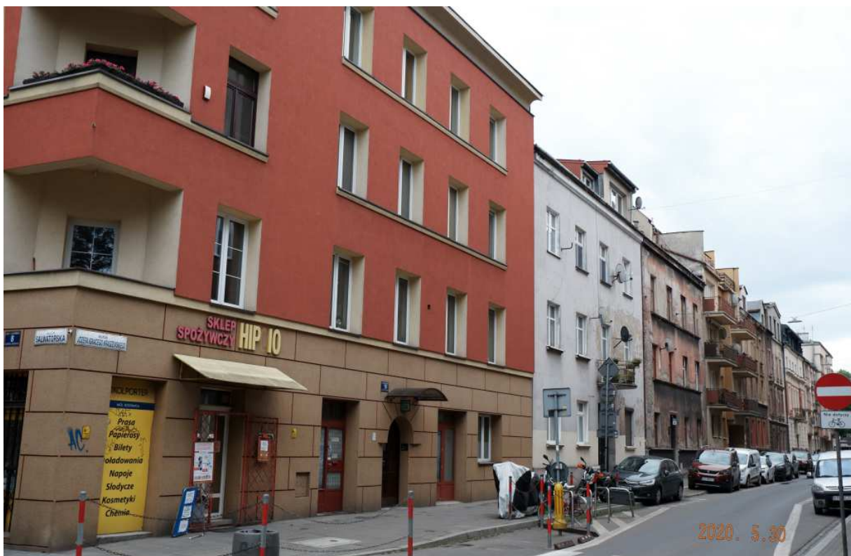
Fot. nr 108. Międzywojenna zabudowa wzdłuż ulicy Kraszewskiego poniżej nr 19.
