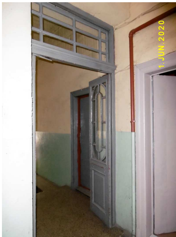
Fot. nr 62. Oryginalna stolarka drzwiowa z początku XX. wieku w sieni domu.
