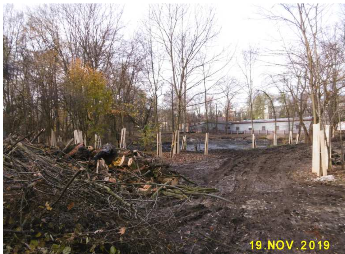
Fot. nr 412. Park Duchacki i jego otoczeniu w trakcie prac rewitalizacyjnych. Trwa oczyszczanie stawu.
