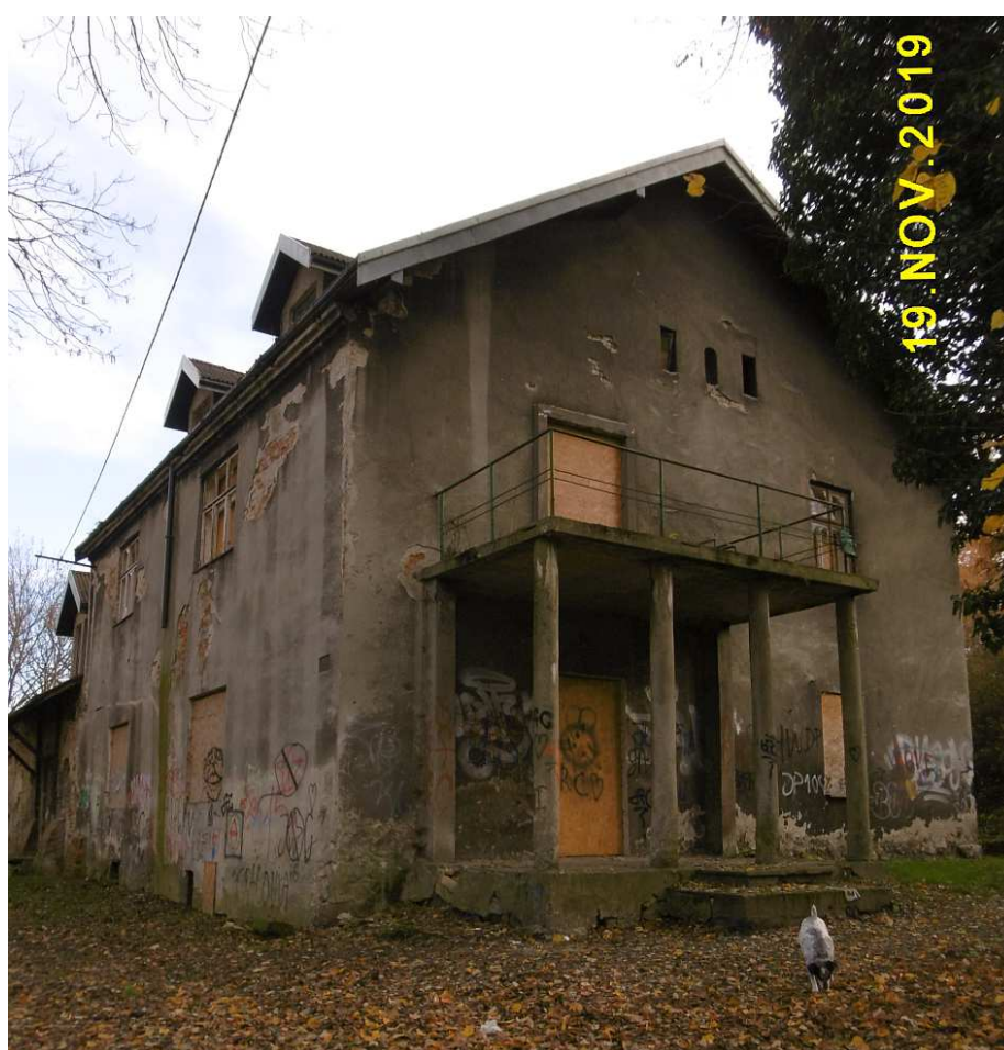
Fot. nr 416. Boczna ściana i wejście od strony ulicy Estońskiej.
