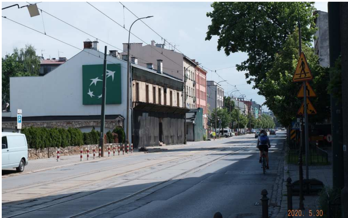
Fot. nr 87. Fragment zabudowy poniżej nr 51, gdzie dawna, niska zabudowa jest systematycznie wypierana przez coraz wyższe budynki.
