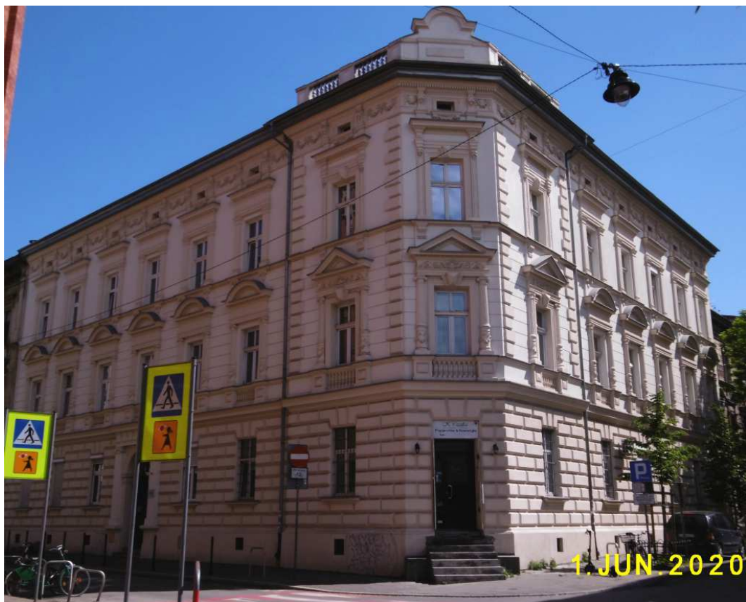
Fot. nr 95. Kamienica narożna pod nr 11.
