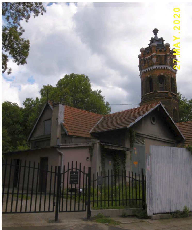
Fot. nr 449. Dawna wieża ciśnień przy ulicy Górników 25 w zespole pałacowym Erazma Jerzmanowskiego.
