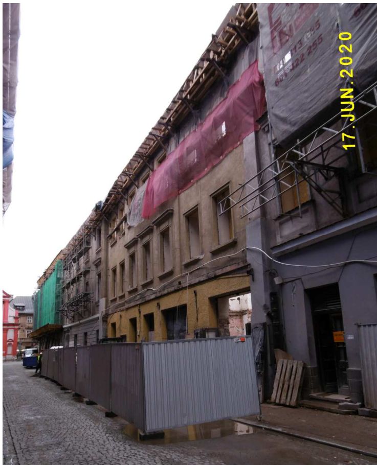
Fot. nr 39. Trwa przebudowa, połączona z wypruwaniem wnętrz, kwartału wzdłuż ulicy św. Tomasza 11-15 i św. Jana 6. Widok od strony ulicy Sławkowskiej.
