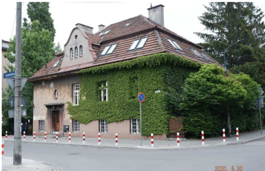
Fot. nr 201. Pokryta dzikim winem modernistyczna willa Cyrankiewiczów z ulicy Salvatorskiej 22, której nie ma nawet w ewidencji zabytków.
