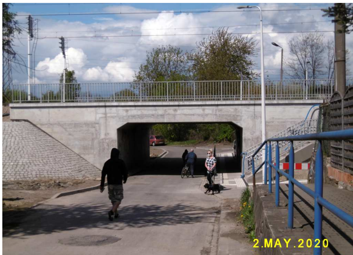
Fot. nr 413. Wreszcie ukończony widukt w ciągu ulicy Morawiańskiego.
