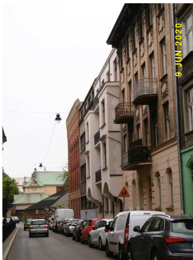
Fot. nr 52 (52-53). Wzdłuż ulicy Loretańskiej.
