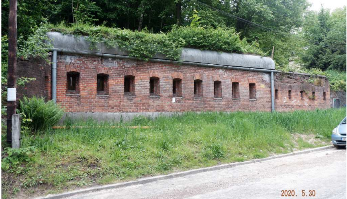
Fot. nr 215 (215-218). Fragmenty zespołu bramnego 3b fortu Kościuszko pod nr 23: mury obronne ze strzelnicami, ostróg-wartownia i wał ziemny.
