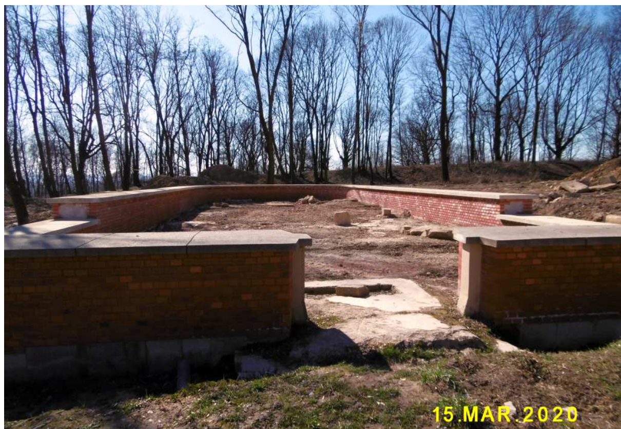
Fot. nr 227 (227-229). Odtworzone przyziemie bastionu nr I.
