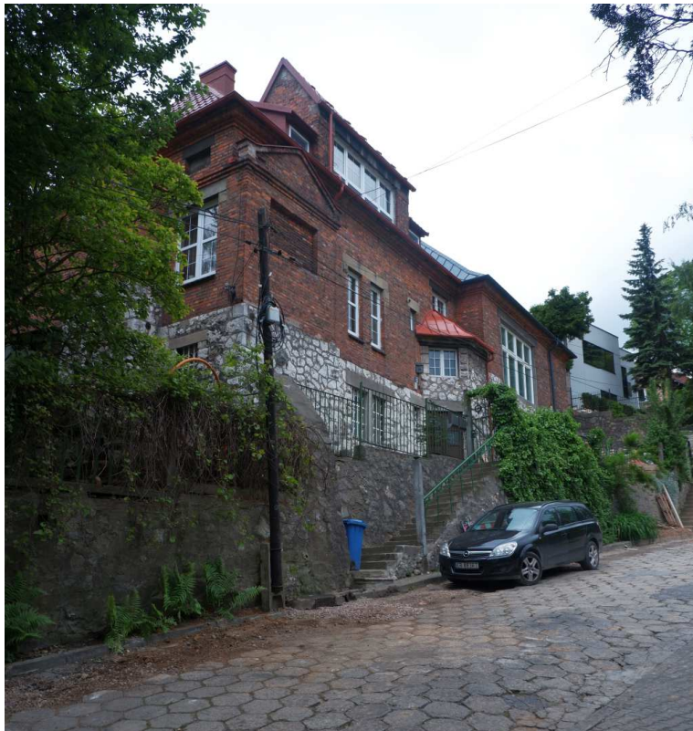
Fot. nr 217. Modernistyczna willa spod nr 13, wybudowana w II dekadzie XX wieku, gdzie okresowo mieszkał i tworzył Vlastimil Hoffman.
