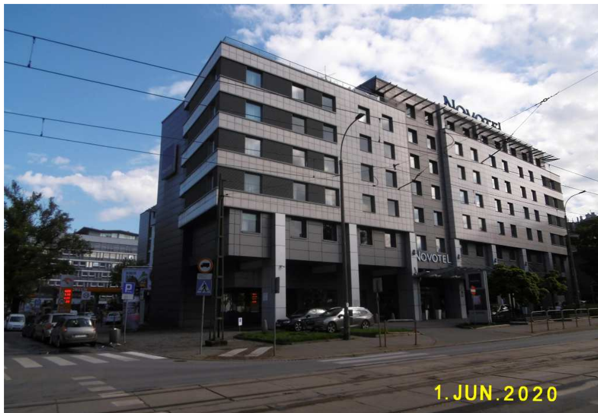
Fot. nr 183 (183-196). Wzdłuż ulicy Kościuszki. Tu Hotel Novotel pod nr 5.
