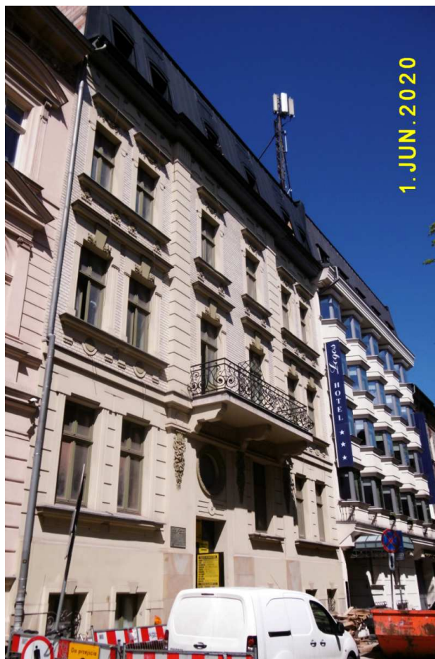
Fot. nr 60. Remont kamienicy pod nr 5.
