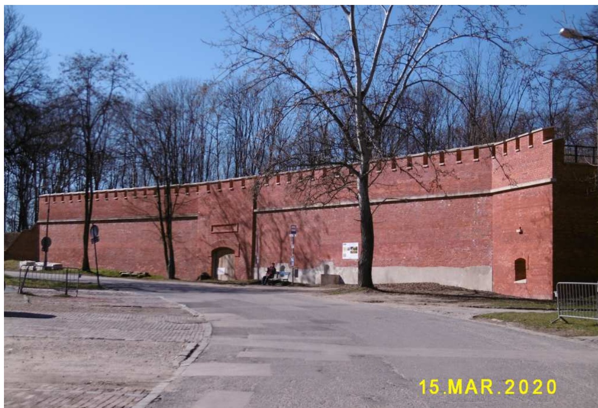
Fot. nr 224. Zrekonstruowana ściana zewnętrzna bastionu nr II.
