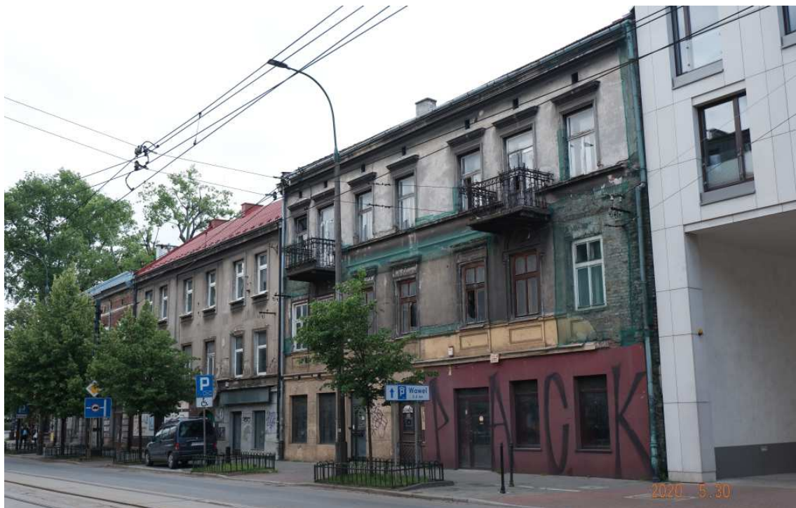
Fot. nr 186. Fragment (jeszcze) niskiej zabudowy ulicy o nr: 18-22. Wkrótce tym dwóm ostatnim przybędą dwa piętra. Niechronione przez PZP Półwie dramatycznie się zmienia.
