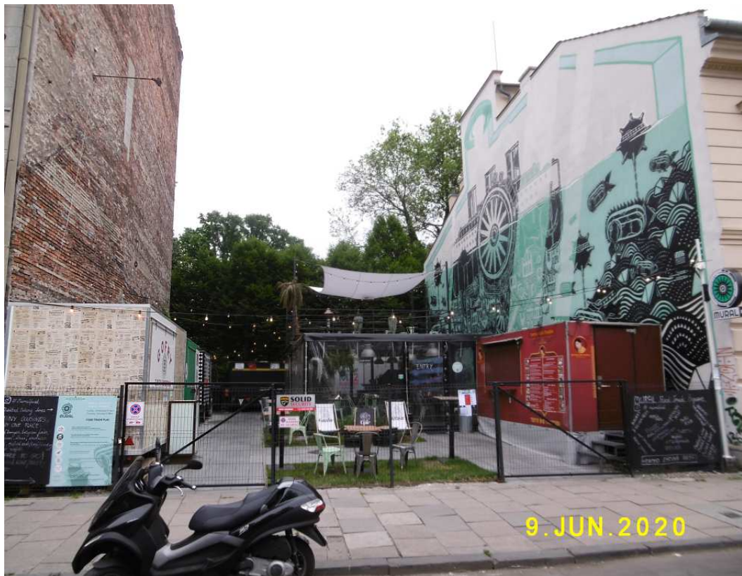
Fot. nr 61. Pusta przestrzeń po domku Rzegocińskich pod nr 24, która została prowizorycznie zagospodarowana na małą gastronomię przez Tio Malo Tex-Mex Bar.
