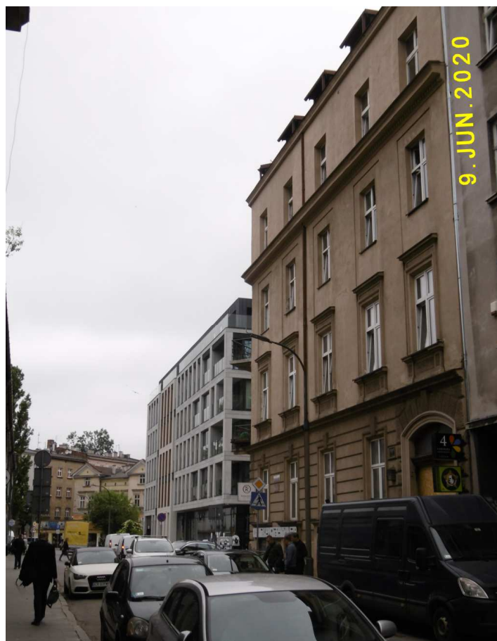
Fot. nr 64. Fragment zabudowy poniżej nr 9.
