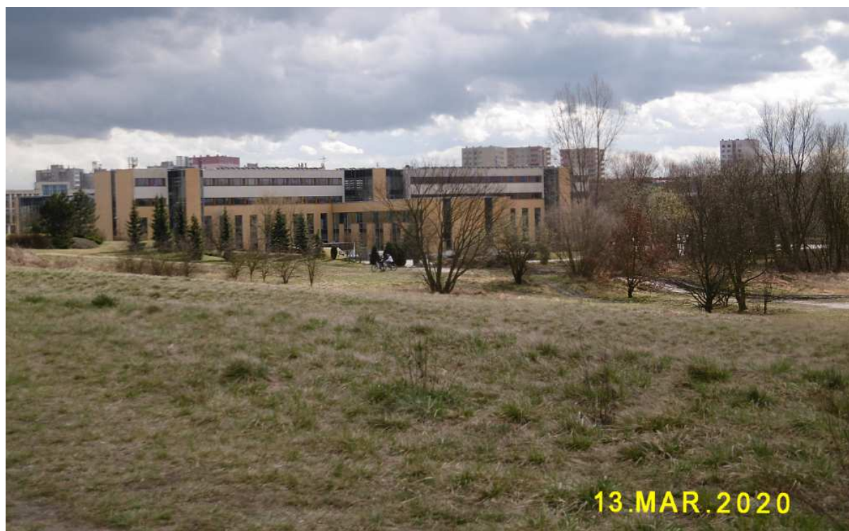
Fot. nr 275 (275-276). Zabudowa Kampusu UJ w rejonie ulicy Łojasiewicza. Widoki od strony ulicy Norymberskiej.
