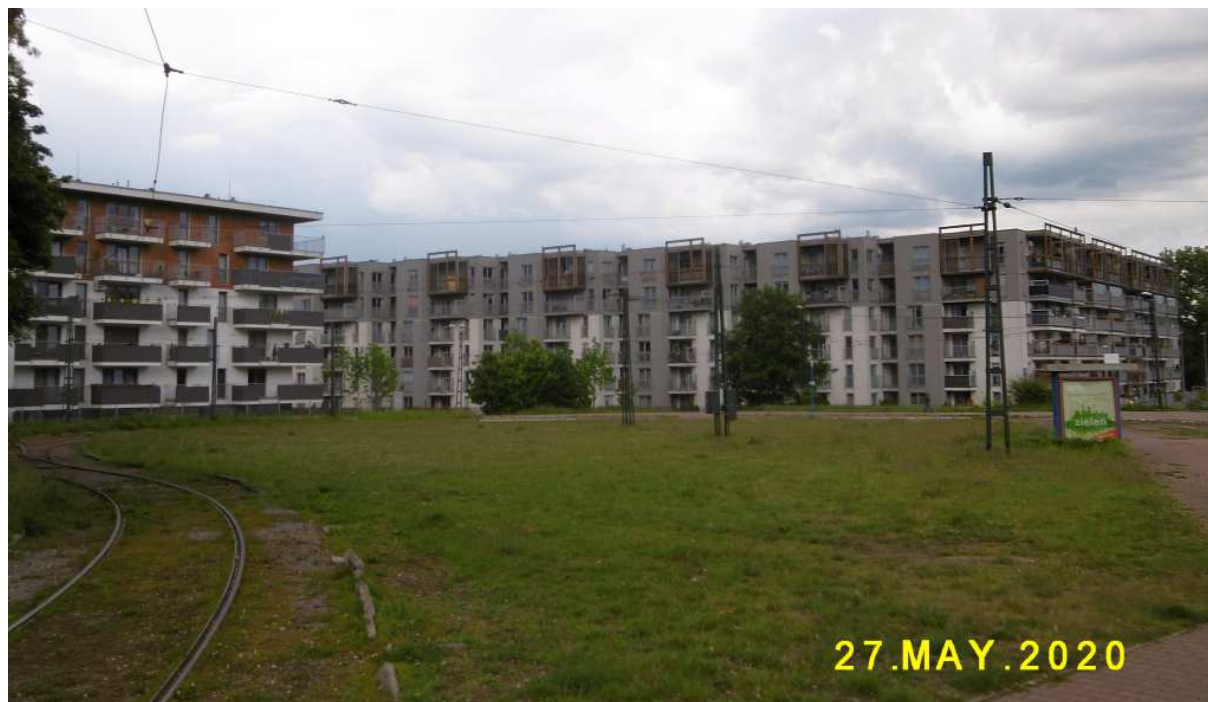
Fot. nr 444. Giganty mieszkalne na terenie dawnych ogródków działkowych przy pętli tramwajowej: „Alcatraz” – z prawej - (ul. Górników: 50-66) oraz nowe blokowisko w sąsiedztwie ulicy Żniwnej (ul. Górników: 68-70).
