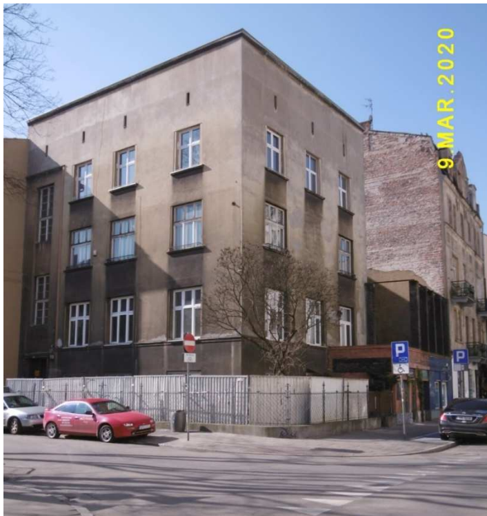
Fot. nr 120 (120-128). Kamienica spod nr 16/Szujskiego 11 na etapie przebudowy.
