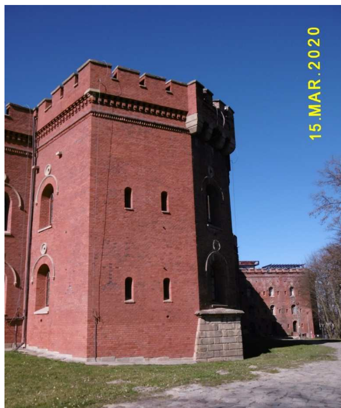
Fot. nr 220. Basteja pomiędzy bastionami nr: IV i V.
