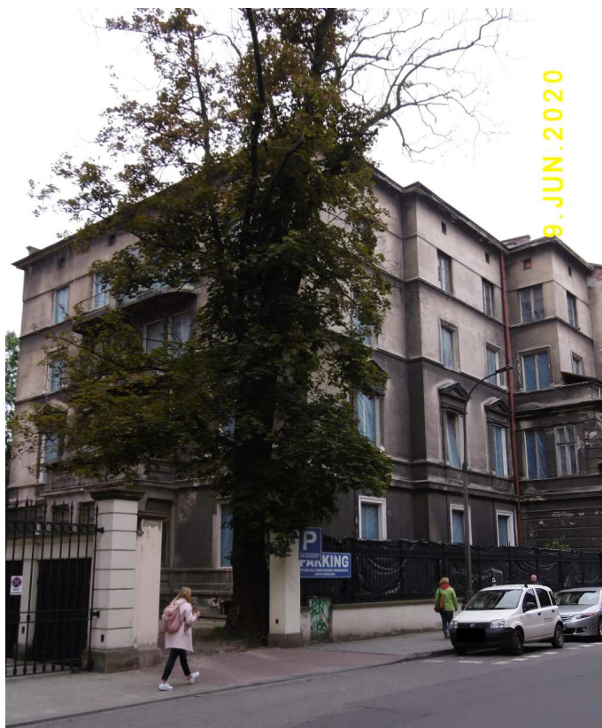
Fot. nr 56. W kamienicy pod nr 18 ciągle nie może ruszyć remont.
