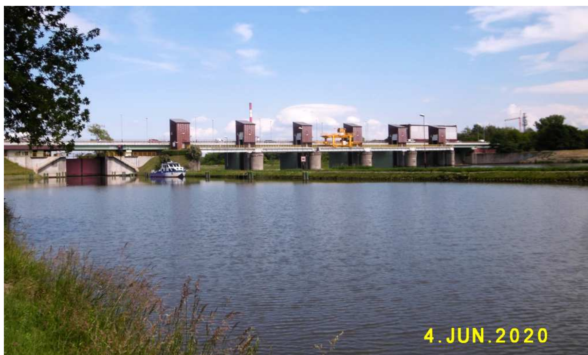
Fot. nr 270. Stopień wodny na Dąbiu.
