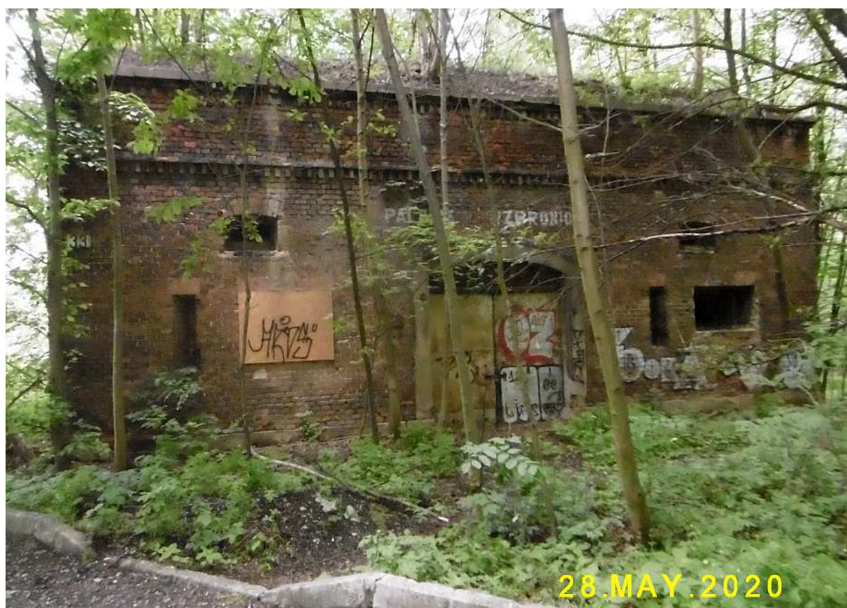
Fot. nr 262 (262-264). Niewielkie pozostałości po tzw. Lunecie Grzegórzeckiej, jednym z pierwszych fortów Twierdzy Kraków
