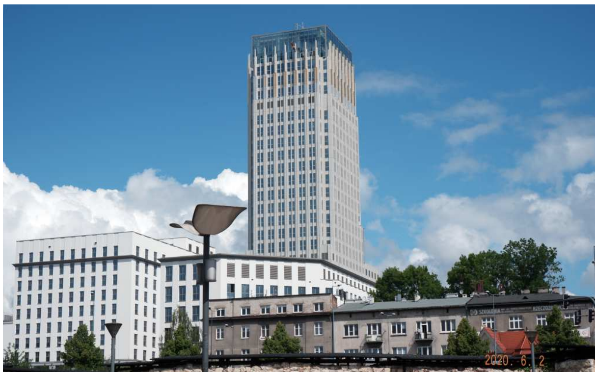
Fot. nr 251 (251-255). Ukończony do wielu dekadach „szkieletor”. Sam wygląda całkiem ciekawie, ale ta granista obudowa o wielkich gabarytach musi porażać.
