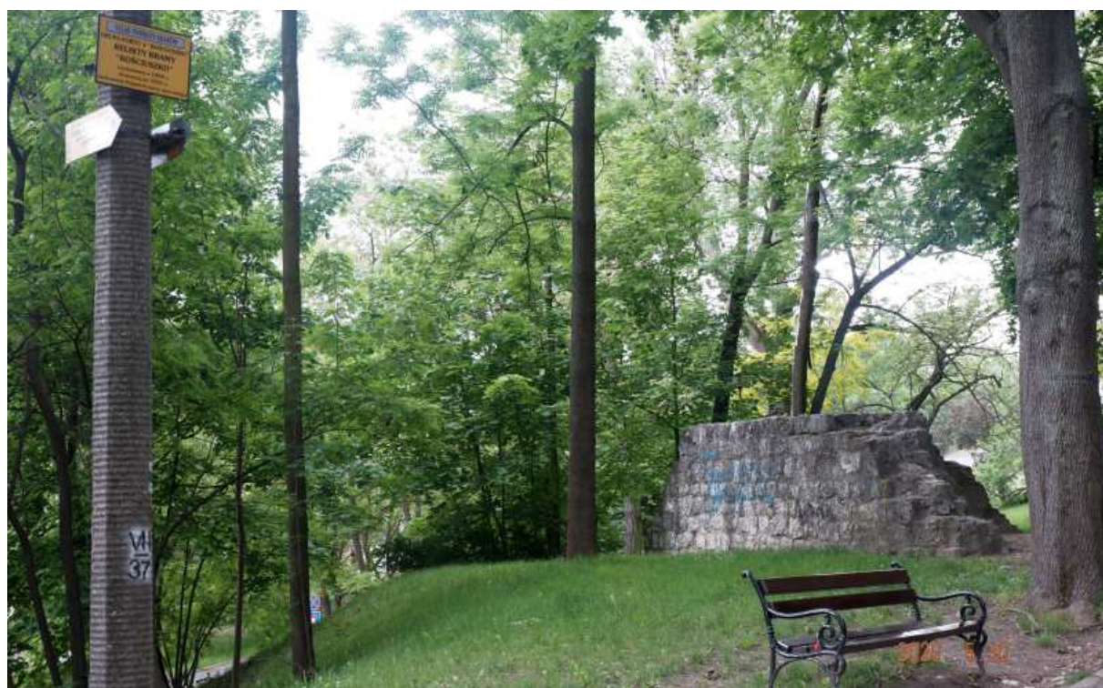
Fot. nr 212. Marne pozostałości po bramie Kościuszko przy alei Waszyngtona.
