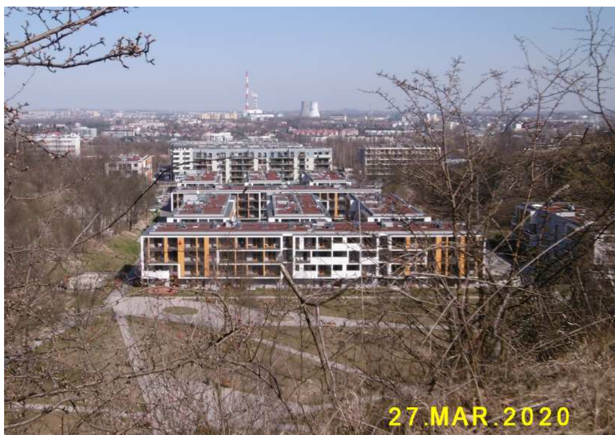
Fot. nr 320 (320-321). „Osiedle koncentracyjne” przy ulicy Wielickiej 57.
