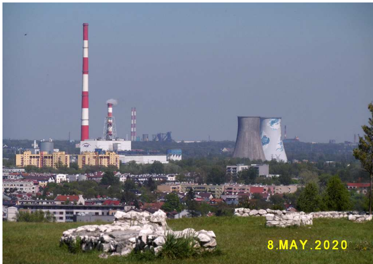
Fot. nr 317. Kominy elektrociepłowni w Łęgu.
