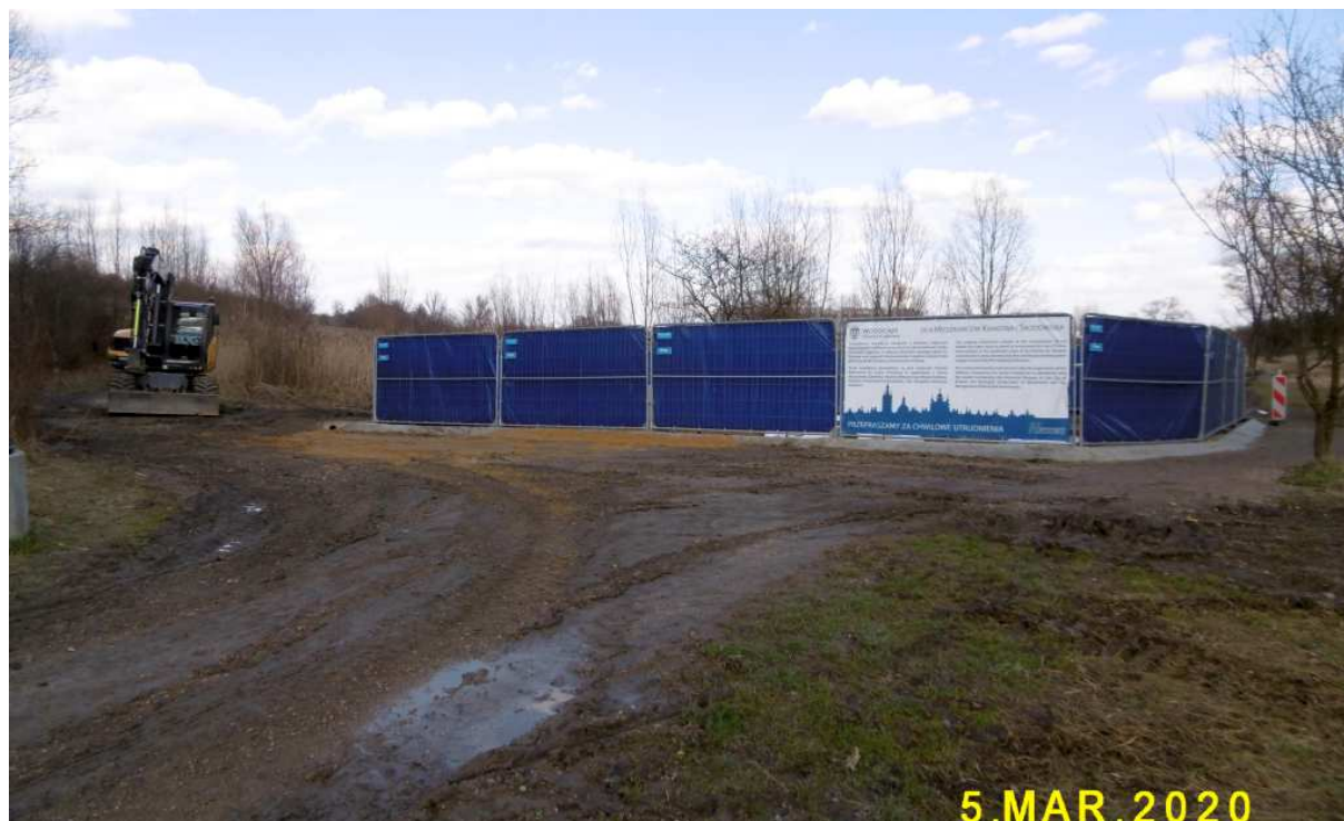
Fot. nr 373 (373-374). Przekopywania magistrali wodociągowej wzdłuż ulicy Abrahama.
