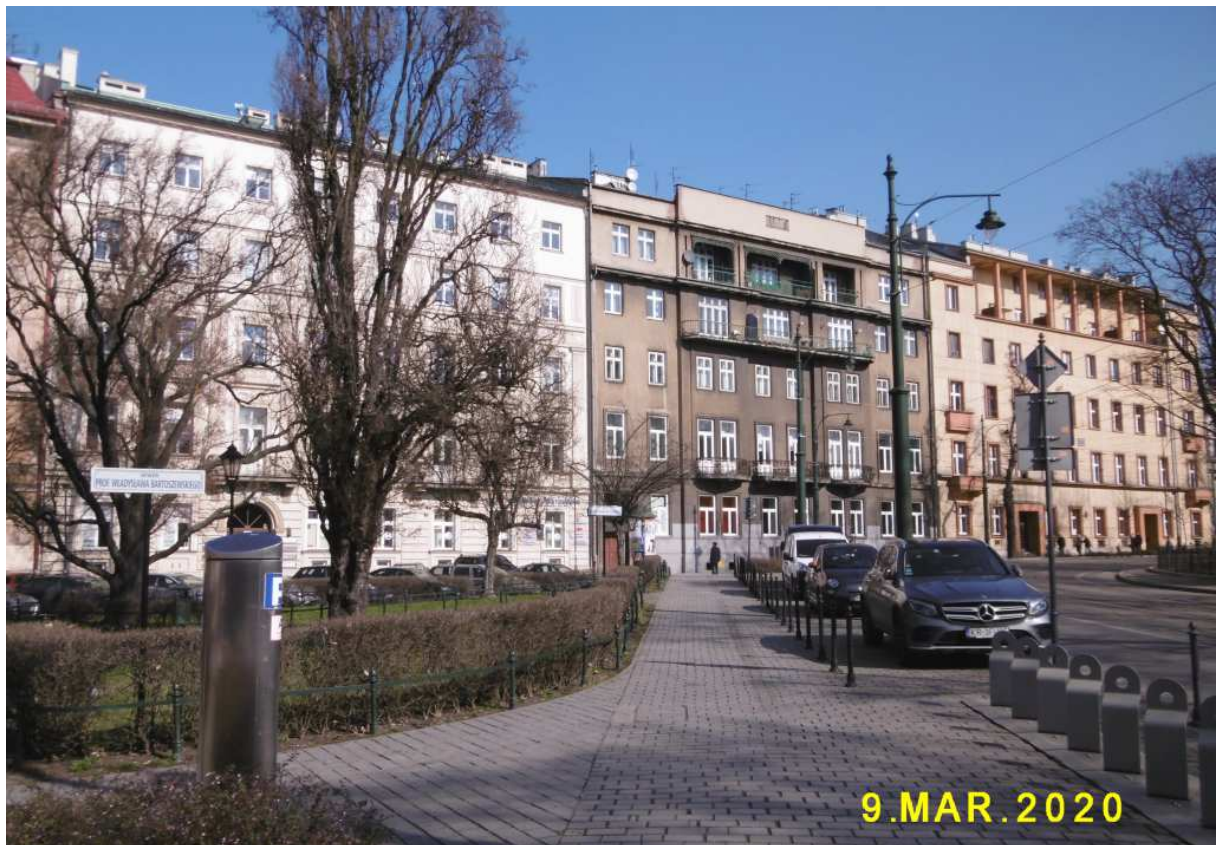
Fot. nr 107. Fragment międzywojennej zabudowy ulicy Basztowej o numerach: 4-10.
