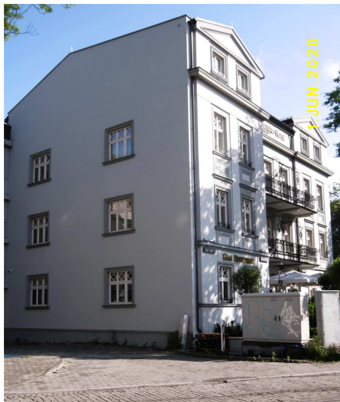
Fot. nr 139. Po dawnej willi zostały tylko zewnętrzne ściany – wnętrze zostało wyprute.
