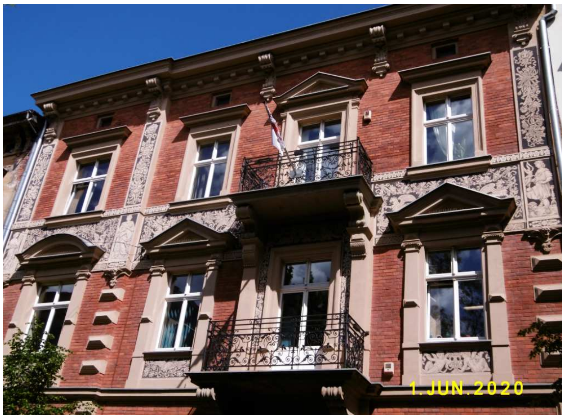
Fot. nr 87 (87-88). Niedawno odnowiona dekoracja sgraffitowa.
