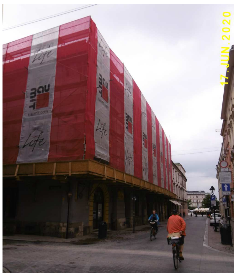
Fot. nr 38. Trwa remont hotelu Saskiego przy ulicy Sławkowskiej 5/7.
