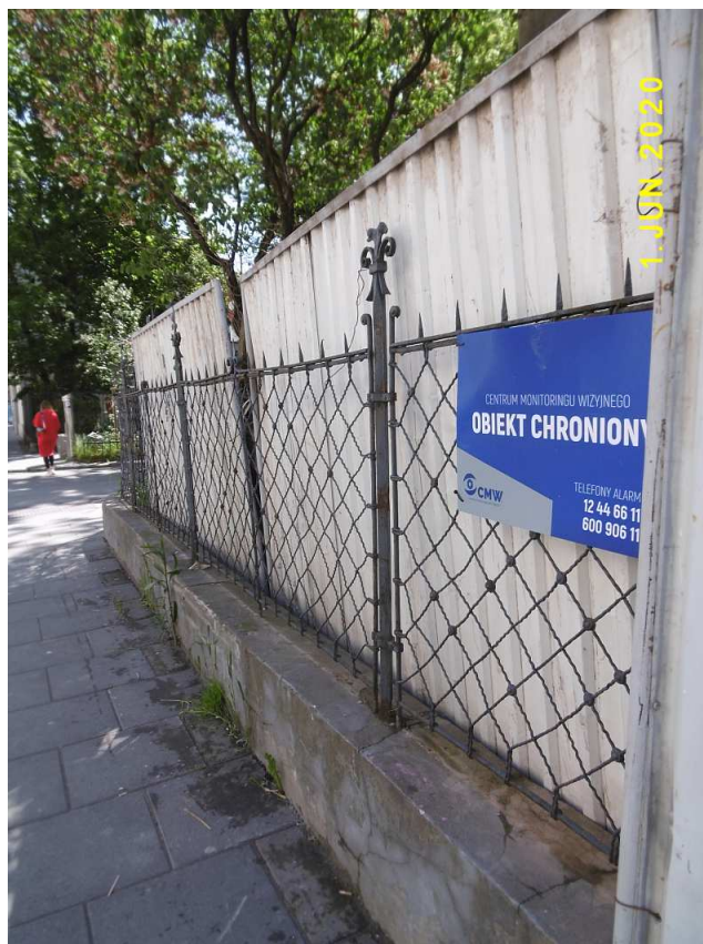
Fot. nr 128. Po dawnej, secesyjnej willi dr Kupczyka, która stała tu do połowy lat 30. zeszłego wieku, zostało tylko ogrodzenie. Ciekawe czy przetrwa?
