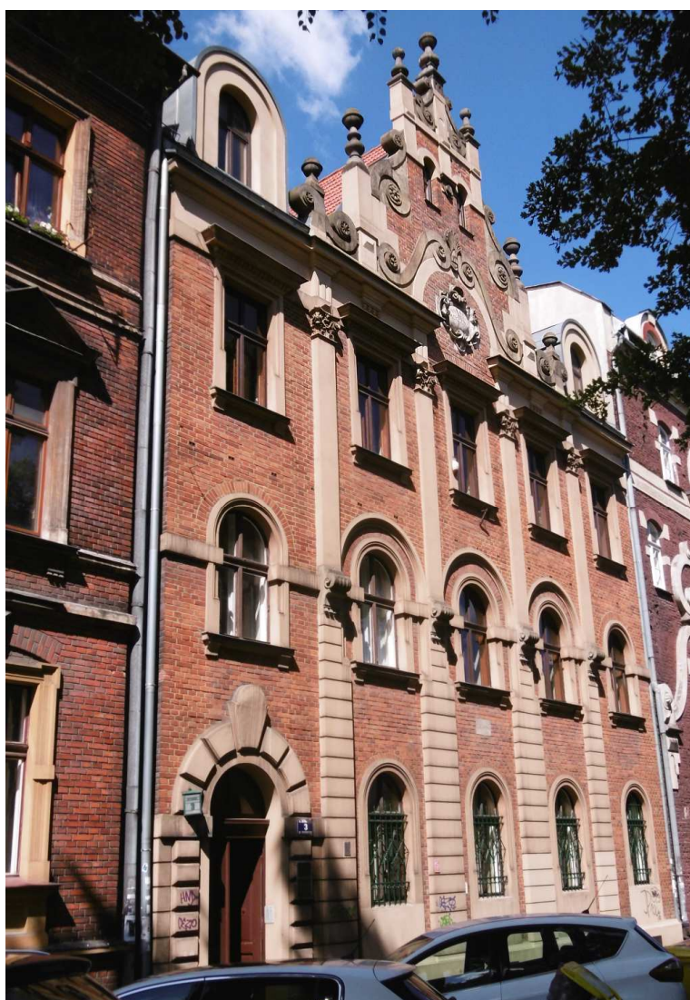
Fot. nr 154 (154-155). Kamienica pod nr 3, która powstała w roku 1891.
