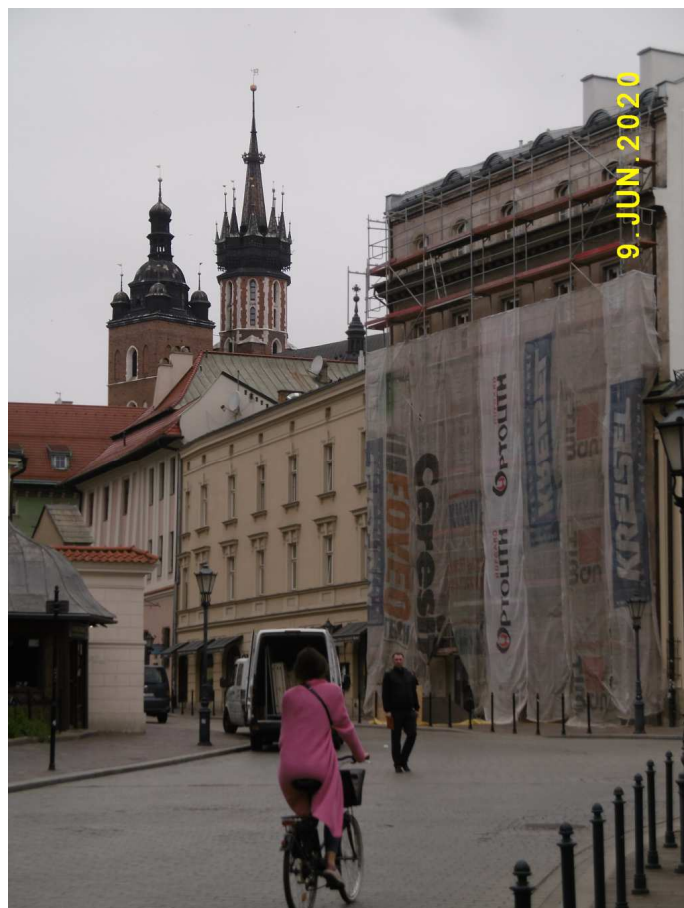
Fot. nr 9 (9-10). Końcowy fragment ulicy. Trwa remont kamienicy pod nr 14.
