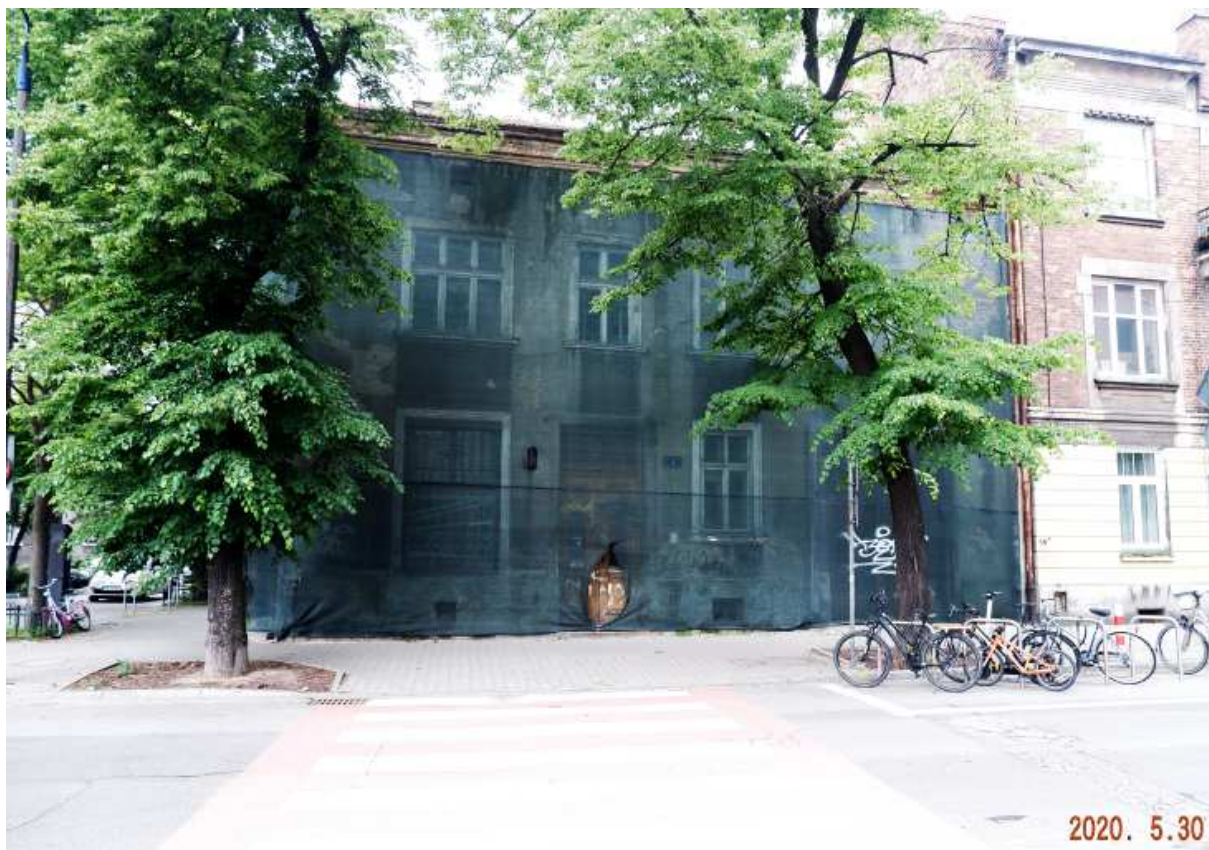
Fot. nr 199a. Co w najbliższym czasie powstanie w miejscu tej kamieniczki z ulicy Senatorskiej 5, w której w czasach PRL od strony ulicy Filareckiej 1 mieściła się wytwórnia wód gazowanych Jaworskiego?
