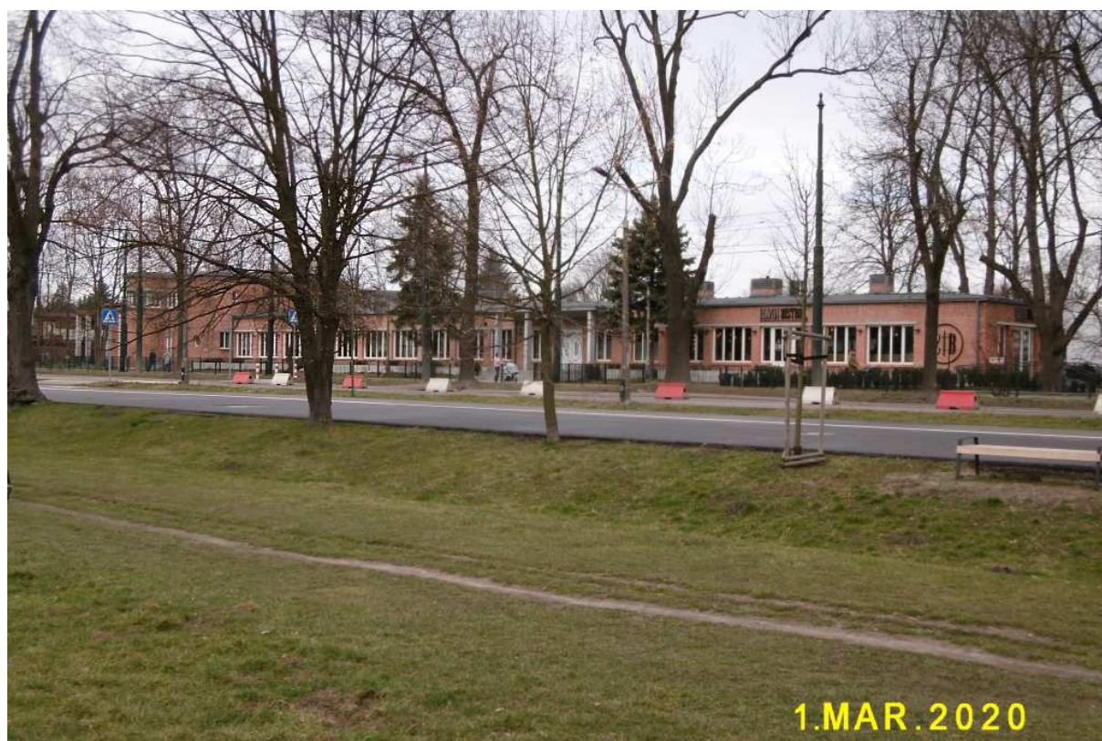
Fot. nr 168 (168-170). Na plus Comarchu trzeba oddać wierną restaurację budynków gospodarczo-mieszkalnych dawnego kompleksu trzech basenów.
