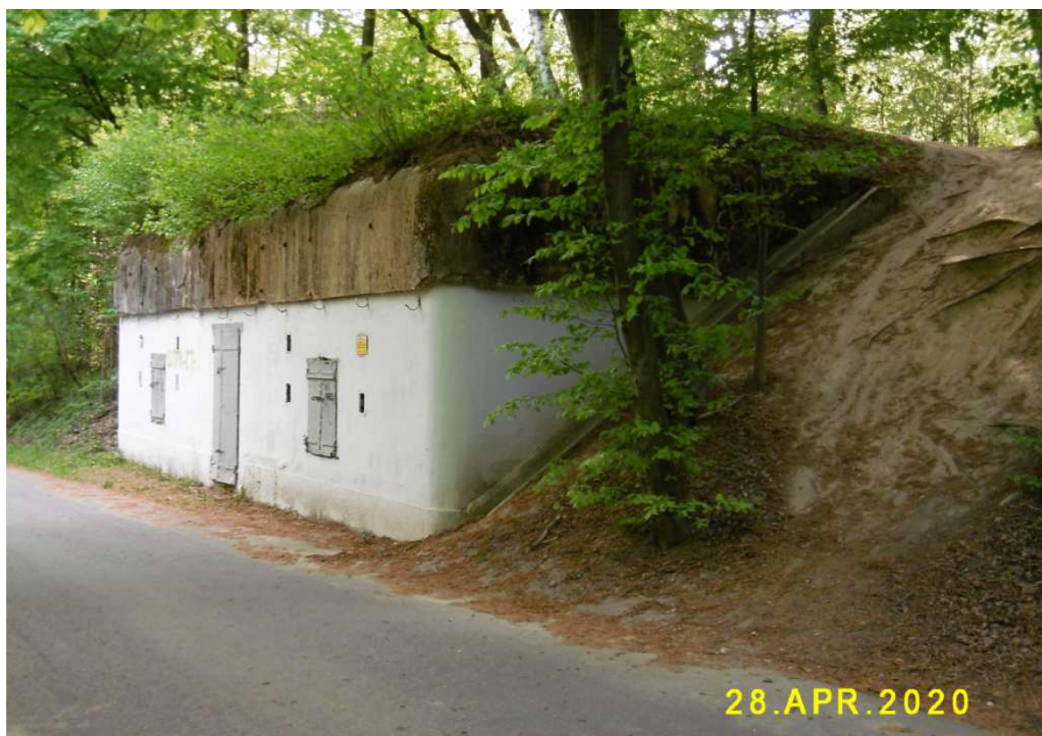
Fot. nr 238. Schron amunicyjny z czasów Twierdzy Kraków na szczycie Ostrej Górze.
