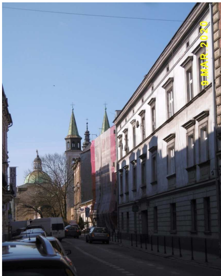
Fot. nr 104. Fragment zabudowy powyżej nr 7.
