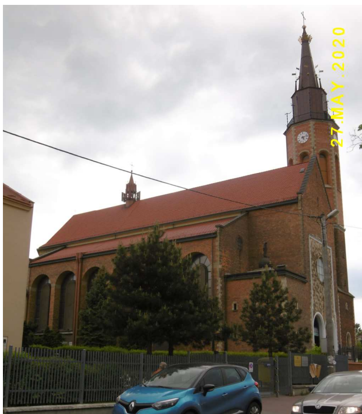
Fot. nr 442. Kościół parafialny przy ulicy Prostej po zakończeniu prac związanych z budową wieży.
