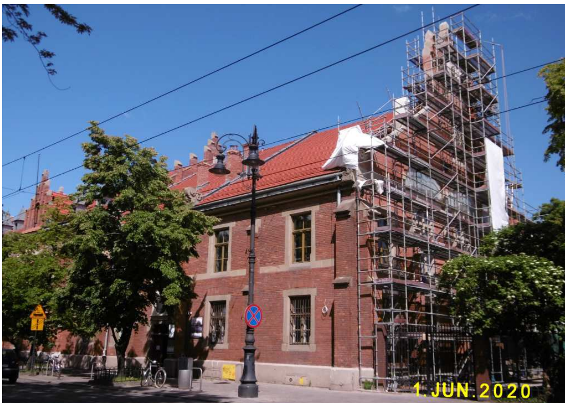
Fot. nr 73 (73-74). Sciana szczytowa Sokoła w trakcie kolejnej renowacji.
