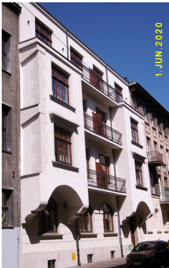
Fot. nr 53. Modernistyczna kamienica pod nr 5.
