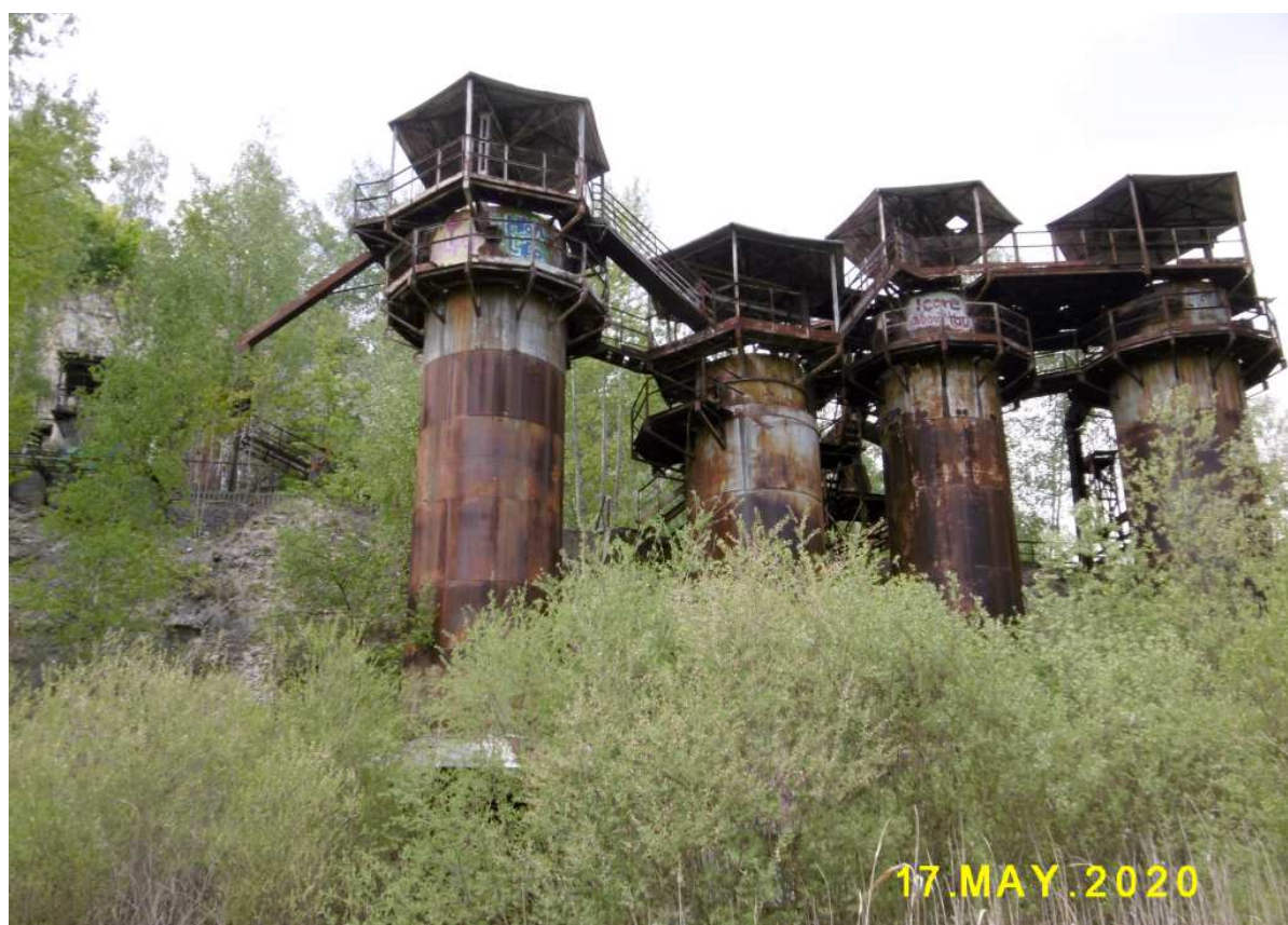
Fot. nr 340 (340-343). W niecce dawnego kamieniołomu Libana. Fot. nr: 340-341 – pozostałości instalacji przeróbczej skały wapiennej.
