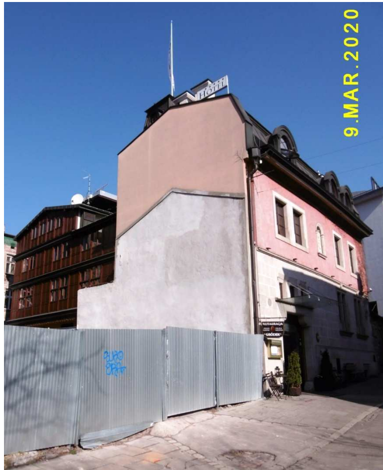
Fot. nr 7. Pusta po przestrzeń po wyburzonym domu pod nr 5. Co tu powstanie?
