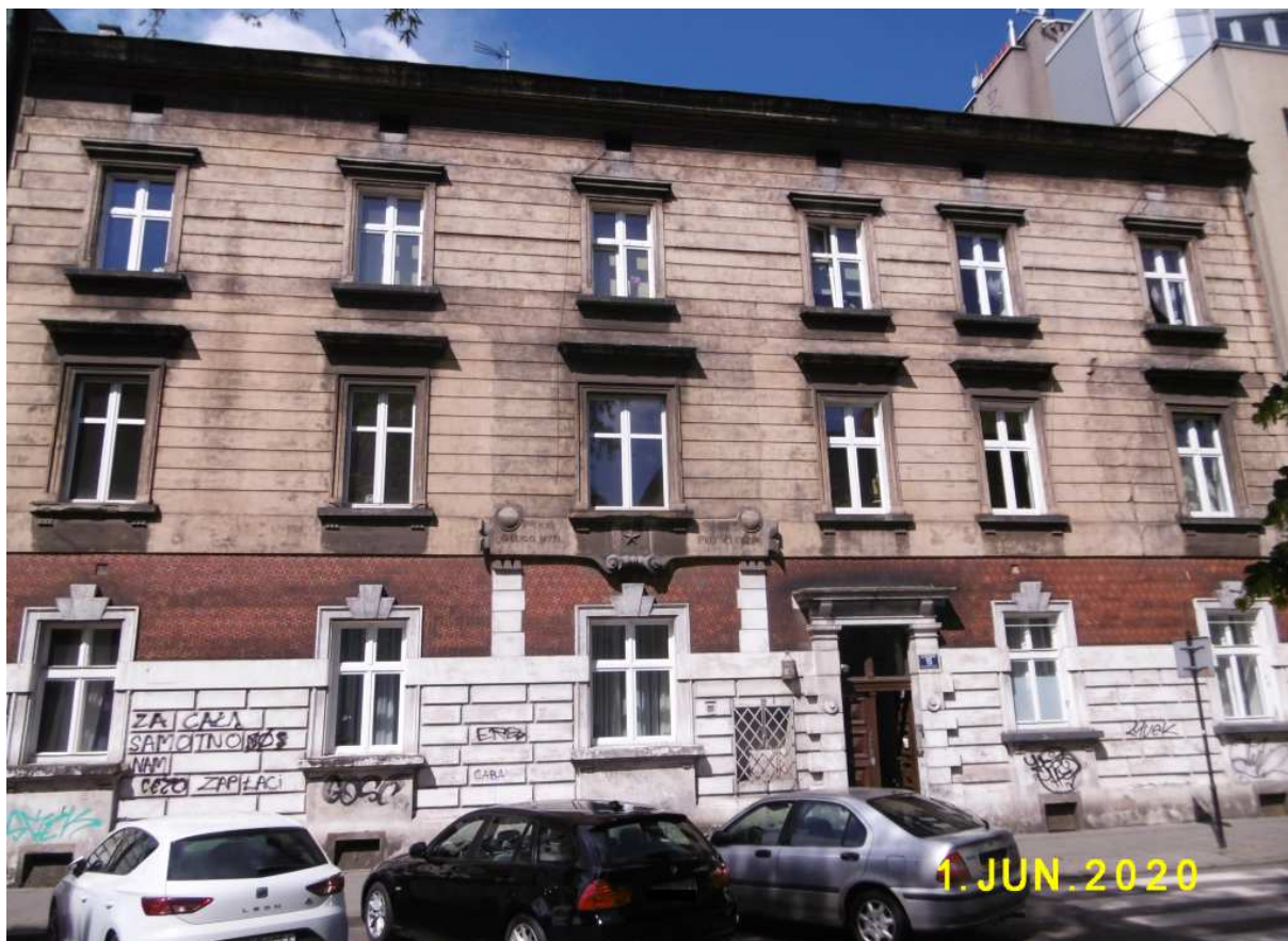
Fot. nr 145 (145-158). Galeria kamienic autorstwa Teodora Talowskiego wzdłuż ulicy Retoryka. Tu kamienica pod nr 19: „Długo myśl - prędko czyn”.
