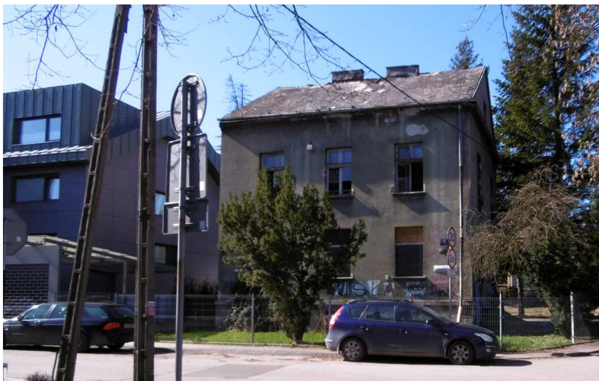
Fot. nr 231. Przedwojenny dom z ulicy Tondosa 10 na etapie remontu bądź przebudowy.
