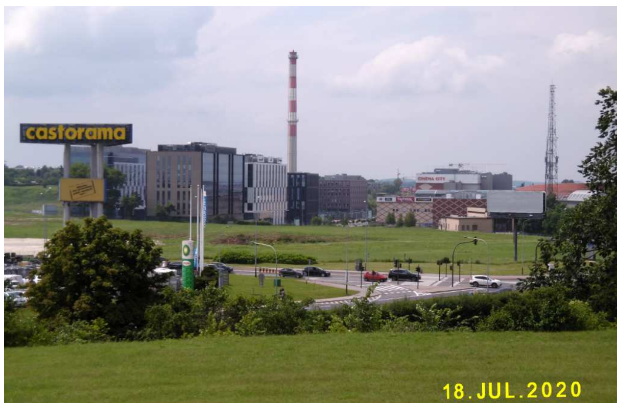
Fot. nr 139. Stale rozbudowujący się kompleks biurowy przy CH Bonarka.
