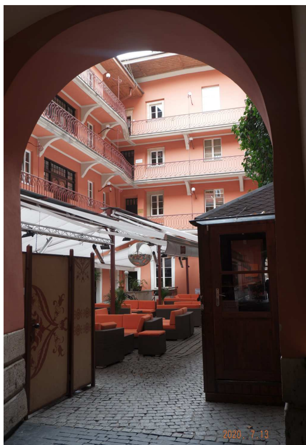
Fot. nr 77. Dziedziniec Szarej Kamienicy pod nr 6.
