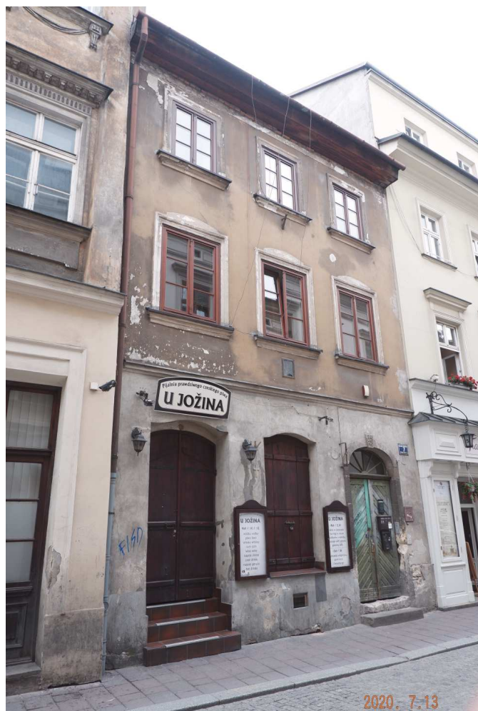
Fot. nr 46. Kamieniczka przy ulicy św. Tomasza 7.
