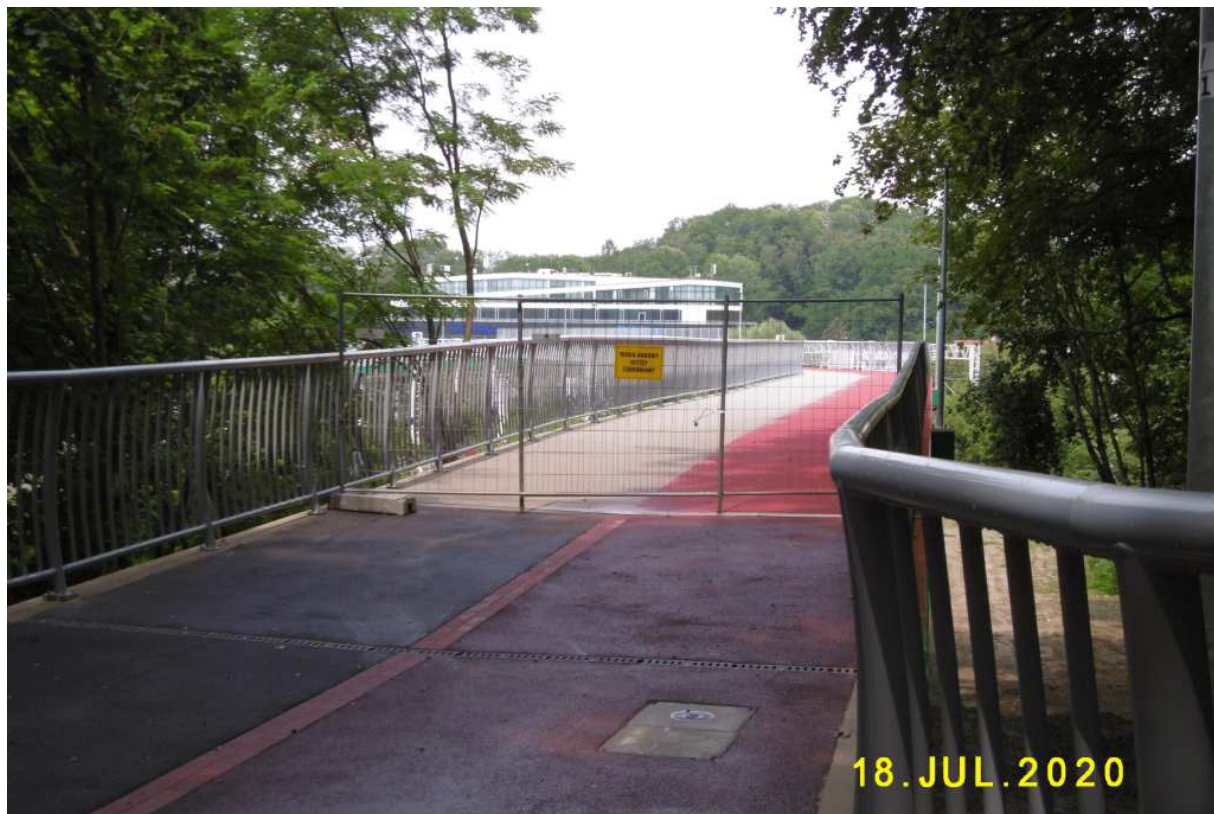
Fot. nr 130 (130-131). Niemal gotowa kładka pieszo-rowerowa ponad torami kolejowymi w sąsiedztwie ulicy Kamieńskiego.
