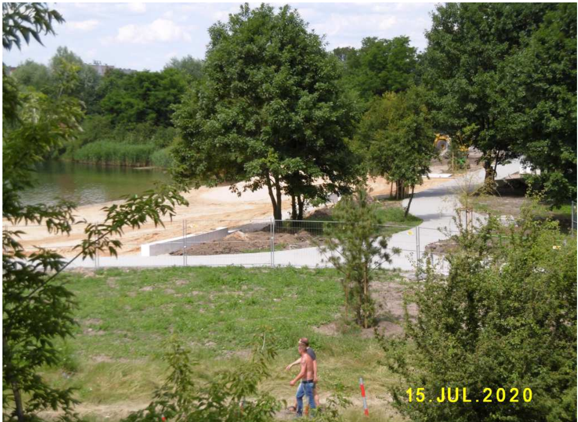
Fot. nr 162 (162-165). „Rewitalizacja” dzikiej plaży przy ulicy Bagrowej, gdzie tempo prac przypominało strajk włoski. Była zamknięta do użytku niemal dopołowy sierpnia, co musiało budzić powszechne niezadowolenie. Po zakończeniu prac będzie tu więcej betonu.
