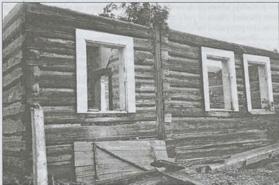
Maniowy, rozbiórka domu Nr 22 - wrzesień 1987 r.
