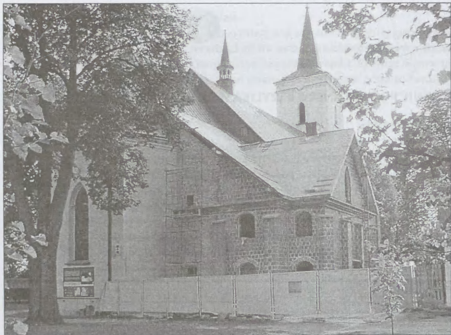
Budowa nowej zakrystii
