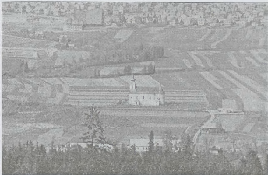
Widok kościoła w Maniowach przed wyburzeniem, w tle zabudowa Nowych Maniów - lipiec 1993 r.
