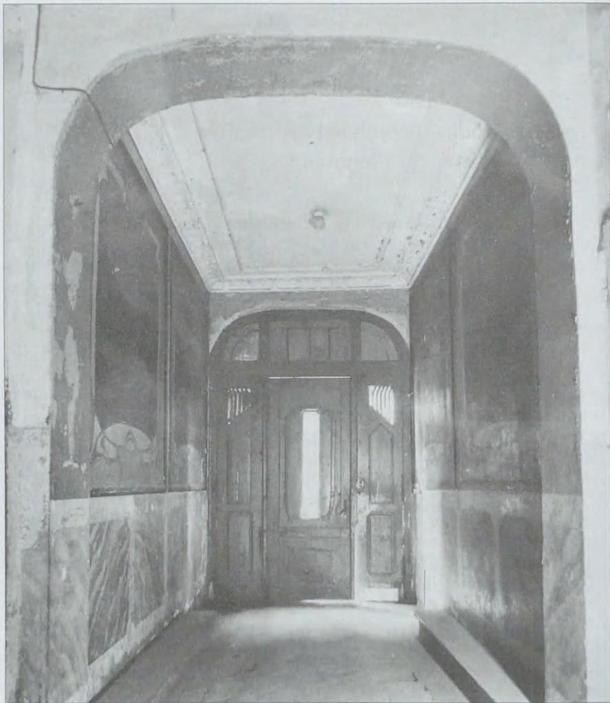
Sień kamienicy z malowidłami pienińskimi
