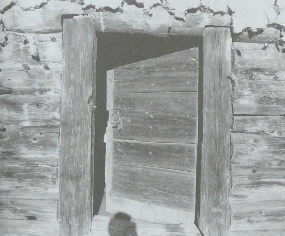
Kacwin. Drzwi sypańca. Wokół nich widoczne kołeczki i resztki gliny.
