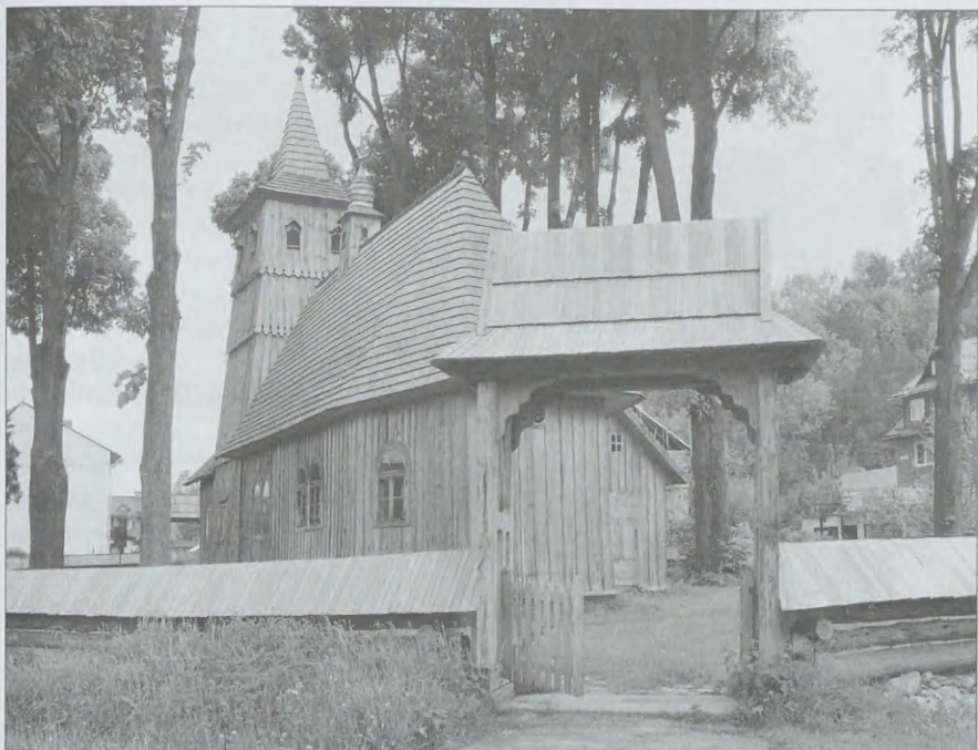
Kościółek po remoncie
