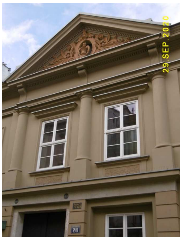
Fot. nr 12. Tympanon i półkolumny pośrodku fasady.
