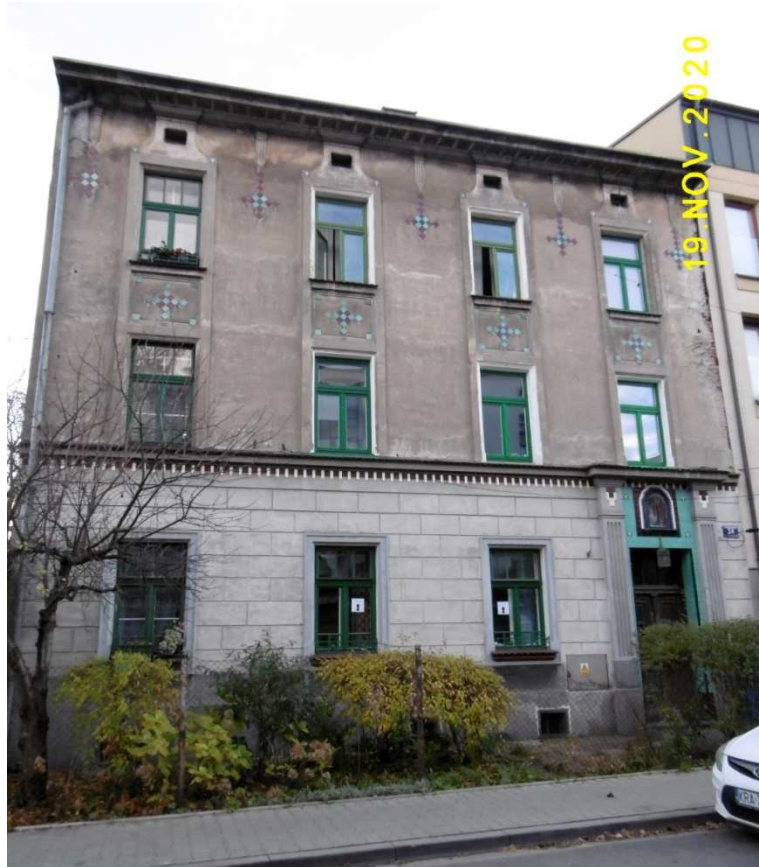
Fot. nr 123 (123-125). Modernistyczna w swym kształcie kamienica pod nr 34.
