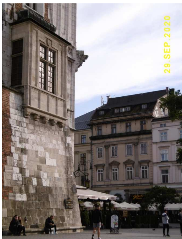
Fot. nr 32. Ciągłe zaniedbana kamienica pod nr 22.
