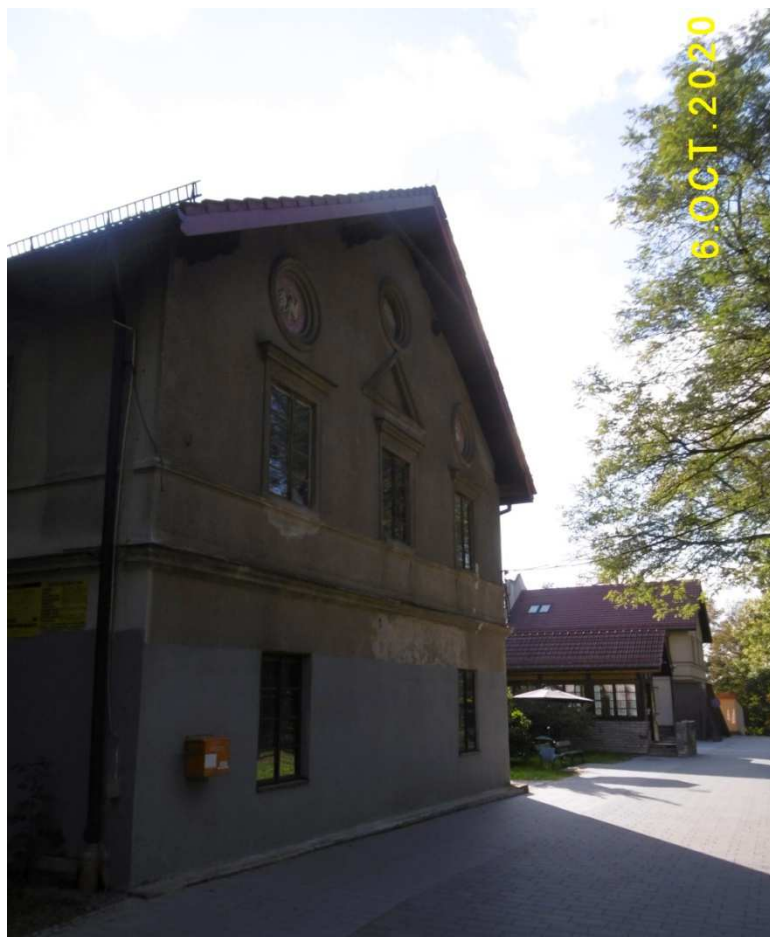
Fot. nr 384 (384-386). Środkowy fragment budynku.
