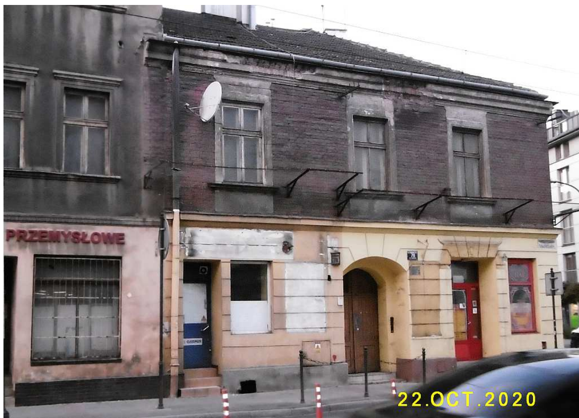
Fot. nr 153 (153-158). Zabudowa fragmentu ulicy Kalwaryjskiej powyżej ulicy Śliskiej. Tu dom pod nr 70.
