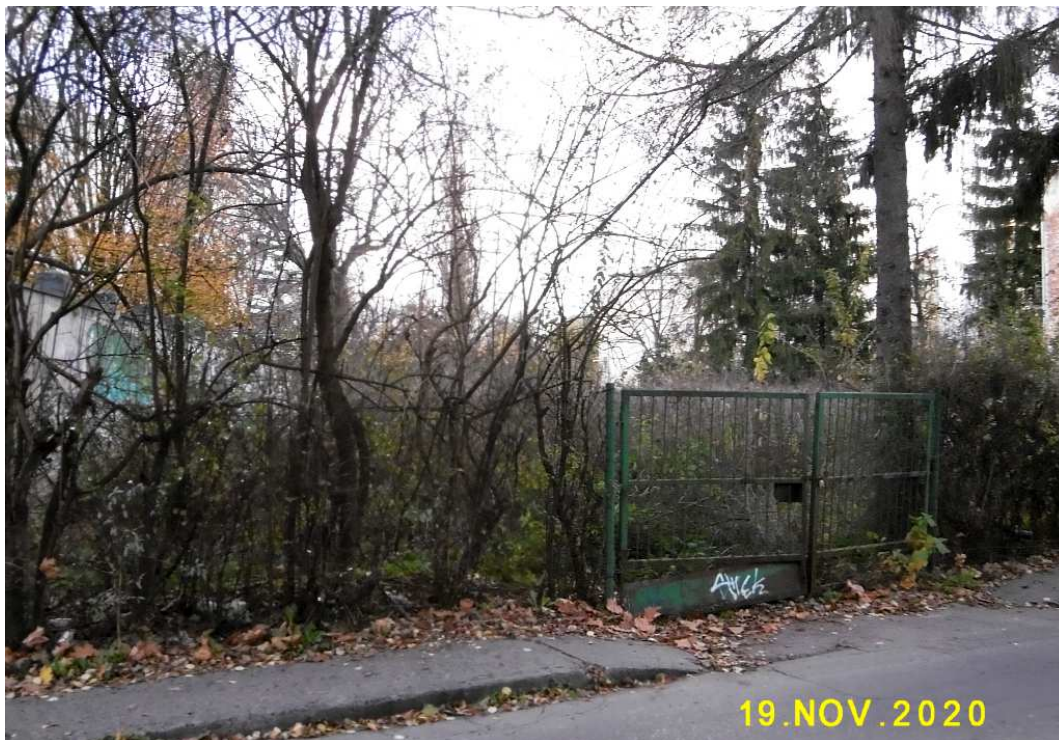
Fot. nr 134. Pusta przestrzeń po wyburzonym domu parterowym przy Bocznej 11.
