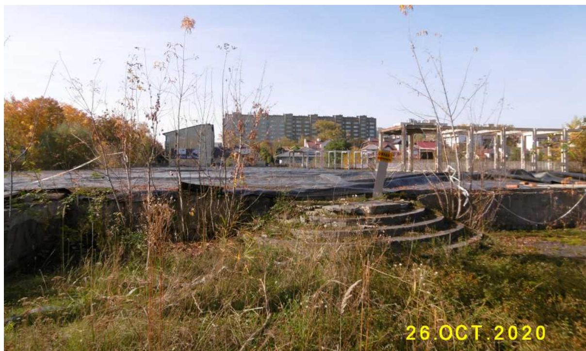
Fot. nr 75 (75-76). Pozostałości po dawnym hipermarkecie „Gigant” pod nr 6, który spłonął na początku lat 90. zeszłego wieku.
