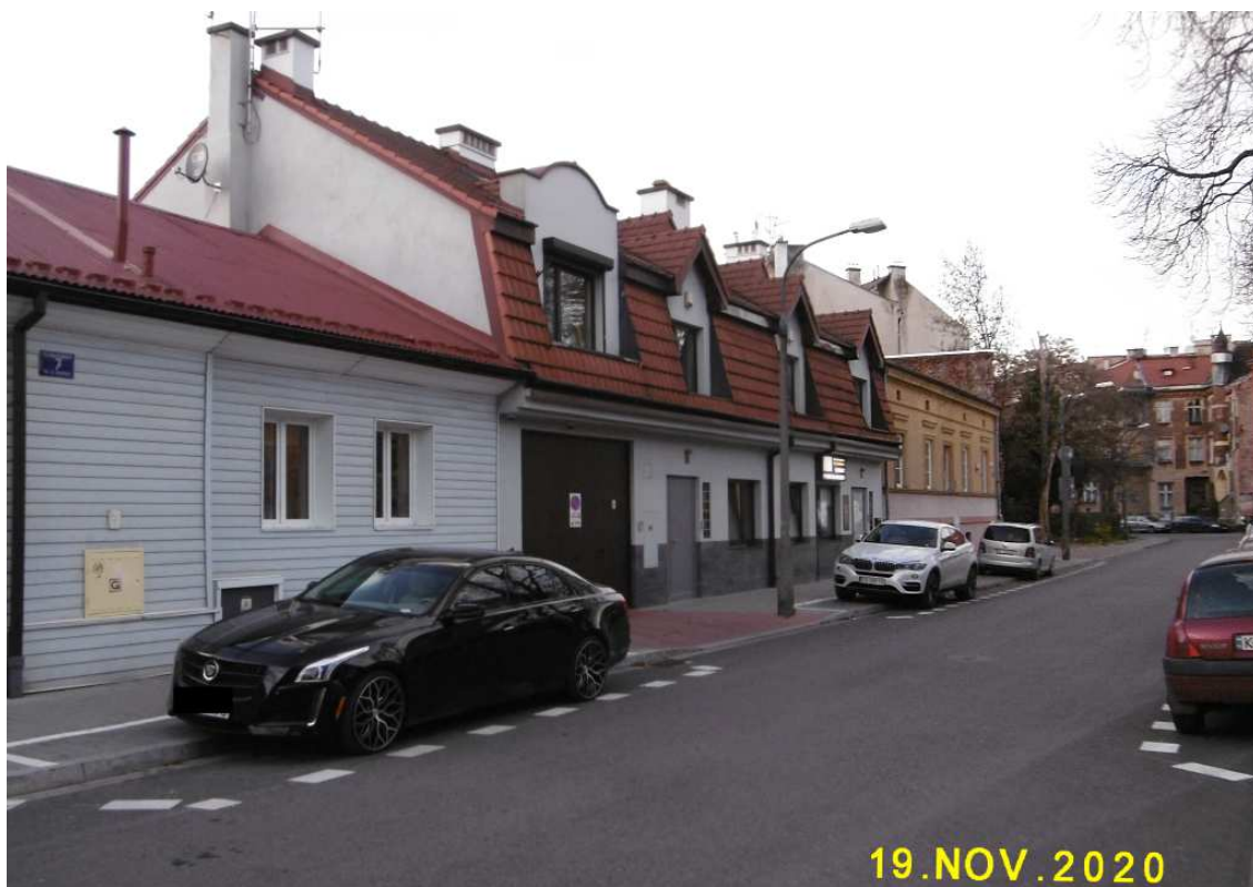
Fot. nr 104. Fragment niskiej zabudowy poniżej numeru 7.
