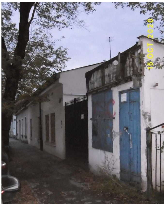
Fot. nr 185 (185-186). Dom pod nr 24 i przylegający do niego dawny obiekt handlowy.
