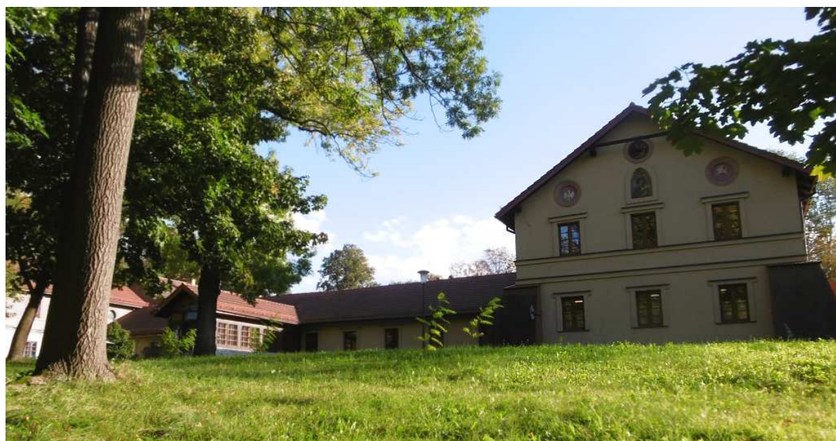
Fot. nr 387 (387-391). Prawe skrzydło.
