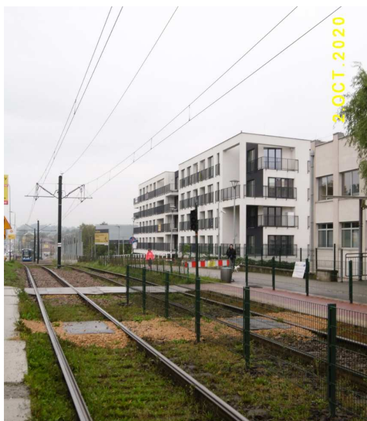
Fot. nr 226. Zabudowa ulicy Wadowickiej poniżej budynku ZUS pod nr 33.
