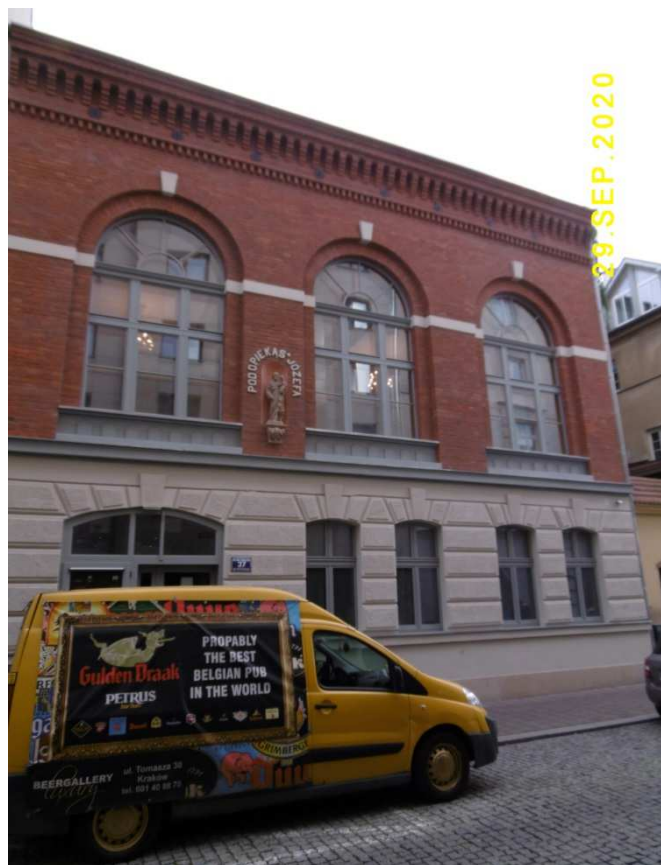
Fot. nr 6 (6-7). Odnowiona kamienica pod nr 37 i jej detale.
