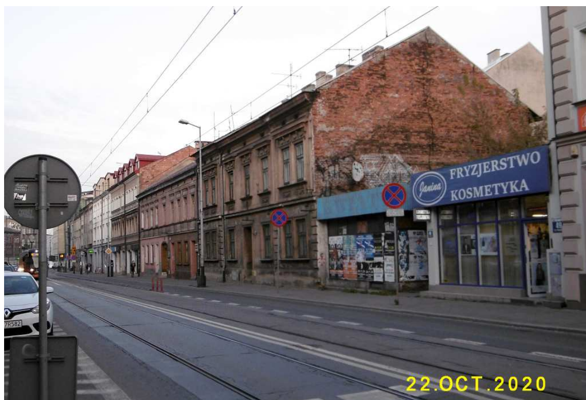
Fot. nr 151. Fragment zabudowy poniżej nr 49.
