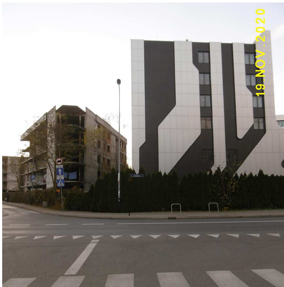
Fot. nr 112. Początkowy fragment ulicy Twardowskiego z niedokończoną od około 20 lat zabudową.
