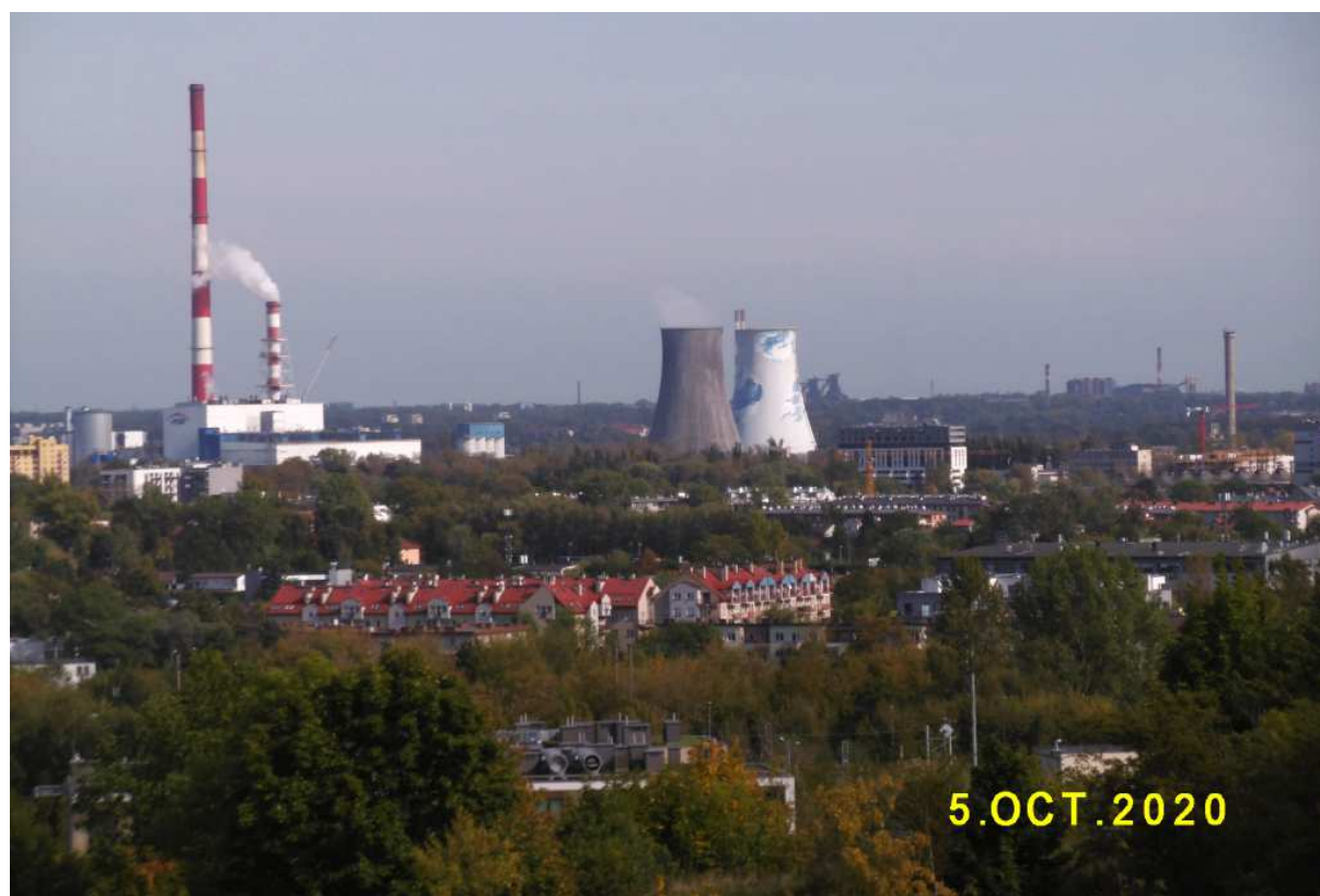
Fot. nr 192. Kominy elektrociepłowni w Łęgu, a z prawej niedymiące już kominy dawnej HiL.
