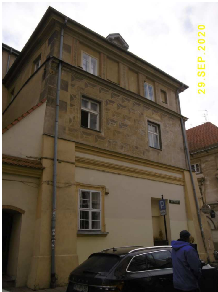
Fot. nr 8. Kamienica pod nr 35 w narożu z ulicą św. Krzyża, a w jej parterze oryginalne, ośmiopółkowe okno, typowe dla zabudowy Krakowa z połowy XIX wieku.
