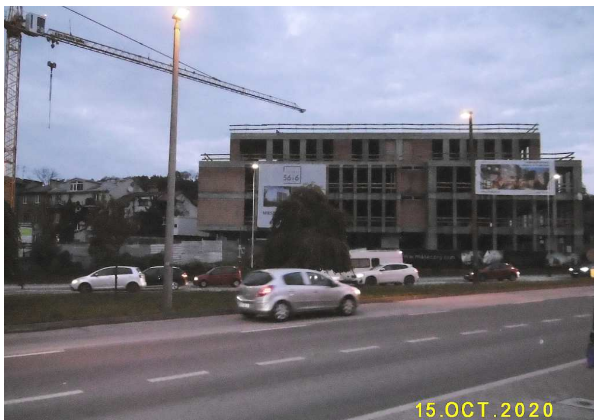
Fot. nr 164 (164-166). Nowy budynek na początku ulicy Kamieńskiego, który powstaje w miejscu wyburzonych, drewnianych willi.
