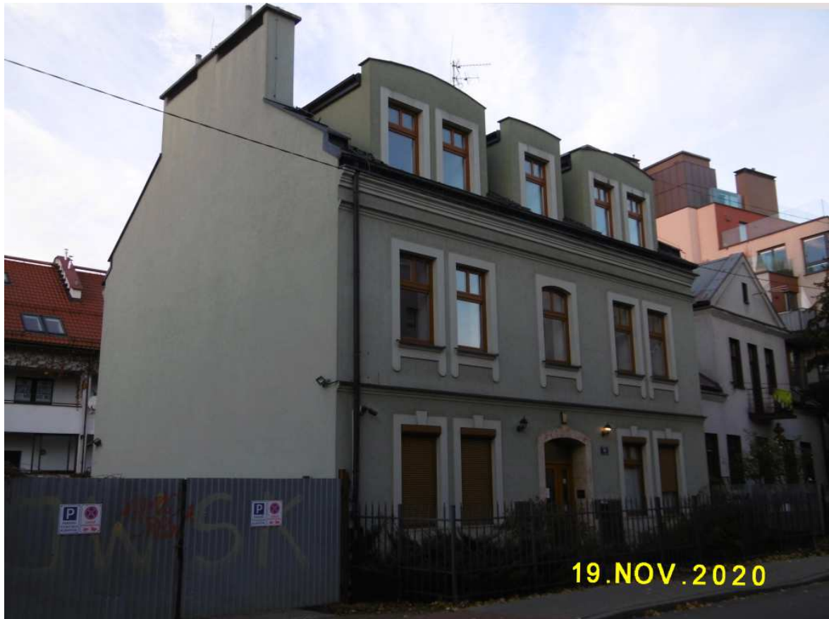
Fot. nr 128. Wyremontowana kamieniczka pod nr 41, z dobudowanym poddaszem.
