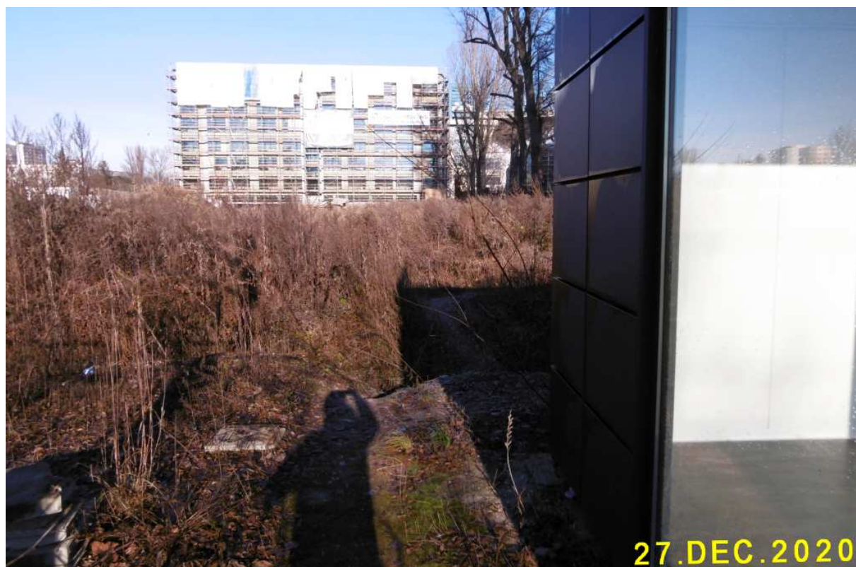
Fot. nr 12. Nowy gigant mieszkalny powstający w sąsiedztwie stadionu Wisły.
