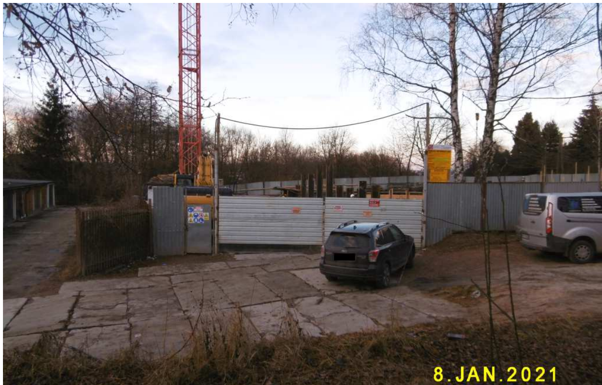
Fot. nr 228. Plac budowy w miejscu dawnego przedwojennego domu przy końcu ulicy Pierackiego.
