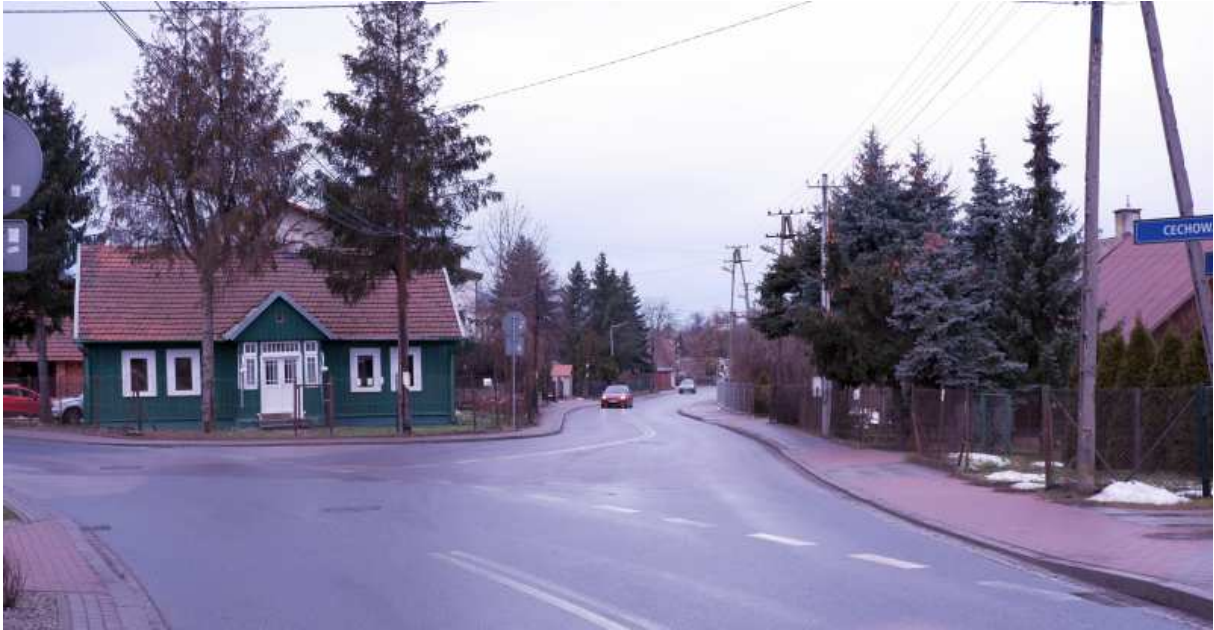
Fot. nr 342 (342-346). Drewniany dom w zagrodzie pod nr 101, zlokalizowany na cyplu utworzonym przez ulice: Łużycką i Cechową, który powstał w roku 1934. (23.01.2021)
