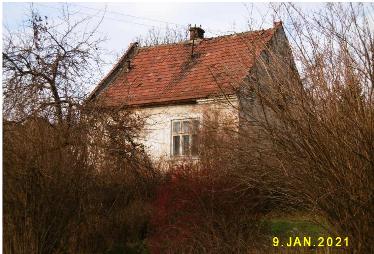
Fot. nr 485. Zapewne międzywojenny dom murowany pod nr 46.
