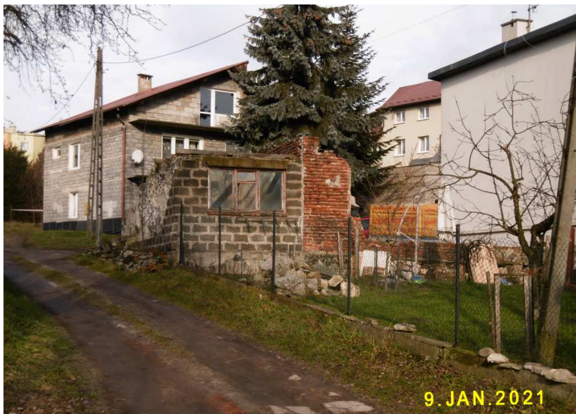
Fot. nr 482. Pozostałości po dawnej zabudowie posesji pod nr 42.
