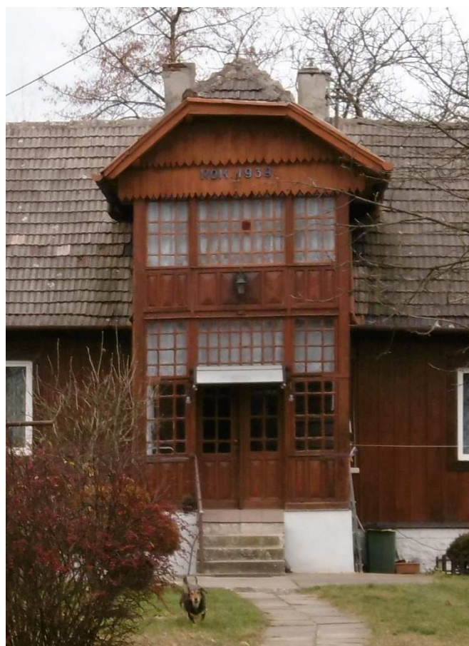
Fot. nr 225. Oszklony ganek z werandą ma piętrze, a na nim data budowy obiektu: 1939.
