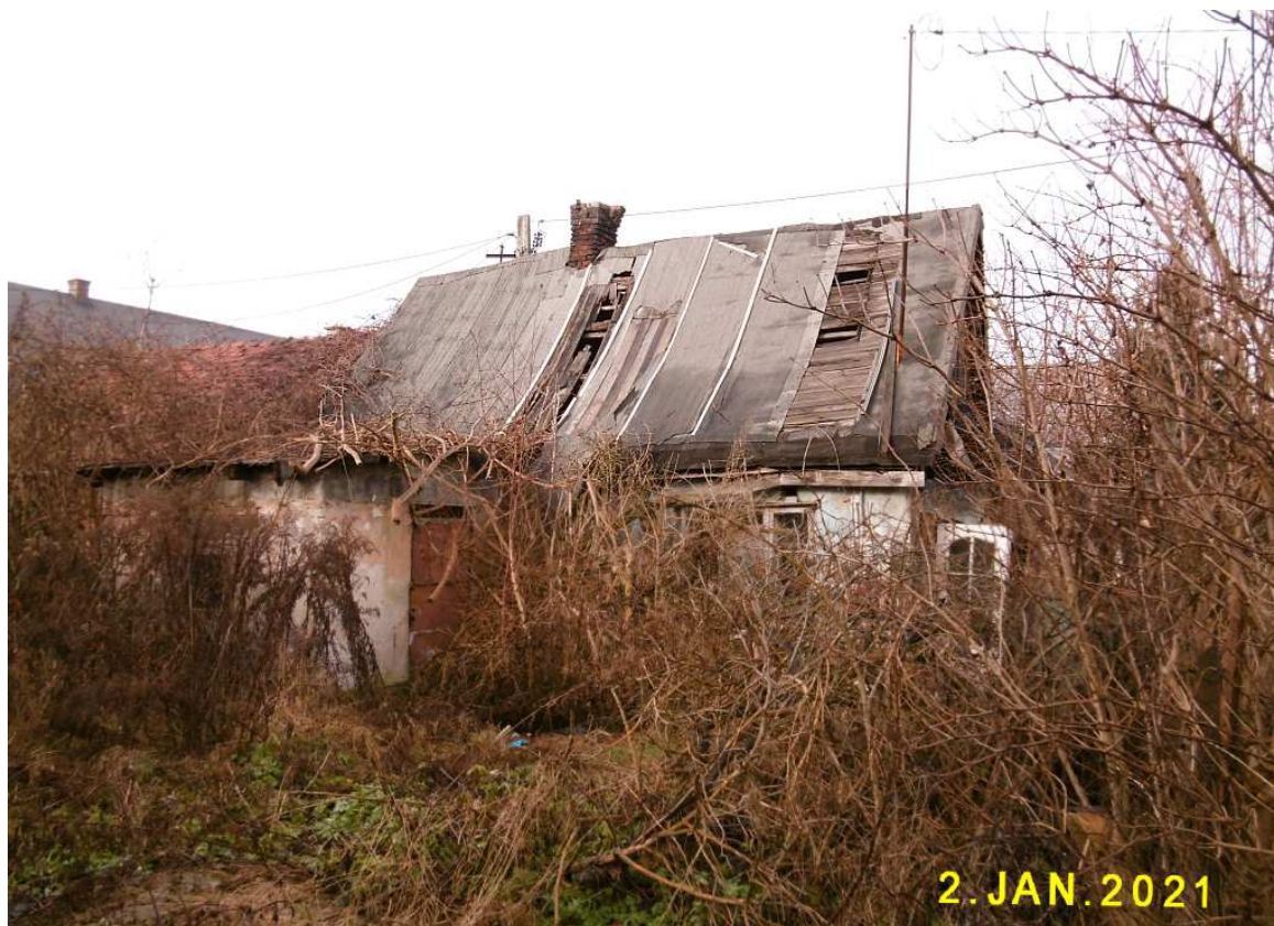
Fot. nr 103 (103-104). Ukryty pośród zarośli ok. 100-letni, murowany dom spod nr 137.
