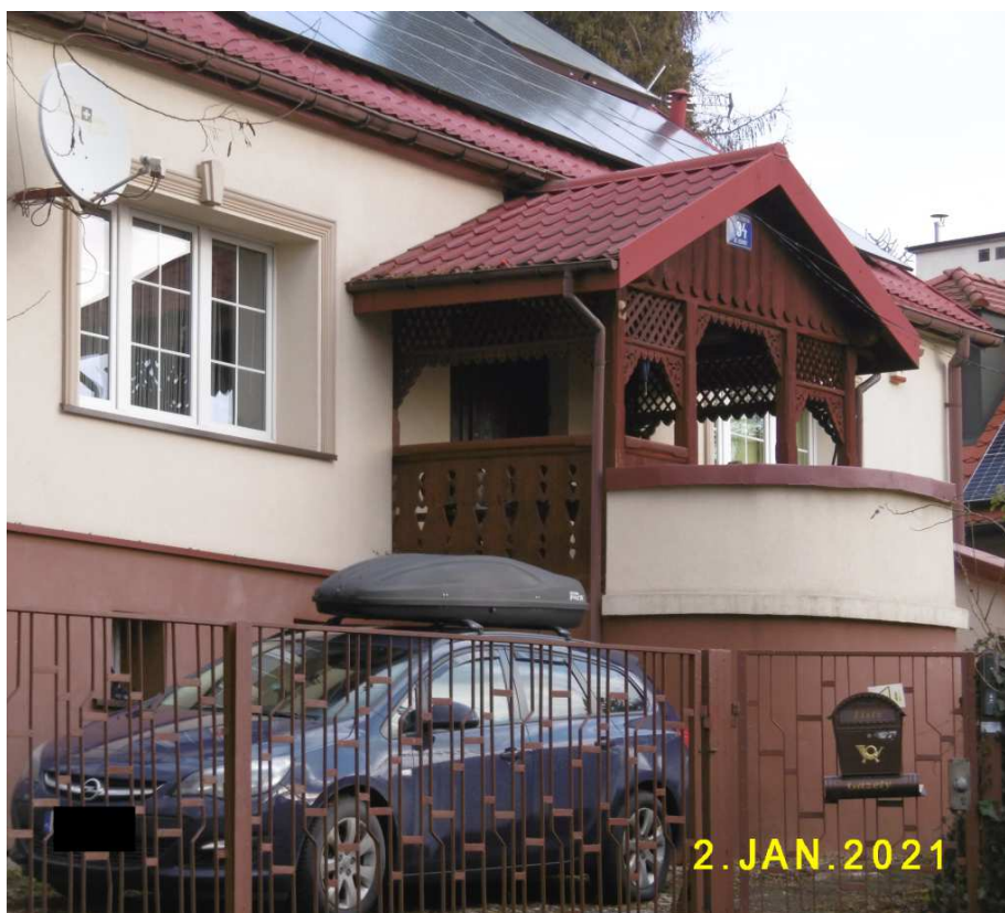
Fot. nr 63. Oryginalny, ażurowy ganek domu spod nr 34.
