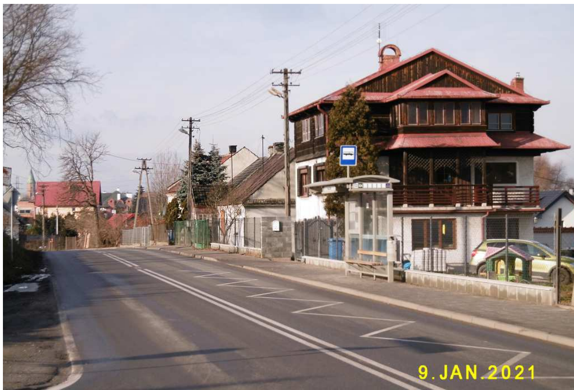
Fot. nr 295 (295-309). Wzdłuż ulicy Rzęckiej. Tu zabudowa końcowego odcinka ulicy poniżej willi o numerze 47.
