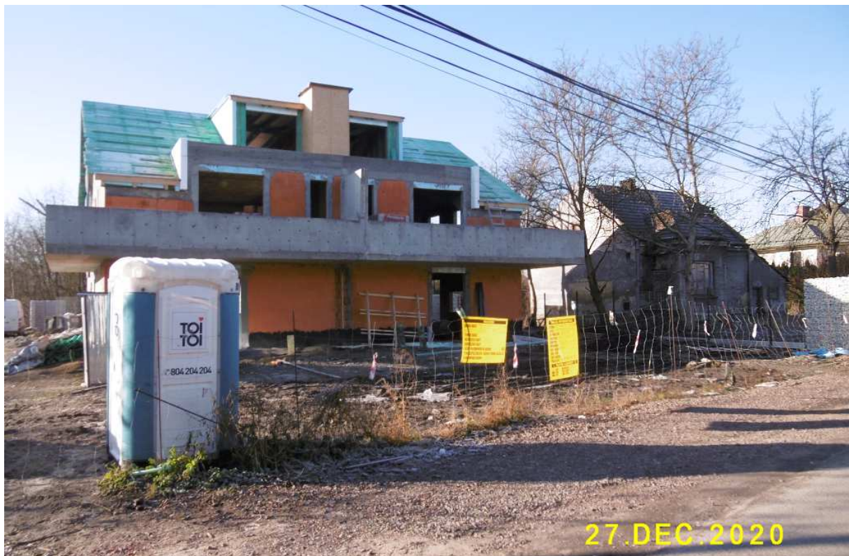
Fot. nr 30 (30-35). Wzdłuż ulicy Hamernia.
