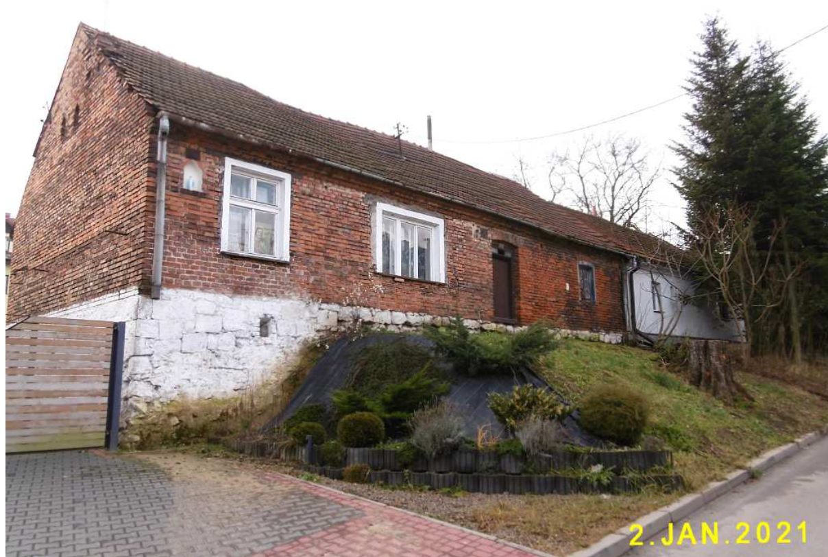
Fot. nr 78 (78-79). Kompleks przedwojennych budynków murowanych pod nr: 13 i 15.
