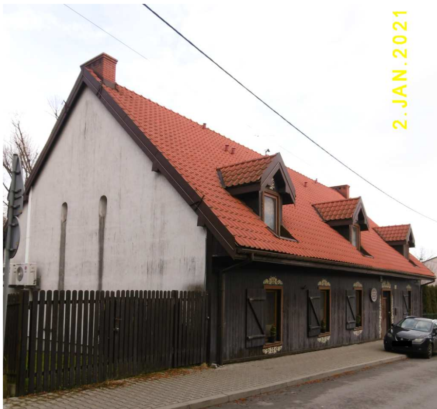
Fot. nr 74. Pensjonat Pola w zrewitalizowanym współcześnie domu pod nr 14.
