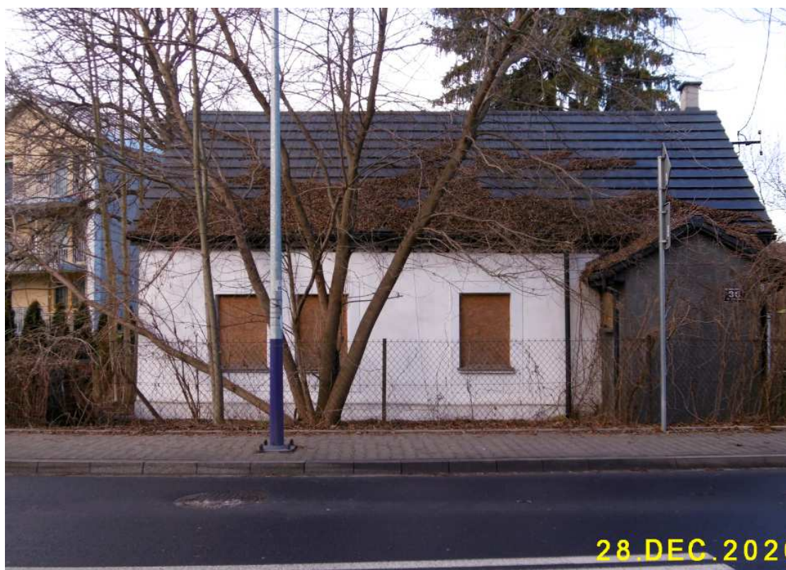
Fot. nr 179. Opuszczony od lat dom pod 36.
