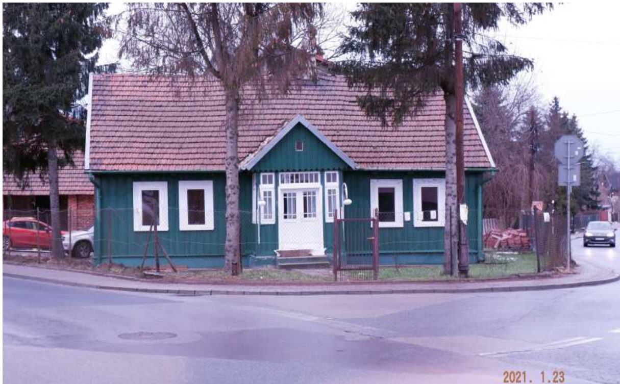
Fot. nr 343. Fasada domu na etapie remontu. Niestety drewniane okna typu ościeżnicowego zostały zamienione przez bezpodziałowe plastiki.
