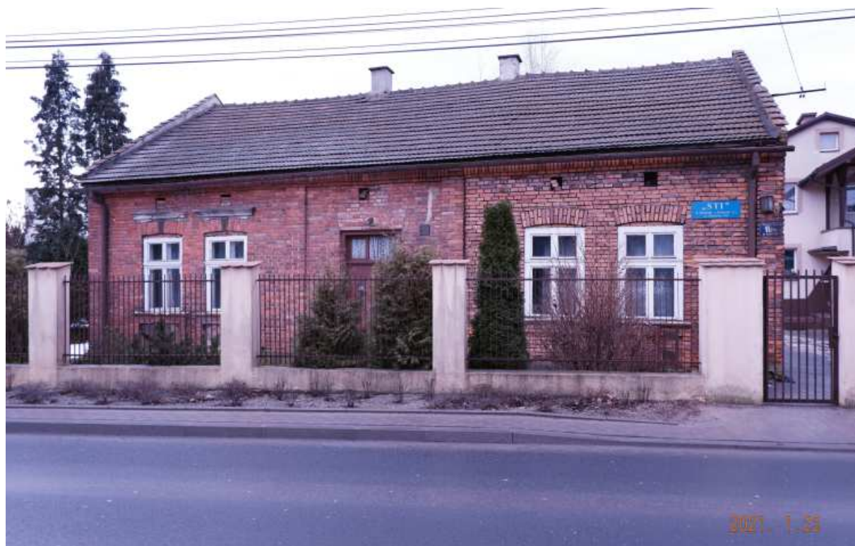
Fot. nr 351. Ceglany dom spod 104, który powstał na przełomie lat 20/30 XX wieku.
