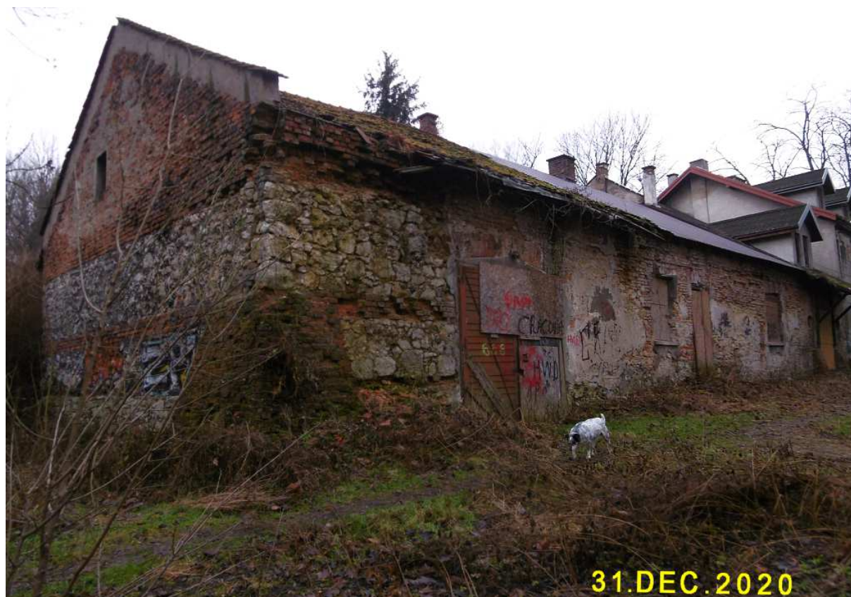
Fot. nr 212. Stara wozownia przylegająca do dworu.
