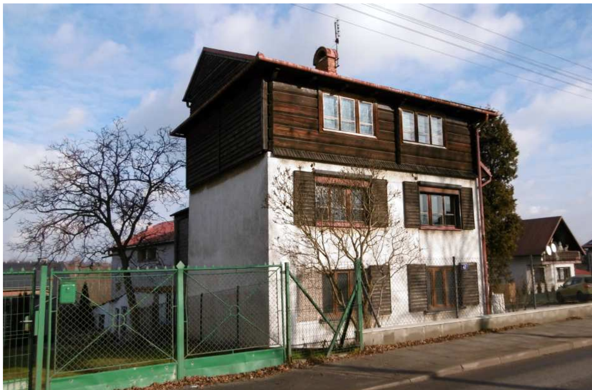
Fot. nr 297. Fasada od strony ulicy.
