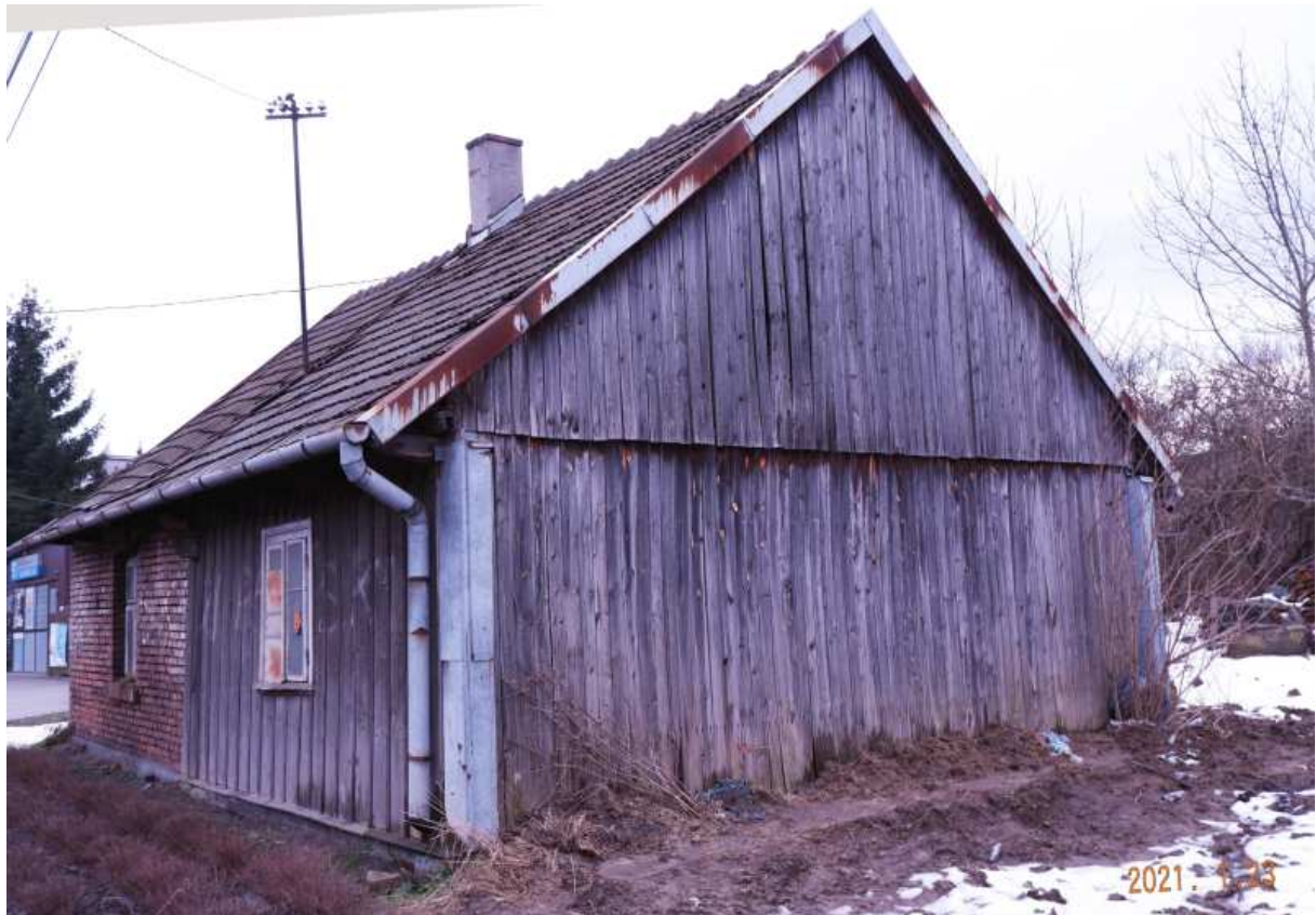
Fot. nr 339 (339-340). Oryginalna w prawym fragmencie chałupa spod nr 116, która mogła powstać nawet na przełomu XIX i XX wieku.
