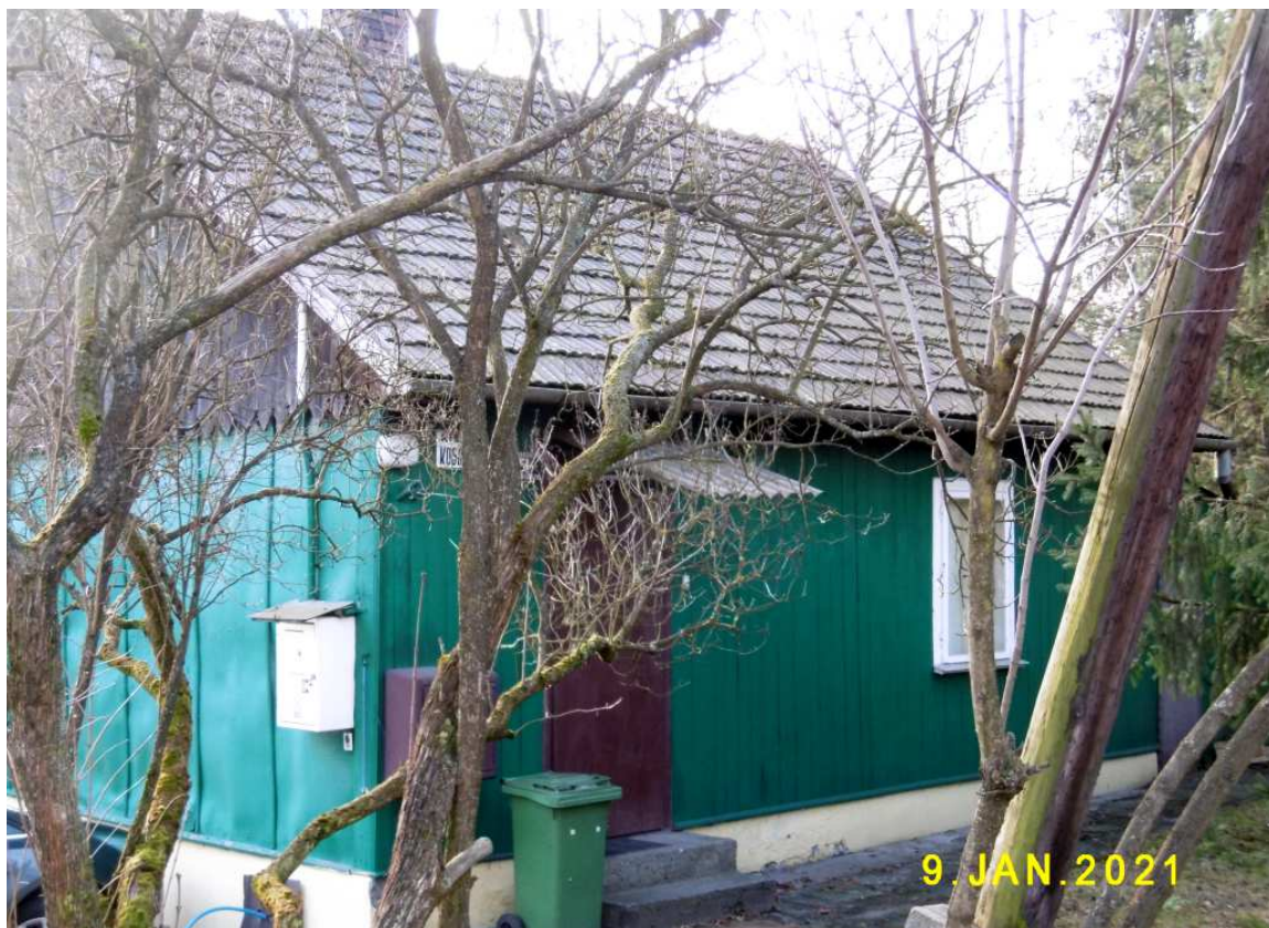
Fot. nr 486. Dom z lat 30. XX wieku spod nr 51.
