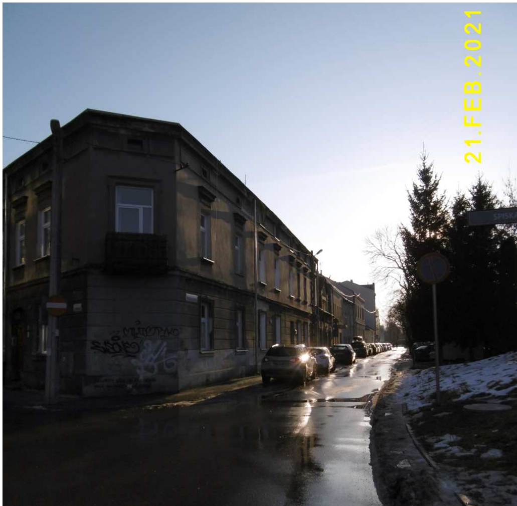
Fot. nr 162. Wzdłuż ulicy Przedwiośnie - ujęcie z ulicy Spiskiej.
