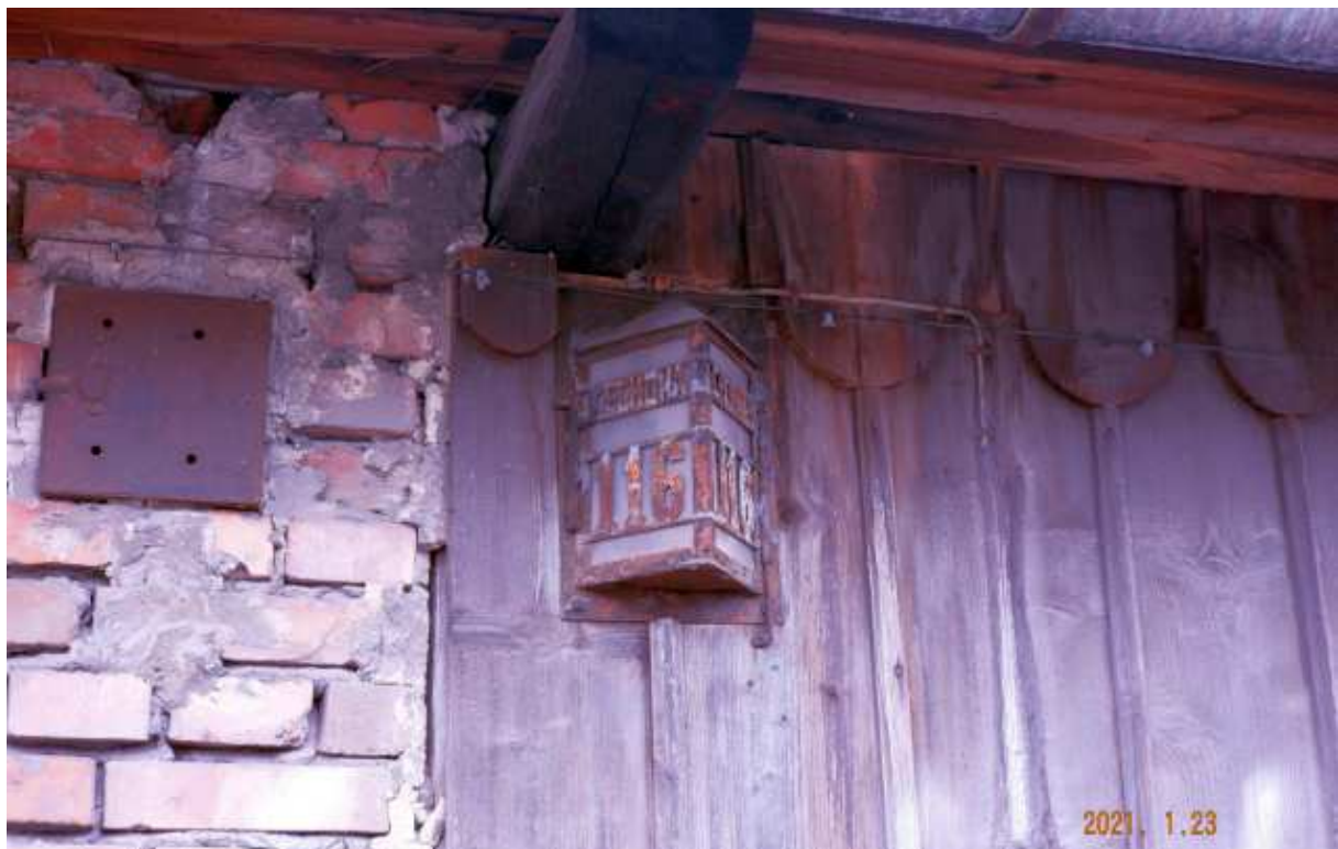
Fot. nr 340. Tzw. „latarnia policyjna” z podświetlanym numerem obiektu i detale drewnianego szalunku.
