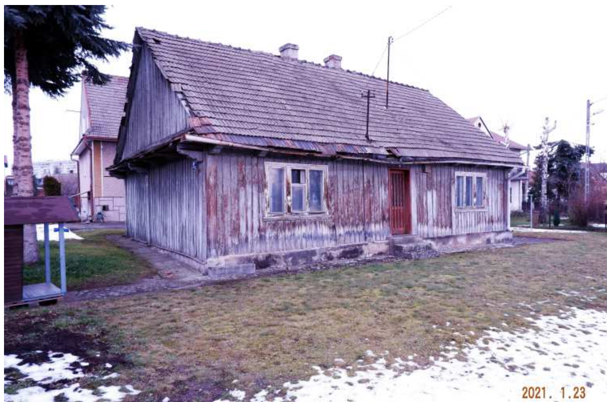
Fot. nr 377. Widok na elewację w ujęciu od strony ulicy Kijanki.
