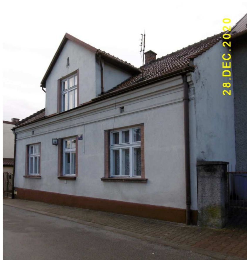
Fot. nr 189 (189-190). Wzdłuż ulicy Krawieckiej. Fot. nr 189. Zapewne jeszcze przedwojenny dom pod nr 5.
