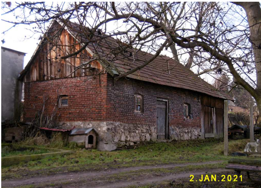
Fot. nr 89. Murowany budynek gospodarczy w kompleksie ze stodołą pod nr 13.
