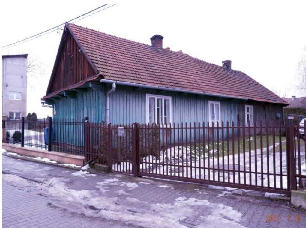
Fot. nr 381. Tylne część od strony dawnego ogrodu.
