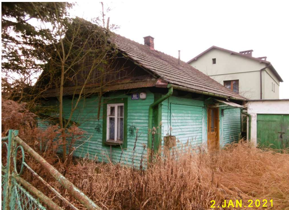
Fot. nr 102. Przedwojenny, pokryty boazerią dom spod nr 111.
