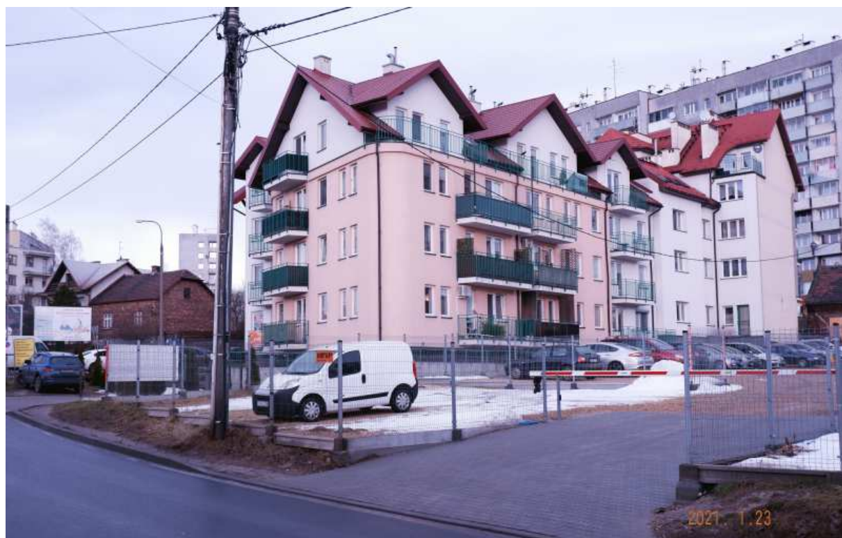
Fot. nr 391. Współczesna zabudowa ulicy pod nr 73c. Jeszcze niedawno stała tu zrujnowana chałupa.
