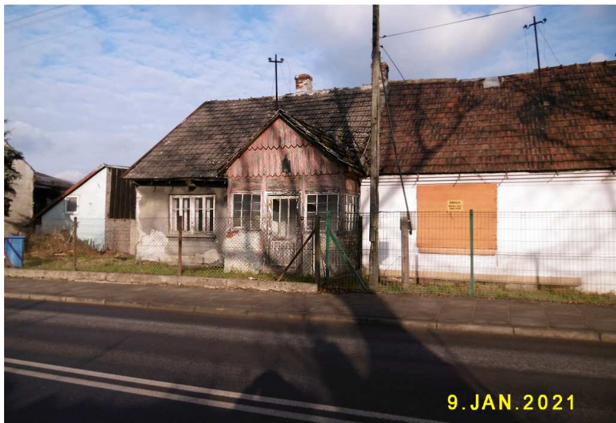
Fot. nr 299. Oryginalny, lewy fragment elewacji frontowej.
