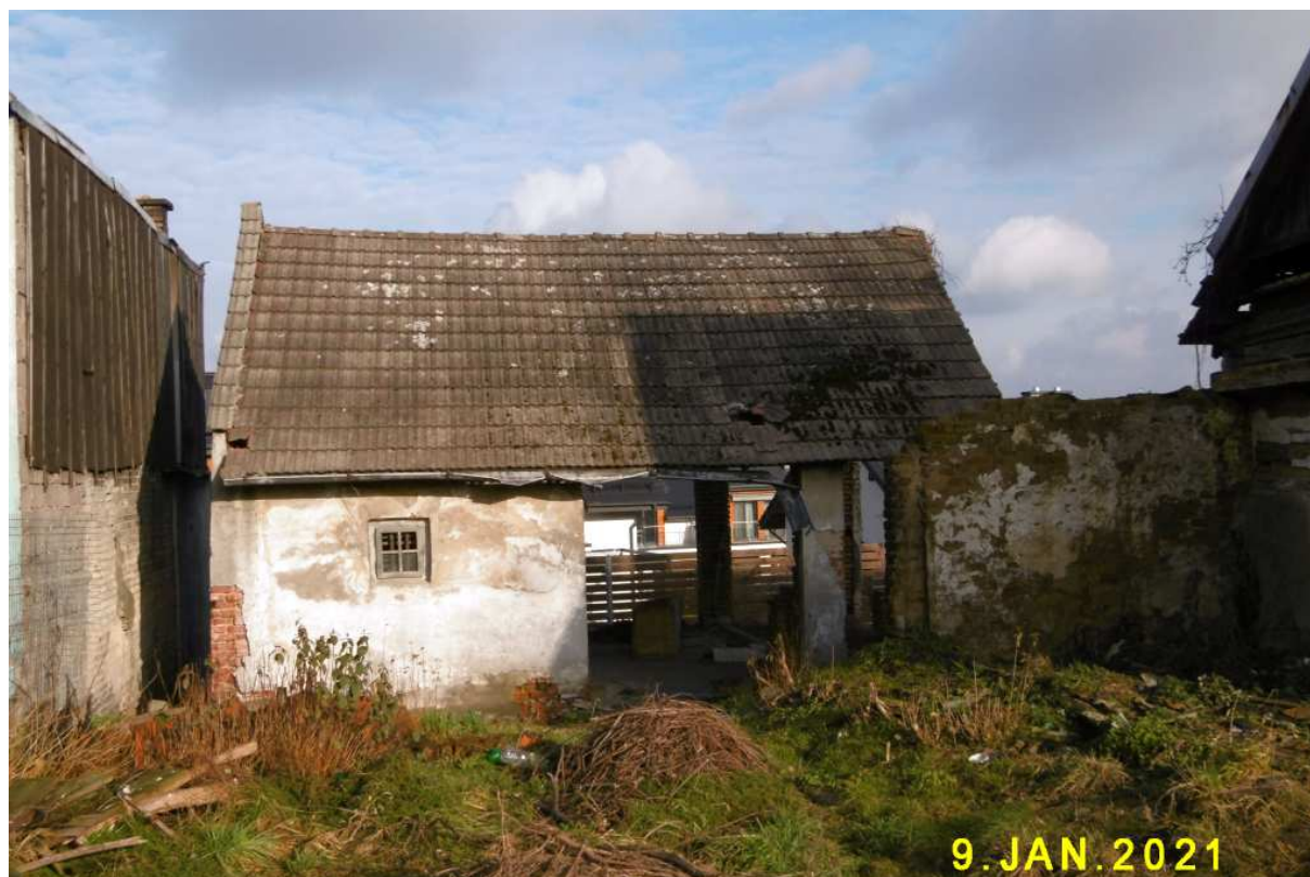
Fot. nr 300. Stajnia na tyłach zagrody pod nr 45.
