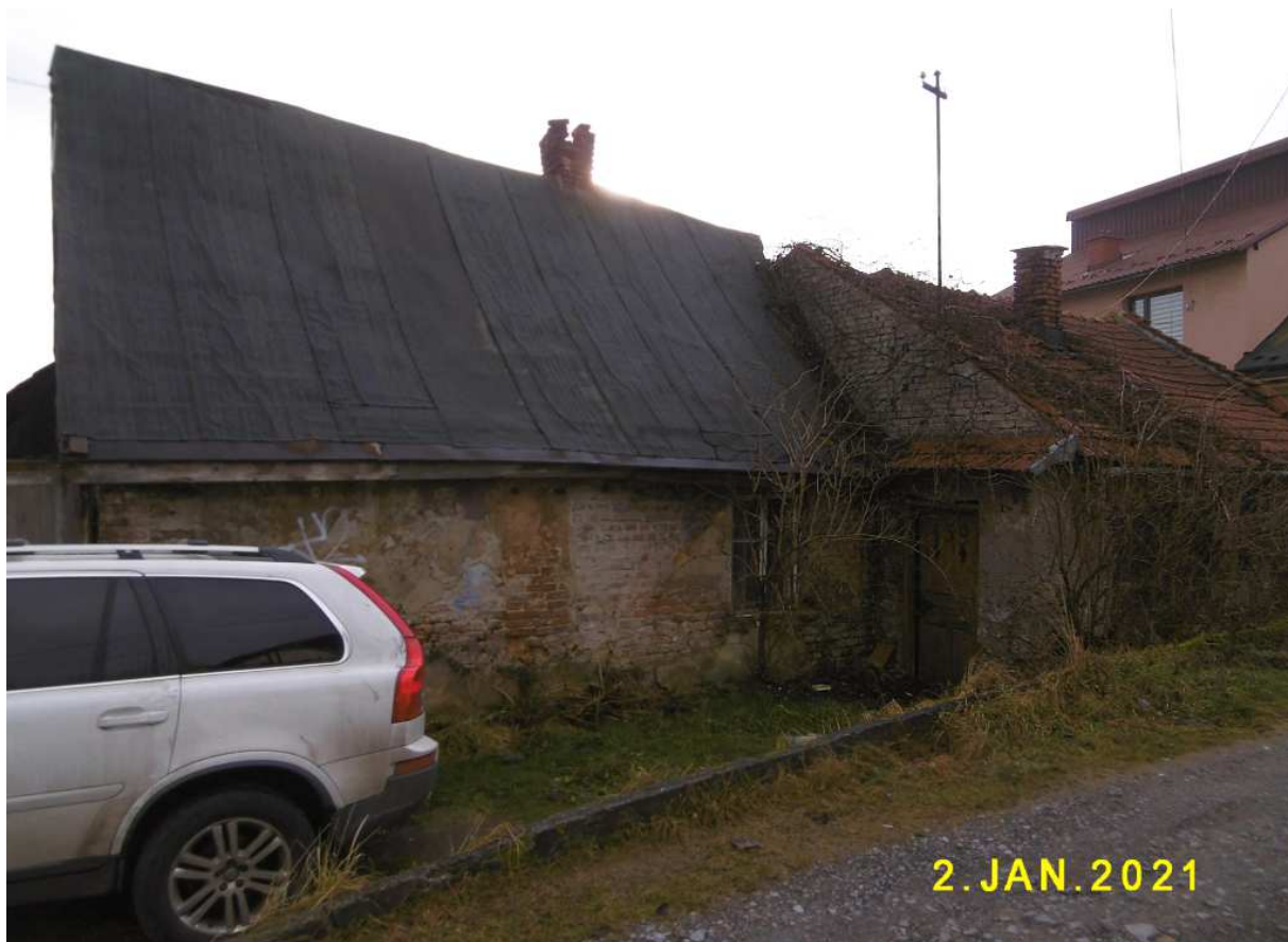
Fot. nr 104. Tylne części domu i przylegającej do niego zapewne gospodarczej dobudówki.
