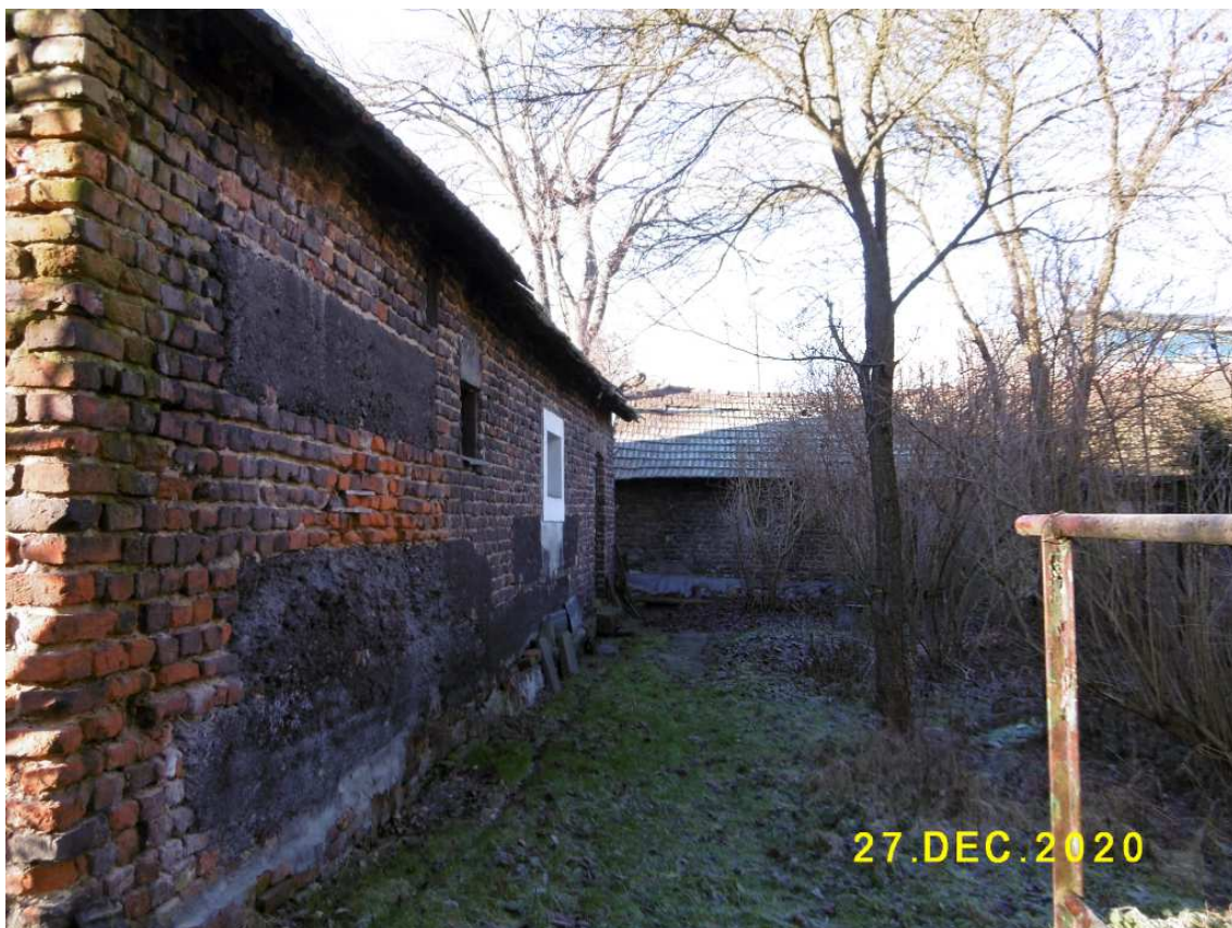
Fot. nr 48. Ściana budynku od strony podwórka z widoczną w tle częścią gospodarczą.
