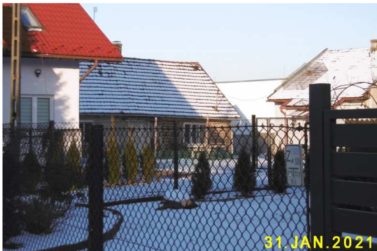
Fot. nr 337. Oryginalny, drewniany fragment chałupy ukrytej na tyłach posesji o numerze 119.
