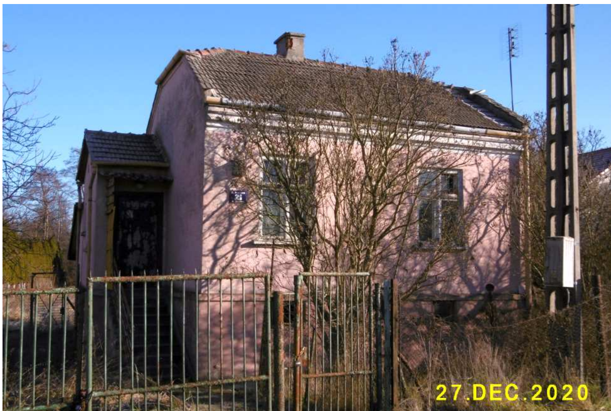
Fot. nr 33. Zapewne jeszcze przedwojenny dom pod nr 21, który przysłaniają krzaki.
