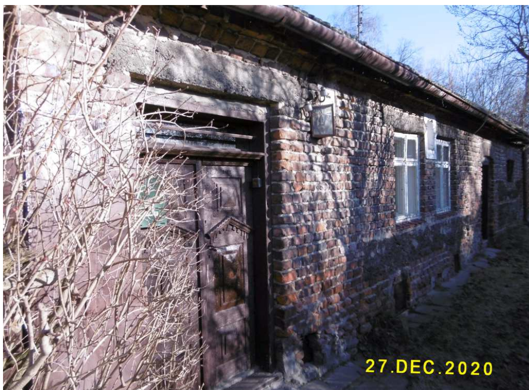
Fot. nr 48. Ujęcie fasady od strony ulicy Na Błonie, gdzie zachowały się oryginalne drzwi i okna typu ościeżnicowego.
