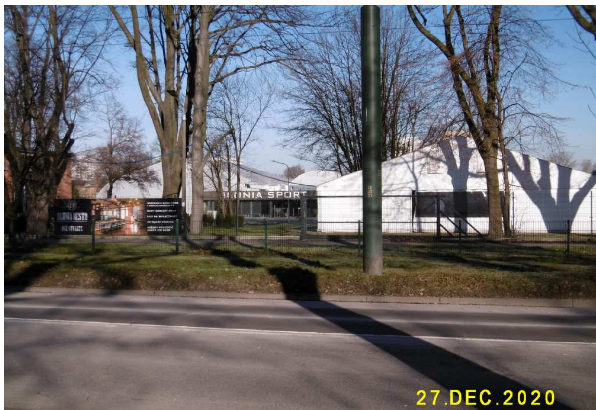
Fot. nr 16 (16-17). Rekreacyjne pawilony „Błonia Sport” w miejscu kompleksu basenów.
