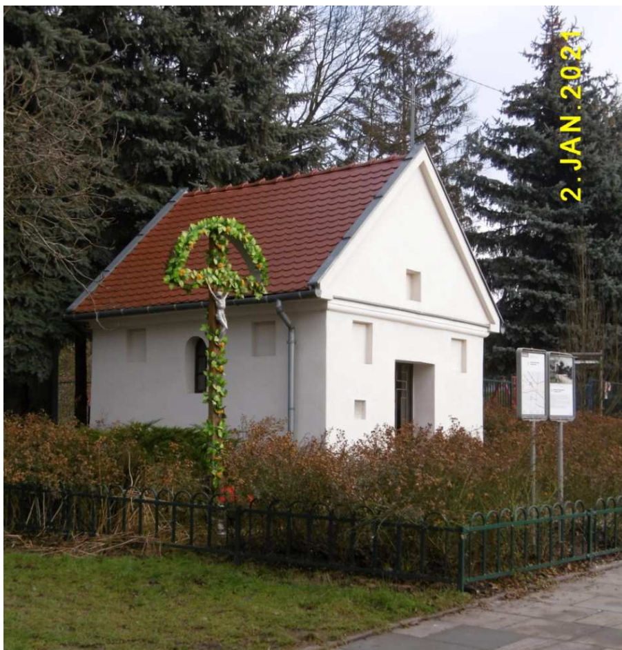
Fot. nr 54 (54-55). Wybudowana w roku 1867 kapliczka p.w. św. Jakuba, posadowiona w bliskości posesji pod nr 4.
