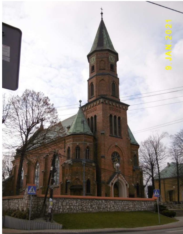
Fot. nr 315. Ujęcie z ulicy Cechowej.
