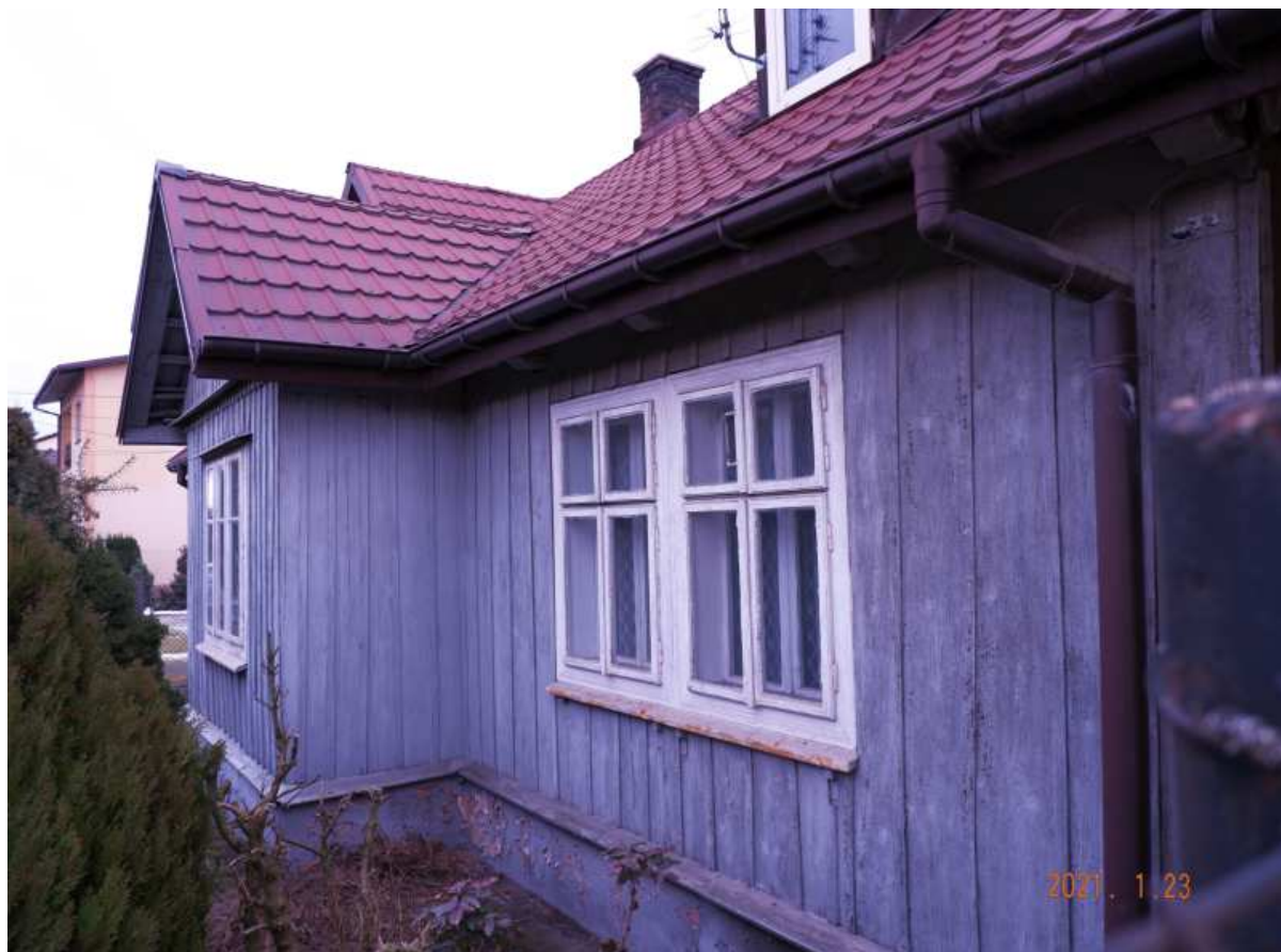
Fot. nr 354. Oszalowany, drewniany dom z gankiem spod nr 91. Obiekt, który nadal posiada oryginalne okna typu ościeżnicowego, został wybudowany w roku 1919.
