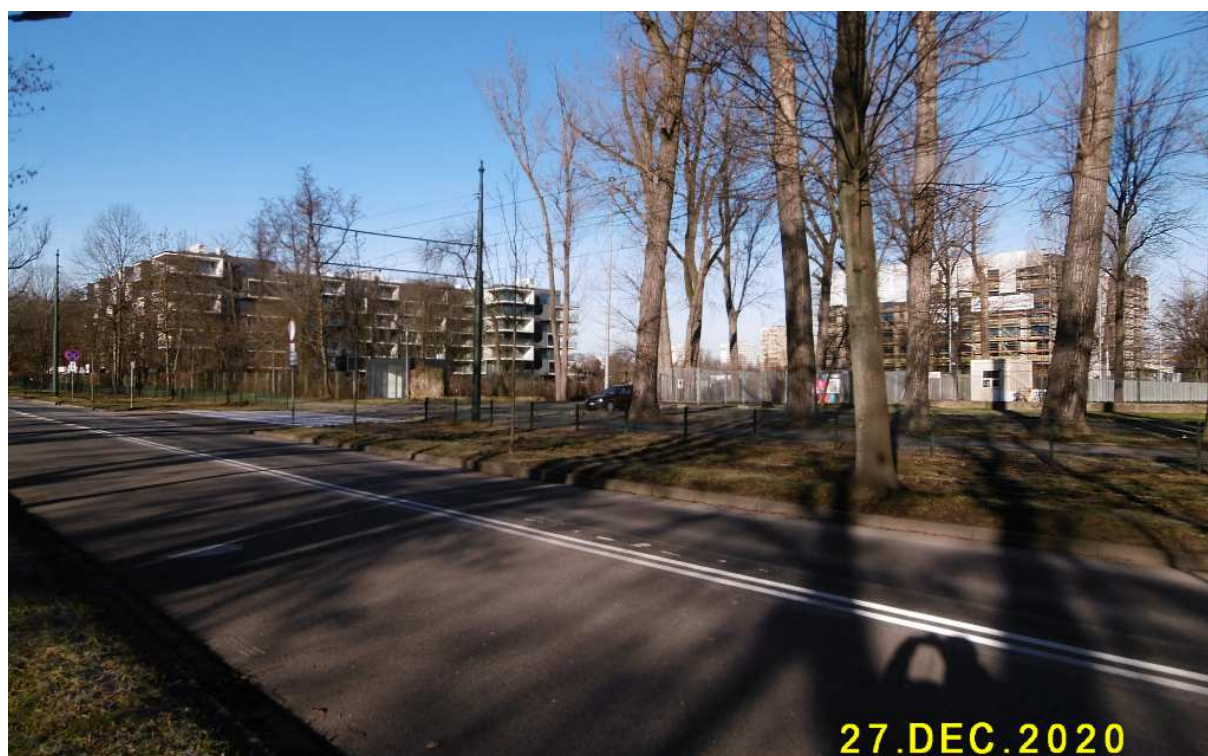
Fot. nr 11 (11-14). Piękne tereny sportowo-rekreacyjne w Cichym Kąciuku, które bezwzględnie zostały zastąpione przez stale się rozbudowujący, betonowy „Błonia Park”.
