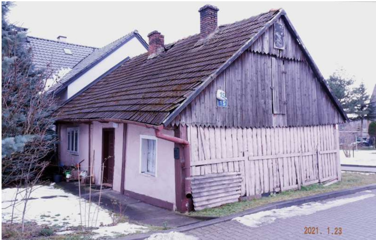
Fot. nr: 374 (374-377). Wzdłuż ulicy Ukośnej. Fot. nr: 374-375. Około 100-letnia chałupa spod nr 15.
