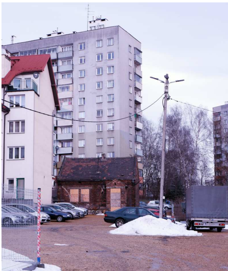
Fot. nr 392 (392-393). Ruina może jeszcze przedwojennego domu spod nr 75a.
