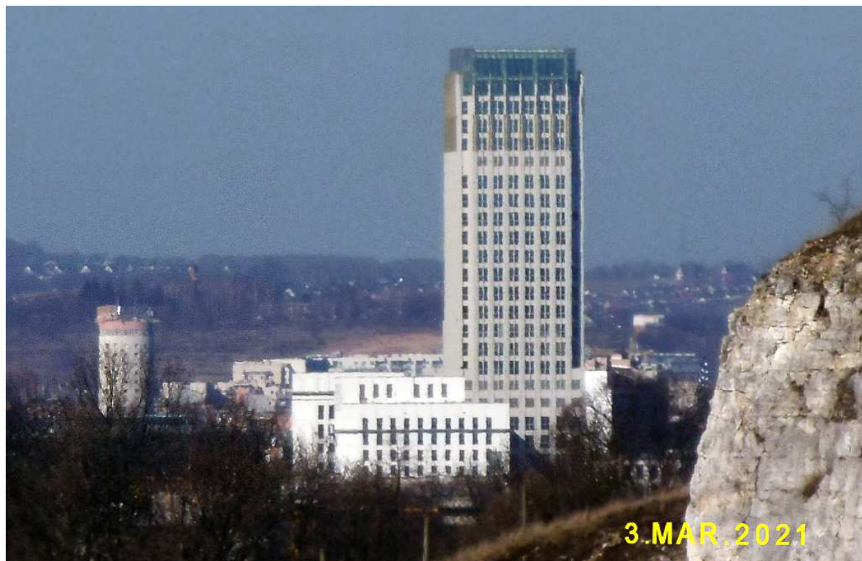
Fot. nr 168. „Szkieletor” z Ronda Mogilskiego, a z lewej w tle okrągła „wieża” z Prądnika Czerwonego.
