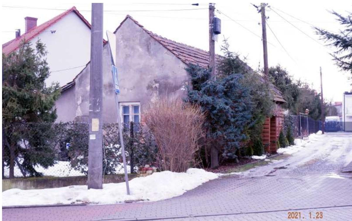
Fot. nr 400 (400-411). Wzdłuż ulicy Łużyckiej od ulicy Kijanki do ulicy Cechowej. Tu niewielki budynek na posesji pod nr 78 w ujęciu od strony ulicy Kijanki.
