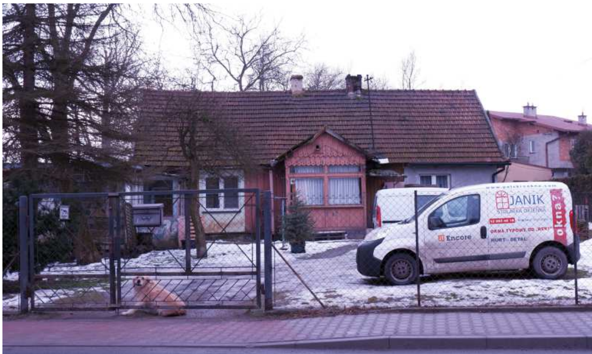
Fot. nr 411. Dom z oszklonym gankiem o zmodyfikowanej już fasadzie spod nr 86, który mógł powstać w latach 30. XX wieku.
