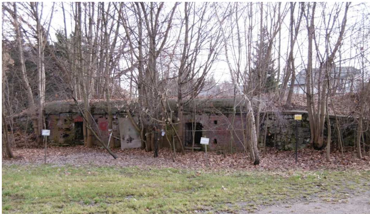
Fot. nr 311. Schron amunicyjny „Kosocice”, usytuowany przy wojskowym posterunku na początku ulicy Niebieskiej, wybudowany w latach: 1913-1914.
