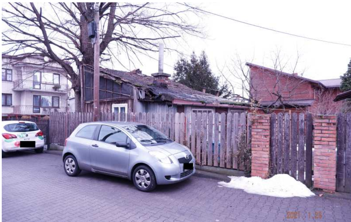
Fot. nr 378. Niewielka chatka z ulicy Gwarnej 11a.
