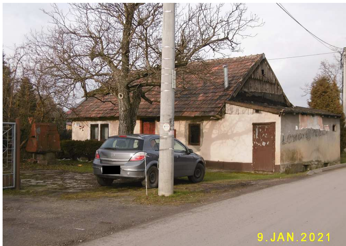
Fot. nr 292. Dawna chałupa przy ulicy Obronnej 12, w której niedawno wymieniono oryginalne okna.
