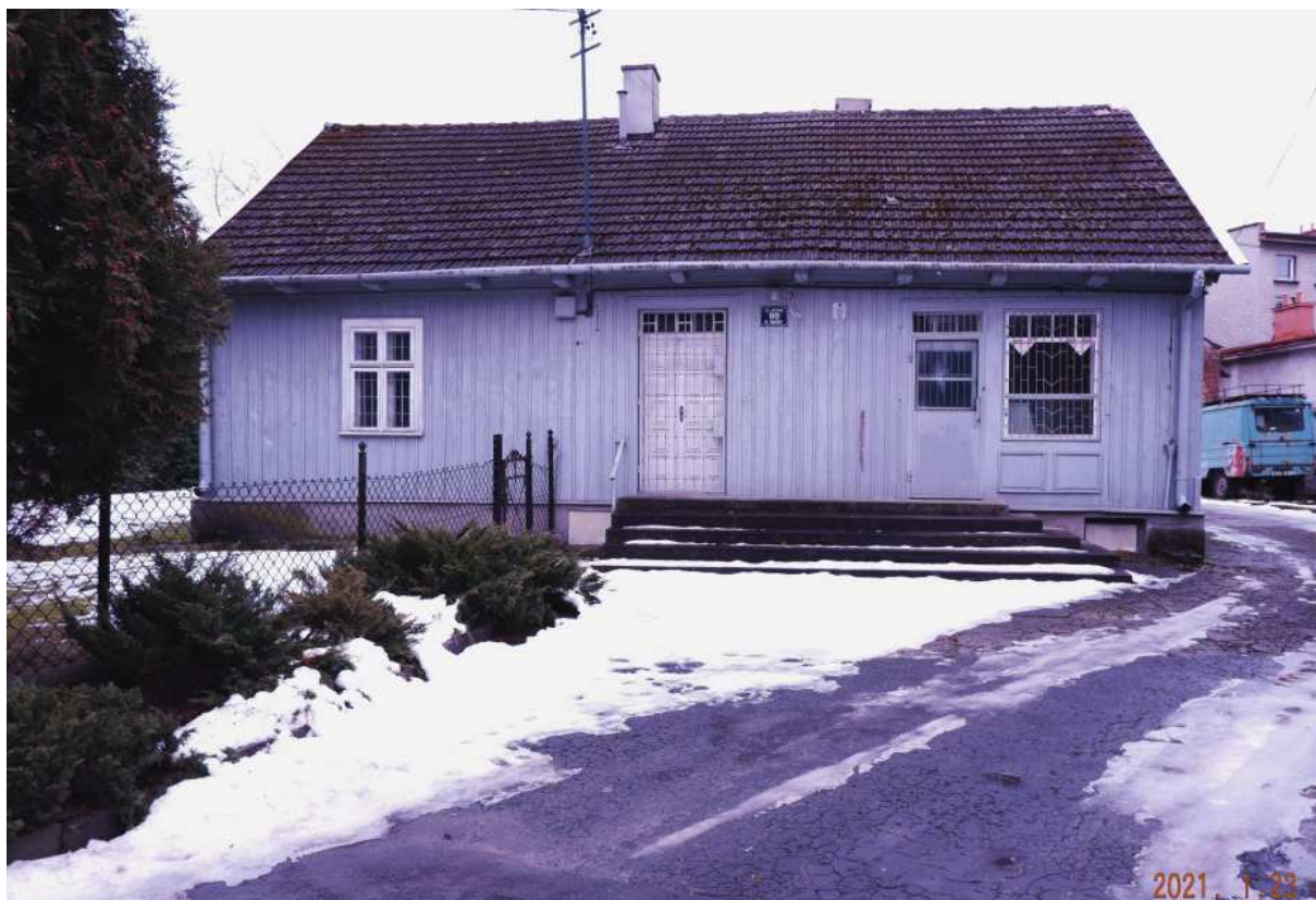
Fot. nr 402 (402-403). Zabudowa posesji pod nr 80. Tu oszalowany dom z lat międzywojennych, w którego w prawym fragmencie znajduje się dawne pomieszczenie posklepowe. Sklep spożywczy działał tu jeszcze w latach 90. zeszłego wieku.
