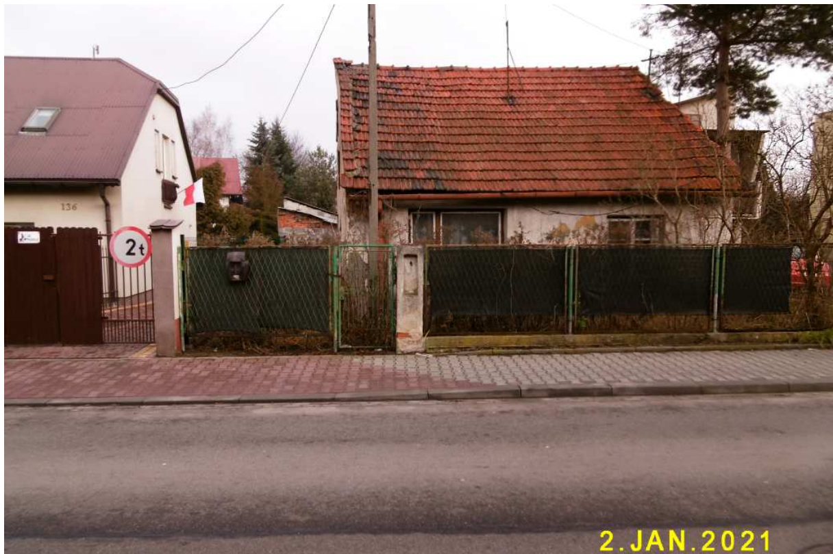
Fot. nr 92 (92-109). Wzdłuż dalszego fragmentu ulicy Ojcowskiej. Fot. nr 92. Zapewne jeszcze przedwojenny dom pod nr 134.
