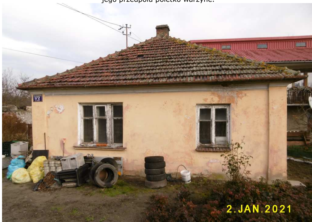
Fot. nr 107. Fasada domu, w którym zachowały się oryginalne okna ościeżnicowe.
