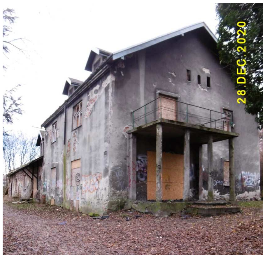
Fot. nr 213. Ściana szczytowa od strony ulicy Estońskiej.
