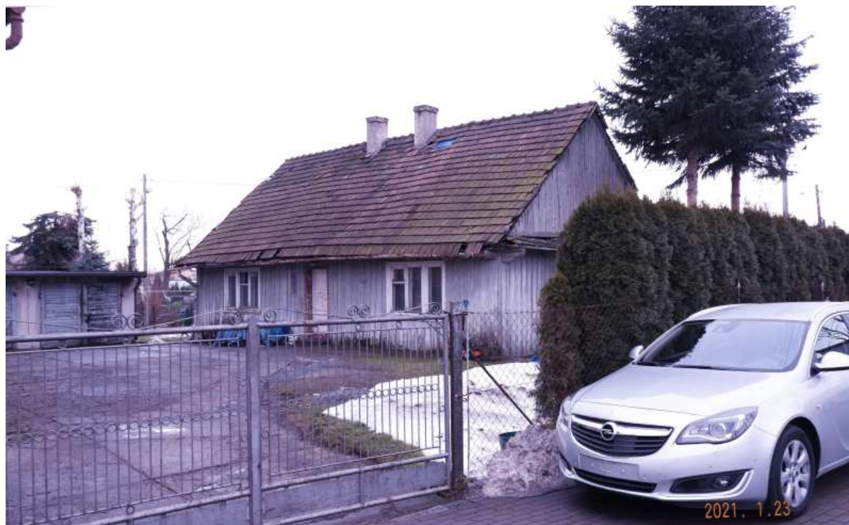
Fot. nr 376 (376-377). Popadający od lat w ruinę blisko stuletni dom spod nr 19. Tu widok od strony podwórka.
