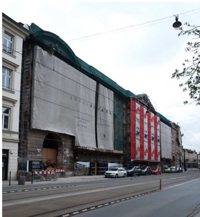
Fot. nr 316. Dawny budynek dowództwa Twierdzy Kraków pod nr: 12-14, wcześniej klasztoru Bożogrobców, obecnie przerabiany na hotel. (25.04.2021)
