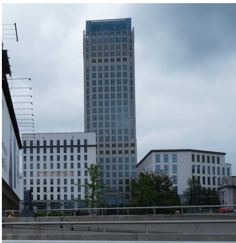
Fot. nr 495. Ukończony wreszcie i rozbudowany „szkieletor” z Ronda Mogińskiego; formalny adres to ulica Beliny Prażmowskiego 20. (19.05.2021)
