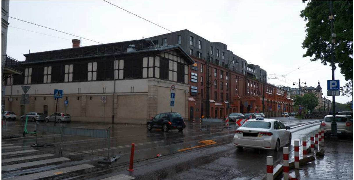
Fot. nr 508 (508-511). Tak dziś wygląda przekształcony w dzielnicę mieszkalną zespół dawnego Browaru Kraków, którego początki sięgają roku 1840. (16.05.2021)
