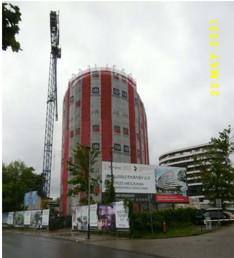
Fot. nr 534 (534-535). Trwa zabudowa terenu dawnych zakładów Zieleniewskiego przy ulicy Grzegórzeckiej 69.
