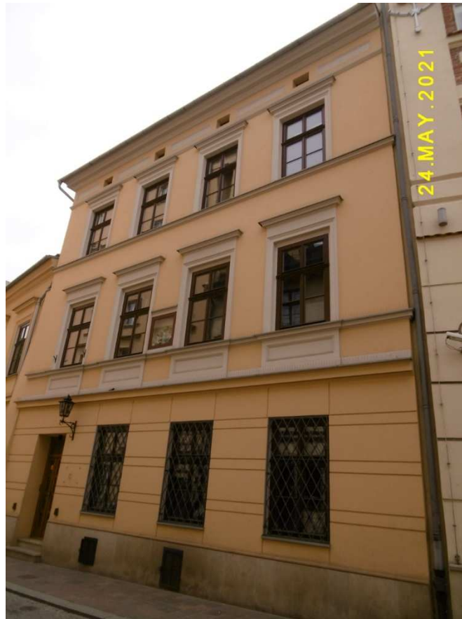
Fot. nr 108. Wyremntowana kamienica pod nr 17.
