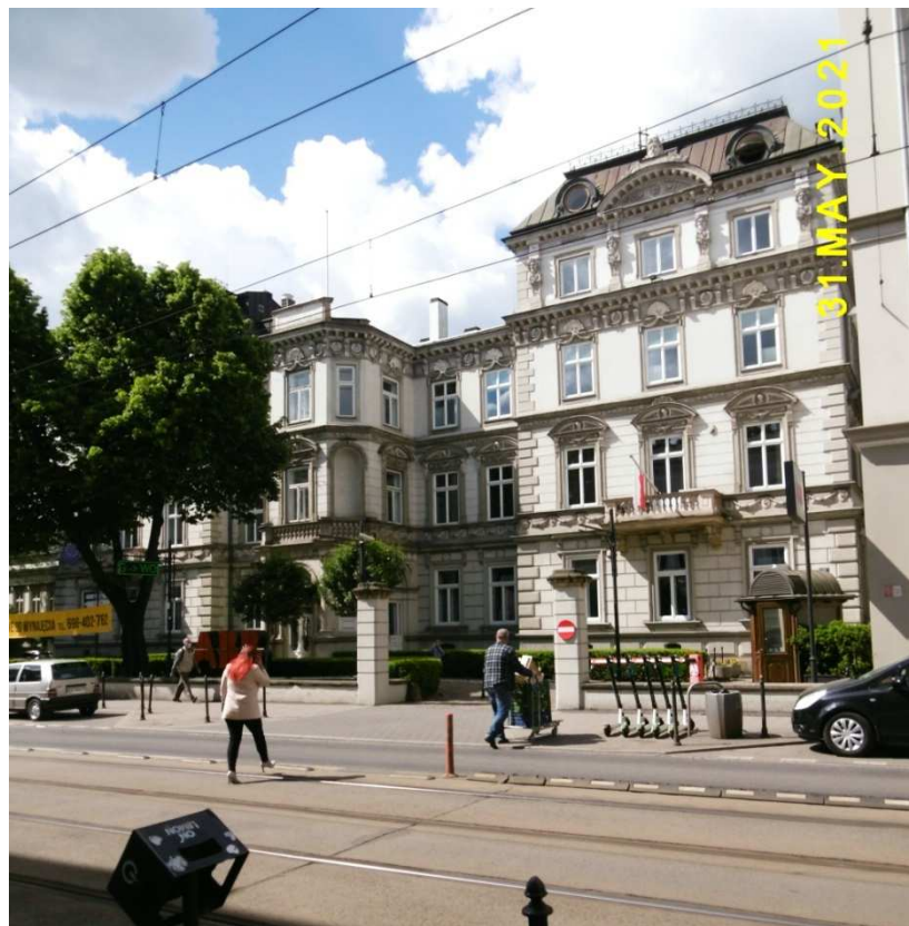
Fot. nr 427 (427- 428). Fasada pałacu spod nr 13.
