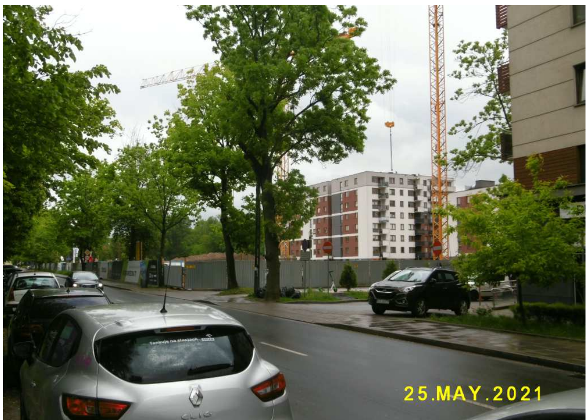
Fot. nr 539. Nie ustaje intensywna zabudowa ulicy Grzegórzeckiej. Tu nowo powstające blokowisko na posesji pod nr 75.
