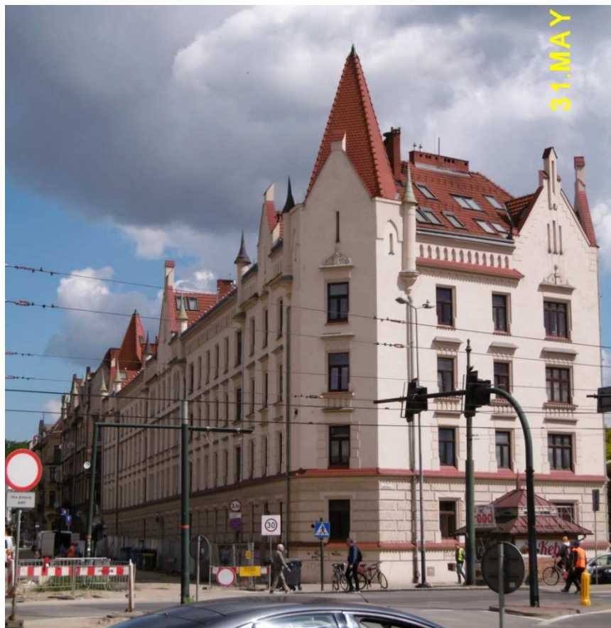
Fot. nr 435. Neogotyckie kamienice C.K. urzędników kolei przy ulicy Blich: 7-9.
