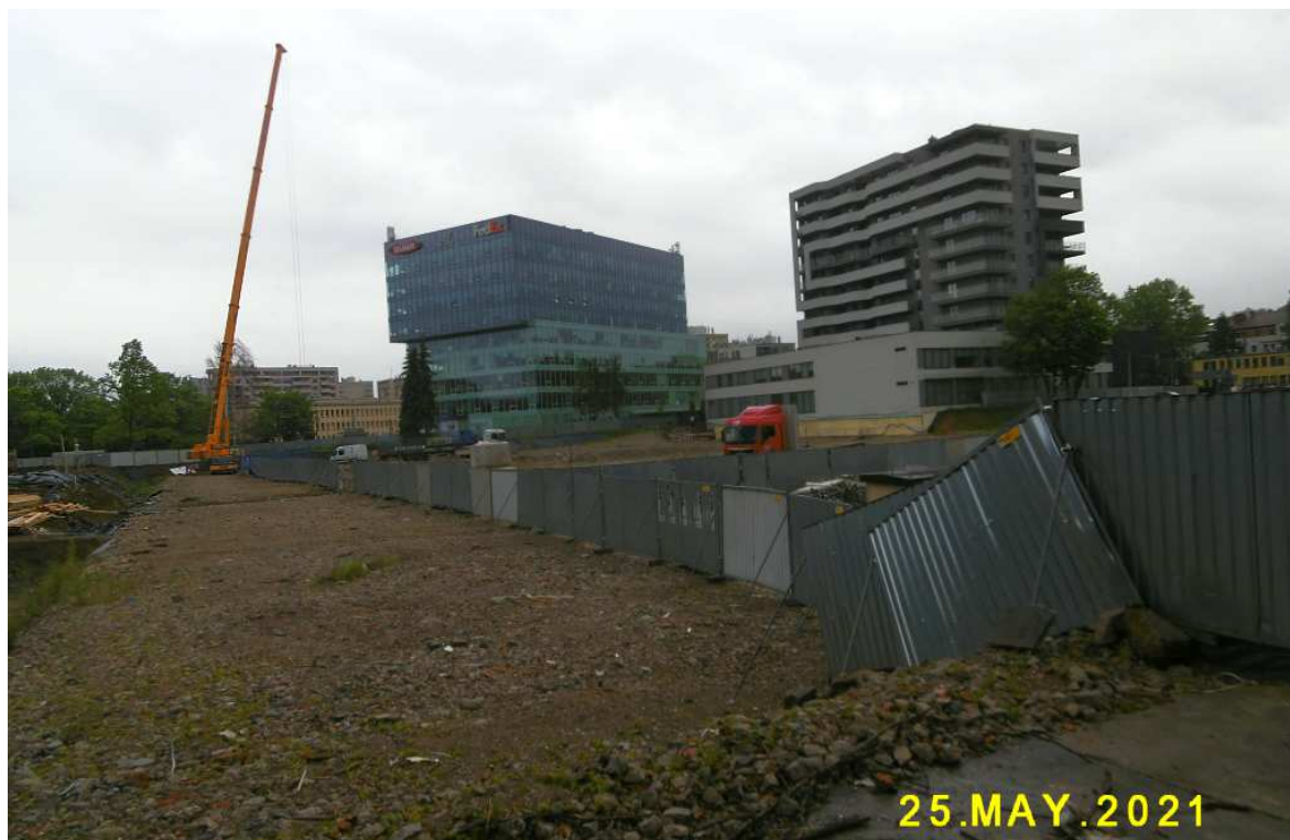
Fot. nr 532. Współczesny plac budowy na posesji przy ulicy Grzegórzeckiej 3.
