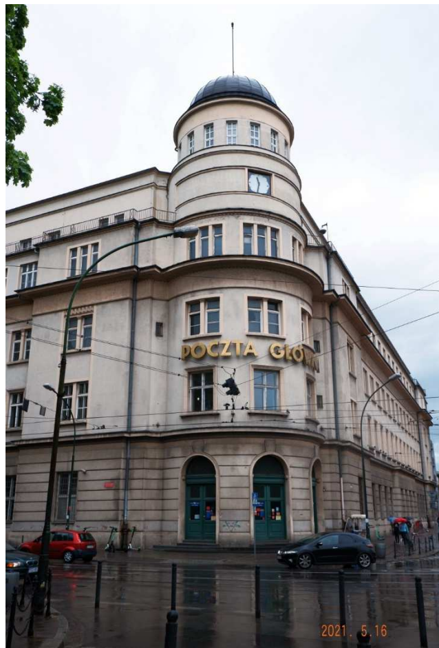
Fot. nr 437. Narożna wieża gmachu Poczty Głównej.
