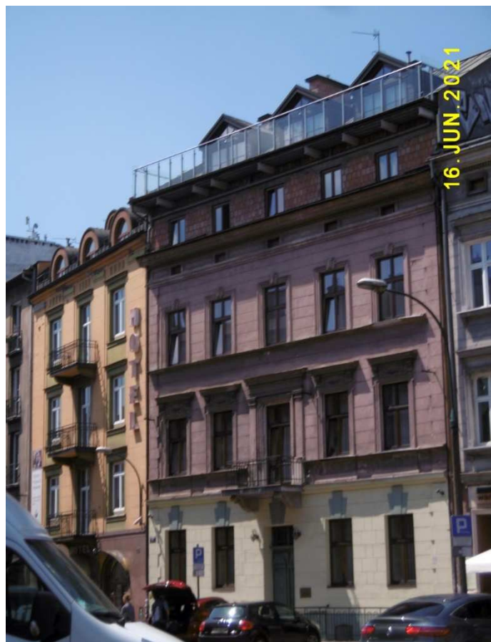
Fot. nr 378. Kamienica pod nr 16 i jej nielegalna nadbudowa.
