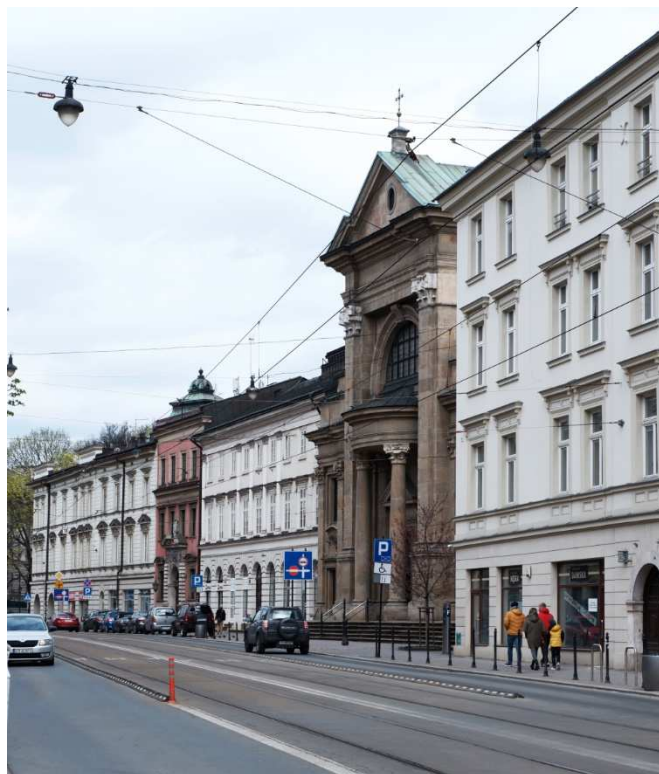
Fot. nr 315. Fragment zabudowy poniżej numeru 10. (25.04.2021)
