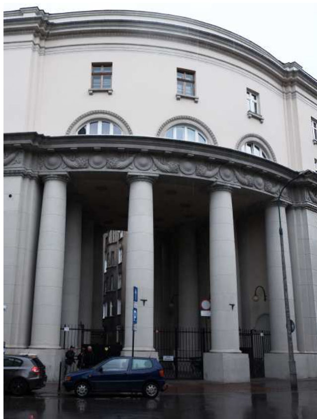
Fot. nr 452. Kolumnowe brama przy wejściu na podwórkę. (16.05.2021)
