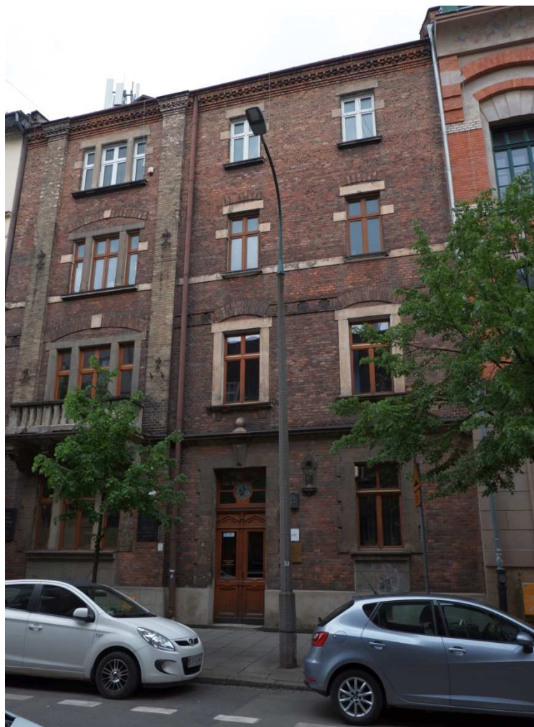
Fot. nr 486 (486-490). Kamienica przy ulicy Topolowej 18 autorstwa Jana Sasa-Zubrzyckiego i jej detale. (19.05.2021)
