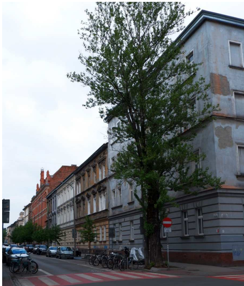
Fot. nr 491. Ulica Topolowa w ujęciu z ulicy Ariańskiej. (19.05.2021)
