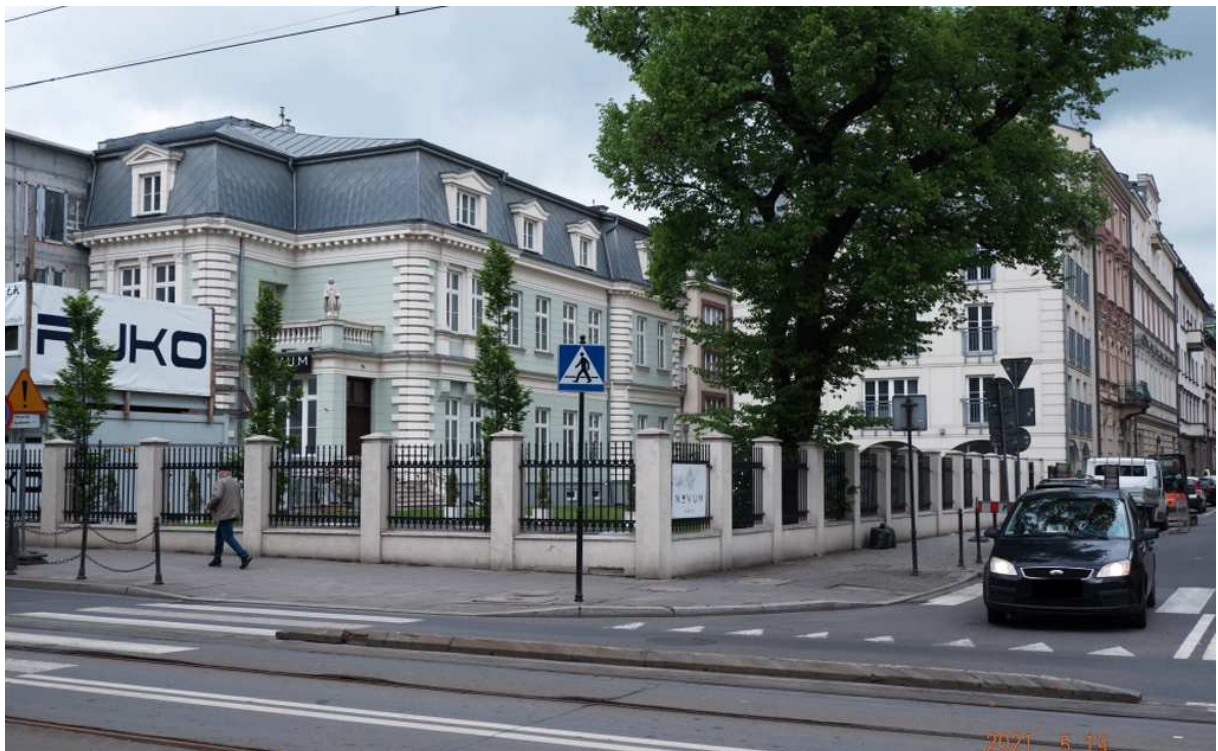
Fot. nr 501. Wyremontowany pałacyk z naroża ulic: Lubicz 42 i Ariańskiej 2. Powstał w latach: 1879-87 wg projektu Adolfa Opida.
