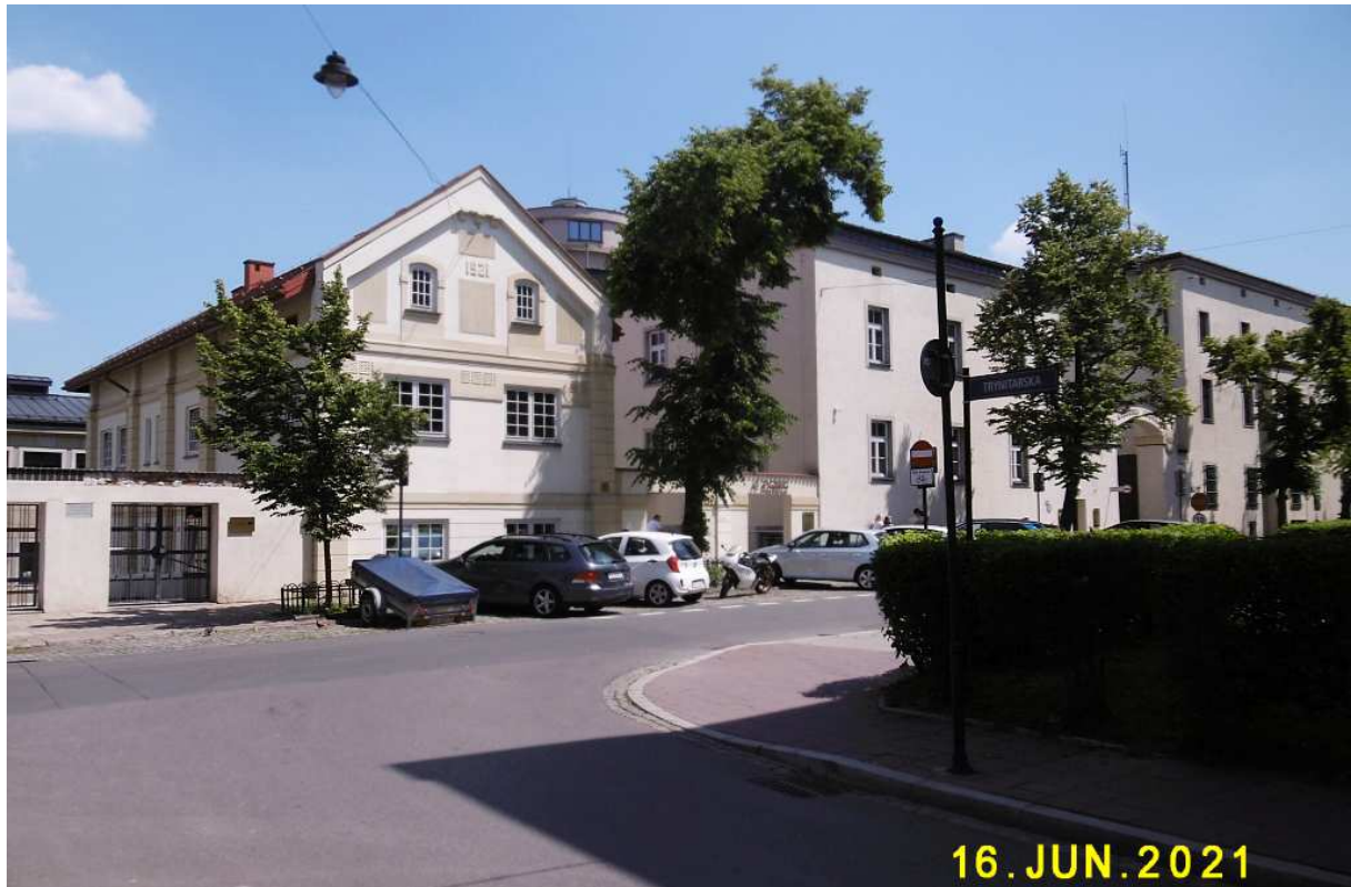
Fot. nr 356 (356-357). Budynki Gazowni Miejskiej przy ulicy Gazowej 14.
