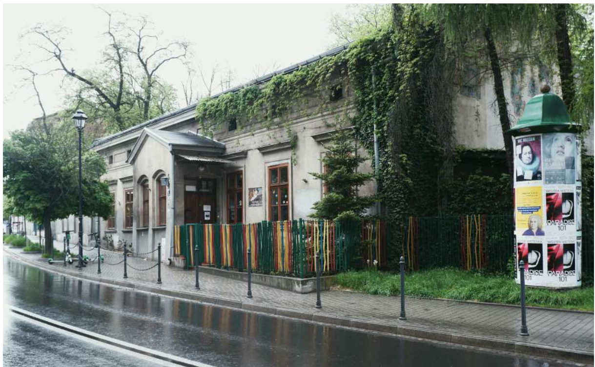
Fot. nr 525 (525-526). Budynek dawnego szpitala przy ulicy Kopernika 16, działającego przy kościele już może nawet na przełomie XVIII i XIX wieku. (16.05.2021)
