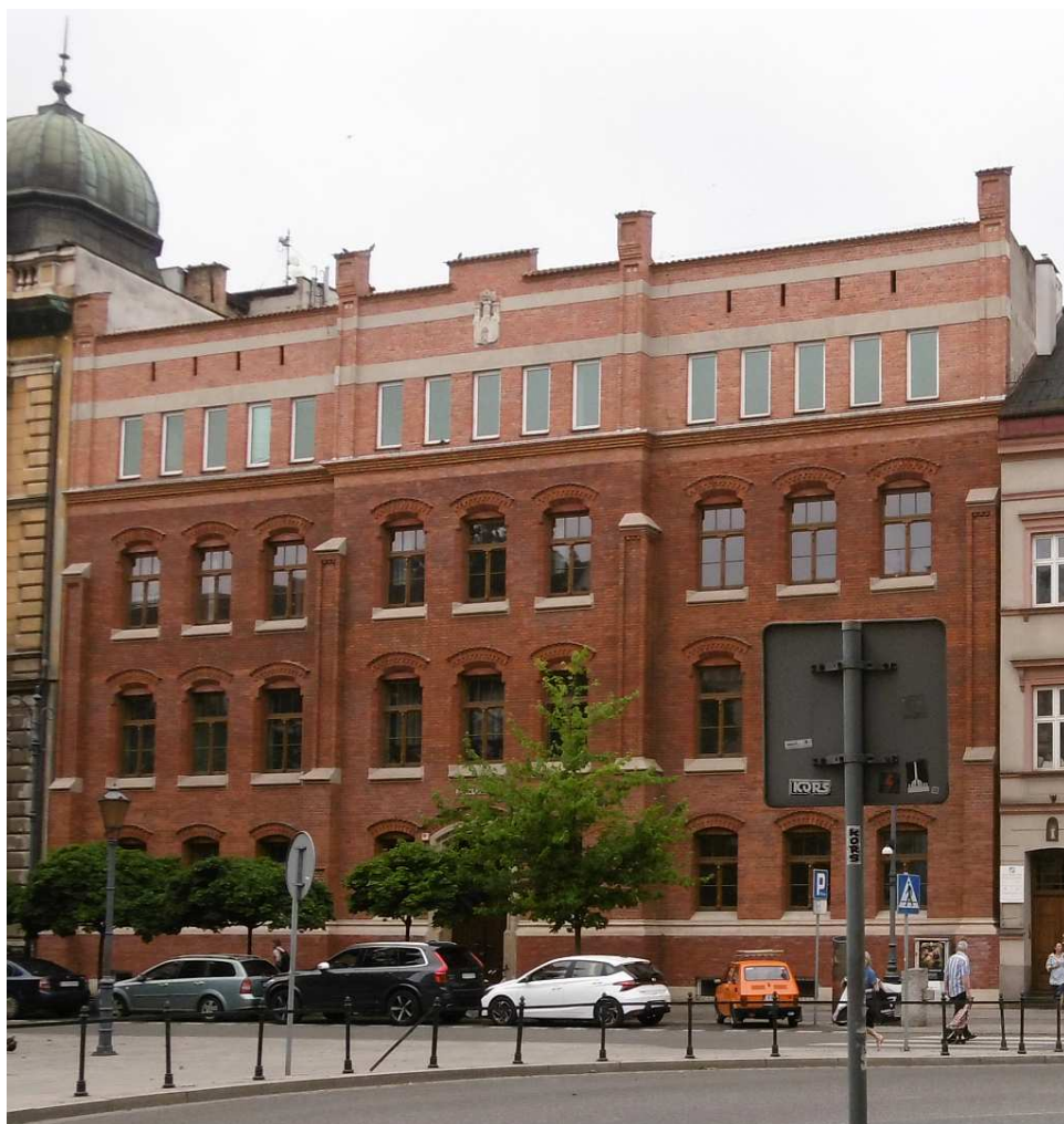
Fot. nr 412. Budynek szkolny spod nr 2.
