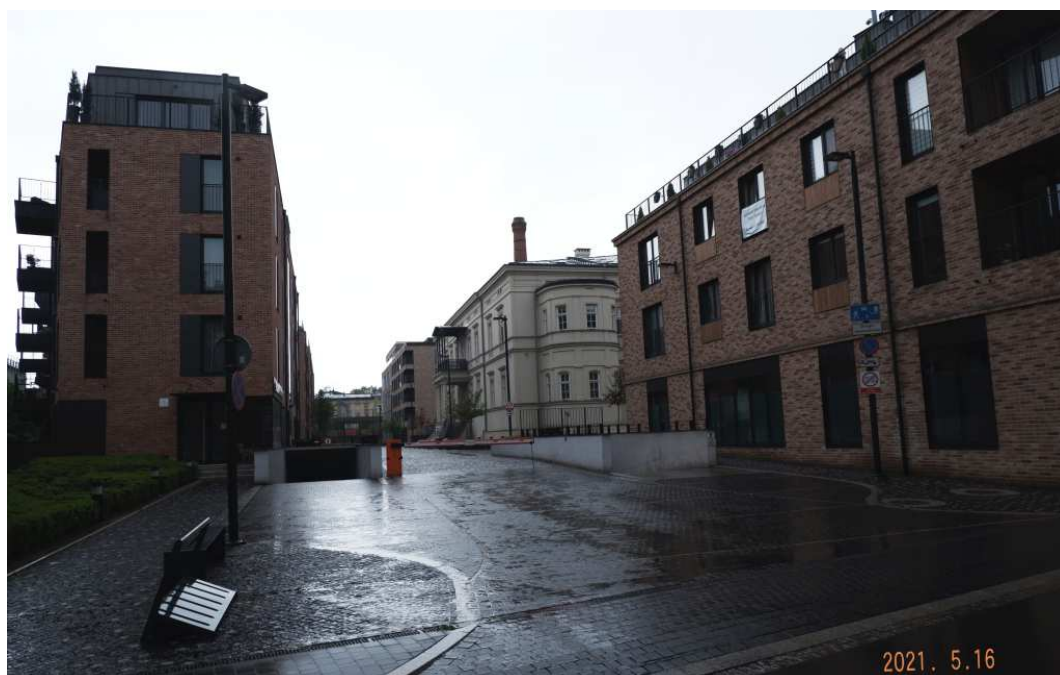
Fot. nr 513 (513-514). Konglomerat współczesnego blokowiska i elementów dawnej zabudowy na terenie dawnego Browaru Kraków.
