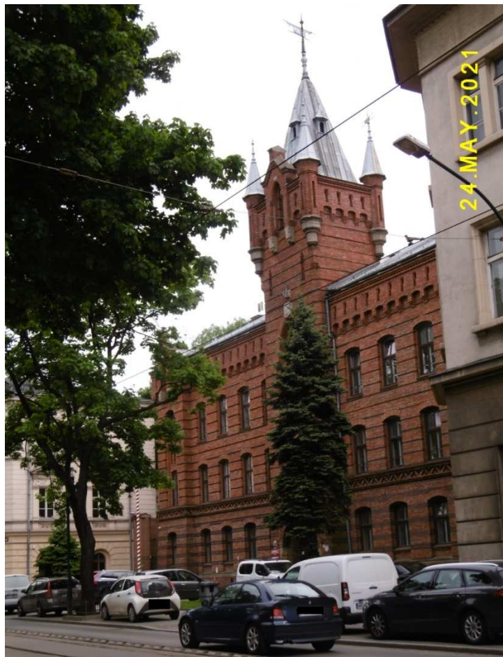
Fot. nr 439 (439-440). Budynek Straży Pożarnej pod nr 19.
