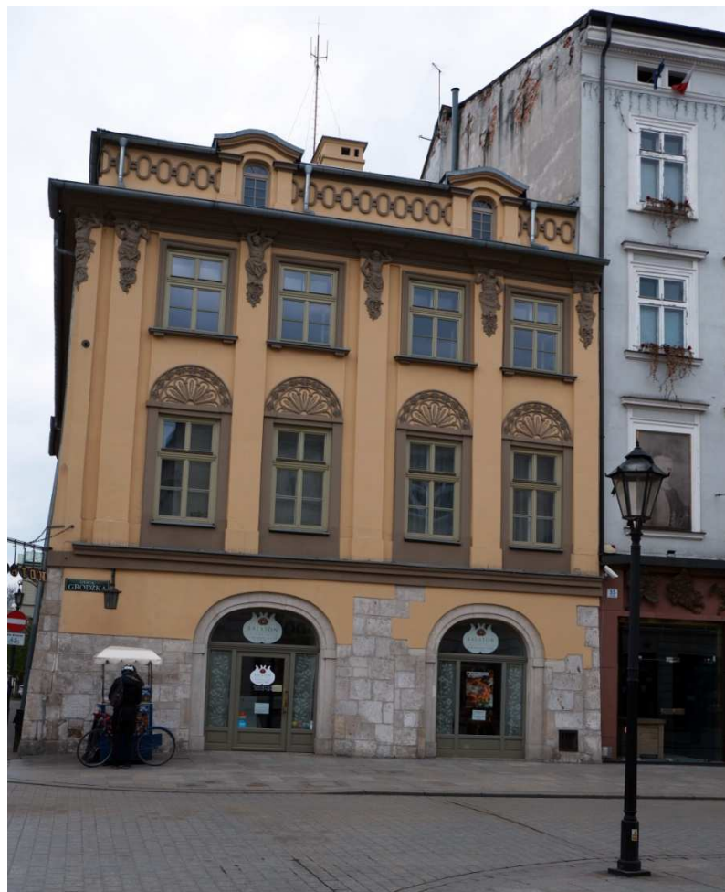
Fot. nr 253. Narożna kamienica przy ulicy Grodzkiej 37.
