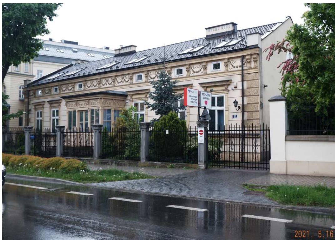
Fot. nr 517. Powstała w roku 1887 willa Szafrąskich spod nr 30.
