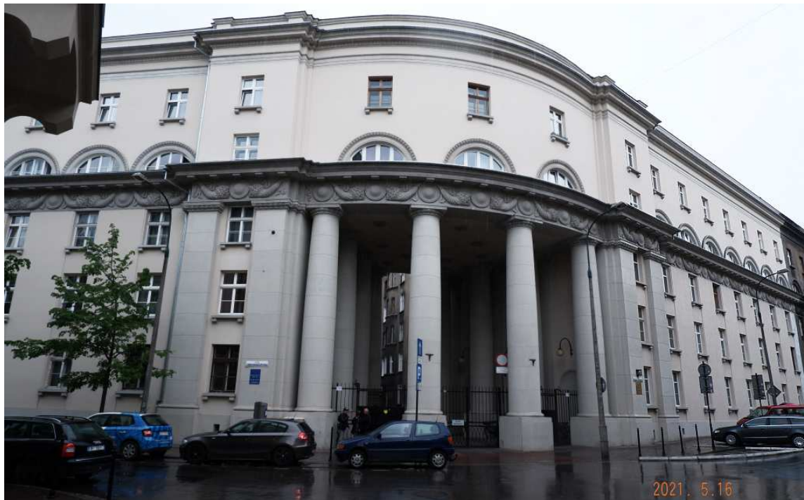
Fot. nr 451 (451-453). Kamienica pracowników Banku PKO na styku ulic: Zybkiewiczza 5 oraz Librowszczyzna 10 i jej detale.
