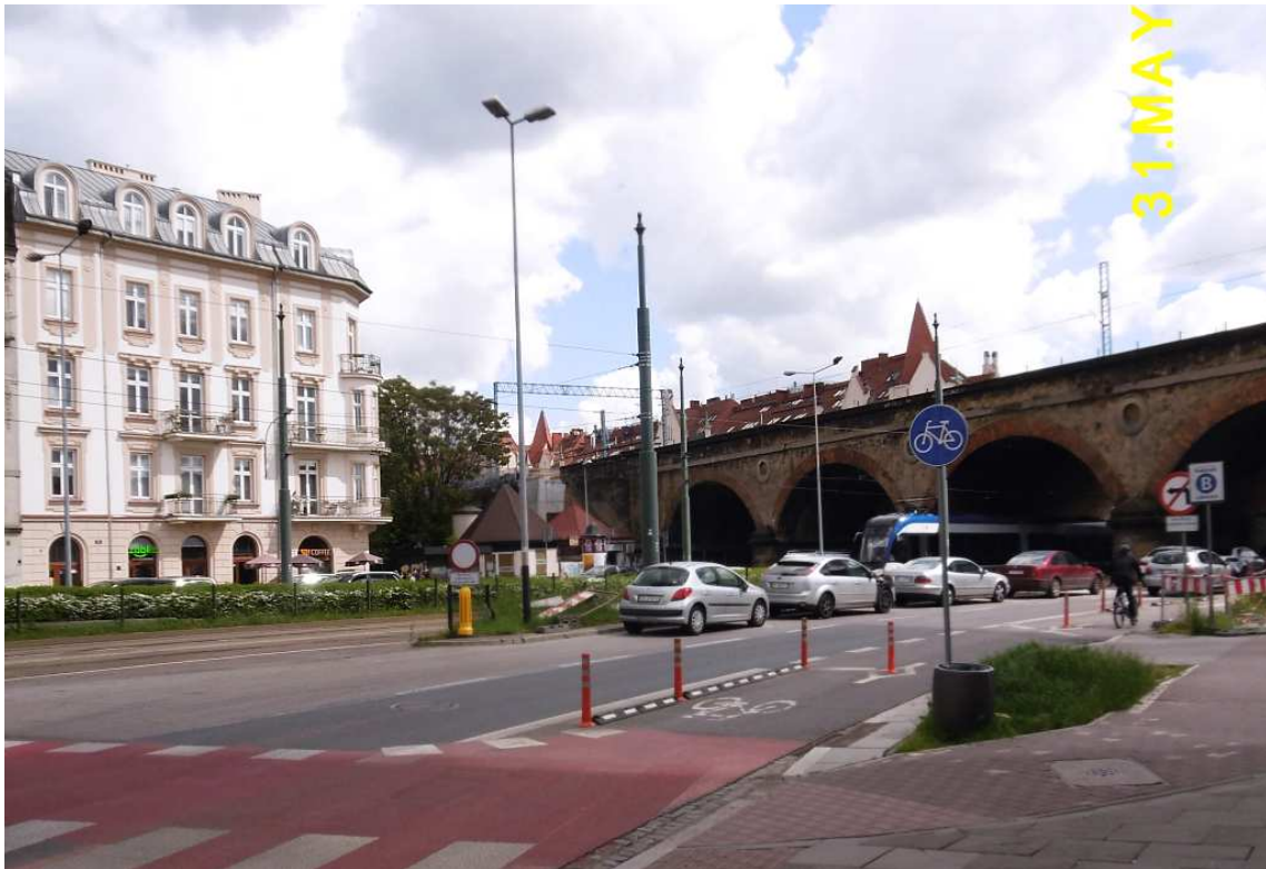
Fot. nr 434. Poszerzony widukt kolejowy pomiędzy ulicami: Dietla i Grzegórzecką
