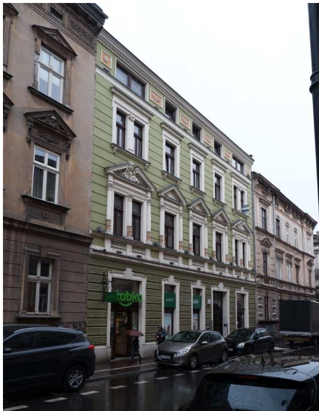
Fot. nr 463. Odnowiona kamienica pod nr 27. (16.05.2021)
