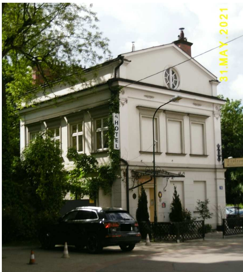
Fot. nr 429. Tylne część lewej oficyny pod nr 15a.
