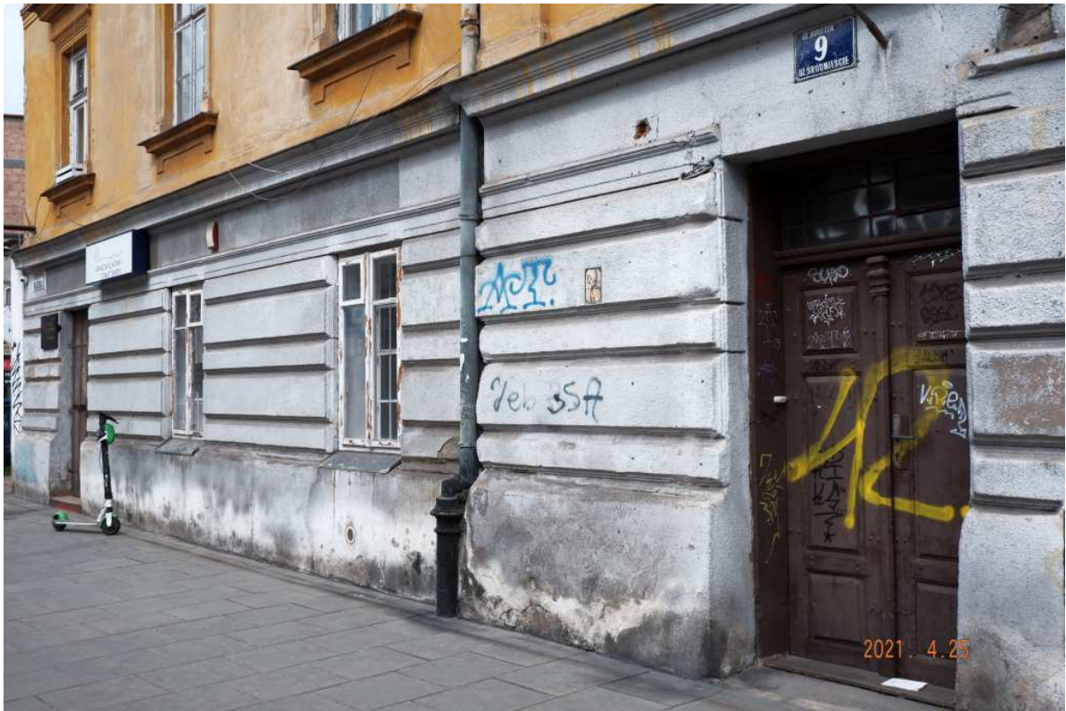
Fot. nr 326 (326-327). Parter z oryginalnymi drzwiami i niespotykanymi już oknami.
