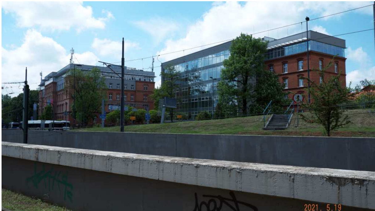
Fot. nr 395 (395-406). Spacer po ulicy Warszawskiej. Fot. nr: 395-397. Gmach Politechniki pod nr 24.
