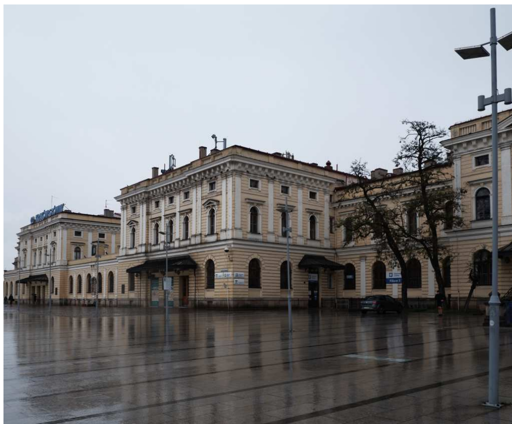
Fot. nr 475 (475-477). Dawny gmach Dworca Głównego (16.05.2021)
