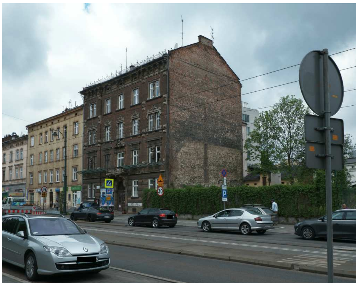
Fot. nr 503. Fragment zabudowy o numerach: 30-34. Pierwsza z prawej (nr 34) to kamienica Bujwidów, wybudowana w ostatniej dekadzie XIX wieku. (19.05.2021)
