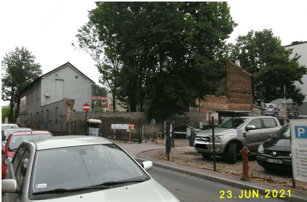
Fot. nr 416 (416-418). Fragment niskiej zabudowy na styku z ulicą Worcella, gdzie niebawem ma powstać wysoki budynek hotelowy.
