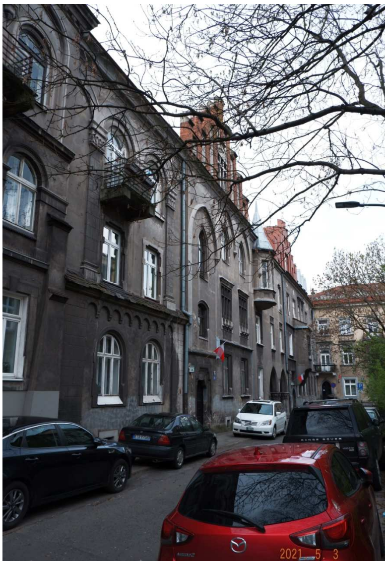
Fot. nr 107. Zabudowa wnętrza ulicy pod numerami 16. Na pierwszym planie historyzująca fasada kamienicy pod nr 16a; wg GEZ powstała w latach 1911-12 (proj. Ignacy Wentzel).
