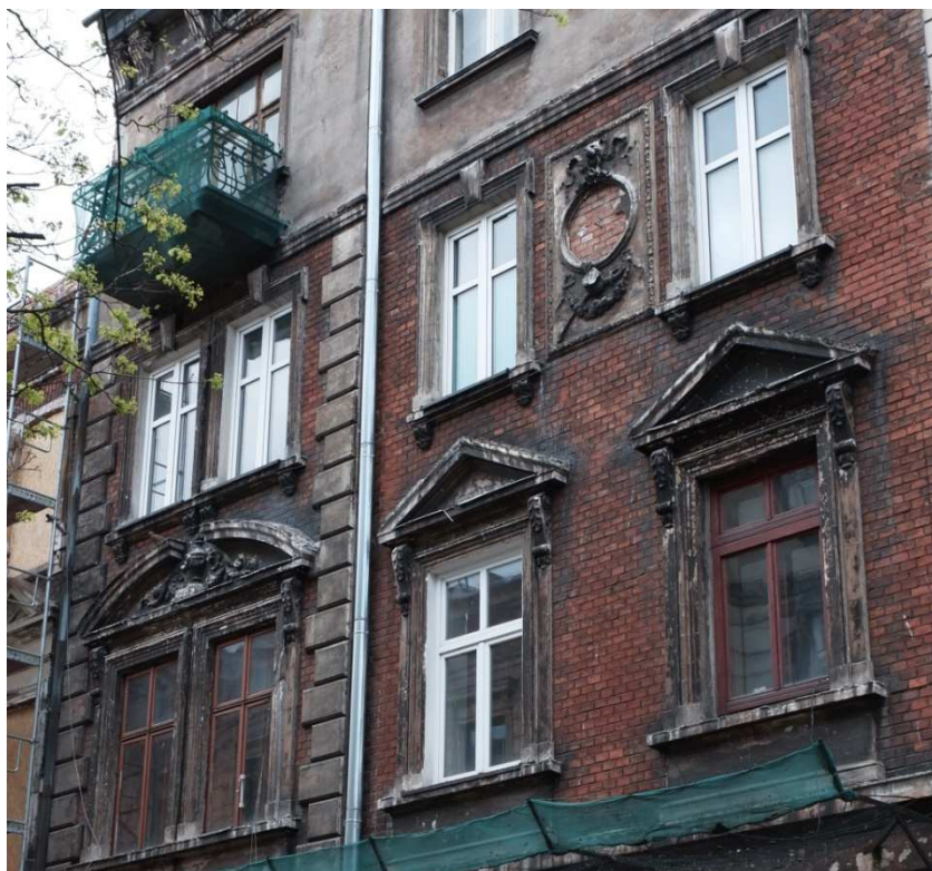
Fot. nr 88. Oryginalne dwa okna trwają jeszcze w lewej części pierwszego piętra. (03.05.2021)
