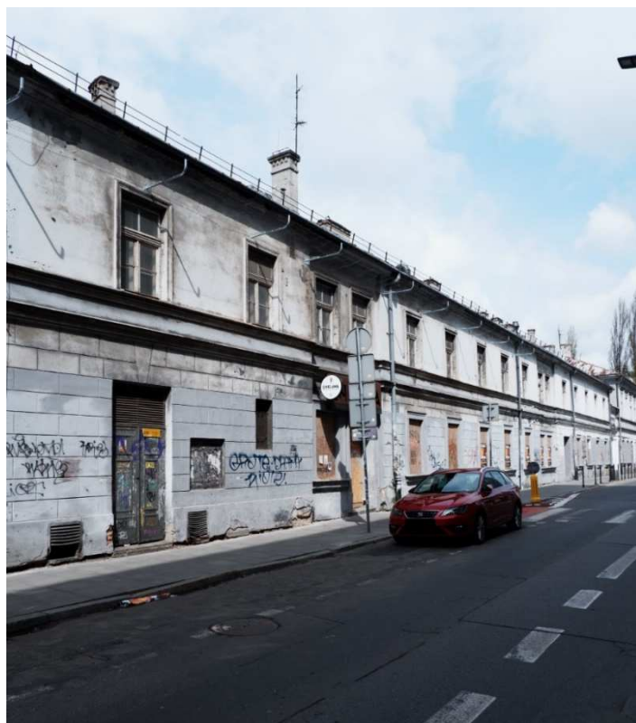
Fot. nr 20 (20-25). Widoki na budynki dawnych Krakowskich Zakładów Tytoniowych z ulicy Dolnych Młynów 10-12.
