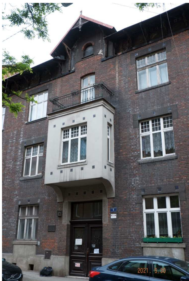
Fot. nr 315. Fasada kamienicy pod nr 6, wybudowanej w latach 1909-11.
