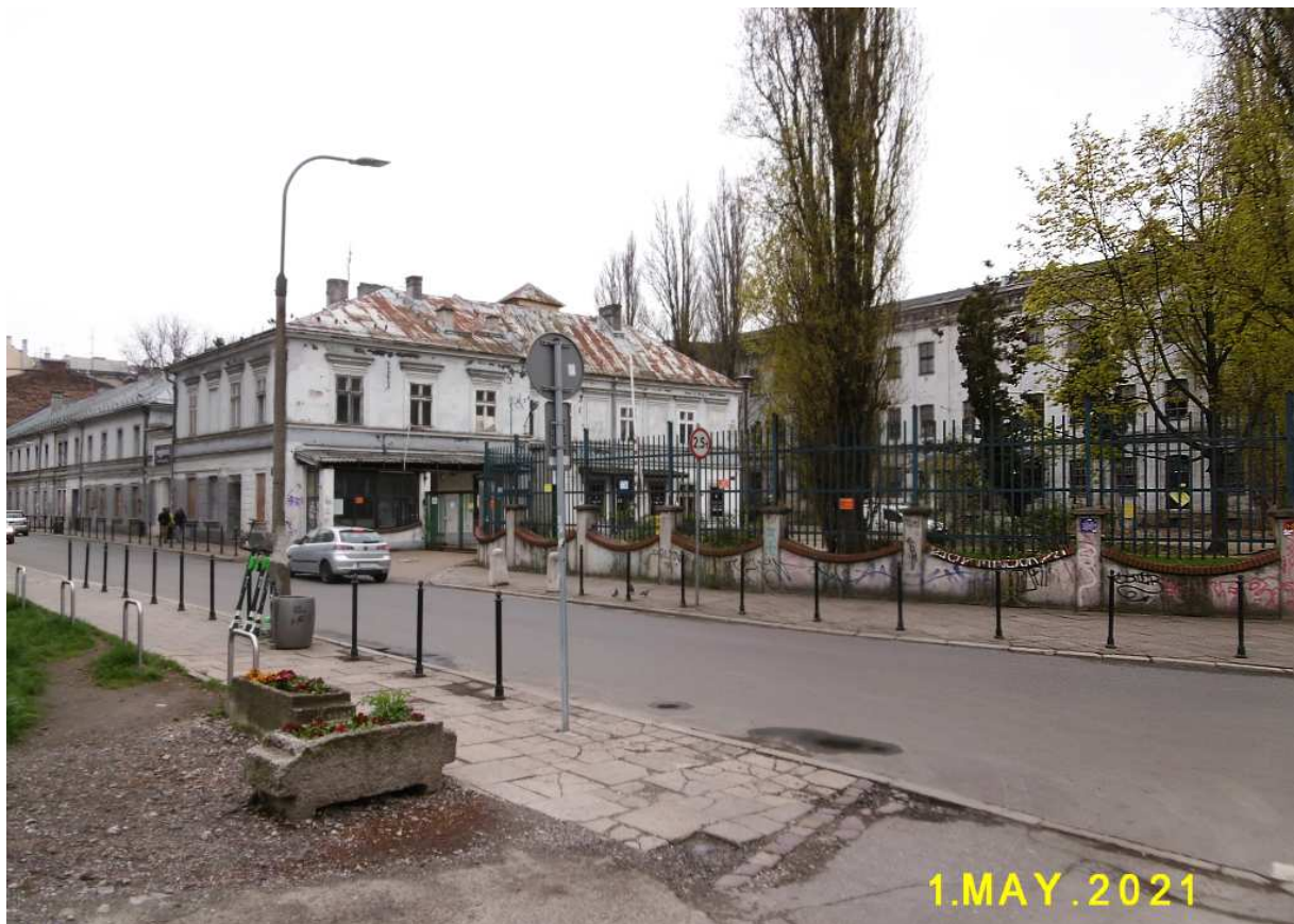
Fot. nr 25. Ujęcie od strony ulicy Czarnowiejskiej.
