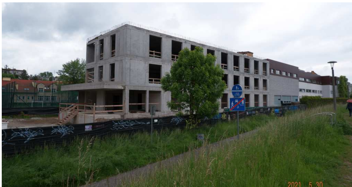
Fot. nr 292 (292-295). Wzdłuż ulicy Kasztelańskiej. Trwa zabudowa końcowego jej fragmentu.
