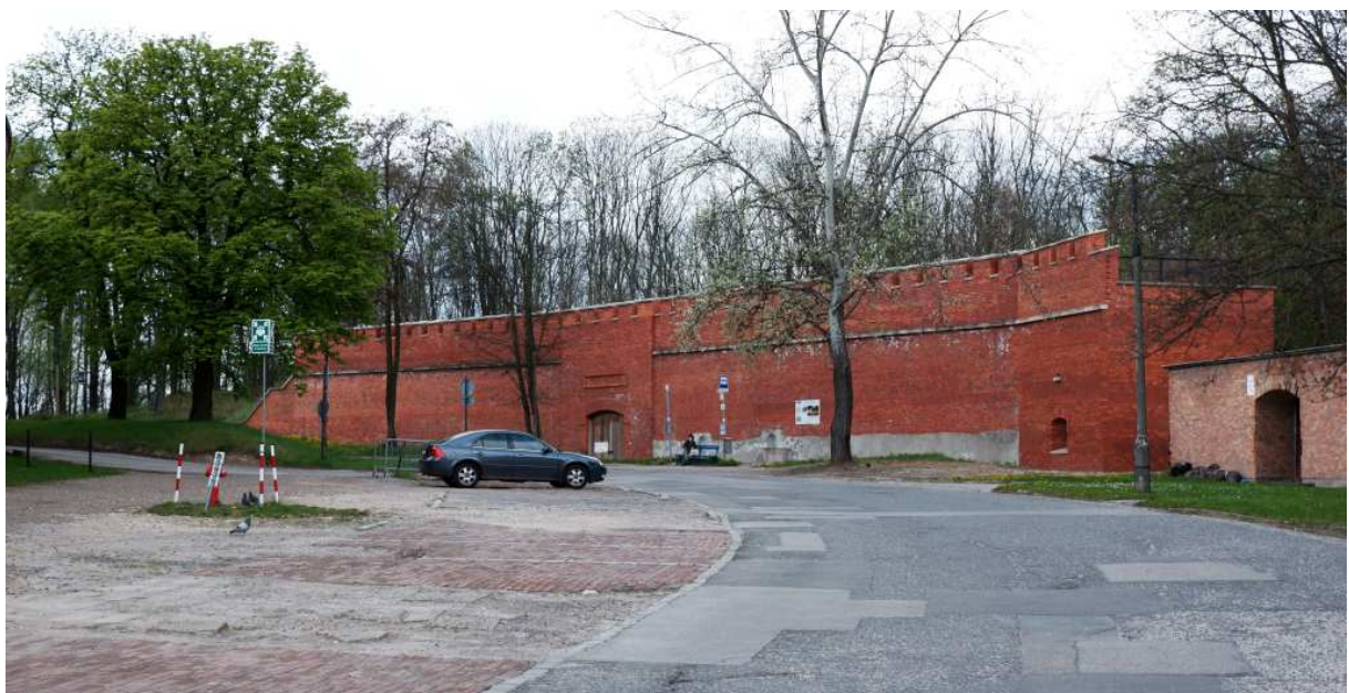
Fot. nr 329. Zrekonstruowana ściana wewnętrzna bastionu nr II. (08.05.2021)
