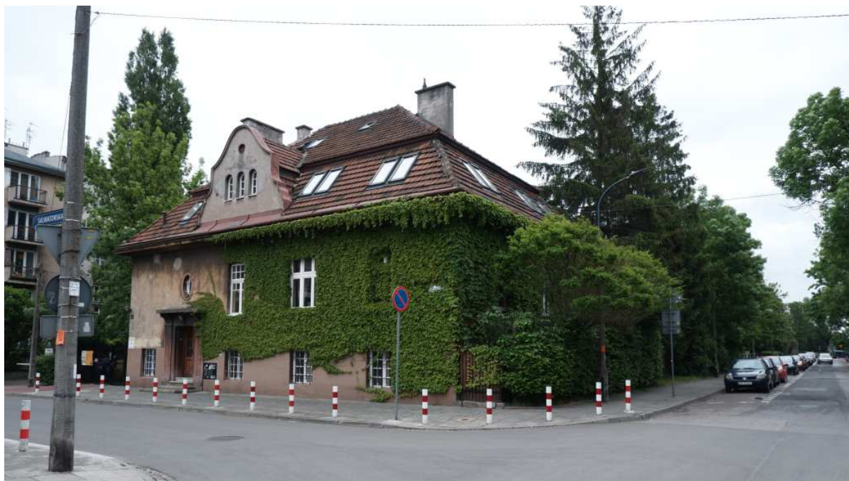
Fot. nr 296. Dawna willa Cyrankiewiczów z ulicy Salvatorskiej 22. (30.05.2021)
