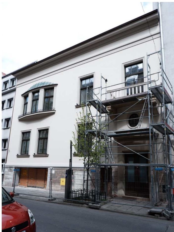
Fot. nr 142. Willa prof. Natansona z ulicy Studenckiej 3 na etapie remontu. (03.05.2021)
