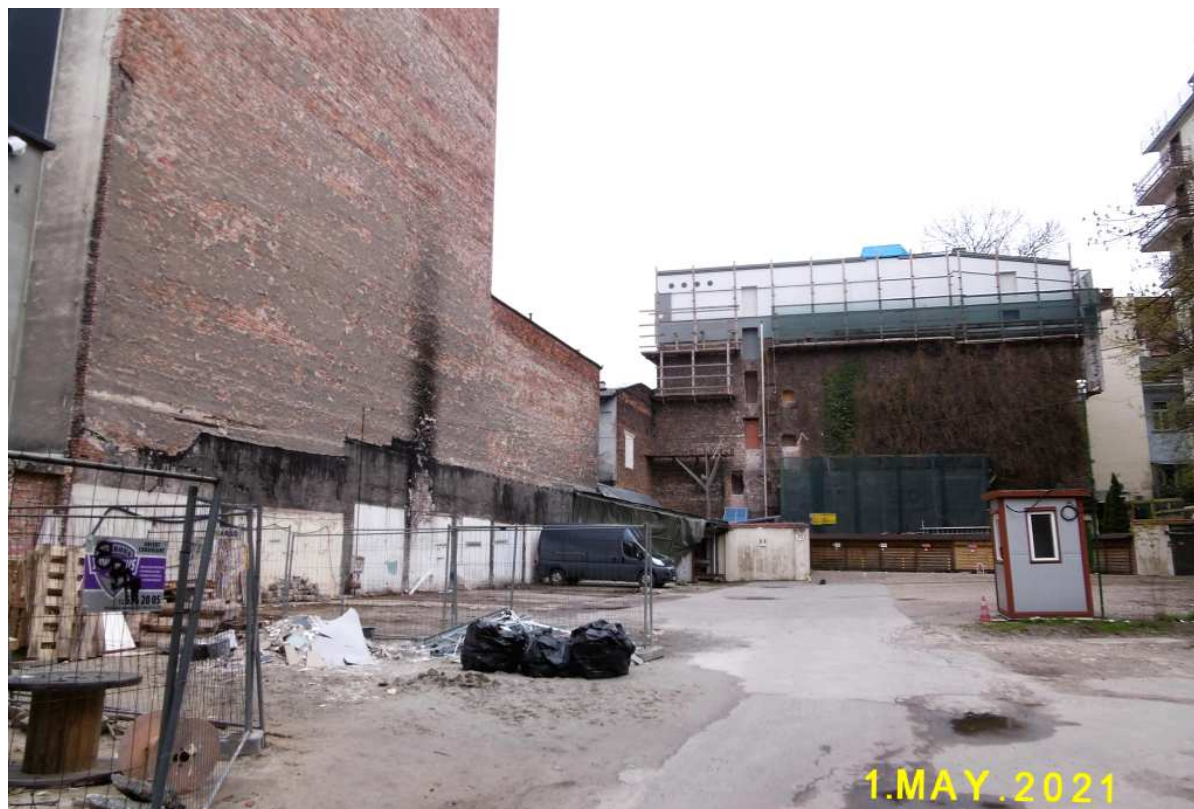
Fot. nr 62 (62-63). Nie ustają prace budowlane na rozległym, zielonym podwórku, ograniczonym zabudową ulic: Karmelickiej 13-17 i Garbarskiej 18-26.
