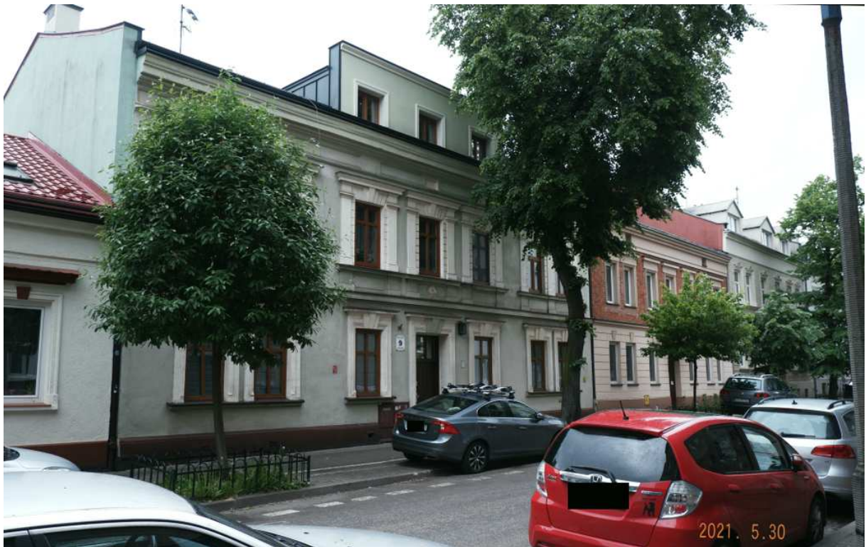
Fot. nr 303. Jednopiętrowe domy spod nr: 5-9.
