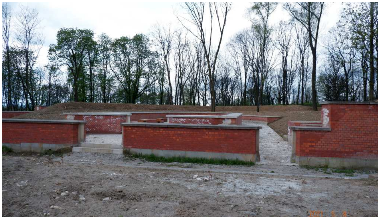
Fot. nr 332 (332-336). Odtworzone mury przyziemia bastei usytuowanej pomiędzy bastionami: I i II.
