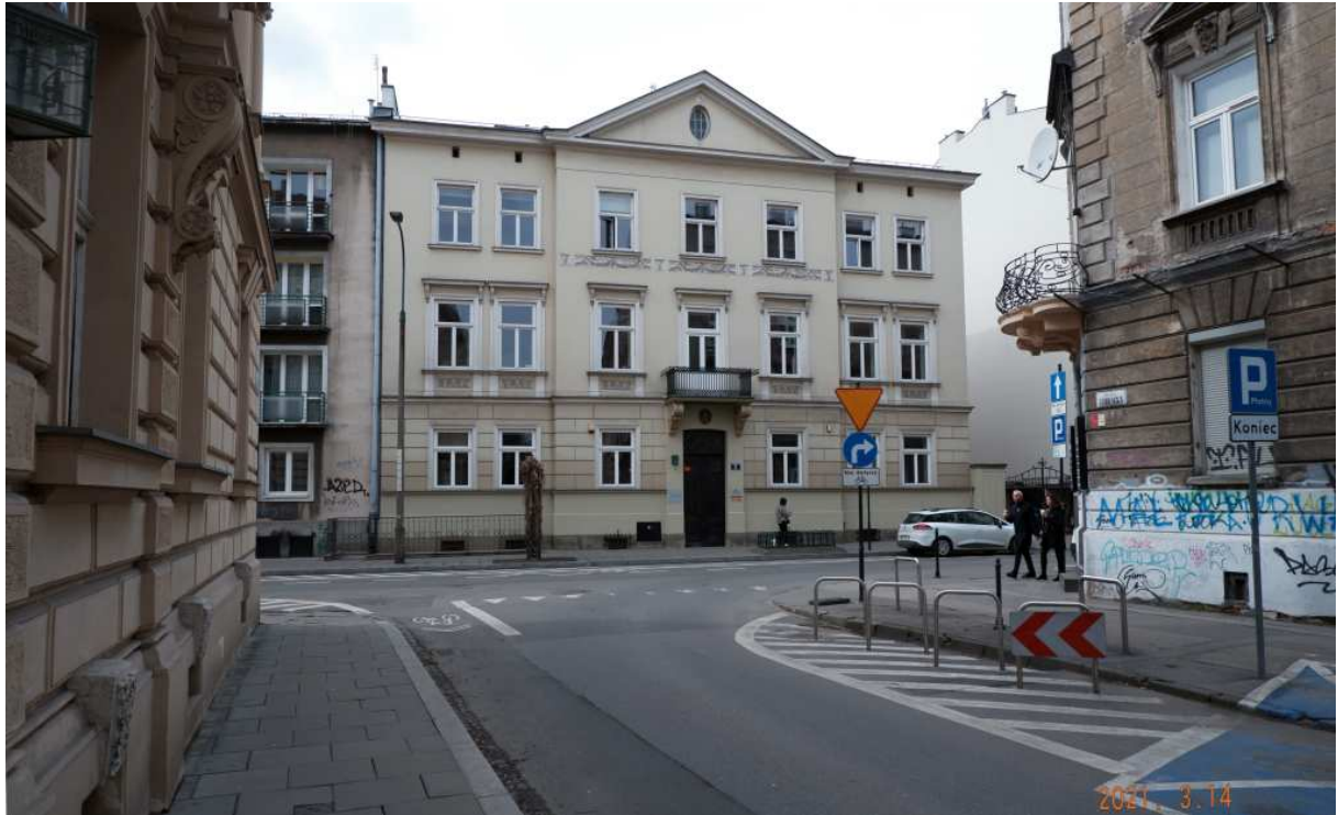
Fot. nr 150 (150-154). Zabudowa ulicy Garncarskiej. Nadbudowany w okresie międzywojennym o jedno piętro dom pod nr 5.
