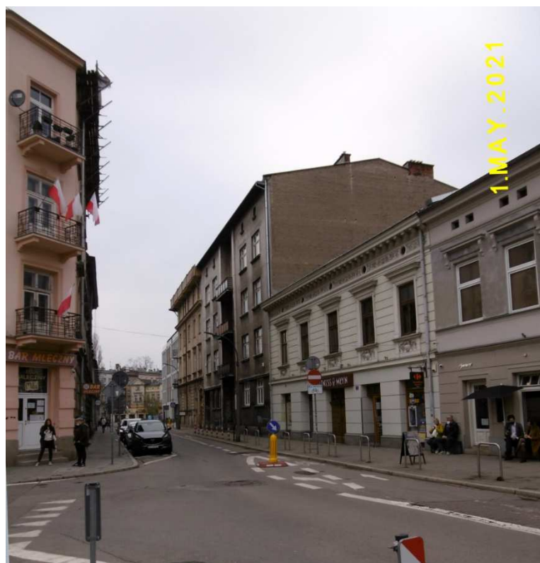
Fot. nr 17. Fragment zabudowy powyżej ulicy Czystej.
