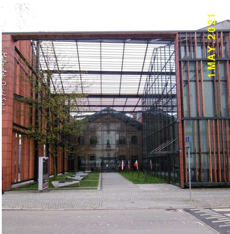
Fot. nr 53. Widok na fasadę Małopolskiego Ogrodu Sztuki spod nr 12.
