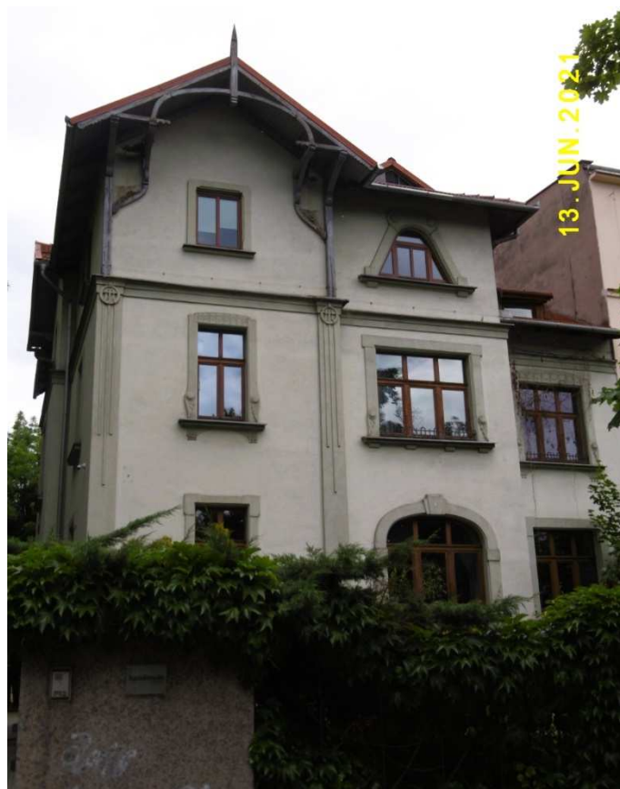
Fot. nr 221. Fasada obiektu.
