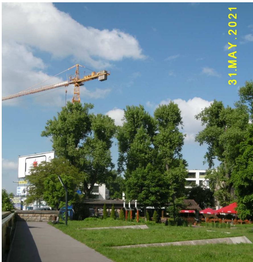
Fot. nr 252 (252-292). Wzdłuż ulicy Kościuszki, gdzie obserwujemy gwałtowne zanikanie historycznego przedmieścia. Plac budowy na posesji pod nr: 20-22.
