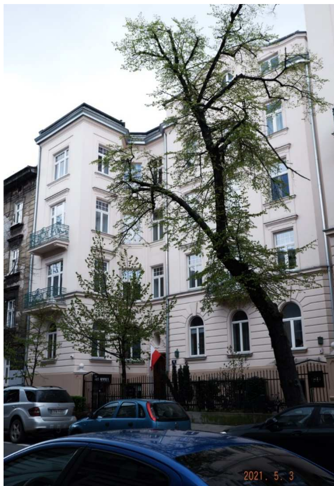
Fot. nr 90. Powstała pod koniec I dekady XX wieku kamienica z ulicy Szlak 11.
