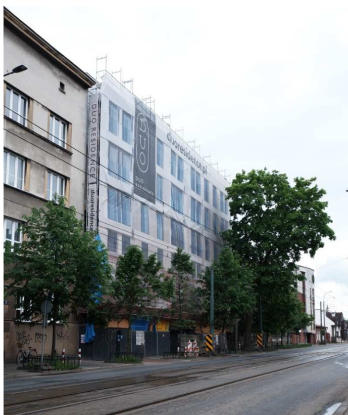
Fot. nr 281 (281-284). Dramatyczna demolka urokliwej, liczącej 110 lat zabudowy we fragmencie pod nr: 60-66. Ściany zewnętrzne domów pod nr: 60-62 zostaną „wklejone” w fasadę powstającego tu czteropiętrowego apartamentowca. (30.05.2021)
