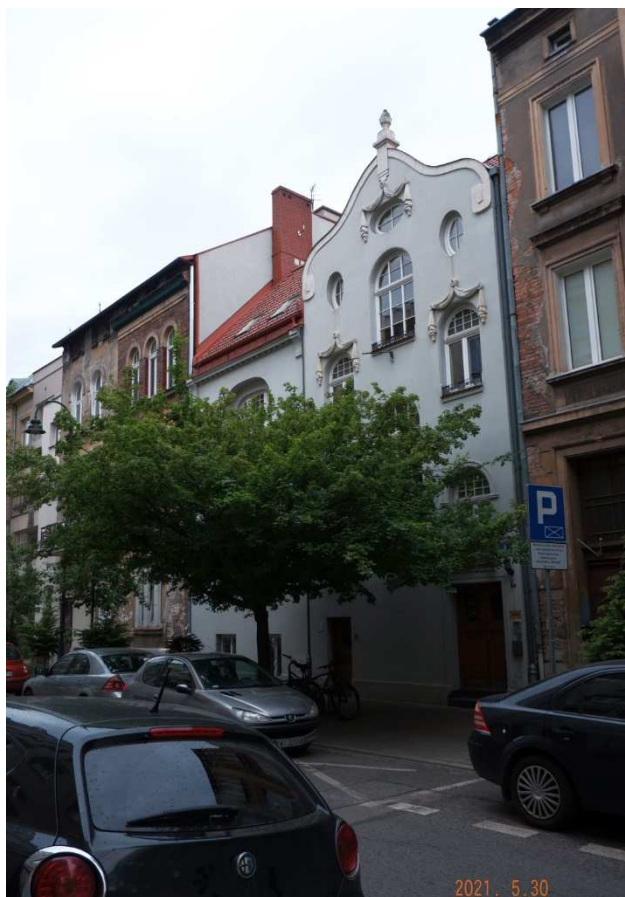
Fot. nr 186 (186-187). Kamienica pod numerem 5.
