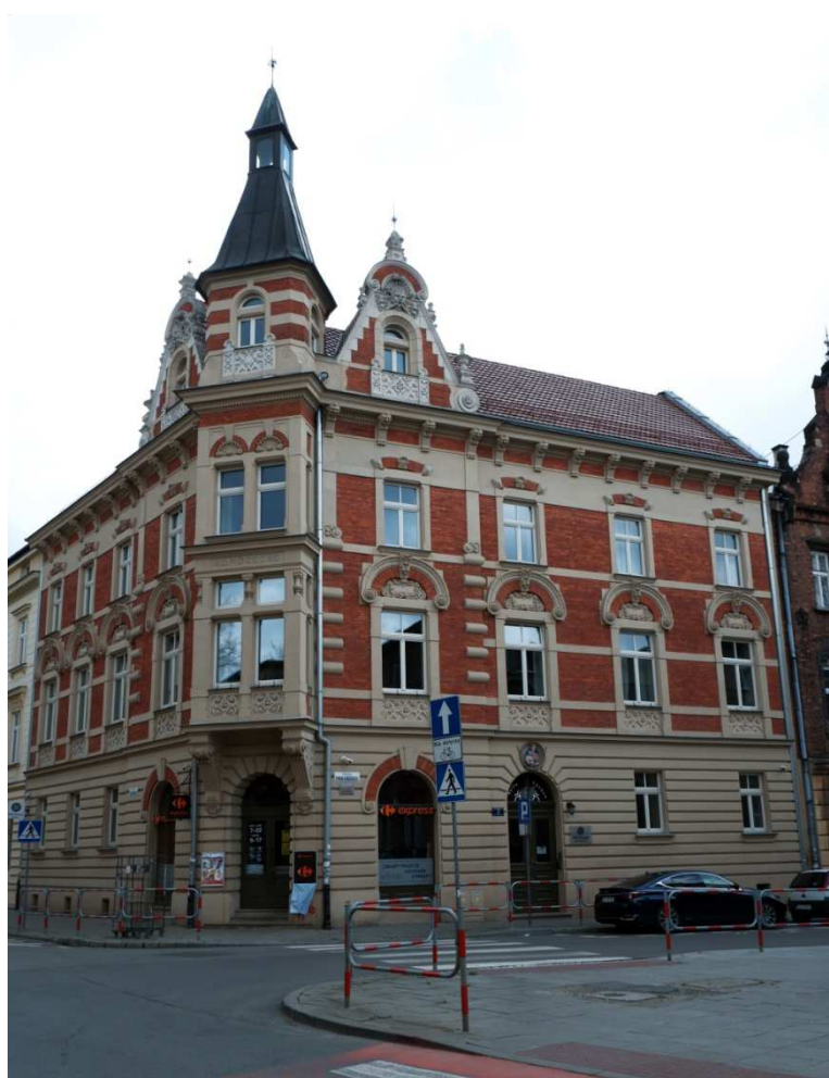
Fot. nr 81(81-84). Odnowiona kamienica spod nr 28 (róg z Siemiradzkiego).(05.03.2021)
