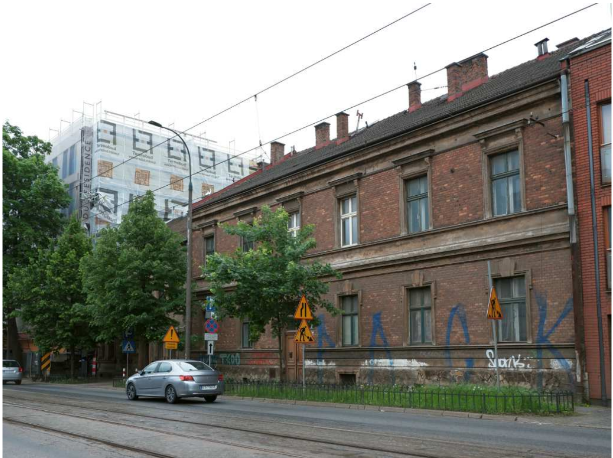
Fot. nr 282 (282-283). Domy pod nr: 64 i 66 jeszcze trwają. Może to już ich ostatnie zdjęcia? (30.05.2021)
