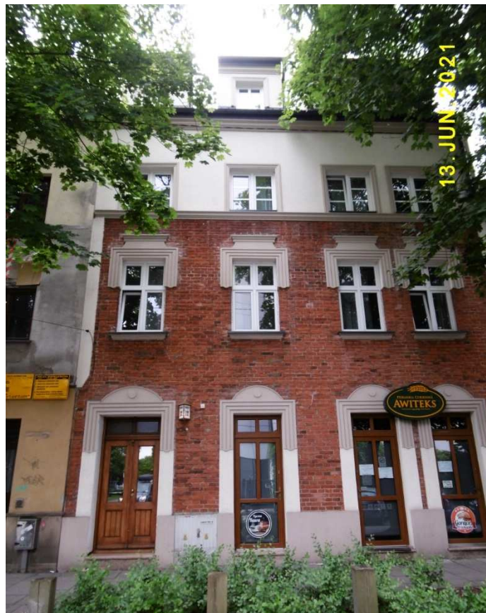
Fot. nr 231. W przypadku obiektu spod nr 12 również w fasadzie zaszły widoczne zmiany.
