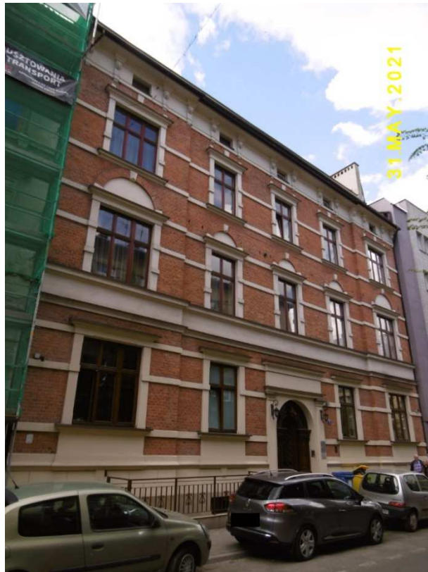
Fot. nr 194 (194-195). Wyremontowana kamienica z przełomu XIX i XX wieku z ulicy Zegadłowicza 4.
