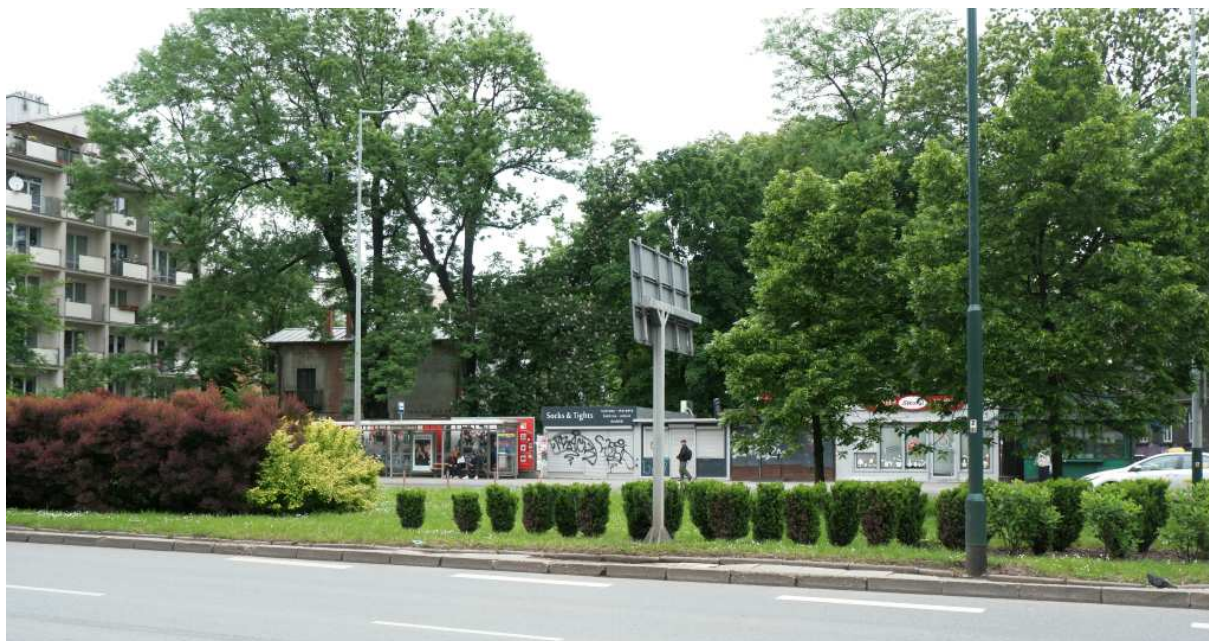
Fot. nr 176 (176-180). Widoki na Kossakówkę na etapie remontu – tu od strony alei Krasińskiego.
