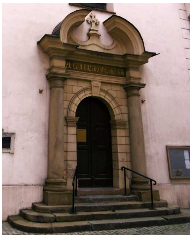
Fot. nr 197. Portal przy wejściu do kościoła.
