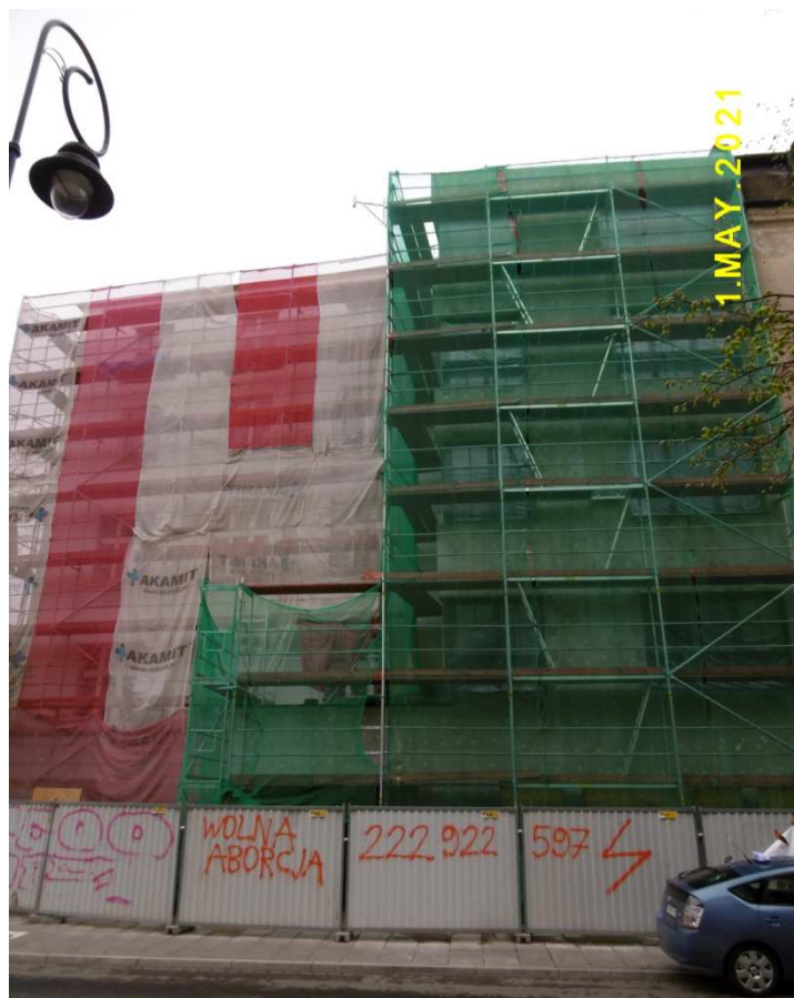
Fot. nr 50 (50-52). Trwa zabudowa poseji pod nr 18, połączona z przebudową narożnej kamienicy spod nr 16/Szujskiego 11.
