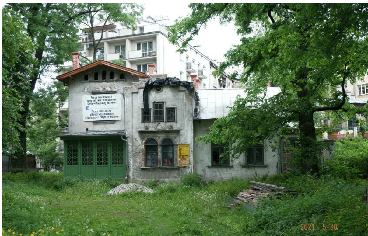
Fot. nr 177 (177-179). Fasada willi od strony ulicy Morawskiego.
