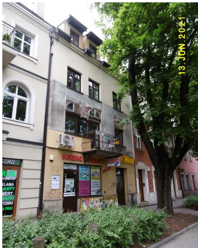
Fot. nr 230. Również współcześnie zmieniona fasada kamieniczki spod nr 10.
