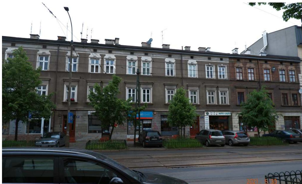
Fot. nr 265 (265-267). Ciągłe dwupiętrowa kamienica pod nr 23 i jej detale.
