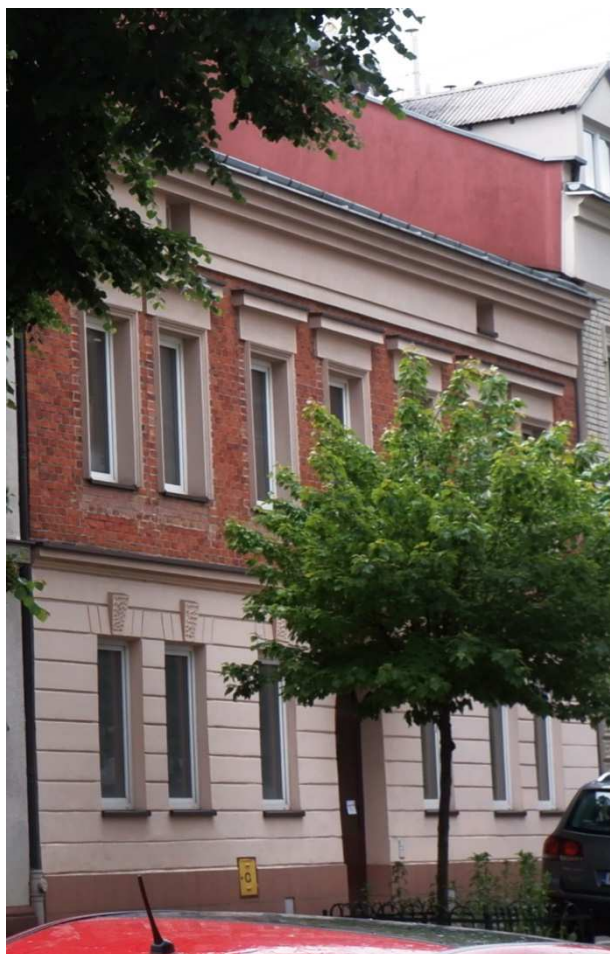
Fot. nr 305. Dom spod nr 7. Urok fasady zniszczyły bezpodziałowe plastiki. (30.05.2021)
