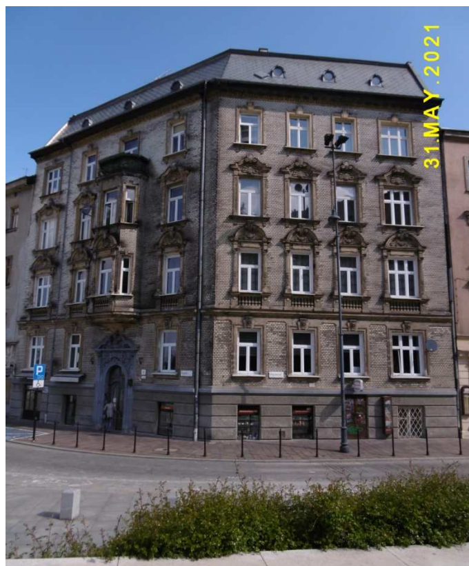
Fot. nr 171. Kamienica z ulicy Powiśle 12.
