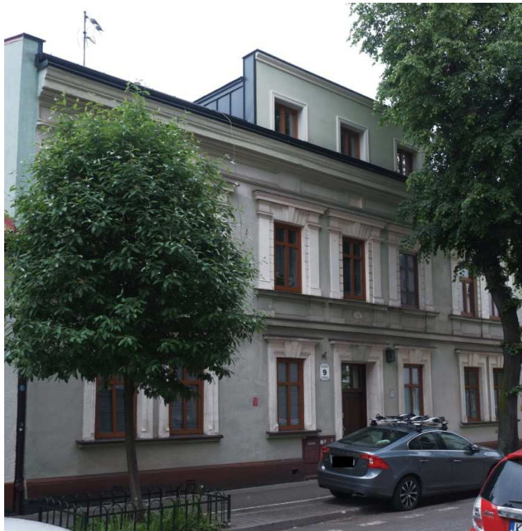
Fot. nr 304. Nadbudowany dom pod nr 9. (30.05.2021)
