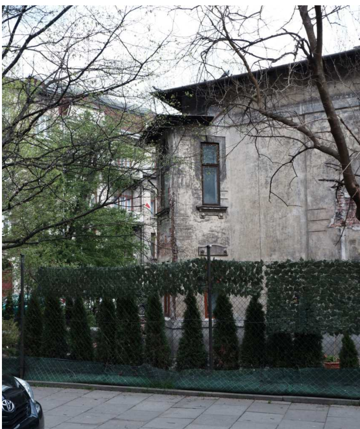
Fot. nr 43(43-44). Narożny wykusz z oryginalnymi jeszcze oknami I piętra. (03.05.2021)
