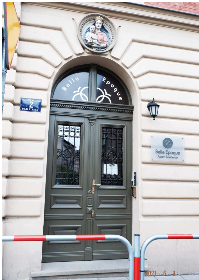
Fot. nr (82-84). Oryginalne detale we fragmencie fasady od strony ulicy Siemiradzkiego 2. Pełne eklektycznego bogactwa drzwi.
