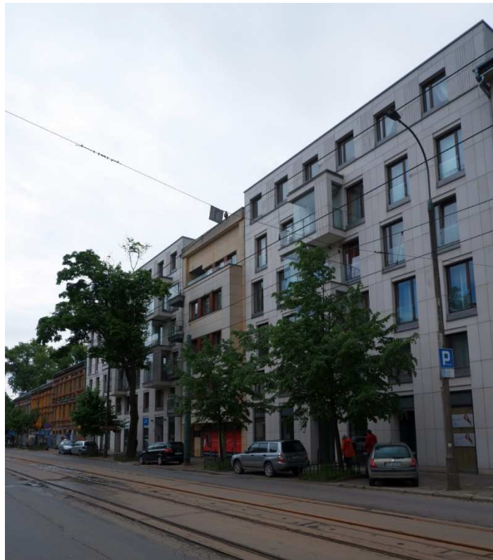
Fot. nr 262. Aparatamentowic pod nr 24, który totalnie zaburza klimat niskiej zabudowy Połwsia. (30.05.2021)
