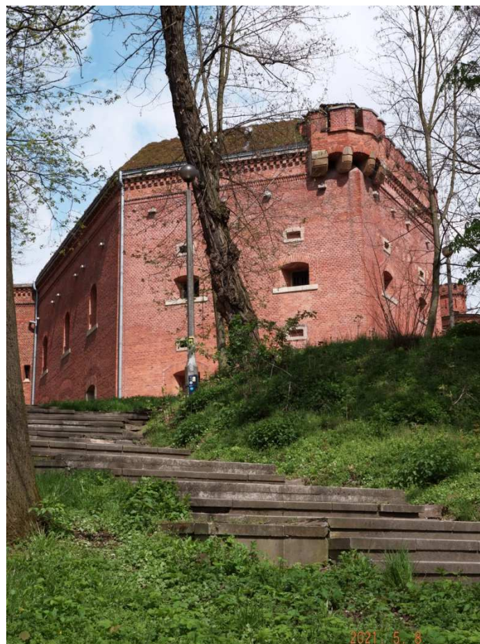
Fot. nr 319 (319-321). Bastion nr V.
