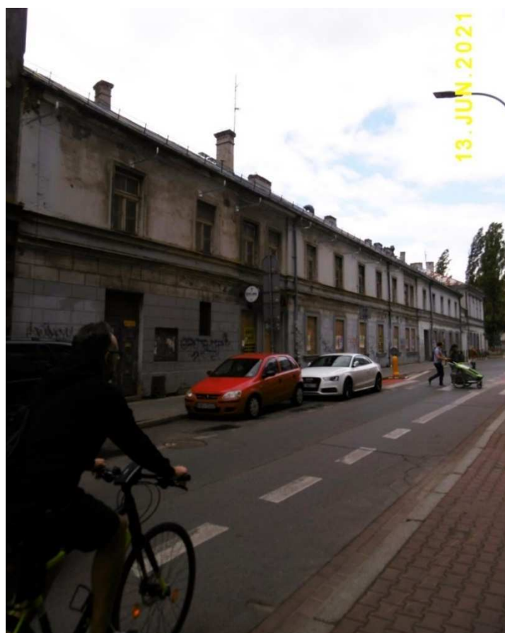
Fot. nr 21 (20-22). Dawny budynek socjalny.
