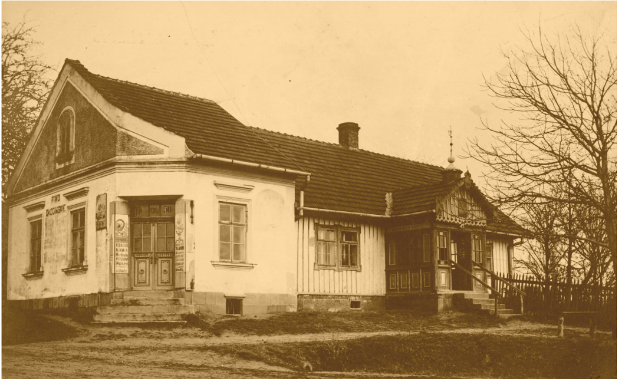
Fot. nr 2. Budynek na „Klinie” (Bilczyce nr 50) w pełnej krasie – jeszcze bez dobudowanego w prawej części fragmentu tzw. stolarni. Stan zapewne gdzieś z początku lat 20.
