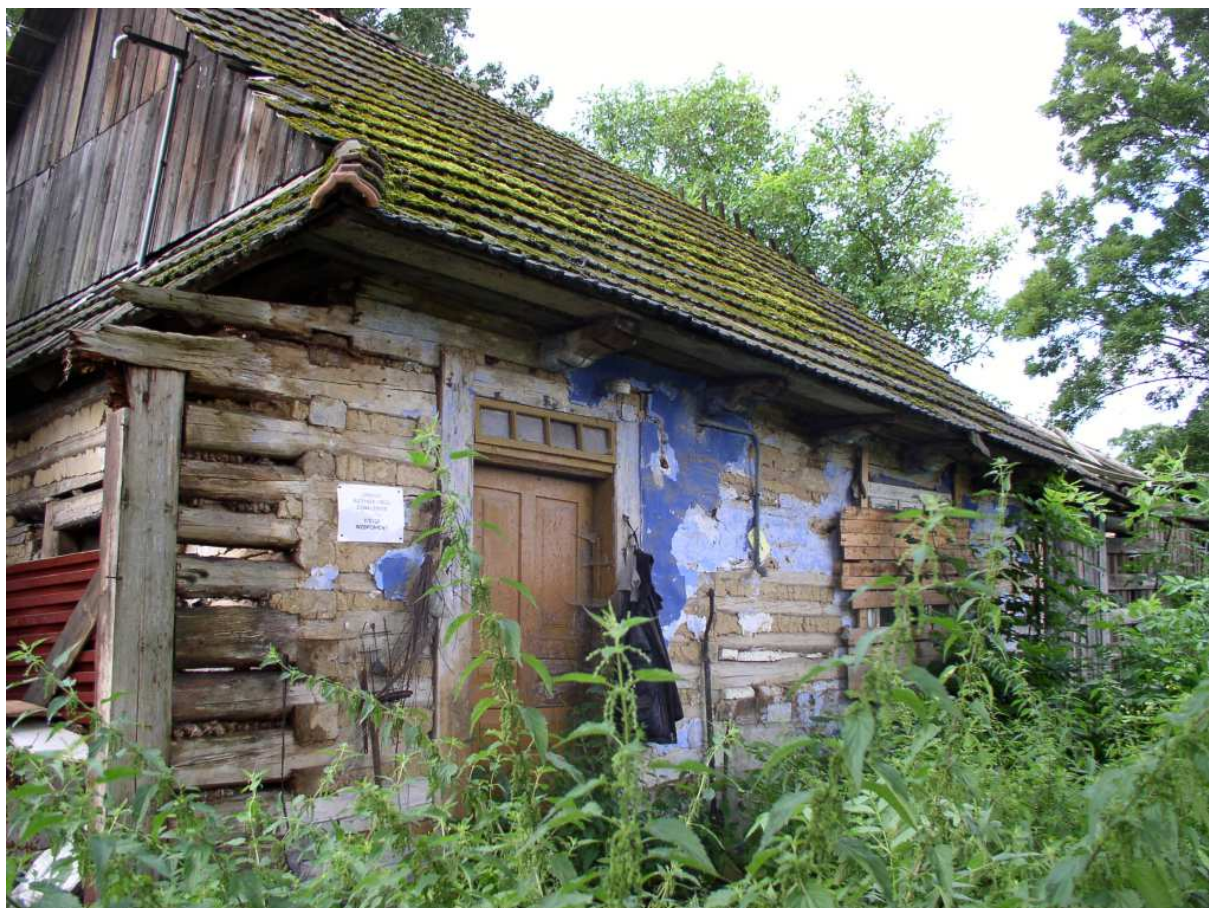
Fot. nr 53. Detale chałupy: konstrukcja zrębowa, pokryta gliną bielona ściana i drzwi z oberlichtem, które pozwalają na datowanie nawet na koniec XIX wieku. (29.07.2009)
