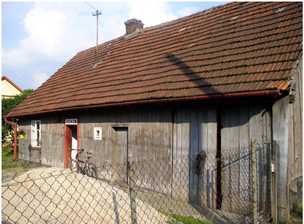
Fot. nr 86. Obita szalunkiem ściana dawnej chałupa – widok z ulicy. (15.06.2010)
