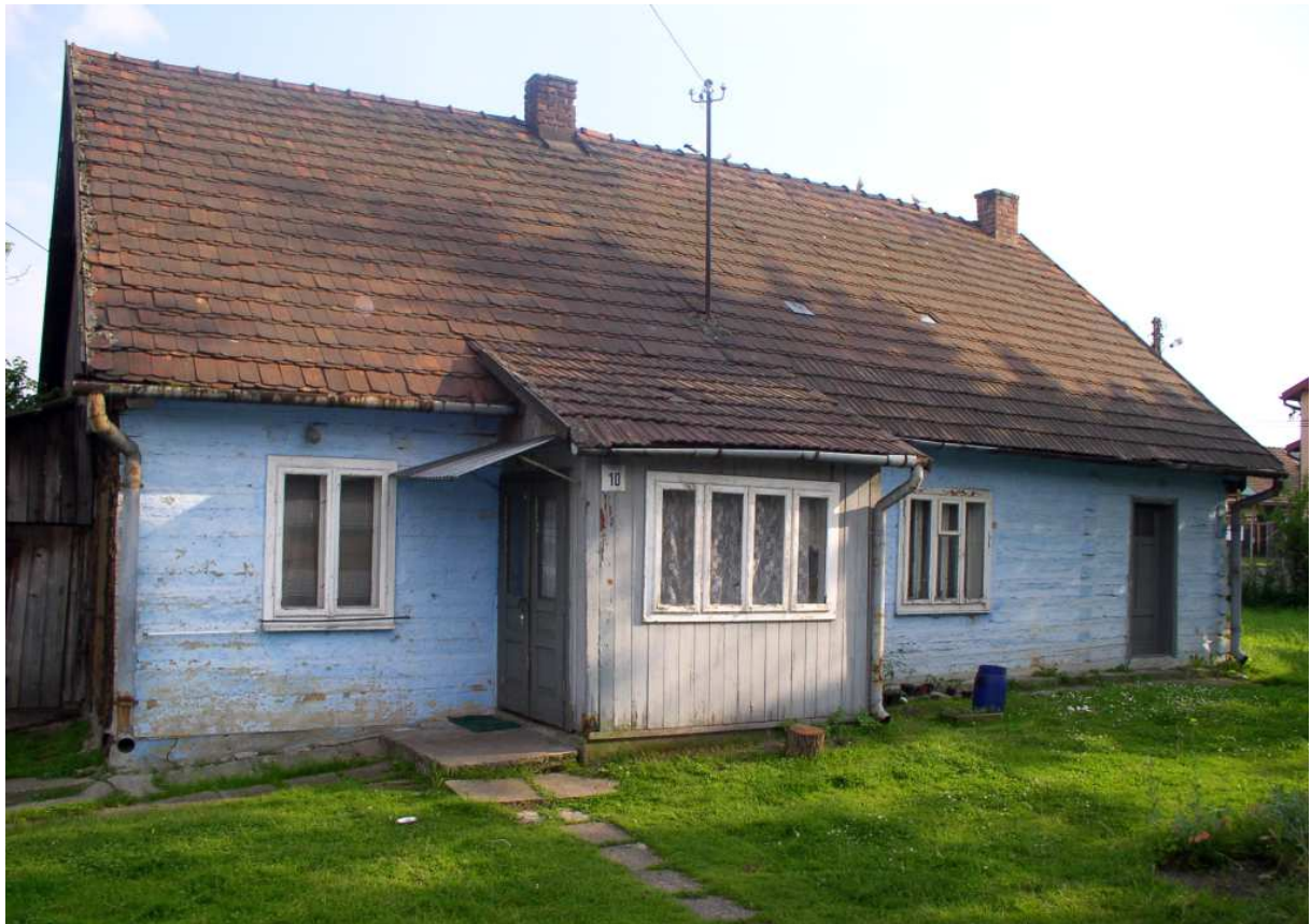
Fot. nr 97 (97-99). Dom pod nr 10 na styku ulic: św. Jana i Kokotowskiej, który powstał zapewne na początku XX wieku. (15.06.2010)
