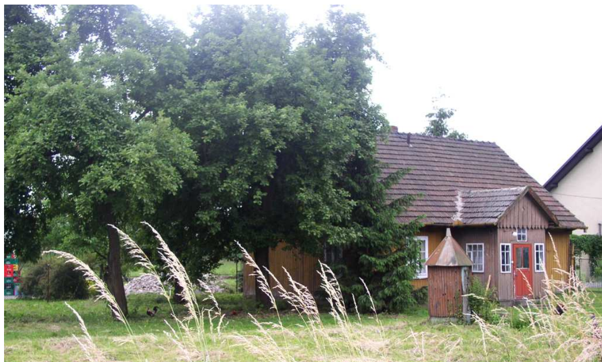
Fot. nr 112 (112-114). Zapewne niespełna 100-letni dom z gankiem pod nr 43, usytuowany na skraju przysiółka Kolonia. Tu widok od strony podwórka. (17.06.2010)
