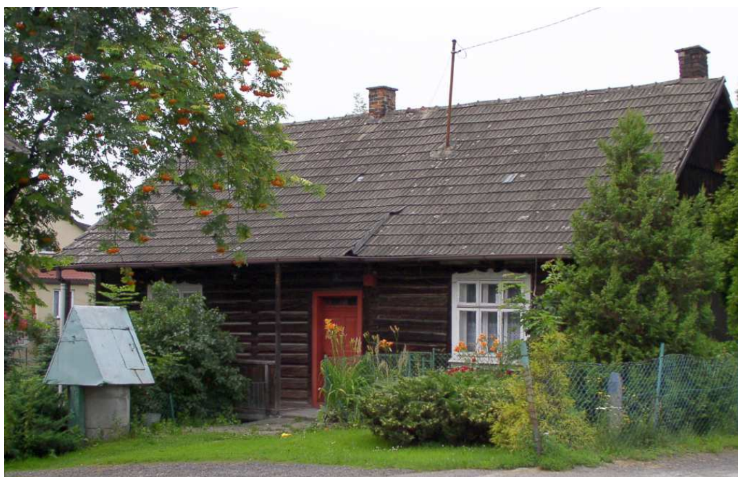
Fot. nr 165. Zapewne około 100-letni dom drewniany o konstrukcji zrębowej, z oknem typu weneckiego w fasadzie. (02.07.2009)
