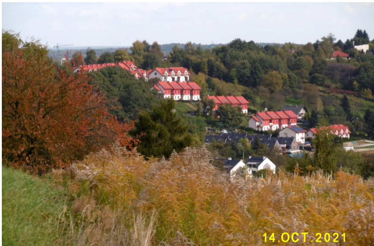
Fot. nr 24. Intensywna zabudowa na narażonym na erozję zboczu już skutkuje osuwaniem się ziemi przy niektórych budynkach. Odkąd sięga moja pamięć u podnóża tej góry zawsze były gliniane osuwiska, ale deweloperowi nie przeszkadzało to zaklinać nauki.
