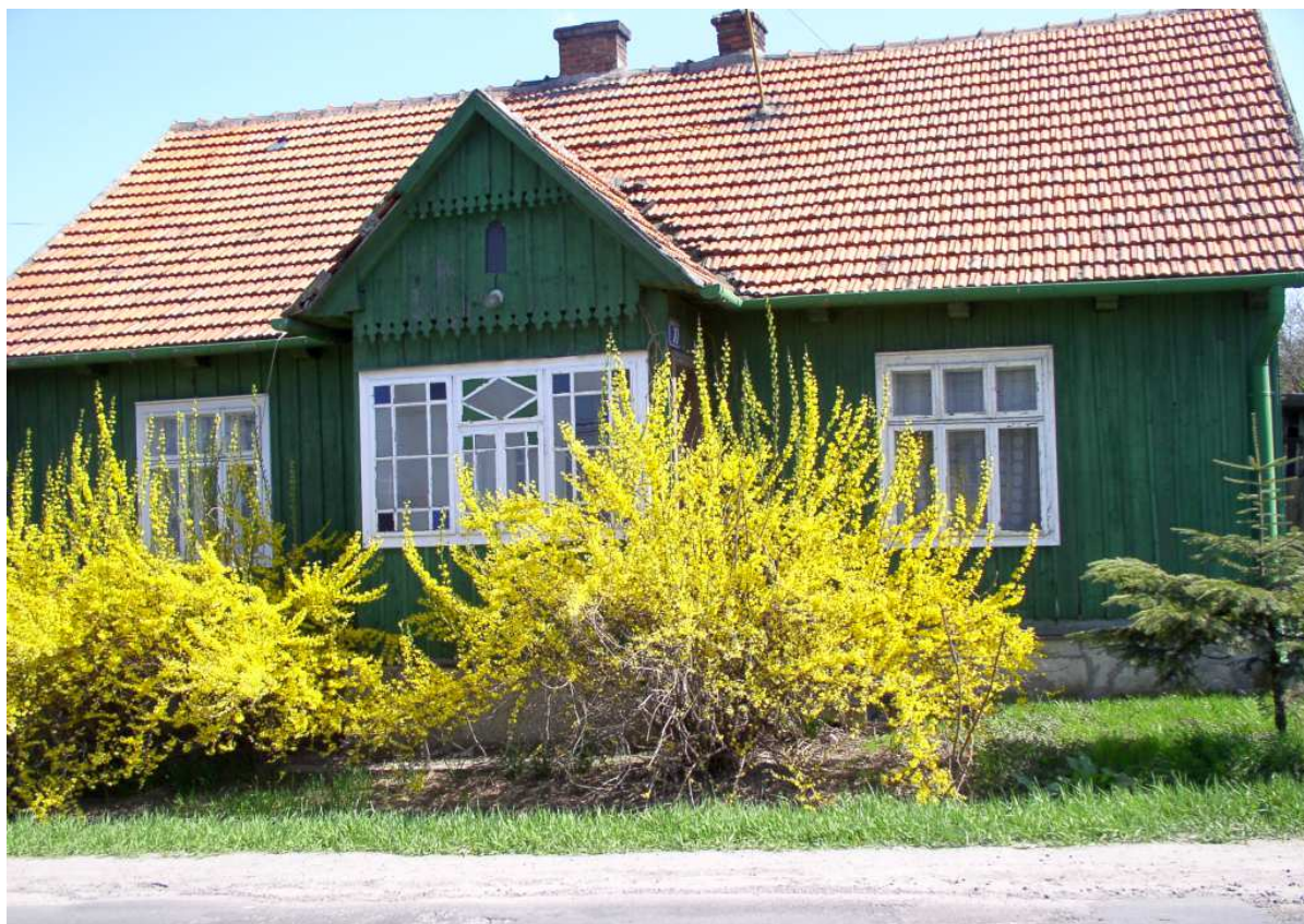
Fot. nr 207. Szczegóły fasady. (16.04.2009)
