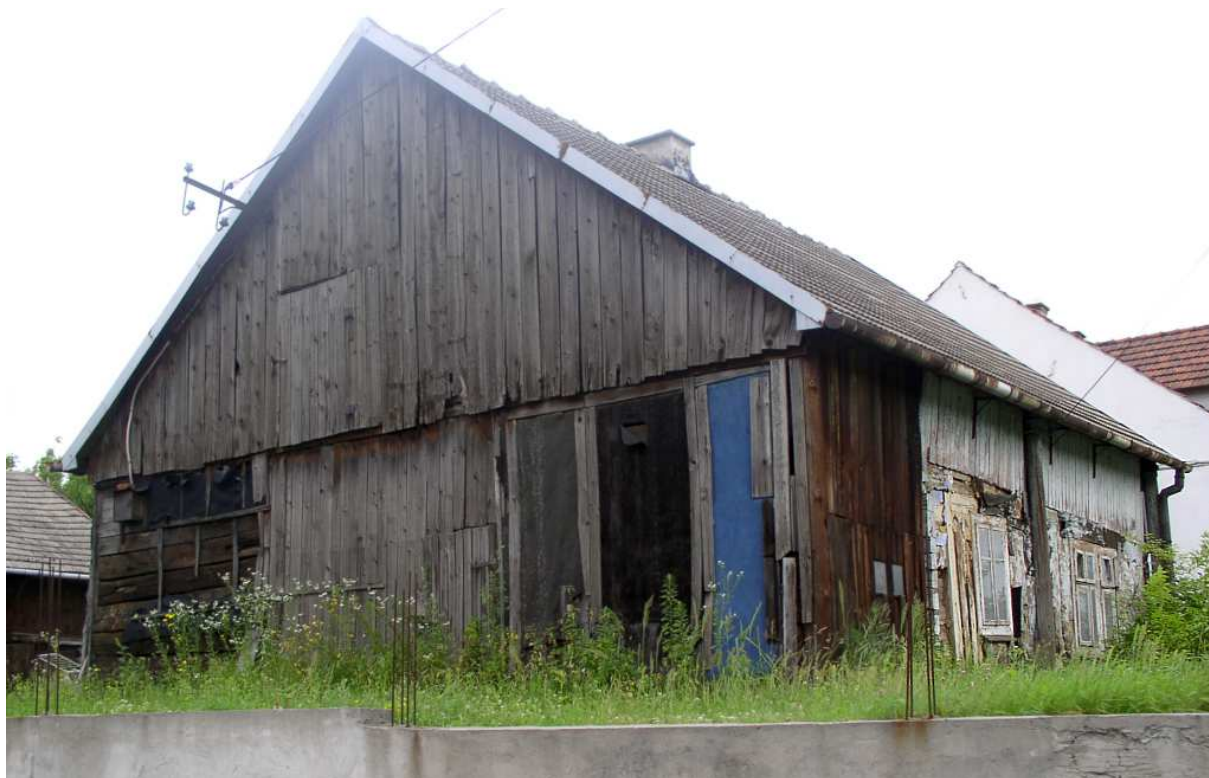
Fot. nr 107. Ściana szczytowa częściowo przebudowanej chałupy. (17.06.2010)
