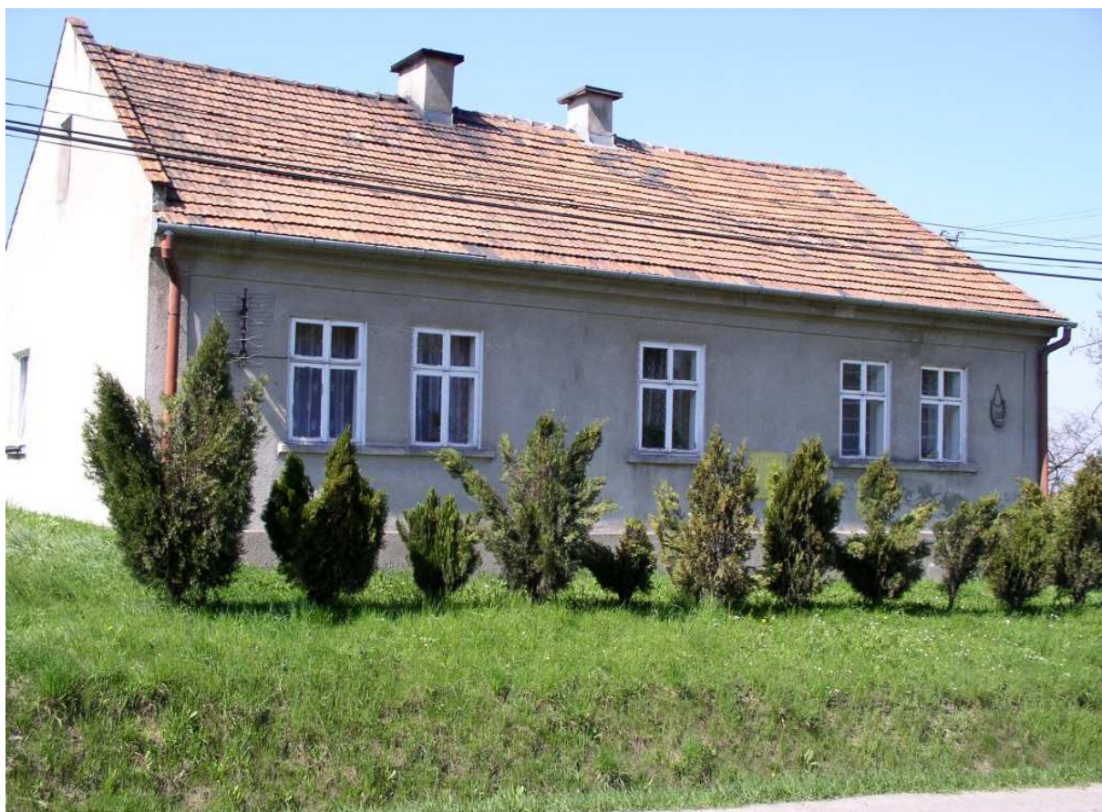
Fot. nr 204. Murowany dom wielorodzinny spod nr 33, charakterystyczny dla zabudowy wsi w połowie XX wieku. (16.04.2009)
