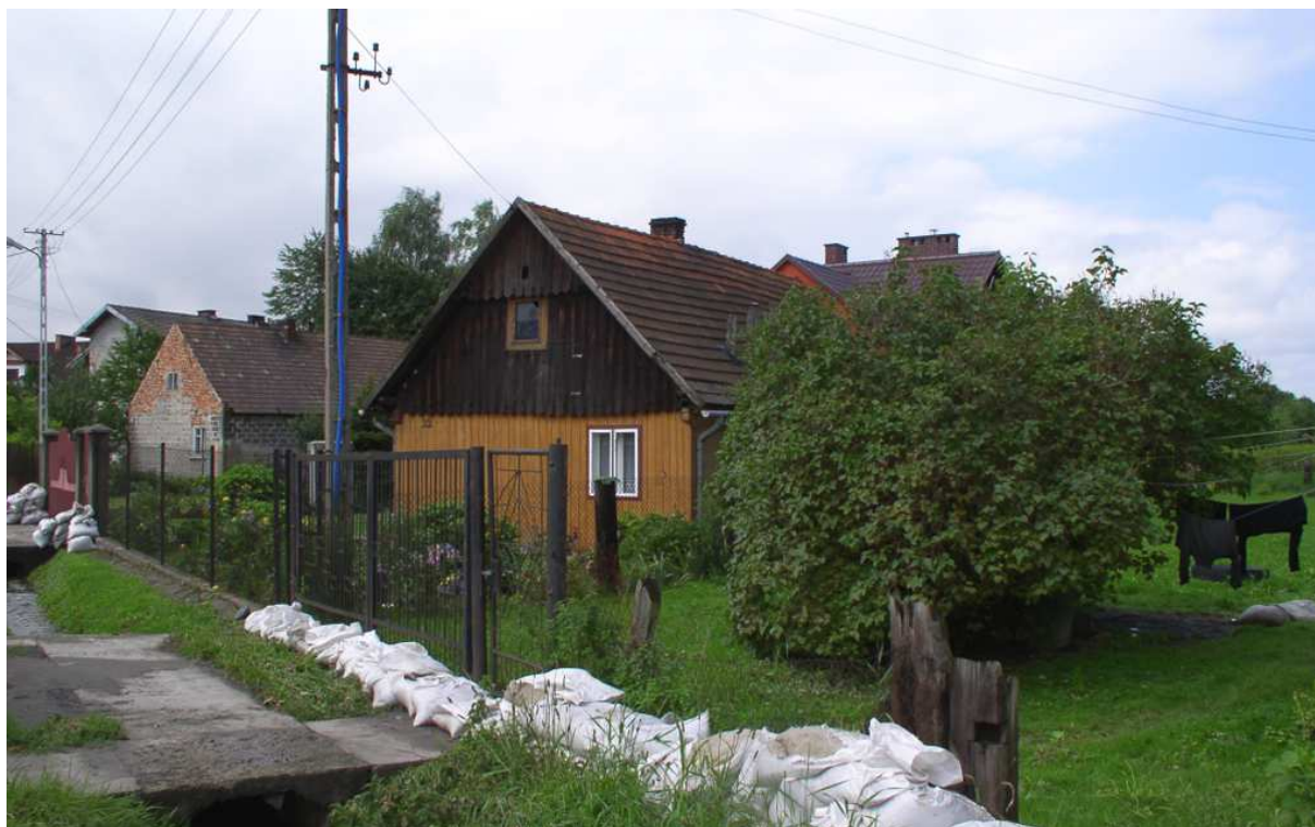
Fot. nr 47. Ściana szczytowa od strony ulicy. (29.07.2009)
