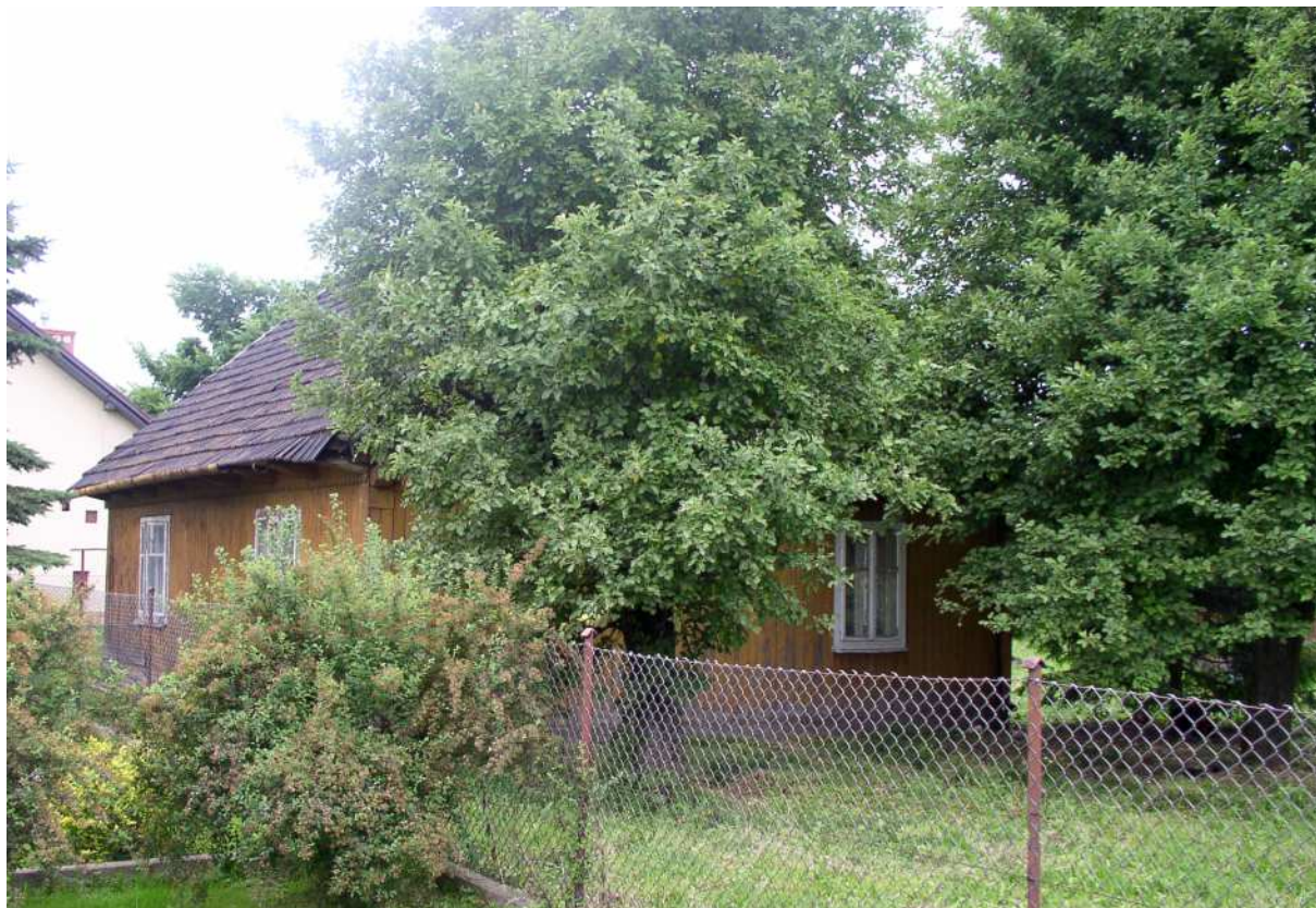
Fot. nr 113 (113-114). Fasada od strony torów kolejowych. (17.06.2010)
