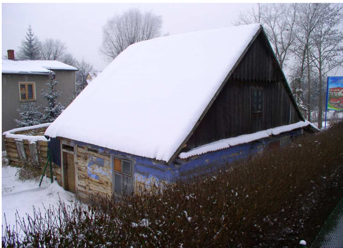
Fot. nr 142 (142-144). Ostatnie chwile chałupy z ulicy Gdowskiej spod nr 77, która mogła powstać II połowie XIX wieku. (18.01.2010)
