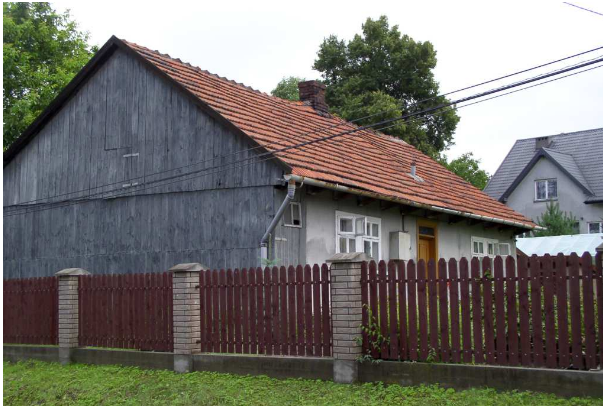
Fot. nr 40 (39-40). Fragment od strony podwórka z oknami typu ościeżnicowego. (29.07.2009)
