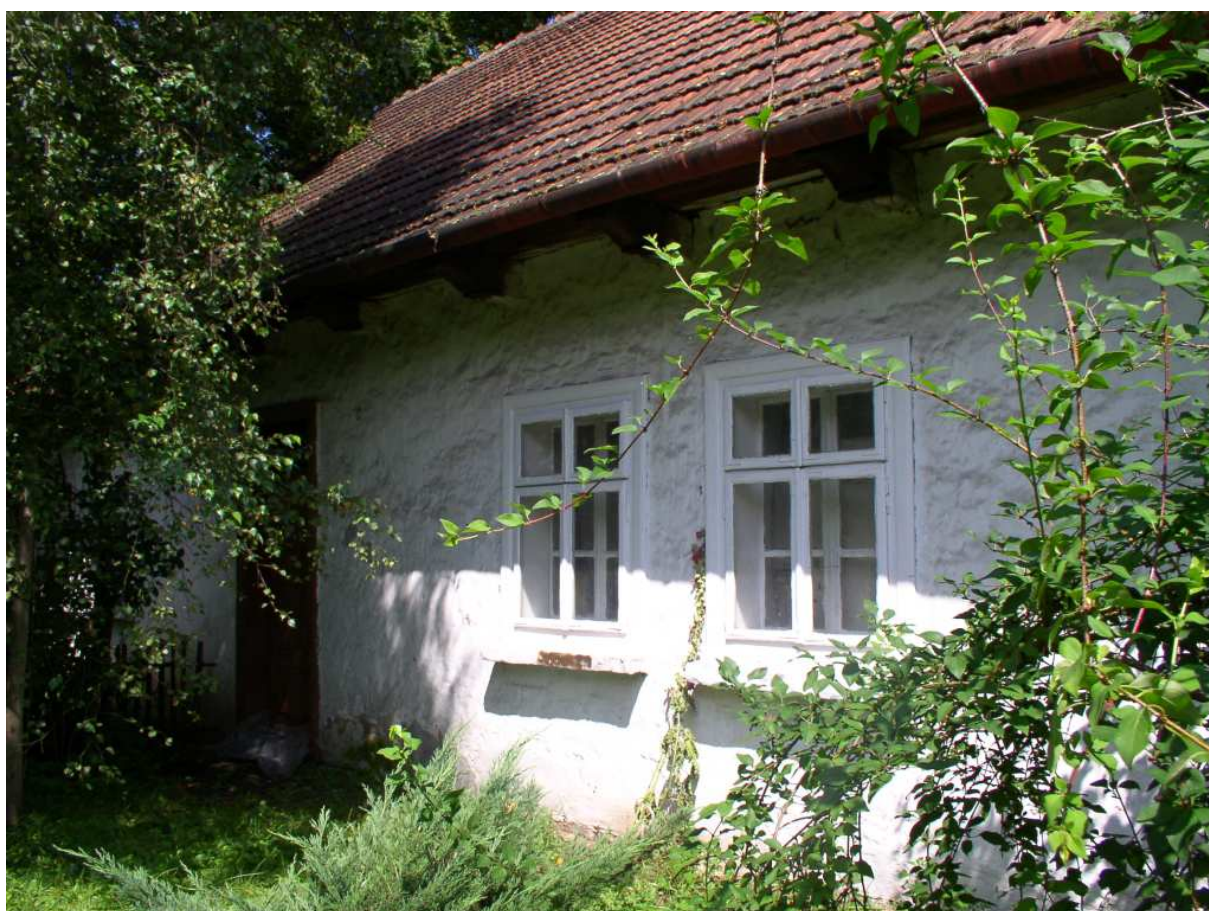
Fot. nr 120. Okna typu ościeżnicowego w przykładnie bielonej fasadzie. (29.07.2009)
