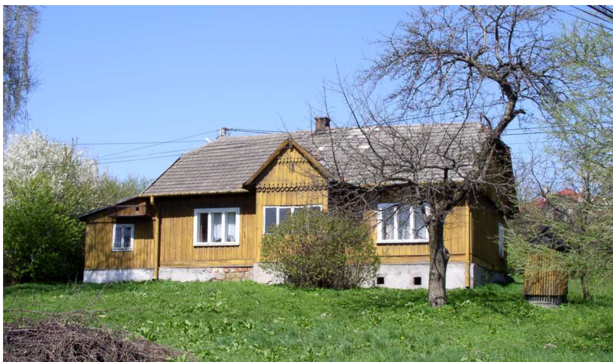
Fot. nr 213. Około 90-letni, drewniany dom z gankiem przy ulicy Dobczyckiej pod 69. Fragment od strony ogrodu. (16.04.2009)
