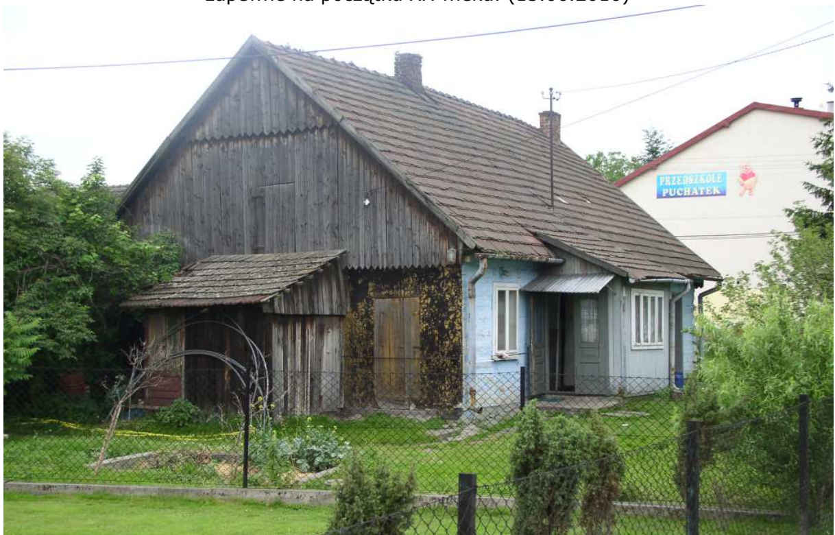
Fot. nr 98 (97-98). Bielona fasada, zapewne z nieco później dobudowanym gankiem, w ujęciu od strony ulicy Kokotowskiej. (17.06.2010)
