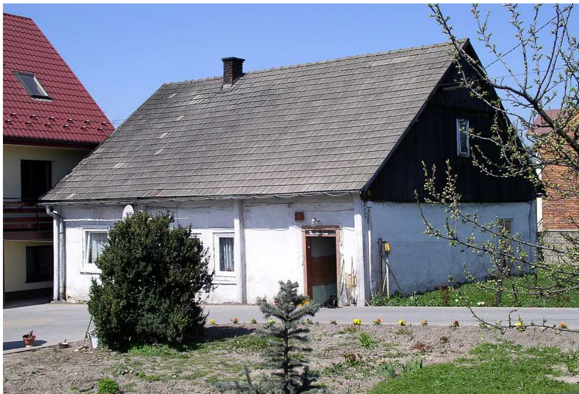
Fot. nr: 186-212. Wzdłuż ulicy Dobczyckiej. Fot. nr 186 (186-188). Współcześnie obudowana i zniekształcona w fasadzie chałupa spod nr 12. (16.04.2009)
