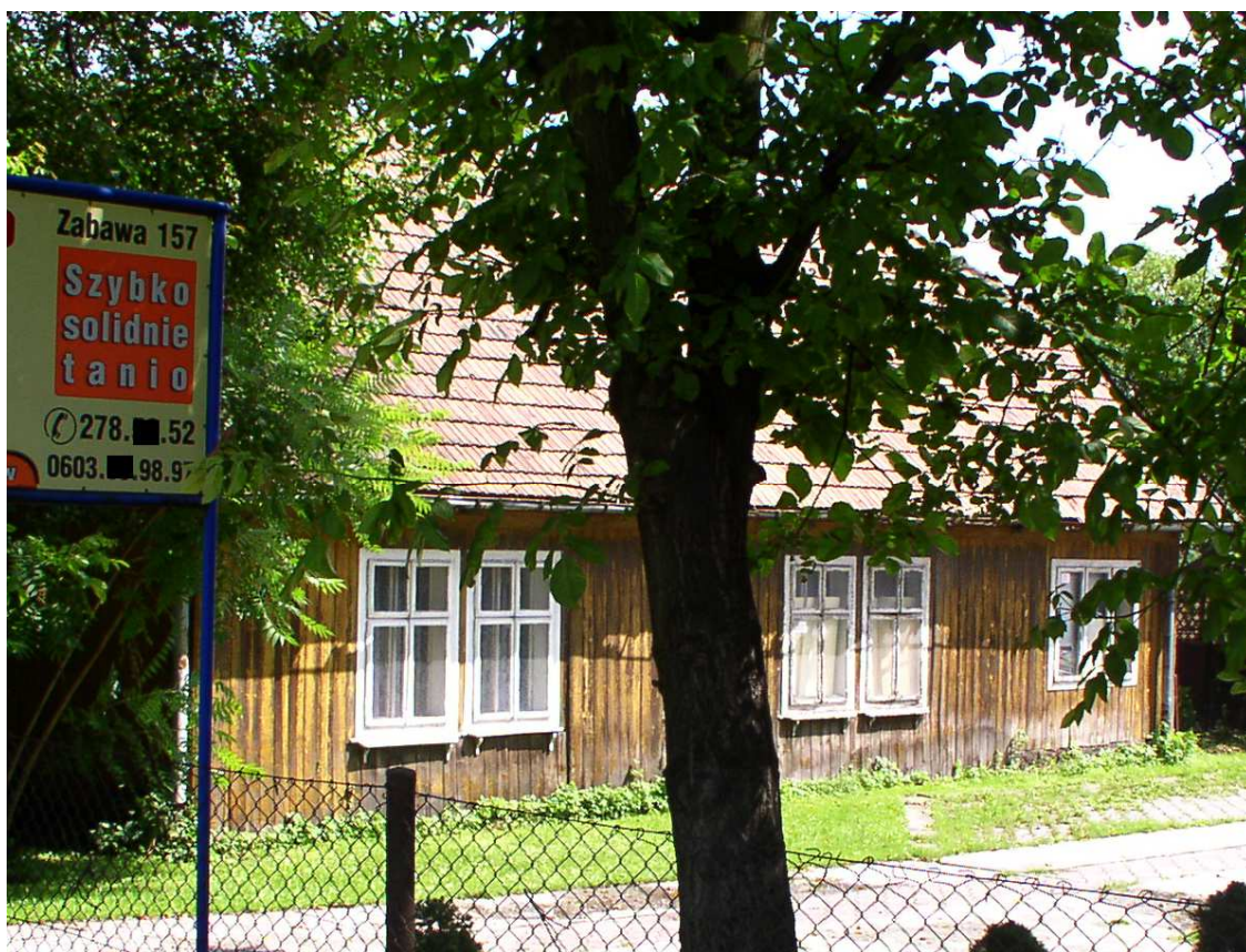
Fot. nr 118. Oszalowana ściana z oryginalnymi oknami typu ościeżnicowego. (29.07.2009)
