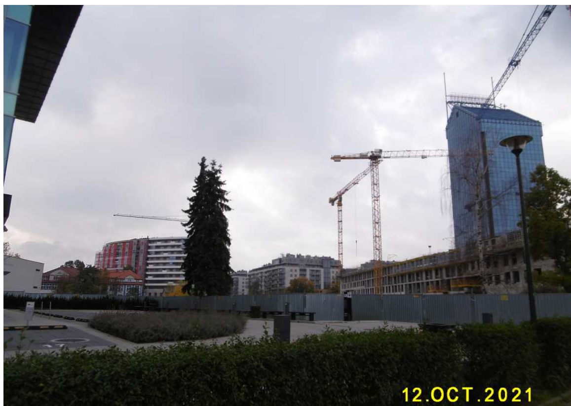
Fot. nr 339 (339-342). Trwa zabudowa przestrzeni wokół „błękitka” PKO przy alei Pokoju.
