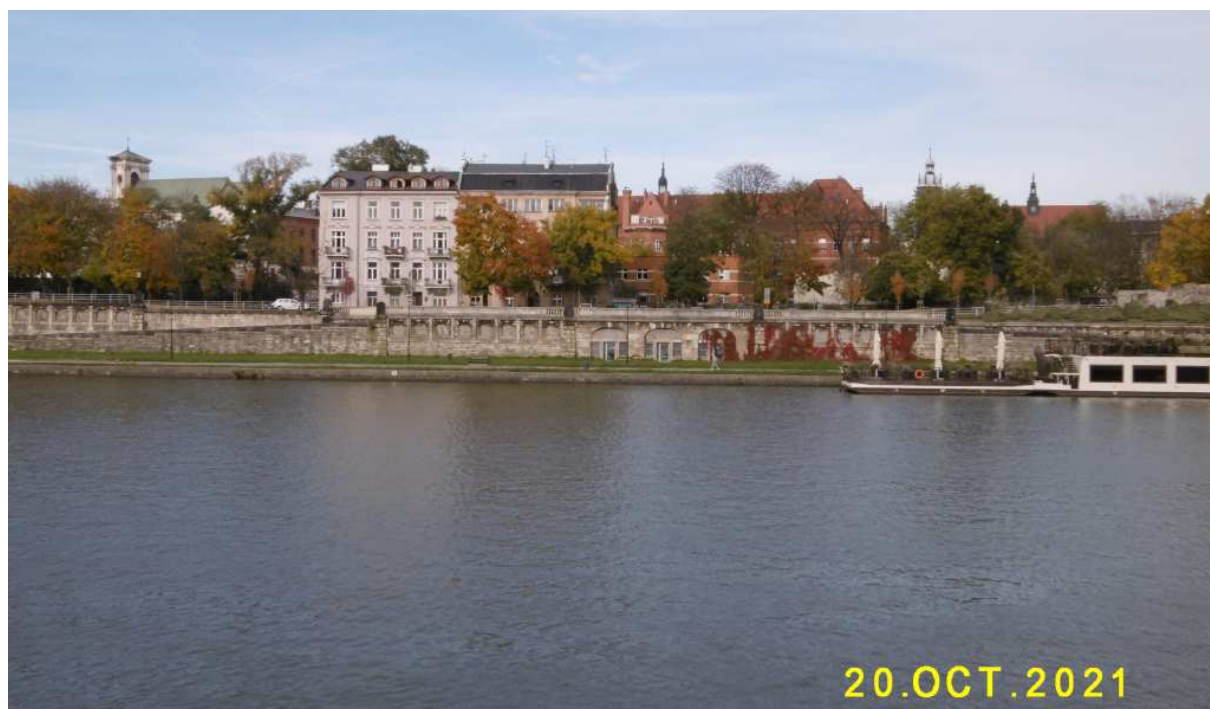
Fot. nr 364. Fragment zabudowy pomiędzy ulicami: Krakowska i Mostową.
