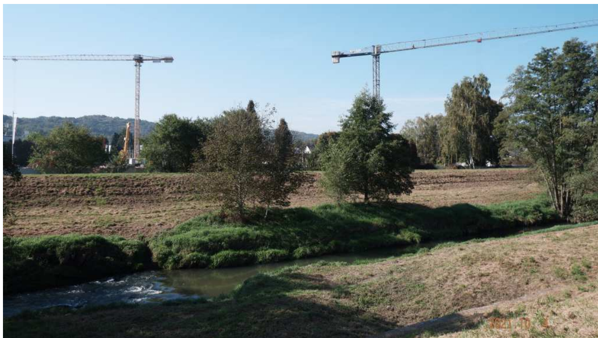
Fot. nr 123. Trwa akcja budowlana na terenie dawnych szklarni i poletek warzywnych pomiędzy wałem Rudawy, a ulicą Królowej Jadwigi.
