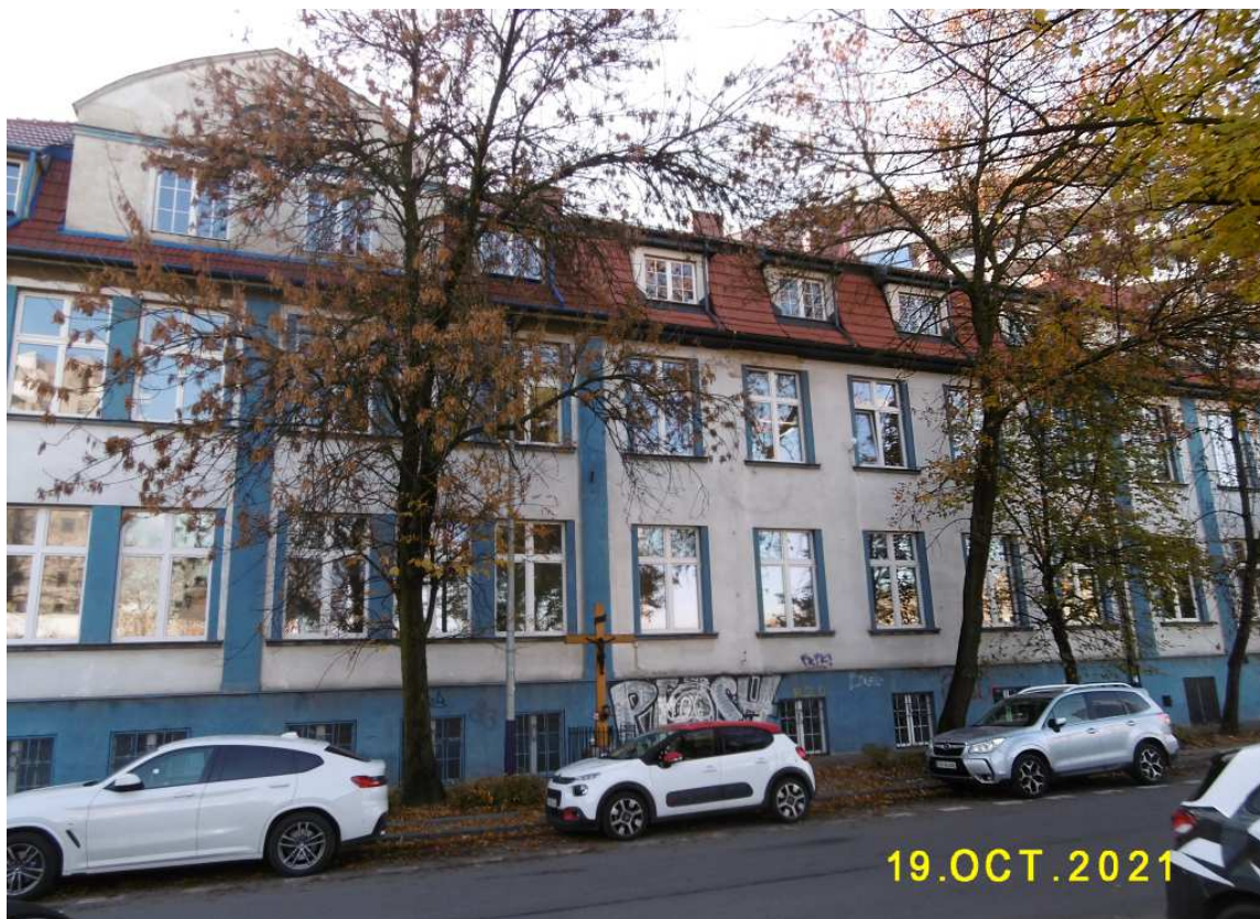
Fot. nr 343 (343-344). Budynek administracyjny dawnej fabryki Zieleniewskiego z ulicy Grzegórzeckiej 69, który jest już jedyną pamiątką materialną po tej znanej marce.
