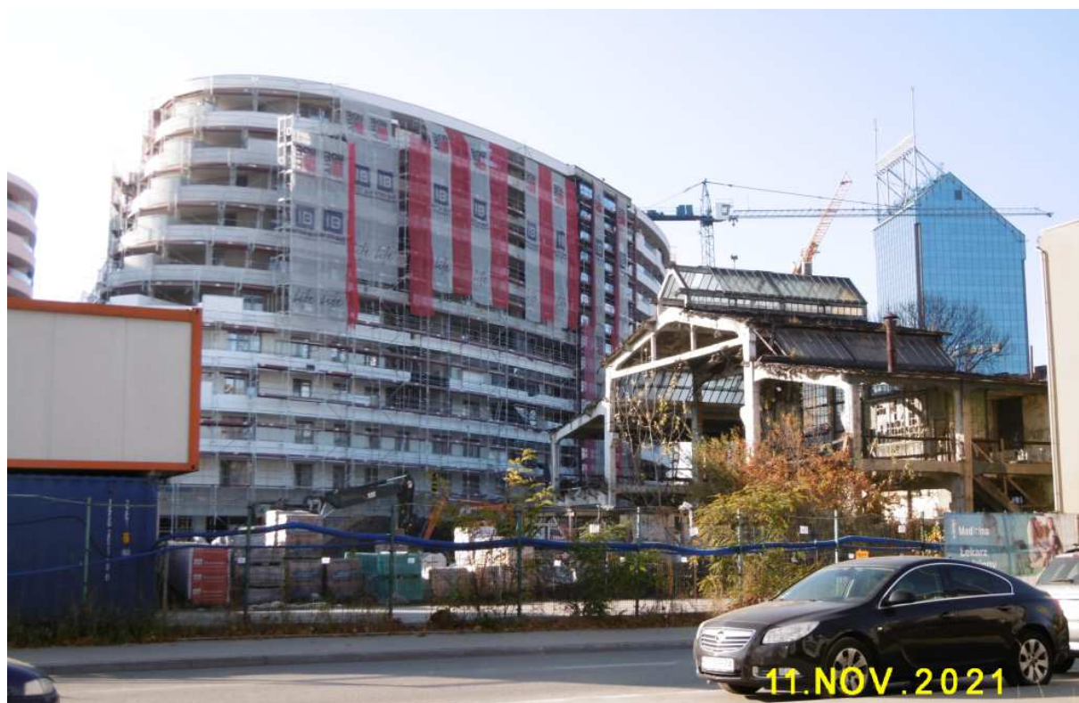
Fot. nr 352 (352-353). Współczesna zabudowa na terenie dawnej fabryki Zieleniewskiego. Widoki z ulicy Zieleniewskiego.
