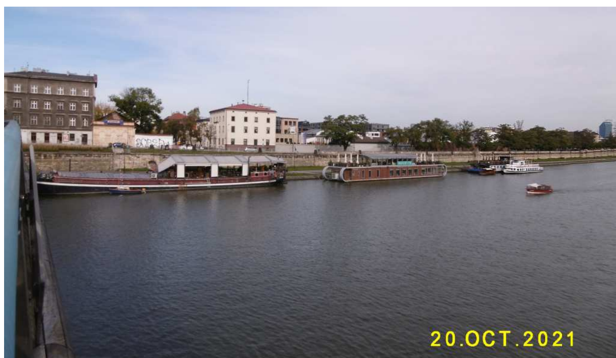
Fot. nr 368. W stronę zabudowań dawnych: gazowni i elektrowni.
