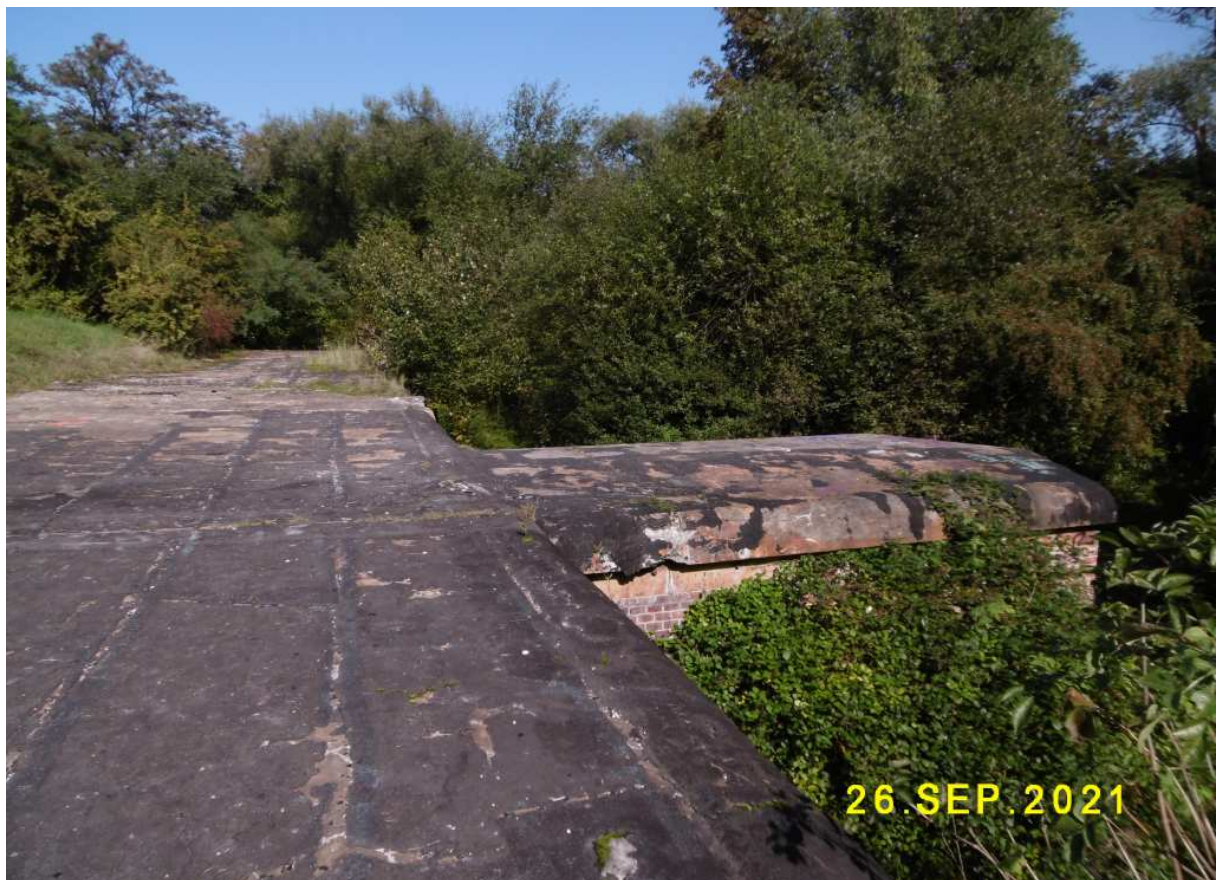
Fot. nr 312. Na dachu fortu.
