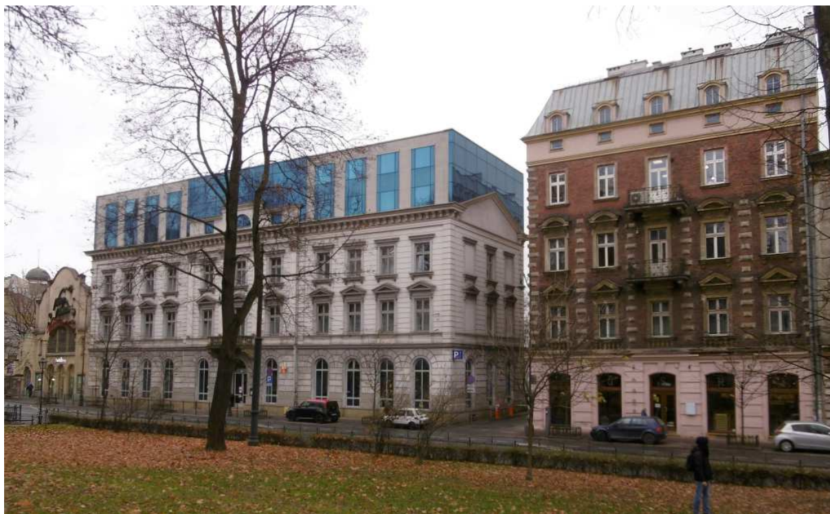
Fot. nr 47. Kontynuowana jest nadbudowa kamienic przy ul. św. Gertrudy. (19.11.2021)
