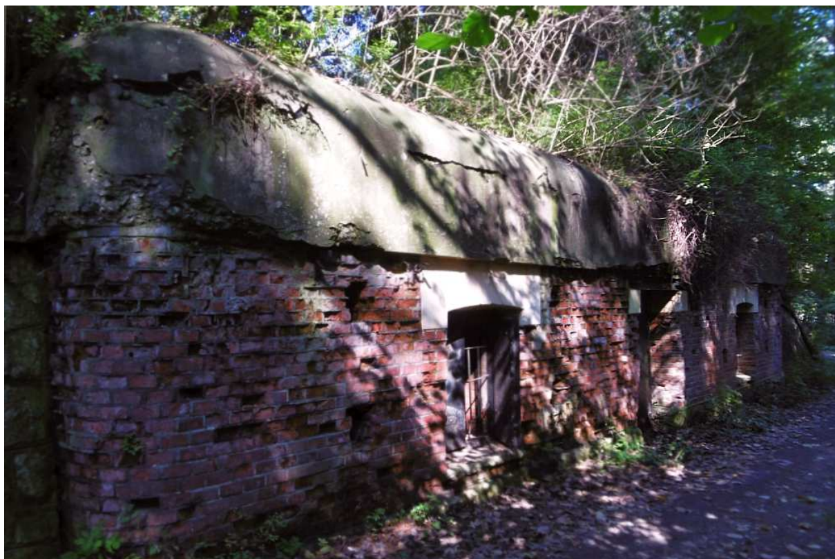
Fot. nr 239 (239-244). Schron amunicyjny przy forcie nr 41 Bronowice i jego detale. (26.09.2021)
