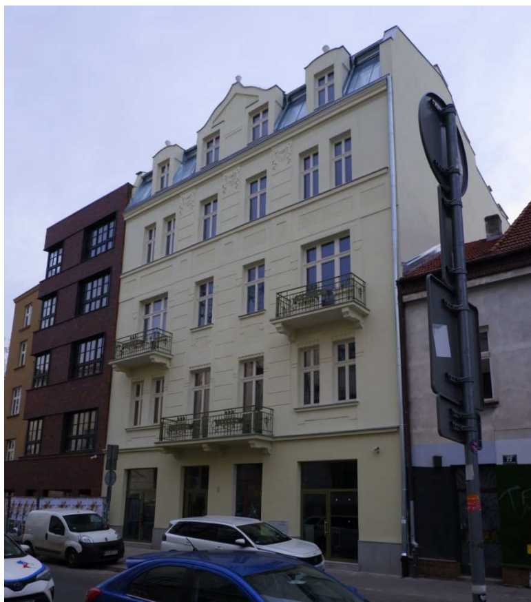
Fot. nr 97. Świeżo odnowiona fasada 100-letniej kamienicy pod nr 20. (04.12.2021)
