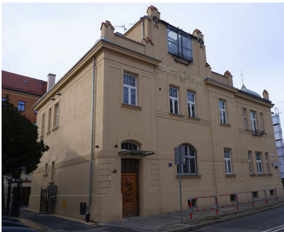
Fot. nr 83 (83-84). Fasada od strony ulicy Czarnowiejskiej. (04.12.2021)
