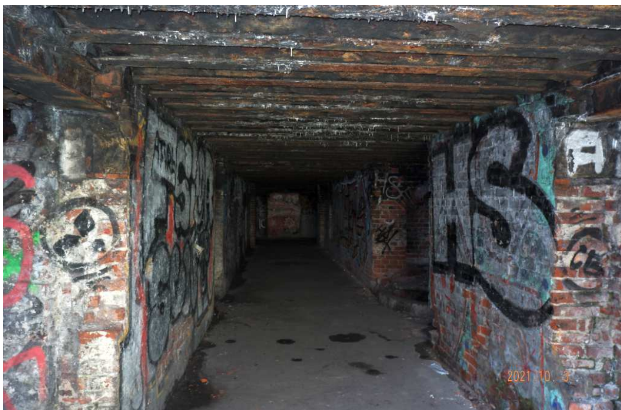
Fot. nr 306 (306-307). Korytarz przy wejściu.
