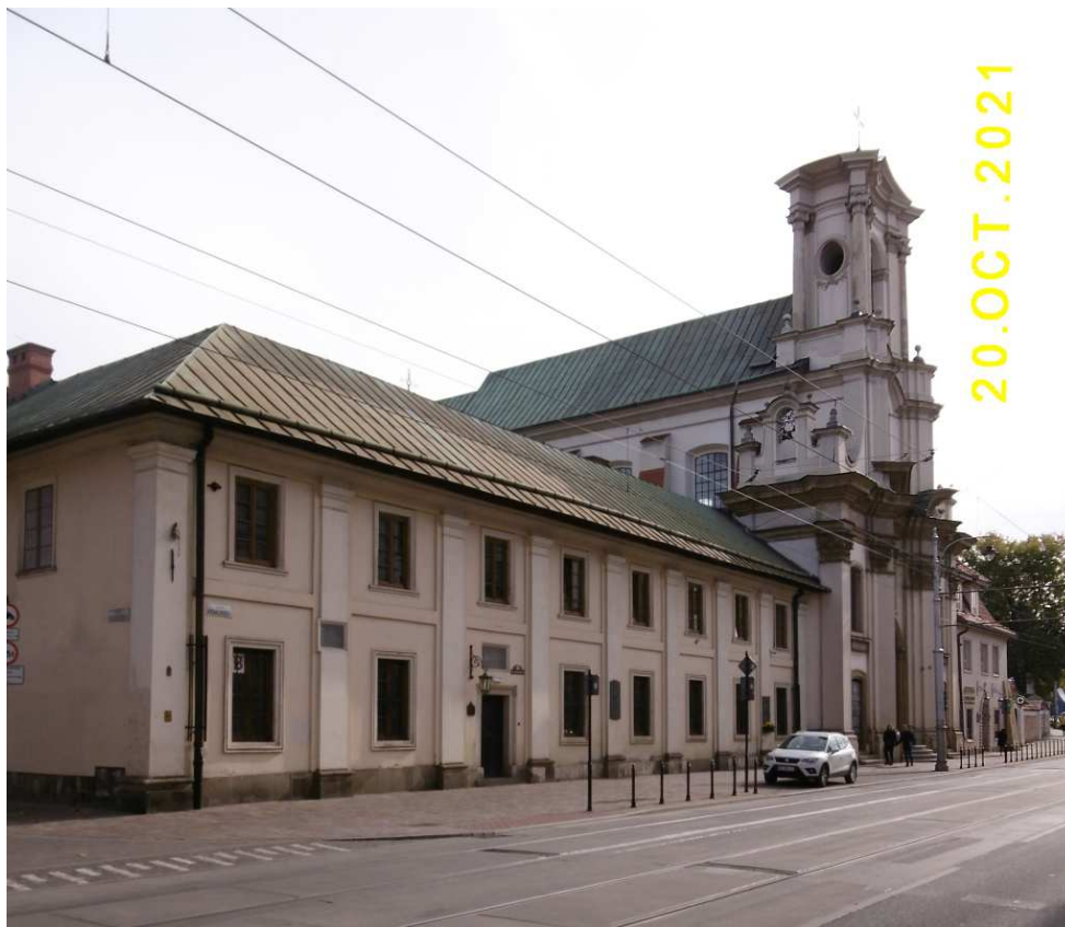
Fot. nr 374(374-381). Wzdłuż ulicy Krakowskiej. Budynek klasztorny i kościół Bonifratrów.
