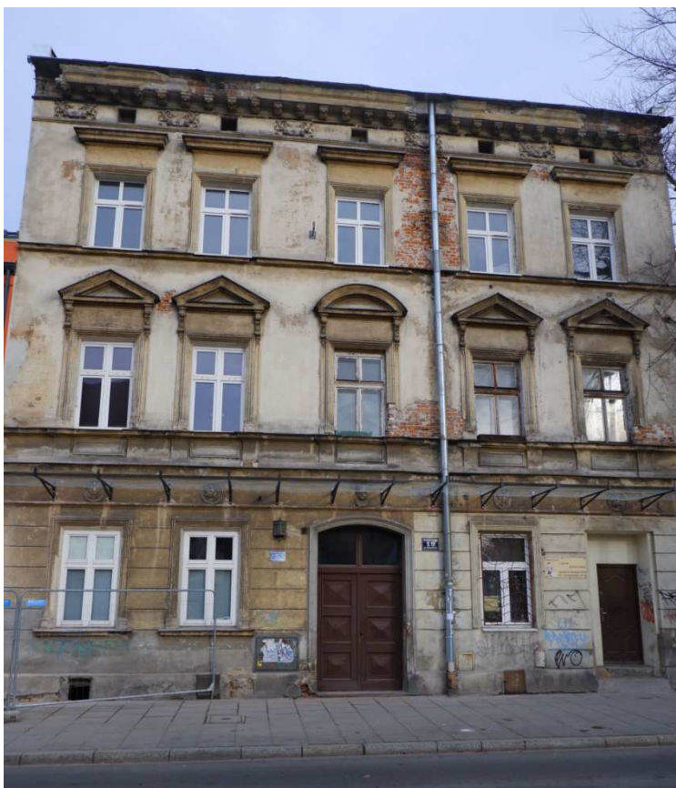
Fot. nr 88. Kamienica pod nr 19 w oczekiwaniu na odnowę elewacji. (04.12.2021)
