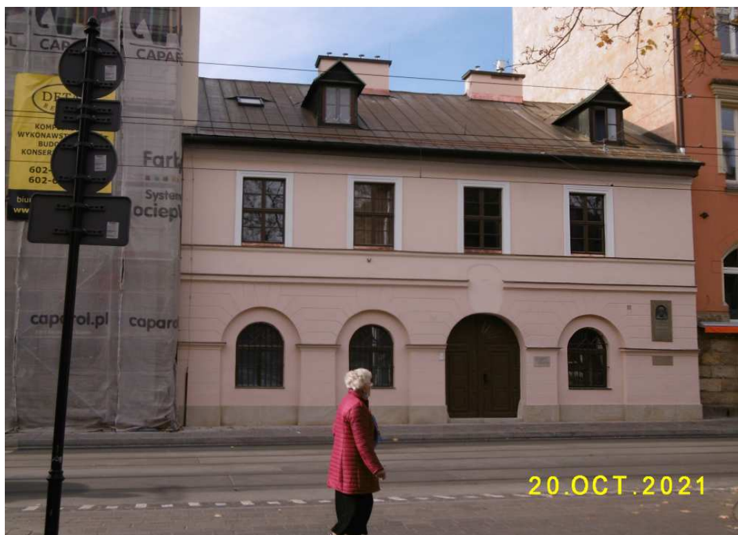
Fot. nr 378 (378-379). Dom św. Brata Alberta pod nr 43, wzniesiony w latach 1837-39.
