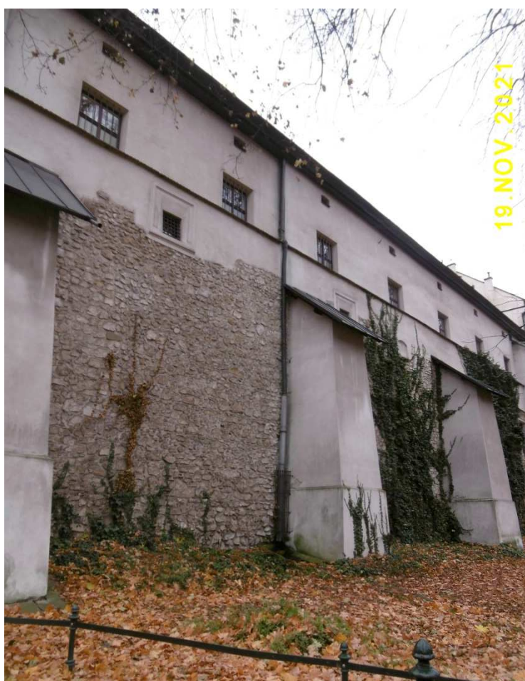
Fot. nr 48 (48-49). Ściana klasztoru Bernardynek z fragmentami muru miejskiego.
