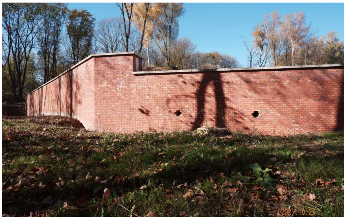
Fot. nr 150 (150-154). Rozpoczęły się prace przy częściowej rekonstrukcji bastionu nr I. W ramach tej akcji został już odtworzony naarys bastei usytuowanej pomiędzy bastionami: I i II.
