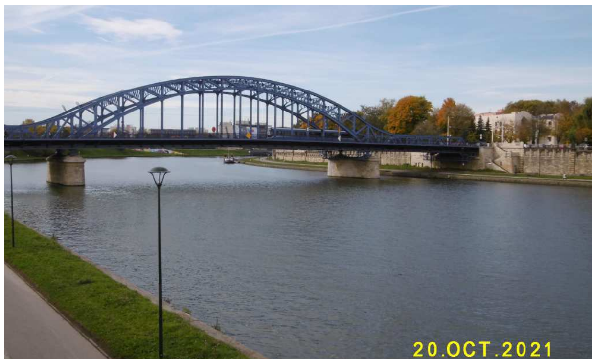
Fot. nr 363 (363-368). Widoki na Kazimierz w ujęciach z Bulwaru Lotników Alianckichw Podgórzu. Kiedyś II., dziś IV. Most im Józefa Piłsudskiego. W tle.
