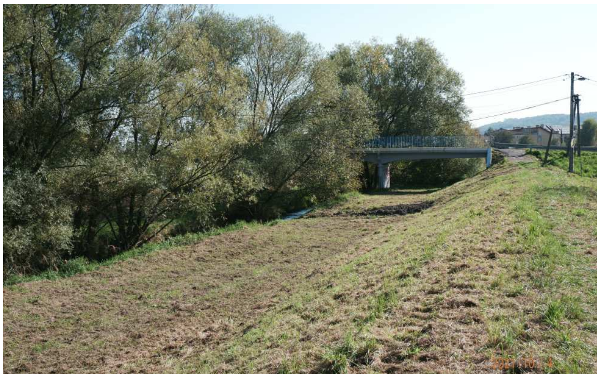
Fot. nr 135. Widok na szósty most w ciągu ulicy Nad Zalewem.
