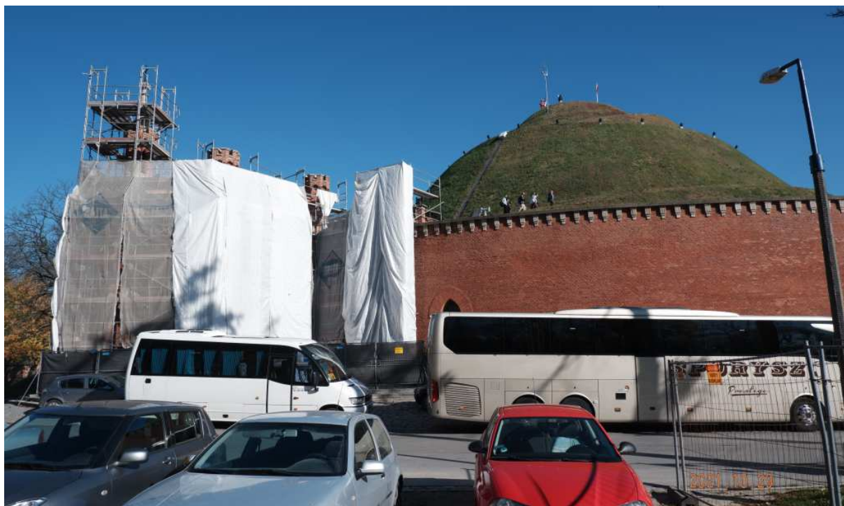
Fot. nr 155 (155-157). Kopiec Kościuszki i przylegająca do niego kaplica bł. Bronisławy na etapie renowacji.
