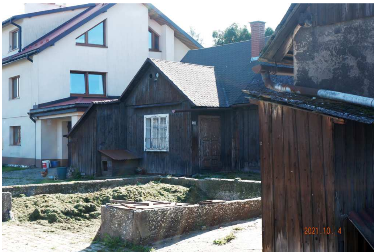
Fot. nr 186 (186-187). Dziedziniec zagrody przy ulicy Nad Zalewem 1.
