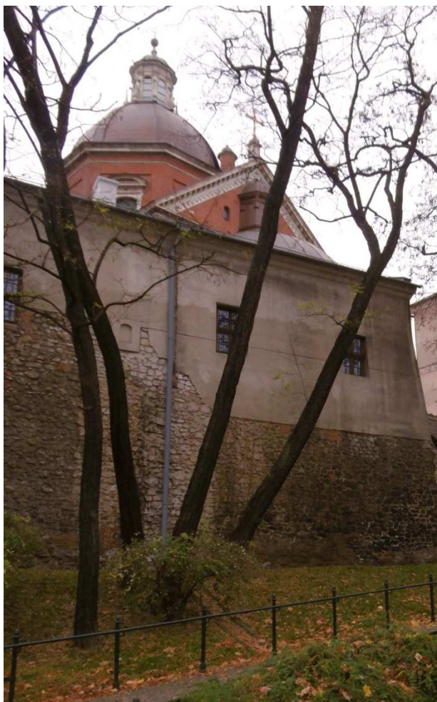
Fot. nr 51. Widok na prezbiterium i kopułę kościoła śś. Piotra i Pawła. (19.11.2021)
