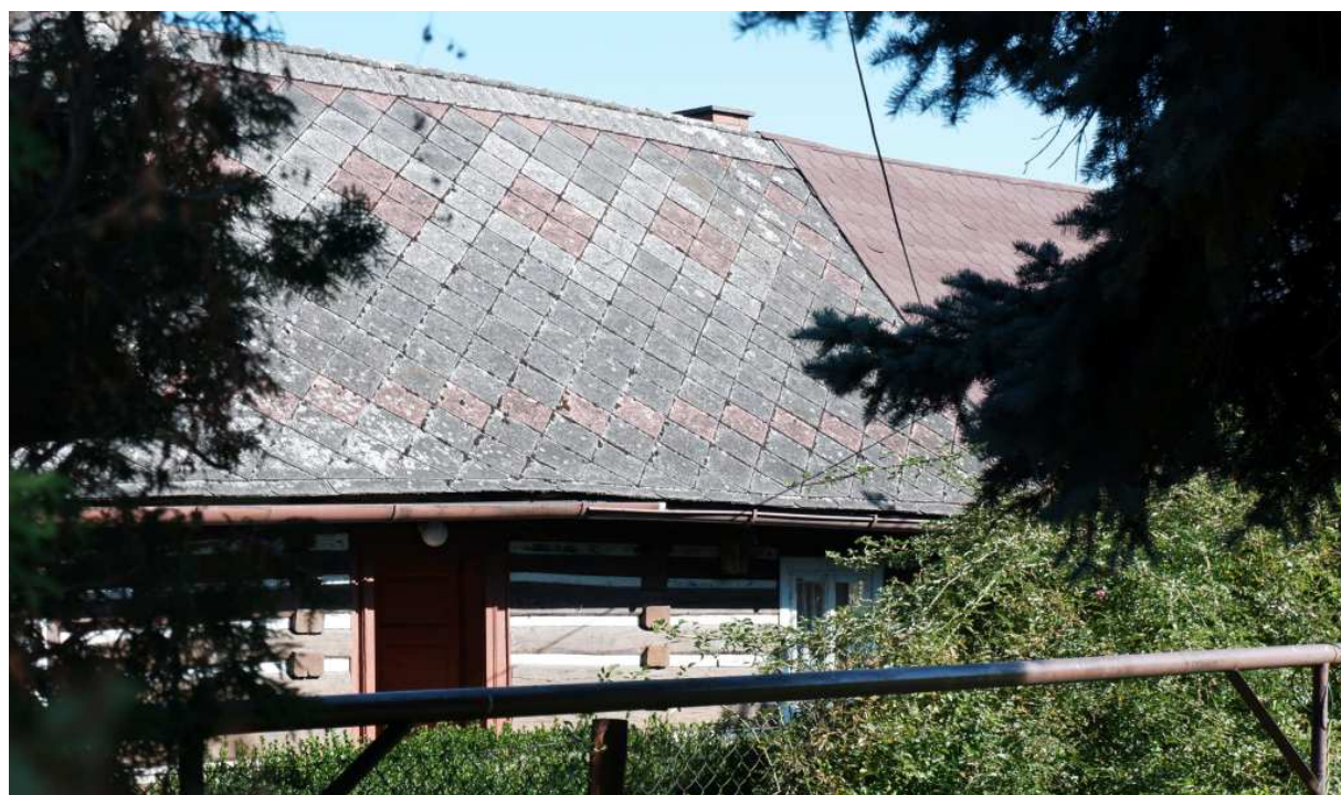
Fot. nr 184 (184-185). Jednotraktowa chałupa przy ulicy Nad Zalewem 1, wybudowana ok. 1900 roku przez Macieja Waligórę, wójta Woli Justowskiej, która ma szansę trafić do krakowskiego skansenu.
