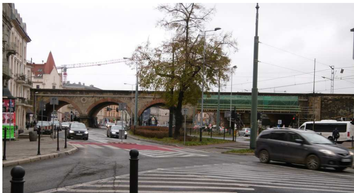
Fot. nr 338. Zabytkowy, wybudowany w roku 1863 wiadukt nad ulicą Grzegórzecką, któremu grozi rozbiórka i wybudowanie „od nowa”. (19.11.2021)
