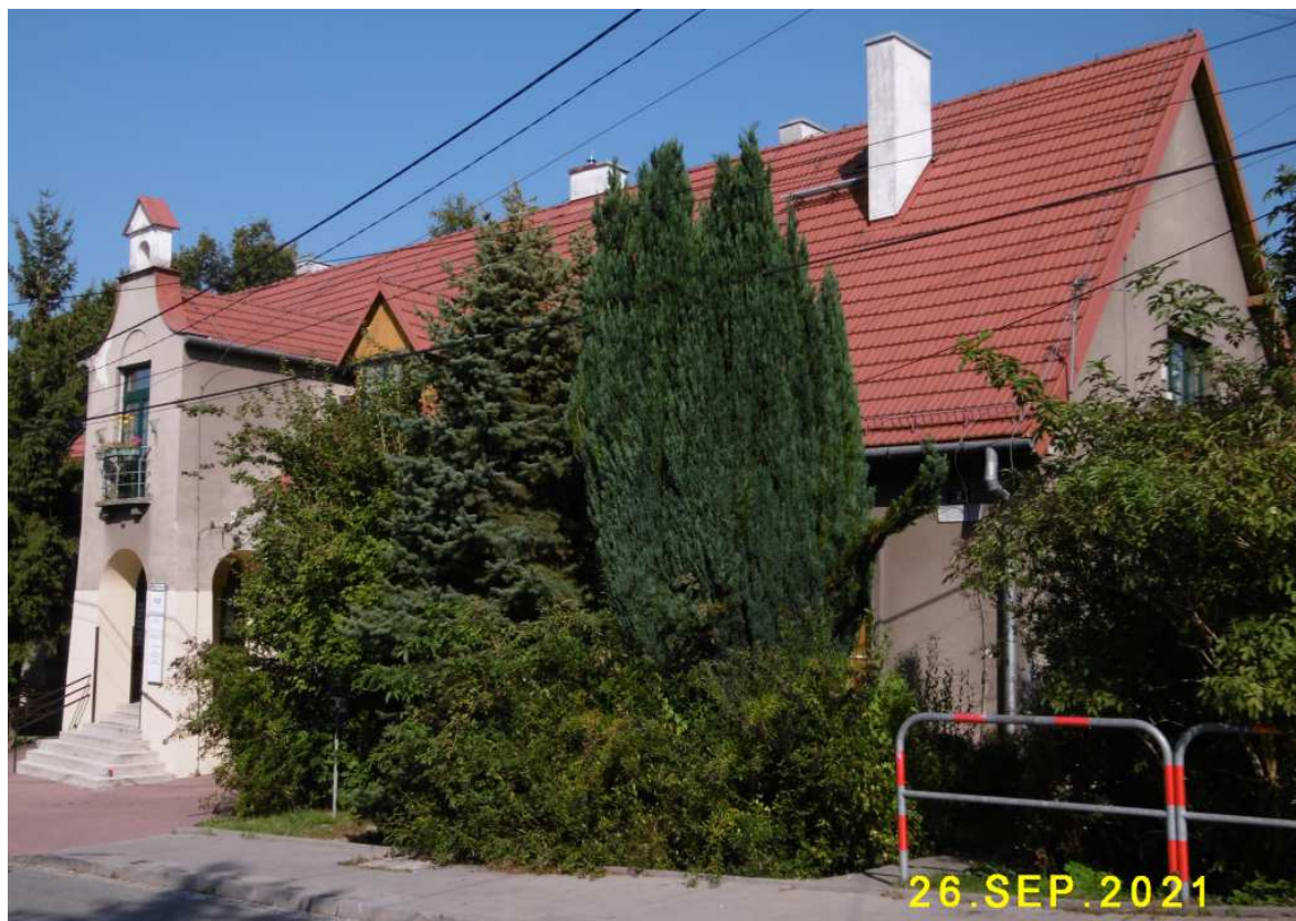
Fot. nr 215 (215-244). Wzdłuż ulicy Tetmajera. Fot. nr: 215-217. Budynek dawnej szkoły spod nr 2, wybudowany na początku XX wieku.
