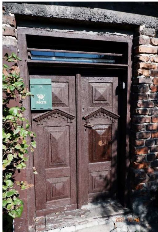
Fot. nr 198. Profilowane w drewnie drzwi.
