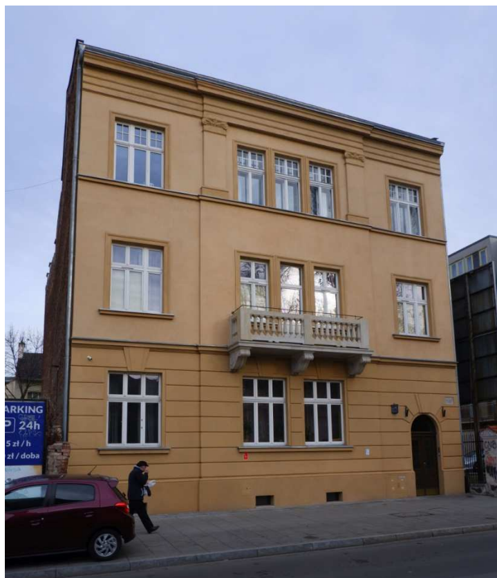
Fot. nr 90. Secesyjna kamienica pod nr 15. (04.12.2021)
