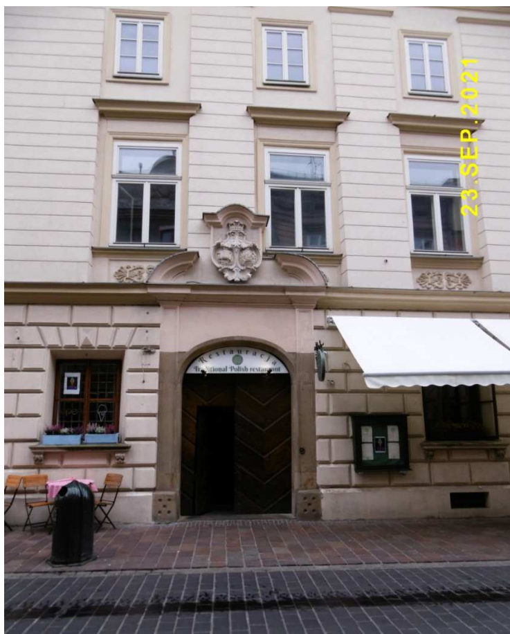
Fot. nr 20. Fasada pałacu Tarnowskich pod nr 15.
