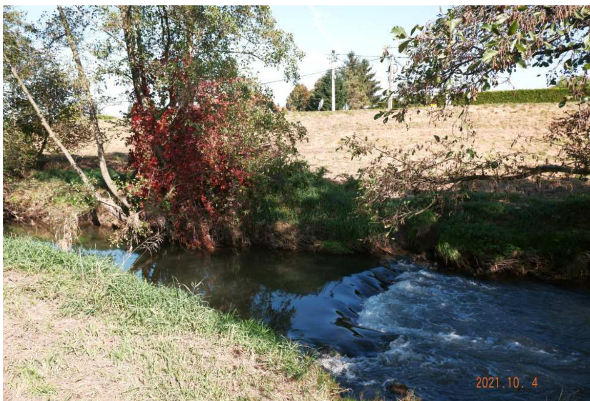
Fot. nr 128. Pozostałości po dawnej tamie, jakich kiedyś było wiele na rzece. Spiętrzenia rzeki ułatwiały kąpiel i karmienie bydła.
