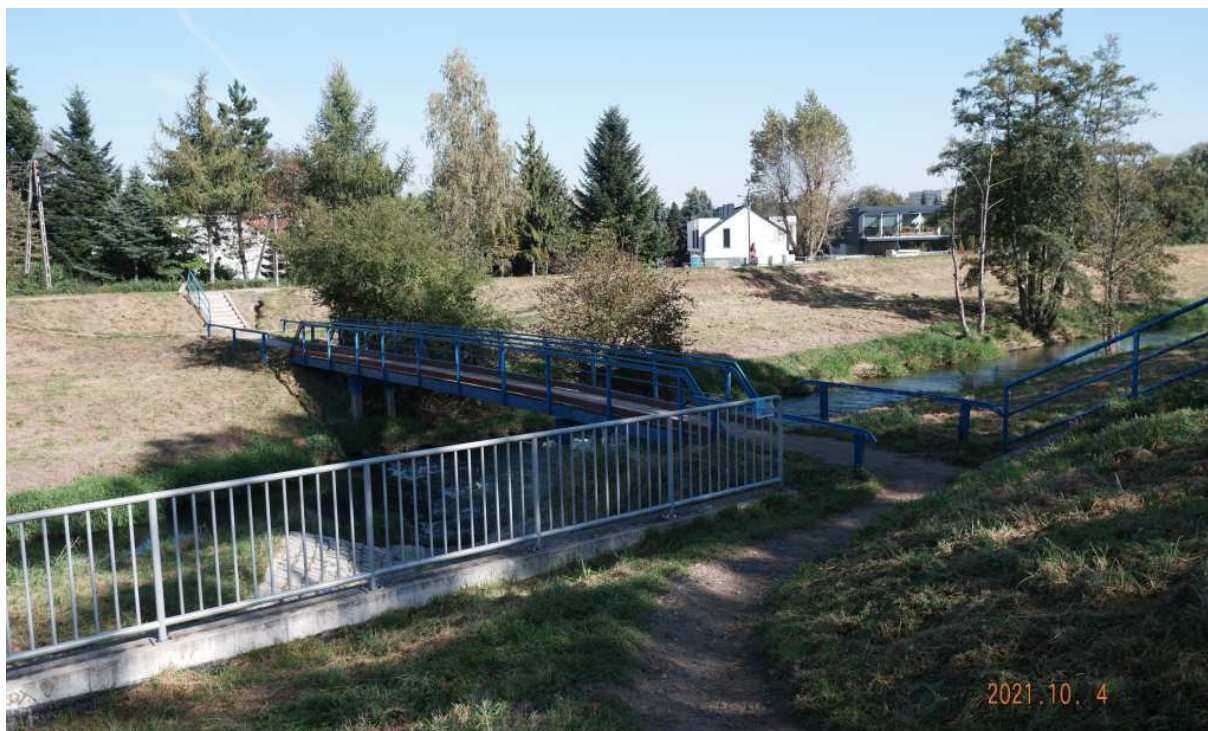
Fot. nr 127. Kładka w miejscu drewnianej kiedyś ławy, zwanej też „czerwonym mostkiem”, na przedłużeniu ulicy Korbutowej.
