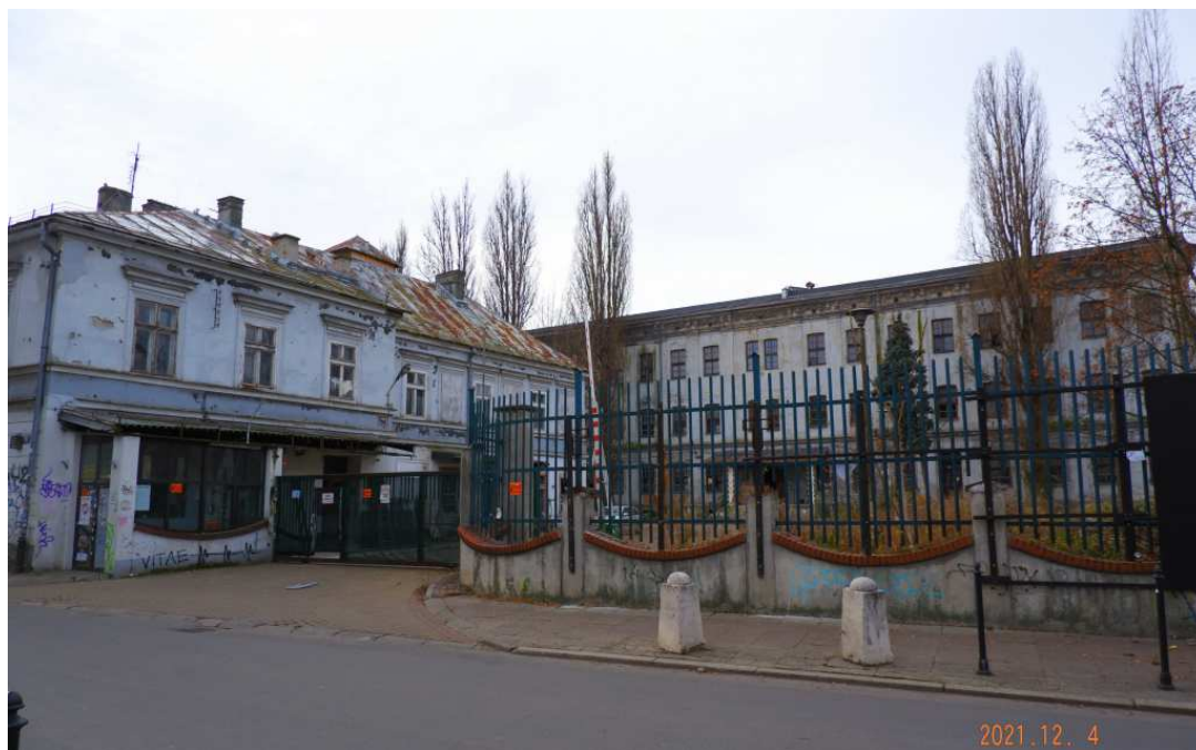
Fot. nr 95. Dawna brama wjazdowa na teren Krakowskich Zakładów Tytoniowych.
