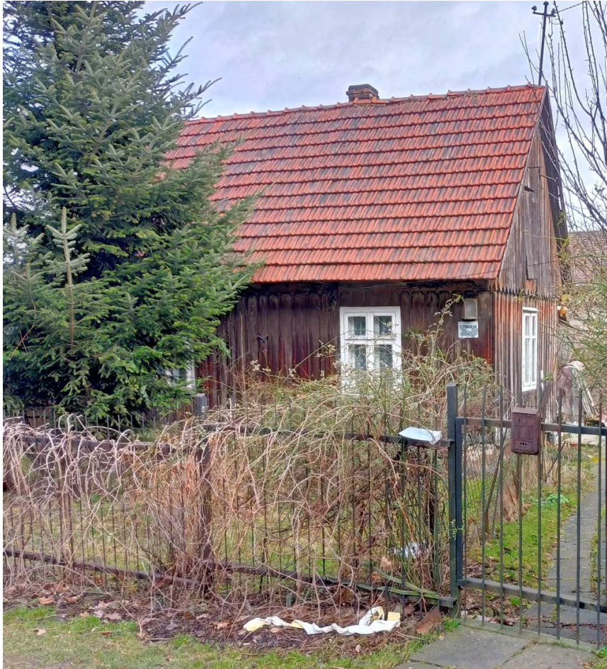
Fot. nr 246 (246-247). Fasada domu. (20.02.2022)
