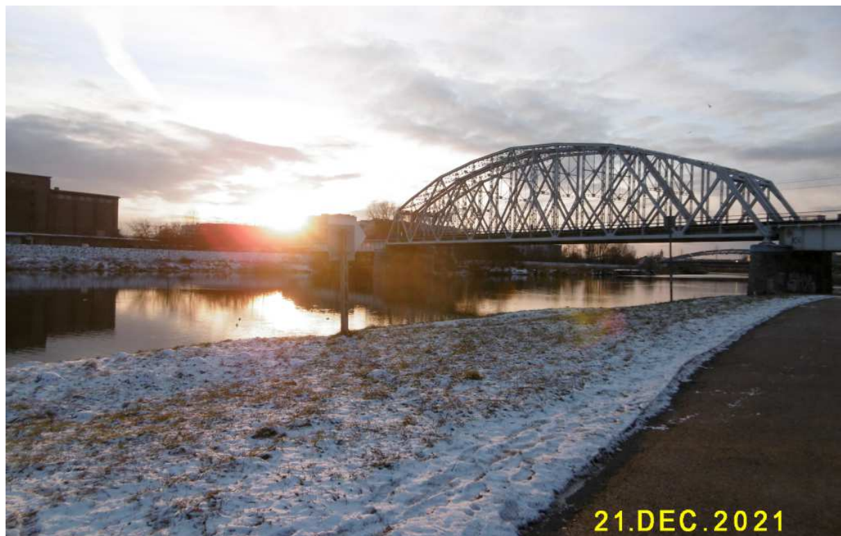
Fot. nr 51. Widok o ds. trony stopnia wodnego w Dąbiu.
