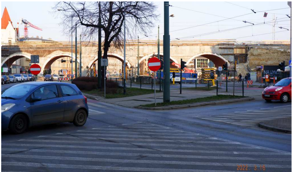
Fot. nr 30. Praktycznie wybudowany od nowa zabytkowy do niedawna, bo powstały w roku 1863 nad korytem starej Wisły, wiadukt nad ulicą Grzegórzecką – widok z wylotu ulicy Wielopole.
