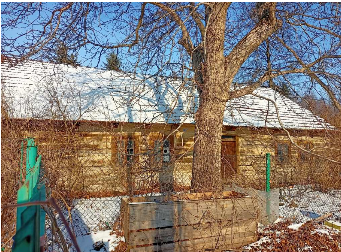
Fot. nr 72 (71-72). Fasada od strony ogrodu.
