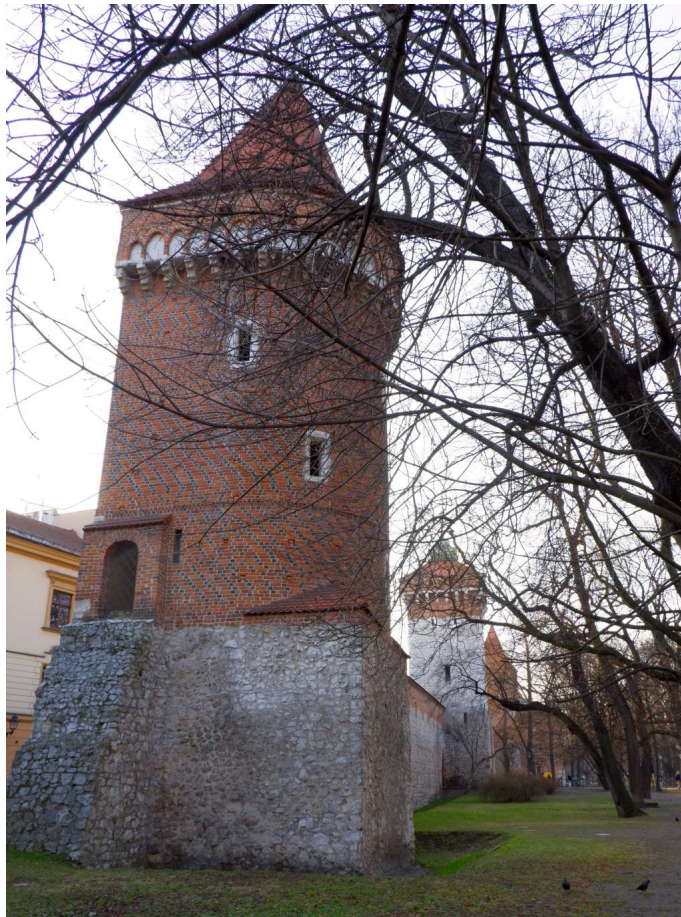
Fot. nr 7. Widok z ulicy Szpitalnej. (16.03.2022)
