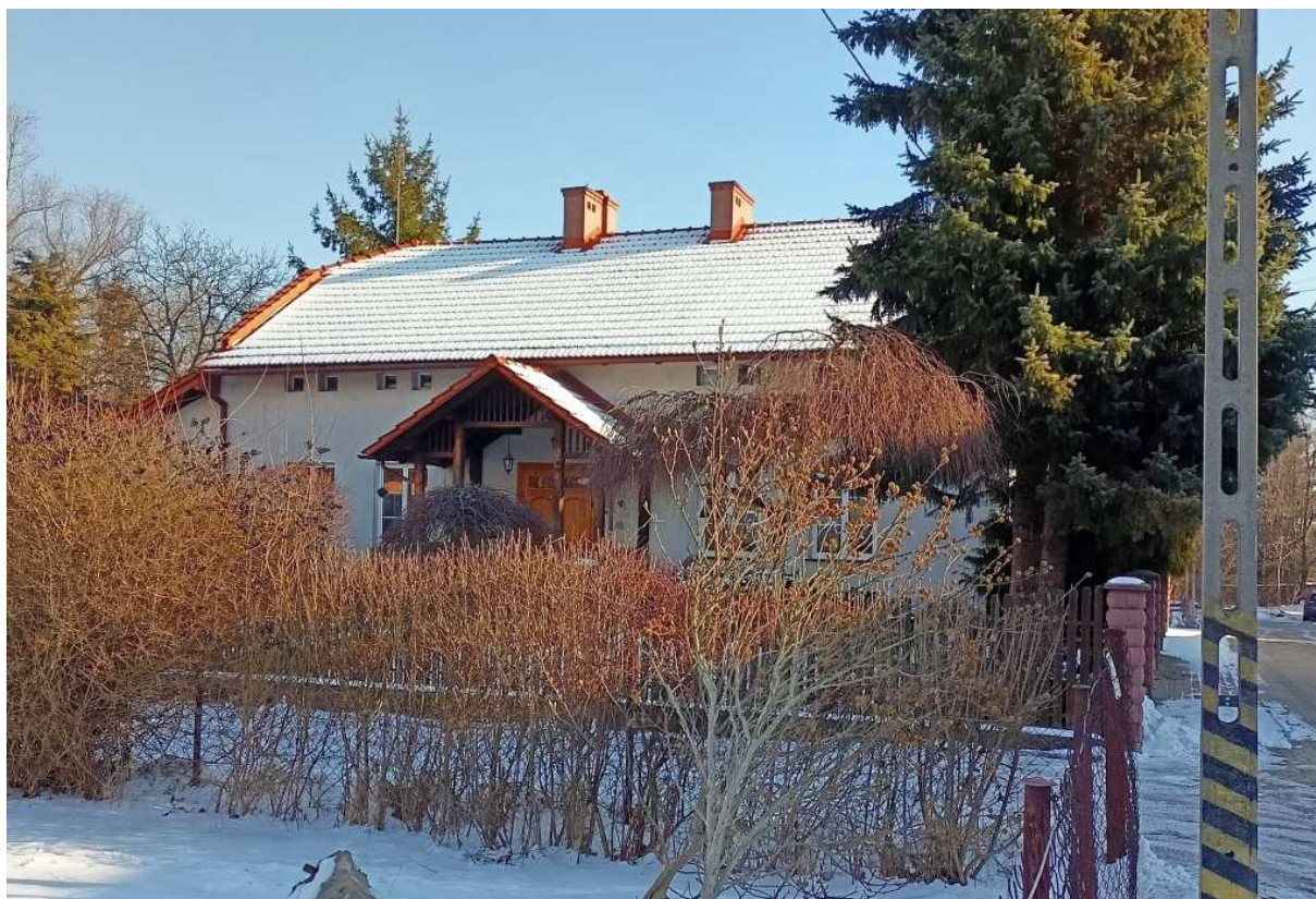
Fot. nr 76. Budynek dawnego dworu pod nr 2.
