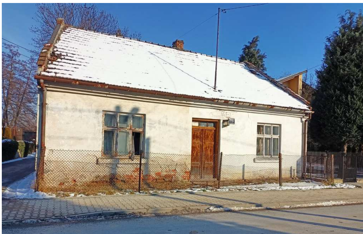
Fot. nr 83. Dom pod nr 46, kiedyś pod adresem: Dz. Nowa Huta Bieńczyce 119
