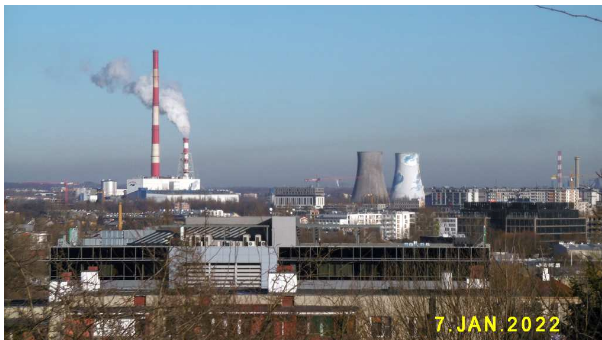
Fot. nr 157 (157-158). W stronę elektrociepłowni w Łęgu ponad Płaszowem.
