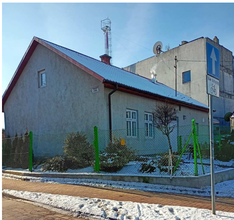
Fot. nr 97. Murowany dom, zapewne międzywojenny, pod nr 13.
