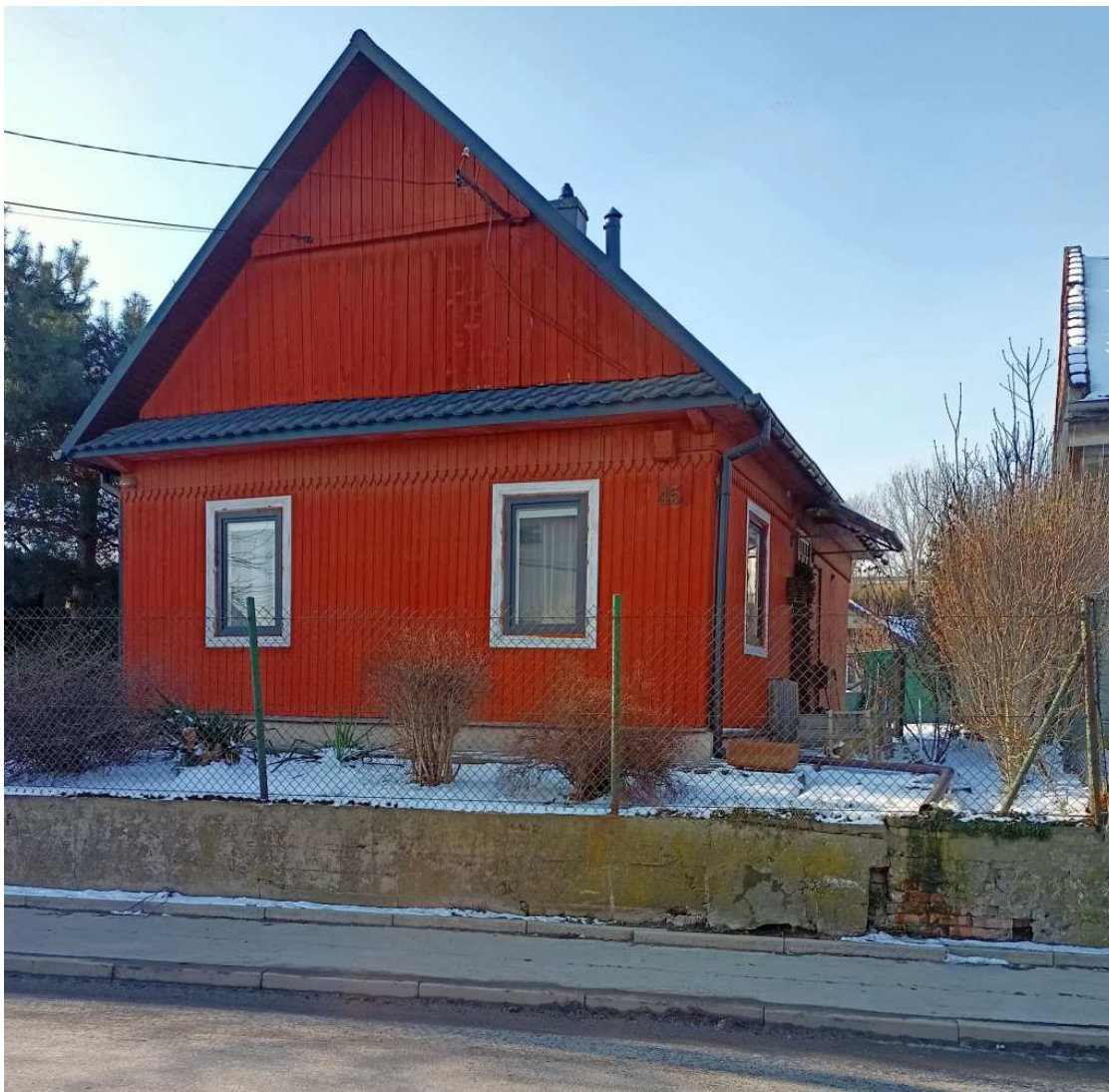
Fot. nr 70. Ściana szczytowa od strony ulicy.
