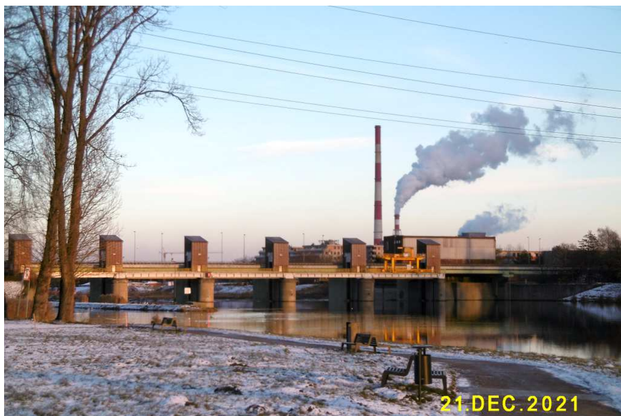
Fot. nr 52. Stopień wodny na Dąbiu.
