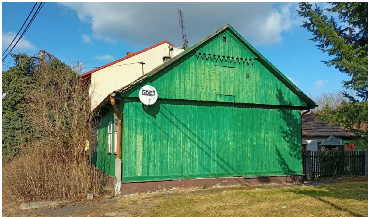
Fot. nr 233 (233-234). Dom przy ulicy Ściegiennego 41 – widok z ulicy. (08.03.2022)
