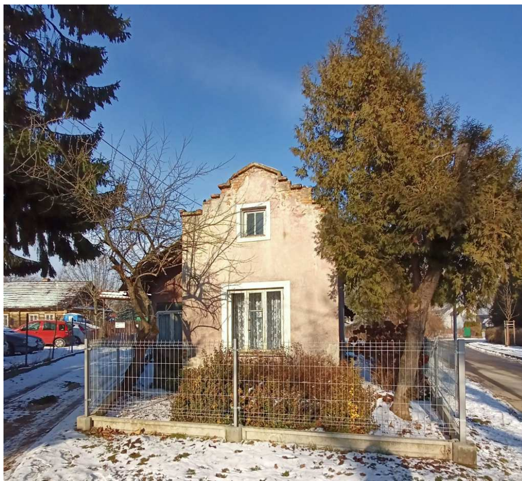
Fot. nr 75. Dawny budynek Straży Ogniowej pod nr 5.
