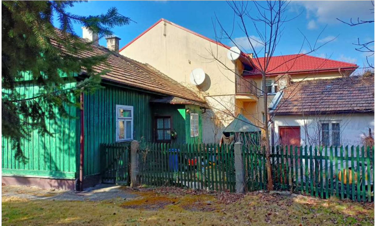
Fot. nr 234. Na zapleczu dawnej zagrody. (08.03.2022)
