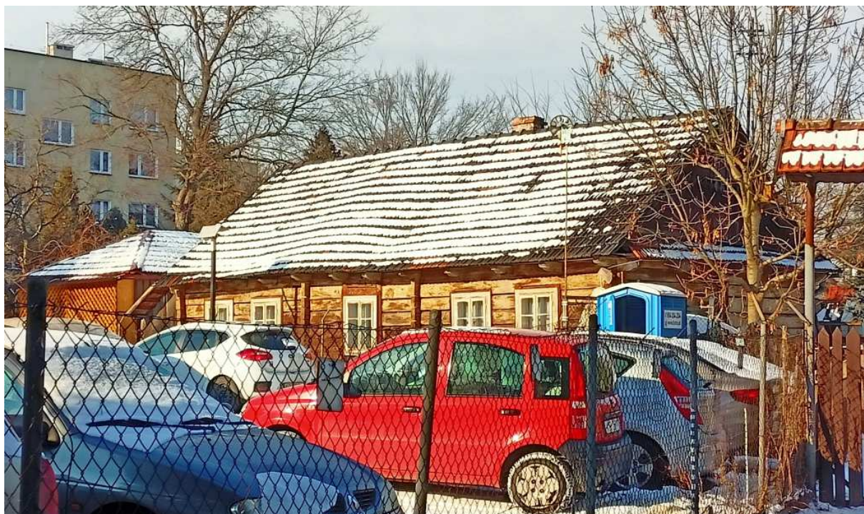
Fot. nr 74 (74-81). Wzdłuż ulicy Kaczeńkowej. Chałupa (zapewne) z początku XX wieku spod nr 3.
