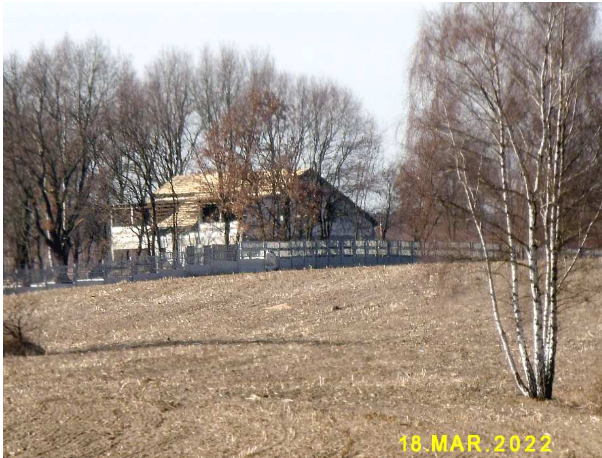
Fot. nr 288. Nowy dom powstający na tyłach ulicy Obronnej na styku ze Słoną Wodą.
