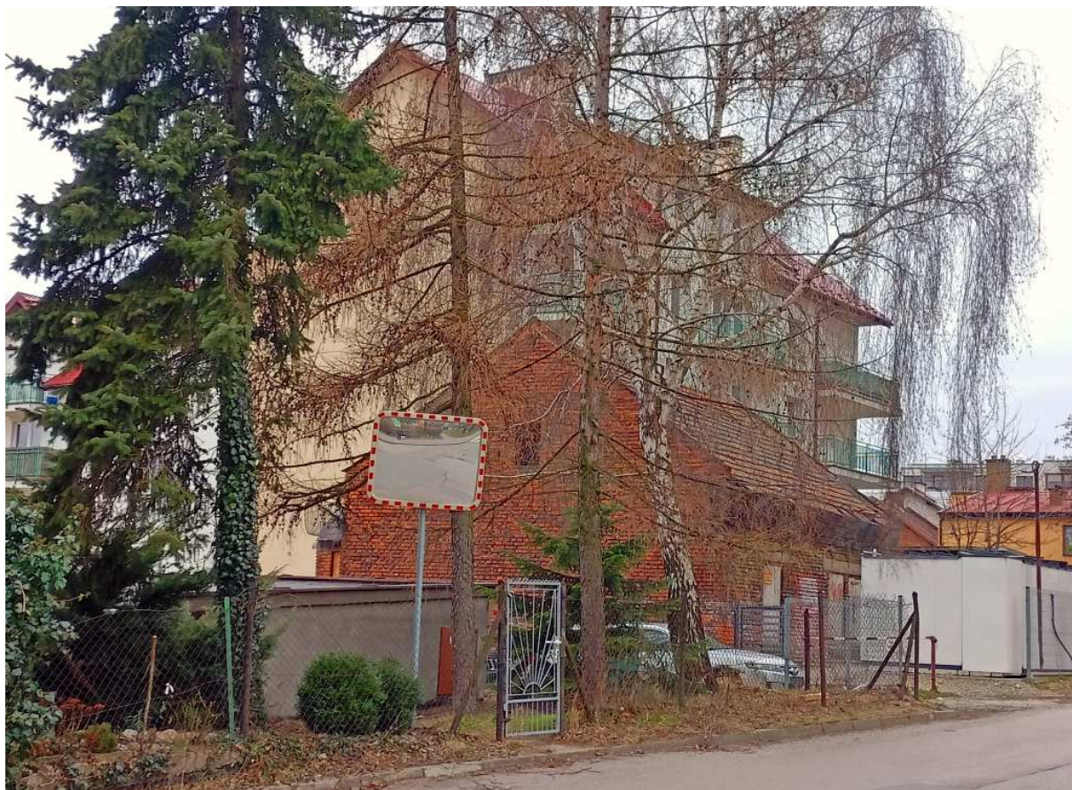
Fot. nr 238. Ruina ceglanego domu z ulicy Łużyckiej 75a. (06.03.2022)
