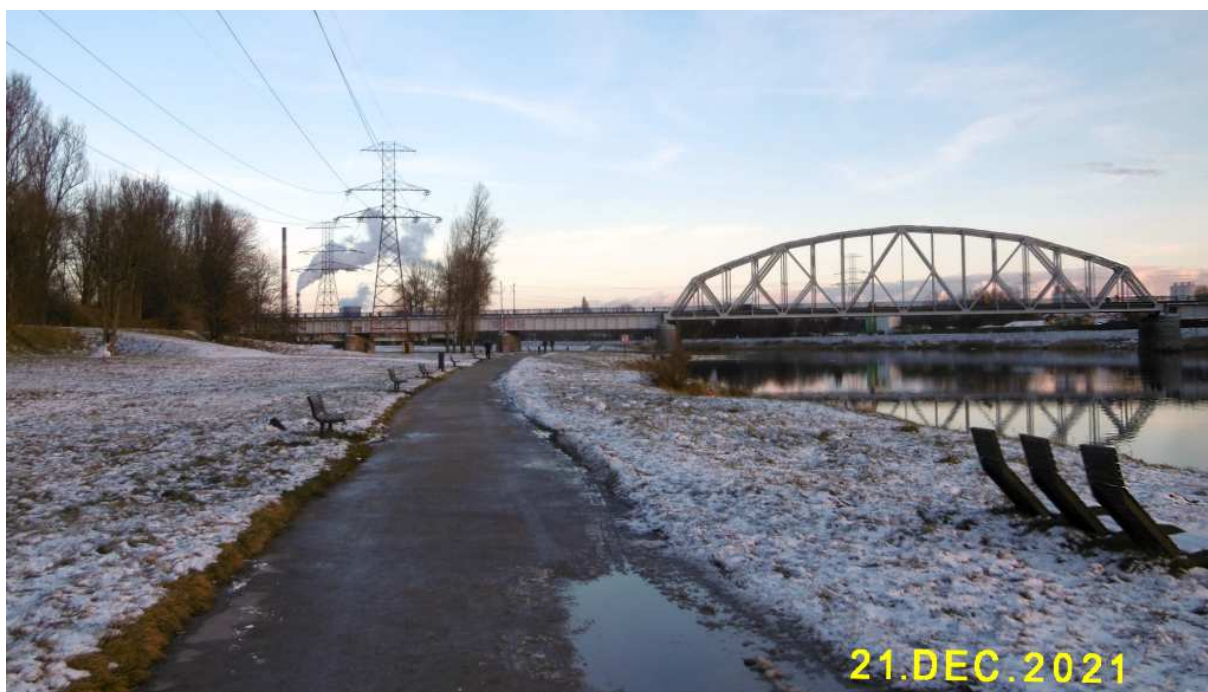
Fot. nr 50 (50-51). Most kolejowy na wysokości Zabłocia.
