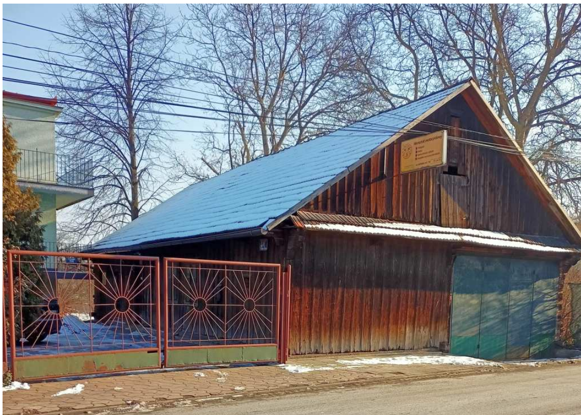
Fot. nr 73. Widok od strony podwórka.
