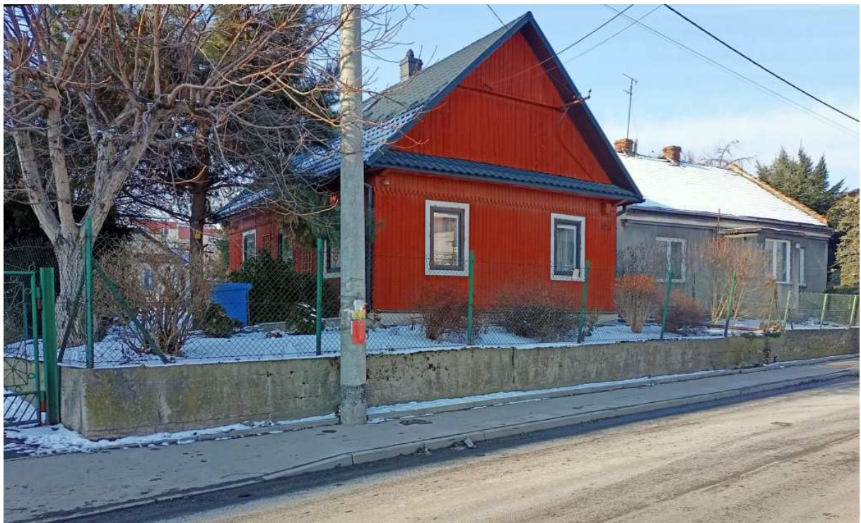
Fot. nr 69 (69-70). Dom spod nr 45 już z nowymi, niedawno wymienionymi oknami, czym wiele stracił na uroku.
