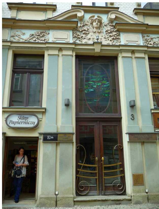
Fot. nr 141. Drzwi i portal. (08.06.2022)
