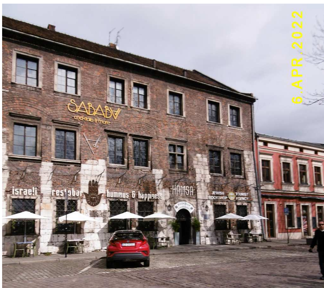
Fot. nr 438. Kamienica Landauów pod nr 1.
