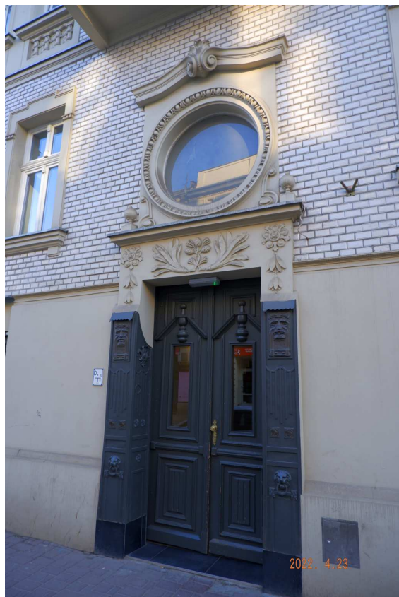
Fot. nr 434. Połączenie secesji i eklektyzmu na przykładzie fasady kamienicy pod nr 43.
