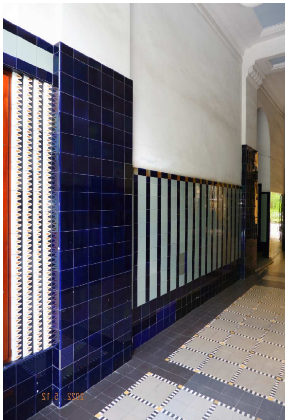
Fot. nr 148. Wykładzina z sieni kamienicy.
