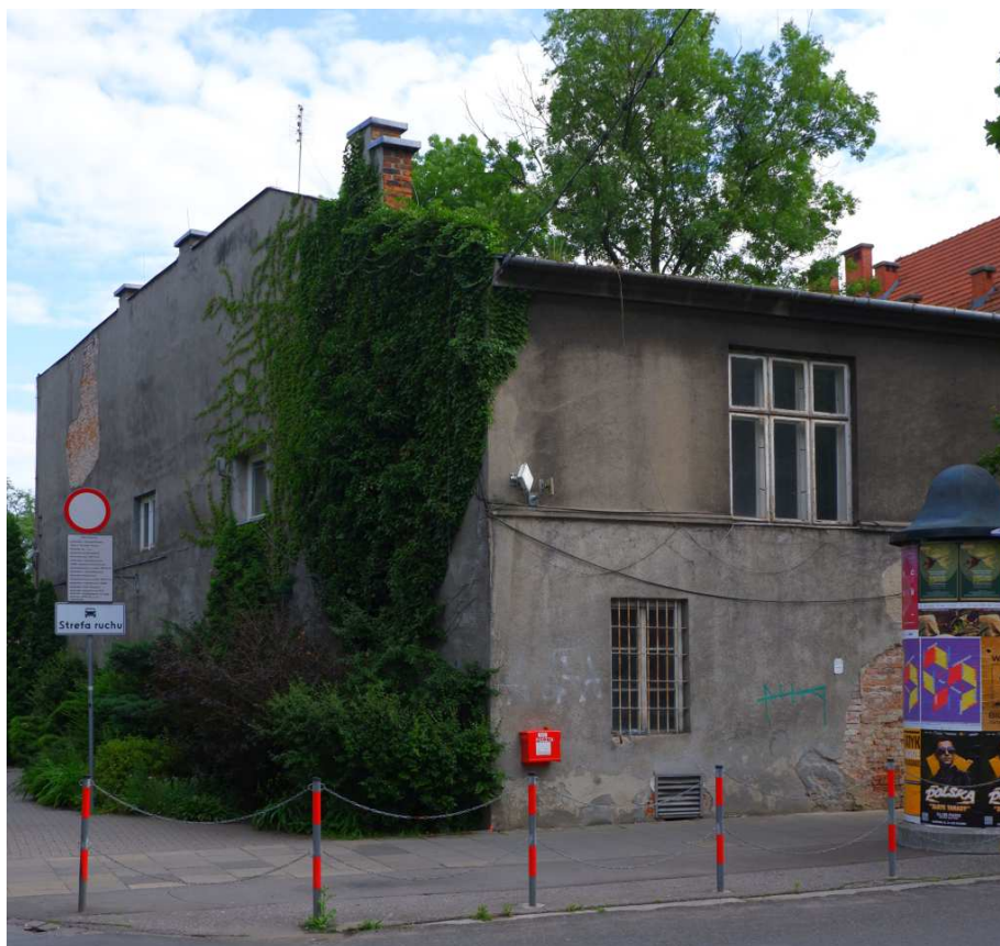
Fot. nr 319. Portiernia przy wjeździe na ulicę Śniadeckich. (17.06.2022)
