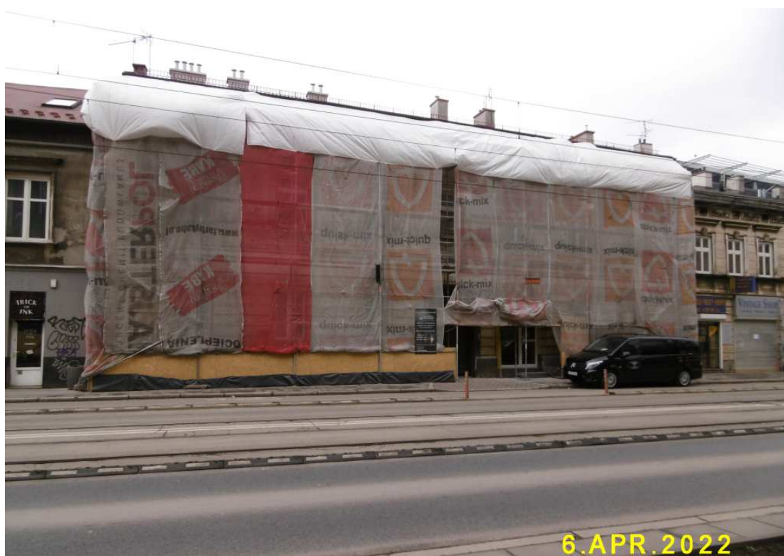
Fot. nr 398. Remontowany dom pod nr 27, powstały ok. roku 1900.
