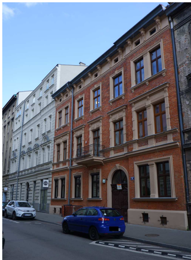
Fot. nr 103. Kamienice pod nr: 8 i 10, ta pierwsza szpetnie nadbudowana. (19.04.2022)
