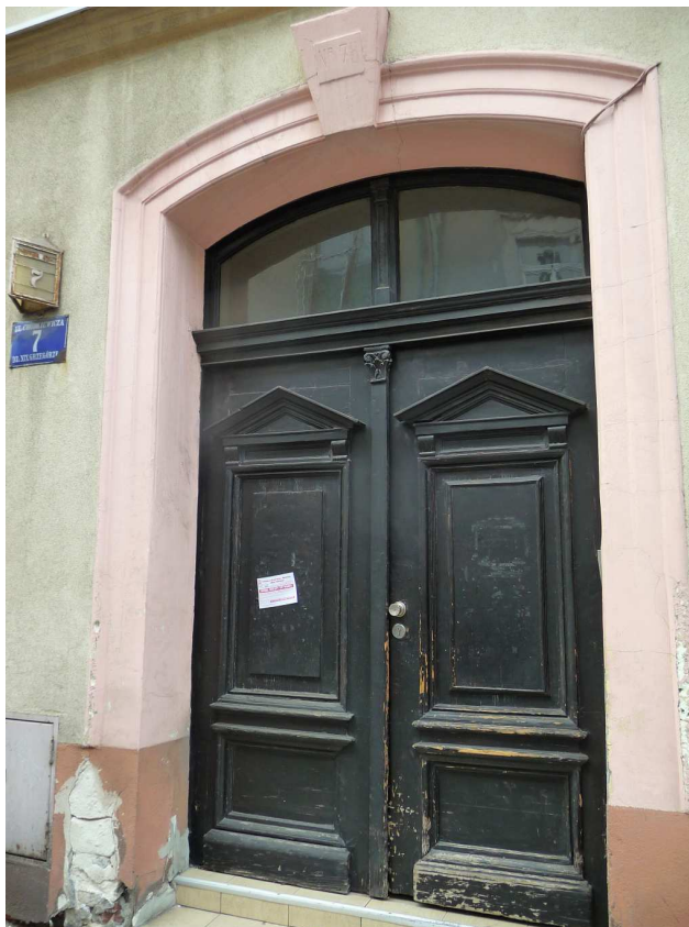
Fot. nr 403. Oryginalne drzwi domu spod nr 7.
