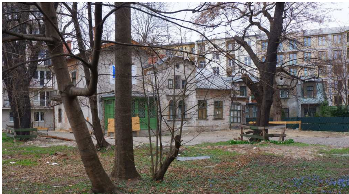
Fot. nr 194 (194-196). Spojrzenia na Kossakówkę przy placu Kossaka 4 na etapie ślimaczącego się remontu, z przeznaczeniem na Muzeum Kossaków. (29.03.2022)
