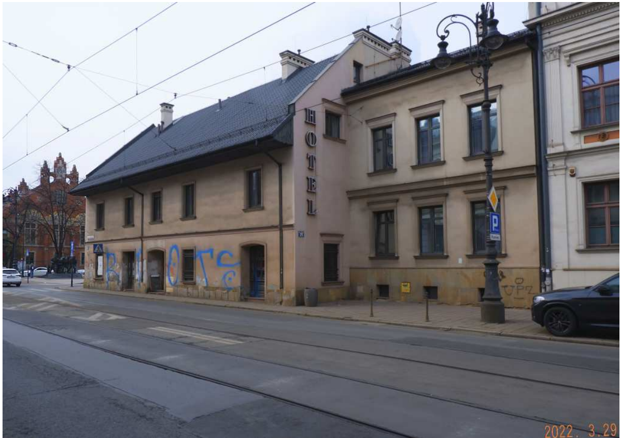
Fot. nr 200. Niska zabudowa pod nr 25. To dawny lokal Baru Przy Błoniach („U Żyda”).
