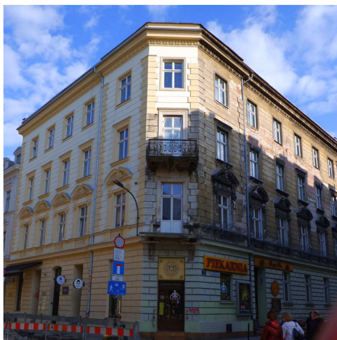
Fot. nr 135. Narożna kamienica pod nr 12. (23.04.2022)
