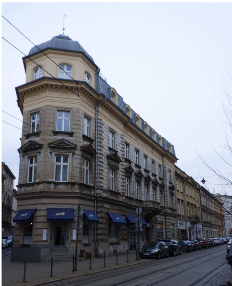
Fot. nr 192. Ciekawie nadbudowana kamienica spod nr 27. (29.03.2022)
