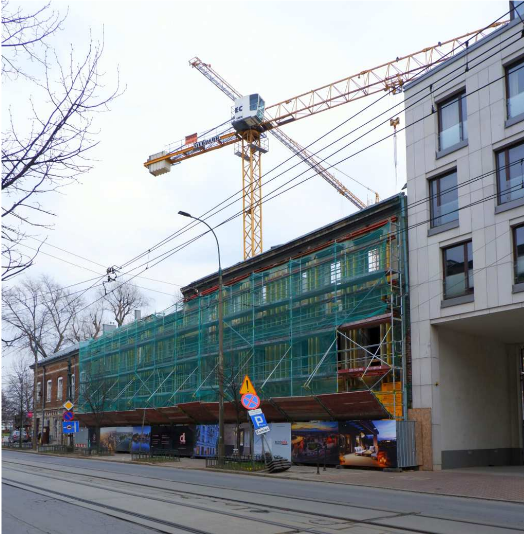
Fot. nr 209. Przebudowywane na apartamentowce domy pod nr: 20 i 22. (29.03.2022)
