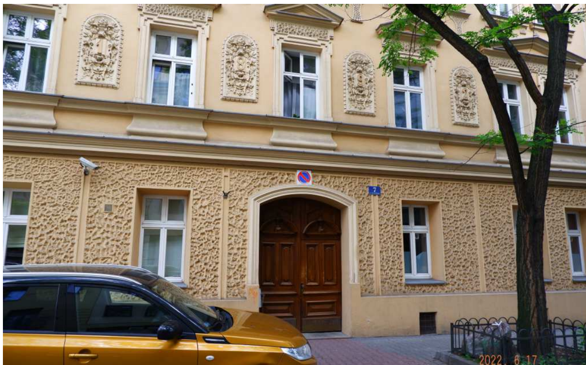
Fot. nr 299. Data powstania kamienicy (1892) pomiędzy oknami na wysokości I. piętra
