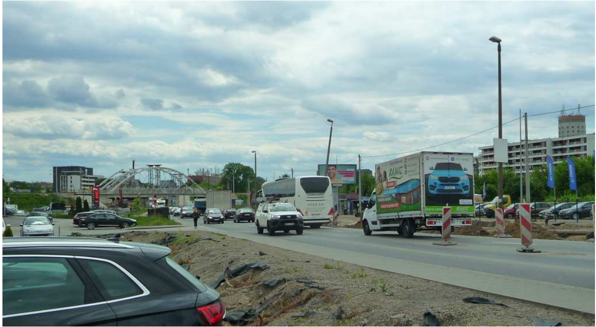
Fot. nr 451. Widok od strony ulicy ks. Meiera. (26.05.2022)
