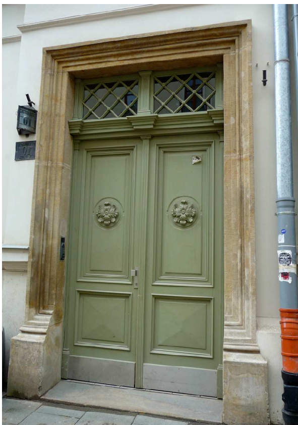
Fot. nr 138. Drzwi kamienicy pod nr 10. (08.06.2022)
