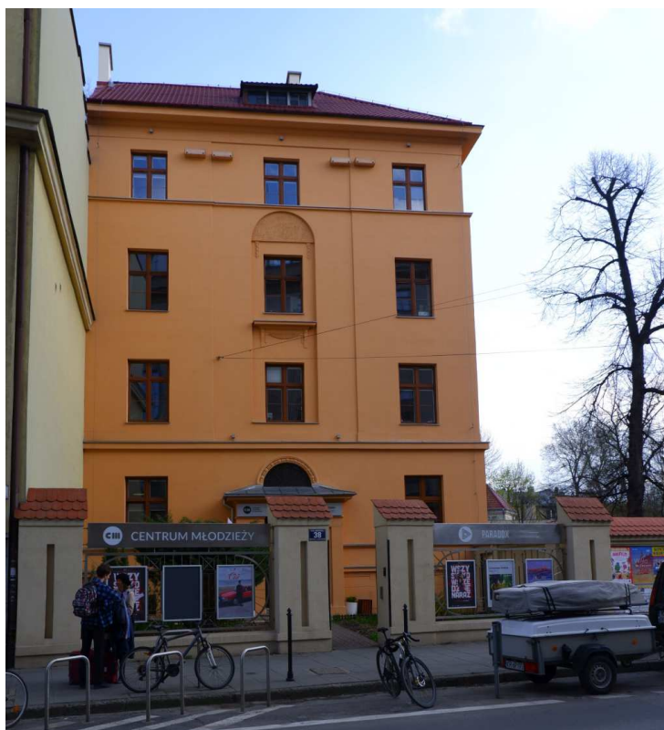
Fot. nr 107 (107-110). Fragment zabudowy ulicy Krupniczej. (19.04.2022)
