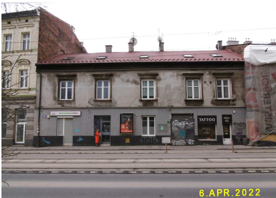
Fot. nr 397. Jednopiętrowy dom spod nr 29, wybudowany ok. roku 1890.
