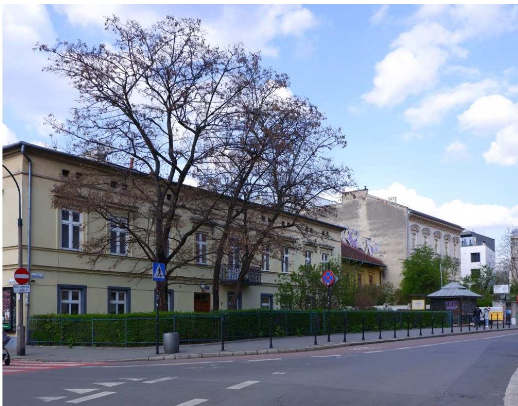
Fot. nr 94. Fragment zabudowy pod nr: 17-21. (19.04.2022)
