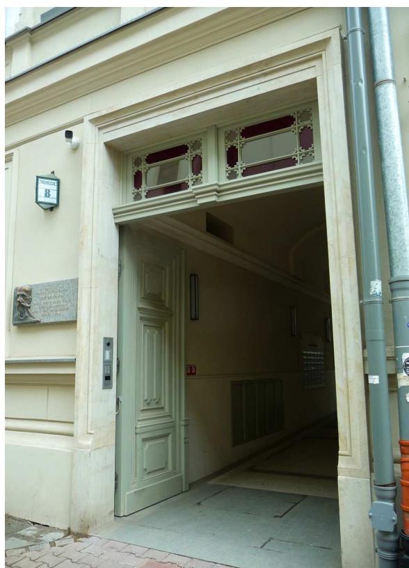
Fot. nr 139. Drzwi kamienicy pod nr 8. (08.06.2022)
