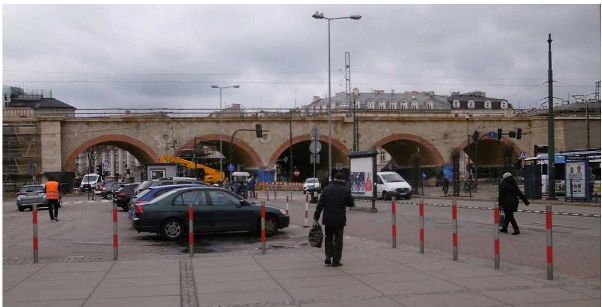
Fot. nr 414 (414-416). Przebudowywany czy raczej budowany od nowa wiadukt przy ulicy Grzegórzeckiej, który w oryginale powstał nad korytem starej Wisły w roku 1863. Fot. nr: 415-416 - ujęcia z ulicy Grzegórzeckiej. (06.04.2022)
