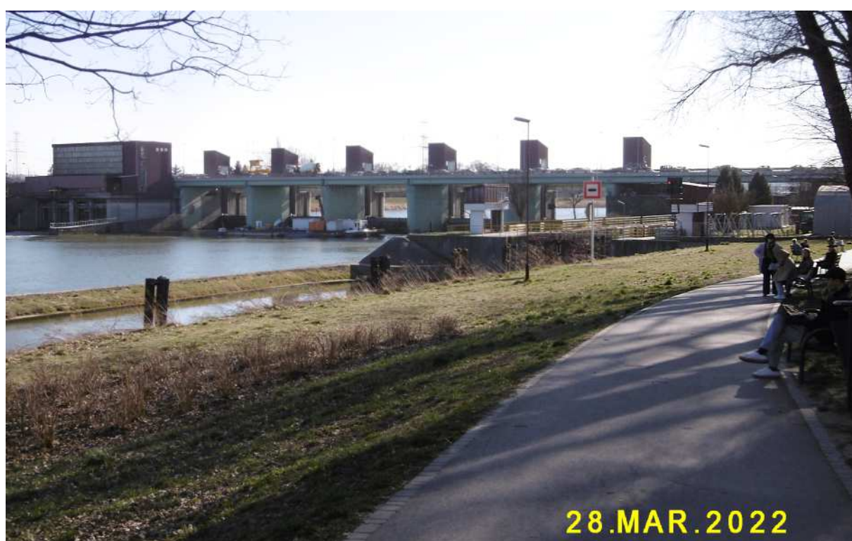
Fot. nr 424. Stopień wodny na Dąbiu.
