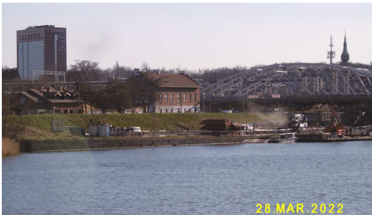
Fot. nr 340. W stronę II. Mostu im. Powstańców Śląskich.
