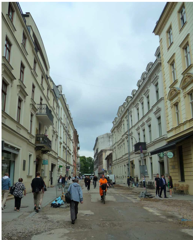
Fot. nr 136. W stronę ulicy Podwale. (08.06.2022)
