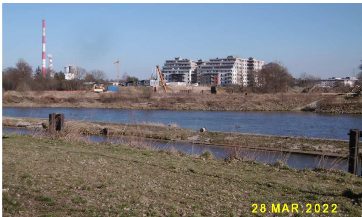
Fot. nr 422 (422-423). Nowa zabudowa wokół współcześnie powstałej ulicy Na zakolu Wisły.
