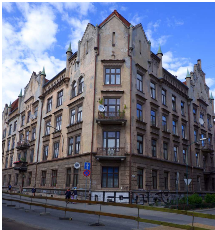
Fot. nr 301 (301-305). Wzdłuż ulicy Blich. Narożnik z ulicą Sołtyka. (17.06.2022)
