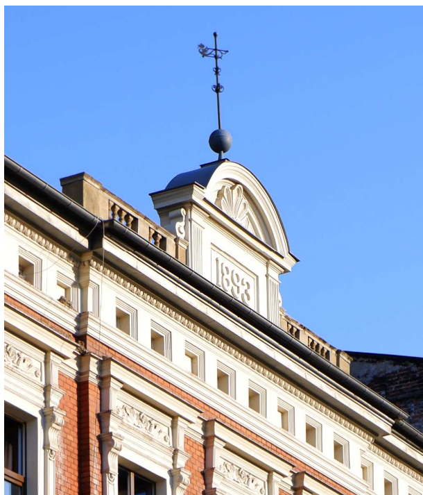
Fot. nr 431 (431-432). Detale kamienicy pod nr 85. (23.04.2022)
