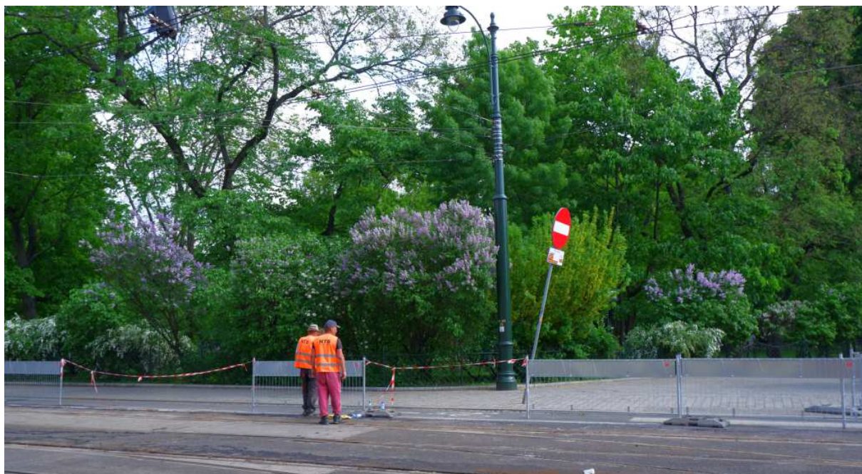
Fot. nr 33. Widok na skraj Plant z wylotu ulicy Długiej. (12.05.2022)
