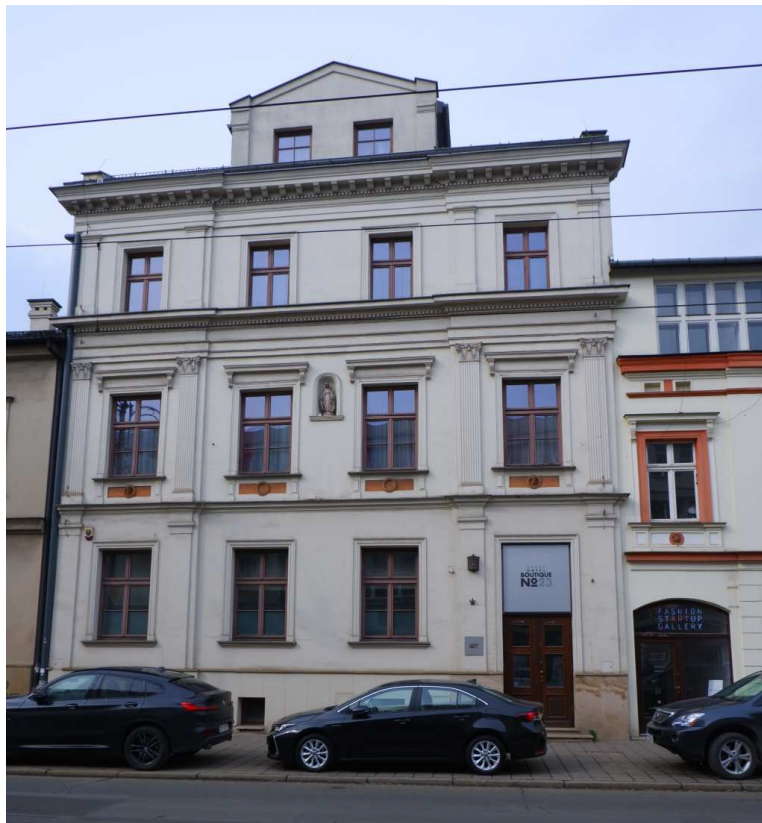
Fot. nr 201. Nadbudowana kamienica pod nr 23. (29.03.2022)
