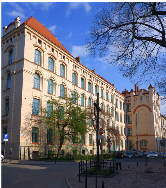
Fot. nr 178 (178-181). Gmach Technikum Energetycznego z ulicy Loretańskiej 16 z początku XX wieku, kiedy wówczas mieściła się tu szkoła św. Jadwigi. 23.04.2022)
