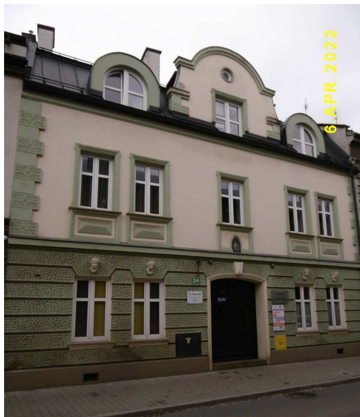
Fot. nr 387. Nadbudowany dom spod nr 24.
