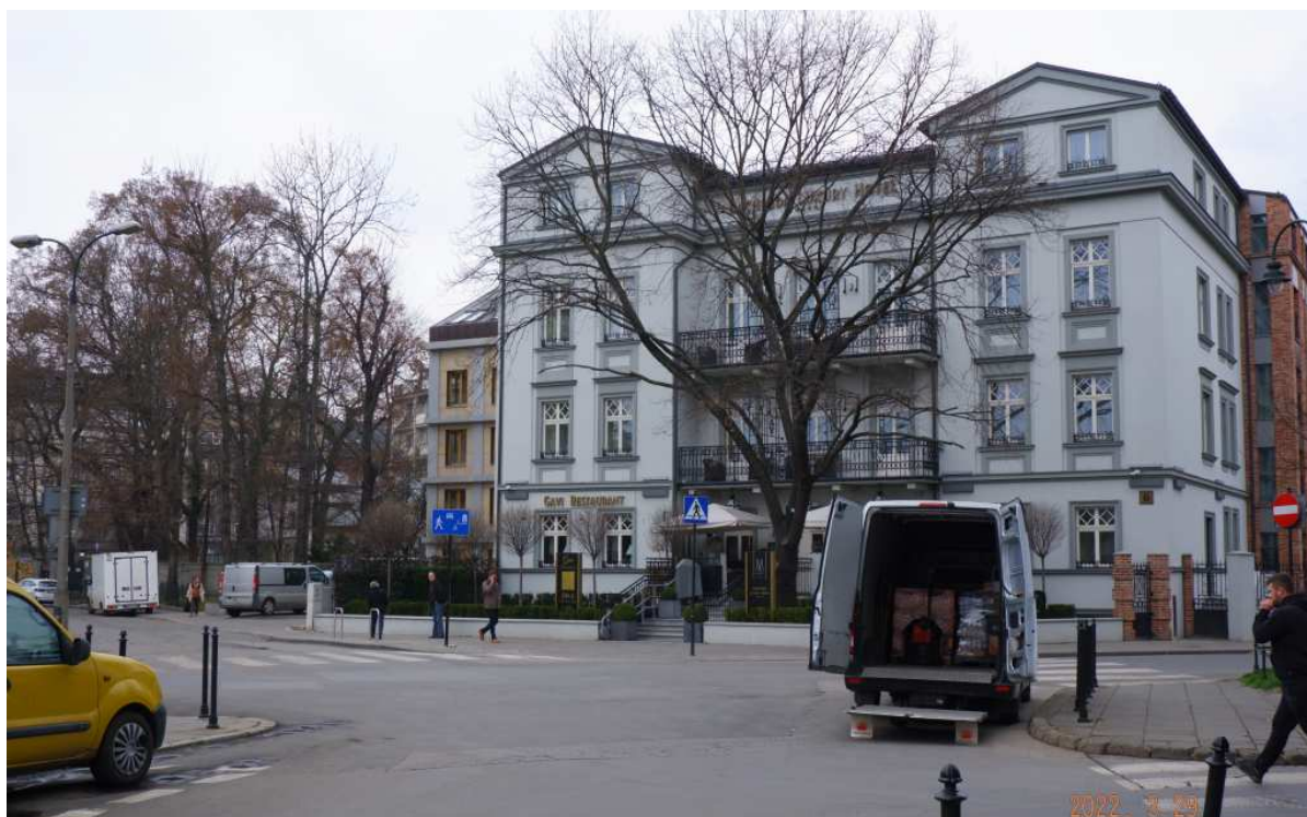
Fot. nr 193 (193-196). Przebudowana na hotel dawna willa Medyńskich z placu Kossaka 6. To przykład „zabytku – wydmuszki” z całkowicie wyprutym wnętrzem. (29.03.2022)
