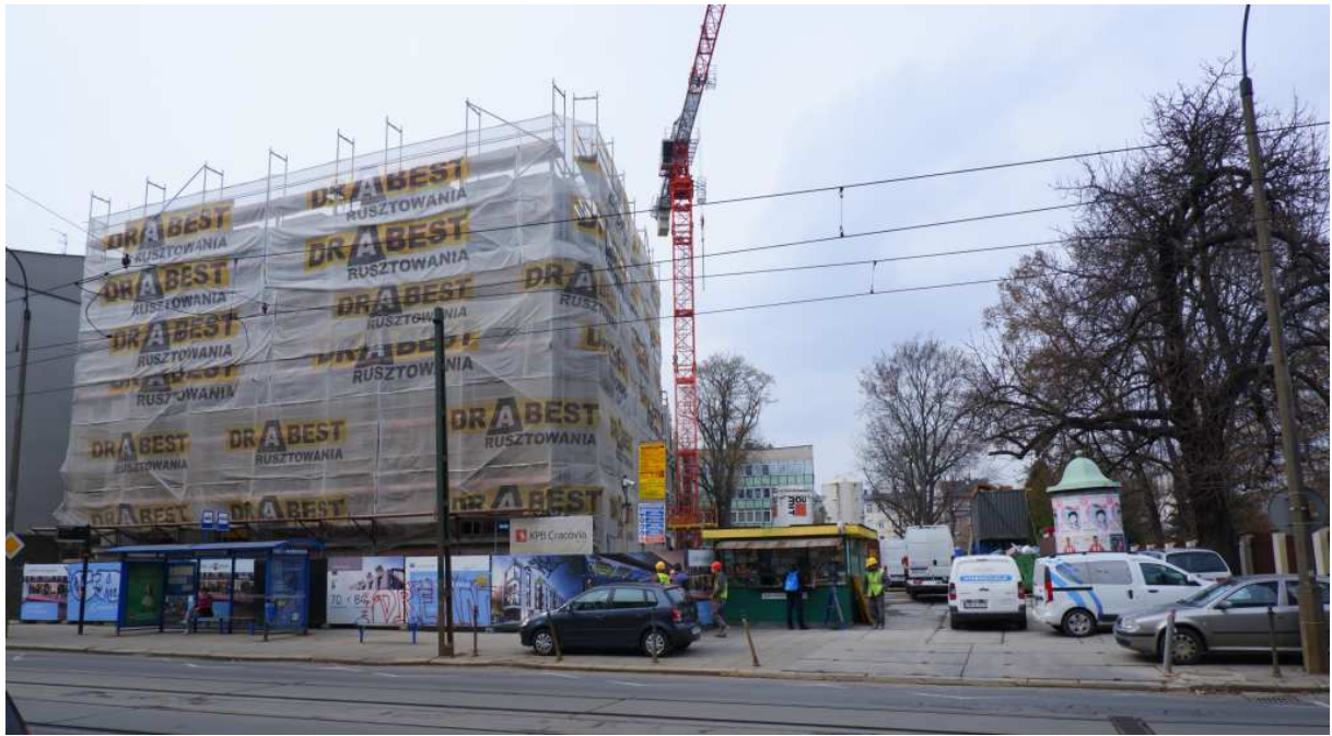
Fot. nr 215 (215-216). Trwa zabudowa posesji pod nr 39. (29.03.2022)
