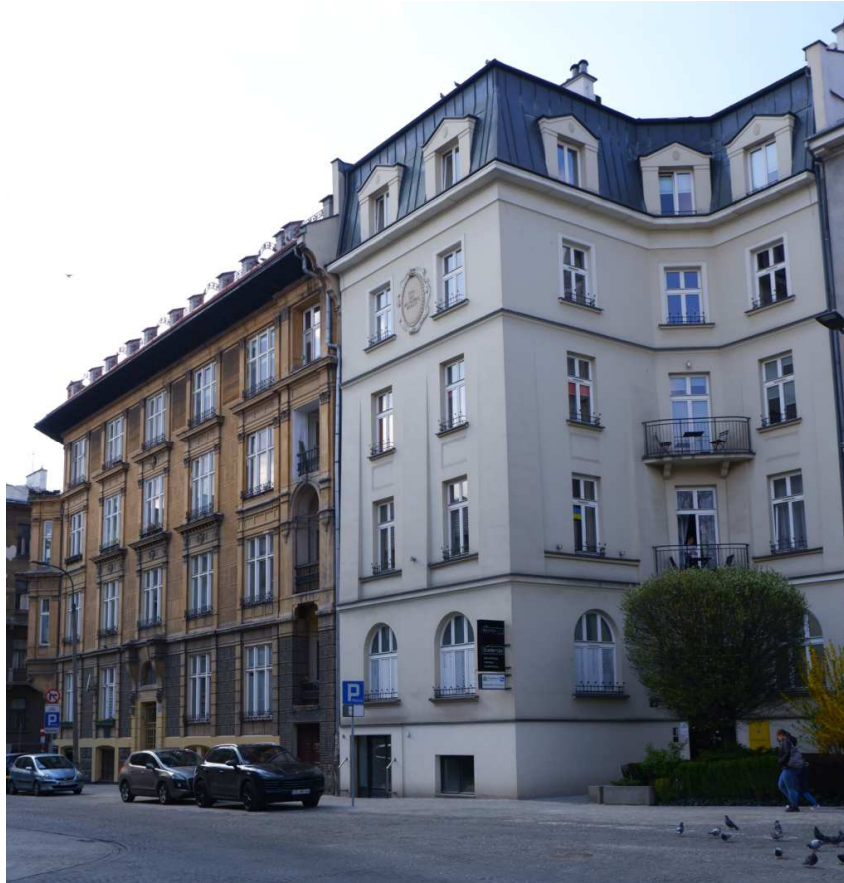
Fot. nr 58. Zabudowa ulicy pod nr 1 i 2. Z lewej Dom Jasny, kamienica własna Jana Zawiejskiego, a z prawej Dom Nad Młynówką. (19.04.2022)
