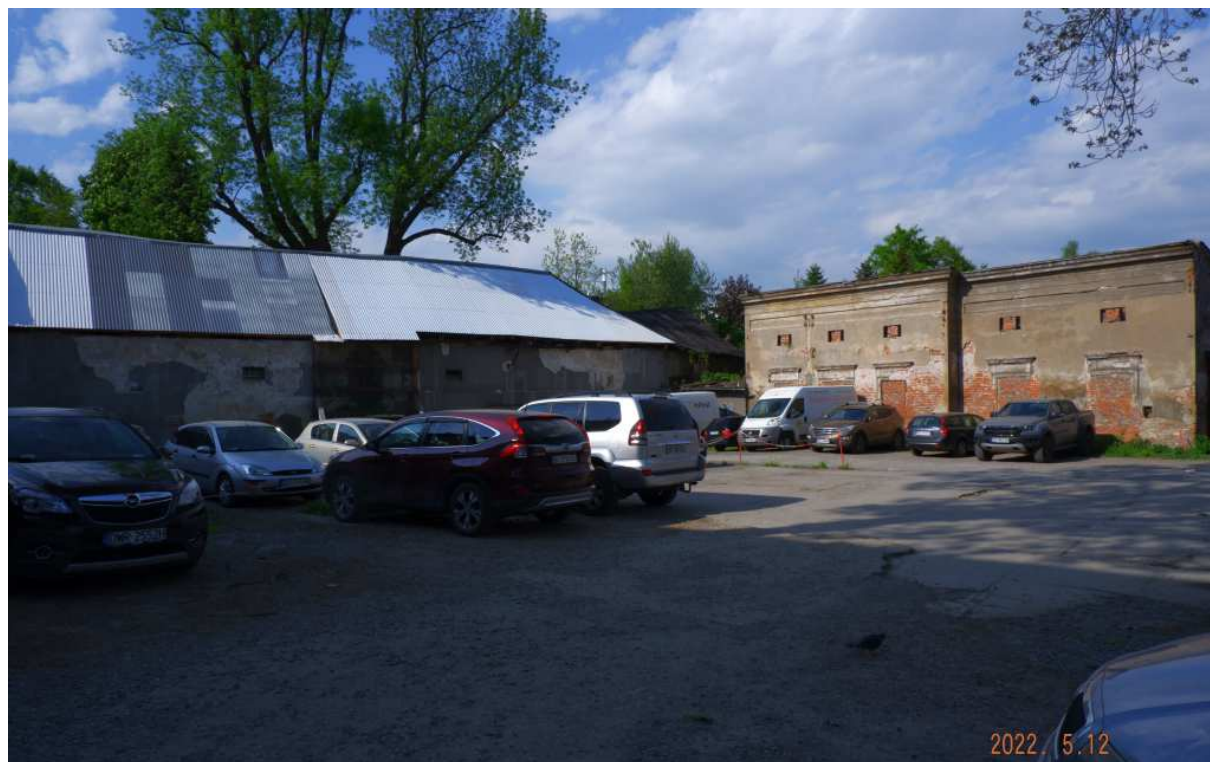
Fot. nr 161. Narożnik północno-wschodni.
