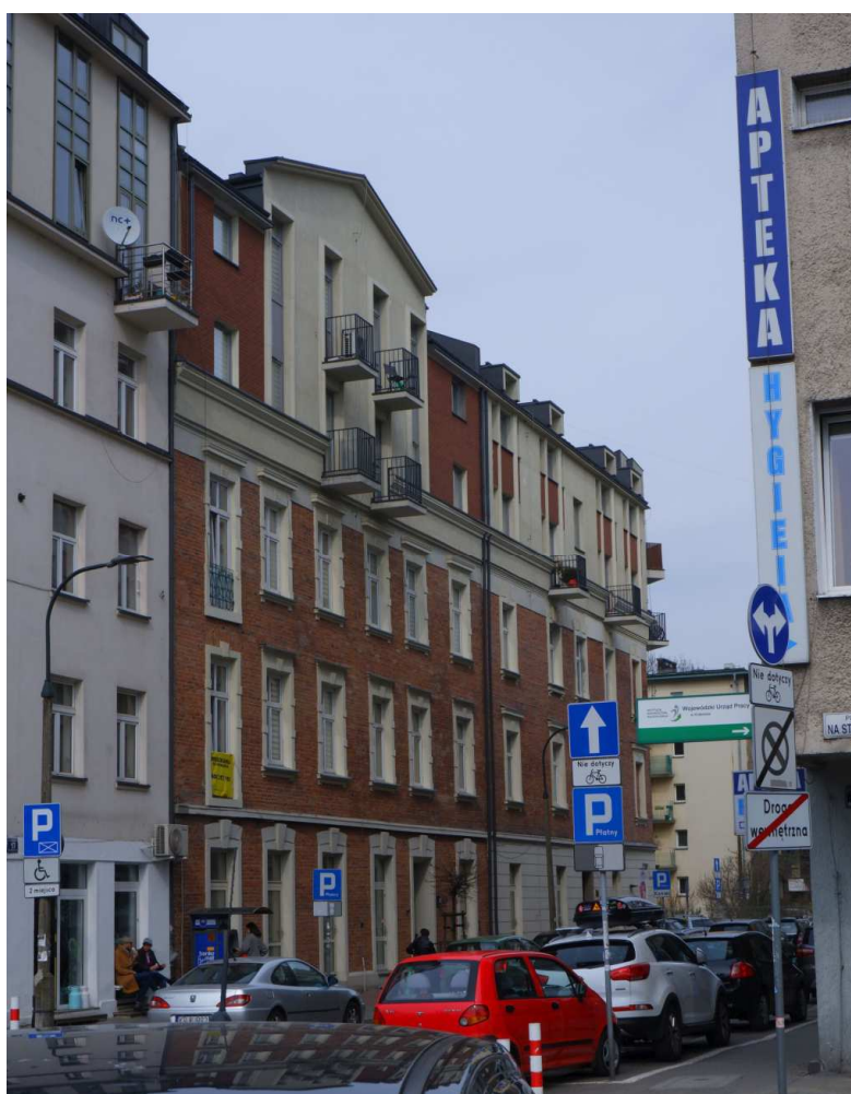
Fot. nr 236. Karkołomna nadbudowa kamienicy z ulicy Stachowicza 13. (29.03.2022)
