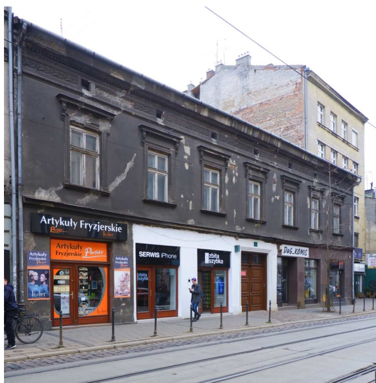
Fot. nr 187. Dom pod nr 12. (29.03.2022)
