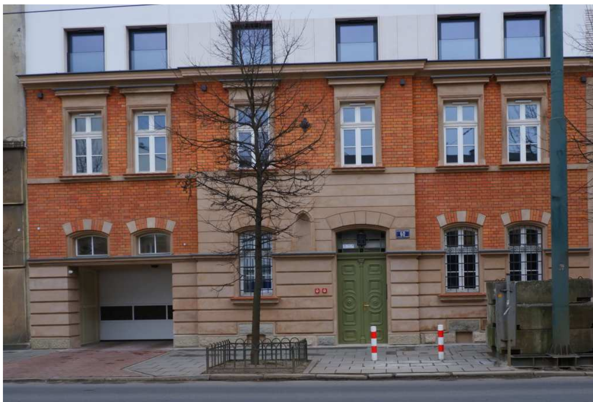
Fot. nr 226 (226-227). Fasada domu pod nr 60 „wklejona” w apartamentowiec. (29.03.2022)
