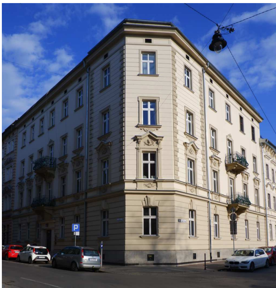
Fot. nr 131. Odnowiona kamienica z narożu: Loretańskiej 10 i Studenckiej. (23.04.2022)
