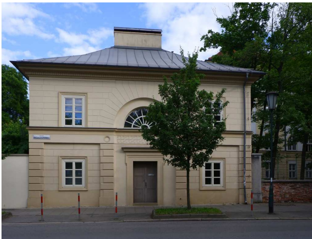
Fot. nr 325 (325-328). Zespół Collegium Śniadeckich, dawnego obserwatorium astronomicznego, pod nr 27. Prawa oficyna. (17.06.2022)
