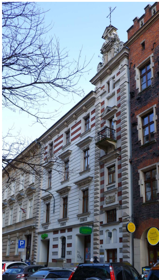
Fot. nr 65. Kamienica pod nr 26, dzieło Teodora Talowskiego z roku 1888. (19.04.2022)
