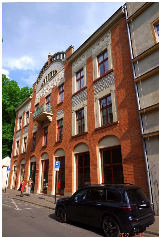
Fot. nr 43 (43-44). Secesyjna kamienica pod nr 3. (12.05.2022)
