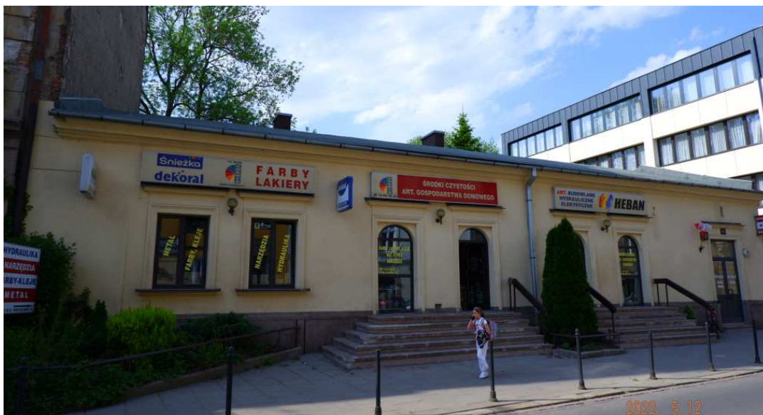
Fot. nr 152. Dom na kształt dworku spod nr 11, wybudowany w II poł. XIX wieku.
