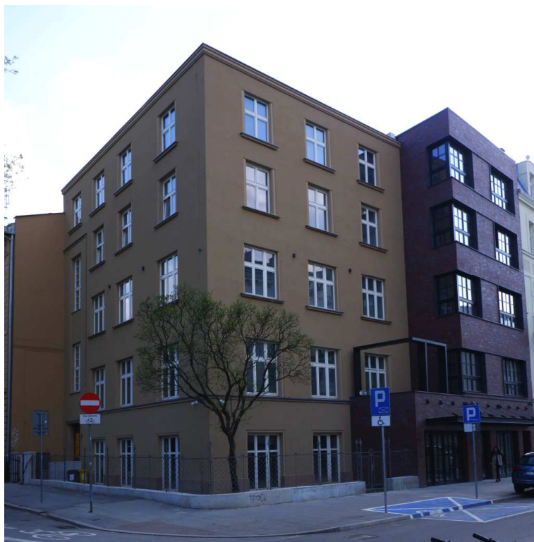
Fot. nr 87 (87-88). Współcześnie nadbudowana o jedno piętro kamienica pod nr 16/Szujskiego 11. (19.04.2022)
