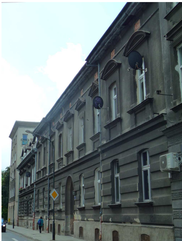
Fot. nr 404. Fragment zabudowy powyżej nr 19. (02.06.2022)
