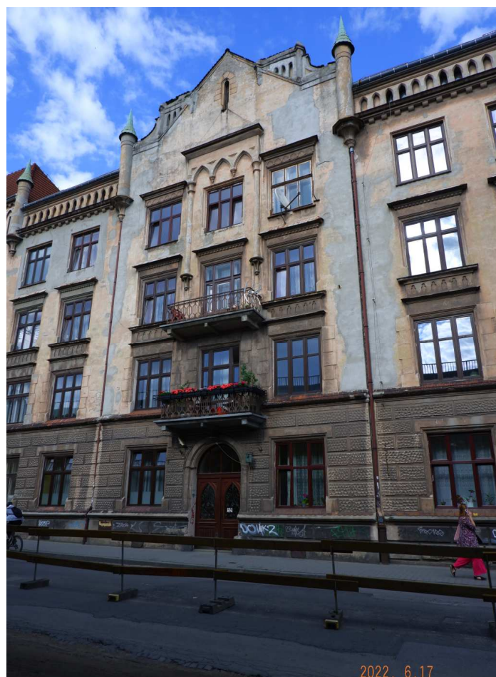
Fot. nr 302 (301-302). Kolejna kamienica c.k pracowników kolei pod nr 6/Sołtyka 2.
