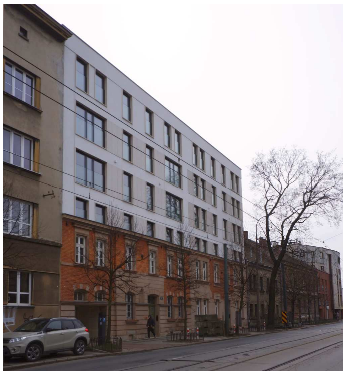
Fot. nr 223 (223-231). Fragment zabytkowej, powstałej z ok. roku 1910, niskiej zabudowy pod nr: 60-66, która podlega współczesnej dewastacji. (29.03.2022)
