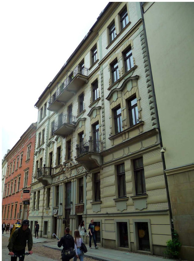
Fot. nr 140 (140-141). Kamienica pod nr 3, przykład obiektu z okresu przejściowego między eklektyzmem i secesją. (08.06.2022)
