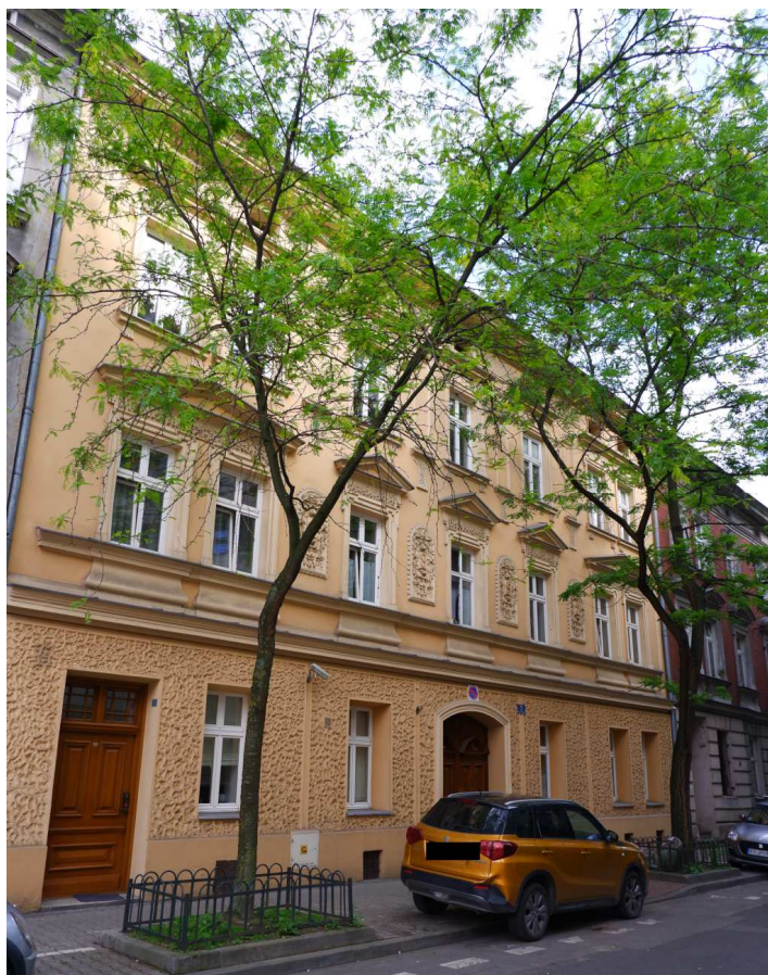
Fot. nr 298 (298-300). Kamienica przy ulicy Dwernickiego 7 i jej detale. (17.06.2022)
