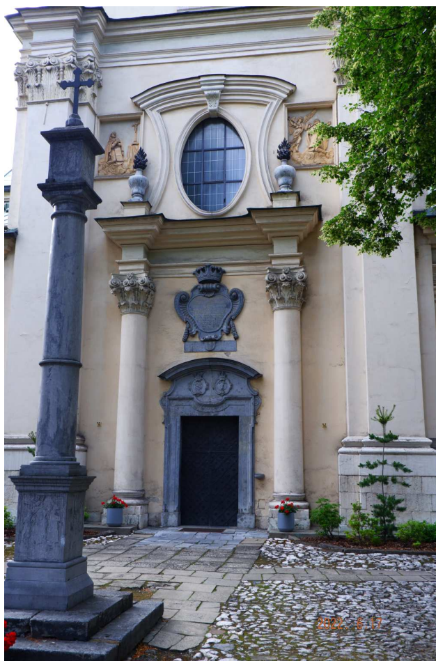
Fot. nr 318. Kolumna na dziedzińcu i barokowy portal przy wejściu do kościoła.
