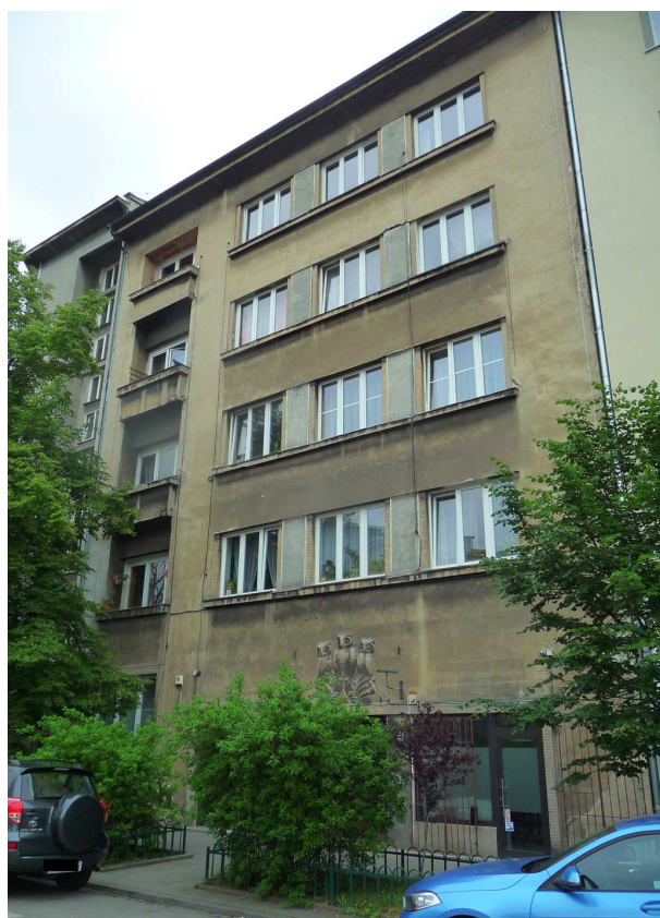
Fot. nr 412 (412-413). Przedwojenna (wybudowana w roku 1937) kamienica Pod Sowami z ulicy Metalowców 5. (10.06.2022)
