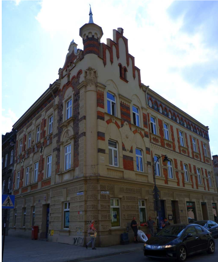
Fot. nr 285 (285-286). Kamienica pod nr 15 w narożu z ulicą św. Filipa 16. (12.05.2022)
