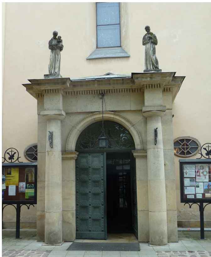
Fot. nr 129. Portal przy wejściu do kościoła. (08.06.2022)
