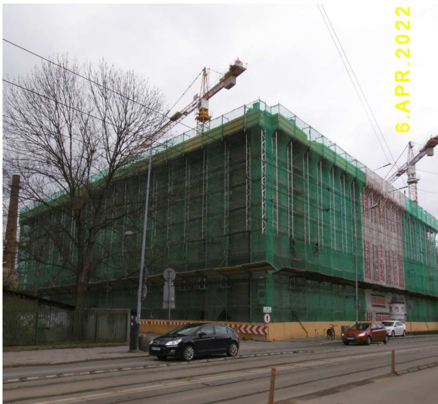
Fot. nr 394 (393-394). Remontowany i rozbudowywany budynek dawnej bursy akademickiej AM pod nr 20.
