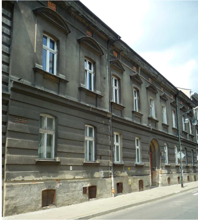
Fot. nr 405 (405-406). Kamieniczka pod nr 19 z roku 1907 i jej detale.
