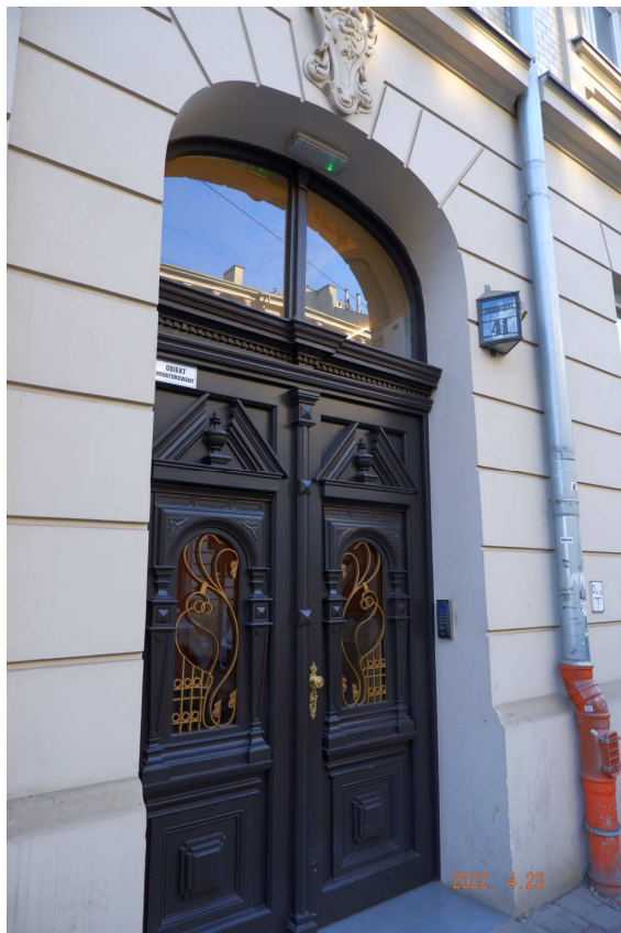
Fot. nr 433. Przykładnie odnowione drzwi kamienicy z ulicy Starowiśnej 41.
