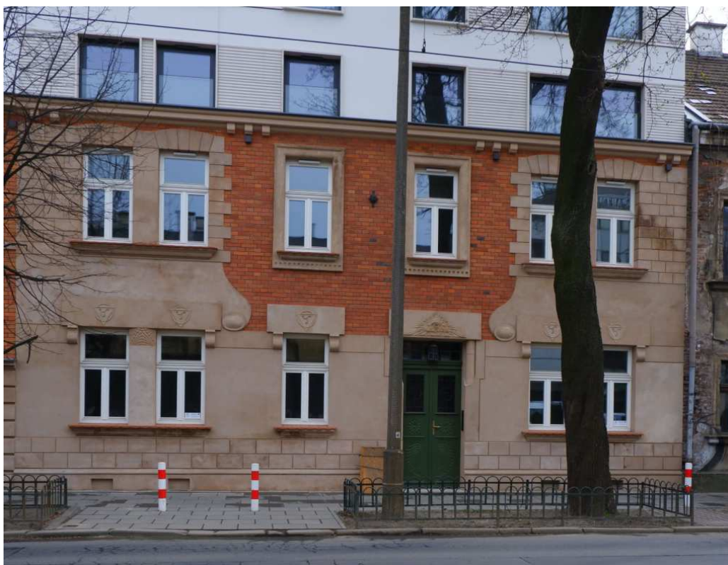
Fot. nr 228 (228-229). Zniszczony dom Pod Opatrznością spod nr 62. (29.03.2022)
