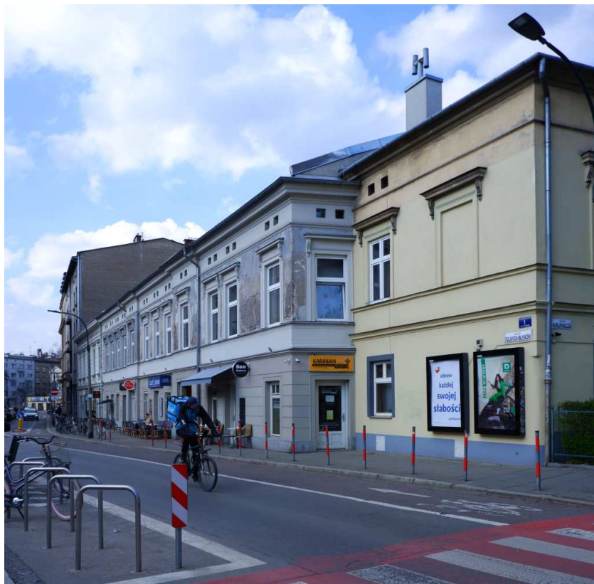
Fot. nr 96. Ulica Dolnych Młynów – widok z ulicy Krupniczej. (19.04.2022)
