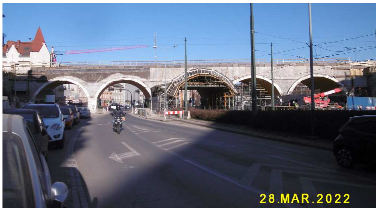
Fot. nr 416. Widok od strony ulicy Dietla.
