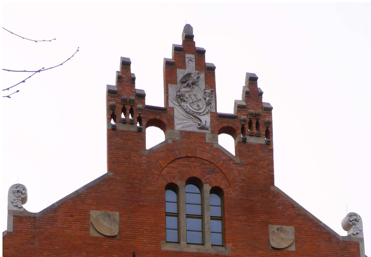
Fot. nr 116. Zwieńczenie ściany szczytowej. (19.04.2022)
