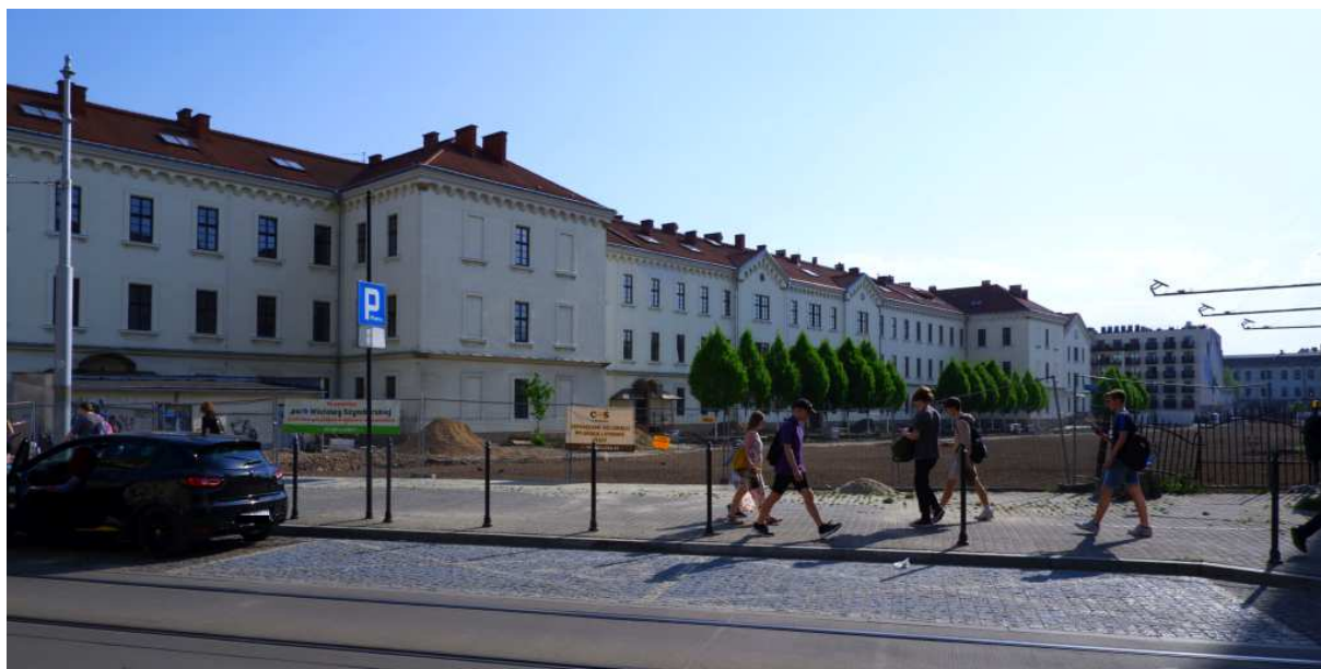
Fot. nr 164. Dziedziniec dawnych c.k. koszar przy ulicy Rajskiej 1-3, gdzie właśnie powstaje park. (12.05.2022)
