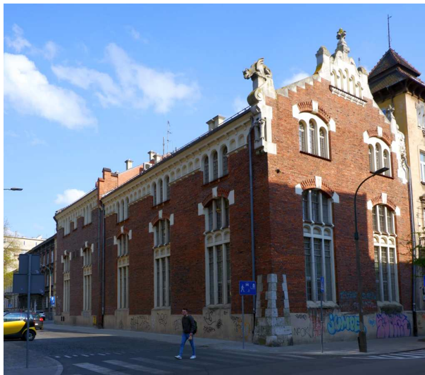
Fot. nr 59 (59-61). Wzdłuż ulicy Łobzowskiej. Budynek podstacji elektrycznej pod nr 12/Biskupia 1.(19.04.2022)
