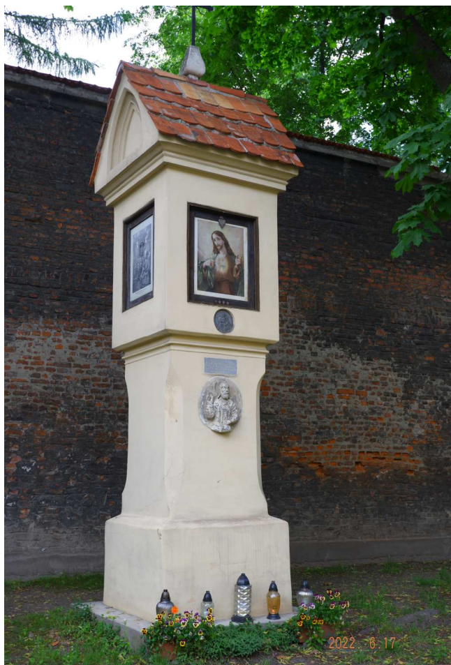
Fot. nr 322 (322-324). Kapliczka słupowa przy murze klasztoru Karmelitanek z roku 1812.
