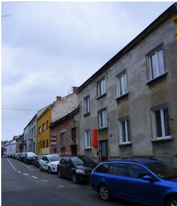
Fot. nr 140. Zabudowa ulicy poniżej domu o numerze 92. (04.04.2022)
