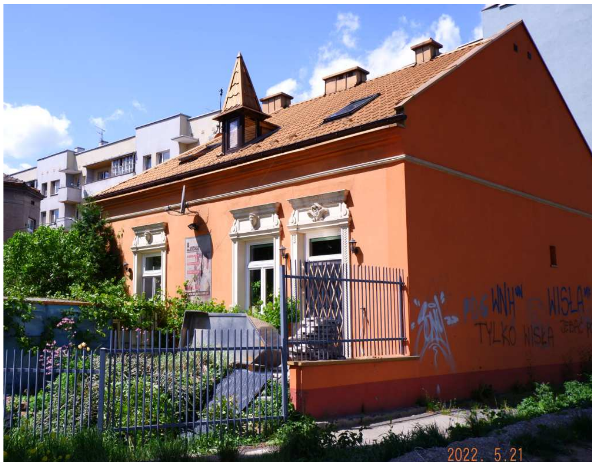
Fot. nr 266. Widok od strony ogrodu. (21.05.2022)
