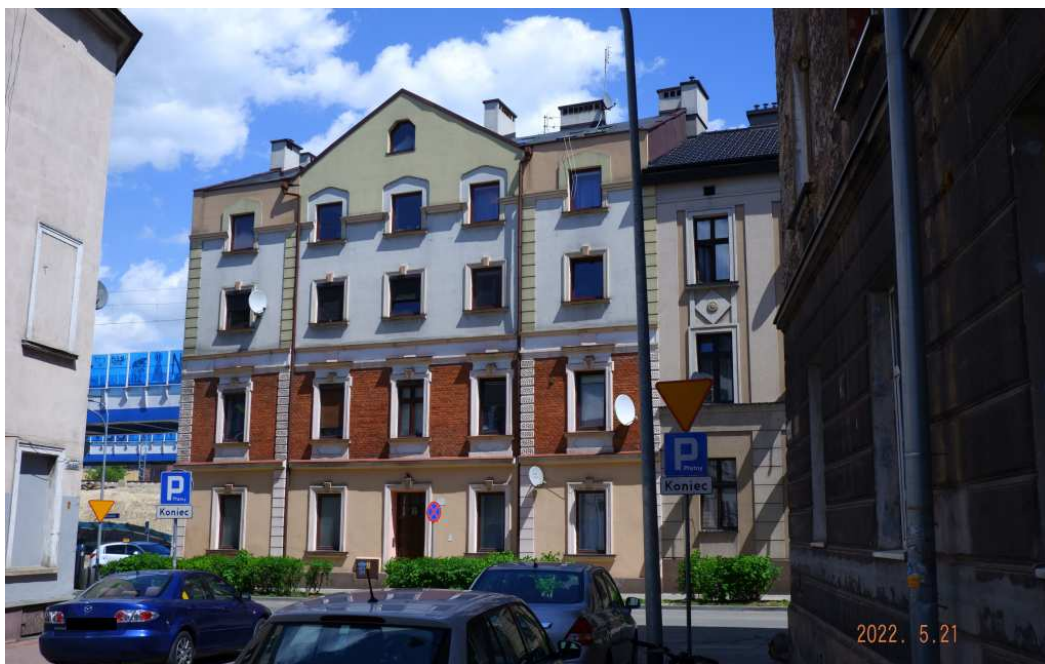
Fot. nr 260 (260-267). Zabudowa wzdłuż ulicy Hetmańskiej. Nadbudowana kamienica pod nr 4. Oryginał powstał w latach 1901-1904 wg projektu Leopolda Tlachny.
