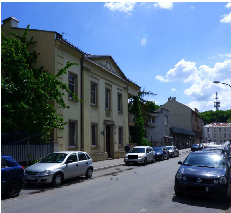
Fot. nr 210 (210-211). Wzdłuż ulicy Smolki poniżej nr 13. (28.05.2022)
