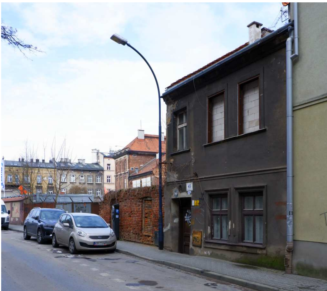
Fot. nr 35. Fragment zabudowy ulicy poniżej domu o nr 45. (04.04.2022)
