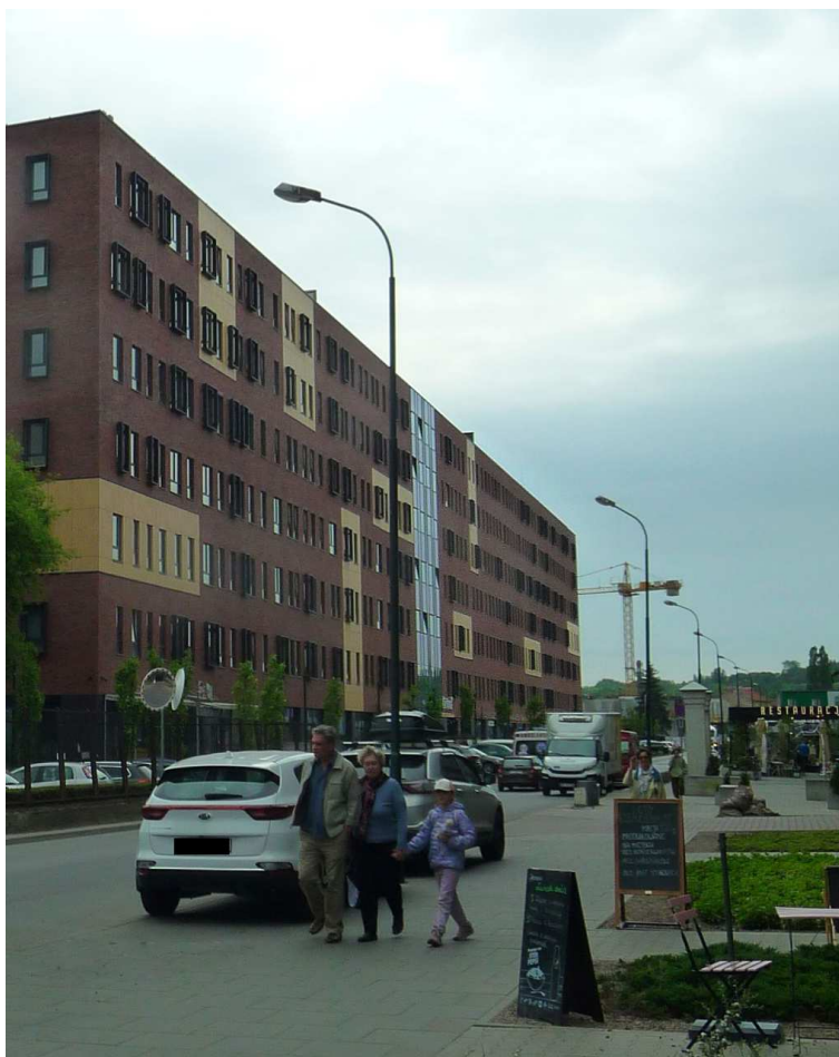
Fot. nr 275. Dawny budynek Krakowskich Zakładów Elektronicznych TELPOD pod nr 4, współcześnie przerobiony na ekskluzywny akademik. (24.05.2022)
