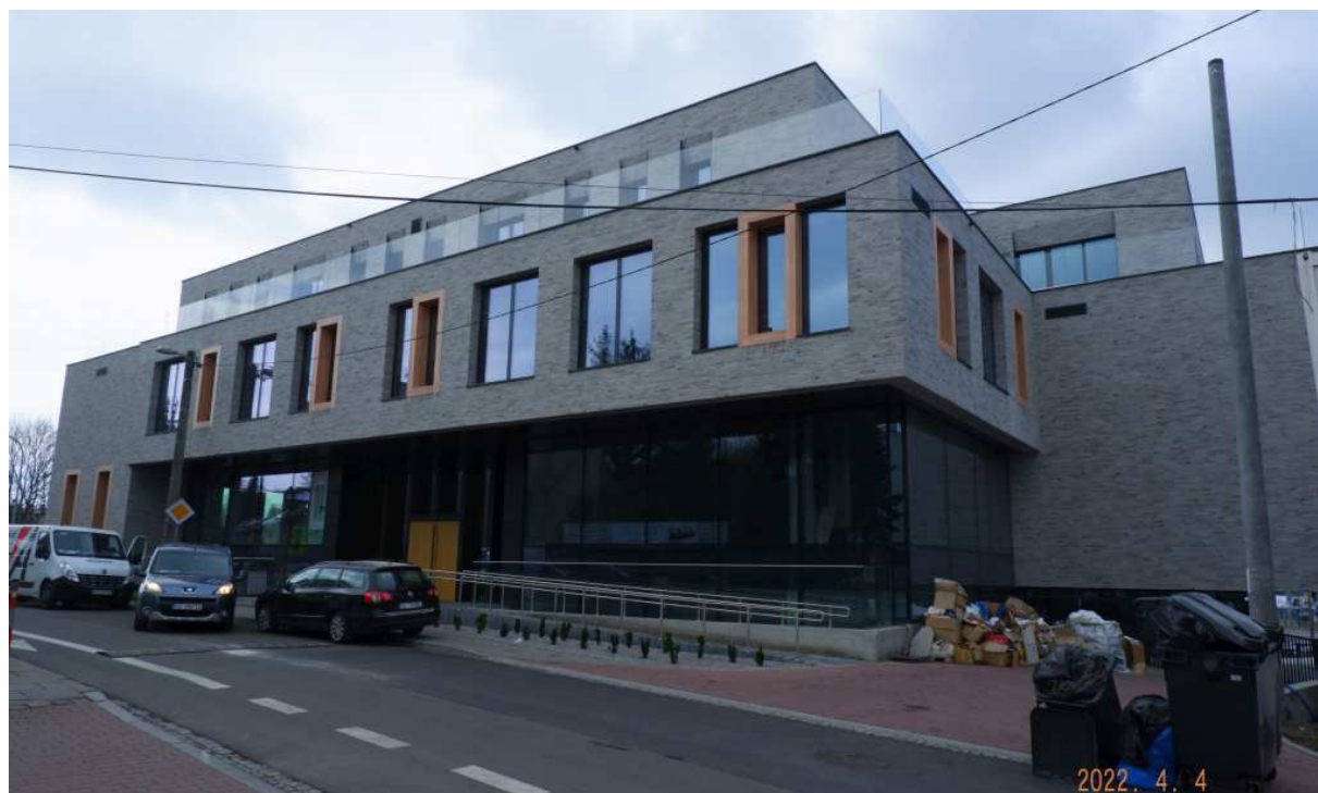
Fot. nr 143. Nowy budynek pod nr 81, który powstał po wyburzeniu 10 lat temu dwóch 100-letnich willi drewnianych.
