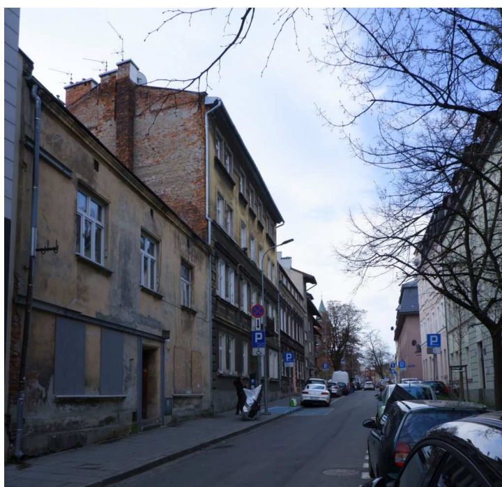
Fot. nr 79. Zabudowa ulicy powyżej domu o numerze 32. (04.04.2022)
