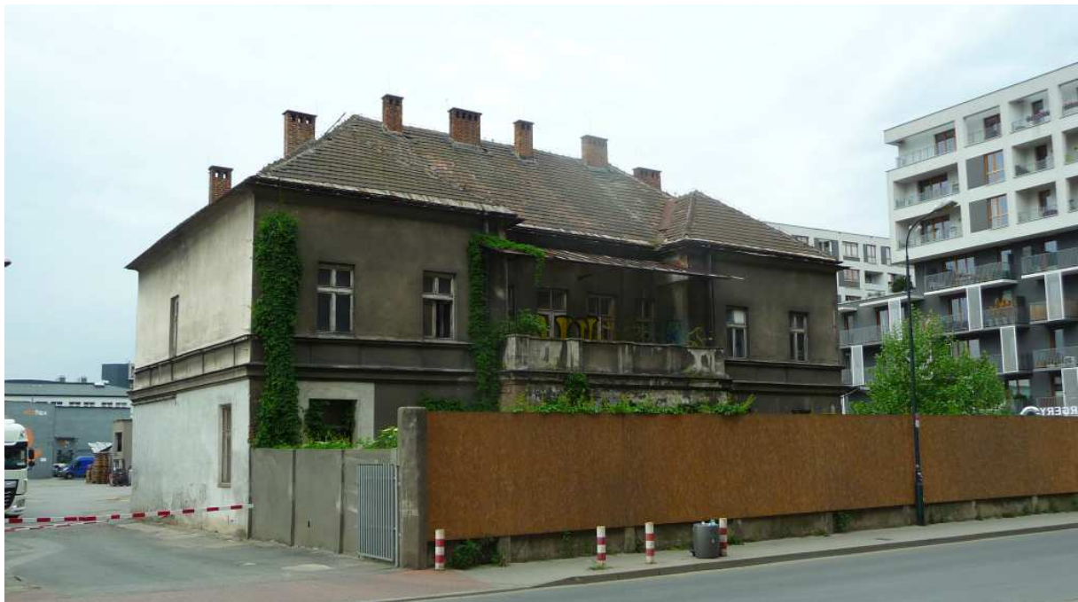
Fot. nr 272 (272-274). Willa z lat 20. XX wieku spod nr 9, będąca pamiątką po Krakowskiej Fabryce Drutu i Wyrobów Żelaznych W. Kucharskiego. Fabryka ta, która była kontynuatką działalności zakładu Józefa Goreckiego, działającego przy ulicy Dajwór 5 pod nazwą: „Fabryka siatek, mebli, konstrukcji żelaznych i wyrobów ornamentalnych kutych”, po I wojnie światowej została przeniesiona na Zabłocie. Już wcześniej jego współnikiem był W. Kucharski, samodzielny właściciel firmy od roku 1920. (24.05.2022)
