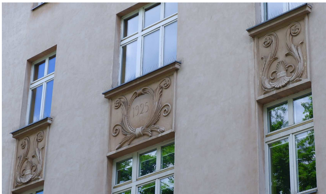
Fot. nr 190. Zdobnictwo nad oknami I. piętra. (28.05.2022)
