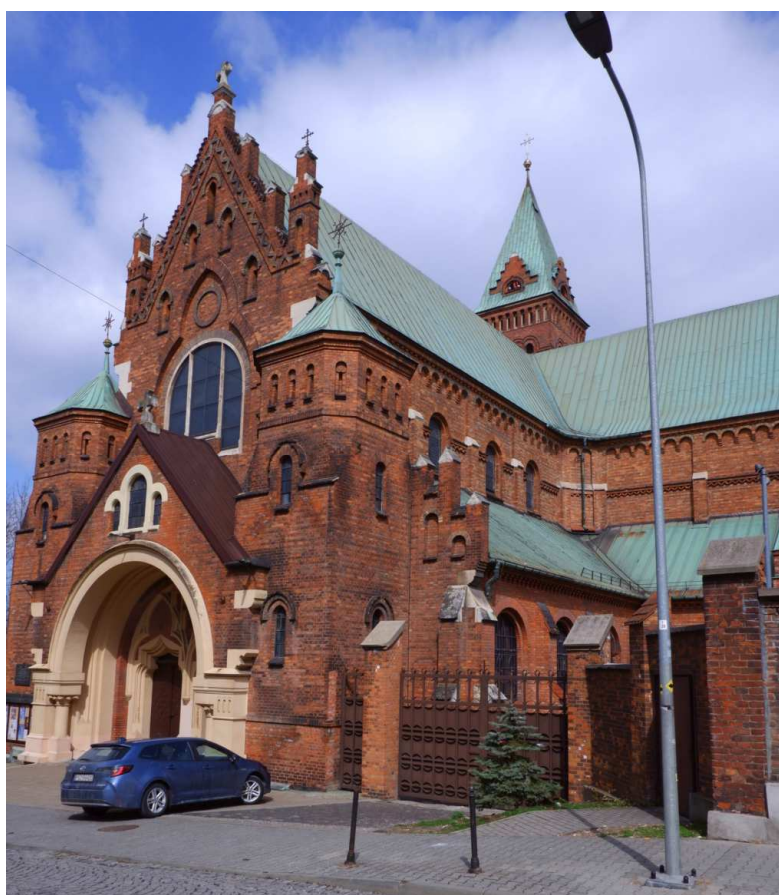
Fot. nr 114. Fasada w ujęciu z ulicy Redemptorystów. (04.04.2022)
