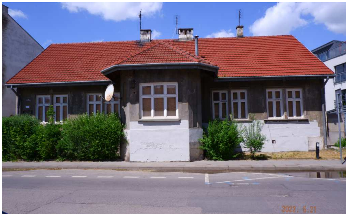
Fot. nr 283 (283-284). Dom z murowanym gankiem pod nr 4, wybudowany w roku 1878 wg projektu Stanisława Serkowskiego.
