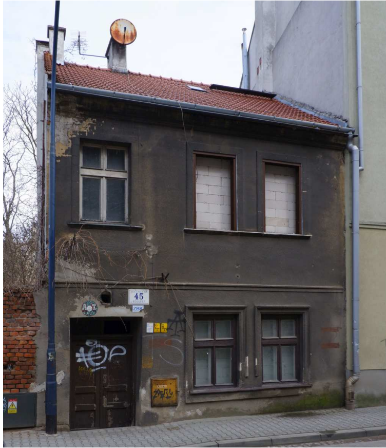
Fot. nr 36. Dom pod nr 45, wybudowany w roku 1887 wg projektu Józefa Taborskiego. (04.04.2022)
