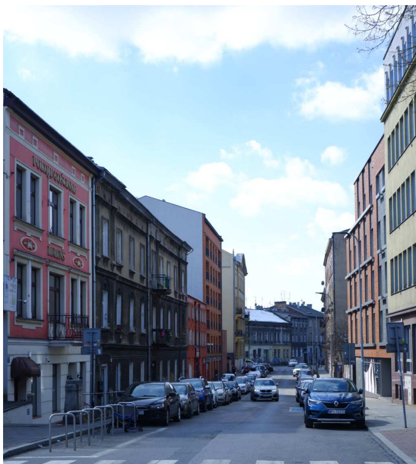
Fot. nr 177. Ulica Rejtana w ujęciu z ulicy Legionów, z zabudową od ostatniej dekady XIX wieku po I dekadę wieku XX. (04.04.2022)
