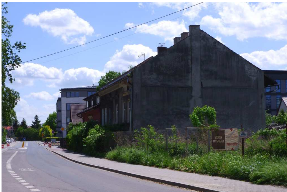
Fot. nr 291. Zabudowa ulicy poniżej domu o numerze 17. (21.05.2022)
