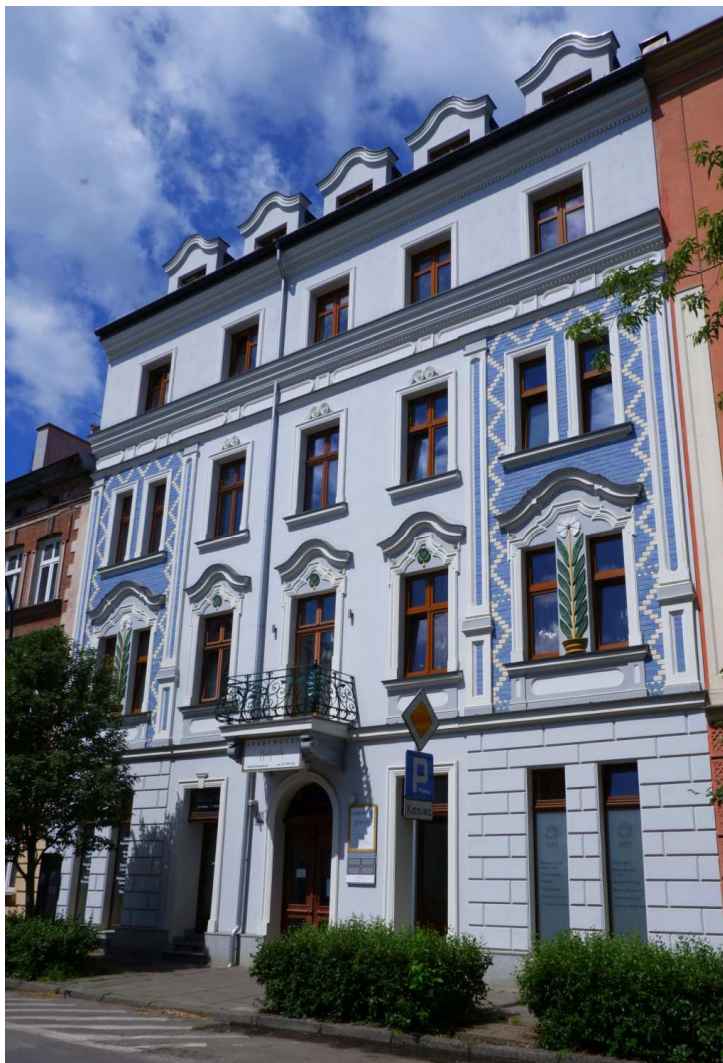
Fot. nr 213 (213-216). Secesyjne zdobnictwo odnowionej i przebudowanej kamienicy pod nr 8, powstałej w roku 1909, pierwotnie dwupiętrowej. (28.05.2022)
