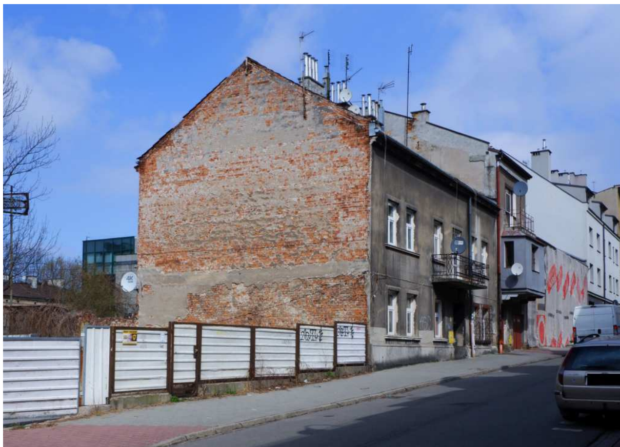
Fot. nr 153. Zabudowa poniżej posesji o numerze 10. (04.04.2022)
