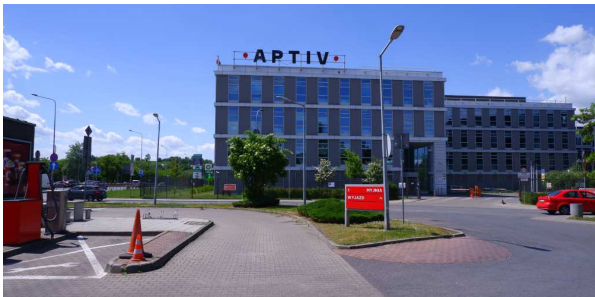
Fot. nr 301 (302-306). Nowo powstały budynek pod nr 9.
