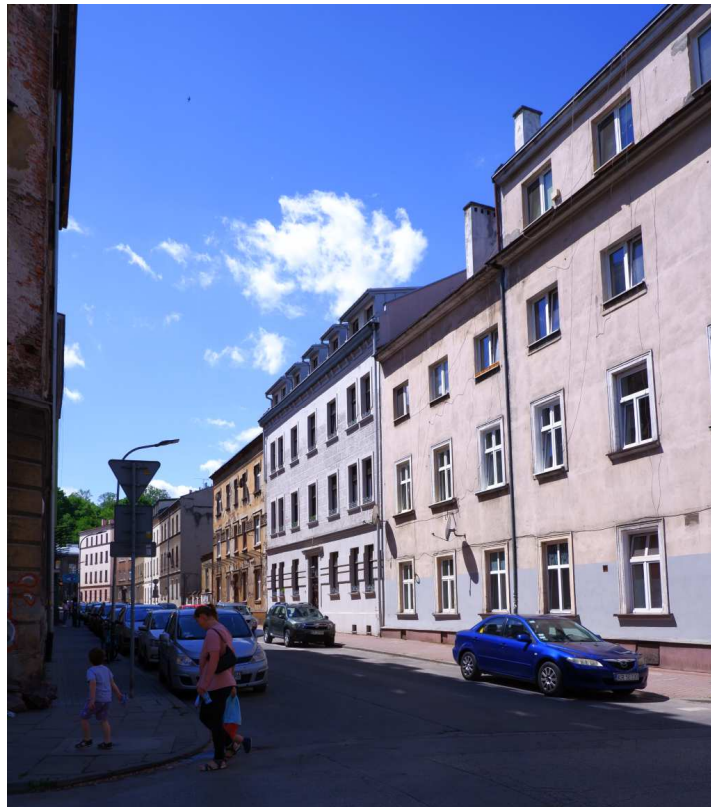
Fot. nr 259. Widok z ulicy Hetmańskiej. Zabudowa ulicy św. Kingi pochodzi z I ćwierci XX wieku. (21.05.2022)
