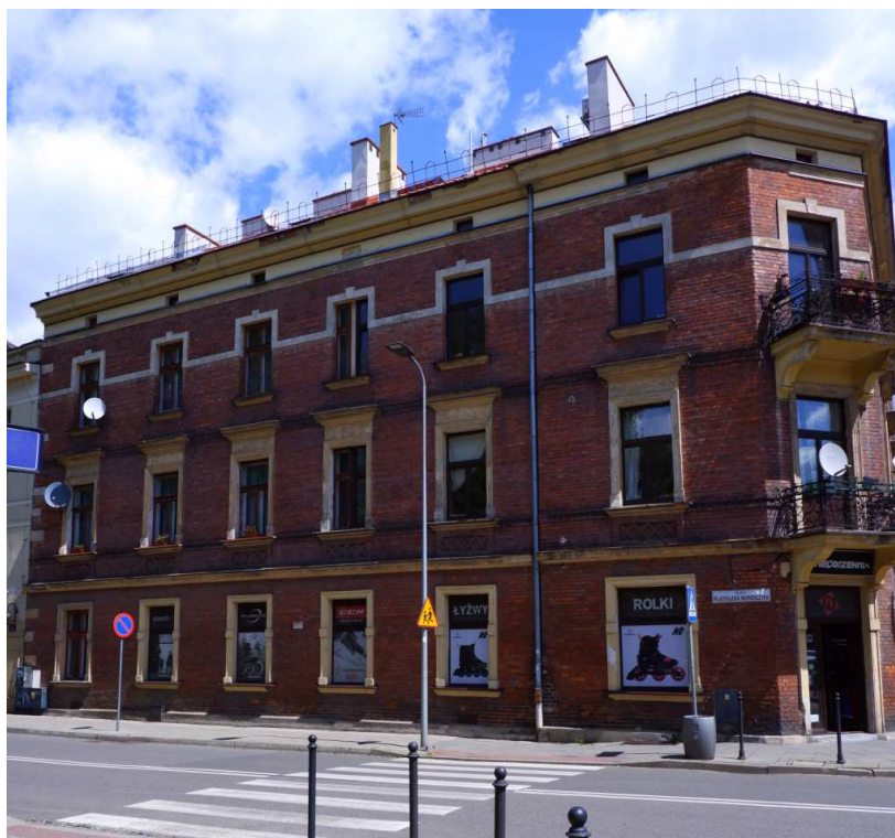
Fot. nr 176. Kamienica spod nr 12 z lat 1911-12 (projektant jak powyżej). (28.05.2022)
