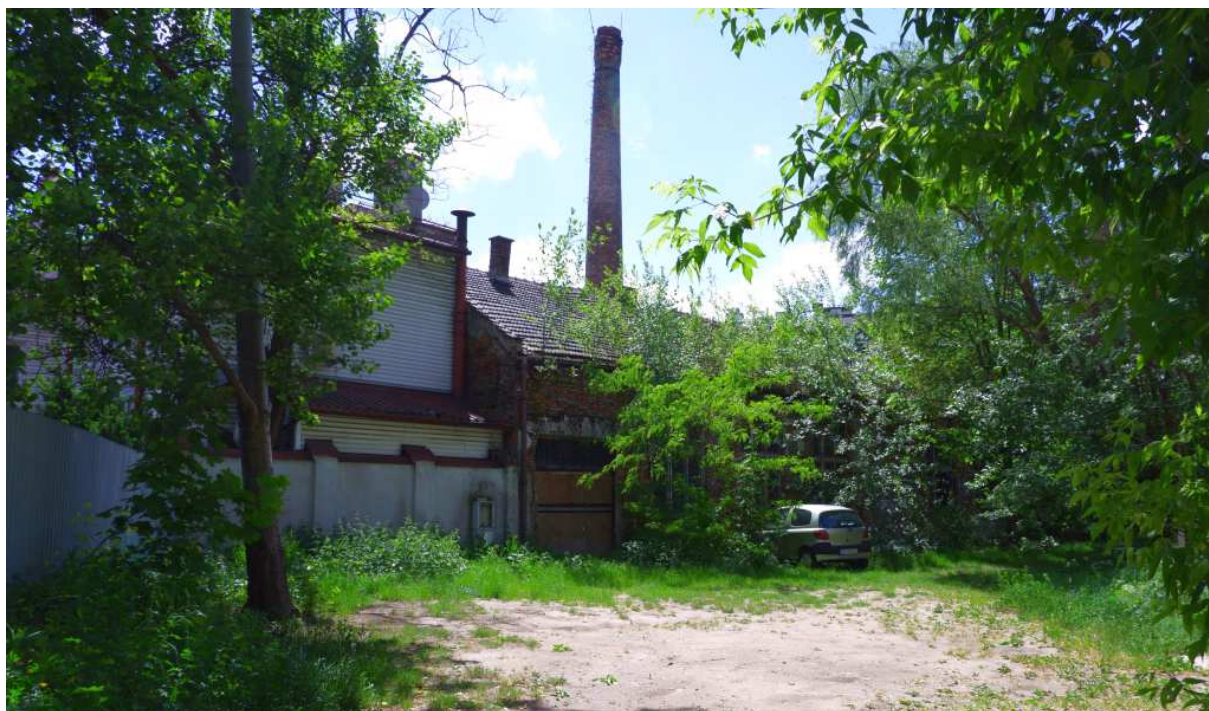
Fot. nr 244 (243-244). Budynki fabryczne w ujęciu z ulicy Dąbrowskiego. (21.05.2022)
