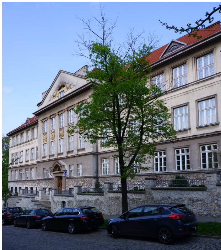
Fot. nr 125. Budynek IV L.O. pod nr 11. (03.05.2022)
