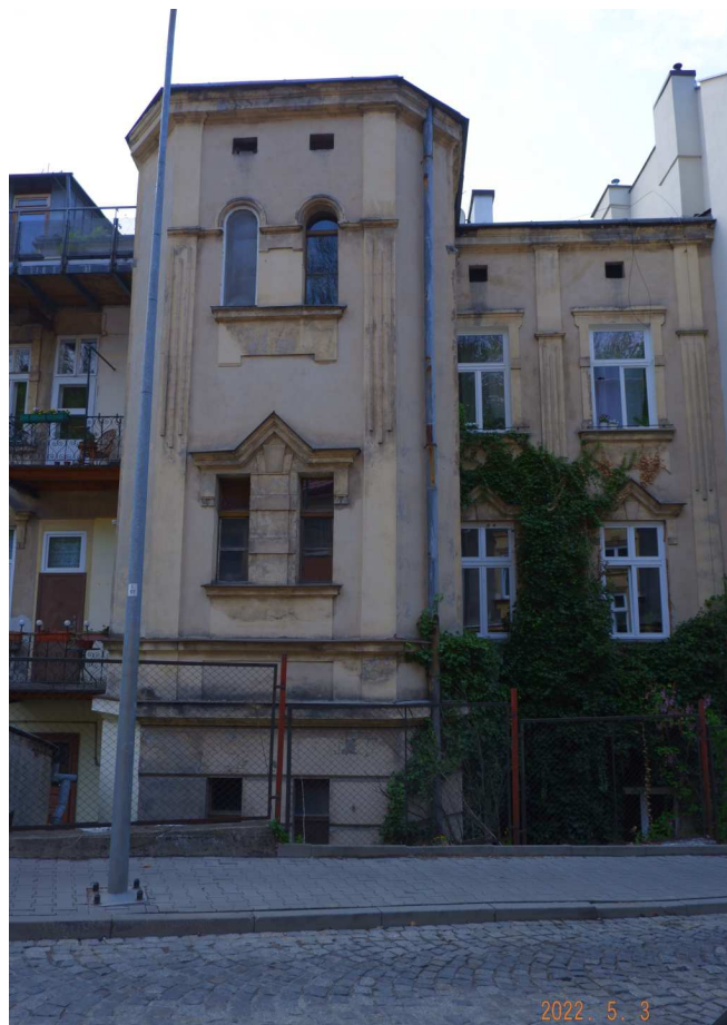
Fot. nr 128. Ryzalit na tyłach kamienicy z ulicy Zamojskiego 26.
