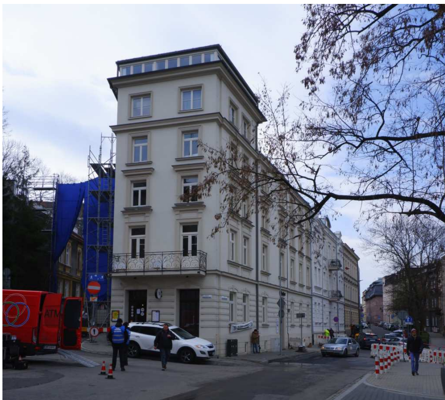
Fot. nr 73. Kamienica z pocz. XX wieku pod nr 24, róg z ulicą Krzemionki 2. (04.04.2022)
