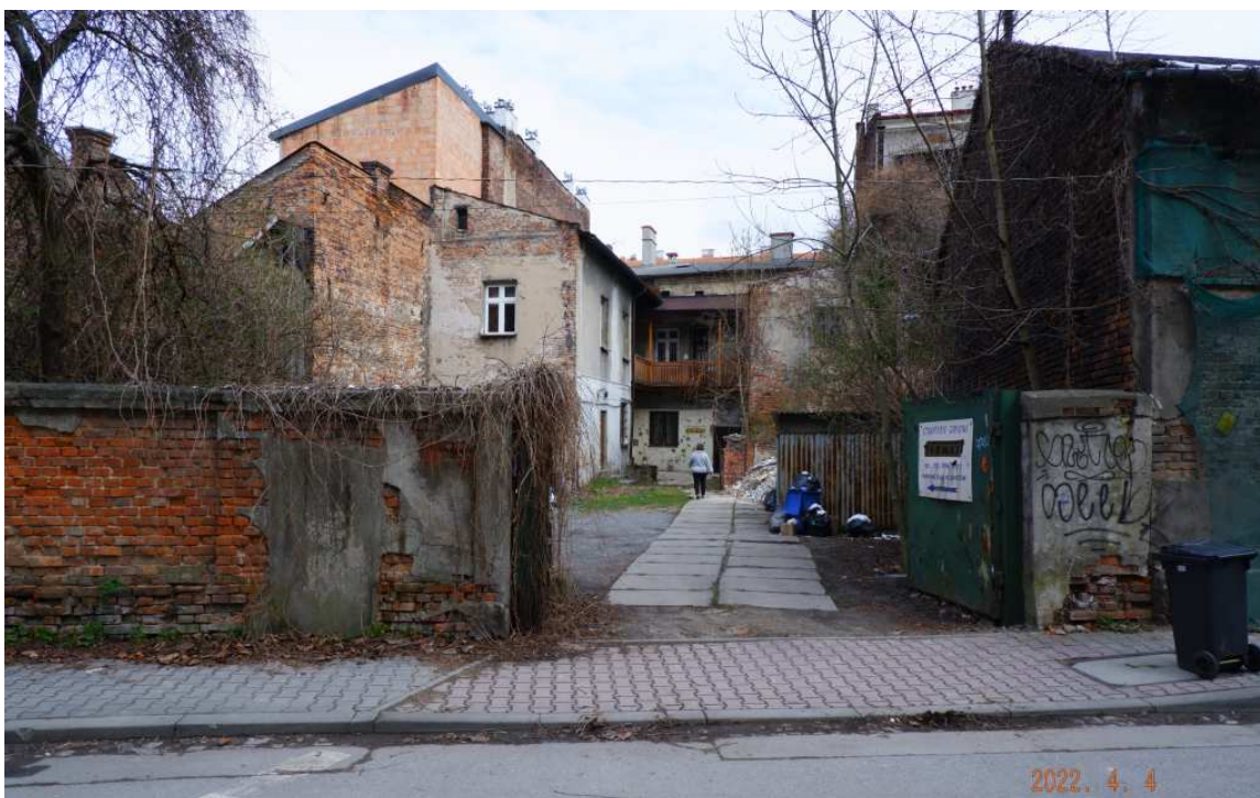
Fot. nr 31. Podwórko na tyłach ulicy Limanowskiego w sąsiedztwie domu o numerze 55.
