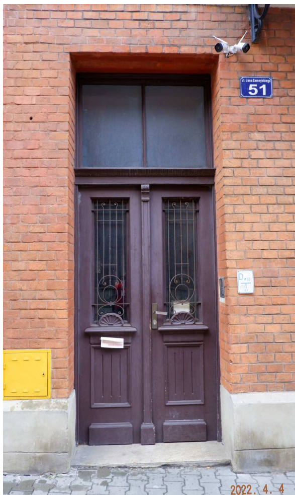
Fot. nr 105. Oryginalne drzwi.
