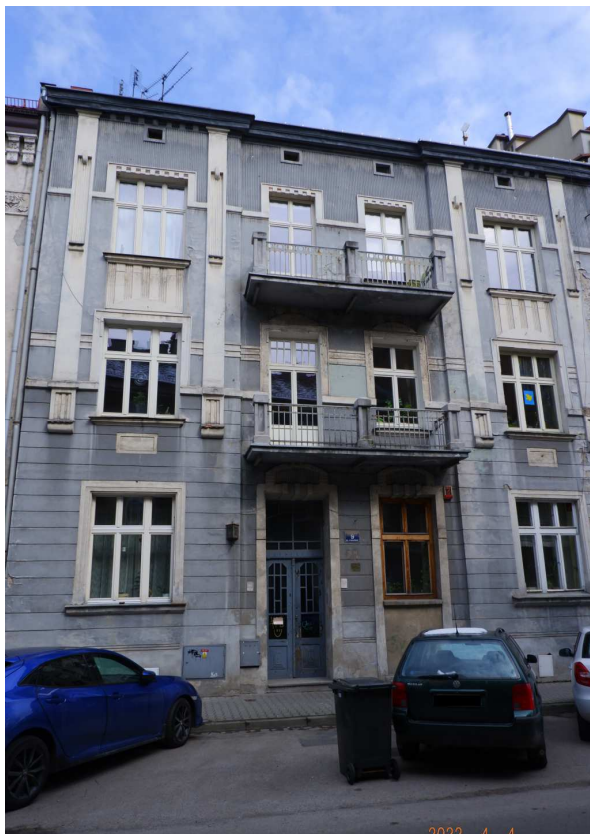
Fot. nr 54. Secesyjna już kamienica pod nr 9 z roku 1912. (04.04.2022)
