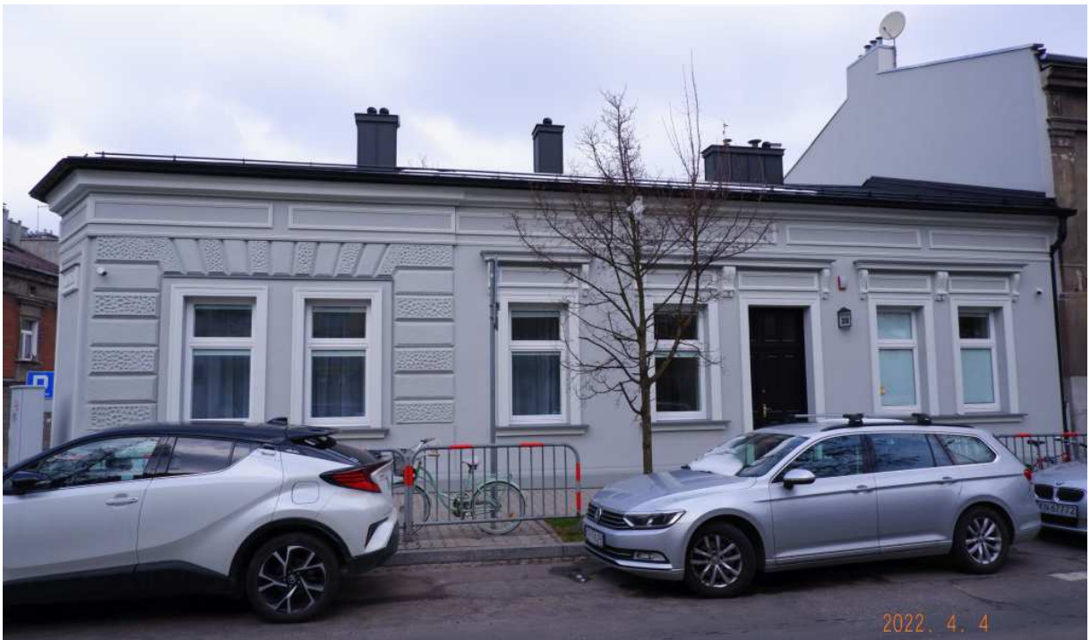
Fot. nr 90 (90-91). Parterowy relikw typowy dawnej zabudowy Podgórze spod nr 39, w narożu z ulicą Smółki. Dom powstał w latach 1886-88 wg projektu Józefa Taborskiego. Gdyby po solidnym remoncie zrekonstruowano również oryginalne okna.....
