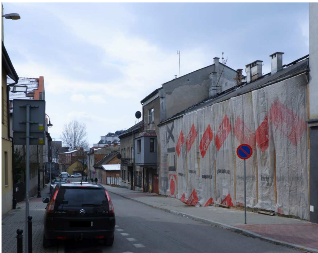
Fot. nr 155. Fragment zabudowy poniżej remontowanego domu nr 4. (04.04.2022)
