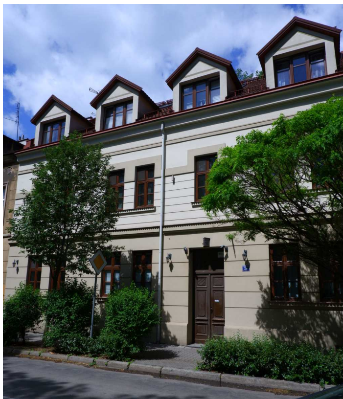
Fot. nr 219. Nadbudowana kamieniczka pod nr 26 z lat 1906-1907. (28.05.2022)
