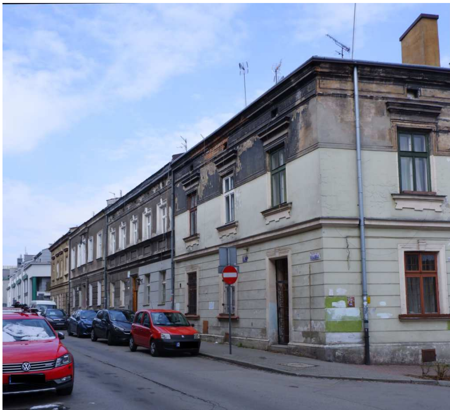
Fot. nr 39. Fragment zabudowy ulicy Rękawka poniżej domu o nr 29. (04.04.2022)
