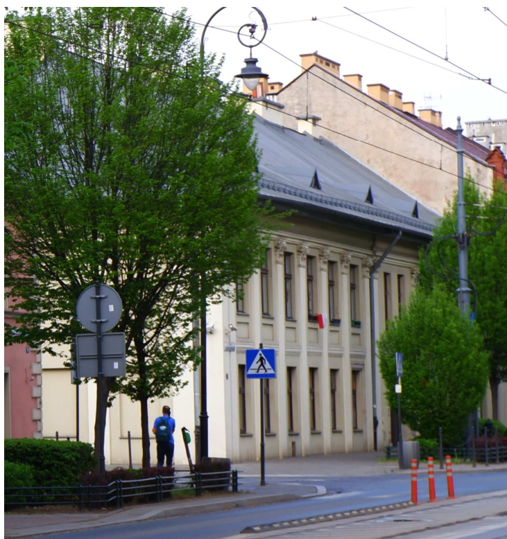
Fot. nr 239. Zabytkowy, bo wybudowany w roku 1843, dom spod nr 13. (03.05.2022)
