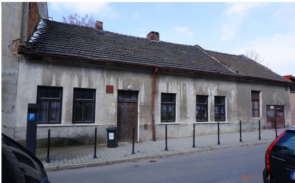
Fot. nr 151. Parterowy dom spod nr 14 z I połowy XX wieku. (04.04.2022)
