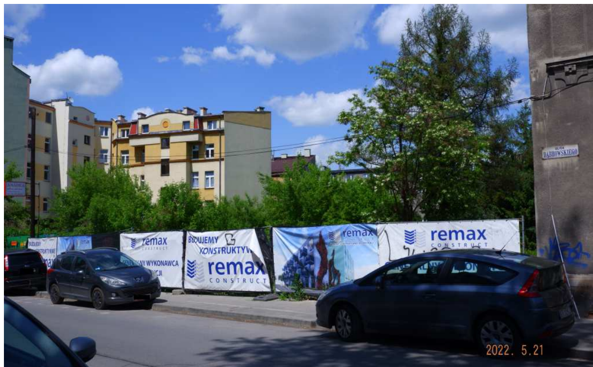
Fot. nr 246. Pusta przestrzeń po niedawno wyburzonym domku spod nr 12.
