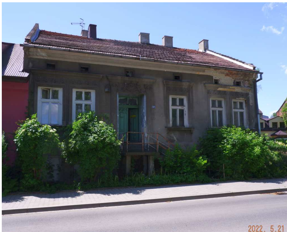
Fot. nr 292 (292-293). Typowo podmiejski dom pod nr 17, datowany na początek XX w.
