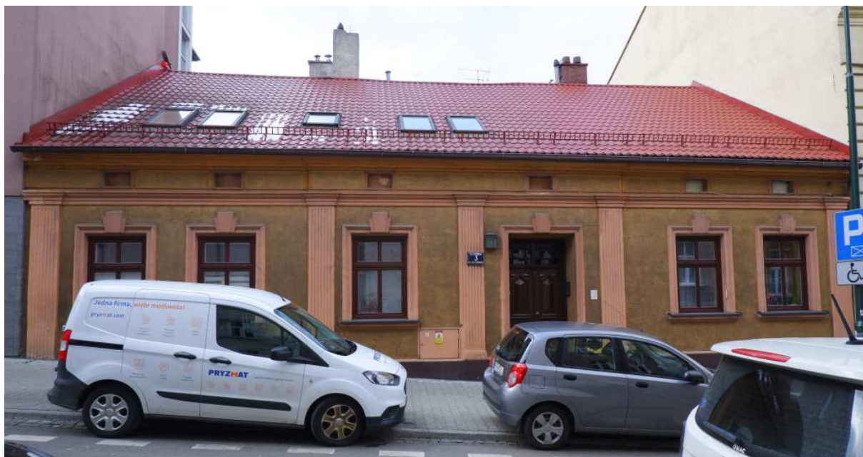
Fot. nr 83 (83-85). Parterowy dom pod nr 3 z roku 1887 i jego detale. (04.04.2022)
