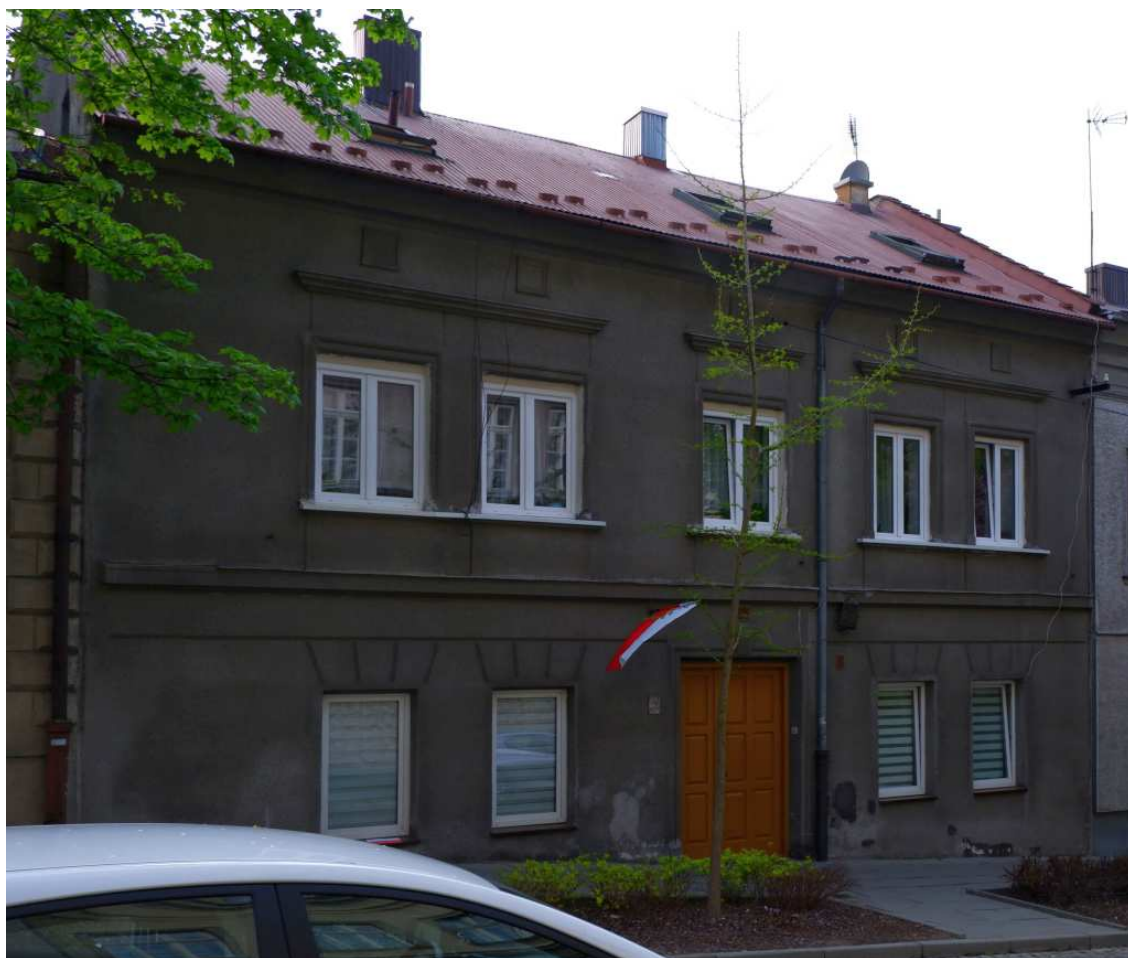
Fot. nr 127a. Dom pod nr 14 ze współcześnie wymienionymi oknami. (03.05.2022)
