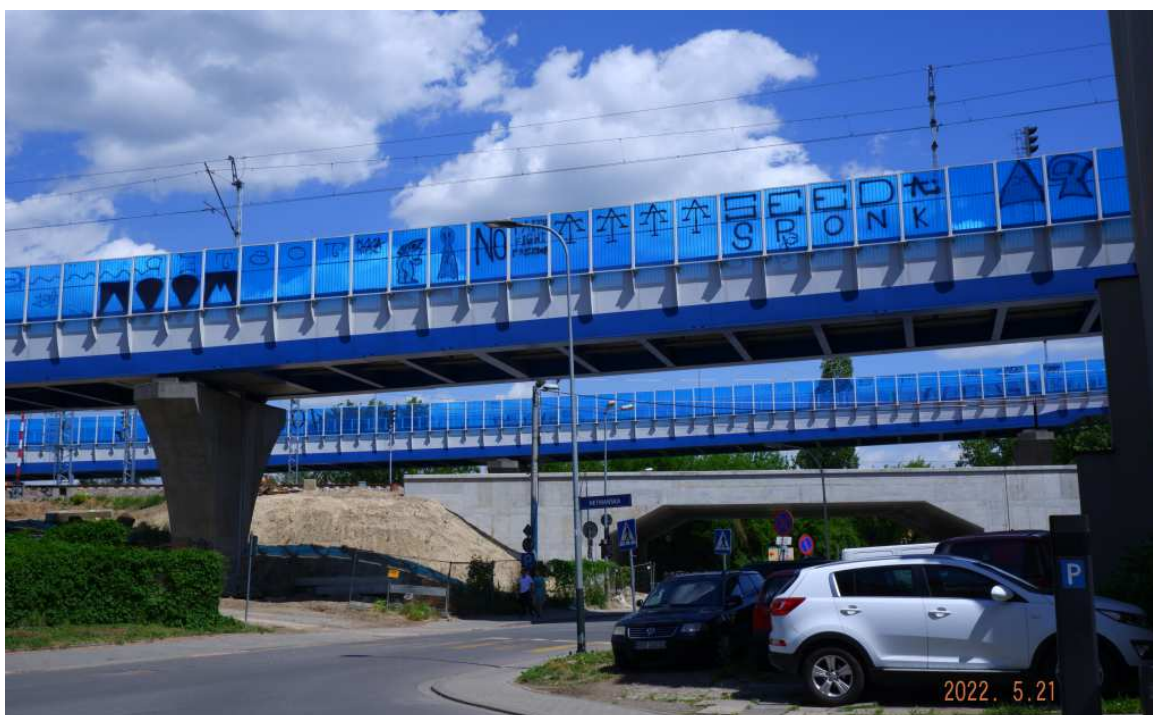
Fot. nr 254. Niedawno wybudowana nitka łącznicy kolejowej, która skraca drogę ze stacji Kraków Główny w kierunku Zakopanego. W tle wiadukt kolejowy z roku 1943.
