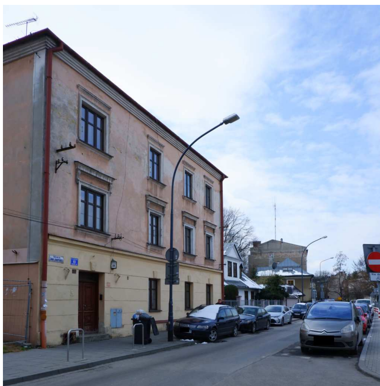
Fot. nr 67. Kamieniczka pod nr 10, wybudowany w połowie XIX wieku. (04.04.2022)
