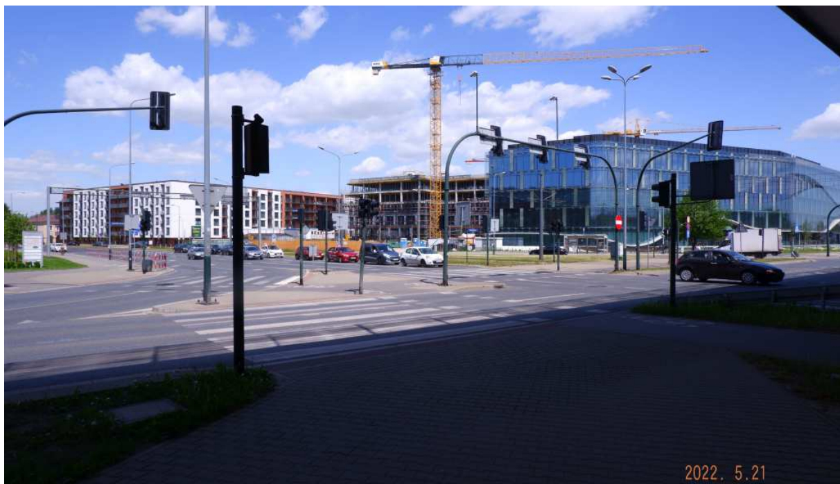
Fot. nr 306. Widok na styk ulic: Powstańców Wielkopolskich i Klimeckiego.
