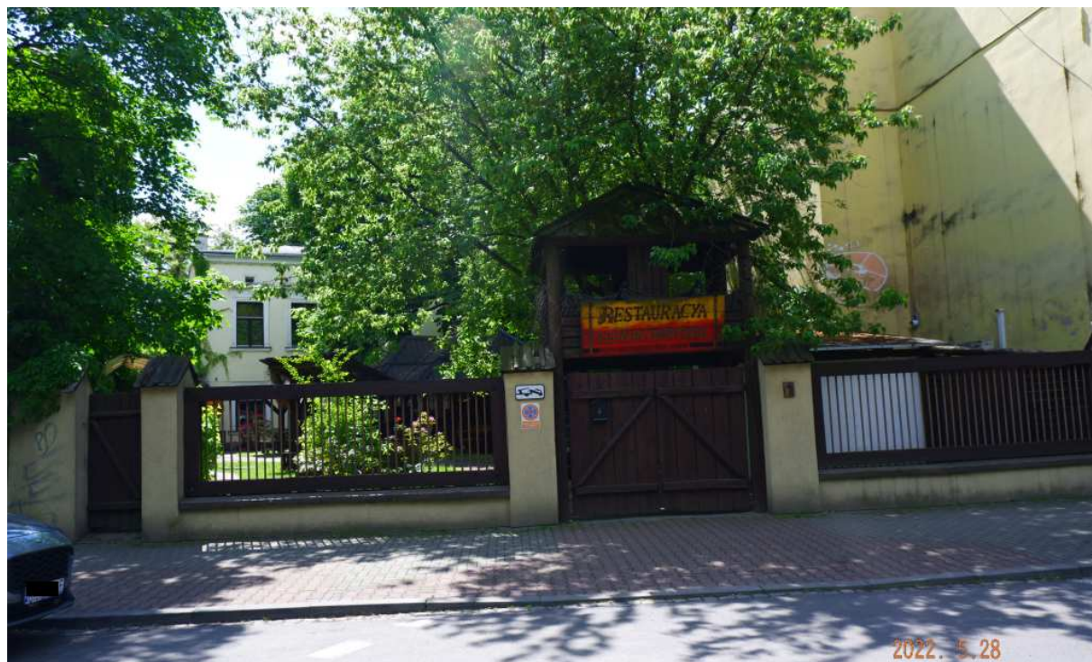
Fot. nr 183 (183-184). Dom spod nr 7, cofnięty w stosunku do ulicy w głębi ogrodu; układ typowy dla ostatniej ćwierci XIX wieku. (28.05.2022)
