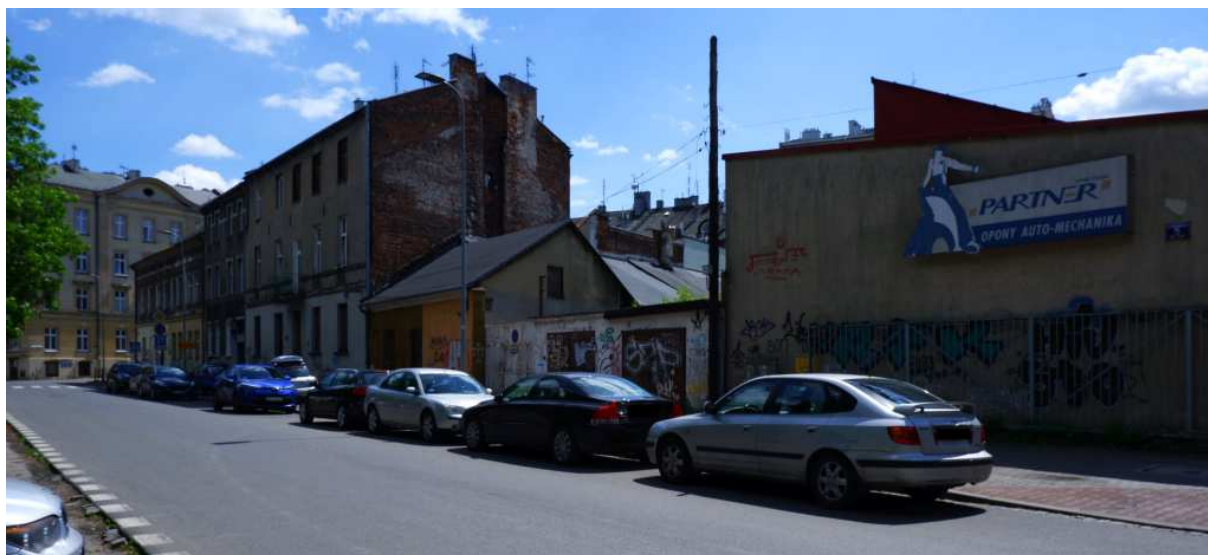
Fot. nr 180. Zabudowa poniżej posesji o numerze 5. (28.05.2022)
