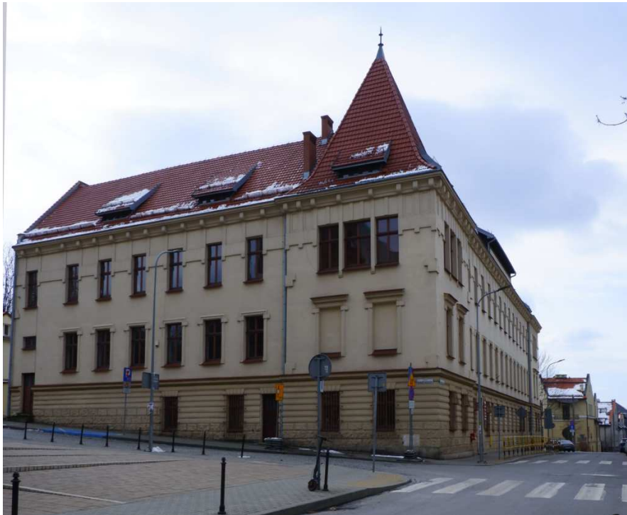
Fot. nr 130 (130-143). Szkoła Pielęgniarek pod nr 58-60, wybudowana ok. roku 1910. (04.04.2022)
