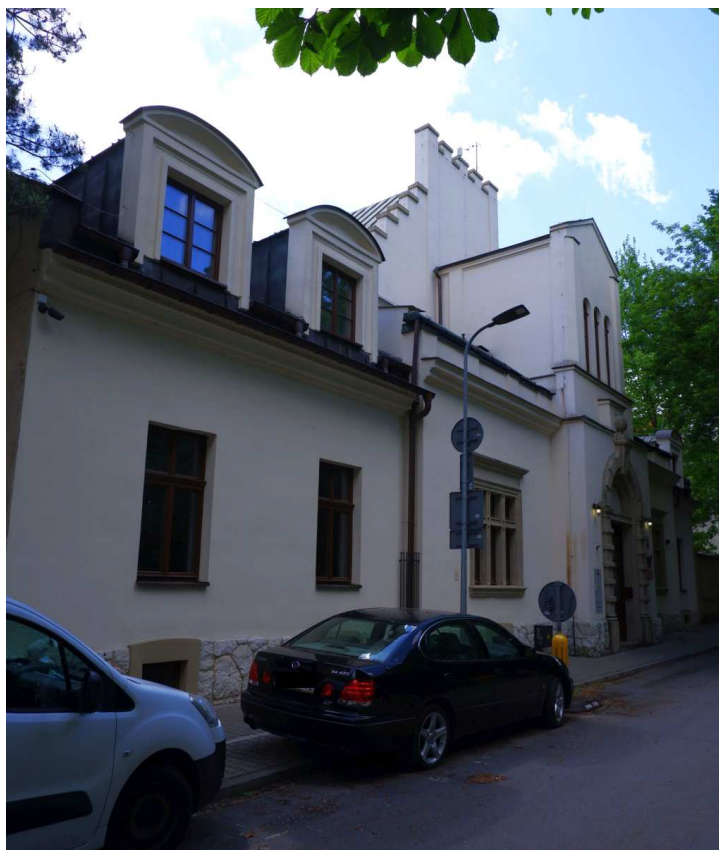
Fot. nr 170 (170-173). Budynek Sokoła Podgórskiego (TG Sokół) z ul. Sokolskiej 17, który został wybudowany w roku 1893 wg projektu Władysława Kryłowskiego. (28.05.2022)
