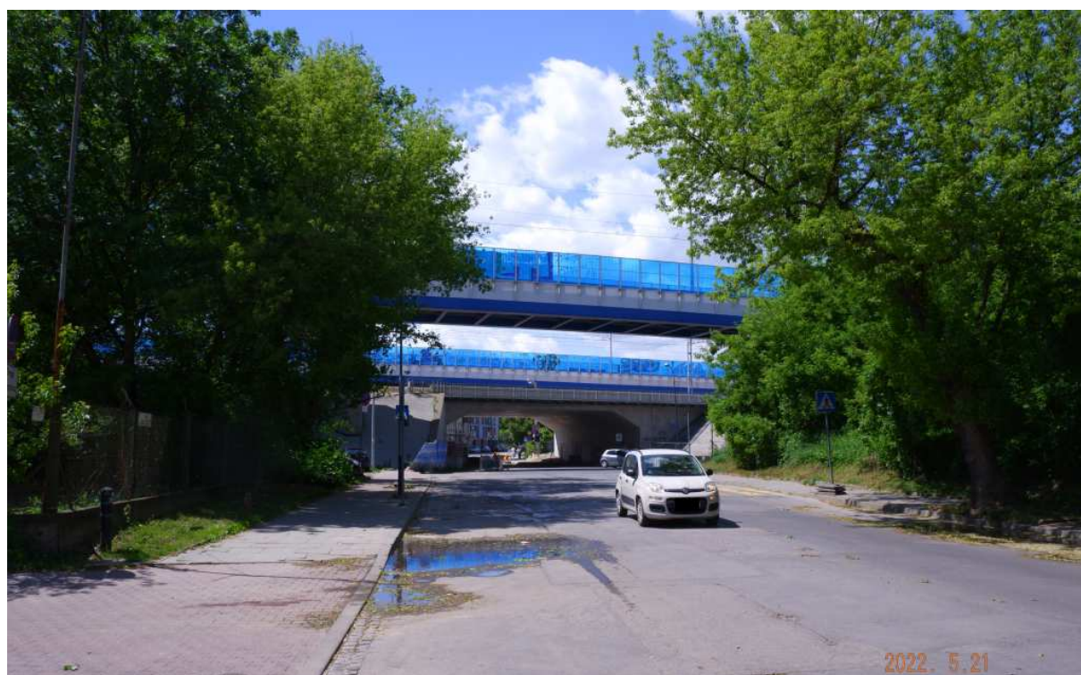
Fot. nr 280. Na pierwszym planie druga nitka łącznicy, a dalej wiadukt kolejowy z roku 1943.
