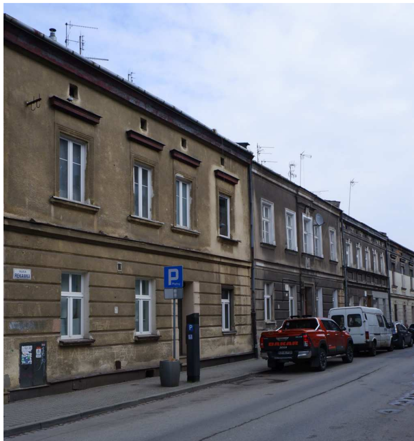
Fot. nr 44. Niska, jednopiętrowa zabudowa poniżej domu o nr 33. (04.04.2022)
