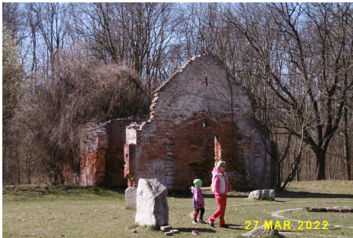
Fot. nr 313 (313-316). Ruina dawnej prochowni z czasów Twierdzy Kraków przy ulicy Swoszowickiej. (315-318).
