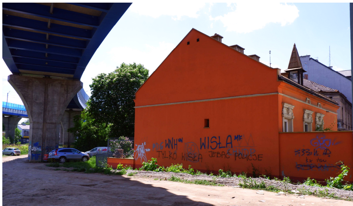
Fot. nr 267. Ujęcie spod łącznicy kolejowej. (21.05.2022)
