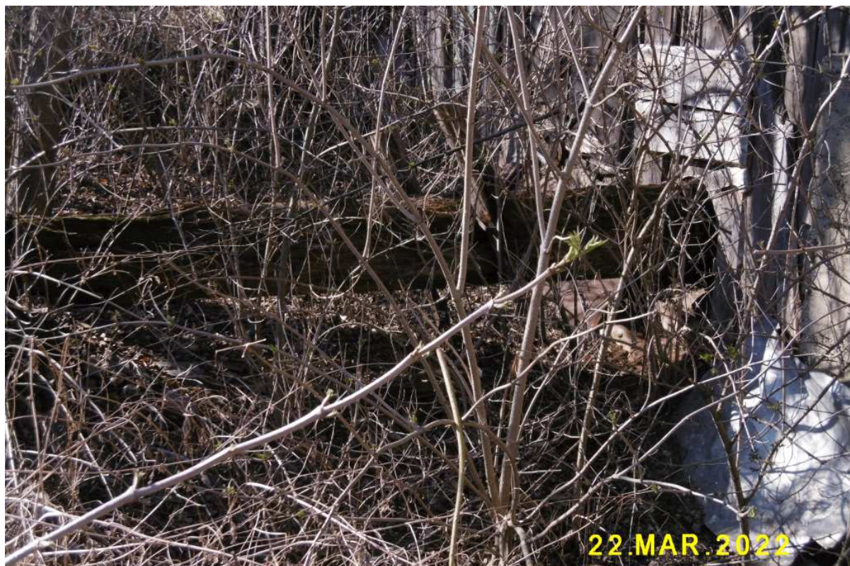
Fot. nr 365. Resztki koła napędowego pod mostkiem.
