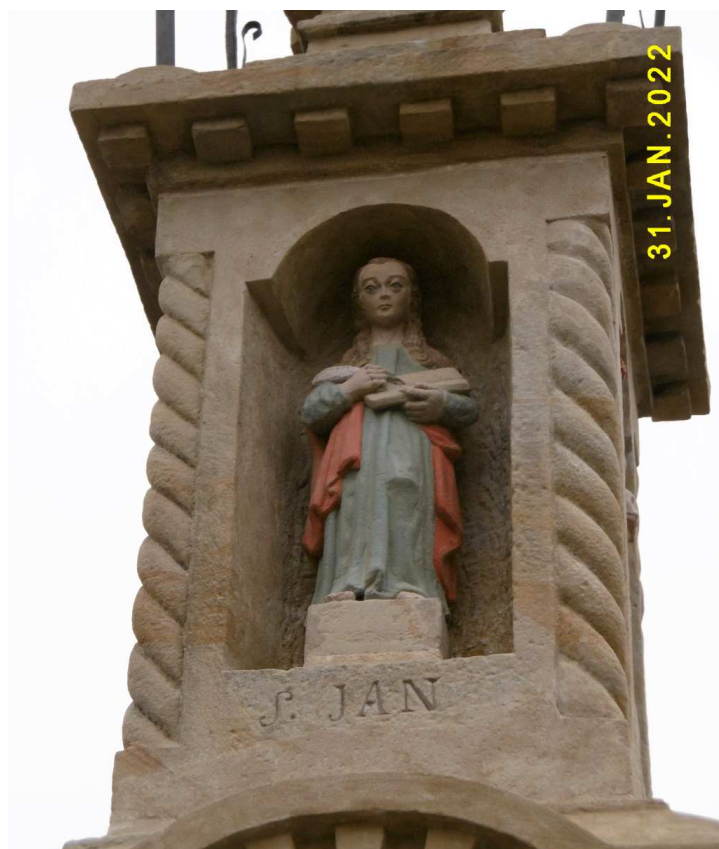
Fot. nr 62 (62-65). Figury lica. Święty Jan w górnej kondygnacji.
