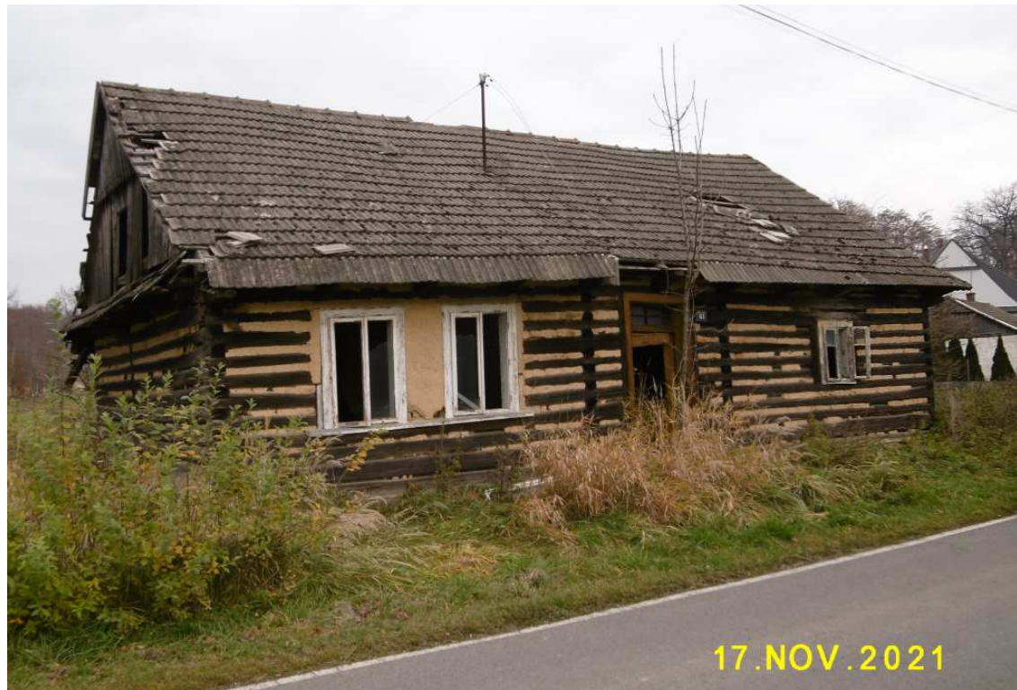
Fot. nr 139 (139-143). Ostatnie chwile chałupy pod nr 63, która mogła powstać na przełomie XIX i XX wieku.
