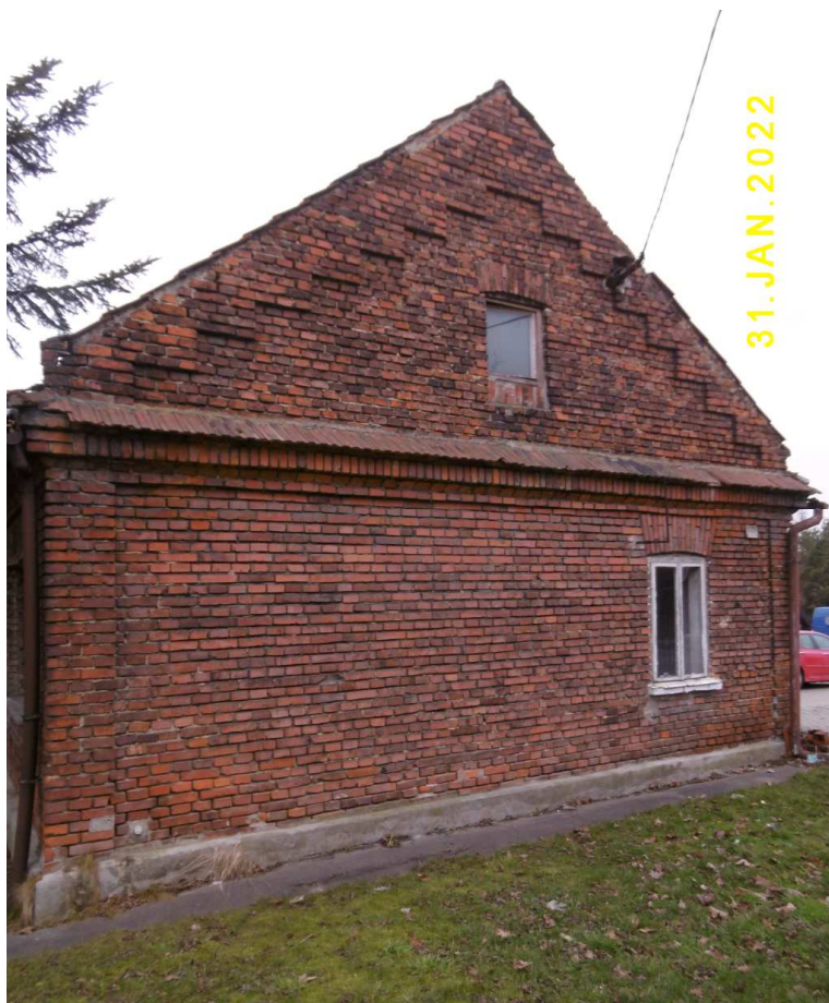
Fot. nr 15. Oryginalna ściana szczytowa.
