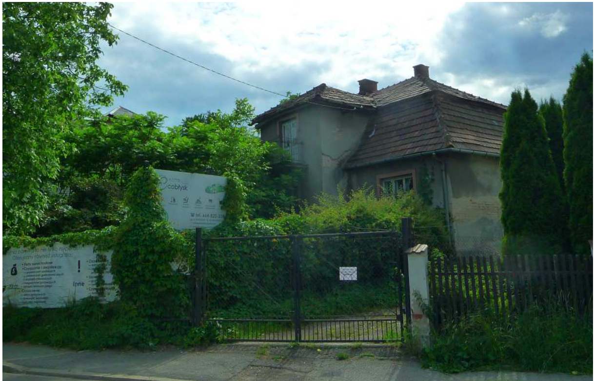
Fot. nr 20. Zapewne około 100-letni dom murowany z łamanym dachem przy ulicy Kościuszki 16. (14.06.2022)
