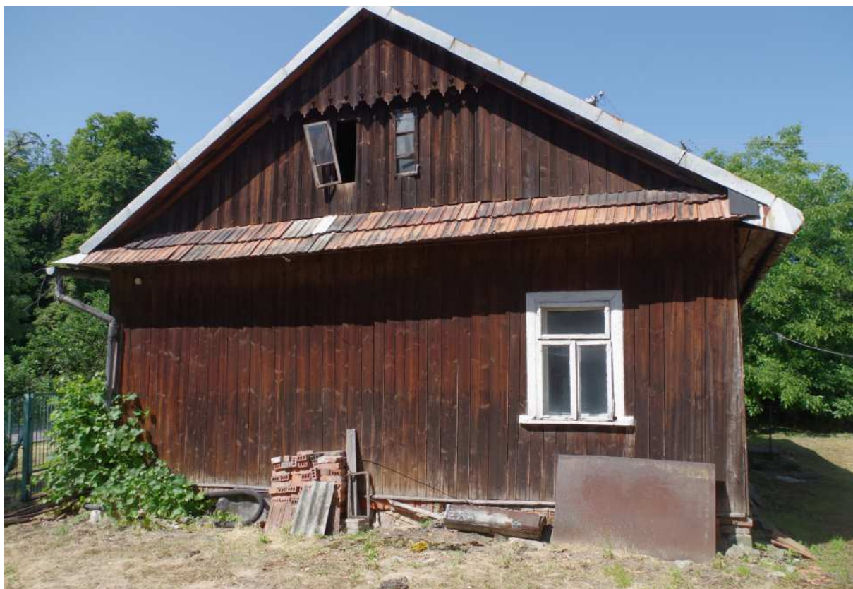
Fot. nr 110. Boczna ściana.
