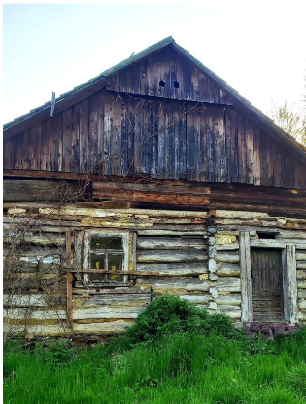
Fot. nr 392 (392-393). Boczna ściana szczytowa i jej detale.
