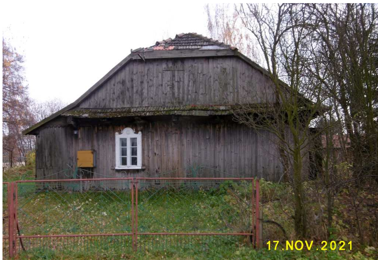
Fot. nr 182 (182-183). Ściana szczytowa z dachem siodełkowym.
