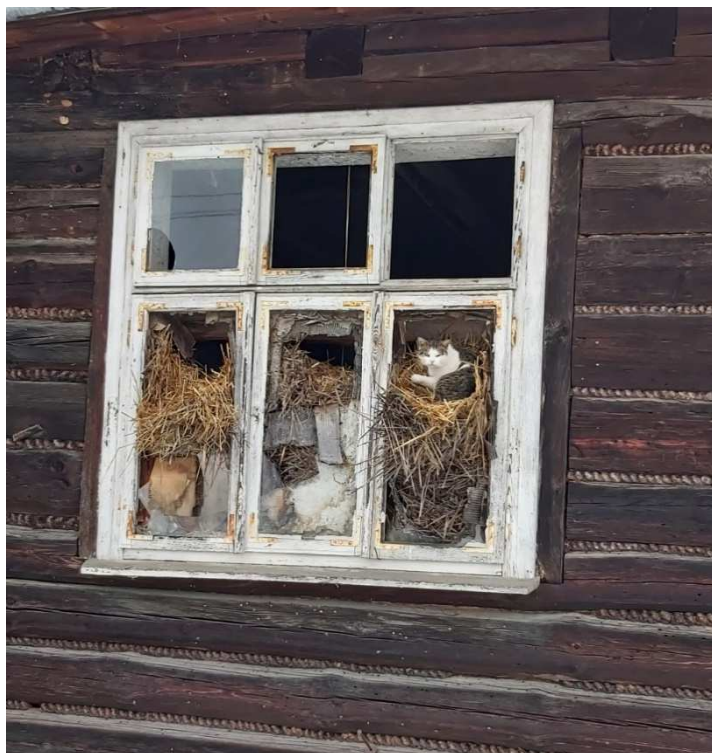
Fot. nr 133. Okno typu weneckiego i mieszkaniec domu.
