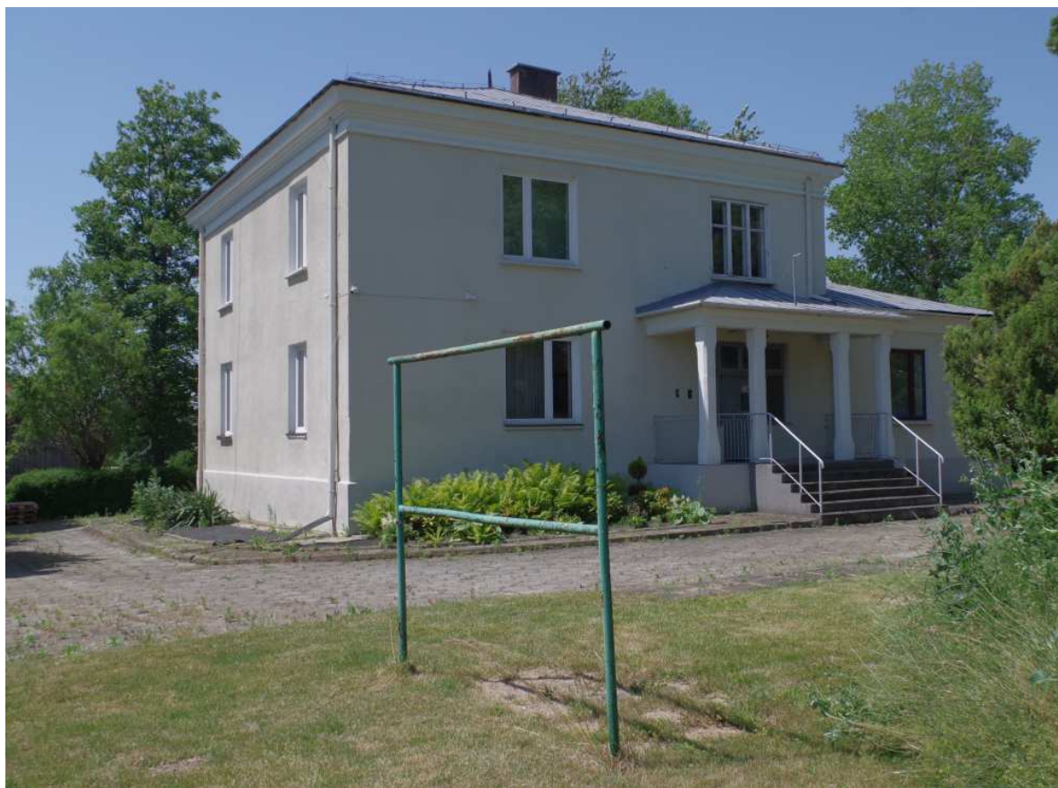
Fot. nr 425 (425-428). Mocno zniekształcony i częściowo przebudowany przedwojenny dwór Bukowskich, w którym po wojnie funkcjonowała szkoła, a potem były tam mieszkania dla nauczycieli.
