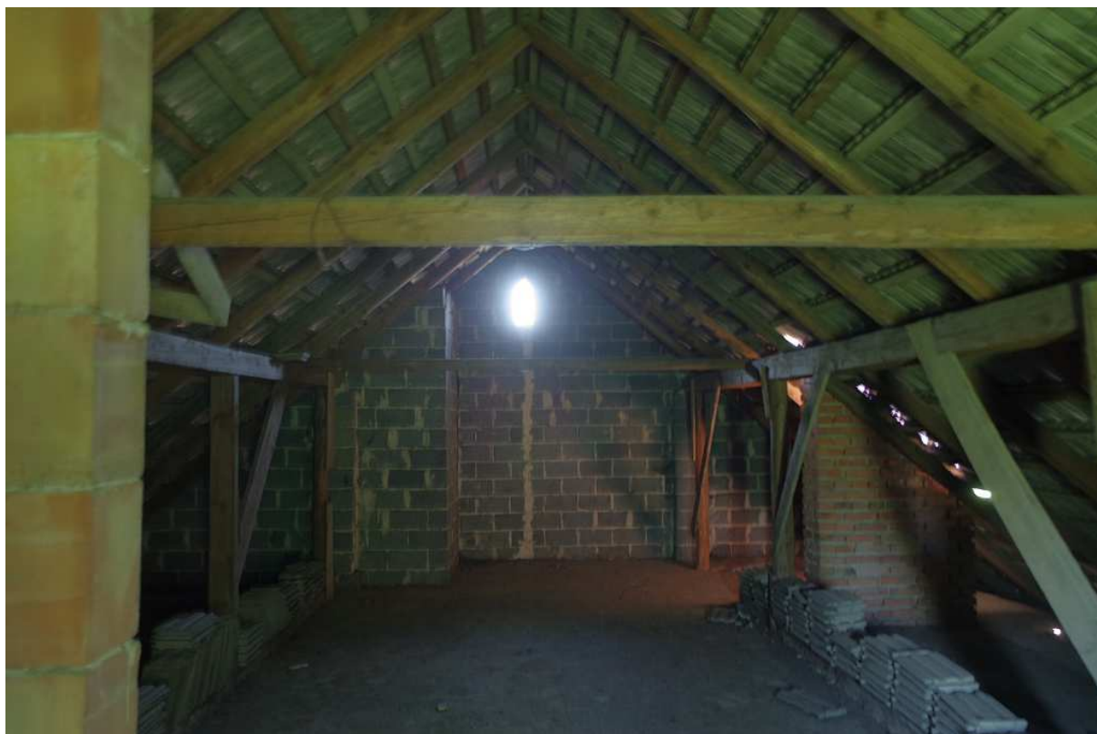
Fot. nr 120. Strych.
