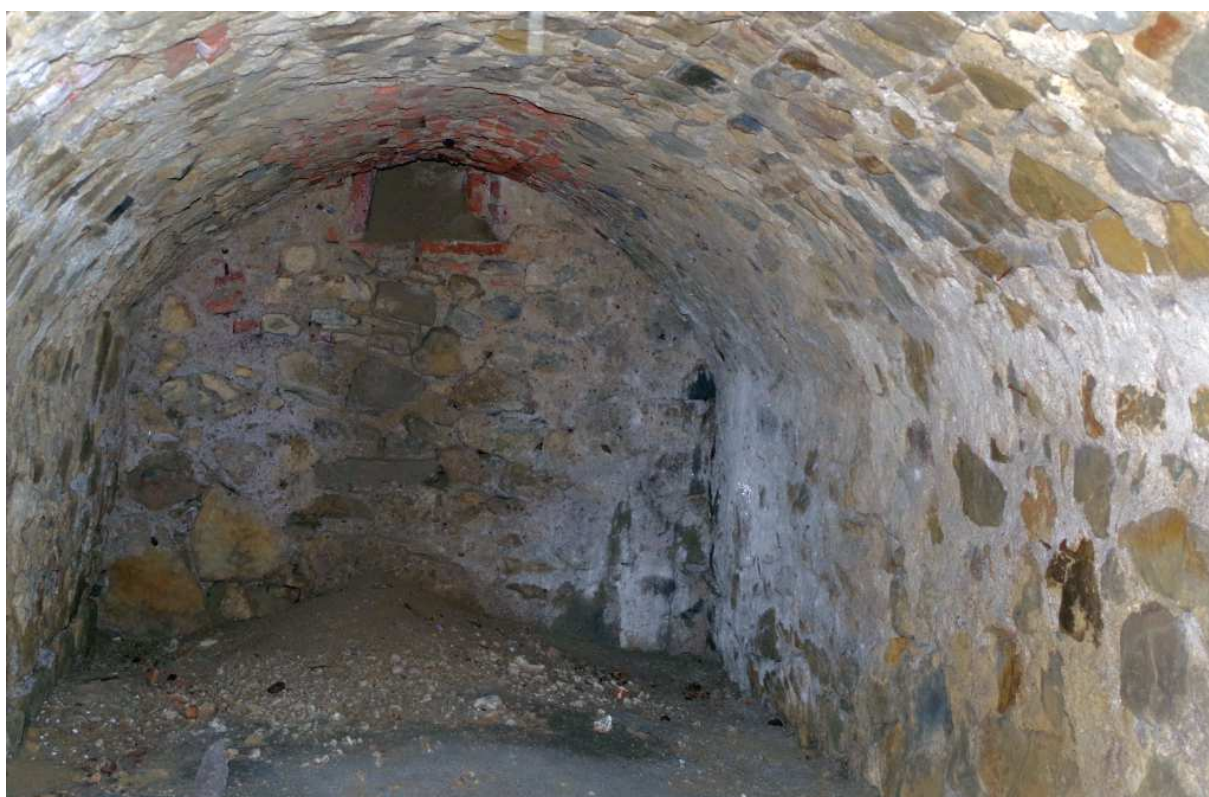
Fot. nr 121. Piwnica.
