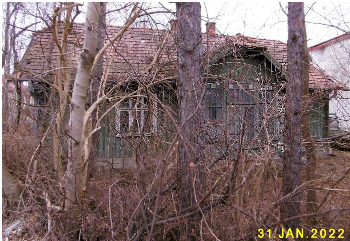
Fot. nr 80 (80-105). Wzdłuż ulicy Krzyszkowickiej. Fot. nr: 80-88. Pokryty drewnianym szalunkiem dom spod nr 8, wybudowany zapewne na przełomie lat 20/30 XX wieku, którego już nie ma.
