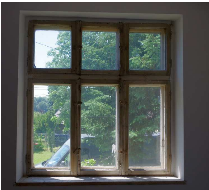
Fot. nr 429 (429-430). Jedyne oryginalne okno typu weneckiego.
