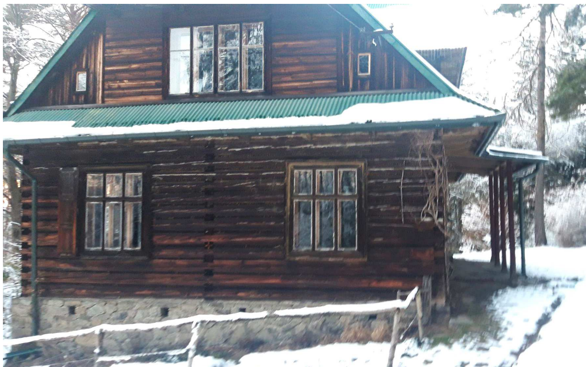
Fot. nr 421. Ściana szczytowa i jej detale. Obiekt znajduje się na zboczu góry Lubogoszcz. Posiada konstrukcję zrębową.
