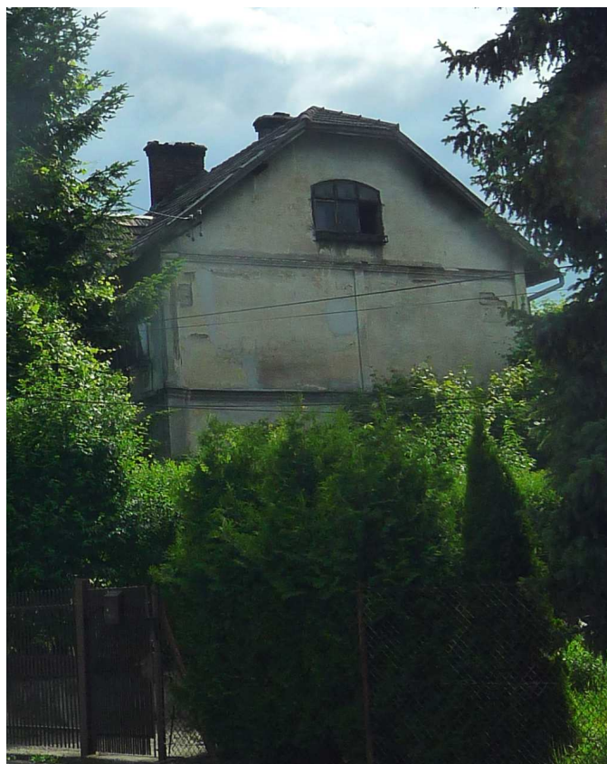
Fot. nr 23. Boczna ściana szczytowa. (14.06.2022)
