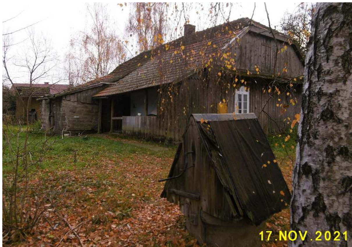
Fot. nr 180. Fragment domu od strony podwórka.
