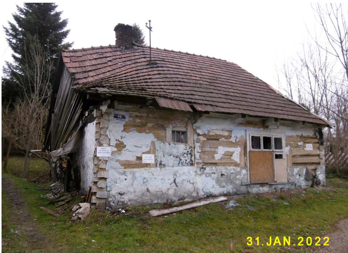
Fot. nr 95 (94-96). Fasada zapewne półtoratraktowej chałupy i jej detale.
