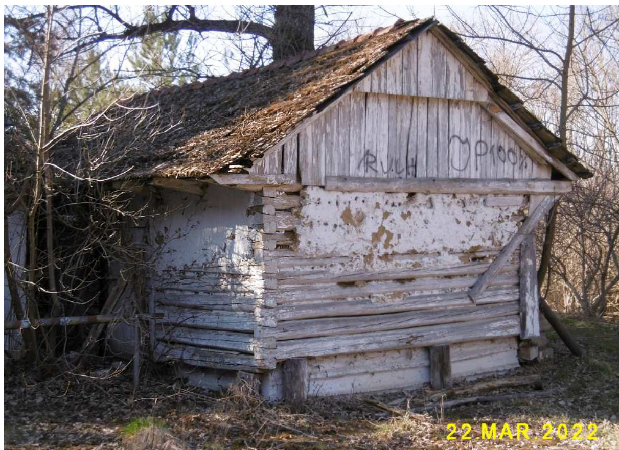
Fot. nr 359 (359-360). Przybudówka przylegająca do domu, zapewne dawna stajnia.
