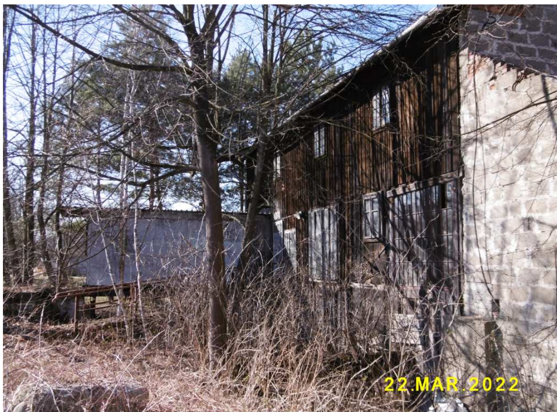
Fot. nr 362 (362-368). Młyn Rudolfa Wojasa w ujęciu od strony drogi dojazdowej i jego zachowane detale. Jako obiekt wodny, zasilany młynówką z Raby, działał do roku 1963.
