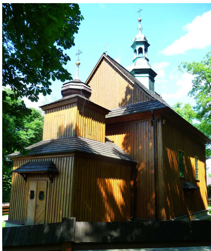
Fot. nr 37 (37-38). Widoki od strony zachodniej. (30.05.2022)
