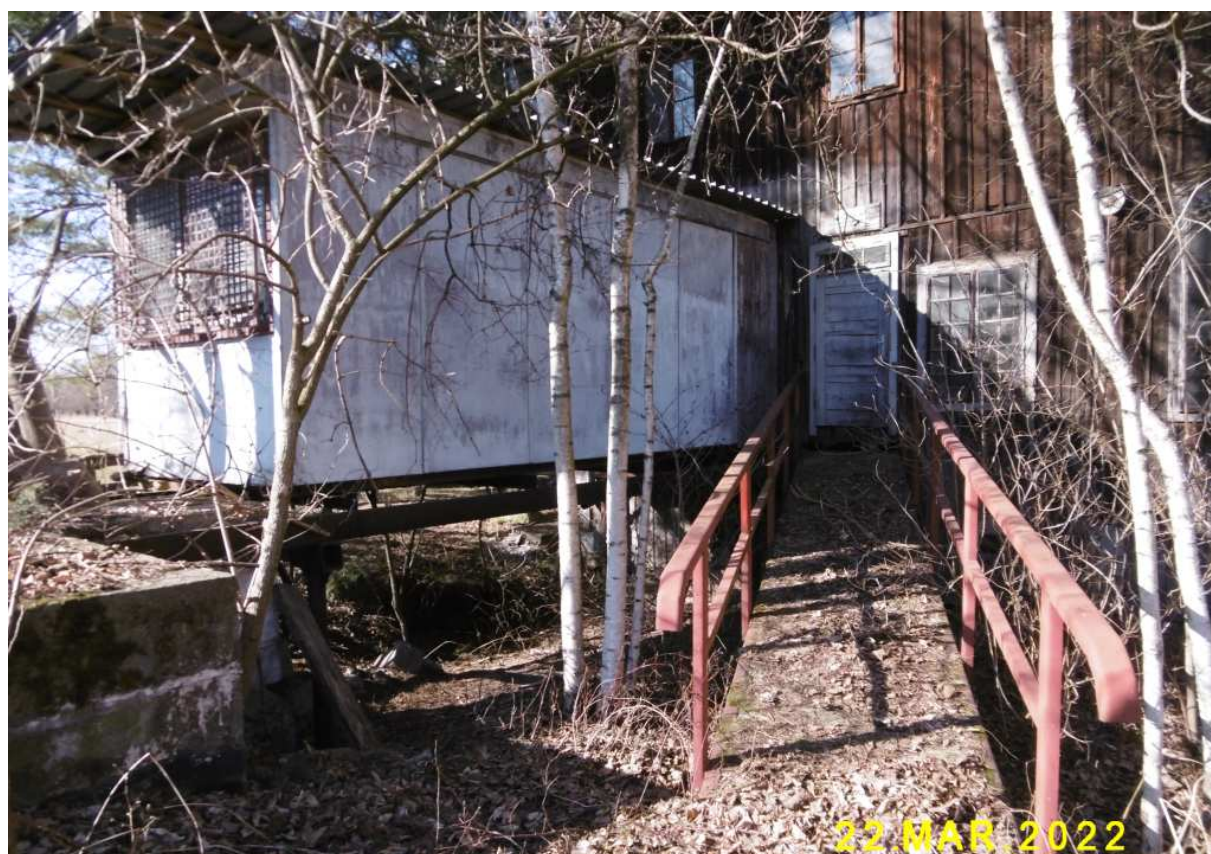
Fot. nr 364. Mostek w miejscu dawnego jazu.
