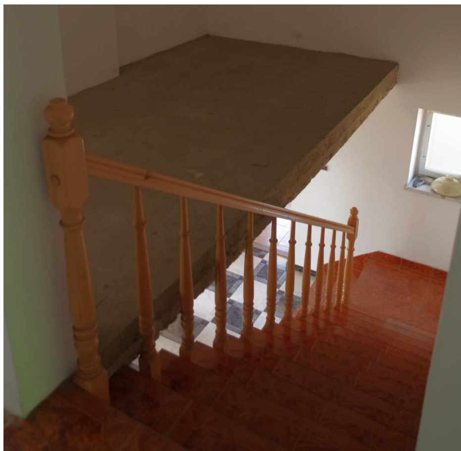
Fot. nr 119. Schody rowadzace na strych.
