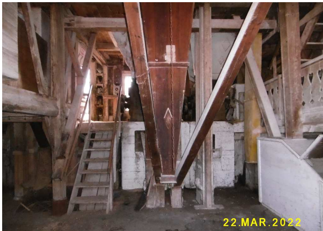
Fot. nr 352 (352-354). We wnętrzu obiektu, który od roku 1963 działał już jako elektryczny.
