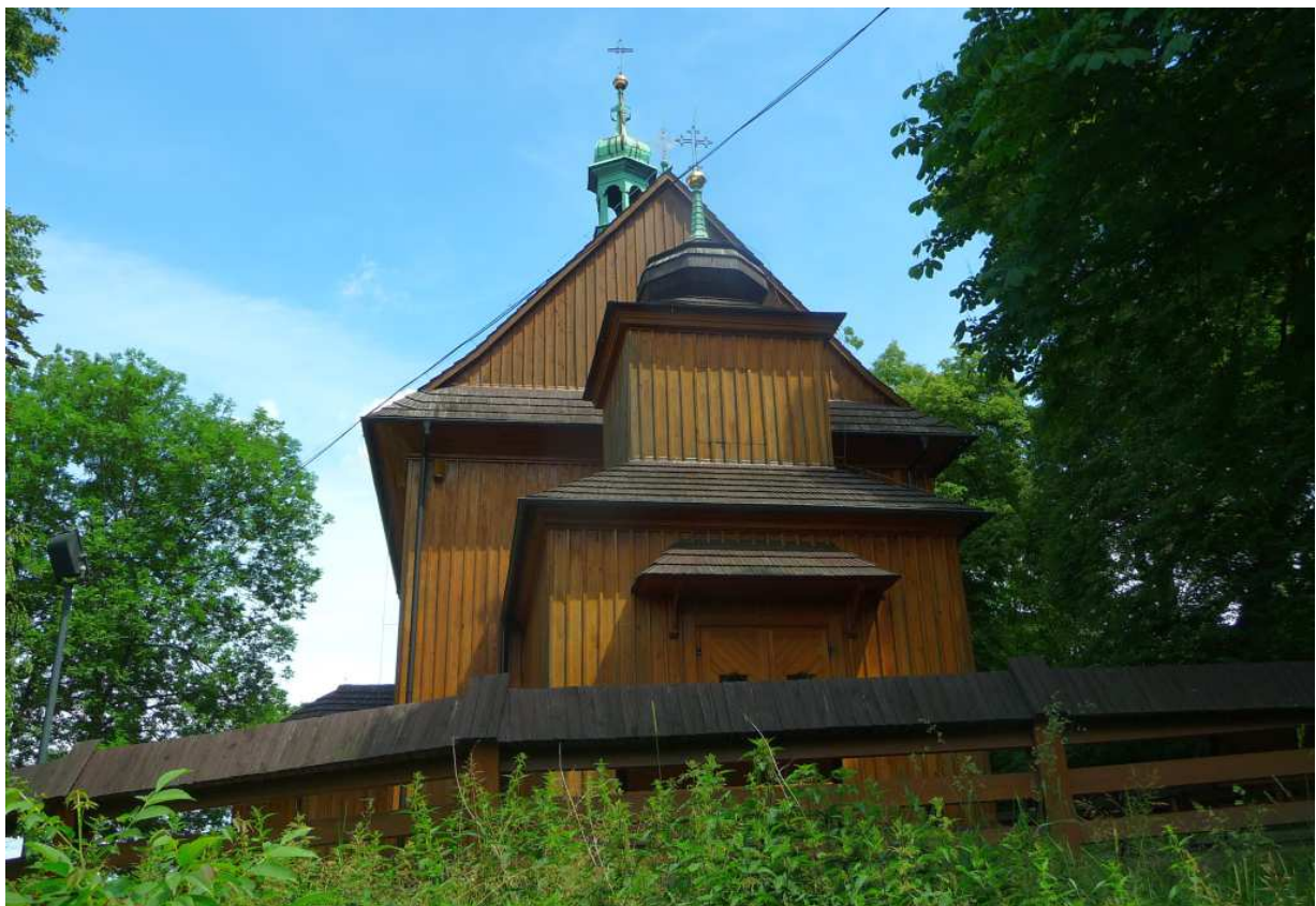
Fot. nr 33 (33-46). Kilkanaście ujęć kościoła św. Sebastiana. Ta zabytkowa, drewniana świątynia o konstrukcji zrębowej, na zewnątrz oszalowana, była konsekrowana w roku 1598, ale jej bryła została przebudowana w XVII i XVIII wieku. W barokowo wyposażonym wnętrzu znajdują się polichromie Włodzimierza Tetmajera z początku XX wieku. (14.06.2022)
