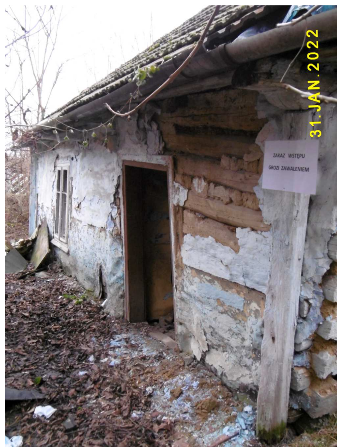
Fot. nr 97 (97-100). Widoki na tylną część z oryginalnym oknem typu ościeżnicowego
