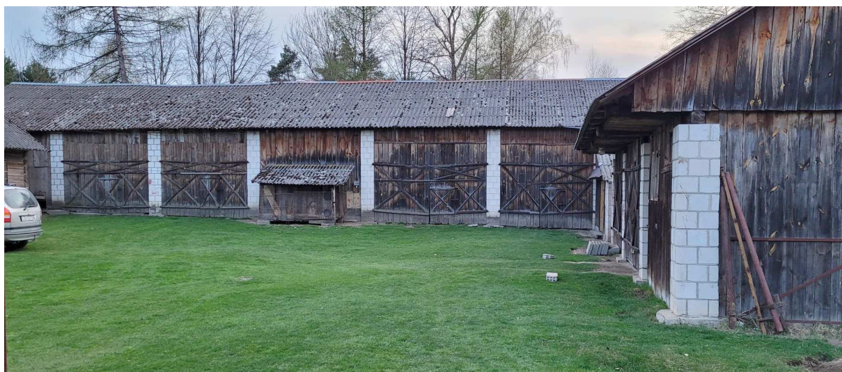
Fot. nr 450 (449-450). Ogrodzona zagroda z domem, pomieszczeniami inwentarskimi i stodołą.
