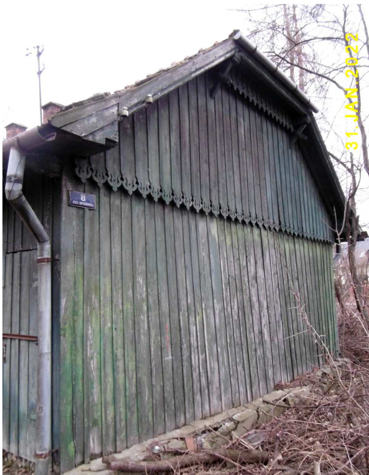
Fot. nr 84. Boczna ściana od strony ulicy.
