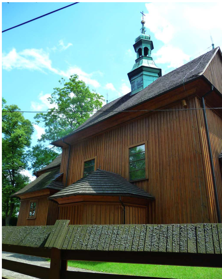
Fot. nr 43 (43-44). Lewy, północny bok nawy i boczne wejście do kościoła. Na wysokości prezbiterium znajduje się zakrystia. (30.05.2022)
