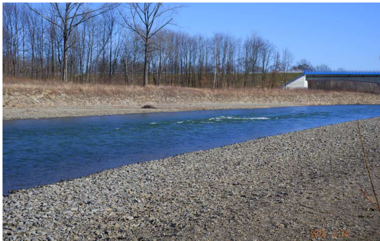
Fot. nr 224 (224-225). W stronę mostu na obwodnicy Gdowa.
