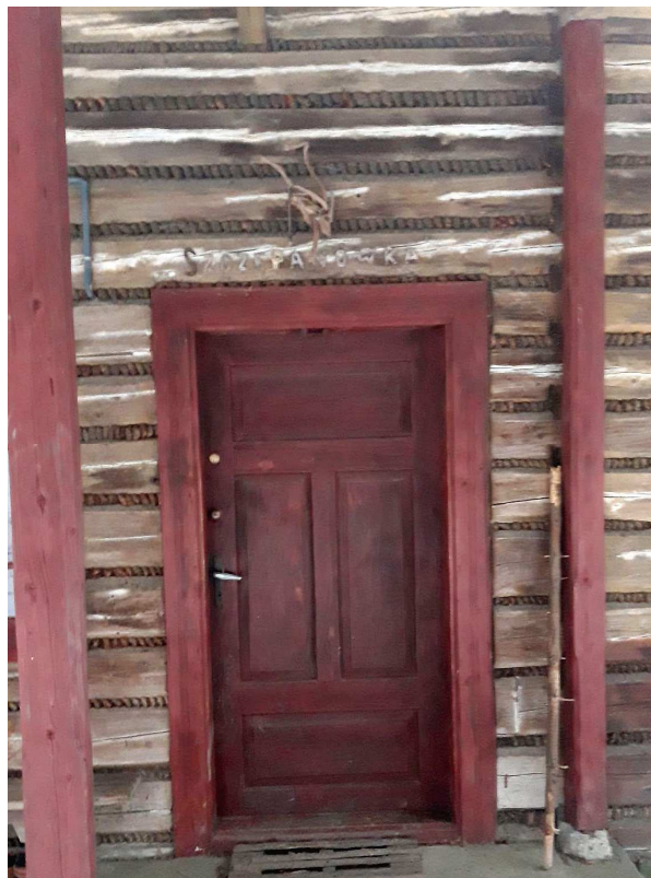
Fot. nr 420. Belki uszczelnianie warkoczem ze słomy.
