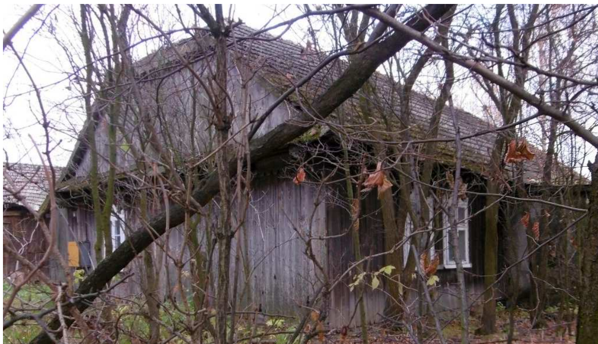
Fot. nr 184 (184-185). Próby uchwycenia fasady domu od strony ogrodu.
