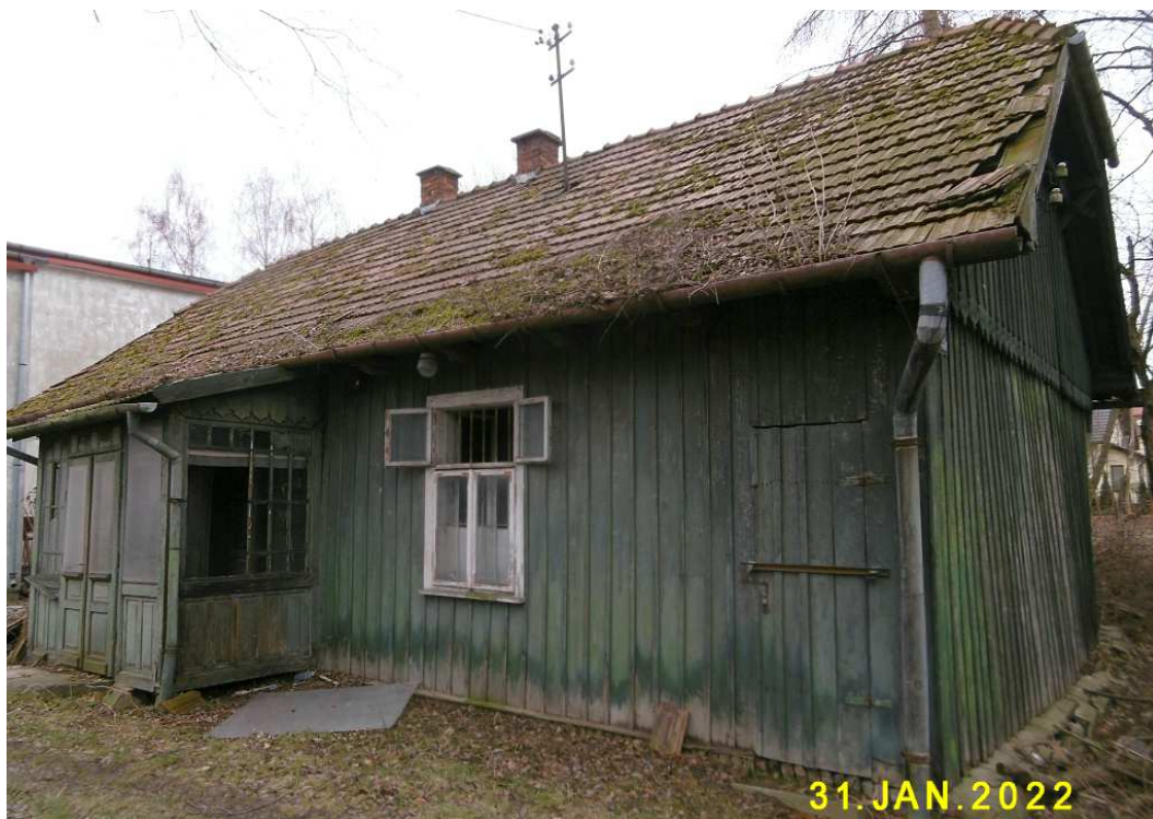
Fot. nr 85 (85-87). Widoki od strony podwórka.
