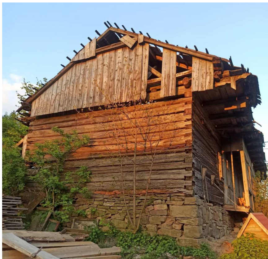
Fot. nr 402. Boczna ściana.
