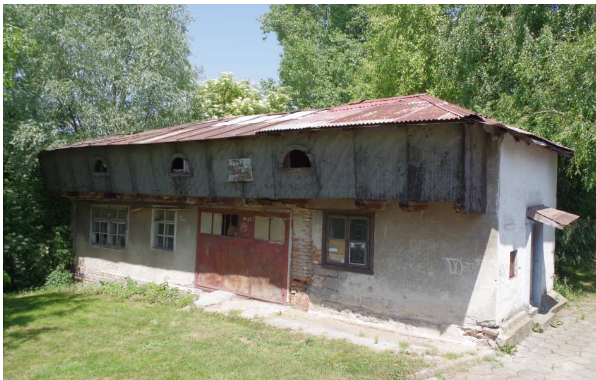
Fot. nr 432 (432-436). Zapewne dawna stajnia i pomieszczenia gospodarcze.
