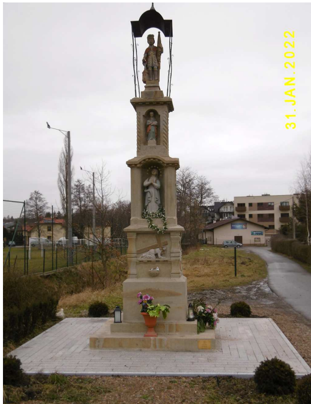
Fot. nr 60 (60-78). Kapliczka z naroża ulic: Sadowej i Krzyszkowickiej – stan po renowacji z roku 2021, którą można stawiać za wzór.
