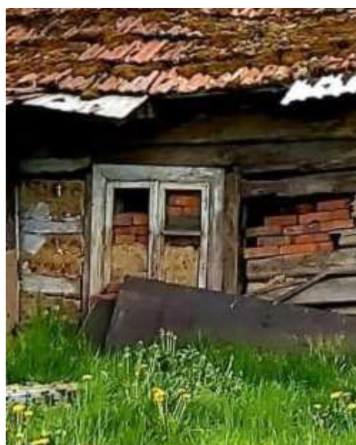
Fot. nr 398. Archaiczne okienka.
