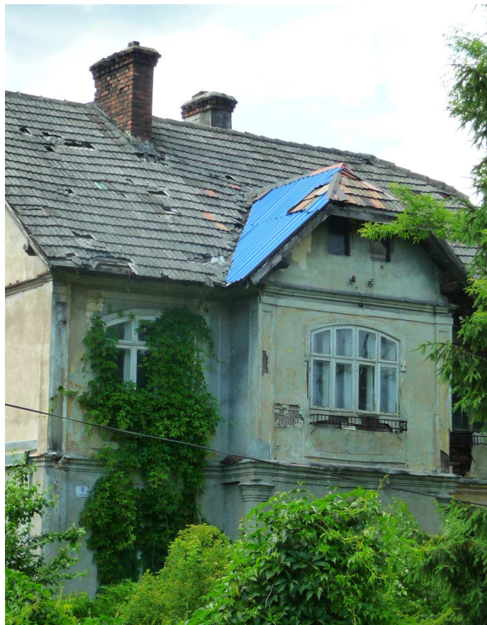
Fot. nr 22. Ryzalit z oryginalnym oknem. (14.06.2022)
