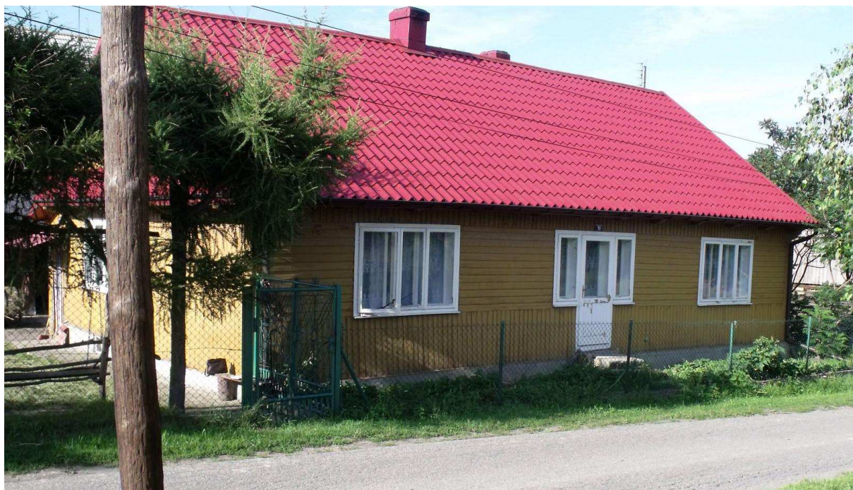
Fot. nr 134 (134-135). Rodzinny dom Franciszka Kalety „We Wsi” pod nr 19. Można przypuszczać, że w miejscu środkowego okna znajdował się kiedyś ganek. (31.07.2012)
