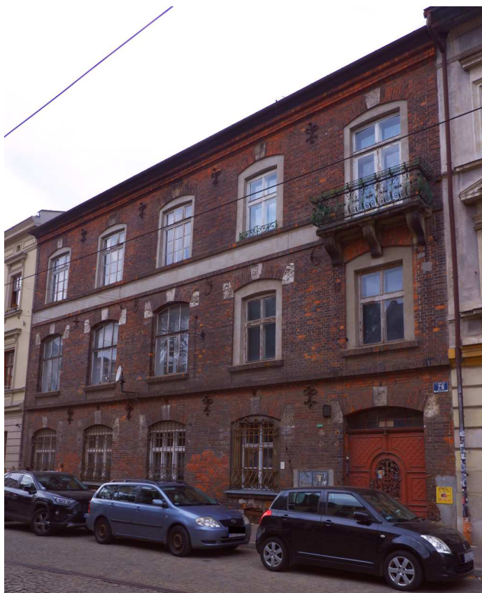
Fot. nr 88 (88-91). Kamienica przy ulicy św. Wawrzyńca 28 i jej detale. (02.07.2022)
