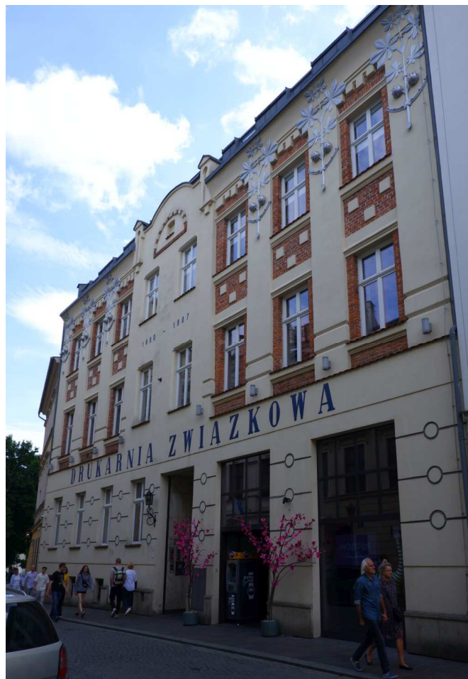
Fot. nr 5 (5-6). Budynek dawnej Drukarni Związkowej pod nr: 13-15. (09.07.2022)
