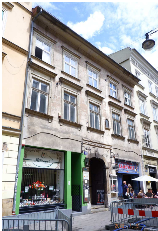
Fot. nr 44 (44-46). Kamienica pod nr 23 i jej detale. (09.07.2022)
