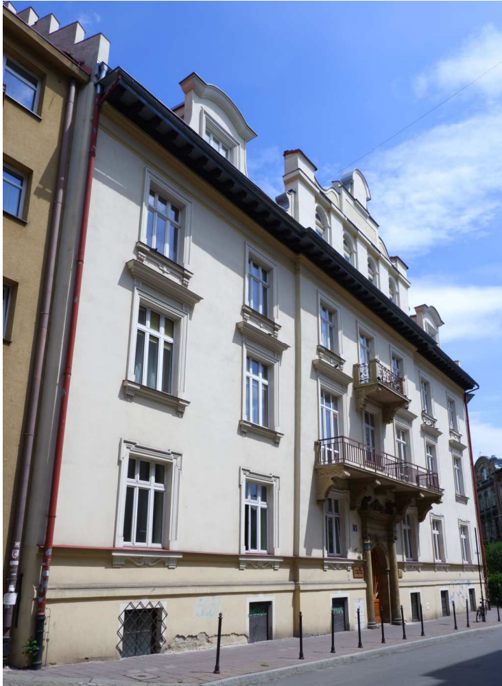
Fot. nr 59 (59-61). Neorenesansowa kamienica pod nr 8. (09.07.2022)
