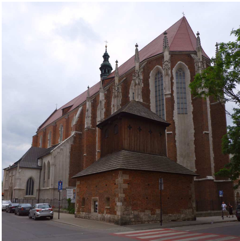
Fot. nr 138 (138-139). Kościół św. Katarzyny i przylegająca do niego dzwonnica. (02.07.2022)
