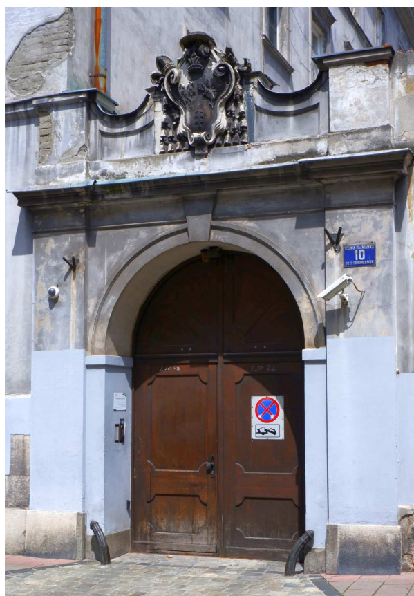
Fot. nr 35. Portal przy bramie wjazdowej na dziedziniec klasztoru Marków pod nr 10. (09.07.2022)
