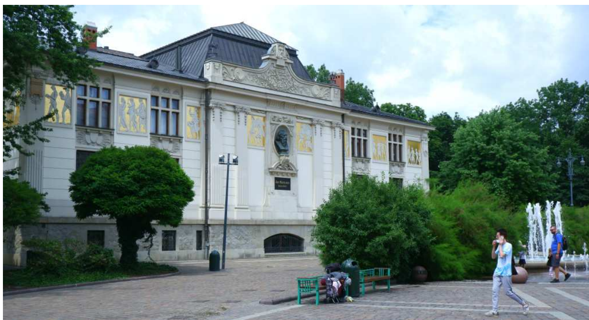
Fot. nr 38. Fasada od strony placu Szczepańskiego. (09.07.2022)
