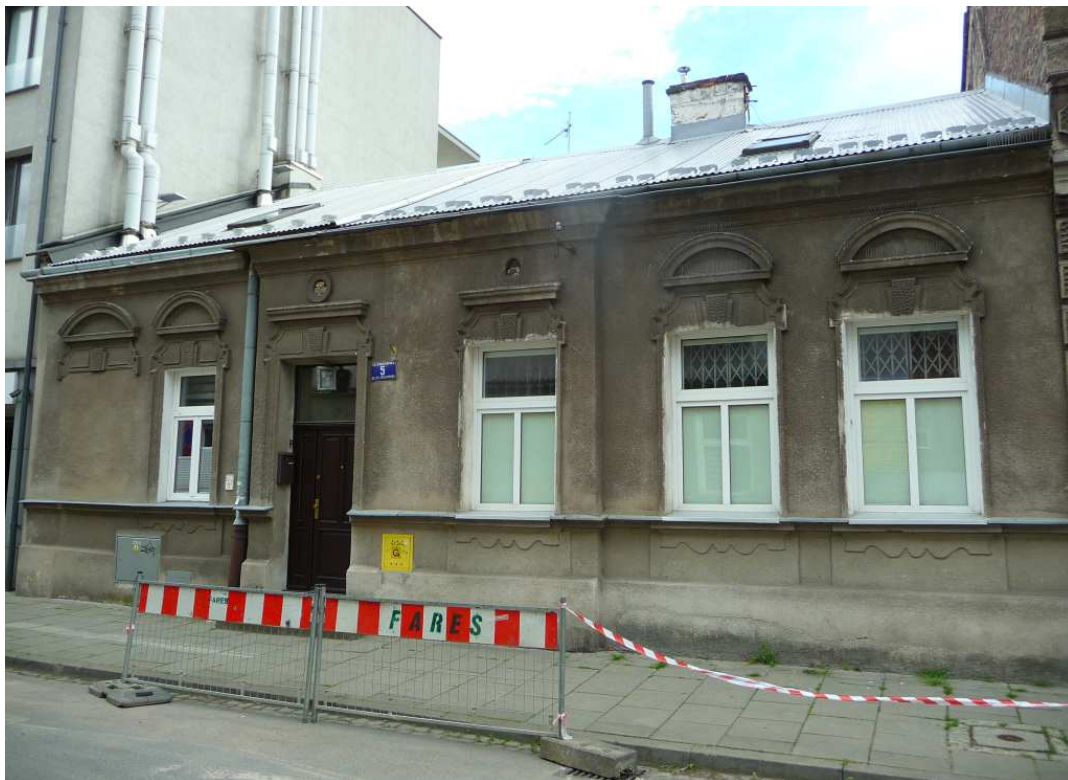
Fot. nr 73. Parterowy dom pod nr 5. (11.07.2022)
