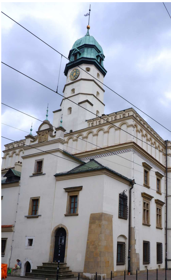
Fot. nr 131. Widok na odtworzony w oryginalnym kształcie fragment. (02.07.2022)
