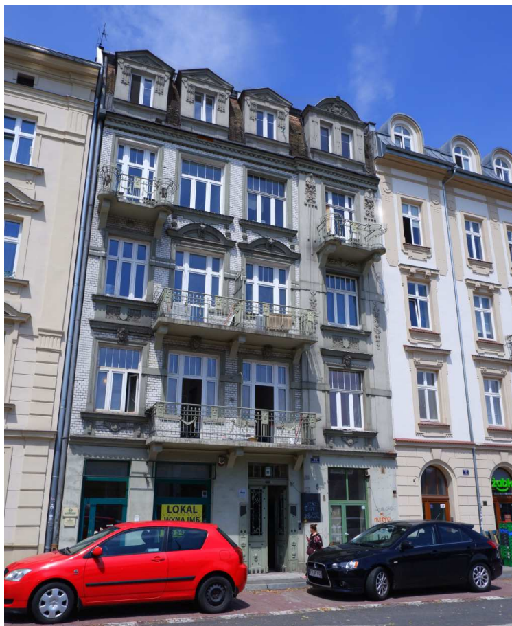
Fot. nr 66 (66-67). Nosząca już znamiona secesji kamienica z Wielopola 30. (09.07.2022)
