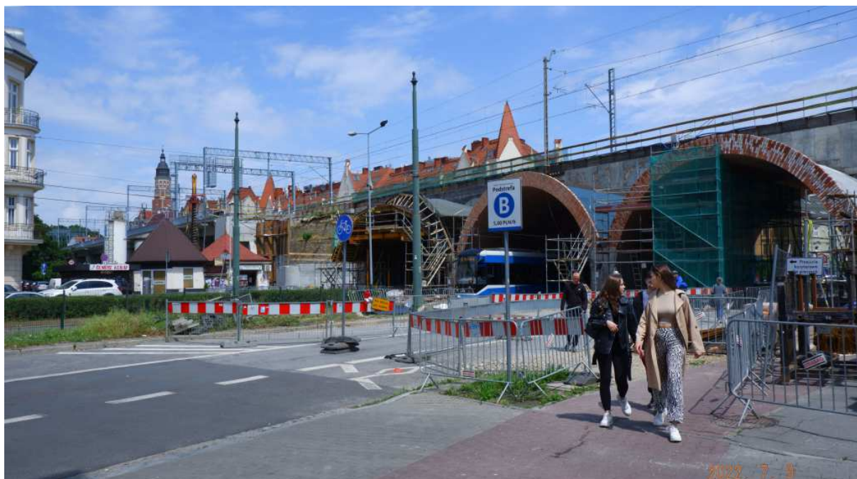
Fot. nr 69 (69-70). Tak nad ulicą Grzegórzecką powstaje „nowy zabytek”.
