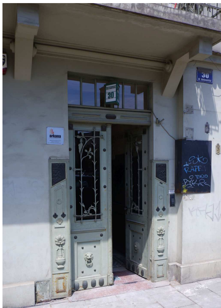
Fot. nr 68. Portal kamienicy powstałej wg projektu Aleksandra Biborskiego. (09.07.2022)
