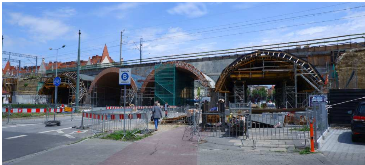
Fot. nr 81 (81-82). Zabytkowy do niedawna wiadukt, powstały nad korytem starej Wisły w roku 1863, dziś już tylko „nowy zabytek”. (09.07.2022)
