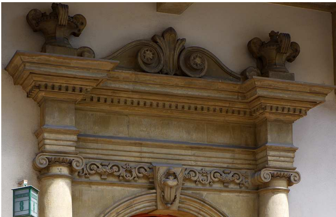
Fot. nr 60. Portal kamienicy powstałej wg proj. Józefa Pakiesa i jego detale. (09.07.2022)
