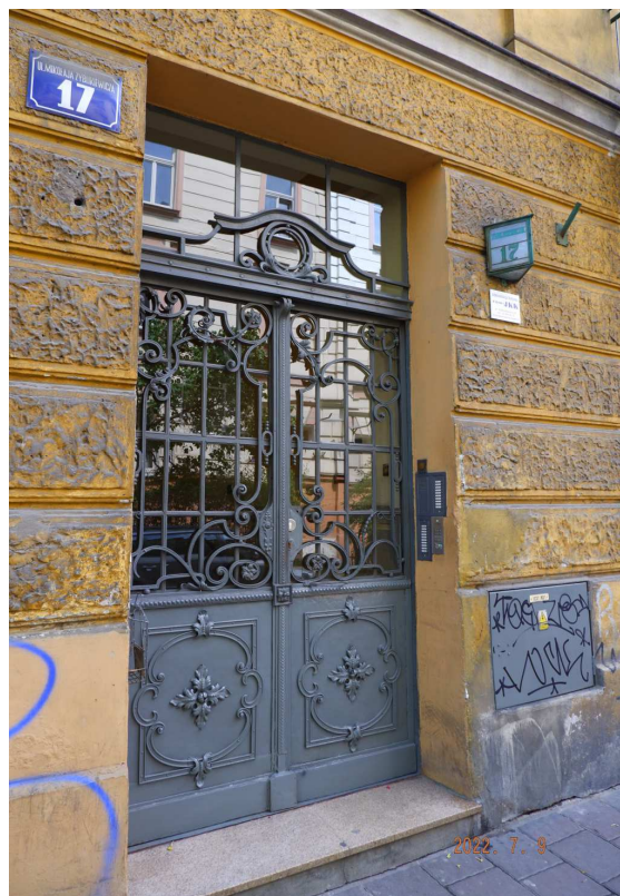
Fot. nr 62. Profilowane w metalu secesyjne drzwi kamienicy pod nr 17.
