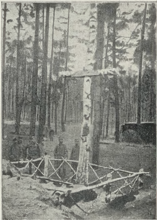
Grób śp. Szumskiego pod Koszyszczami.
