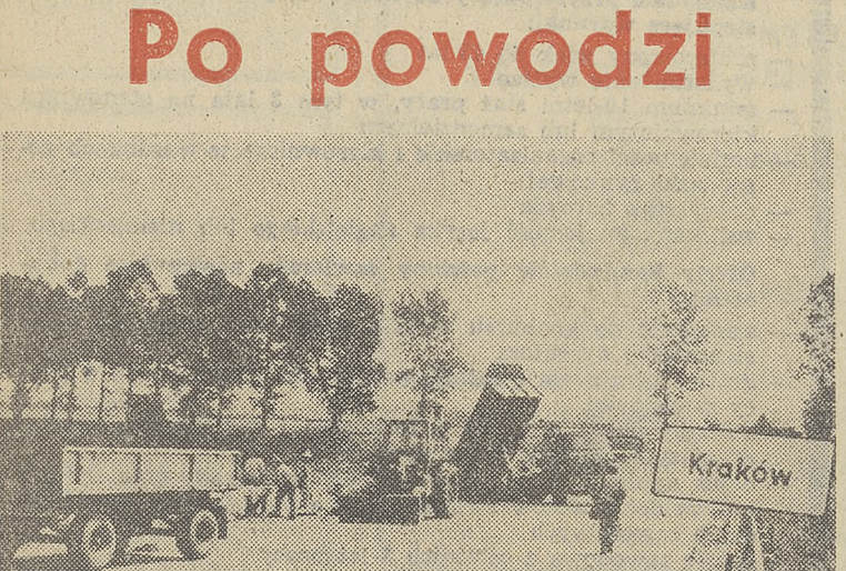
Trwają prace przy umocnieniu podmytej przez Wisłę drogi na Białanach.
