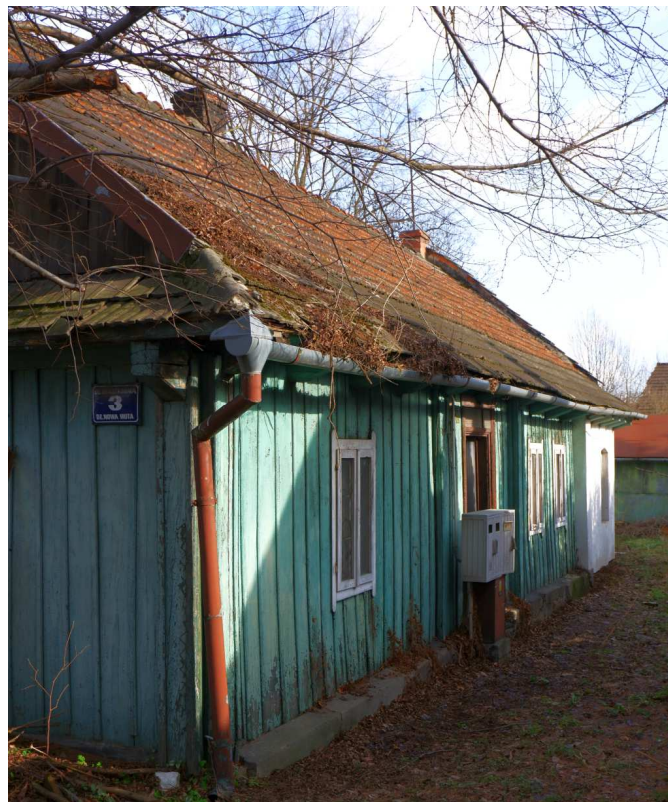
Fot. nr 330. Bliska oryginałowi fasada.
