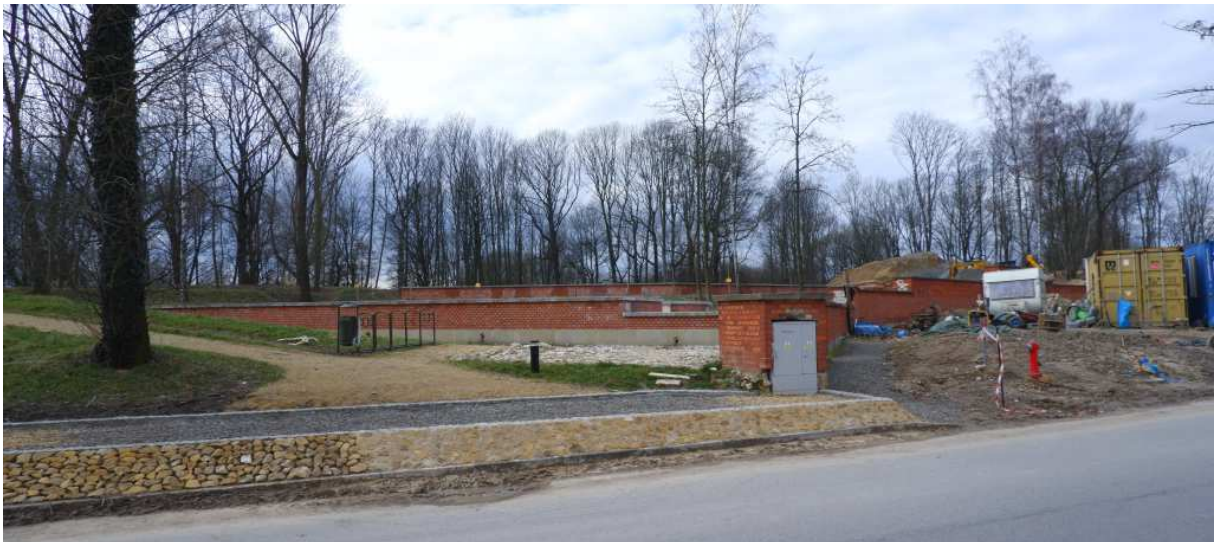
Fot. nr 248 (248-255). Wzdłuż częściowo rekonstruowanej zachodniej części fortu. (26.02.2024)
