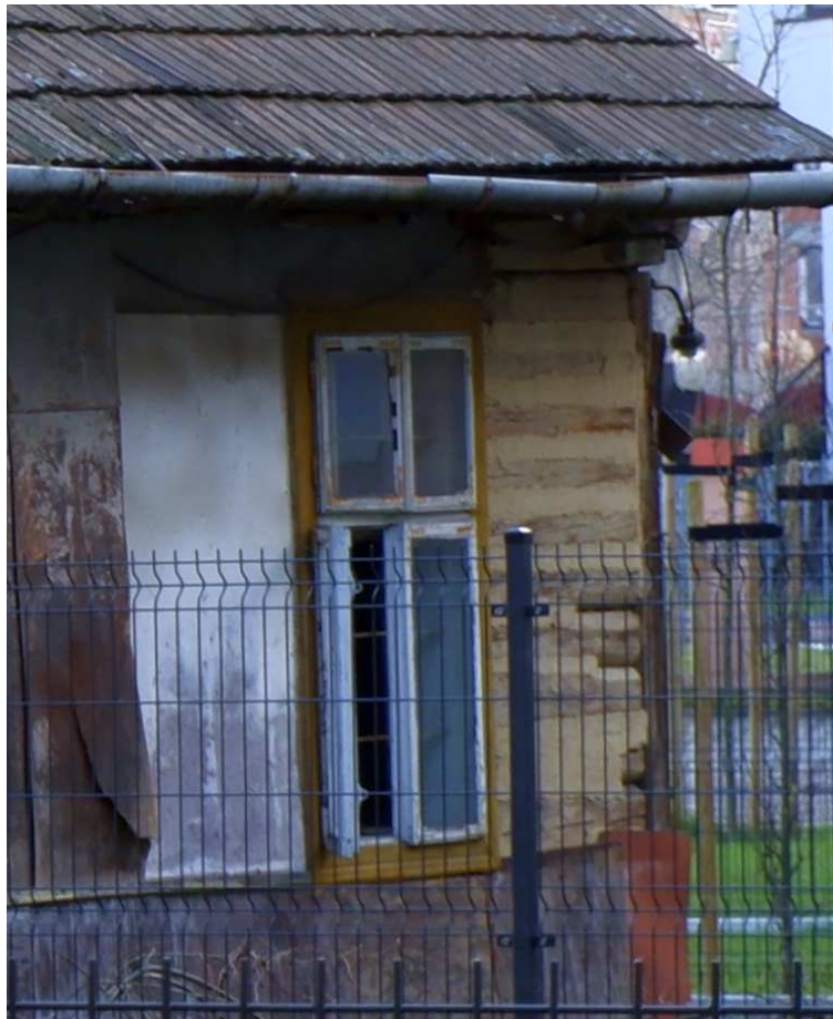
Fot. nr 324. Dawne okno i fragment drewnianej faktury. (02.02.2024)
