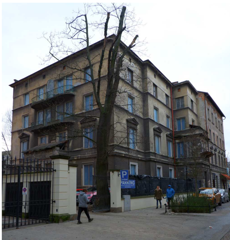
Fot. nr 160. Kamienica pod nr 18, która od lat pogrąża się w ruinie. (17.12.2023)
