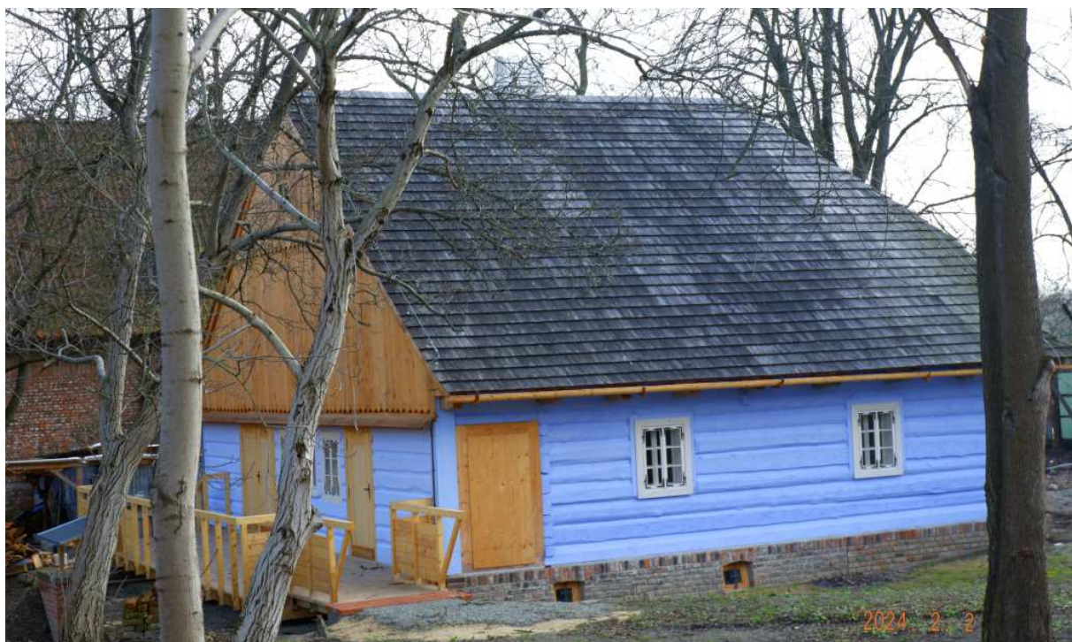
Fot. nr 359 (359-366). Pięknie odrestaurowana ponad 150-letnia chałupa młynarza Pędrackiego przy ulicy Klasztornej 11A, w narożu z ulicą Żaglową
