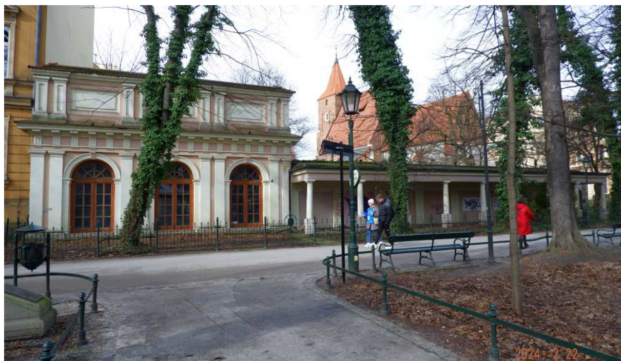
Fot. nr 66. Dawna restauracja-kawiarnia Zakopane, obecnie pusta.
