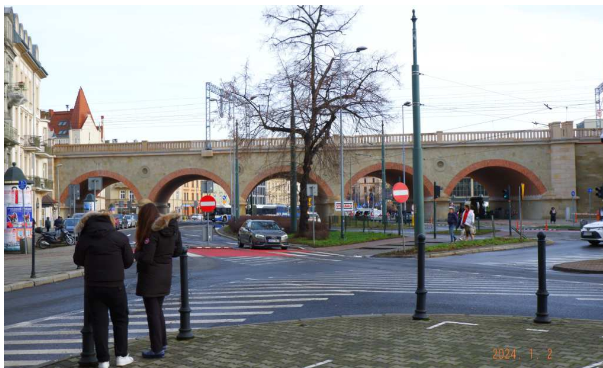
Fot. nr 312. Nowy zabytek, wybudowany od nowa i rozbudowany w stosunku do oryginalnej wersji wiadukt kolejowy nad ulicą Grzegórzecką; oryginał powstał w roku 1863.
