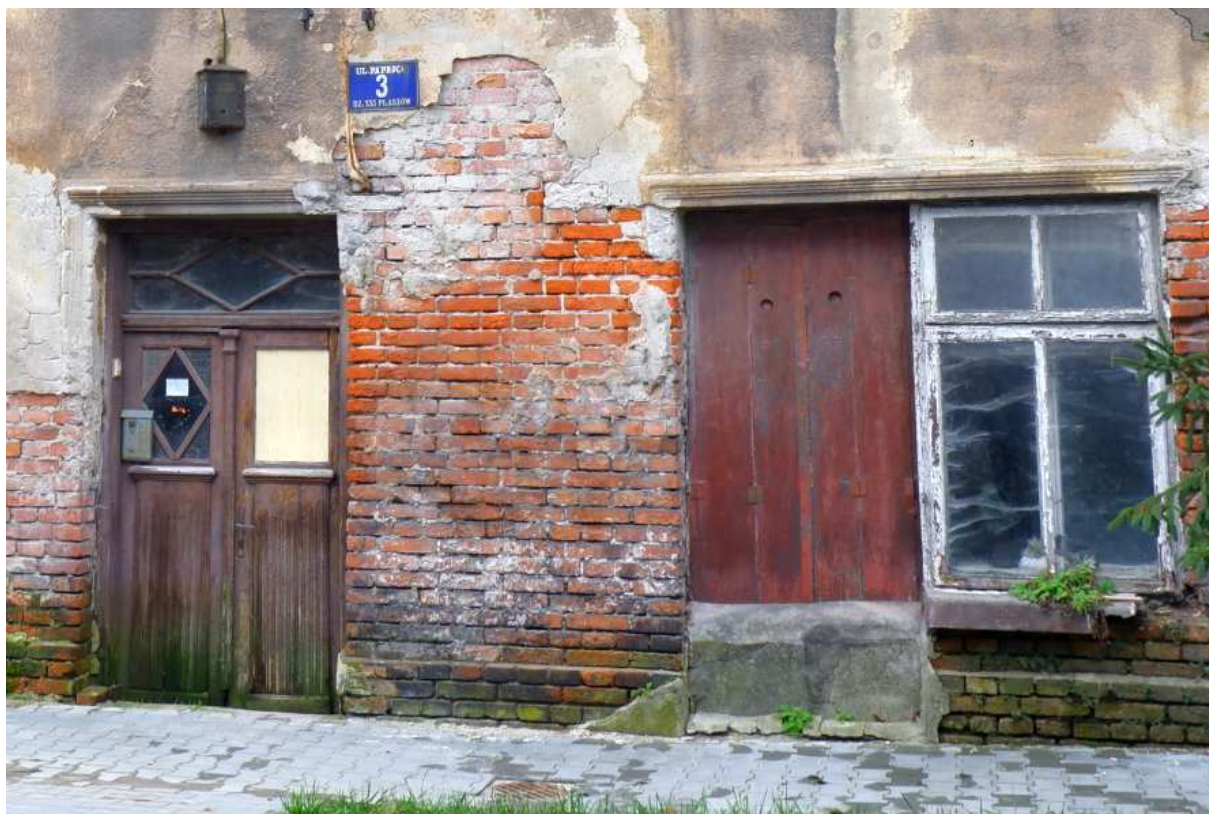
Fot. nr 455. Detale fasady. (14.02.2024)
