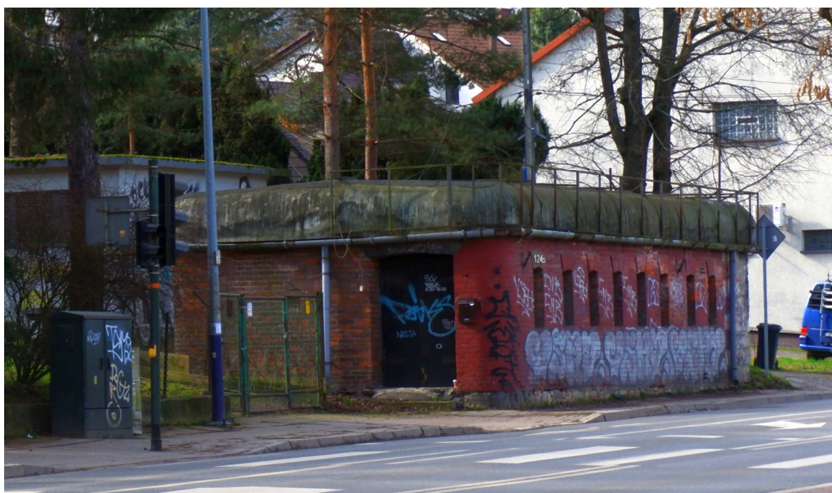
Fot. nr 234. Schron amunicyjny w dawnej bramie Wola Justowska przy ulicy Królowej Jadwigi, u wylotu ulicy Piastowskiej. (26.02.2024)
