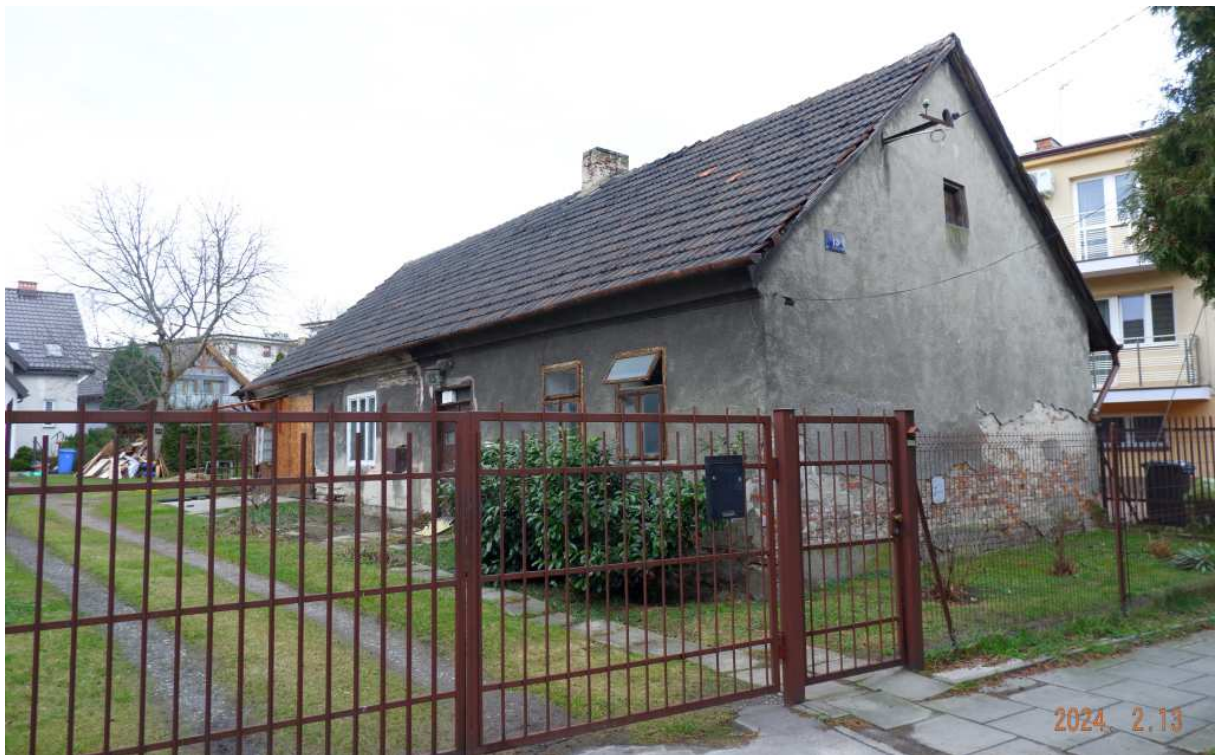
Fot. nr 470 (470-471). Fasada od strony podwórka.
