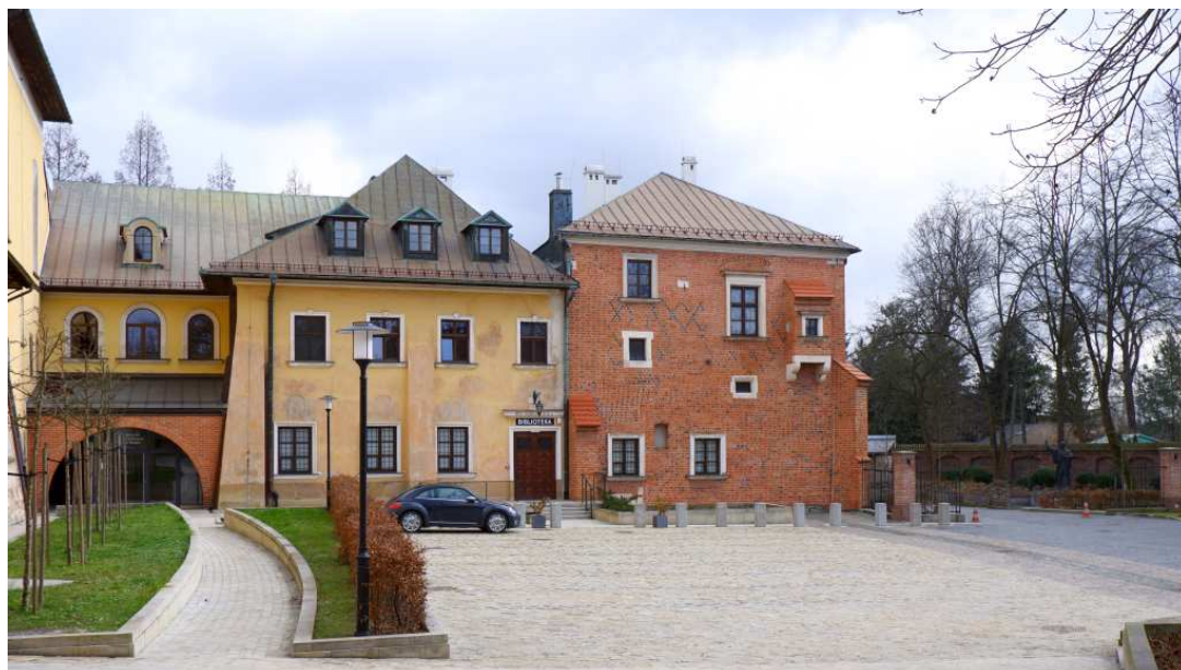
Fot. nr 351. Budynek biblioteki.
