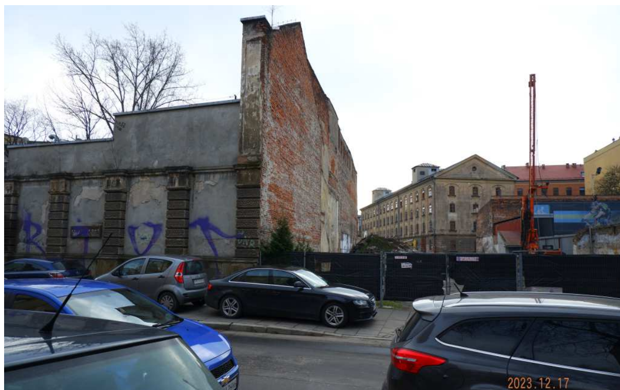
Fot. nr 171. Hala fabryczna „cygar fabryki” ponad wyburzoną kamieniczką pod nr 4.
