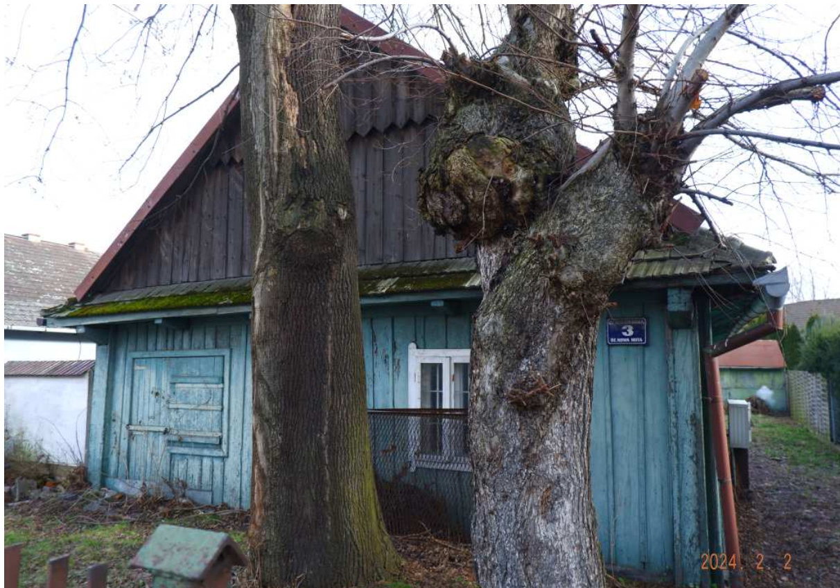
Fot. nr 331. Ściana szczytowa od strony ulicy z pomieszczeniem posklepowym.
