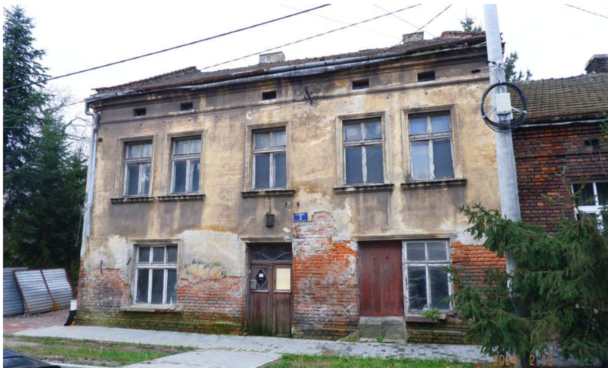
Fot. nr 454 (454-455). Opuszczona kamieniczka pod nr 3.
