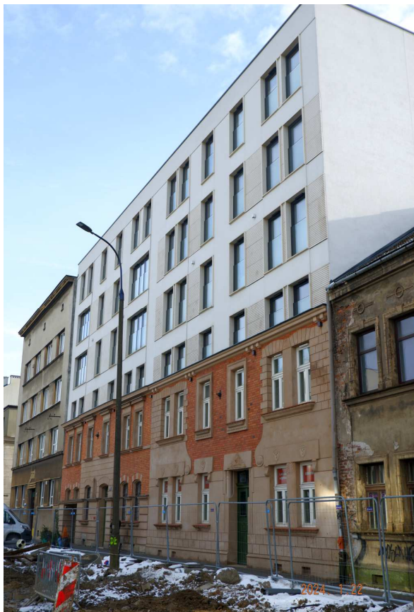
Fot. nr 211 (211-213). Wchłonięte w ścianę apartamentowca fasady domów pod nr: 60-62.
