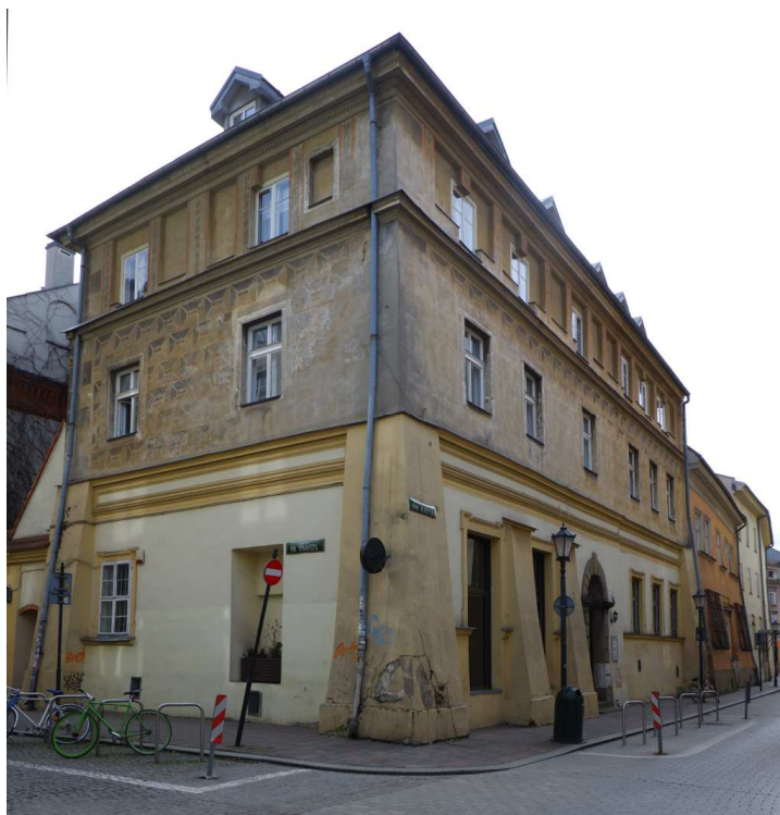
Fot. nr 70. Na styku ulic: św. Krzyża i św. Tomasza. (22.02.2024)
