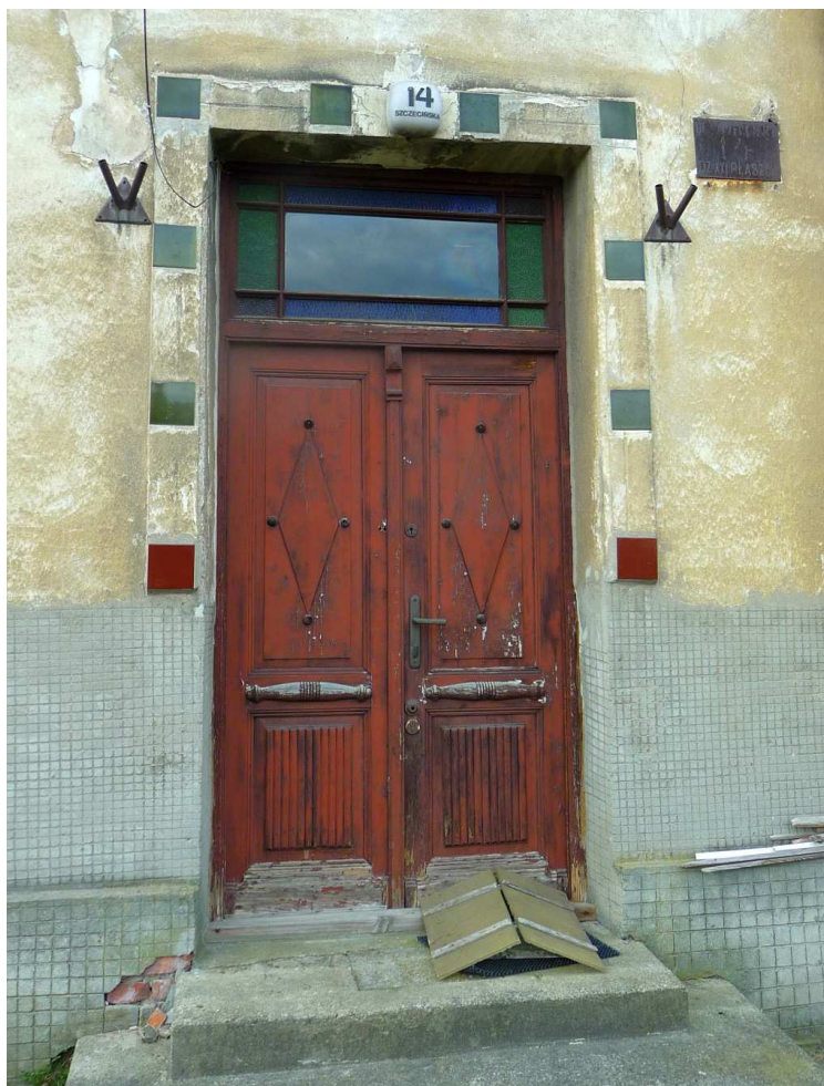
Fot. nr 419. Oryginalne drzwi. (24.02.2024)
