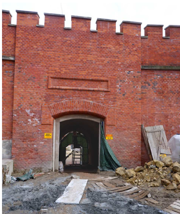
Fot. nr 246. Wjazd do bastionu. (26.02.2024)
