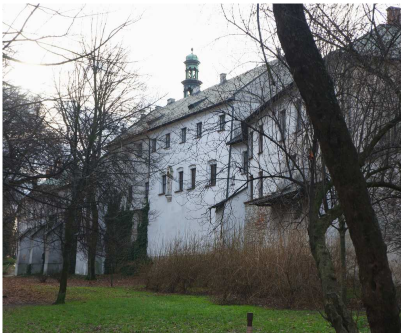
Fot. nr 46. Mury klasztoru Bernardynek w ujęciu z Plant. (29.12.2023)
