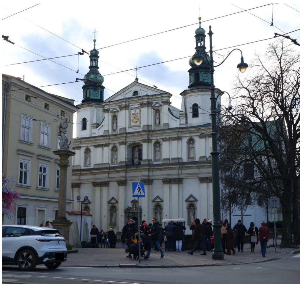
Fot. nr 380. Fasada od strony ulicy Stradomskiej. (29.12.2023)
