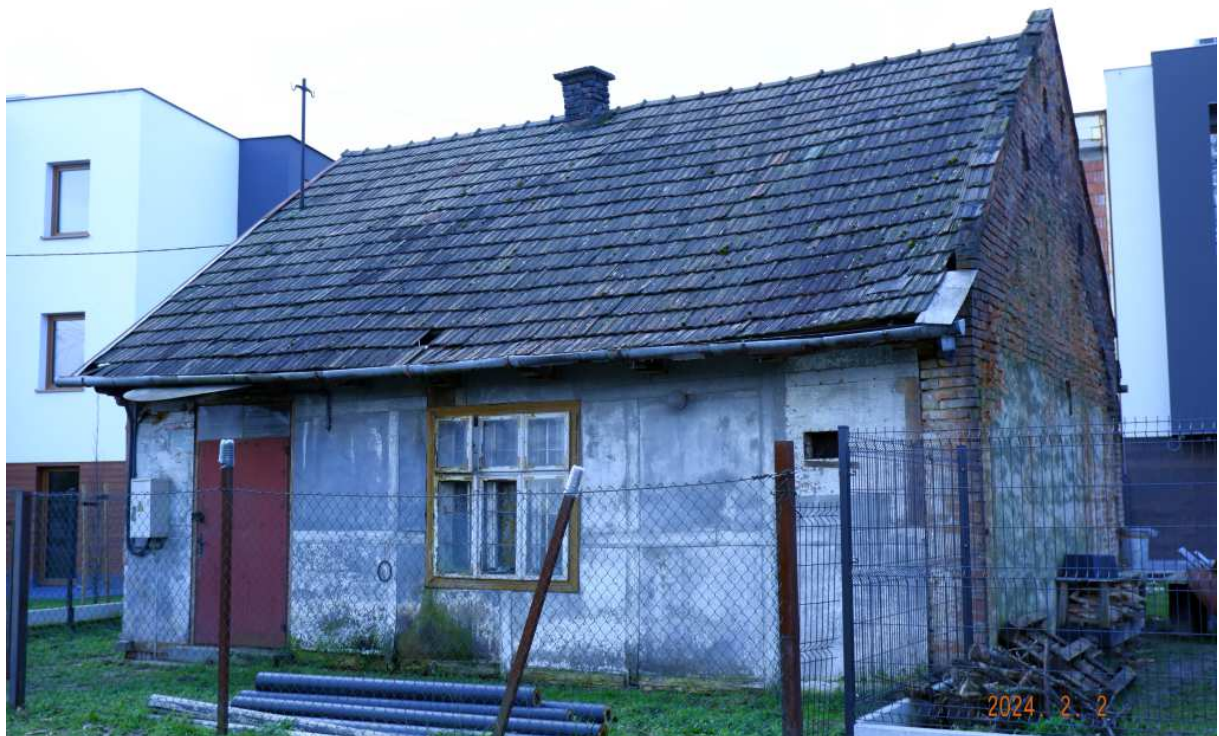
Fot. nr 326 (326-327). Tylna elewacja i jej detale.
