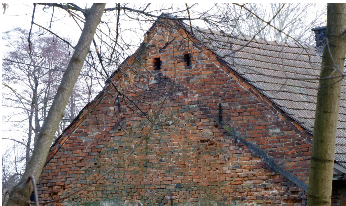
Fot. nr 324. Boczna ściana szczytowa. (02.02.2024)
