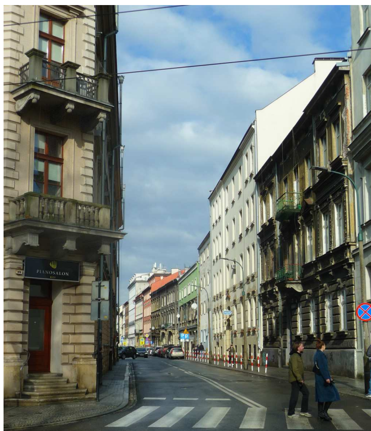
Fot. nr 271. Wzdłuż ulicy Krowoderskiej. (10.02.2024)
