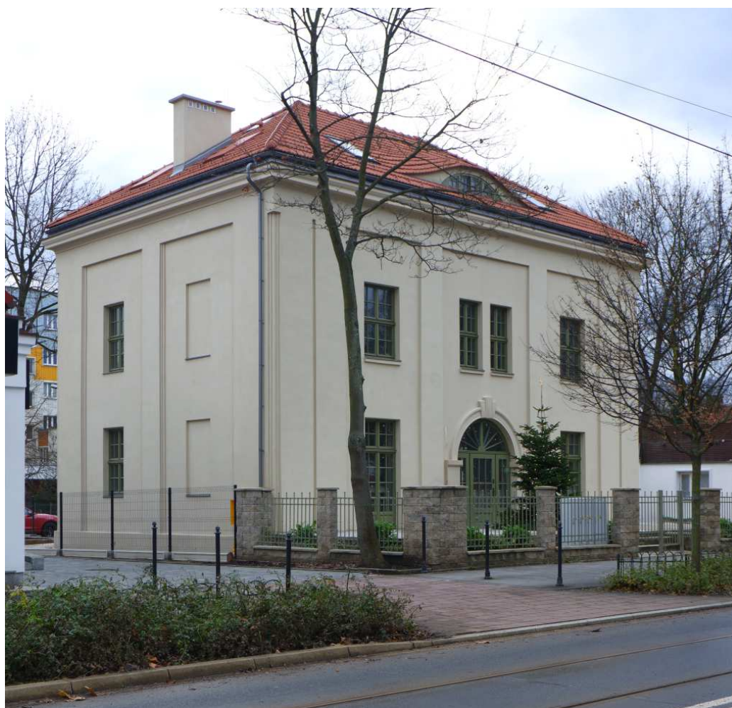
Fot. nr 309. Willa Olsza z ulicy Rakowickiej 35, wybudowana ok. roku 1926, która pierwotnie służyła Miejskiemu Przedsiębiorstwu Ogrodnictwu.
