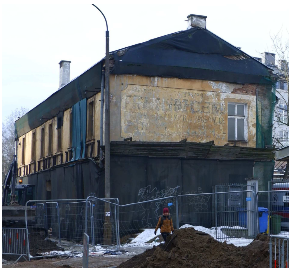
Fot. nr 208. Dom pod nr 51 i ślad dawnej reklamy na jego bocznej ścianie.
