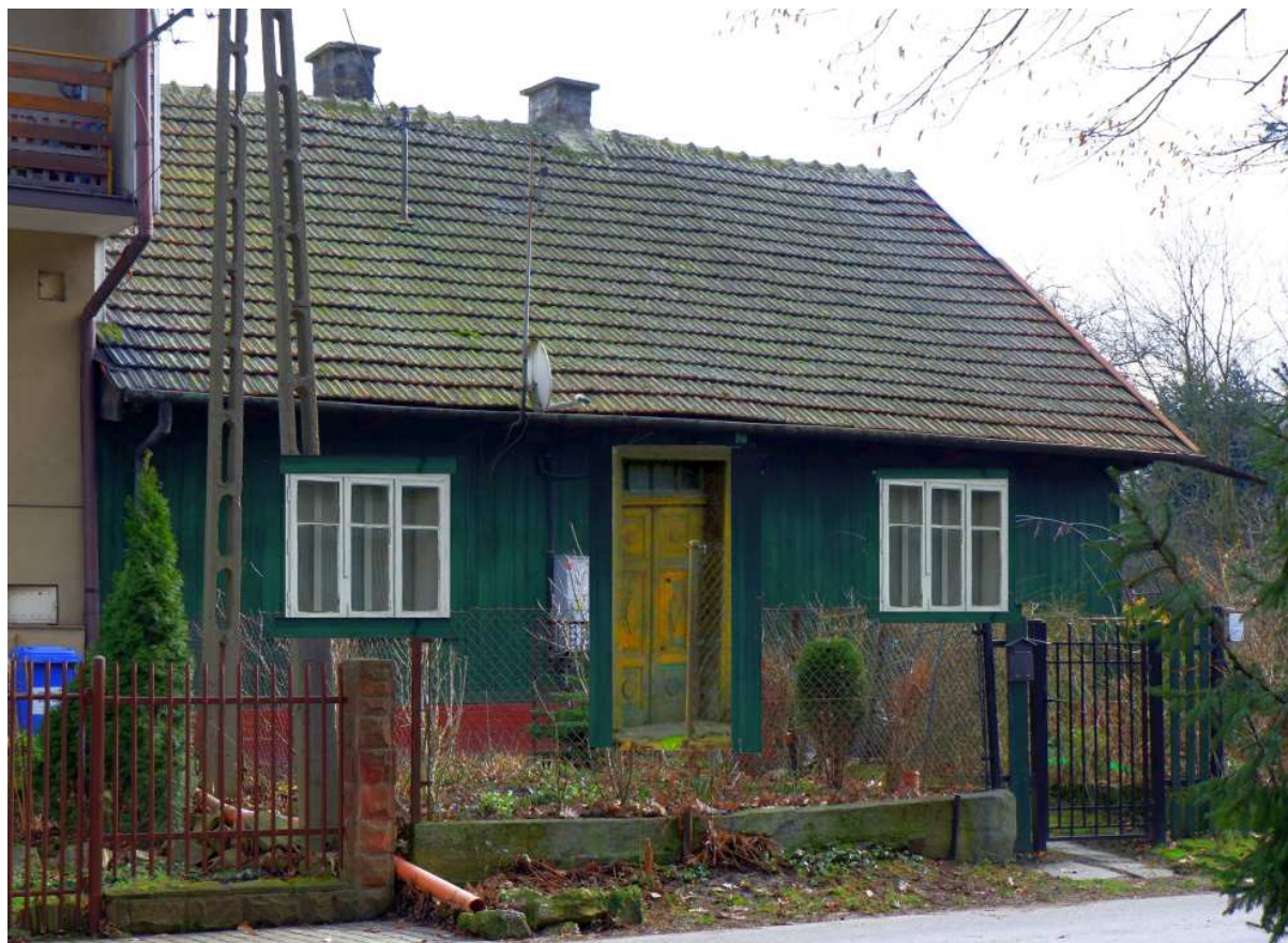
Fot. nr 427. Próba rekonstrukcji fasady.
