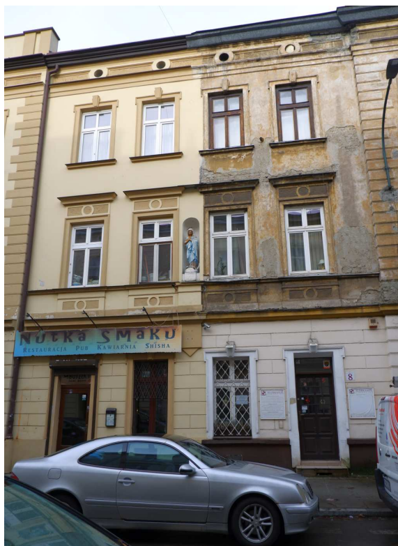
Fot. nr 297 (297-298). Fasada kamienicy z ulicy Zamenhofs 8. (02.01.2024)
