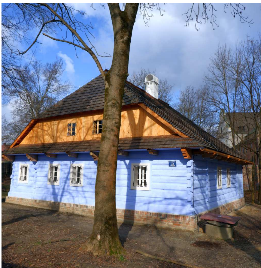
Fot. nr 362 (362-364). Ściana szczytowa.
