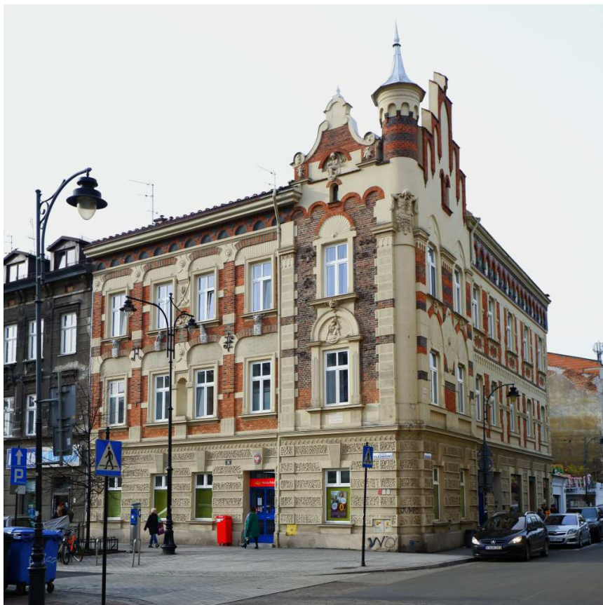
Fot. nr 262. Eklektyczna kamienica z końca XIX wieku z Rynku Kleparskiego 15. (02.01.2024)
