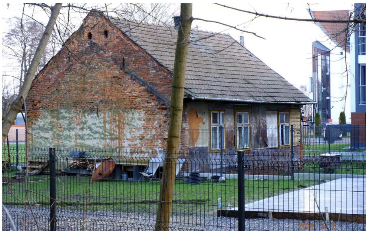
Fot. nr 323 (323-328). Zrujnowana dawna chałupa z ulicy Bulwarowej 11, o czym świadczą zachowane fragmenty ścian wykonanych z drewnianych bali i dwie warstwy dachu, zapewne przebudowana w okresie międzywojennym na murowany dom. Obecnie obiekt jest wciśnięty między współczesną zabudowę.
