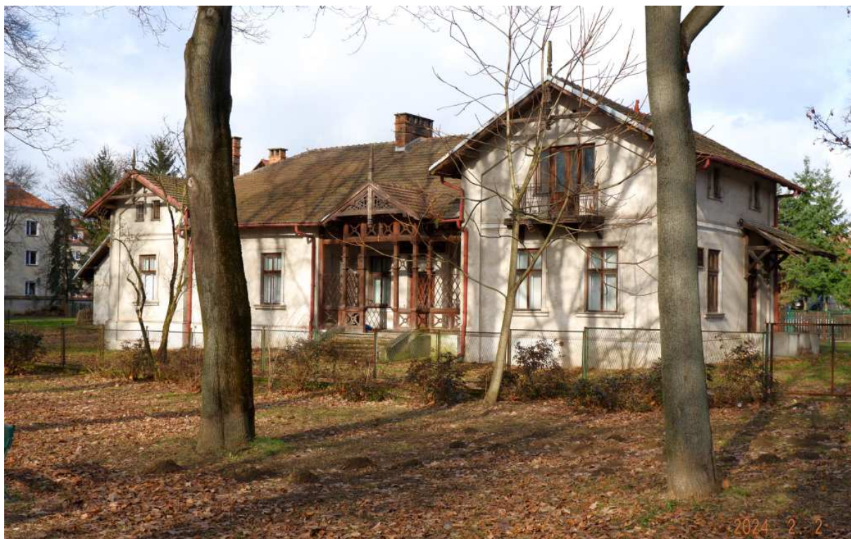
Fot. nr 337 (337-341). Fasada od strony ulicy Sieroszewskiego i jej detale
