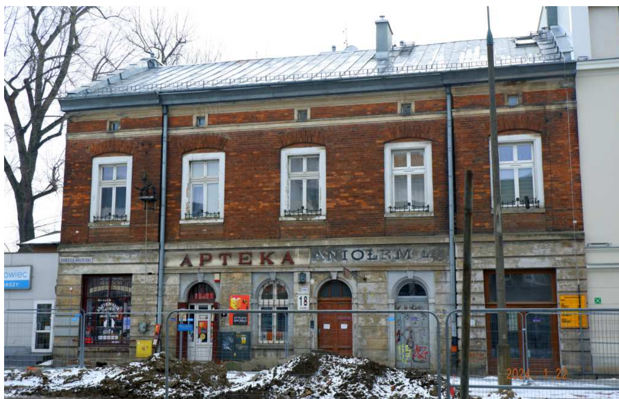
Fot. nr 194 (194-219). Wzdłuż ulicy Kościuszki. Fot. nr: 194-197. XIX-wieczna kamieniczka pod nr 18 i jej detale.
