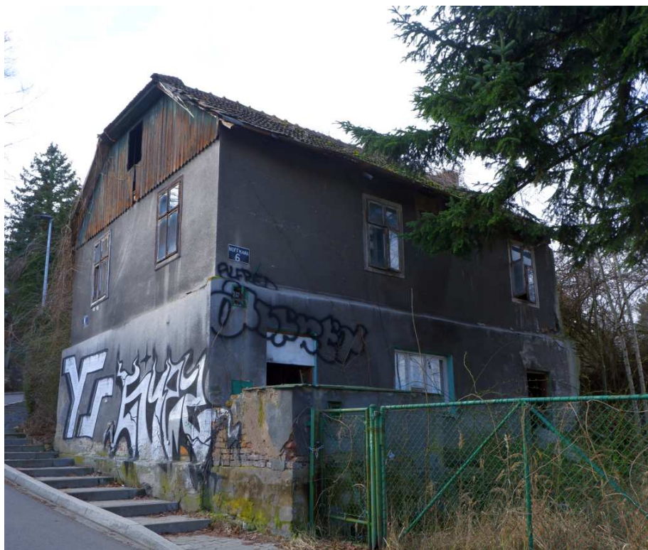
Fot. nr 235 (235-240). Wzdłuż ulicy Hoffmana, dawnej Spadzistej. Relikt dawnej zabudowy pod nr 6. (26.02.2024)
