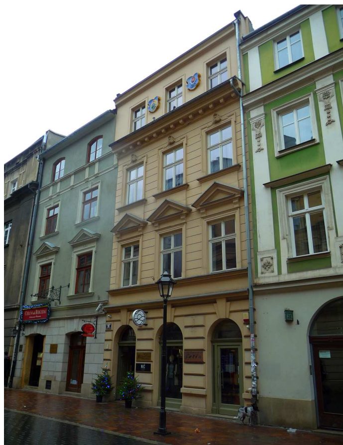
Fot. nr 105. Fragment zabudowy o nr: 26 i 28. (04.01.2024)
