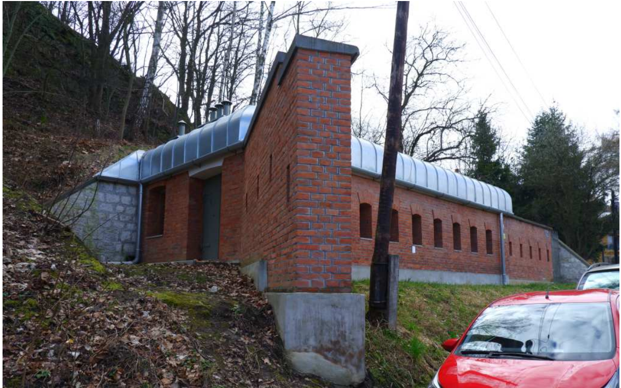
Fot. nr 239 (239-240). Odnowione pozostałości zespołu bramnego 3b fortu Kościuszko pod nr 23. (26.02.2024)
