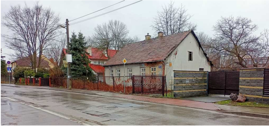
Fot. nr 390 (390-391). Ostatnie chwile wielorodzinnego domu spod nr 93. (05.02.2024)
