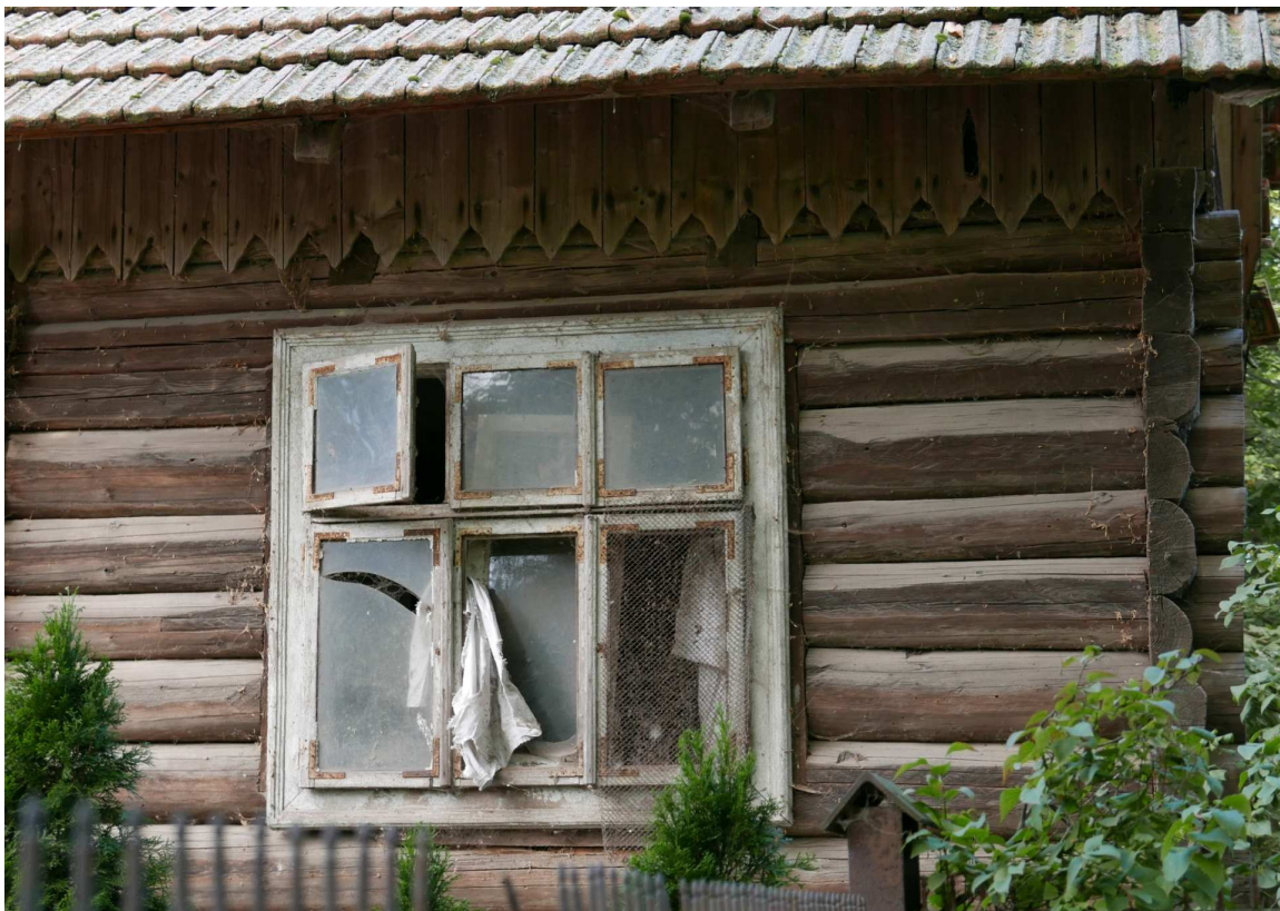
Fot. nr 317 (317-318). Oryginalne okna typu weneckiego.
