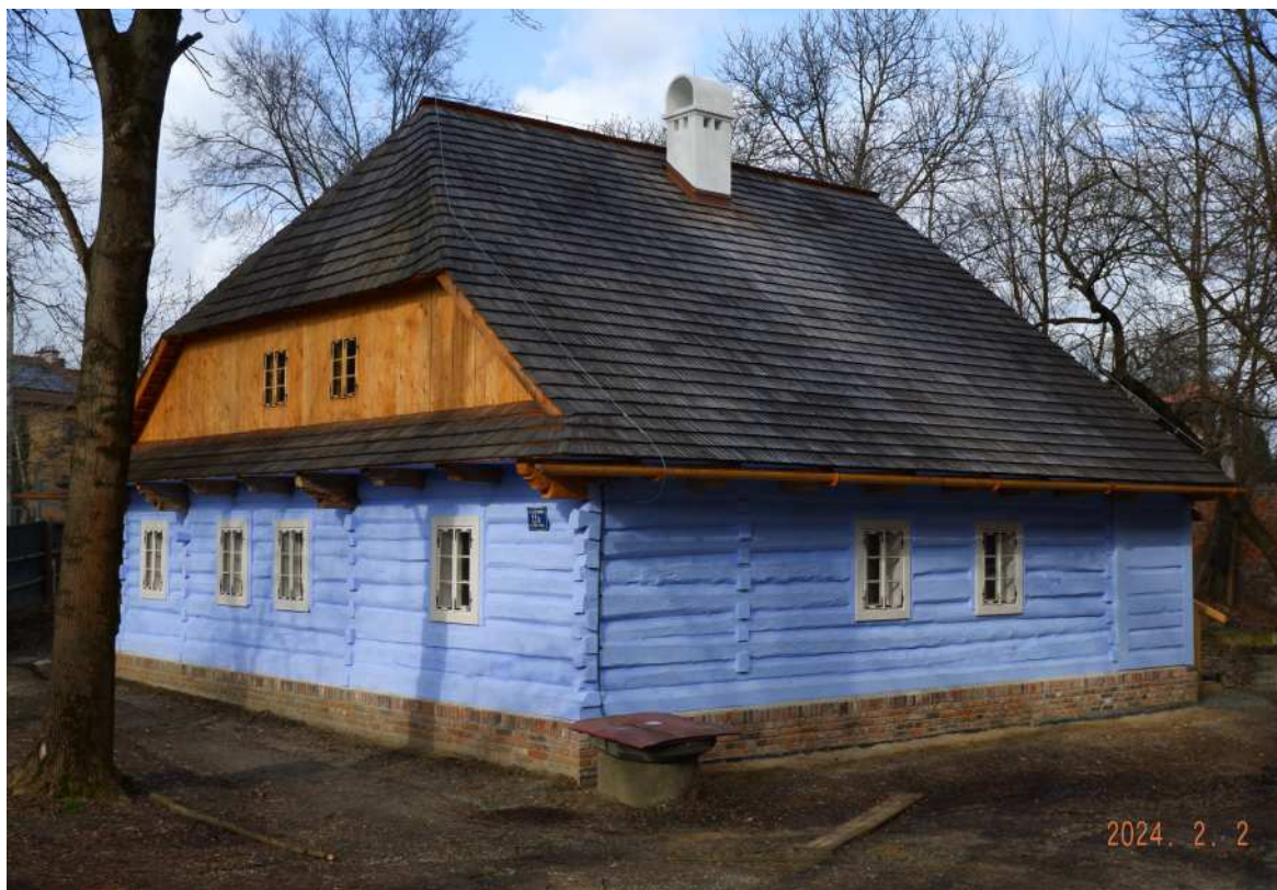
Fot. nr 361 (361-365). Ujęcia od strony ulicy Żaglowej.
