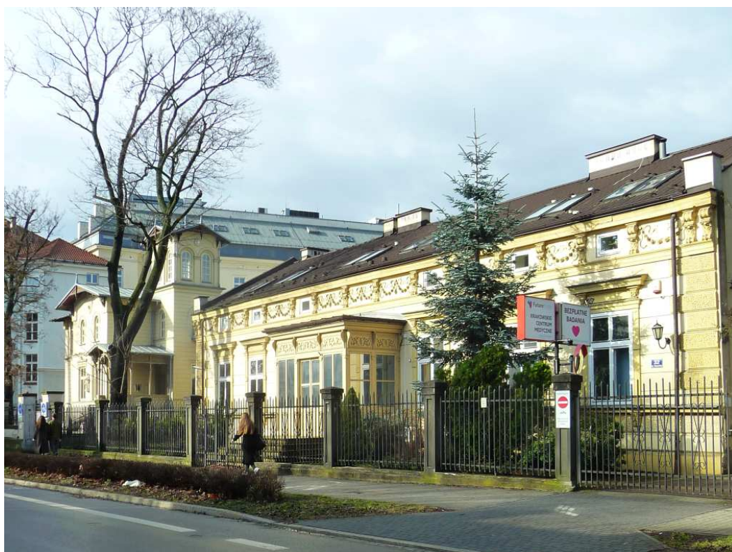
Fot. nr 283. Willa Szafrąńskich przy ulicy Kopernika 32. (10.02.2024)
