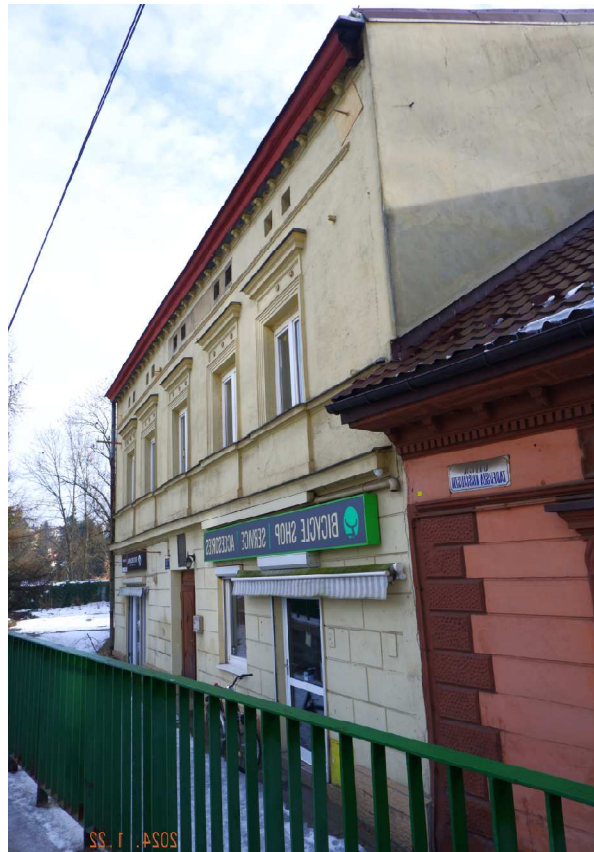
Fot. nr 219. Piętrowy dom pod nr 84.
