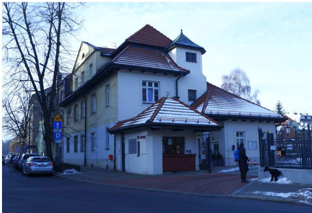
Fot. nr 230. Budynek mieszkalno-administracyjny Krakowskich Wodociągów przy ulicy Senatorskiej 1.
