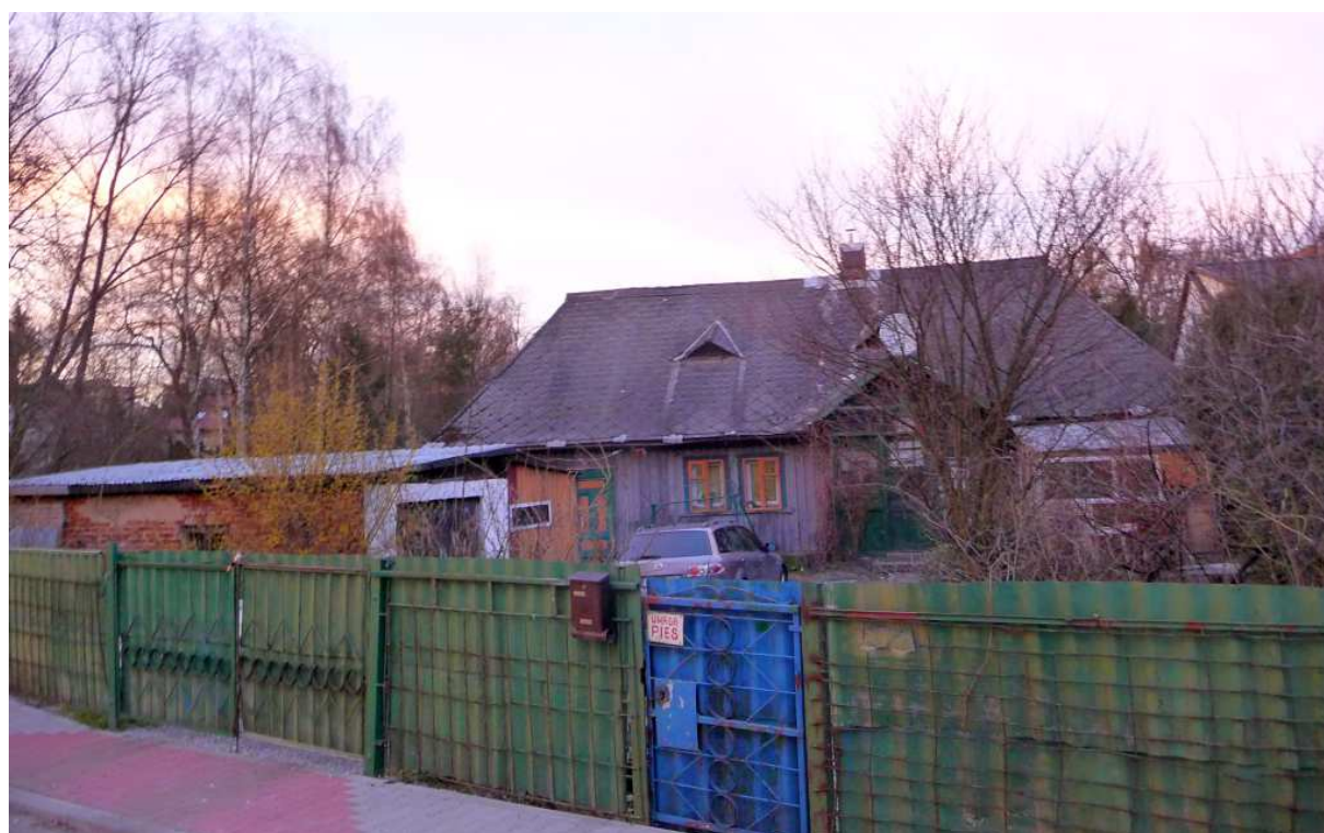
Fot. nr 541 (541-542). Ciągłe zadbana chałupa z ulicy Zbrojarzy 55. (25.02.2024)
