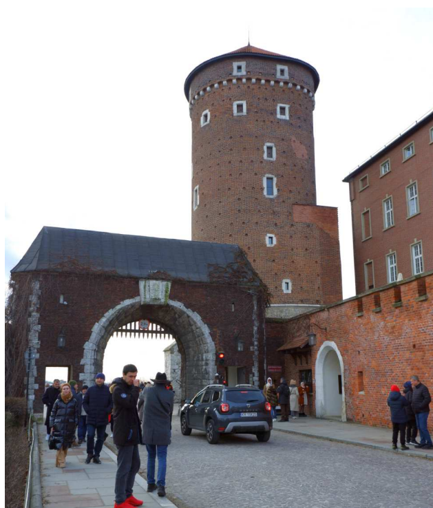
Fot. nr 41. Niehistoryczna brama wjazdowa (Bernardyńska) od strony Stradomia i Baszta Senatorska. (29.12.2023)
