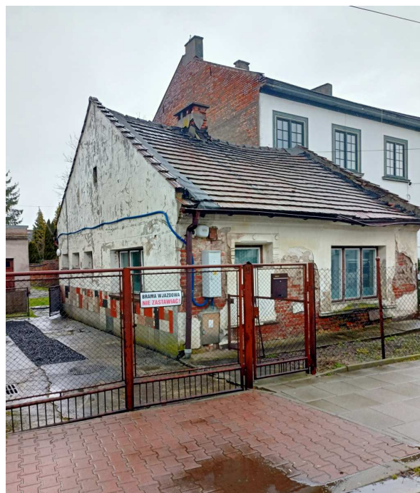
Fot. nr 392. Parterowy dom o mocno zniekształconej fasadzie pod nr 109. (05.02.2024)
