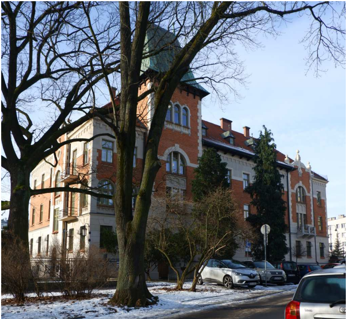
Fot. nr 231. Dworzec Wodociągowy przy ulicy Łowickiej 2.
