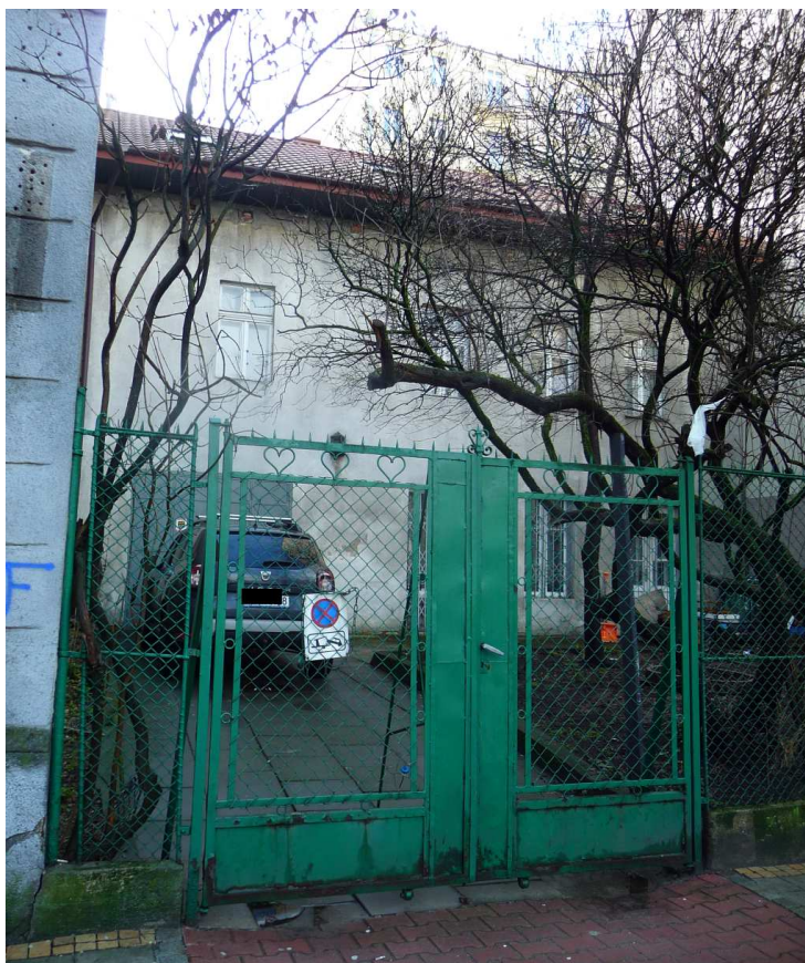
Fot. nr 264. Archaiczny dom, zapewne z końca XIX wieku, z Rynku Kleparskiego 1. (10.02.2024)
