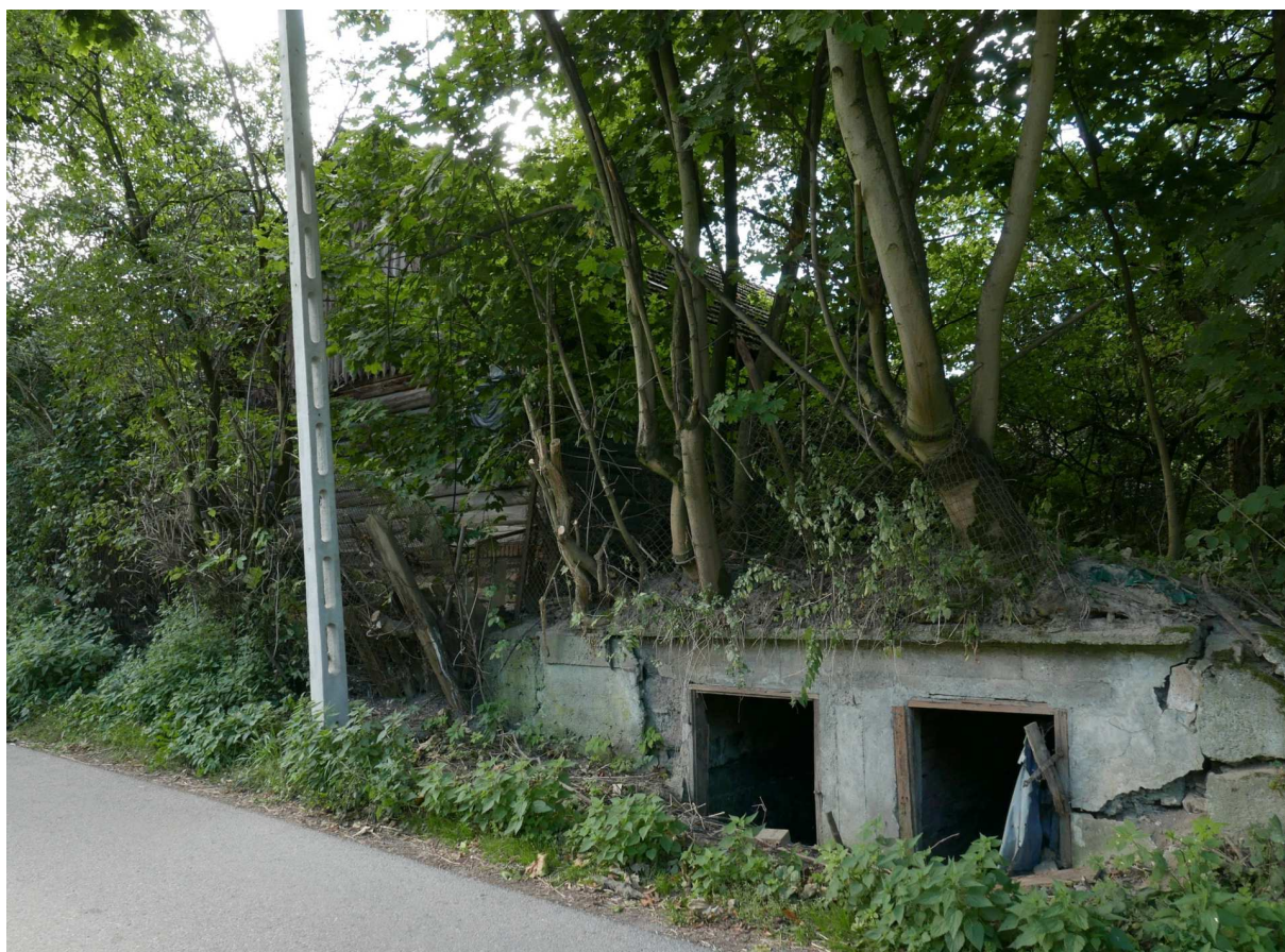
Fot. nr 314. Piwniczka przy domu.
