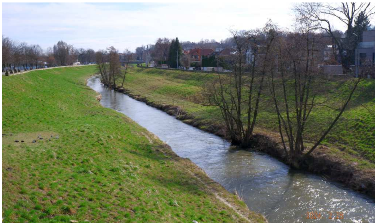
Fot. nr 193. Wzdłuż Rudawy poniżej trzeciego mostu. (26.02.2024)
