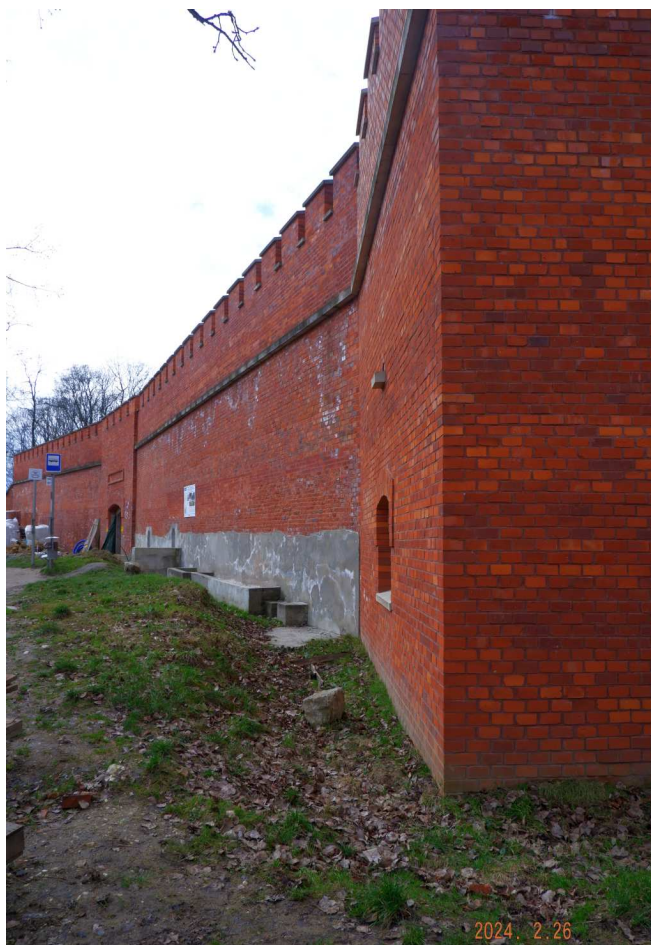
Fot. nr 245 (245-246). Odnowiona ściana wewnętrzna bastionu nr 2.
