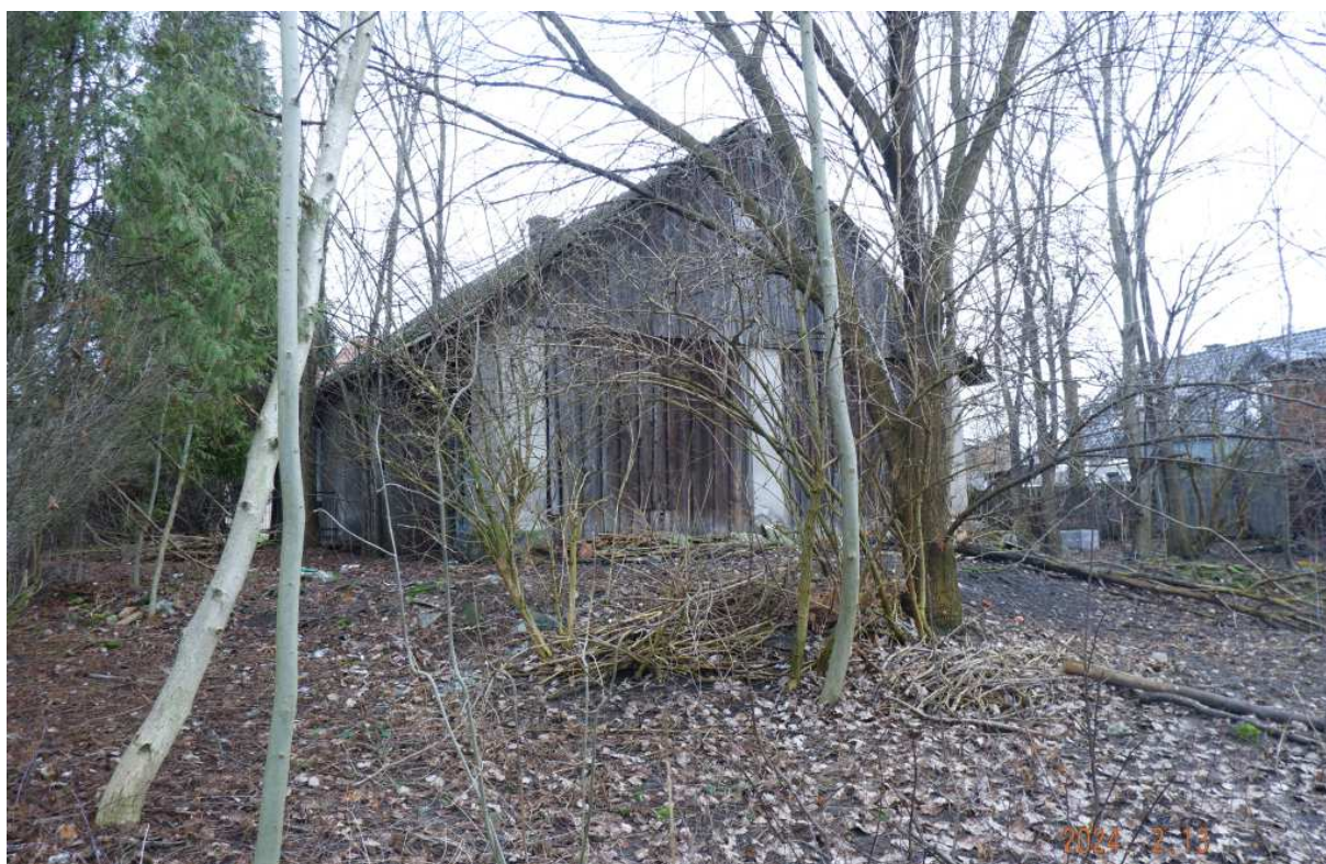
Fot. nr 476. Szczytowa ściana obiektu.
