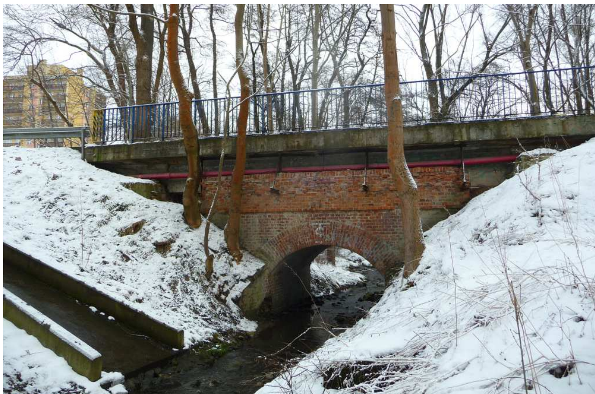
Fot. nr 504. Mostek w ciągu ulicy Facimiech. (19.01.2024)
