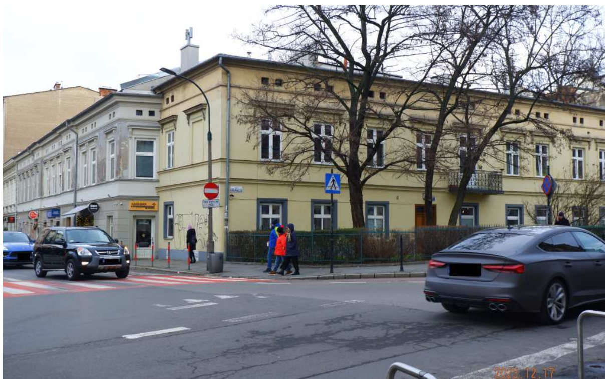
Fot. nr 162. Narożnik z ulicą Dolnych Młynów.
