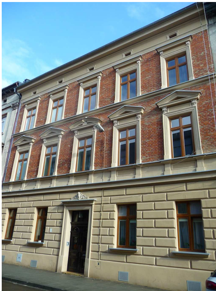
Fot. nr 279. Odnowiona kamienica przy ulicy Strzeleckiej 15. (10.02.2024)
