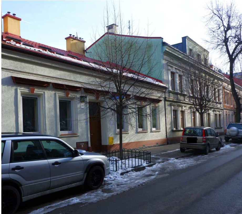
Fot. nr 225 (225-226). Ciągłe niska, typowo podmiejska zabudowa ulicy Filareckiej o numerach: 7-11.
