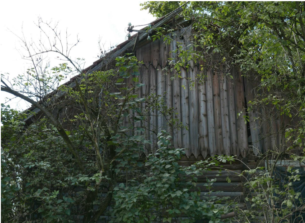
Fot. nr 320 (320-321). Boczna ściana szczytowa.
