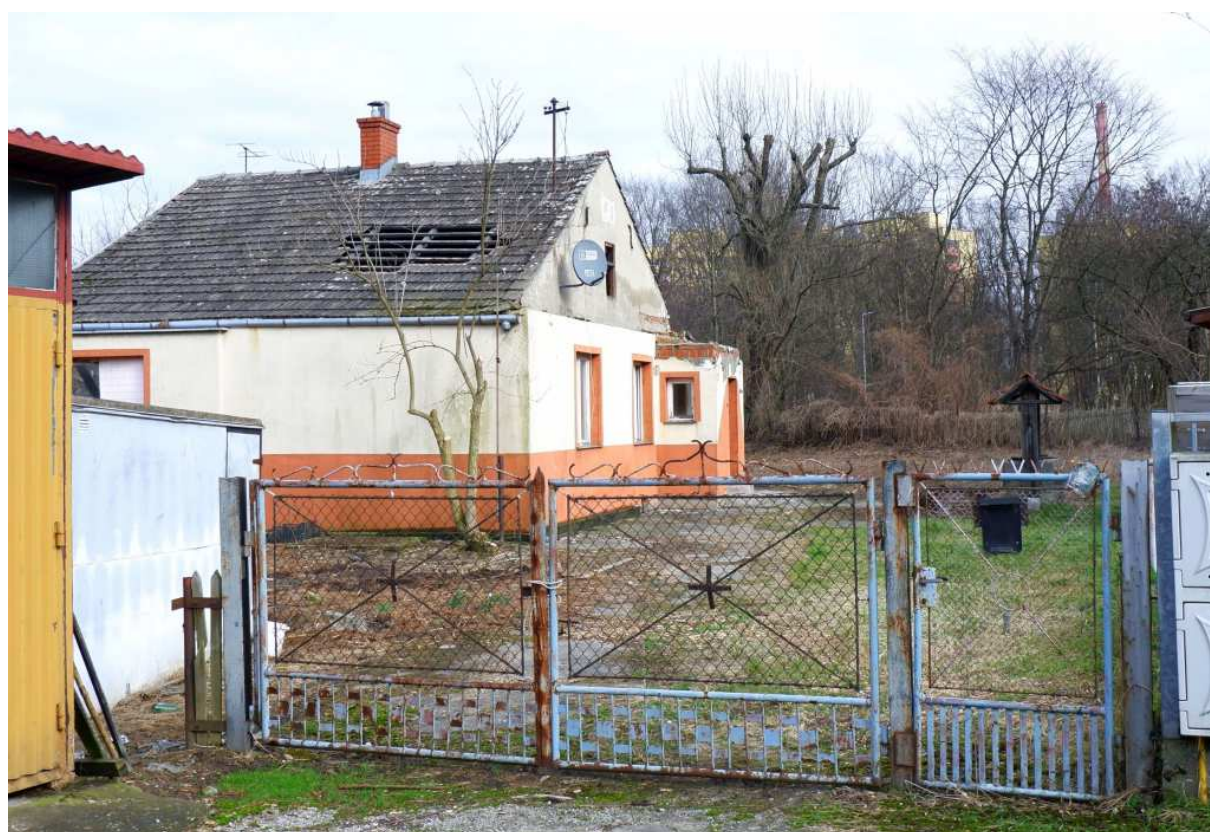
Fot. nr 434. Ruina zapewne powojennego domu z ulicy Zadworze 6. (14.02.2024)
