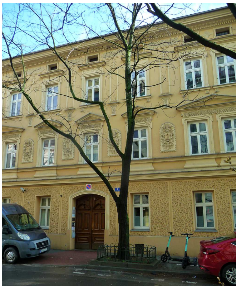
Fot. nr 287. Kolejna odnowiona kamienica czynszowa z ul. Dwernickiego 7. (10.02.2024)
