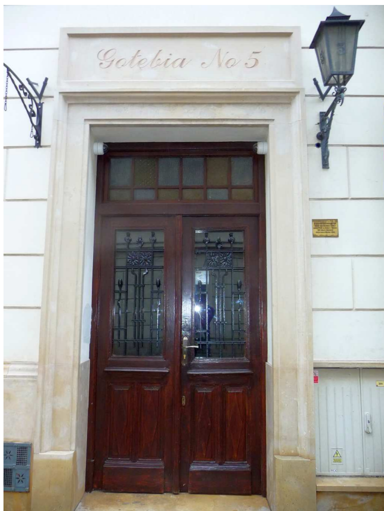
Fot. nr 132. Drzwi kamienicy z ulicy Gołębiej 5.(04.01.2023)
