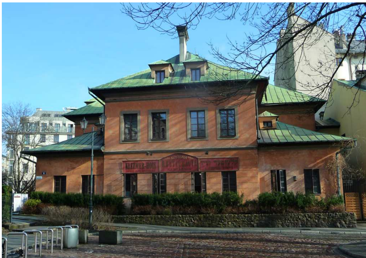
Fot. nr 395. Odbudowana mykwa pod nr 6. (10.02.2024)
