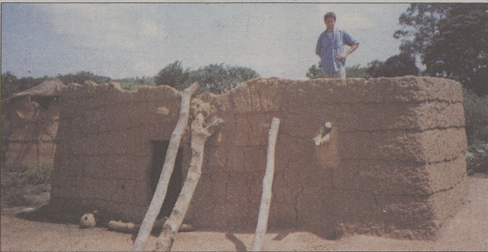
Dom Lobi w budowie
