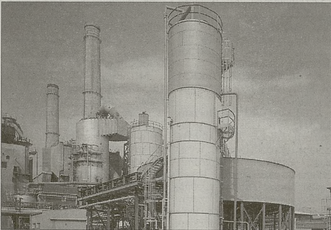
Amerykańska instalacja odsiarczania spalin nie zadziałała w skawińskiej elektrowni
